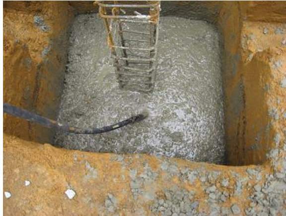
Foto 7. Fundición zapatas
