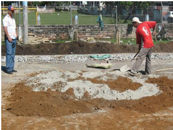
Foto 22. Mezcla del suelo con cemento
