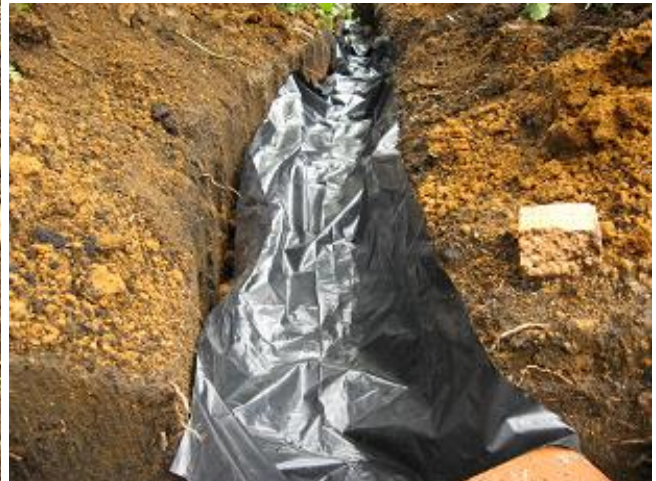
Foto 9,10. Zanjas de infiltración
