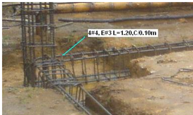
Foto 5. Refuerzo viga de enlace
