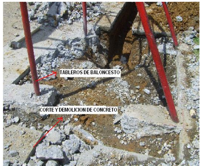
Foto 7. Corte y demolición de concreto
