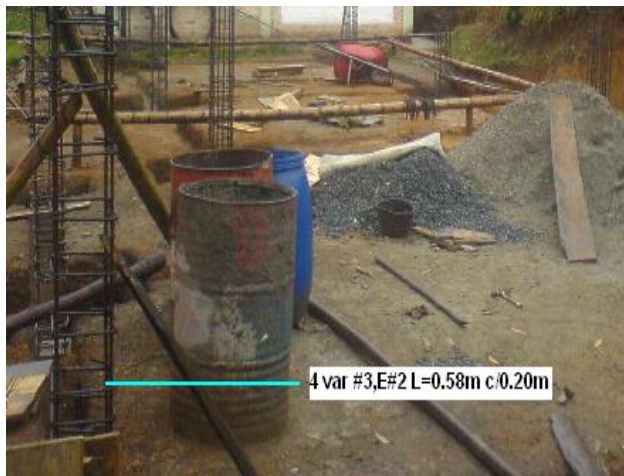
Foto 4. Refuerzo columnas aula.
