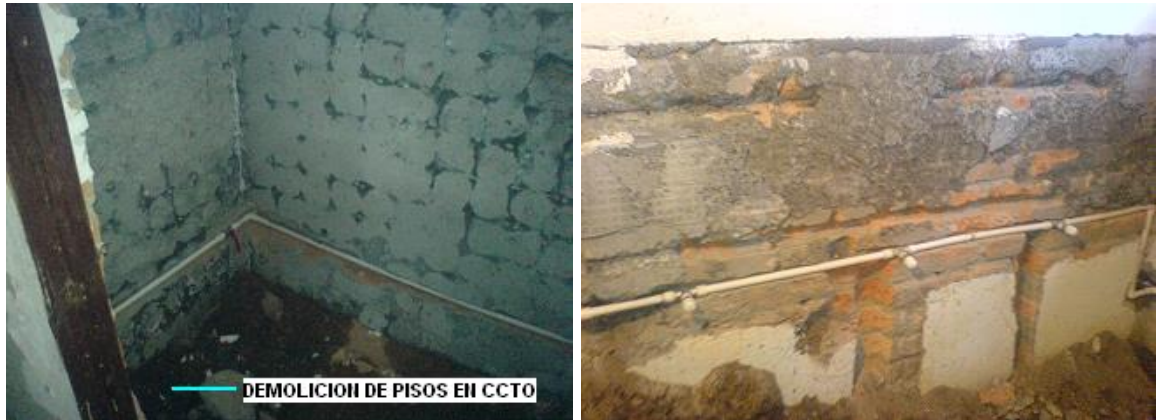
Fotos 5,6,7,8. Demolición enchapes y pisos
