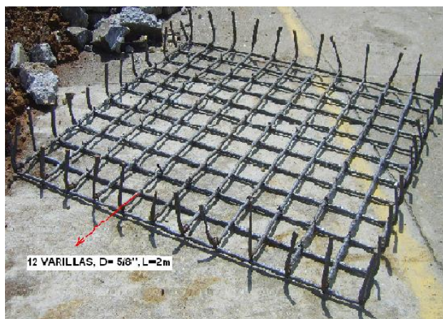
Foto 10. Parrilla para zapatas
