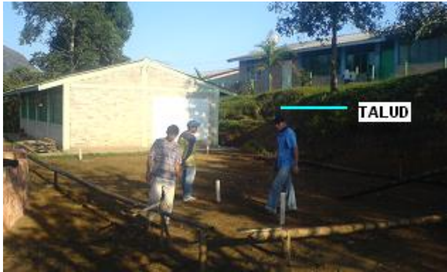
Foto 1. Demarcación zona para construcción
