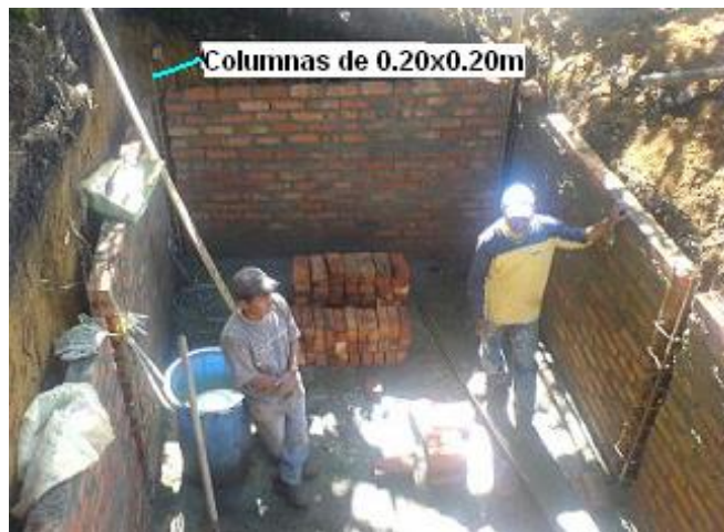
Foto 4. Columnas de confinamiento
