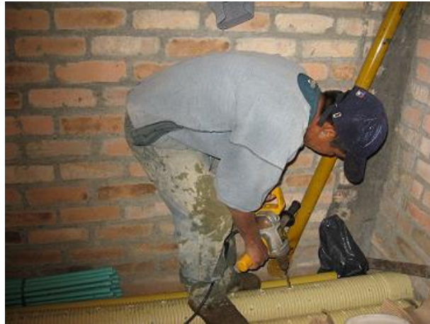
Foto 8. Perforación tubería
