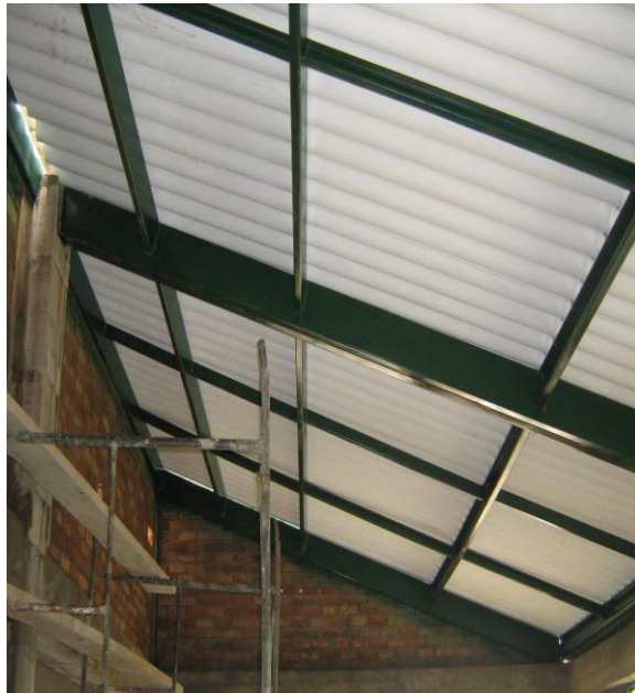
Foto 13. Tejas en Asbesto cemento
