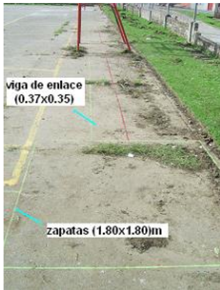
Foto 6. Localización de zapatas y vigas
