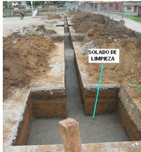
Foto 9. Solado en concreto pobre
