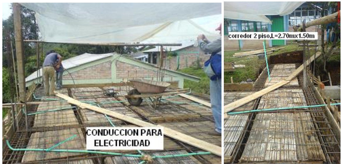
Foto 14,15. Fundición losa aligerada.
