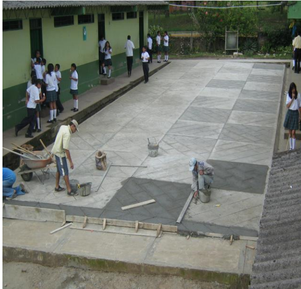
Foto 29. Pavimentación terminada- Patio Secundario
