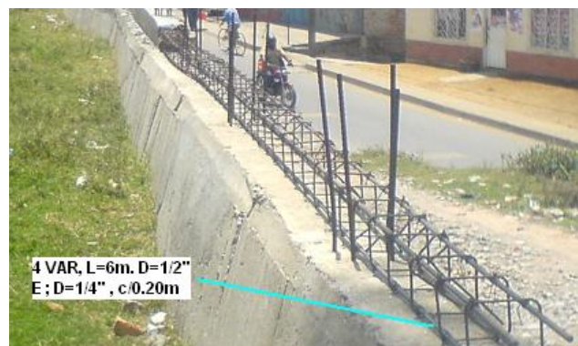
Foto 2. Refuerzo viga de sobrecimiento
