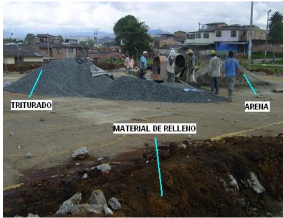
Fotos 13 y 14. Materiales y preparación de Concreto
