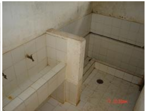
Fotos 3,4. Bateria sanitaria en mal estado
