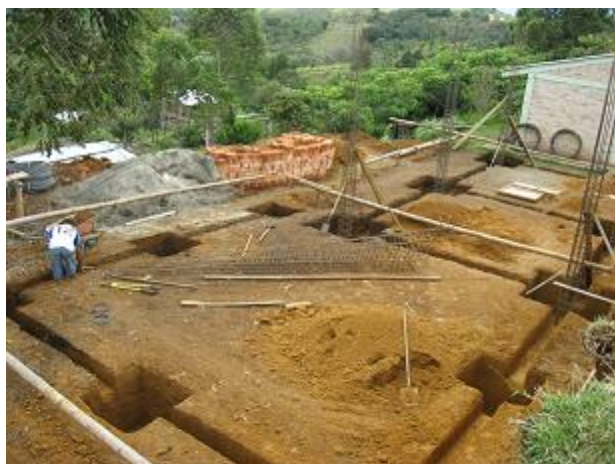
Foto 2. Excavación de zapatas y vigas
