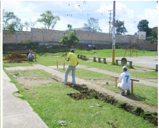
Foto3. Excavación para vigas
