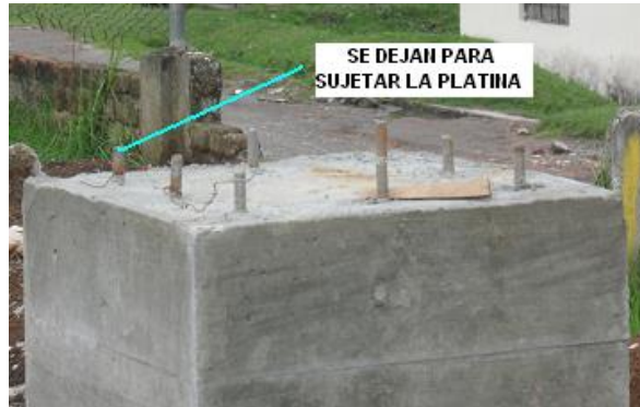
Fotos 19,20,21. Fundición de pedestales
