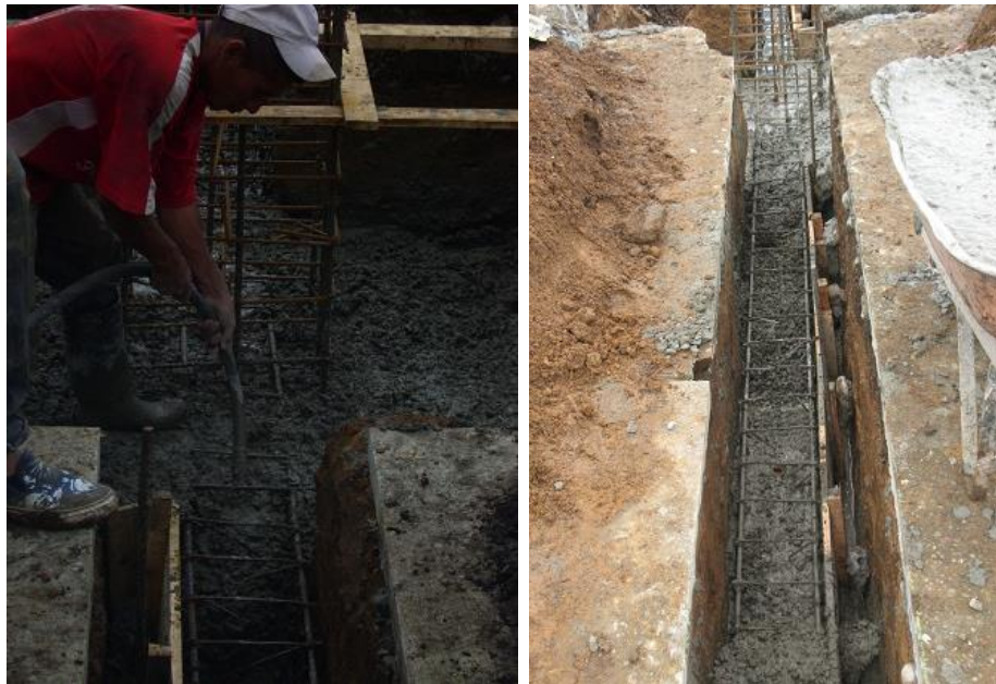
Foto 17 y 18. Vaciado y Vibrado del concreto
