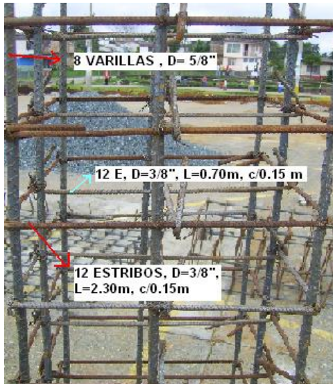
Foto 11. Refuerzo para pedestal
