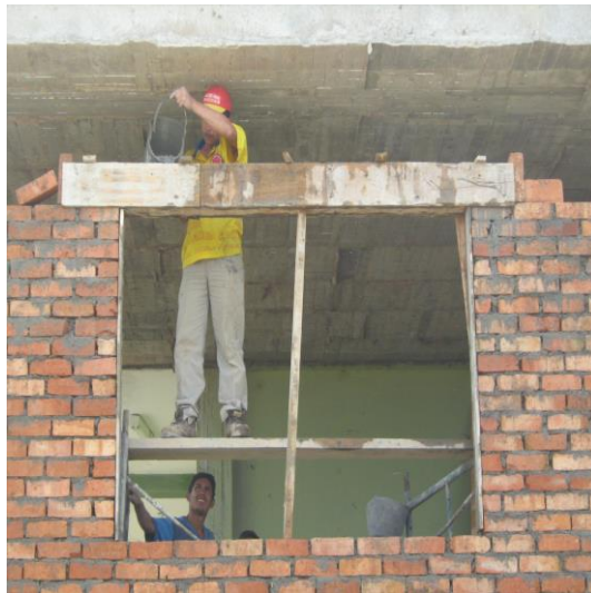
Foto 5. Construcción viga dintel
