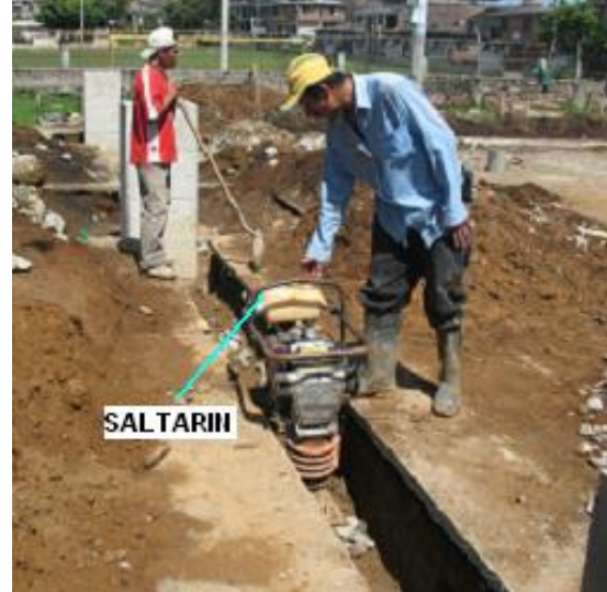
Foto 25. Compactación del material
