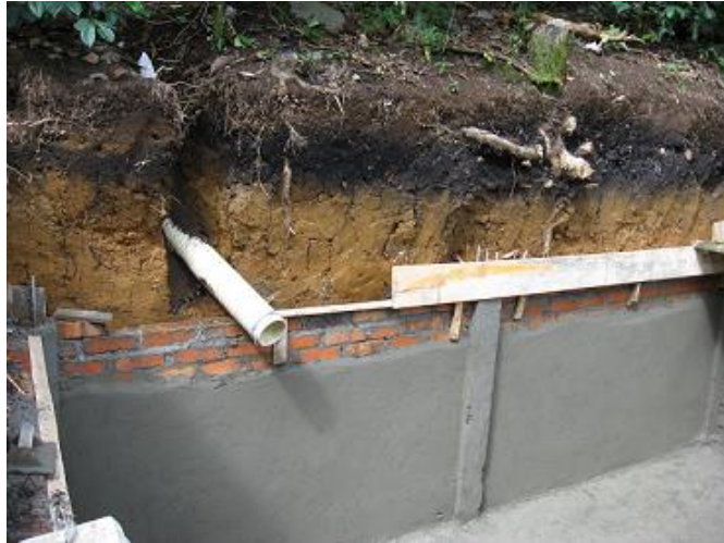
Foto 5. Repello con mortero impermeabilizado
