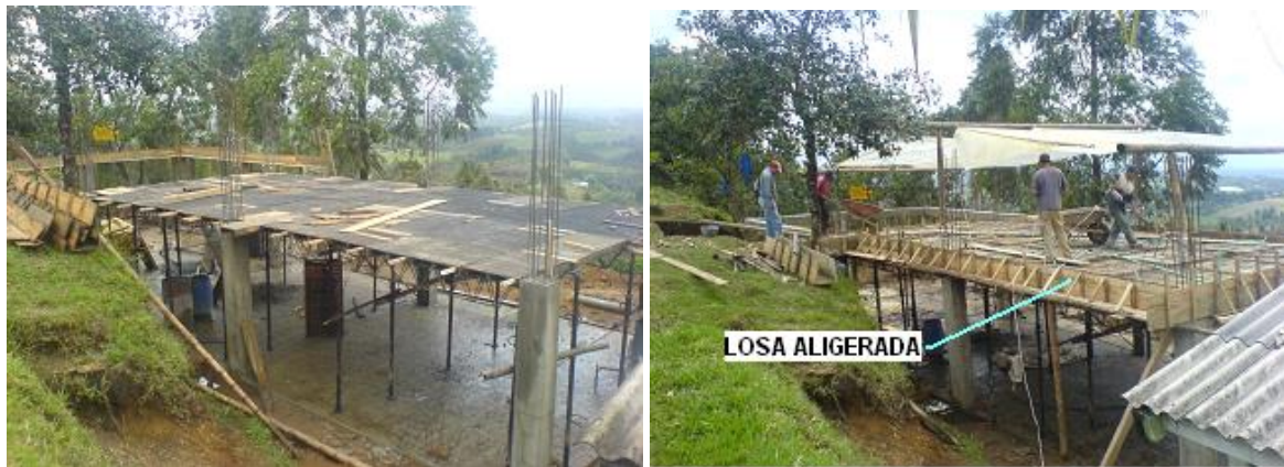
Foto 10,11. Construcción losa aligerada
