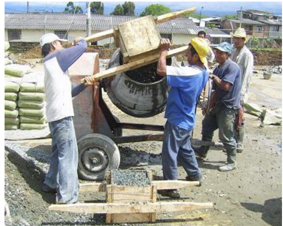
Fotos 13 y 14. Materiales y preparación de Concreto
