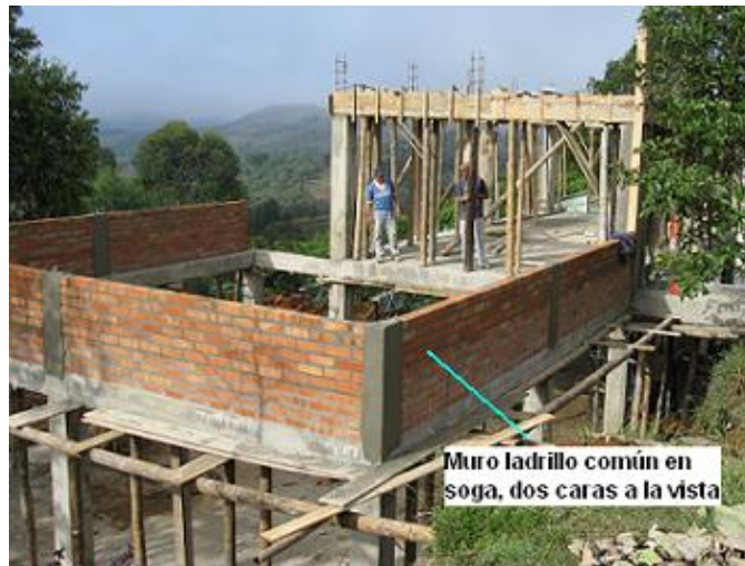
Foto 16. Construcción culata
