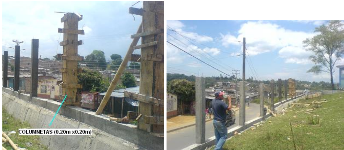
Fotos 3,4. Fundición columnetas
