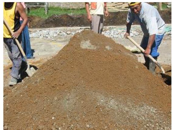
Foto 23. Homogenización del material
