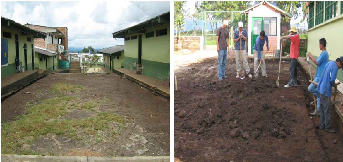
Fotos. 14,15. Nivelación y descapote del terreno
