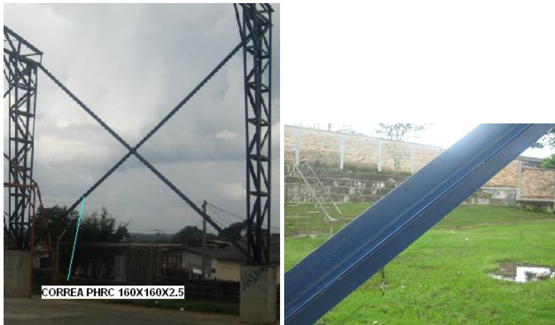
Foto 30,31. Estabilidad de la estructura
