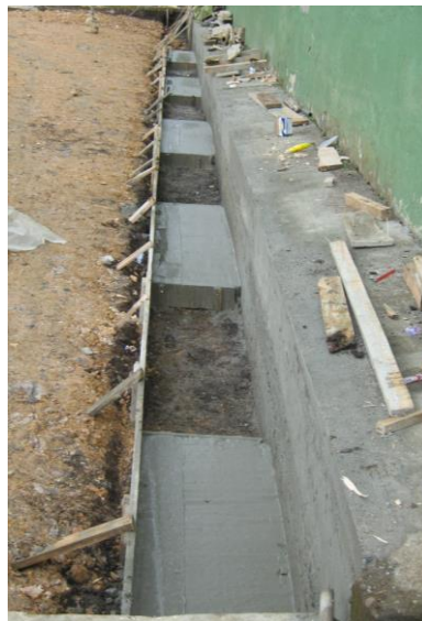
Fotos 16,17,18. Fundición de cunetas
