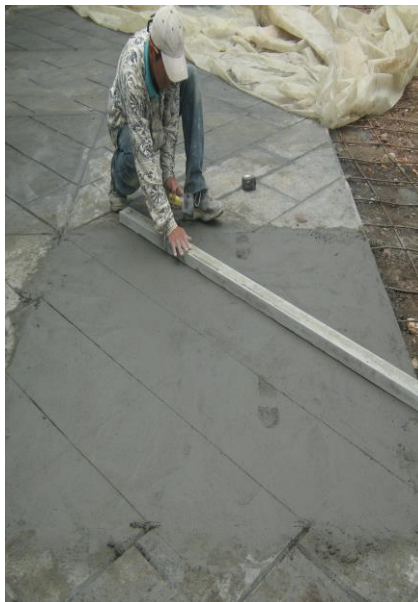
Fotos 22,23,24,25. Construcción Imitación pavimento articulado.
