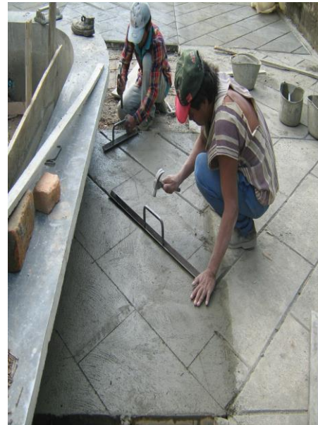
Fotos 22,23,24,25. Construcción Imitación pavimento articulado.
