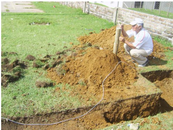
Foto 4. Nivelación con manguera
