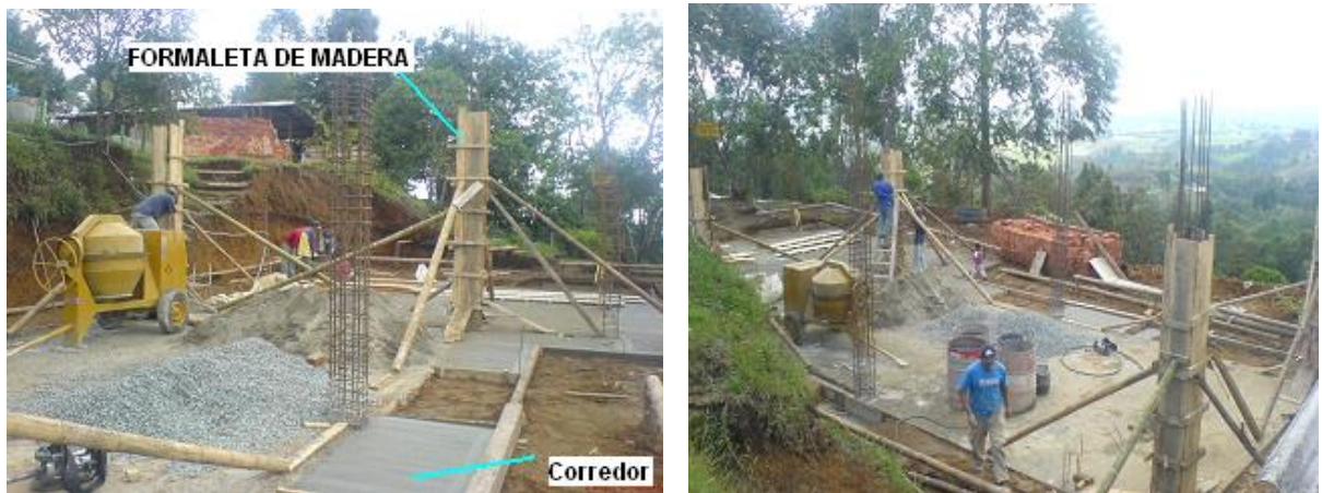
Foto 8,9. Fundición de Losas
