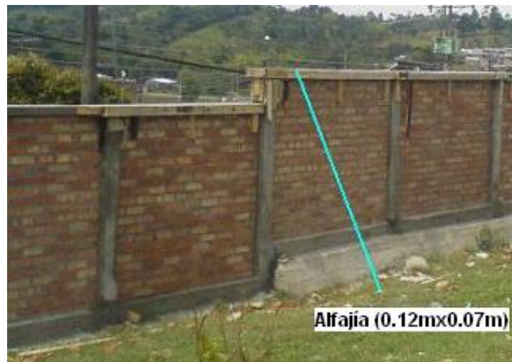
Foto 6. Fundición alfajía con gotero
