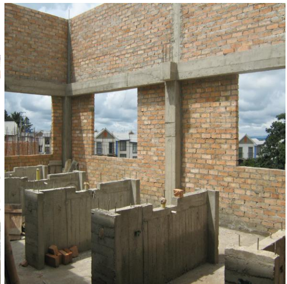
Foto 4. Ventana soportada sobre viga aérea
