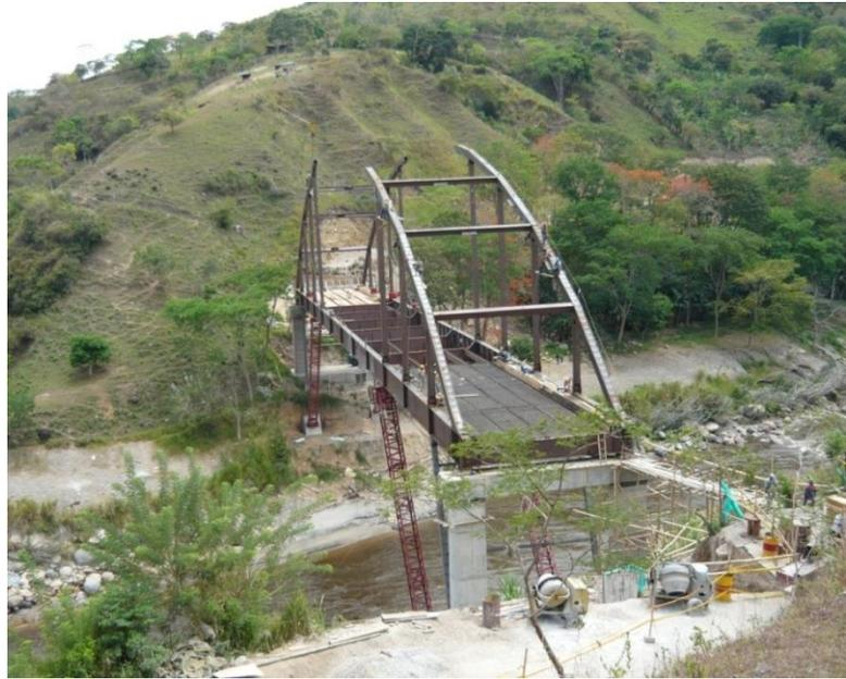
**FOTO 16. Puente Nolasco sin aproches y arcos metálicos sin terminar**
