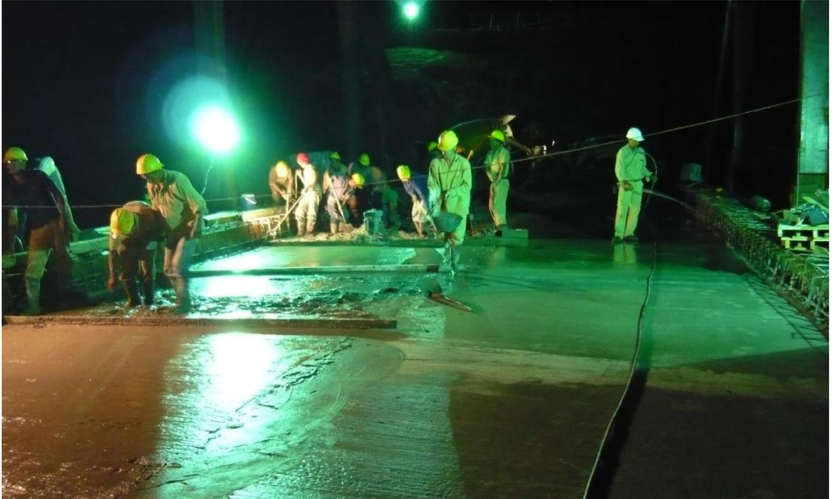
FOTO 10. Fundición de la losa
