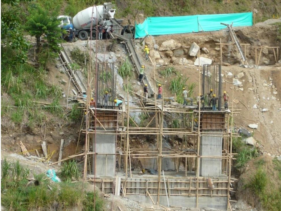
**FOTO 11. Fundición de la columna derecha.**
