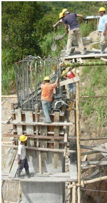
FOTO 12. Fundición columna lado derecho.
