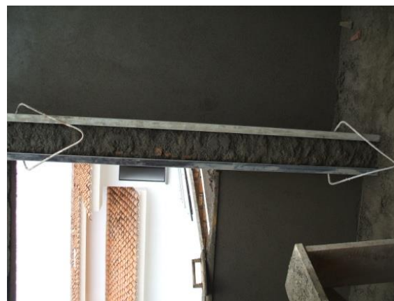
FOTO N°160: COLOCACION DE CODALES PARA CONSTRUCCION DE CARTERAS EN LOS MUROS
