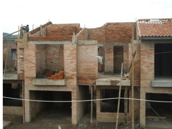
FOTO N°134: VISTA GENERAL DE LA PENDIENTE DE CUBIERTA
