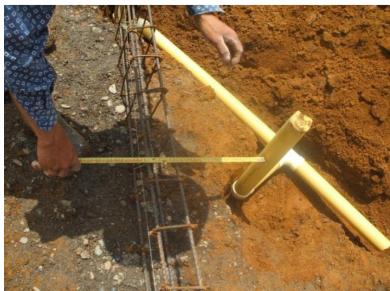
FOTO N°33: INSTALACION DE LAS DERIVACIONES SANITARIAS DEL PRIMER PISO
