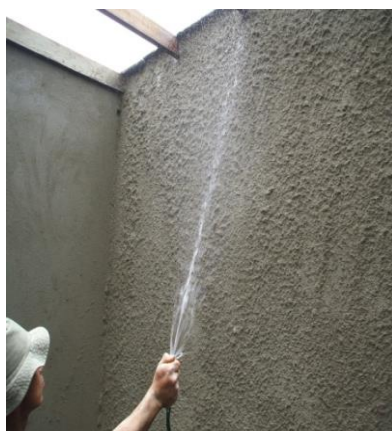
FOTO N°84: RIEGO DE AGUA PARA NIVELAR LA SEGUNDA CAPA DE REPELLO
