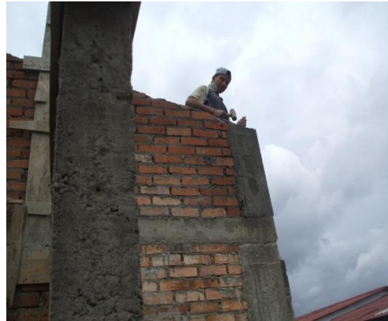
FOTO N°132: CONSTRUCCION DE LA PENDIENTE DE LA CUBIERTA
