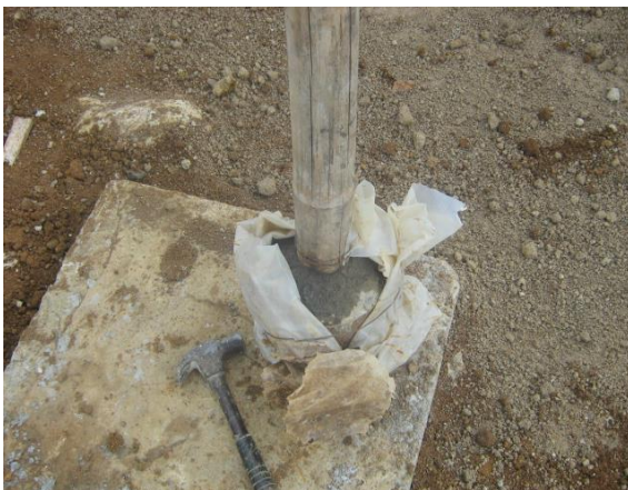
FOTO N°169: ELEMENTO UTILIZADO PARA COMPACTAR RELLENOS.
