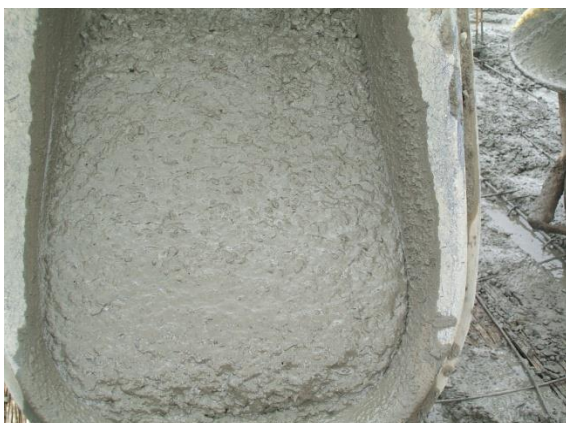
FOTO N°57: MEZCLA DE CONCRETO PARA FUNDIR LOS ELEMENTOS ESTRUCTURALES
