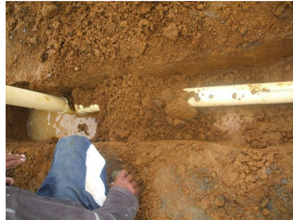
FOTO N°18: RELLENO DE ZANJAS DE LA RED SANITARIA PRICIPAL
