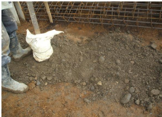
FOTO N°19: COMPACTACION DE ZANJAS DE LA RED SANITARIA PRINCIPAL
