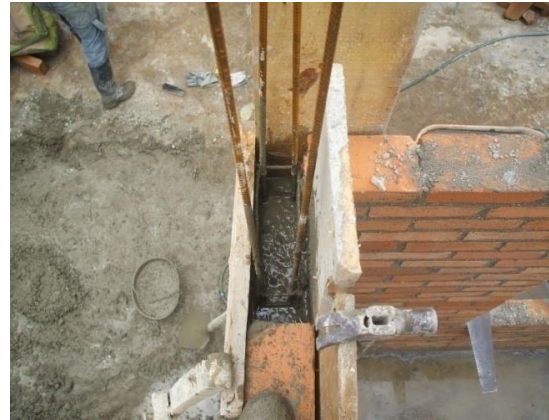
FOTO N°90: FUNDICION DE COLUMNAS
