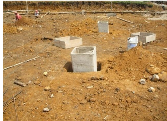
FOTO N°6: COLOCACION DE FORMALETAS PARA CAJAS DE INSPECCION
