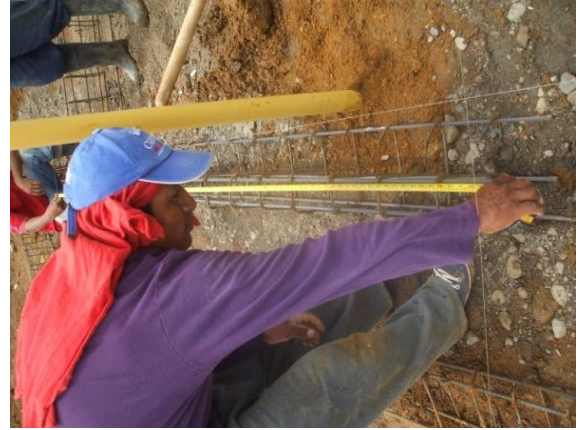
FOTO N°42: MEDICION DE LA LONGITUD DEL ACERO DE CIMENTACION
