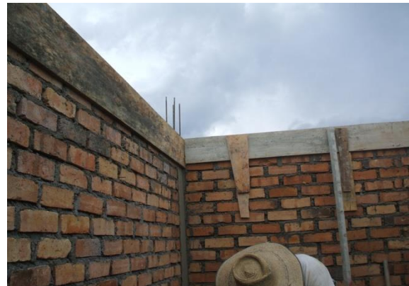
FOTO N°130: FORMALETA PARA VIGAS DE CUBIERTA
