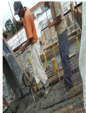
FOTO N°52: VARILLADO DE LOS NERVIOS DEL ENTREPISO
