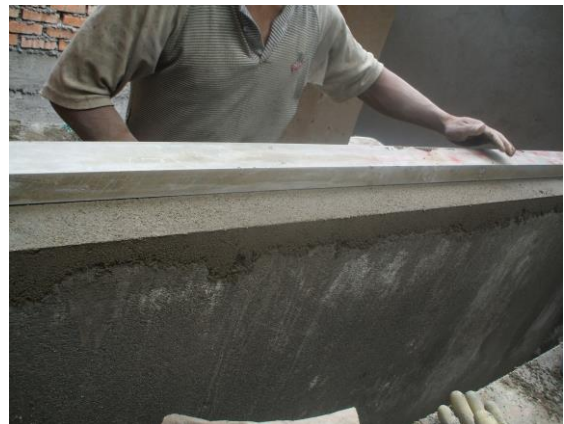
FOTO N°166: VERIFICACION DE LA HORIZONTALIDAD DE CARTERAS EN VENTANAS
