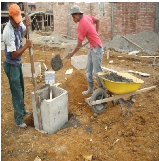
FOTO N°5: FUNDICION DE CAJAS DE INSPECCION
