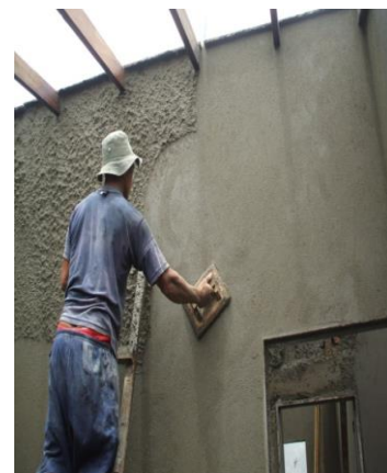
FOTO N°85: NIVELACION DE LA SEGUNDA CAPA DE REPELLO MEDIANTE LLANA DE MADERA
