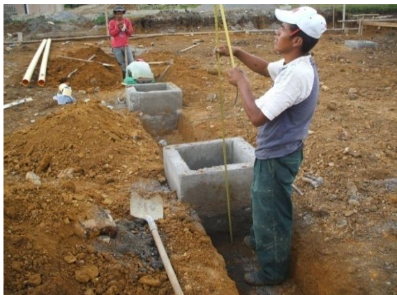
FOTO N°13: VERIFICACION DE LA PROFUNDIDAD Y PENDIENTE DE LAS ZANJAS DE LA RED SANITARIA PRINCIPAL
