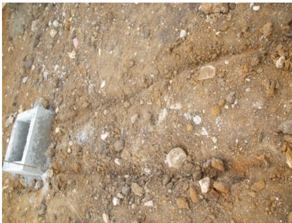
FOTO N°11: DELIMITACION DE ZANJAS PARA EXCAVAR LA RED SANITARIA PRINCIPAL
