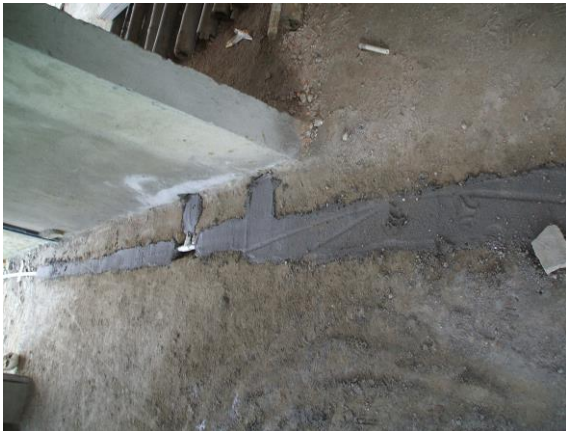
FOTO N°117: INSTALACION DE AGUA POTABLE
