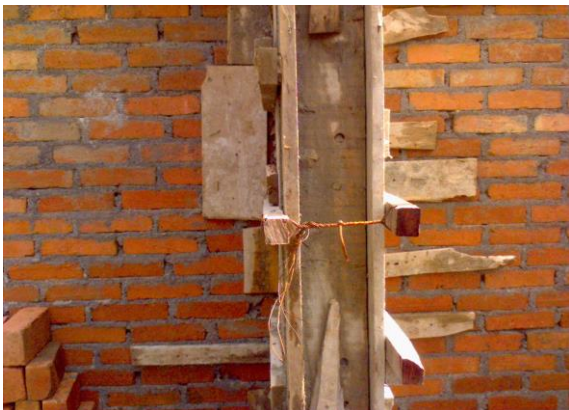
FOTO N°87: FORMALETA PARA COLUMNAS TIPO I (EN FACHADA Y ANTEJARDIN)
