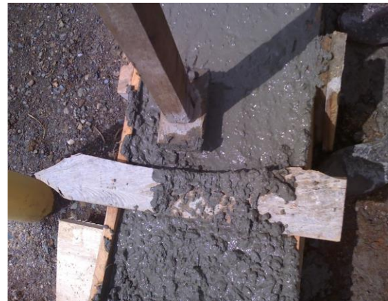
FOTO N°62: COMPACTACION Y TERMINADO DE VIGAS DE CIMENTACION
