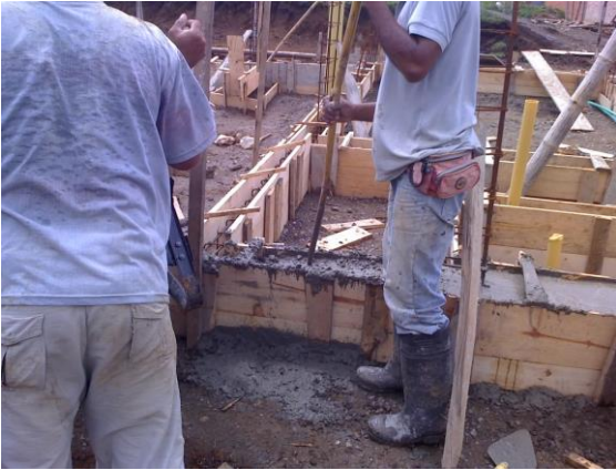
FOTO N°59: VARILLADO DE VIGAS DE CIMENTACION
