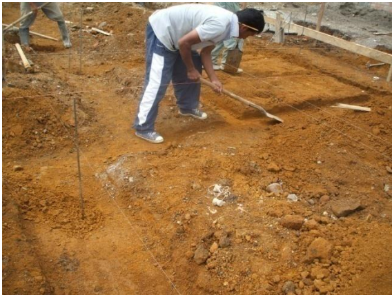
FOTO N°25: EXCAVACION DE ZANJAS DE CIMENTACION
