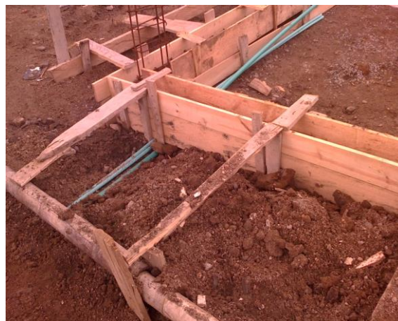
FOTO N°16: FORMALETA RECTANGULAR PARA LA CIMENTACION
