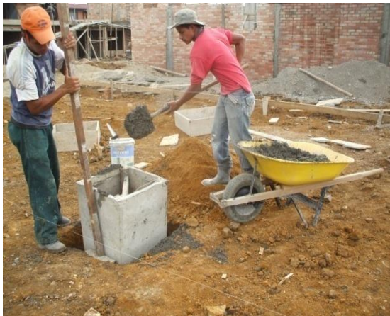
FOTO N°7: FUNDICION DE CAJAS DE INSPECCION
