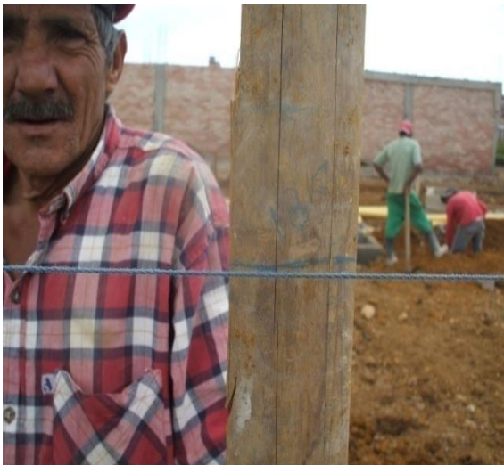
FOTO N°3: MEDICION DE LA PROFUNDIDAD DE LAS CAJAS DE INSPECCION
