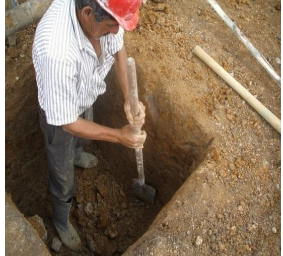
FOTO N°2: EXCAVACION DE LAS CAJAS DE INSPECCION
