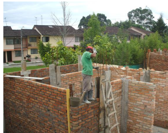
FOTO N°92: VARILLADO DE COLUMNAS
