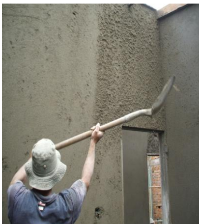
FOTO N°83: COLOCACION DE MORTERO PARA LA SEGUNDA CAPA DE REPELLO
