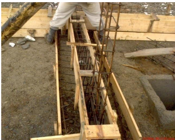
FOTO N°15: FORMALETA TIPO T INVERTIDA PARA LA CIMENTACION
