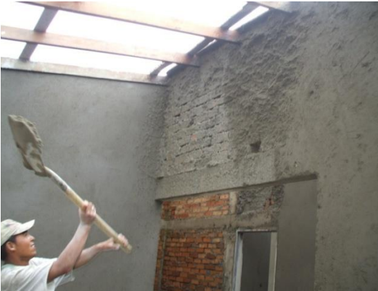
FOTO N°155: COLOCACION DE LA PRIMERA CAPA DE MORTERO PARA RREPELLO
