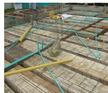
FOTO N°49: INSTALACION DE REDES ELECTRICAS PARA EL SEGUNDO PISO
