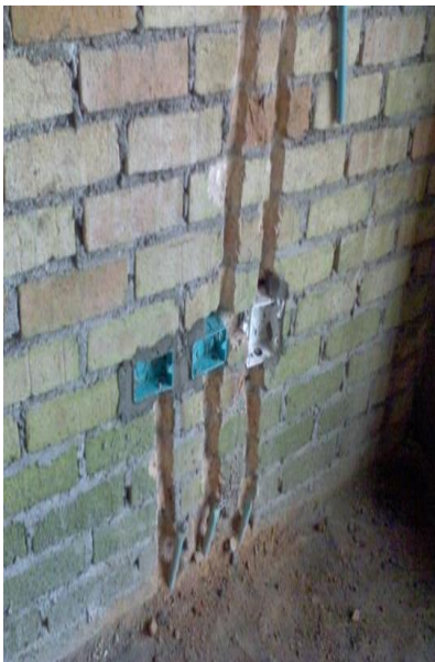
FOTO N°77: CONTINUACION DE LAS INSTALACIONES ELECTRICAS (PUNTOS ELECTRICOS)
