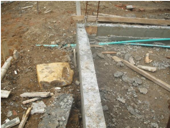
FOTO N°67: VIGA DE CIMENTACION RECTANGULAR
