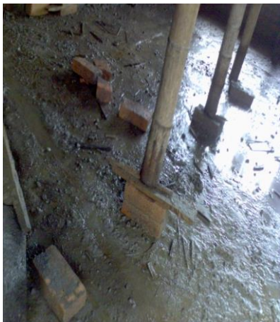
FOTO N°38: ARMADO DE LA FORMALETA PARA EL ENTREPISO (TACOS DE GUADUA)
