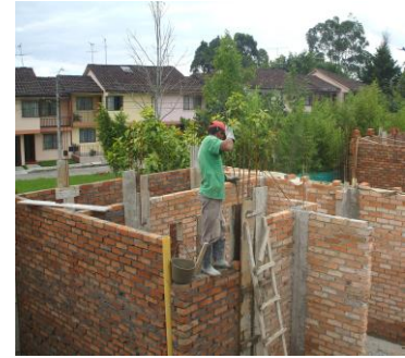
FOTO N°37: VARILLADO DE COLUMNAS
