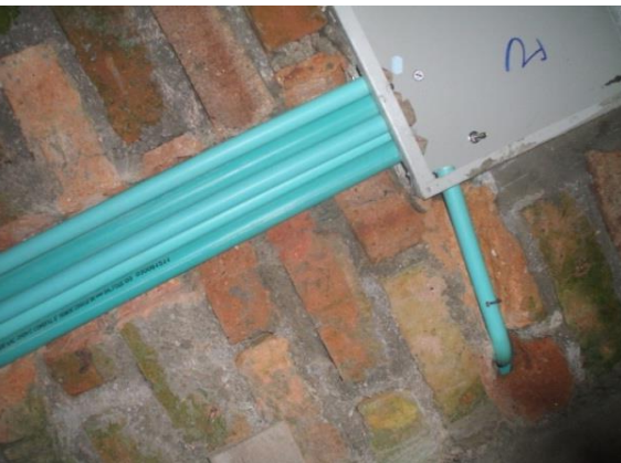
FOTO N°123: CONTINUACION DE LAS INSTALACIONES ELECTRICAS (CAJA ELECTRICA GENERAL)
