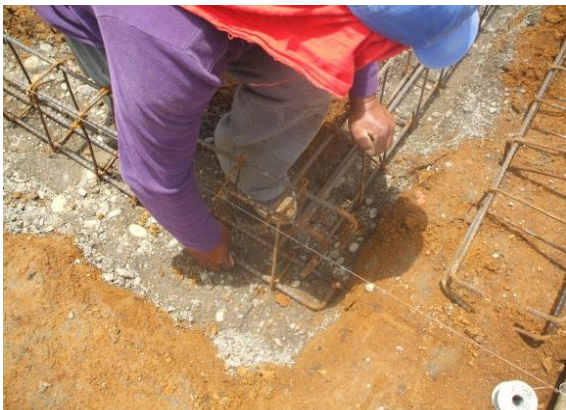
FOTO N°39: ENGANCHE DEL ACERO DE CIMENTACION EN LAS INTERSECCIONES
