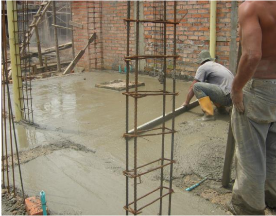
FOTO N°77: FUNDICION DEL PRIMER PISO
