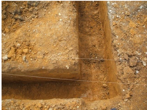
FOTO N°26: ZANJAS DE CIMENTACION
