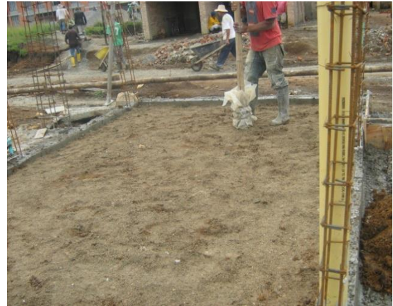
FOTO N°72: RELLENO Y COMPACTACION DEL PISO
