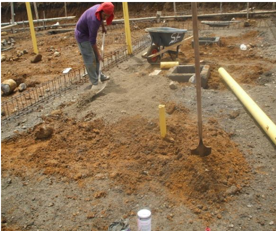
FOTO N°73: EXTENSION DE CAPA DE ARENA SOBRE EL PISO
