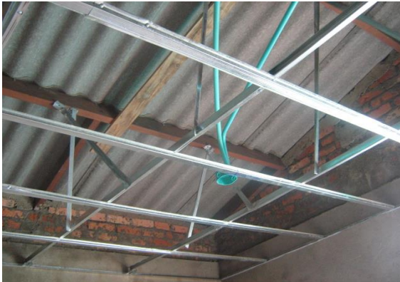
FOTO N°121: CONTINUACION DE LAS INSTALACIONES ELECTRICAS
