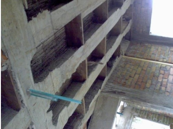
FOTO N°115: DEENCOFRADO DE LA LOSA ALIGERADA
