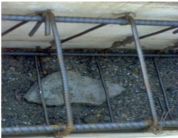
FOTO N°45: RECUBRIMIENTO DEL ACERO DE CIMENTACION
