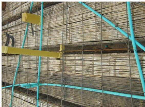
FOTO N°105: ACERO DE RETRACCON Y TEMPERATURA PARA LA LOSA ALIGERADA
