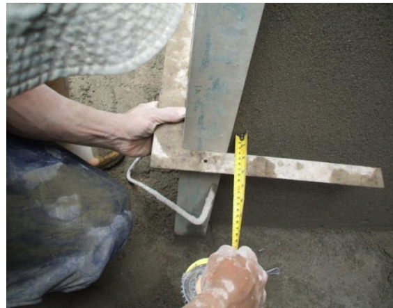
FOTO N°164: VERIFICACION DE LA ANGULARIDAD DE CARTERAS
