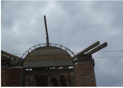
FOTO N°66: FORMALETA PARA EL ARCO UBICADO EN LA FACHADA PRINCIPAL DE LA VIVIENDA
