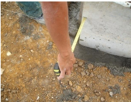
FOTO N°9: VERIFICACION DE LA CONCENTRICIDAD DE LAS CAJAS DE INSPECCION
