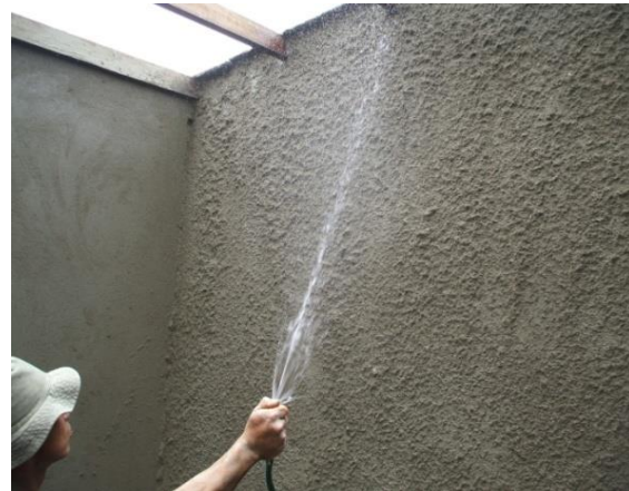
FOTO N°158: RIEGO DE AGUA PARA NIVELAR LA SEGUNDA CAPA DE REPELLO
