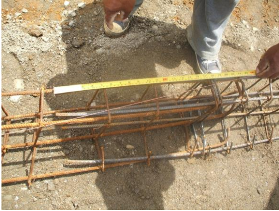
FOTO N°41: VERIFICACION DE TRASLAPOS EN EL ACERO DE CIMENTACION
