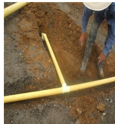
FOTO N°19: INSTALACION DE LAS DERIVACIONES SANITARIAS DEL PRIMER PISO
