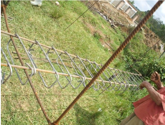
FOTO N°35: ARMADO DEL ACERO PARA LOS ELEMENTOS ESTRUCTURALES
