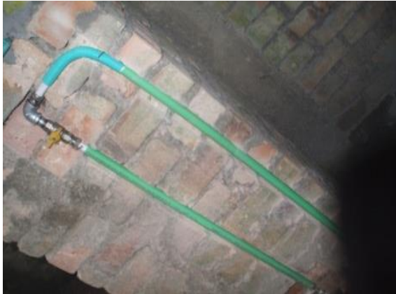
FOTO N°125: INSTALACIONES DE GAS PARA EL PRIMER PISO
