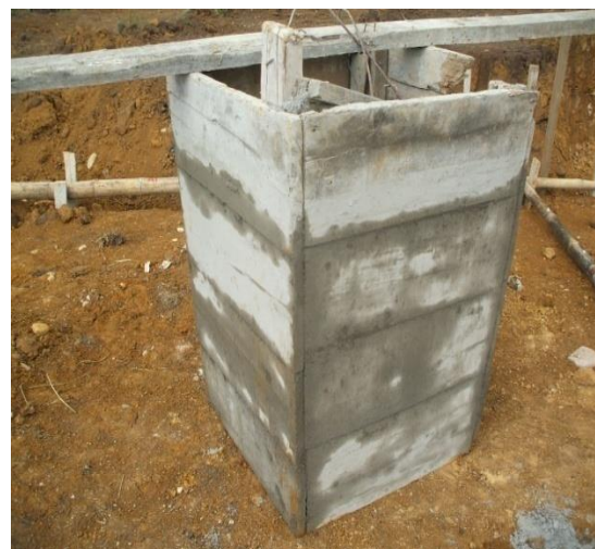
FOTO N°4: FORMALETA PARA LAS CAJAS DE INSPECCION GRANDES.
