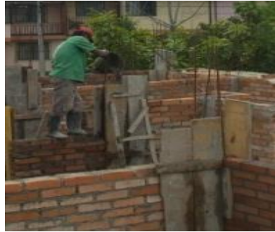
FOTO N°36: FUNDICION DE COLUMNAS
