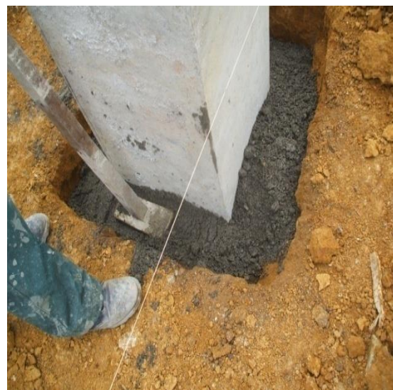
FOTO N°6: COMPACTACION DE CAJAS DE INSPECCION
