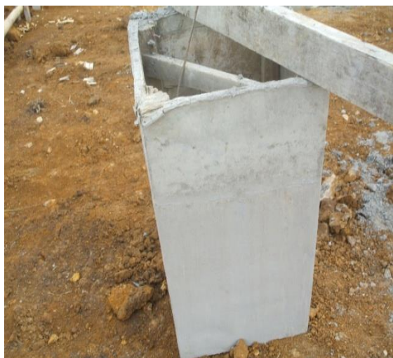
FOTO N°3: FORMALETA PARA LAS CAJAS DE INSPECCION PEQUEÑAS
