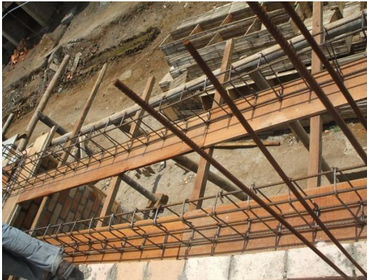
FOTO N°97: ACERO DE VIGAS PRINCIPALES DEL ENTREPISO
