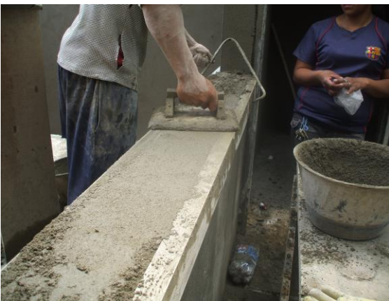
FOTO N°165: CONSTRUCCION DE CARTERAS SOBRE VENTANAS
