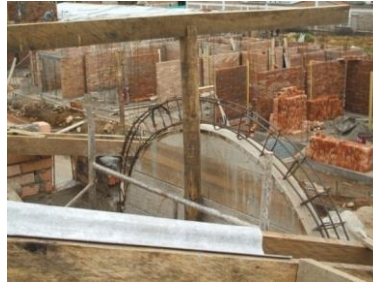
FOTO N°67: ARCO DE ACERO PARA EL DISEÑO DE LA FACHADA PRINCIPAL DE LA VIVIENDA
