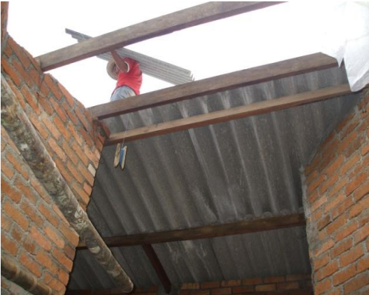
FOTO N°145: COLOCACION DE LAS HOJAS DE ETERNIT EN LA CUBIERTA
