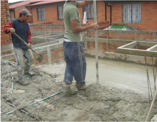
FOTO N°113: CHEQUEO DEL ESPESOR DE LA PLACA DE LA LOSA ALIGERADA
