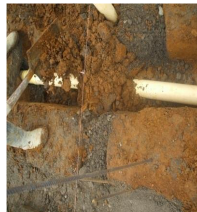
FOTO N°22: RELLENO DE LAS DERIVACIONES SANITARIAS DEL PRIMER PISO
