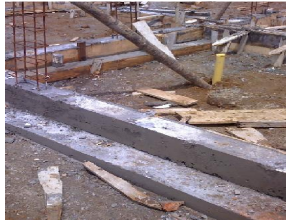
FOTO N°68: VIGA DE CIMENTACION TIPO L
