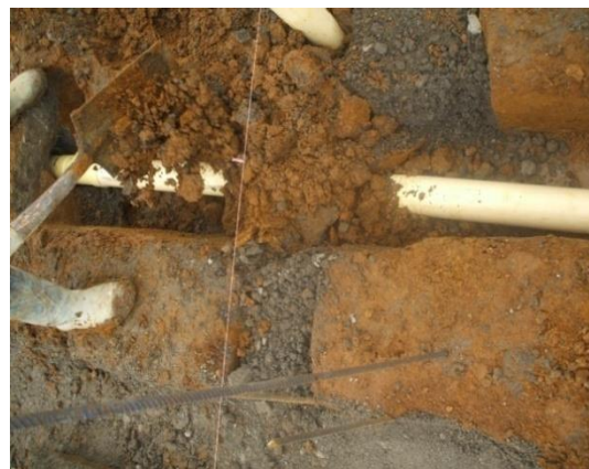
FOTO N°34: RELLENO DE LAS DERIVACIONES SANITARIAS DEL PRIMER PISO
