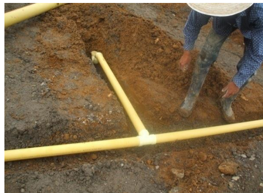
FOTO N°32: INSTALACION DE LAS DERIVACIONES SANITARIAS DEL PRIMER PISO
