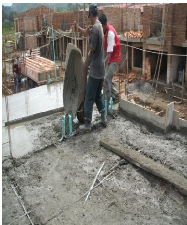
FOTO N°53: FUNDICION DE LA PLACA DE LA LOSA ALIGERADA
