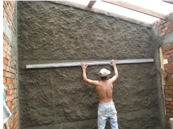
FOTO N°156: NIVELACION DE LA PRIMERA CAPA DE REPELLO MEDIANTE CODAL
