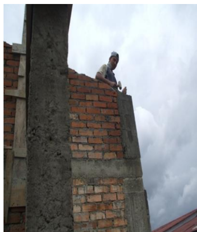
FOTO N°62: CONSTRUCCION DE LA PENDIENTE DE LA CUBIERTA
