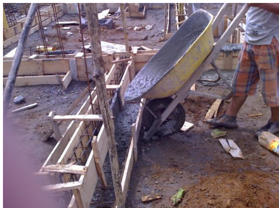
FOTO N°58: FUNDICION DE LAS VIGAS DE CIMENTACION
