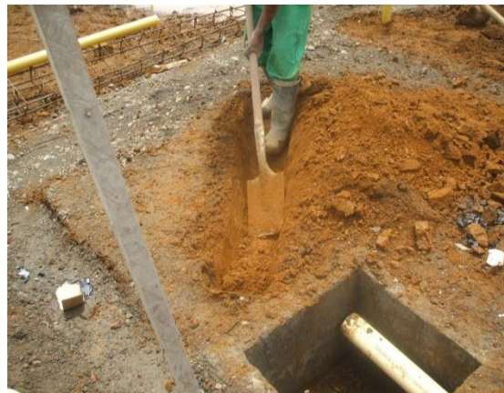
FOTO N°30: EXCAVACION DE LAS DERIVACIONES SANITARIAS DEL PRIMER PISO
