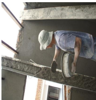
FOTO N°87: COLOCACION DEL MORTERO PARA CONTRUCCION DE CARTERAS
