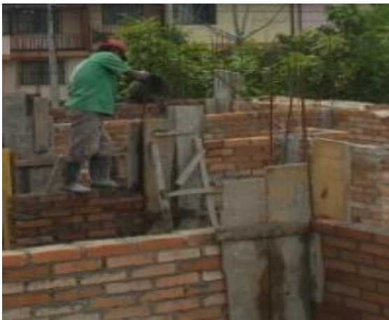
FOTO N°91: FUNDICION DE COLUMNAS
