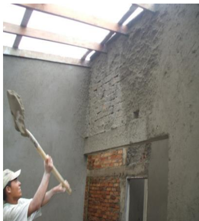
FOTO N°81: COLOCACION DE LA PRIMERA CAPA DE MORTERO PARA RREPELLO
