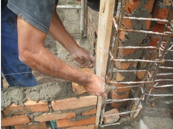
FOTO N°83: COLOCACION DE HILADAS PARA EL LEVANTAMIENTO DE MUROS DEL PRIMER PISO
