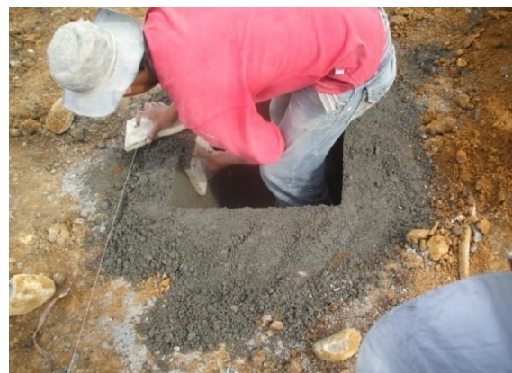
FOTO N°10: TERMINACION DE LAS CAJAS DE INSPECCION
