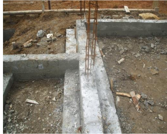
FOTO N°66: VIGA DE CIMENTACION TIPO T INVERTIDA
