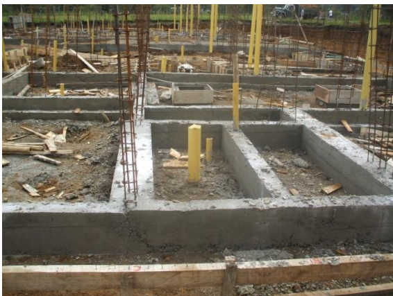
FOTO N°69: VISTA GENETAL DE LAS VIGAS DE CIMENTACION
