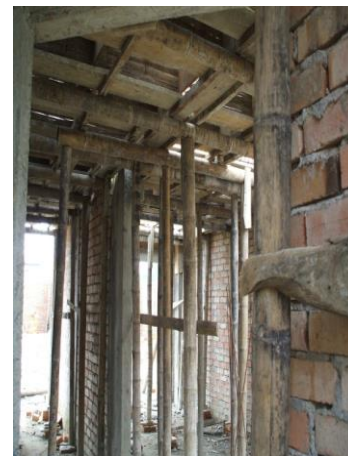
FOTO N°40: ARMADO DE LA FORMALETA PARA EL ENTREPISO (VISTA GENERAL DE LA FORMALETA)
