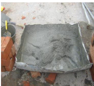
FOTO N°29: MORTERO PARA PEGA DE LADRILLO
