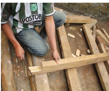
FOTO N°69: MADERA PARA LA ESTRUCTURA DE LA CUBIERTA
