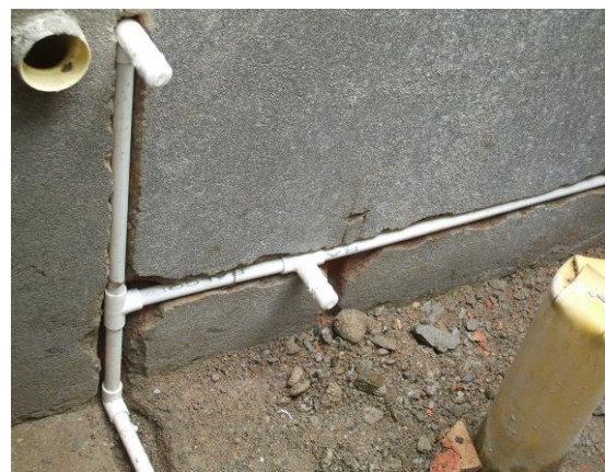
FOTO N°118: INSTALACION DE AGUA POTABLE (PARA EL INODORO Y LA DUCHA)
