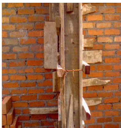
FOTO N°32: FORMALETA PARA COLUMNAS TIPO I (EN FACHADA Y ANTEJARDIN)
