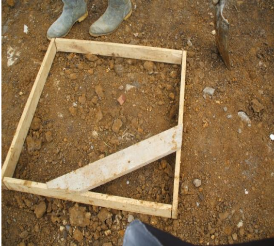
FOTO N°1: MARCO PARA DELIMITAR LAS CAJAS DE INSPECCION
