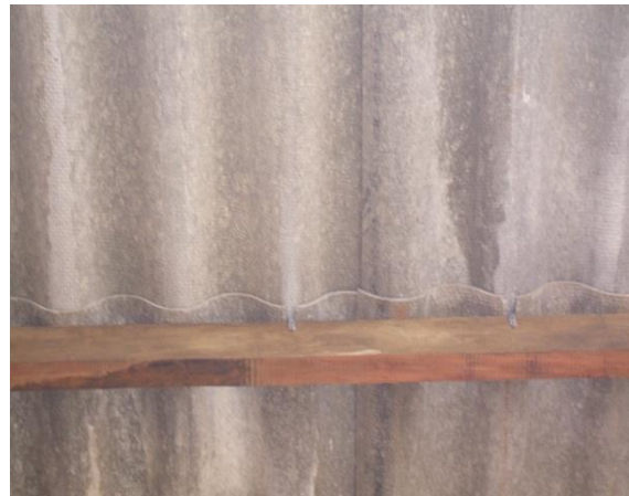
FOTO N°148: ASEGURAMIENTO DE LAS HOJAS DE ETERNIT A LA ESTRUCTURA DE LA CUBIERTA CON GANCHOS
