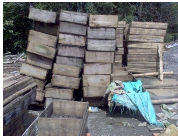
FOTO N°170: CASETONES UTILIZADOS PARA OBTENER LOS NERVIOS DEL ENTREPISO
