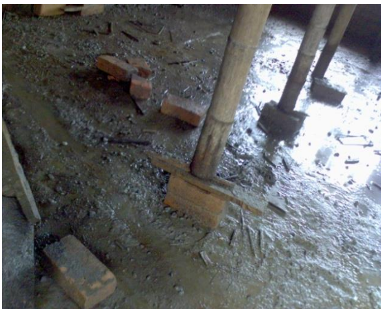
FOTO N°93: ARMADO DE LA FORMALETA PARA EL ENTREPISO (TACOS DE GUADUA)
