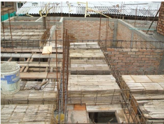
FOTO N°99: COLOCACION DE CASETONES DEL ENTREPISO
