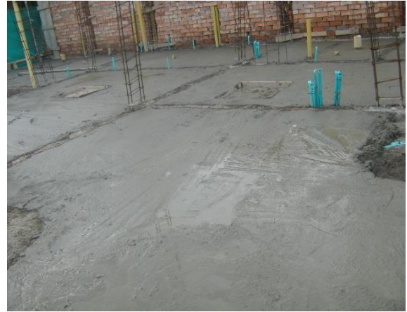
FOTO N°78: FUNDICION DEL PRIMER PISO
