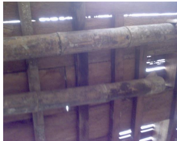
FOTO N°94: ARMADO DE LA FORMALETA PARA EL ENTREPISO (RIELES EN GUADUA Y TELERAS EN MADERA)
