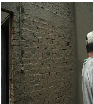
FOTO N°80: CHAMPIADO DE MUROS PARA REPELLO CON PASTA DE CEMENTO MUY FLUIDA
