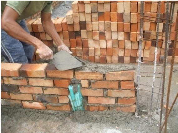
FOTO N°85: LEVANTAMIENTO DE MUROS DEL PRIMER PISO
