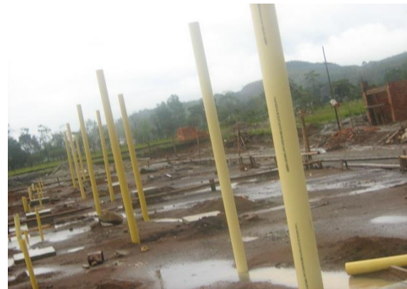
FOTO N°20: TUBERIA PARA LA DEL SANITARIA PRINCIPAL DEL SEGUNDO PISO
