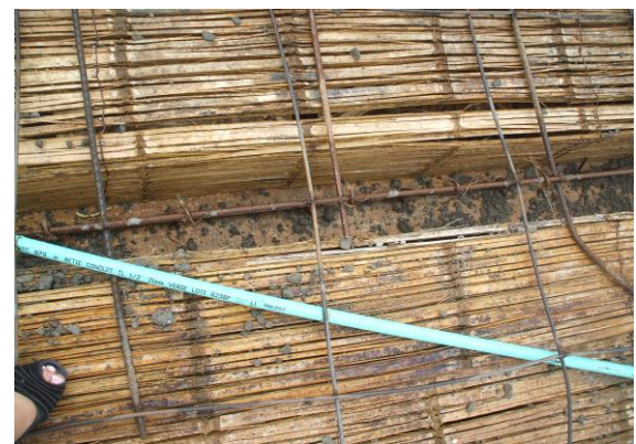
FOTO N°104: ACERO DE RETRACCON Y TEMPERATURA PARA LA LOSA ALIGERADA
