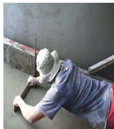
FOTO N°88: VERIFICACION DE LA ANGULARIDAD DE CARTERAS SOBRE LOS MUROS
