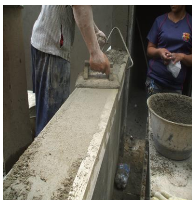
FOTO N°90: CONSTRUCCION DE CARTERAS SOBRE VENTANAS
