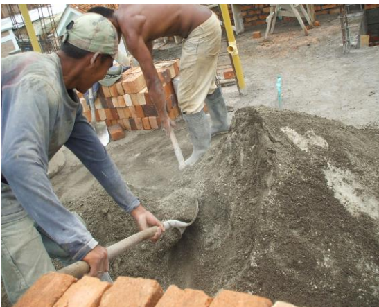
FOTO N°151: MEZCLA DE MORTERO PARA REPELLO
