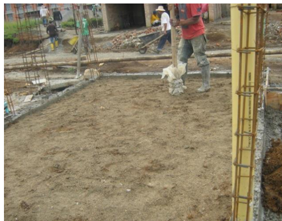
FOTO N°27: RELLENO Y COMPACTACION DEL PISO
