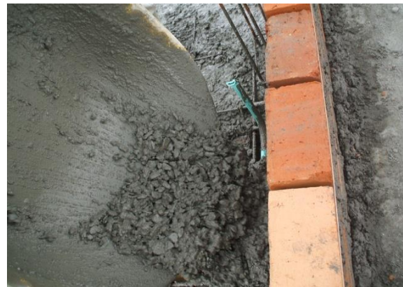
FOTO N°106: CONCRETO PARA FUNDICION DE VIGAS PRINCIPALES Y NERVIOS DEL ENTREPISO
