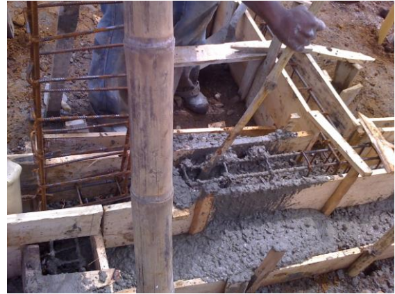
FOTO N°60: VARILLADO DE VIGAS DE CIMENTACION
