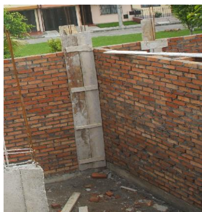
FOTO N°33: FORMALETA PARA COLUMNAS TIPO I (GENERAL)
