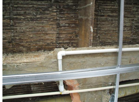
FOTO N°120: INSTALACION DE AGUA POTABLE PARA EL SEGUNDO PISO
