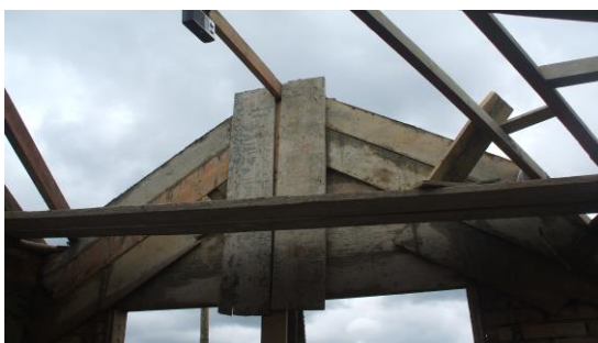
FOTO N°64: ESTRUCTURA DE MADERA SOBRE EL ARCO
