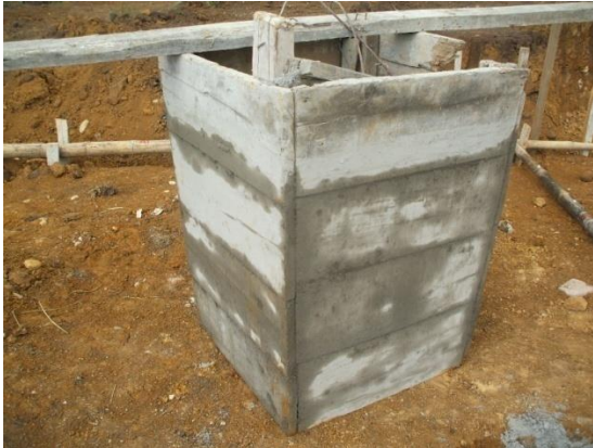
FOTO N°5: FORMALETA PARA LAS CAJAS DE INSPECCION GRANDES.
