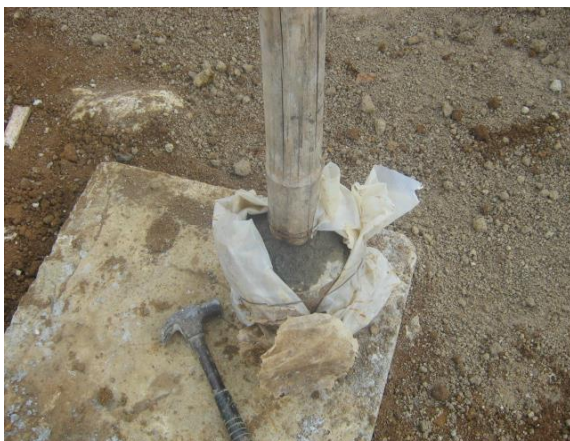
FOTO N°26: ELEMENTO UTILIZADO PARA COMPACTAR RELLENOS
