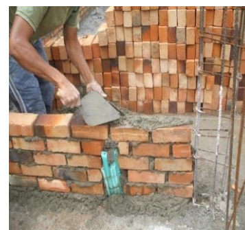
FOTO N°31: LEVANTAMIENTO DE MUROS DEL PRIMER PISO
