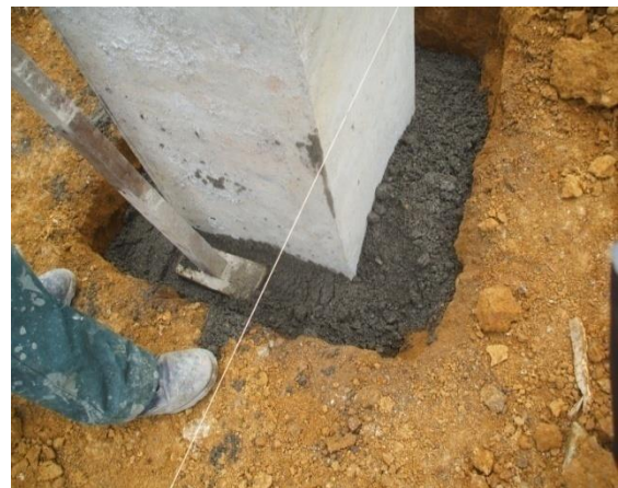
FOTO N°8: COMPACTACION DE CAJAS DE INSPECCION
