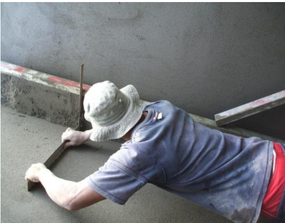
FOTO N°163: VERIFICACION DE LA ANGULARIDAD DE CARTERAS SOBRE LOS MUROS
