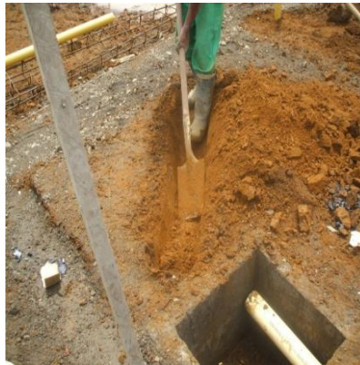
FOTO N°21: EXCAVACION DE LAS DERIVACIONES SANITARIAS DEL PRIMER PISO
