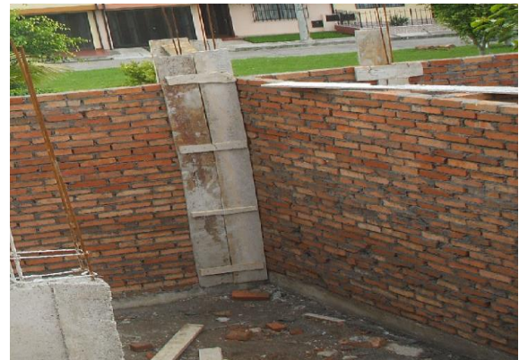
FOTO N°88: FORMALETA PARA COLUMNAS TIPO I (GENERAL)
