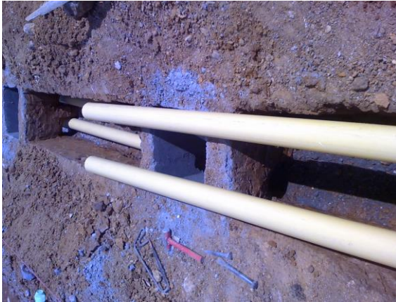
FOTO N°17: INSTALACION DE LA RED SANITARIA PRINCIPAL
