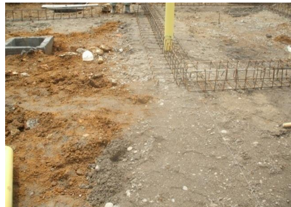
FOTO N°40: ACERO PARA LAS VIGAS DE CIMENTACION
