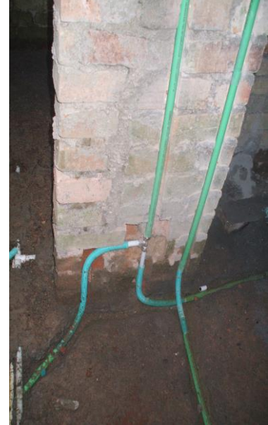
FOTO N°79: INSTALACIONES DE GAS PARA EL PRIMER PISO
