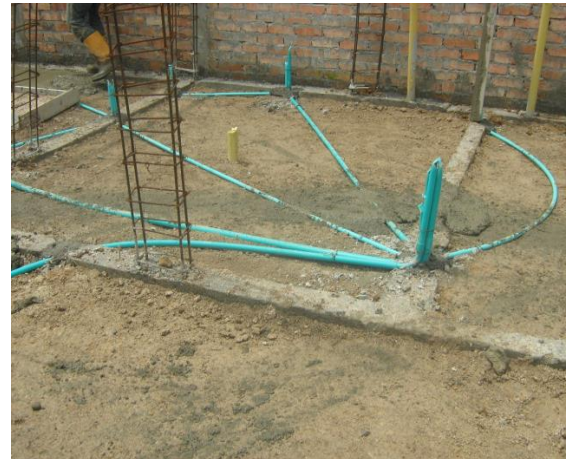
FOTO N°74: INSTALACIONES ELECTRICAS DEL PRIMER PISO
