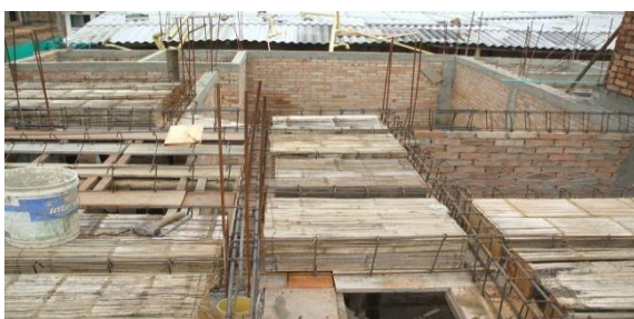
FOTO N°45: COLOCACION DE CASETONES DEL ENTREPISO
