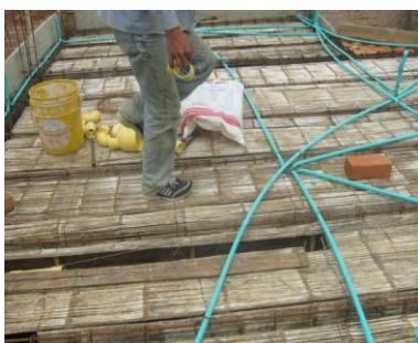
FOTO N°47: INSTALACION DE LAS DERIVACIONES SANITARIAS PARA EL SEGUNDO PISO
