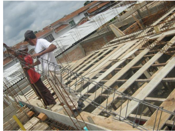
FOTO N°96: COLOCACION DEL ACERO PARA LAS VIGAS PRINCIPALES DEL ENTREPISO
