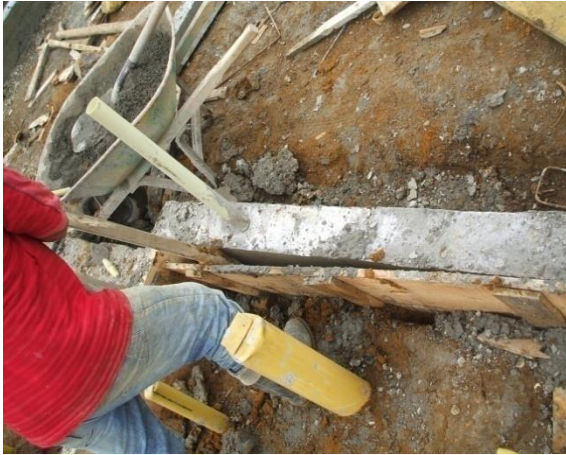
FOTO N°65: DESENOFRADO DE VIGAS DE CIMENTACION
