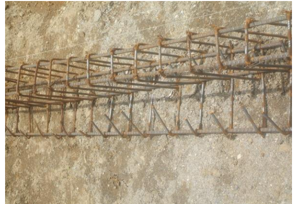
FOTO N°44: ARMADO DEL ACERO TIPO L DE CIMENTACION
