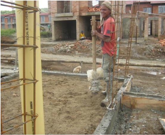
FOTO N°71: RELLENO Y COMPACTACION DEL PISO
