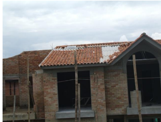
FOTO N°150: COLOCACION DE LAS TEJAS DE ARCILLA ENCIMA DE LAS HOJAS DE ETERNIT
