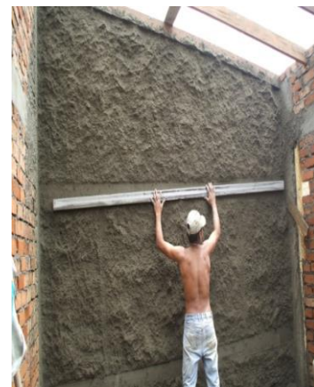
FOTO N°82: NIVELACION DE LA PRIMERA CAPA DE REPELLO MEDIANTE CODAL
