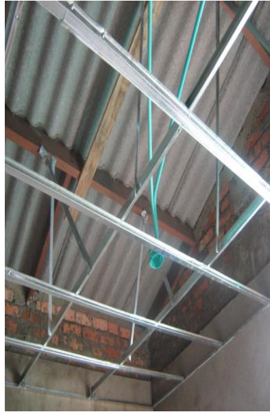
FOTO N°78: CONTINUACION DE LAS INSTALACIONES ELECTRICAS
