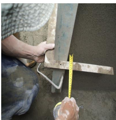
FOTO N°89: VERIFICACION DE LA ANGULARIDAD DE CARTERAS
