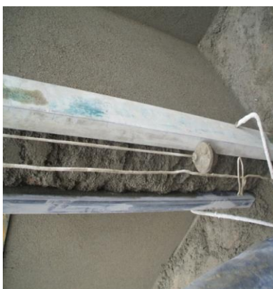
FOTO N°86: VERIFICACION DE LA VERTICALIDAD DE LOS CODALES PARA CONSTRUCCION DE CARTERAS
