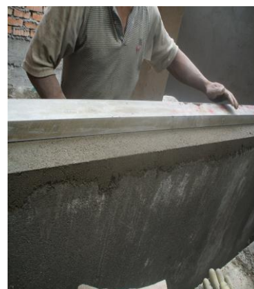
FOTO N°91: VERIFICACION DE LA HORIZONTALIDAD DE CARTERAS EN VENTANAS
