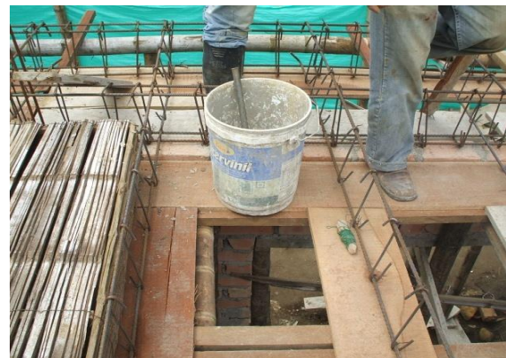
FOTO N°100: COLOCACION DEL ACERO PARA LOS NERVIOS DEL ENTREPISO
