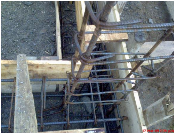
FOTO N°49: ARMADO Y COLOCACION DEL ACERO DE LAS COLUMNAS PARA EL PRIMER PISO
