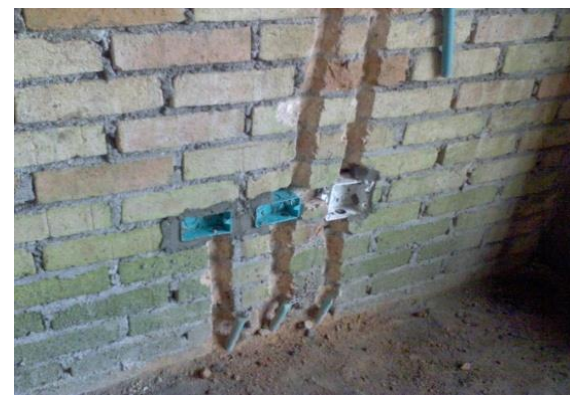
FOTO N°122: CONTINUACION DE LAS INSTALACIONES ELECTRICAS (PUNTOS ELECTRICOS)
