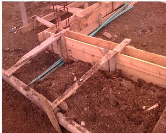
FOTO N°28: FORMALETA RECTANGULAR PARA LA CIMENTACION
