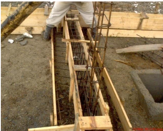
FOTO N°27: FORMALETA TIPO T INVERTIDA PARA LA CIMENTACION
