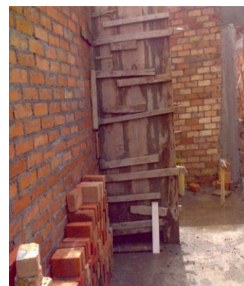
FOTO N°34: FORMALETA PARA COLUMNAS TIPO II
