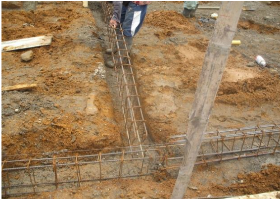
FOTO N°37: COLOCACION DEL ACERO PARA LA CIMENTACION
