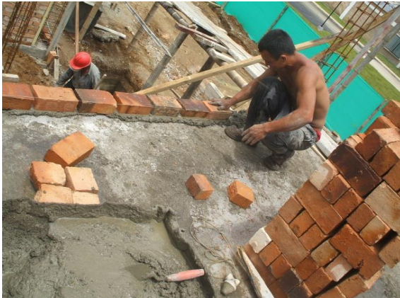
FOTO N°127: HILADAS PARA EL LEVANTAMIENTO DE MUROS DEL SEGUNDO PISO
