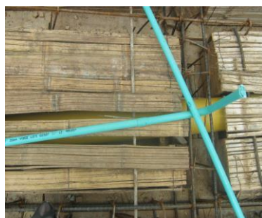
FOTO N°48: DERIVACIONES SANITARIAS DEL SEGUNDO PISO
