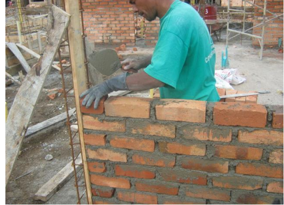
FOTO N°84: LEVANTAMIENTO DE MUROS PARA DEL PRIMER PISO
