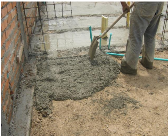
FOTO N°75: FUNDICION DEL PRIMER PISO
