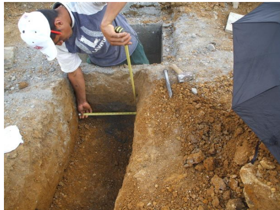
FOTO N°14: VERIFICACION DEL ANCHO DE LA ZANJA PARA LA RED SANITARIA PRINCIPAL
