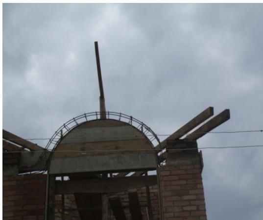
FOTO N°135: FORMALETA PARA EL ARCO UBICADO EN LA FACHADA PRINCIPAL DE LA VIVIENDA
