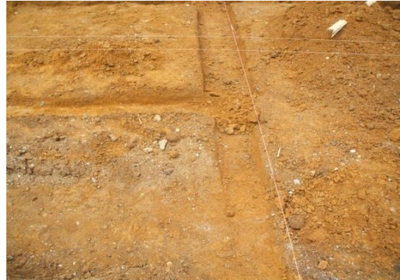
FOTO N°24: DELIMITACION DE ZANJAS DE CIMENTACION
