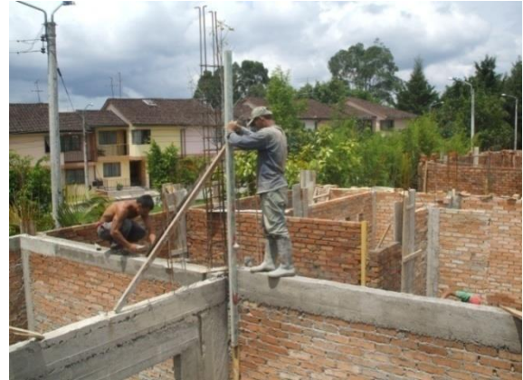
FOTO N°126: INSTALACION DE MIRAS PARA EL LEVANTAMIENTO DE MUROS DEL SEGUNDO PISO
