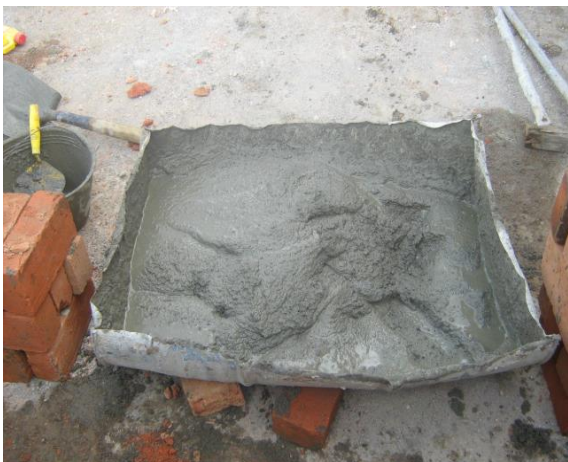
FOTO N°81: MORTERO PARA PEGA DE LADRILLO
