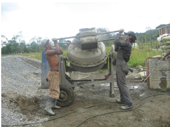
FOTO N°55: MEZCLA PARA LA FUNDICION DE LOS ELEMENTOS ESTRUCTURALES
