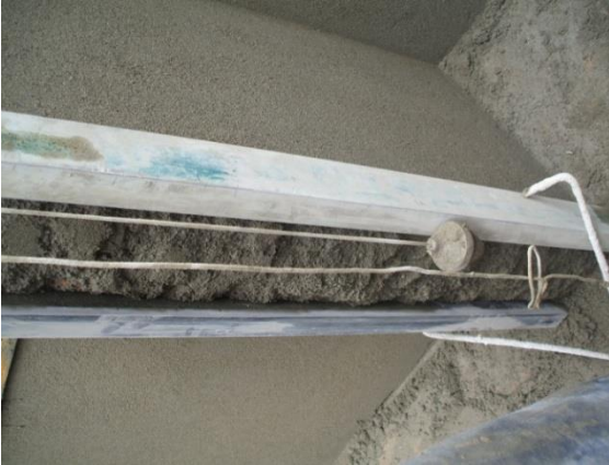
FOTO N°161: VERIFICACION DE LA VERTICALIDAD DE LOS CODALES PARA CONSTRUCCION DE CARTERAS
