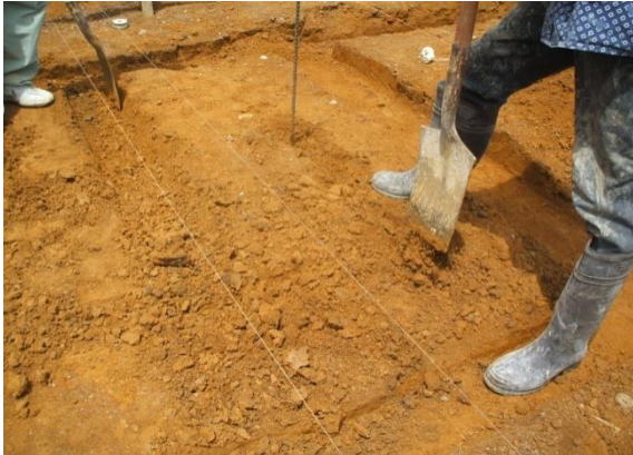
FOTO N°23: HILOS GUIA PARA ZANJAS DE CIMENTACION
