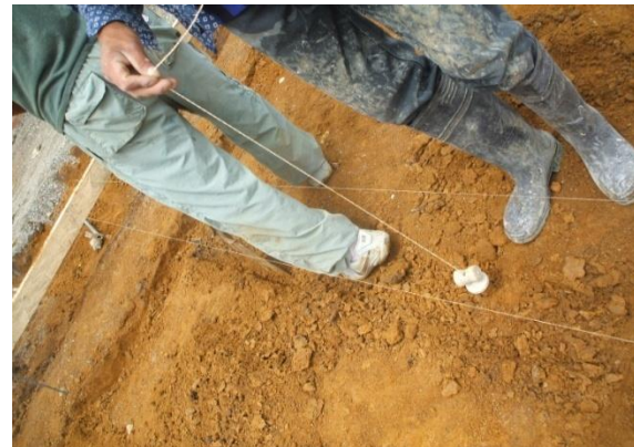
FOTO N°22: COLOCACION DE LOS HILOS GUIA PARA ZANJAS DE CIMENTACION
