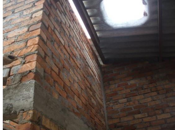
FOTO N°146: LUCETA DE ILUMINACION Y VENTILACION EN LA CUBIERTA
