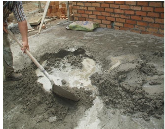
FOTO N°80: MEZCLA PARA PEGA DE LADRILLO
