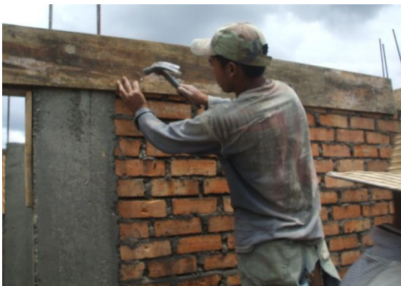
FOTO N°129: ARMADO DE LA FORMALETA PARA VIGAS DE CUBIERTA
