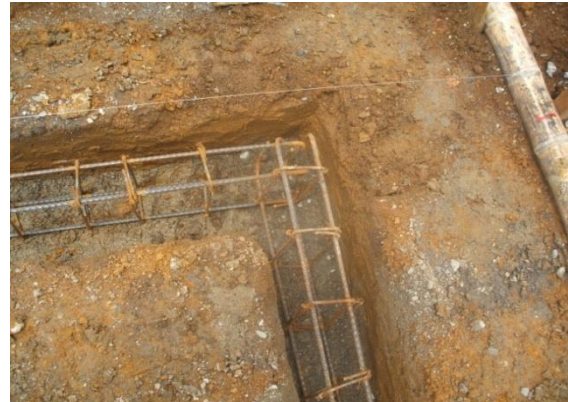
FOTO N°38: ENGANCHE DEL ACERO DE CIMENTACION EN LAS INTERSECCIONES
