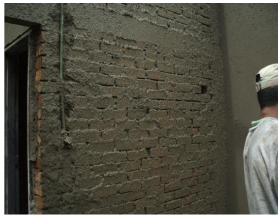
FOTO N°154: CHAMPIADO DE MUROS PARA REPELLO CON PASTA DE CEMENTO MUY FLUIDA
