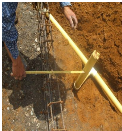
FOTO N°18: INSTALACION DE LAS DERIVACIONES SANITARIAS DEL PRIMER PISO
