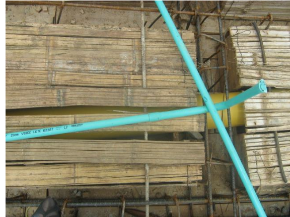
FOTO N°102: DERIVACIONES SANITARIAS DEL SEGUNDO PISO
