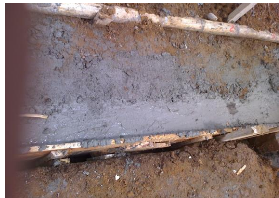
FOTO N°64: TERMINADO DE VIGAS DE CIMENTACION SOBRE LAS ZANJAS DE CIMENTACION
