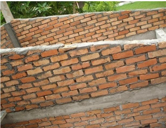
FOTO N°133: PENDIENTE DE LA CUBIERTA
