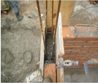
FOTO N°35: FUNDICION DE COLUMNAS
