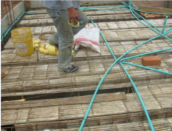
FOTO N°101: INSTALACION DE LAS DERIVACIONES SANITARIAS PARA EL SEGUNDO PISO
