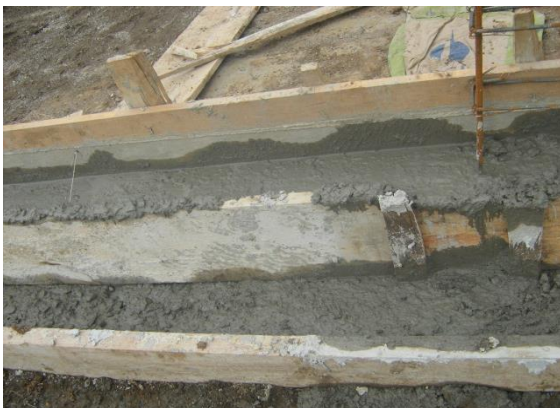
FOTO N°63: TERMINADO DE VIGAS DE CIMENTACION SOBRE LAS FORMALETAS
