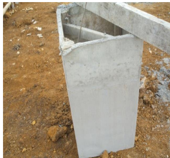
FOTO N°4: FORMALETA PARA LAS CAJAS DE INSPECCION PEQUEÑAS
