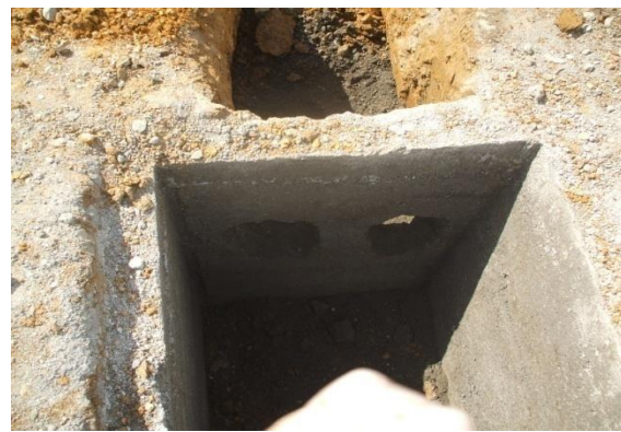
FOTON°16 ORIFICIOS PARA INSTALAR LA RED SANITARIA PRINCIPAL
