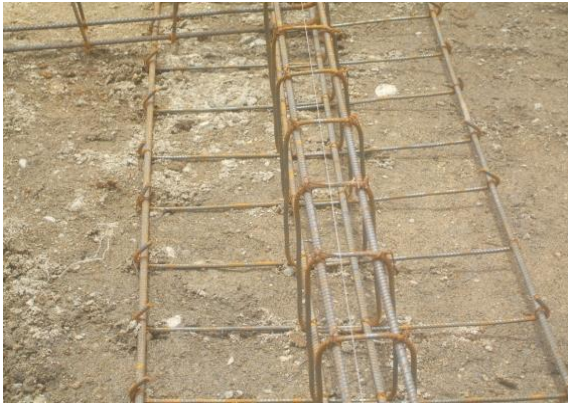
FOTO N°43: ARMADO DEL ACERO TIPO T INVERTIDA DE CIMENTACION
