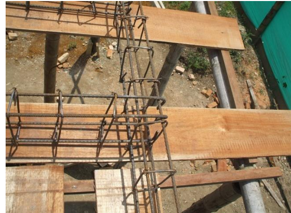
FOTO N°98: ENGANCHE DEL ACERO PARA LAS VIGAS PRINCIPALES DEL ENTREPISO
