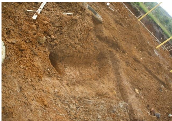
FOTO N°31: DERIVACIONES SANITARIAS DEL PRIMER PISO
