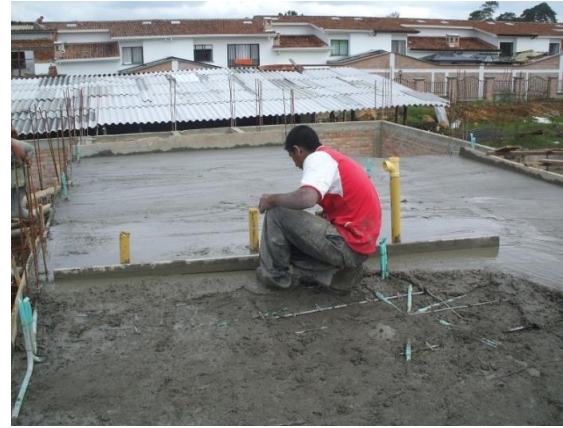
FOTO N°114: NIVELACION DE LA PLACA DE LA LOSA ALIGERADA
