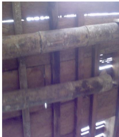
FOTO N°39: ARMADO DE LA FORMALETA PARA EL ENTREPISO (RIELES EN GUADUA Y TELERAS EN MADERA)
