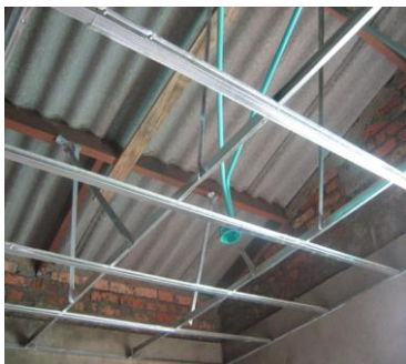
FOTO N°56: CONTINUACION DE LAS INSTALACIONES ELECTRICAS
