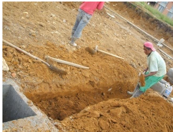
FOTO N°12: EXCAVACION DE LAS ZANJAS PARA LA RED SANITARIA PRINCIPAL
