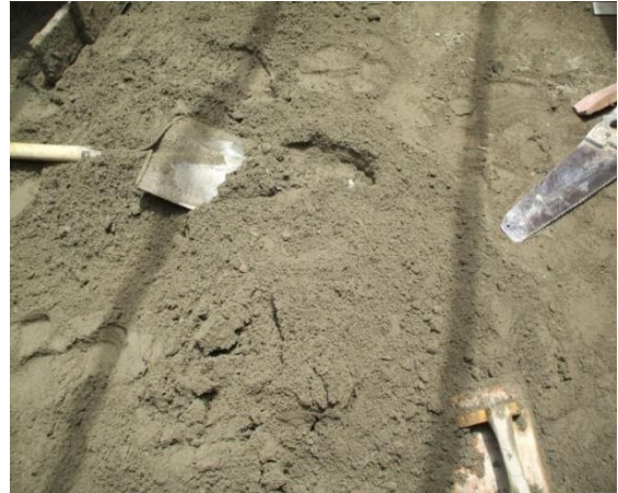
FOTO N°152: MORTERO PARA REPELLO
