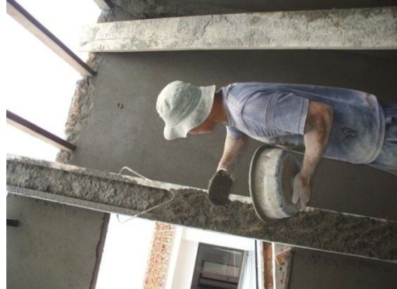
FOTO N°162: COLOCACION DEL MORTERO PARA LA TERMINACION CONTRUCCION DE CARTERAS
