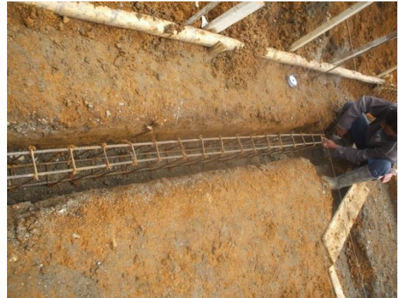
FOTO N°36: COLOCACION DEL ACERO PARA LA CIMENTACION
