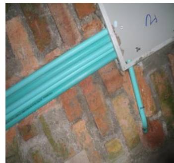
FOTO N°58: CONTINUACION DE LAS INSTALACIONES ELECTRICAS (CAJA ELECTRICA GENERAL)
