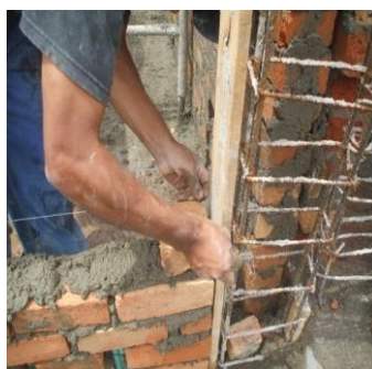
FOTO N°30: COLOCACION DE HILADAS PARA EL LEVANTAMIENTO DE MUROS DEL PRIMER PISO
