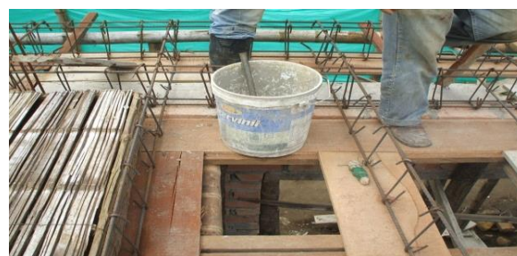
FOTO N°46: COLOCACION DEL ACERO PARA LOS NERVIOS DEL ENTREPISO
