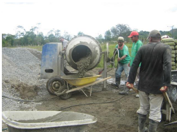
FOTO N°56: MEZCLA PARA LA FUNDICION DE LOS ELEMENTOS ESTRUCTURALES
