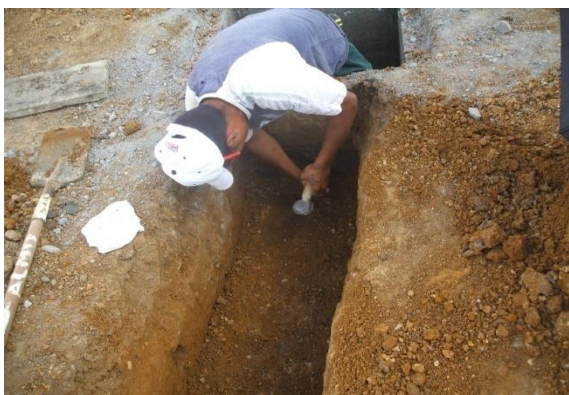
FOTO N°15: PERFORACION DE ORIFICIOS PARA INSTALAR LA RED SANITARIA PRINCIPAL
