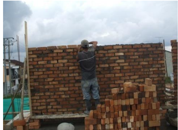
FOTO N°128: LEVANTAMIENTO DE MUROS DEL SEGUNDO PISO
