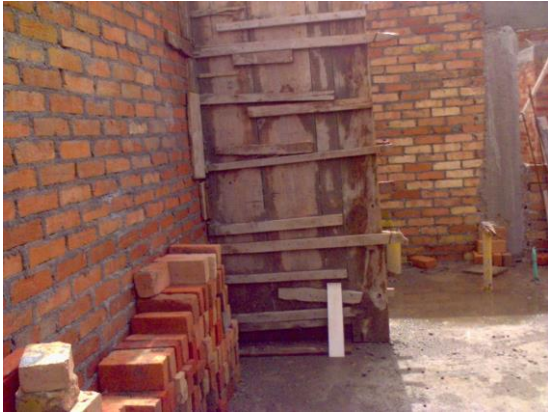
FOTO N°89: FORMALETA PARA COLUMNAS TIPO II
