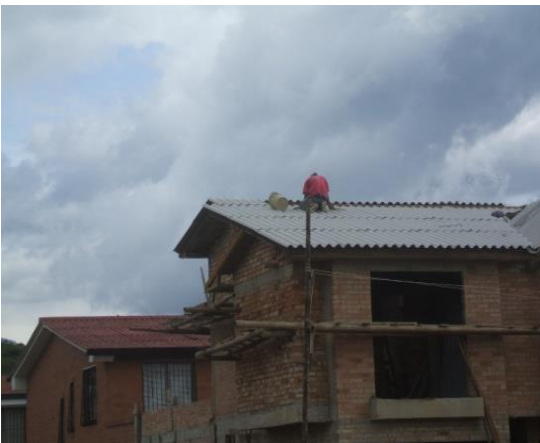
FOTO N°147: VISTA GENERAL DE LA COLOCACION DE LAS HOJAS DE ETERNIT EN LA CUBIERTA
