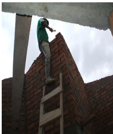
FOTO N°61: PEGA DE LADRILLO PARA ARMAR LA PENDIENTE DE LA CUBIERTA
