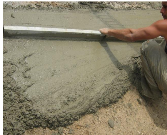
FOTO N°76: NIVELACION DEL PRIMER PISO
