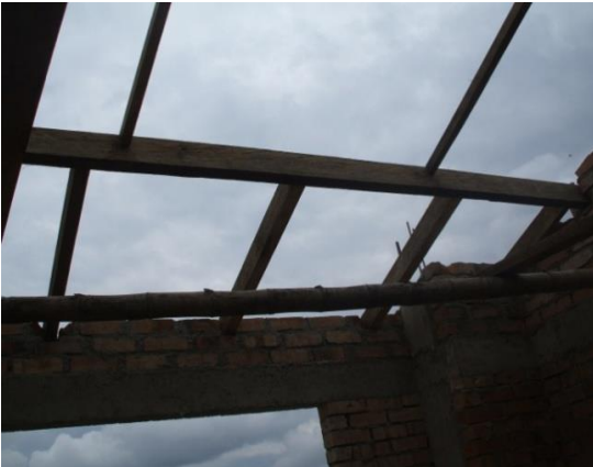
FOTO N°143: ESTRUCTURA DE LA CUBIERTA
