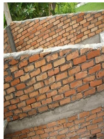
FOTO N°63: PENDIENTE DE LA CUBIERTA
