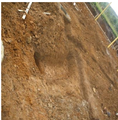
FOTO N°20: DERIVACIONES SANITARIAS DEL PRIMER PISO
