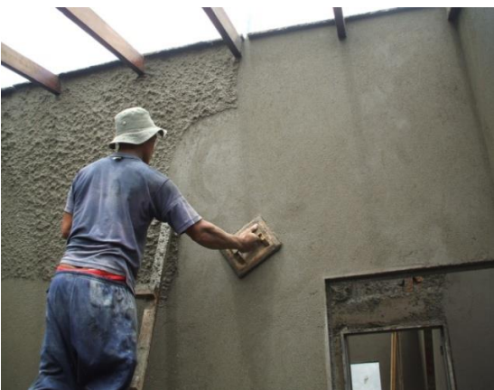
FOTO N°159: NIVELACION DE LA SEGUNDA CAPA DE REPELLO MEDIANTE LLANA DE MADERA
