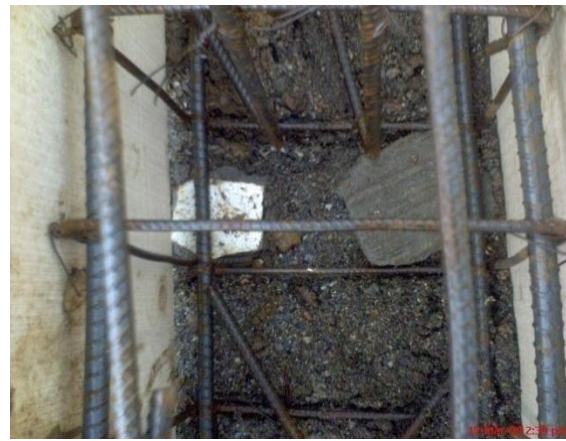
FOTO N°24: RECUBRIMIENTO DEL ACERO DE CIMENTACION
