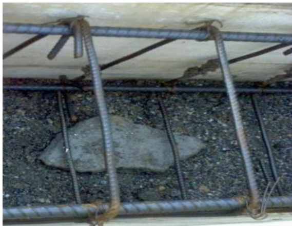
FOTO N°23: RECUBRIMIENTO DEL ACERO DE CIMENTACION
