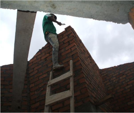
FOTO N°131: PEGA DE LADRILLO PARA ARMAR LA PENDIENTE DE LA CUBIERTA
