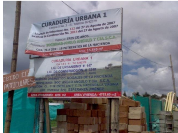
FOTO N°172: LICENCIA DE CONSTRUCCION DEL PROYECTO
