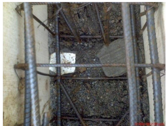
FOTO N°46: RECUBRIMIENTO DEL ACERO DE CIMENTACION
