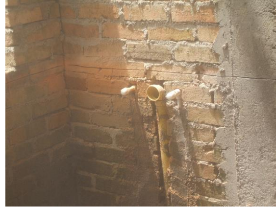
FOTO N°116: CONTINUACION DE LAS INSTALACIONES SANITARIAS
