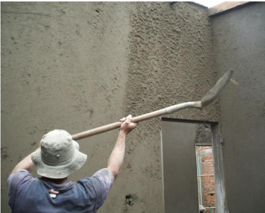
FOTO N°157: COLOCACION DE MORTERO PARA LA SEGUNDA CAPA DE REPELLO
