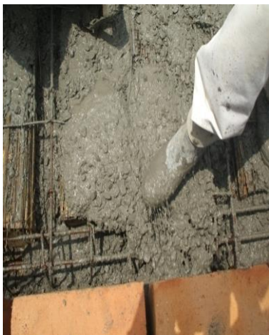
FOTO N°50: FUNDICION DE VIGAS PRINCIPALES Y NERVIOS DEL ENTREPISO
