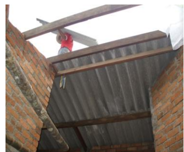
FOTO N°71: COLOCACION DE LAS HOJAS DE ETERNIT EN LA CUBIERTA
