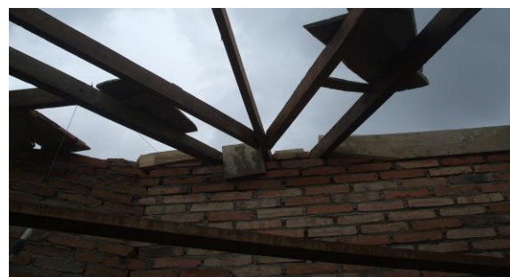
FOTO N°65: ESTRUCTURA DE MADERA TRIANGULAR
