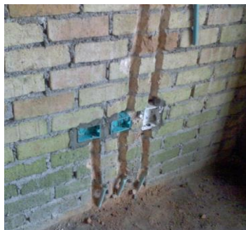
FOTO N°57: CONTINUACION DE LAS INSTALACIONES ELECTRICAS (PUNTOS ELECTRICOS)
