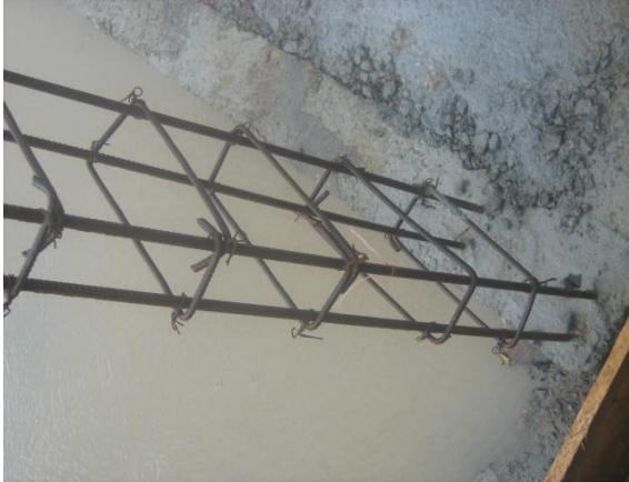
FOTO N°47: COLUMNA TIPO I
