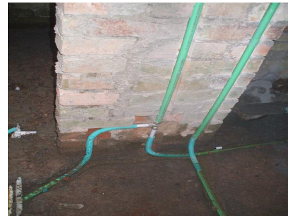
FOTO N°124: INSTALACIONES DE GAS PARA EL PRIMER PISO
