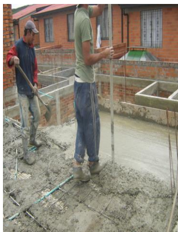
FOTO N°54: CHEQUEO DEL ESPESOR DE LA PLACA DE LA LOSA ALIGERADA
