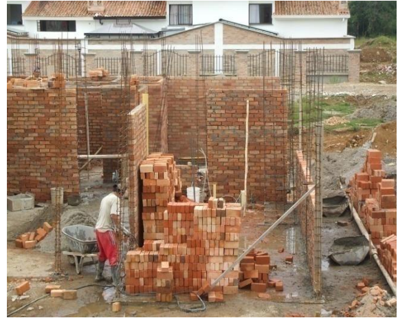
FOTO N°82: HUMEDECIMIENTO DEL LADRILLO PARA PEGA
