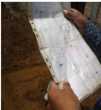
FOTO N°17: LECTURA DE PLANOS PARA INSTALAR LAS DERIVACIONES SANITARIAS DEL PRIMER PISO
