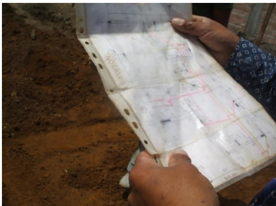
FOTO N°29: LECTURA DE PLANOS PARA INSTALAR LAS DERIVACIONES SANITARIAS DEL PRIMER PISO
