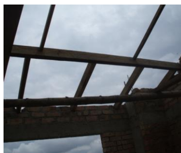
FOTO N°70: ESTRUCTURA DE LA CUBIERTA
