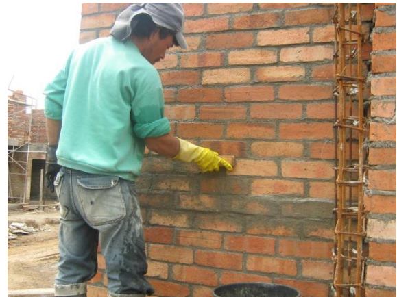
FOTO N°86: LIMPIEZA DE MUROS DE FACHADA
