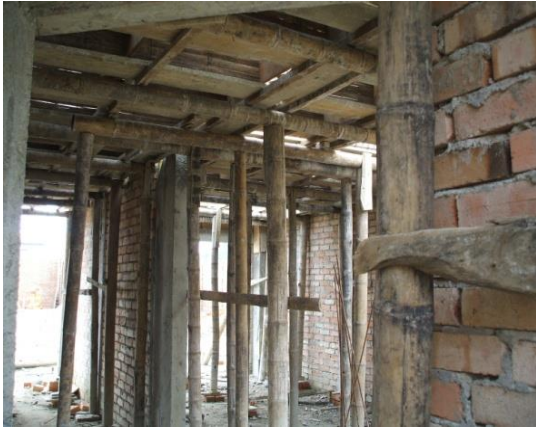
FOTO N°95: ARMADO DE LA FORMALETA PARA EL ENTREPISO (VISTA GENERAL DE LA FORMALETA)
