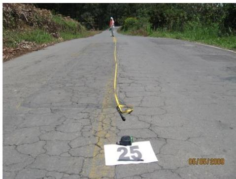
**FOTO N° 17** Medición de área de fallo en piel de cocodrilo en el Eje de la vía PR 08+0350.
