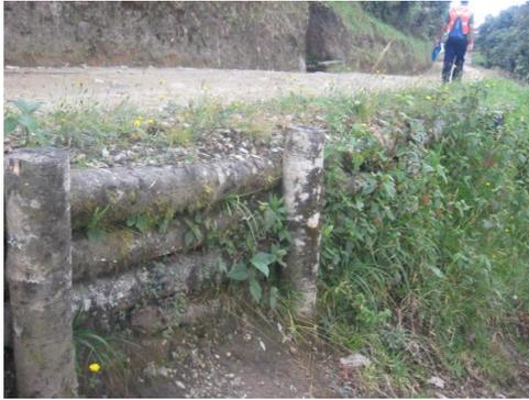
**FOTO Nº 75** Muro de Contención Artesanal hecho con Trinchos de madera.
