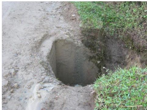
**FOTO N° 33** Perdida de Cabezal a la Entrada de Alcantarilla
