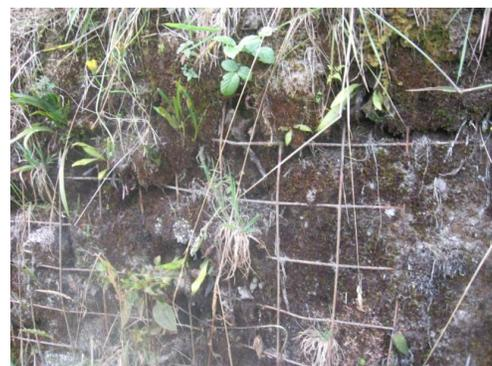
**FOTO N° 74** Muro de Contención Antiguo, sostenido con malla Rígida de Acero
