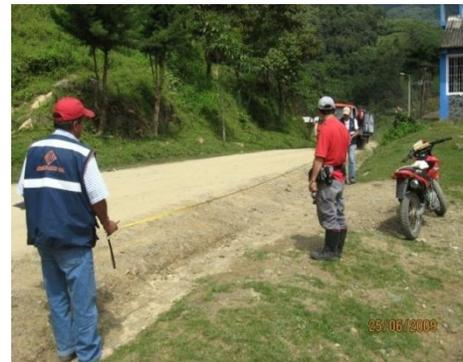
**FOTO N° 84** PR 17+0656, Cuneta existente la cual esta poco profunda por relleno para acceso de vehículos.
