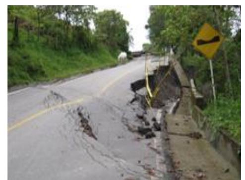
**FOTO N° 62** Señal de hundimiento en zona de vía entre Rosas y La Sierra.
