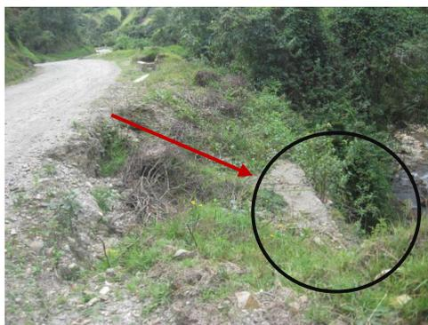
**FOTO N° 73** Zona de Hundimiento de Gaviones.
