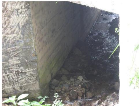
**FOTO N° 47** Box Coulvert en muy buen estado
