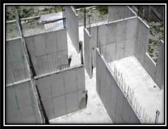
Fotografía 31. Detalle edificio construido con formaleta metálica
