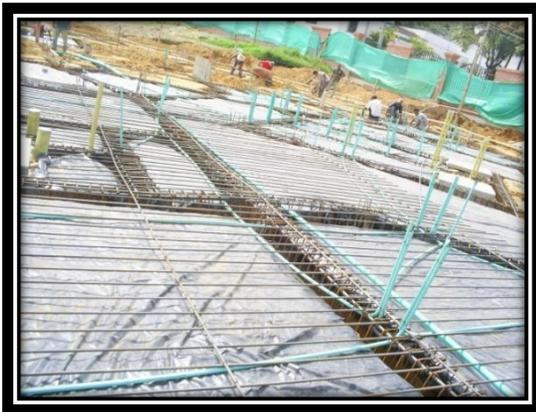
Fotografía 14. Refuerzo en las dos direcciones de la losa de cimentación
