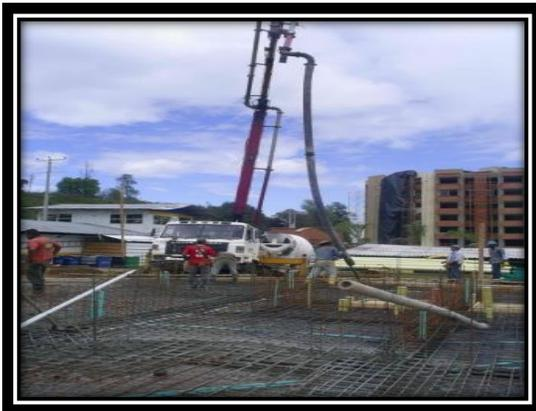
Fotografía 18. Losa de cimentación
