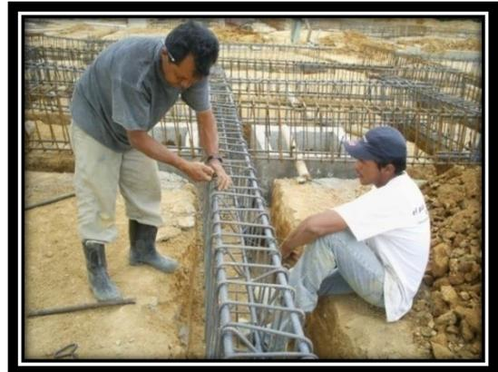
Fotografía 13. Colocación de refuerzo para losa de cimentación
