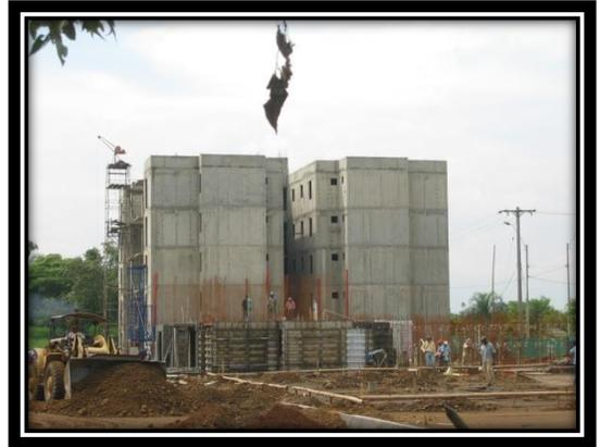
Fotografía 32. Desmontaje de las formaletas para muros
