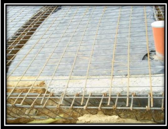
Fotografía 16. Instalaciones hidráulicas en losa de cimentación
