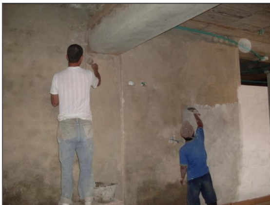
Uso de pegacor y base acrílica en el tercer piso
