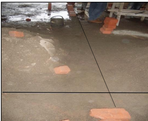
Hilos guía utilizados en el primer piso.
