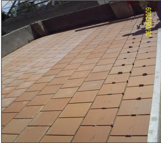
Losa del quinto piso
