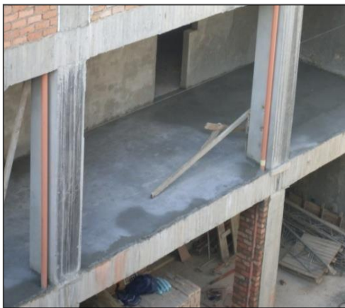
Columnas del segundo piso
