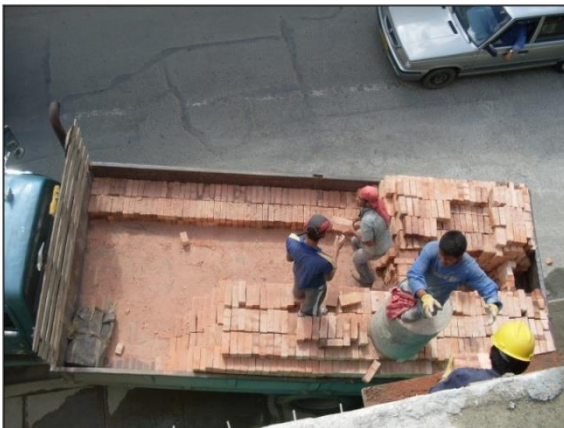
Descargue del ladrillo
