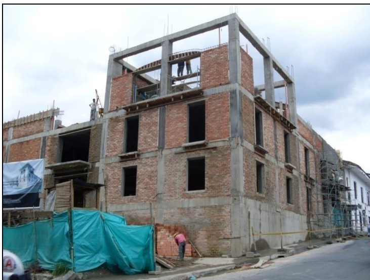
Trabajo de mampostería en el edificio.
