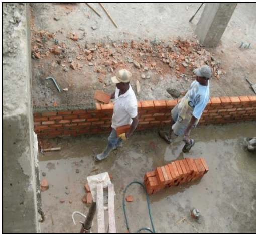
Proceso de mampostería con hilos guía.
