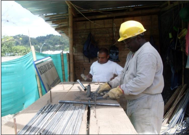
Mesa para flejado en obra.
