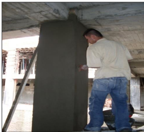
Columnas primer piso
