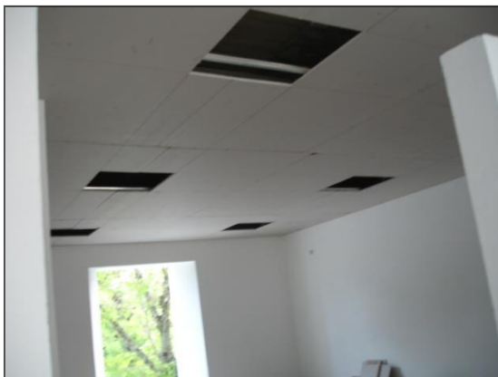
Cielo raso de salones del segundo piso
