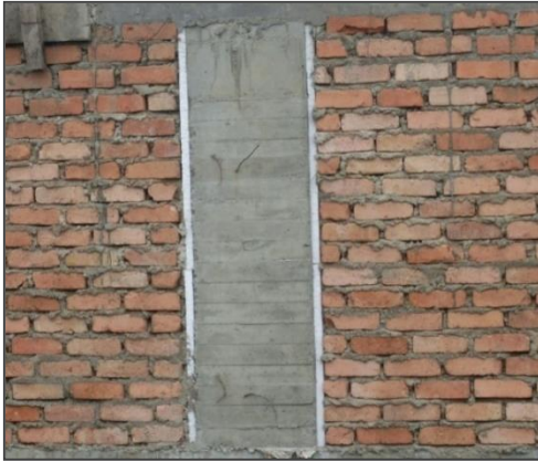
Muro interior del primer piso.
