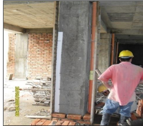
Anclaje de columnas primer piso.
