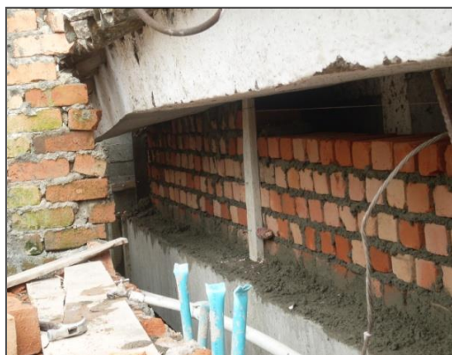
Muro en tizón
