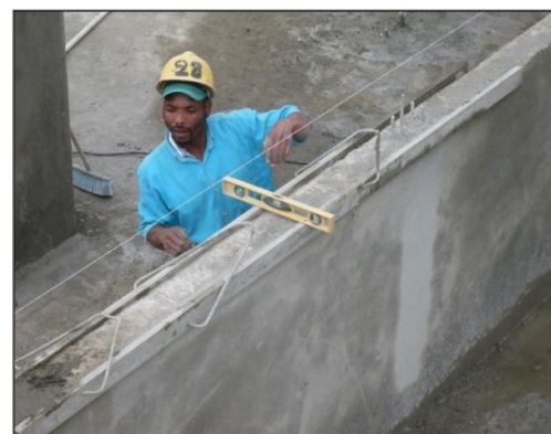
Utilización de un nivel burbuja, un ajustador e hilos guías
