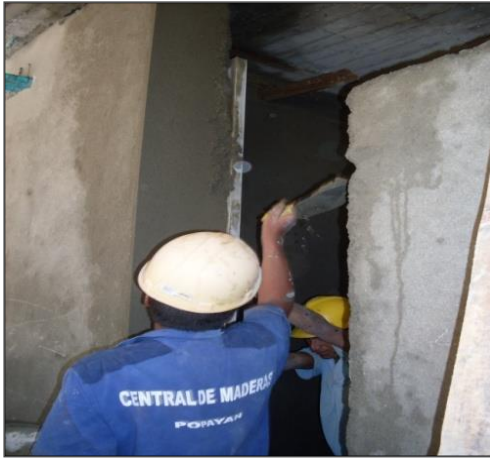
Utilización del codal para la nivelación de la cartera
