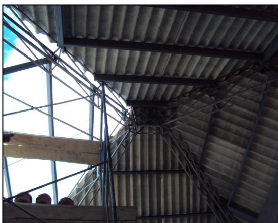
Vista inferior de la cubierta de la torre
