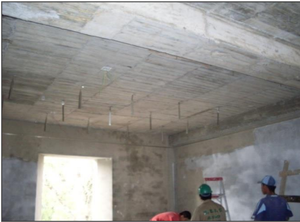
Ángulos en lámina del tercer piso
