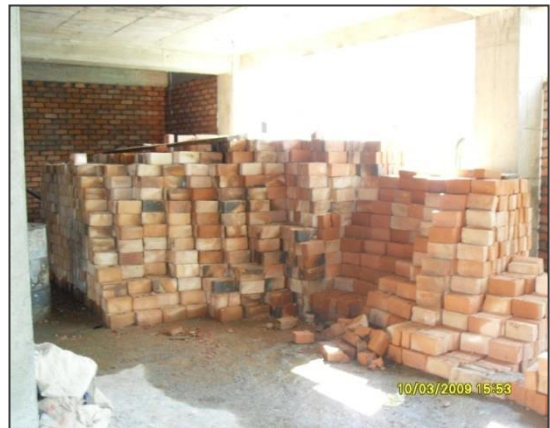
Almacenamiento del ladrillo en la obra.
