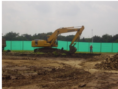
Retiro de capa vegetal
