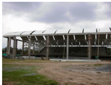
Terminación del techo sur
