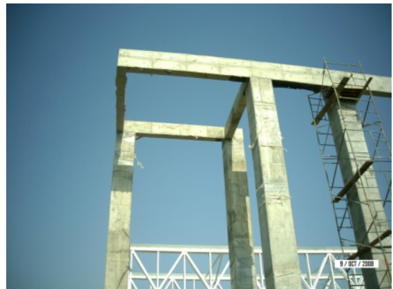
Fundición y desencoframiento de viga voladizo cuadrante A-C del 8-10 Coliseo Sur
