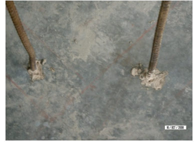
Anclaje de dovelas segundo nivel coliseo sur
