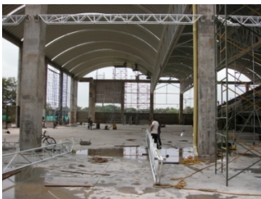
Vigas cerchadas para cubierta triangular
