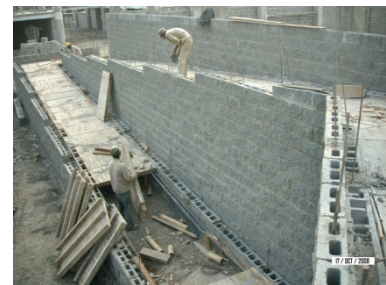
Construcción de encofrado
