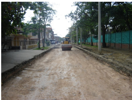
Explanación y compactación de la subrasante
