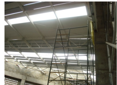
Instalación de cubierta modular
