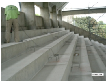
Anclaje y fundición de gradas coliseo sur
