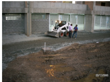
Riego de material
