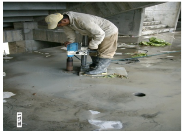
Perforaciones con saca núcleo
