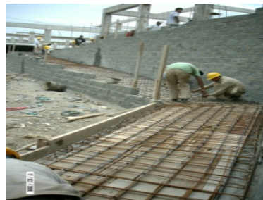
Armado de su respectivo refuerzo para la losa de transito
