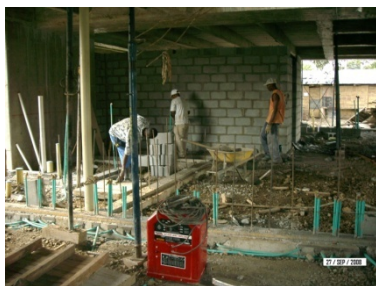
Replanteo y construcción de redes eléctricas
