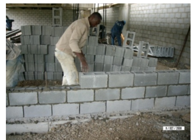
Construcción de muros
