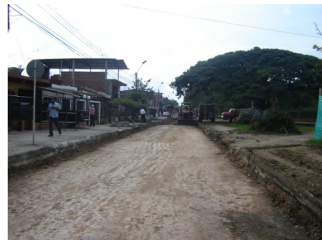
Riego de sub-base y base
