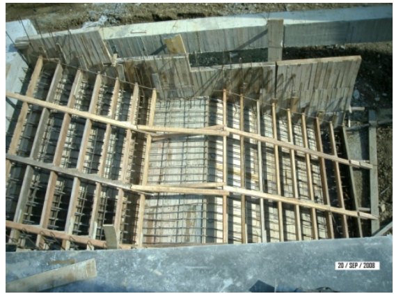
Revisión de acero y formaleta de la gradería ubicada en el cuadrante A-B entre 2-5
