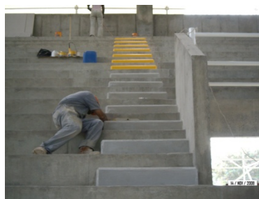
Anclaje y fundición de gradas coliseo sur
