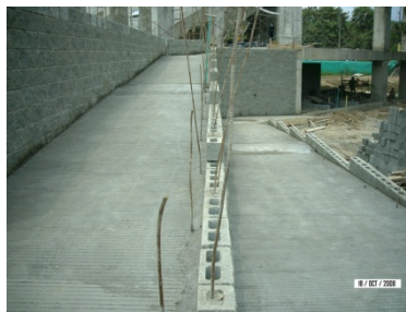
Dovelas para remates
