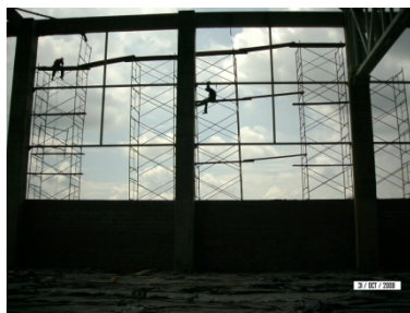
Adecuación de perfilería
