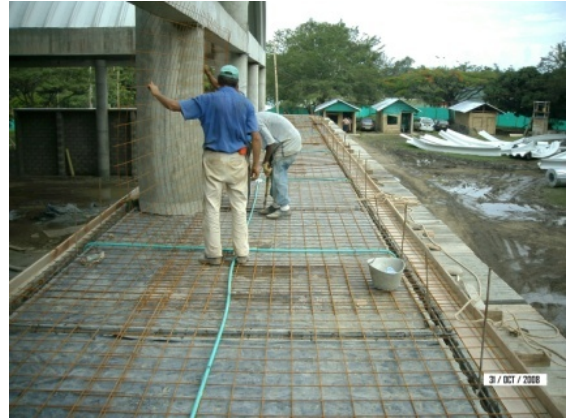
Losa ubicada entre el eje K entre 28-32
