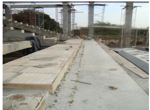
Ampliación y formaleta para aceros
