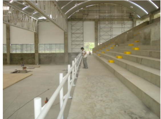
Construcción y pintura de barandas de seguridad a lo largo del eje 5' del coliseo sur
