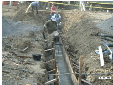
Muro de contención
