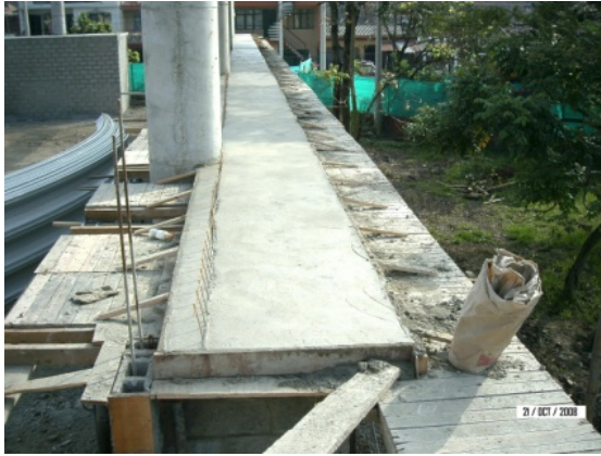
Losa ubicadas en el eje 32 entre K-U
