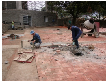
Rectificación de cajas
