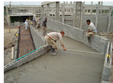
Fundición de la losa
