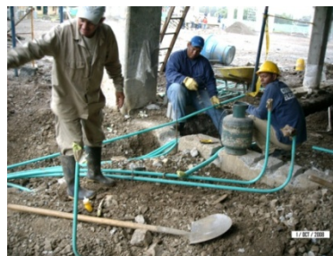
Replanteo y construcción de redes eléctricas
