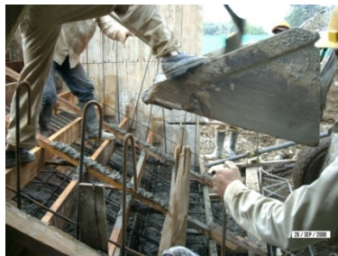
Fundición de gradería en concreto con aditivo SIKASET-L
