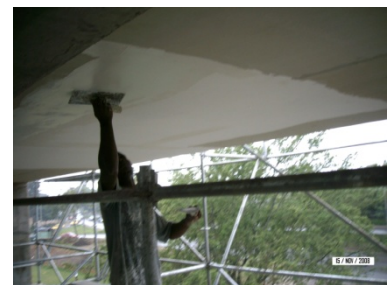
Instalación de panel board, yeso con su sello de juntas, más estuco y pintura
