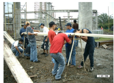
Armada de mesas de soporte para la lámina procesada
