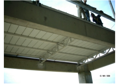
Instalación de teja modular tipo sandwich
