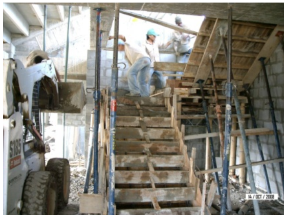
Fundición y acabado de las escaleras ubicadas en el cuadrante G-H entre 3-4
