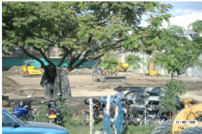
Cajeo de parqueadero
