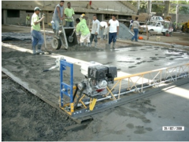
Fundición de pisos
