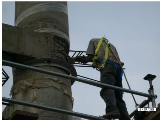
Aplicación del epóxico
