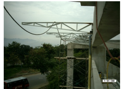
Instalación de cerchas metálicas fachada Av. Simón Bolívar
