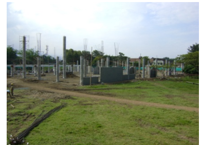
Fundición de columnas y vigas
