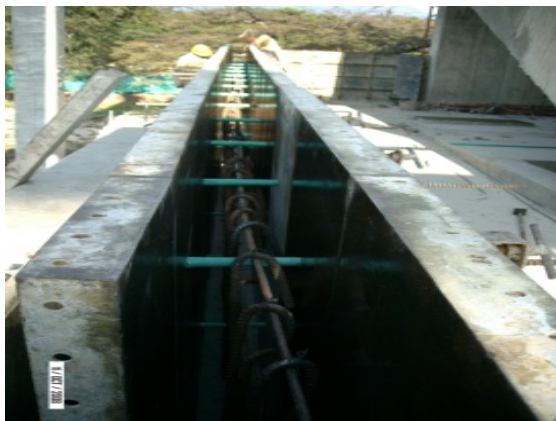
Proceso constructivo de un muro para corredores ubicado en el coliseo sur paralelo al eje B entre 2-5
