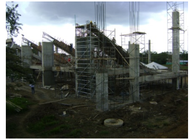
Vigas inclinadas o gualderas
