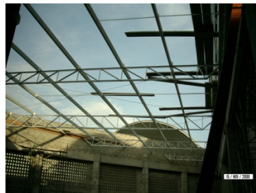
Vigas cerchadas para cubierta triangular
