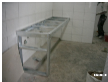
Construcción de mesones para baños Coliseo Sur
