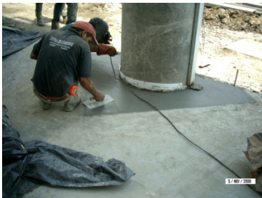
Acabado de dilataciones
