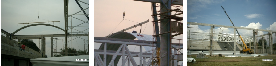
Instalación de tercetas en el coliseo sur al día siguiente
