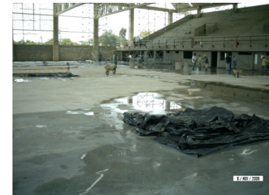
Lavado con hidrolavadora
