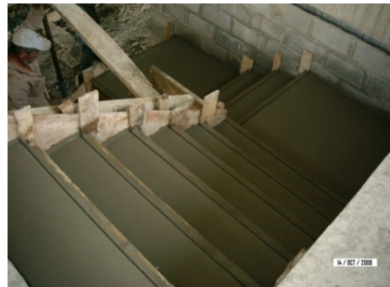
Fundición y acabado de las escaleras ubicadas en el cuadrante G-H entre 3-4
