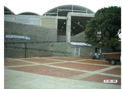
Sellado y Limpieza de Andenes
