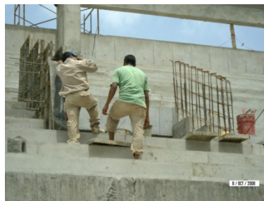
Pasamanos de gradería Muros de seguridad (conexión de grad.espectadores - 2 do piso)
