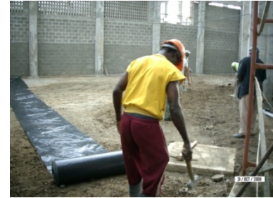
Finalización de pisos
