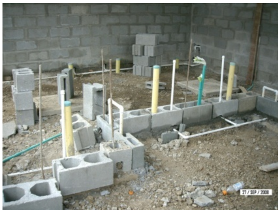
Replanteo de parte hidráulica primer piso
