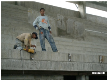
Soldadura de platinas, codos y postes de gradería
