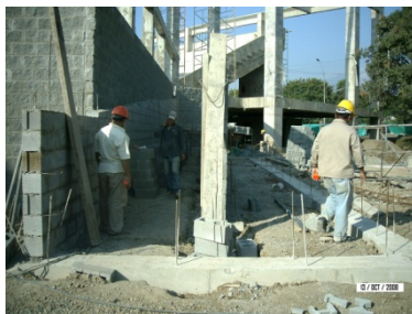
Construcción de muros
