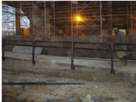
Rampa PMR ubicada al Oriente del coliseo sur
