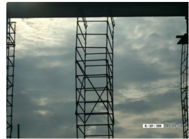
Andamios de carga
