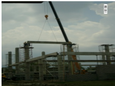
Cargue con grúa
