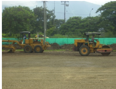
Riego y compactación
