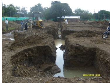
Excavación de fundaciones
