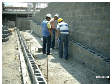
Revisión de dovelas
