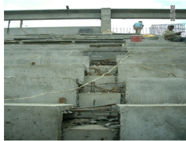
Soldadura de Pelos
