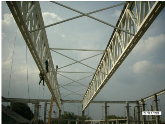
Fijación de riostras, correas en las vigas
