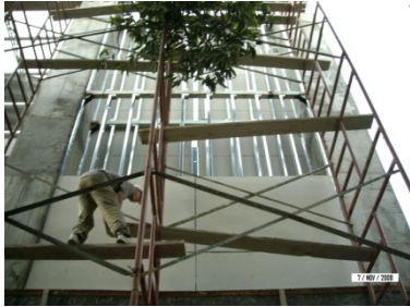
Adecuacion de paneles
