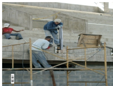
Soldadura de platinas, codos y postes de gradería
