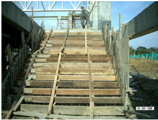
Revisión de acero y formaleta de la gradería ubicada en el cuadrante A-B entre 2-5
