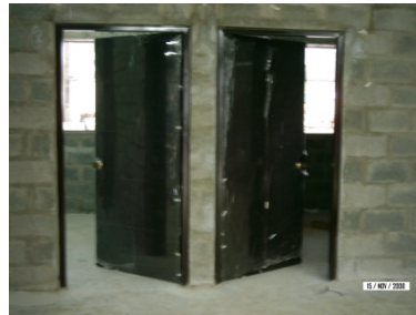
Instalación de puertas en madera y ventanas coliseo sur
