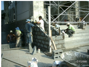
Remates de muros
