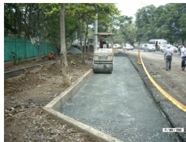
Construcción Estación Bus
