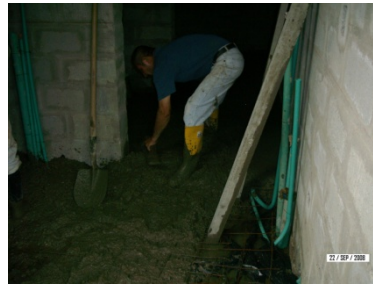
Nivelación de mezcla
