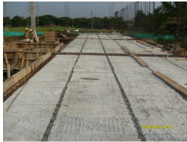
Losa prefabricada
