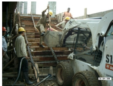
Fundición de gradería en concreto con aditivo SIKASET-L
