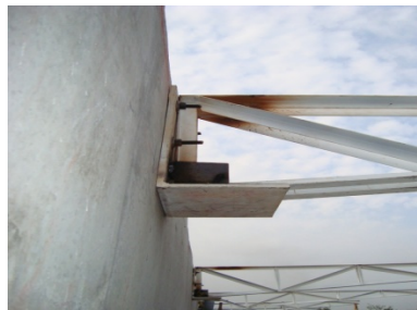
Instalación de cerchas metálicas fachada Av. Simón Bolívar
