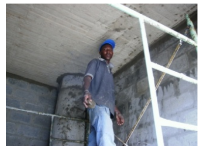
Remate de mampostería
