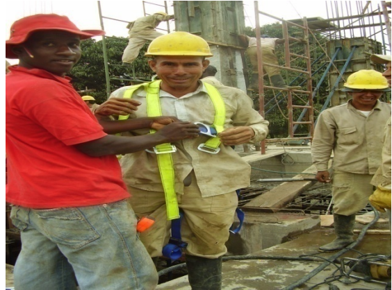
Operario con arnés de seguridad
