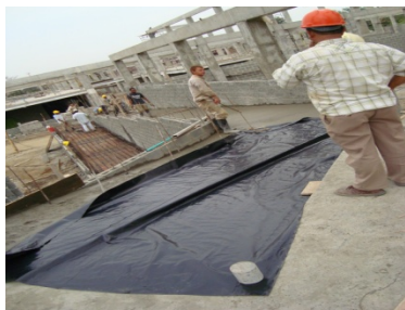
Curado de la losa
