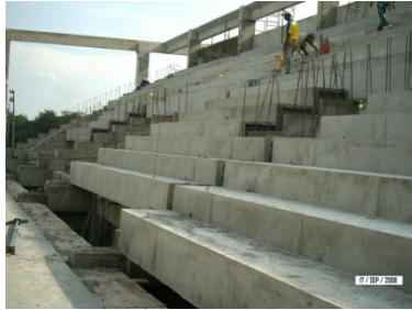
Colocación de gradería
