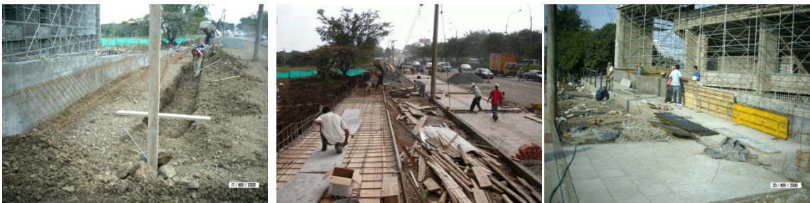
Construcción de losa para rampa paralela a la autopista Fundición de baranda en Ccto
