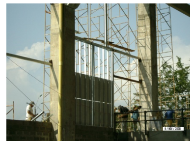
Fijación de panel board, yeso através de sus canales
