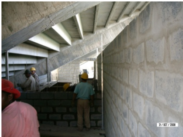
Divisiones de baños
