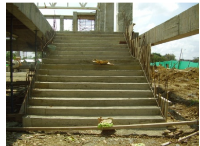
Fundición de gradería en concreto con aditivo SIKASET-L
