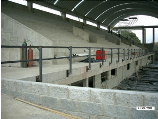
Construcción y pintura de barandas de seguridad a lo largo del eje 5' del coliseo sur
