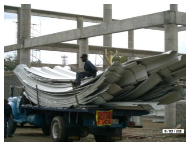
Recolección de escombros
