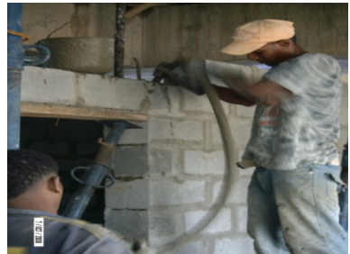
Fundición y vibrado de vigas dintel, bloque viga, anclajes
