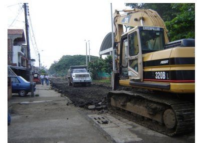
Retiro de carpeta asfáltica
