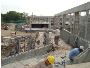
Armado de su respectivo refuerzo para la losa de transito
