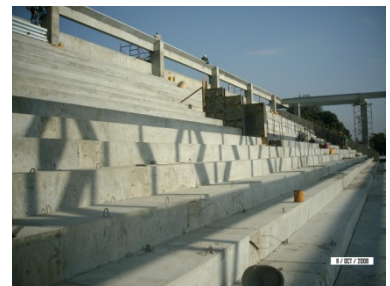
Pasamanos de gradería Muros de seguridad (conexión de grad.espectadores - 2 do piso)
