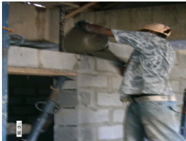
Fundición y vibrado de vigas dintel, bloque viga, anclajes
