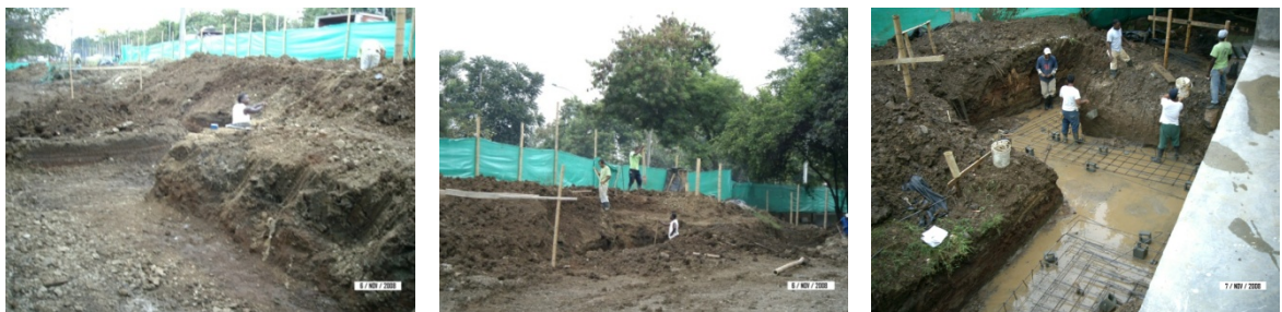
Excavación y nivelación para muro de contención (sector occidental coliseo sur)
