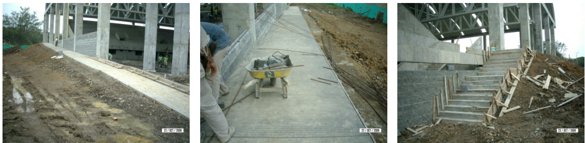
Fundición de rampa PMR y gradas de acceso al coliseo sur ubicada en la parte sur
