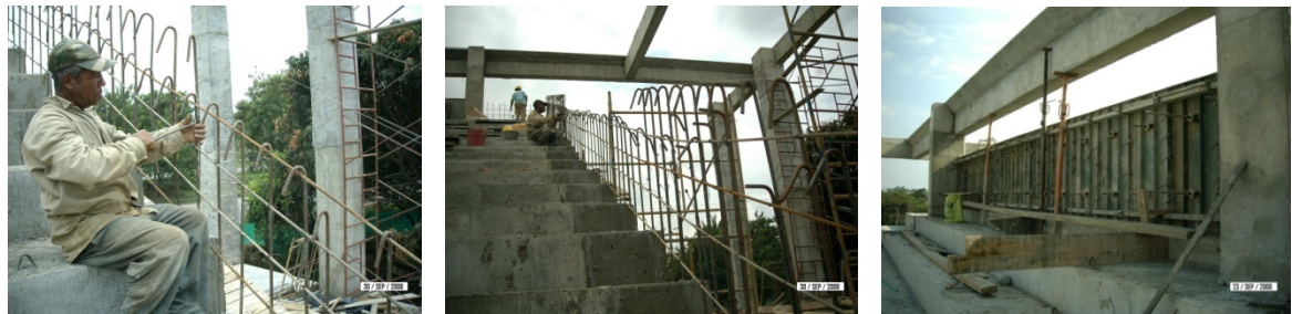
Amarre de acero de momento negativo, formaleta de barandas de aislamiento y seguridad para los espectadores del coliseo sur
