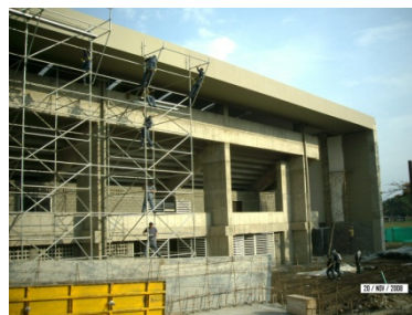
Instalación de panel board, yeso con su sello de juntas, más estuco y pintura
