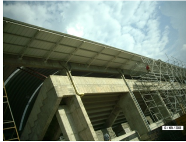
Instalación de teja modular tipo sandwich
