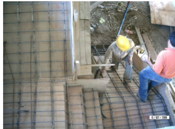
Encofrado, amarre de acero y revisión en la escalera ubicada en el cuadrante G-H entre 3-4
