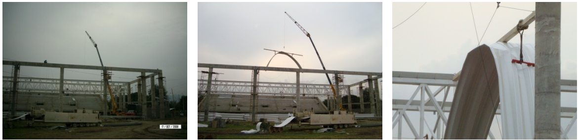
Daños en montaje de la primera terceta por vientos demasiado altos en el coliseo sur
