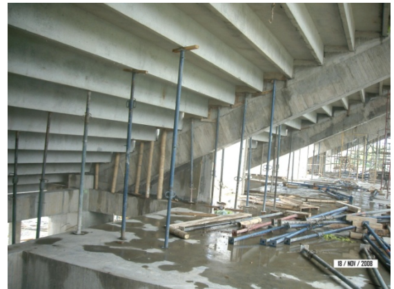
Retiro de puntales de apoyo para gradería
