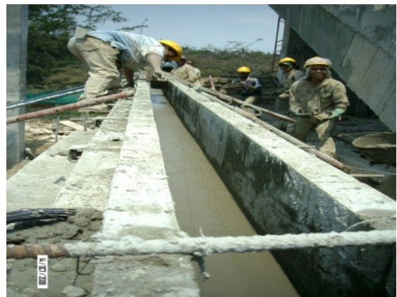
Proceso constructivo de un muro para corredores ubicado en el coliseo sur paralelo al eje B entre 2-5
