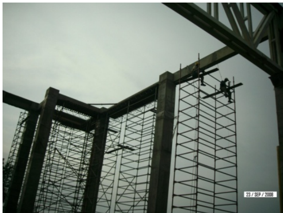
Fundición y desencoframiento de viga voladizo cuadrante A-C del 8-10 Coliseo Sur
