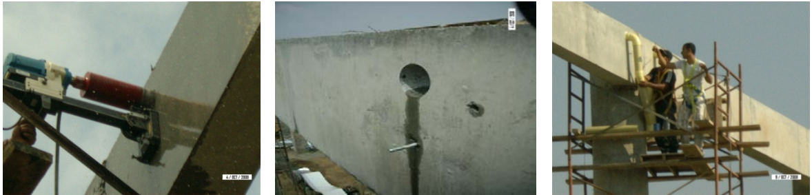
Perforación con saca núcleos más instalación de bajantes
