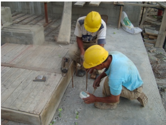
Anclaje para viga Ppal.
