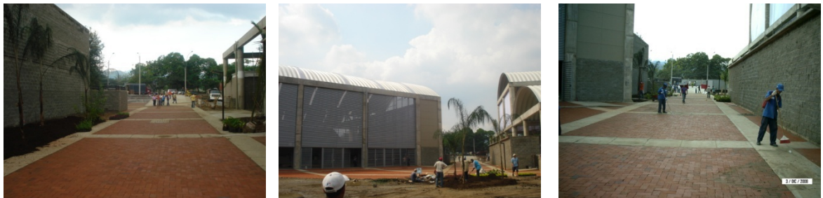
Jardinería, sello de juntas y limpieza de los andenes
