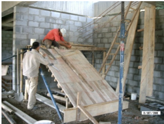
Encofrado, amarre de acero y revisión en la escalera ubicada en el cuadrante G-H entre 3-4
