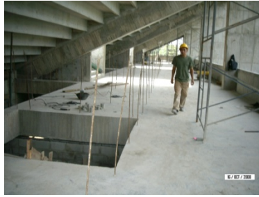
Anclaje de dovelas segundo nivel coliseo sur
