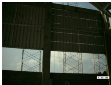
Fijación de panel board, yeso através de sus canales
