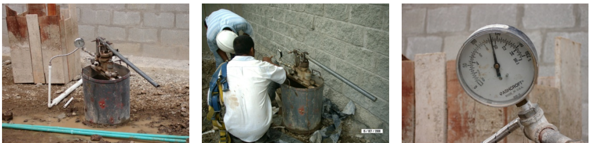
Cierre de circuito Hco a una presión constante de 150 PSI durante 30 min y toma de lectura
