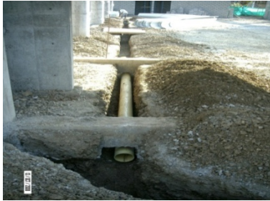
Excavación y tubería
