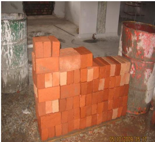
FIGURA 4. LADRILLO TOLETE USADO EN LA OBRA
