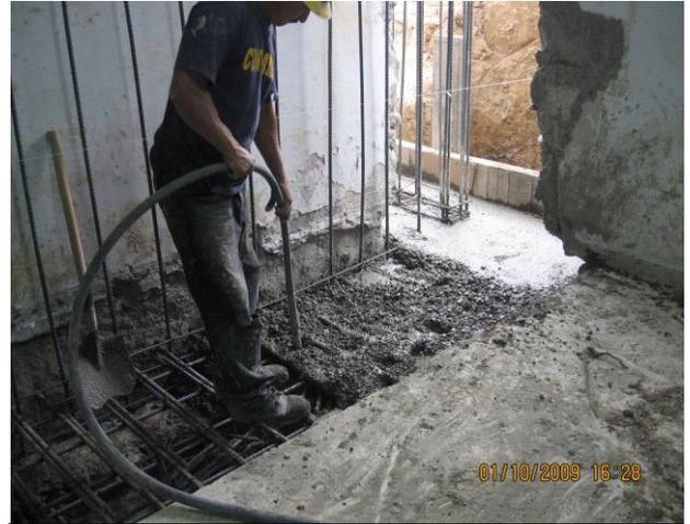
FIGURA 15. VIBRADO DE ZAPATA
