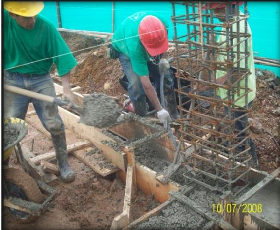
En la obra se pudo corroborar este concepto. Si se presentaba el caso en el que no se alcanzaba a fundir completamente uno o varios pórticos, ya fuera por falta de mezcla de concreto, por tiempo, por estado del clima (lluvia) o porque algún otro elemento del pórtico no estaba listo para fundirse, se debía fundir el nudo y 2/3 de la ó de las vigas que convergían al mismo.
