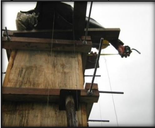
El desencofrado de las columnas fundidas se autorizaba al día siguiente de su fundición.
