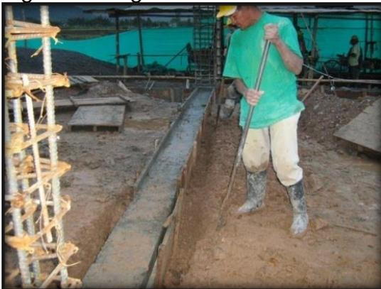
En esta actividad fue necesario realizar unas estructuras de concreto, denominadas Cuellos, debido a que el nivel de las zapatas quedo mas bajo que el de las vigas, las dimensiones de estos elementos son: ancho 0.30m, alto 0.09m y de longitud entre 0.45 y 0.65m.
