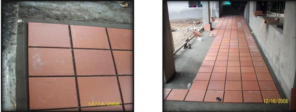
Para este piso, se construyó un guarda escoba en Media caña en gravilla lavada de altura  $h=15$  cm.
