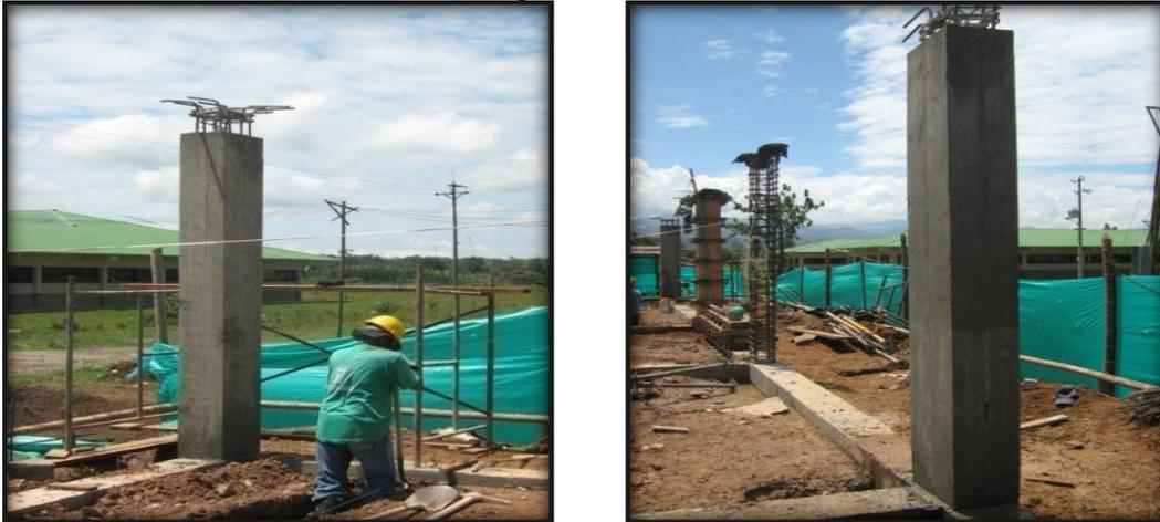
La compactación del concreto de las columnas se hizo por el método de vibrado.
