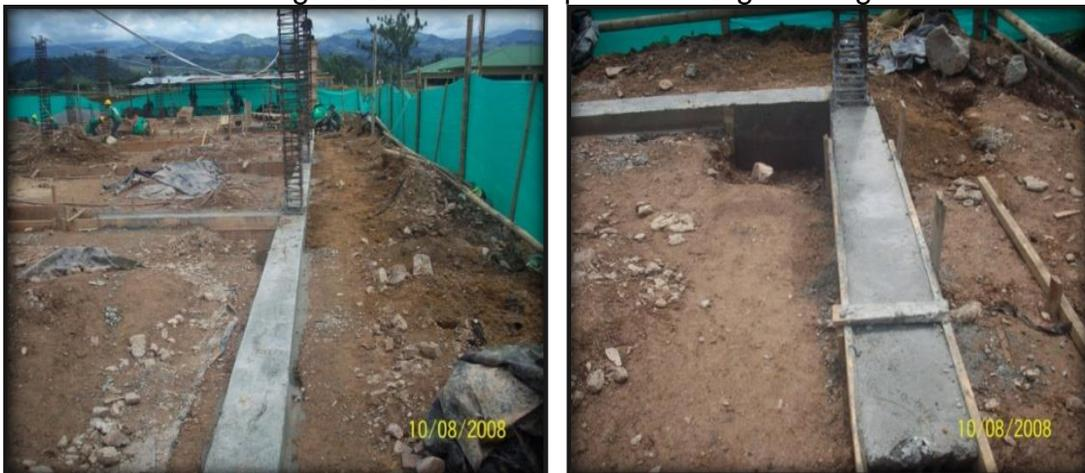
De la mezcla de concreto utilizada para la fundición de estos elementos estructurales se extraían las muestras respectivas para los ensayos de Resistencia del Concreto, en la Tabla 3 se presentan algunos resultados de resistencia obtenidos de algunas vigas, estudios realizados por el laboratorio de la empresa CITEC LTDA.
