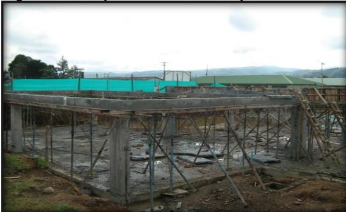
Un punto importante en la fundición de los elementos estructurales de los pórticos, es manejar el concepto de unión monolítica, que se garantiza cuando se funde completa y continuamente cada nudo (unión entre viga y columna).
