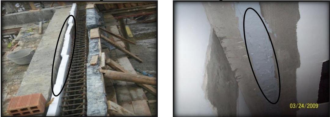
a) Construcción de la dilatación con lámina de icopor.
