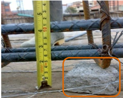
Figura 41. Colocación de panelas para garantizar recubrimiento
