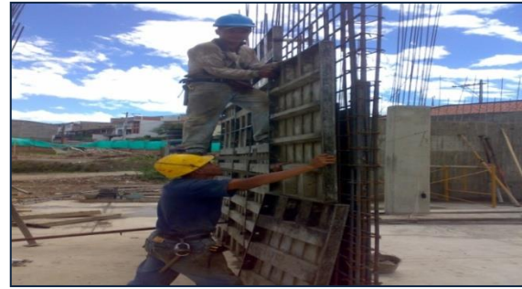
Figura 31. Montaje de formaleta manoportante
