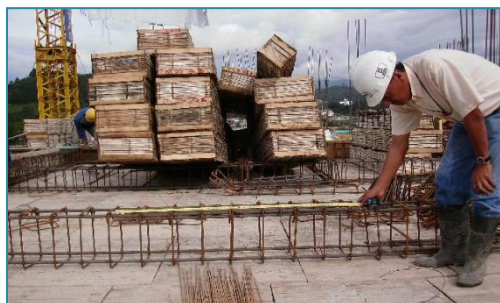
Figura 40. Verificación longitud de los traslapos
