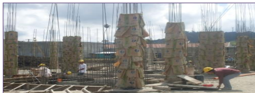
Figura 37. Curado con materiales sellantes
