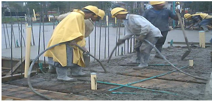
Figura 47. Vibrado en la losa
