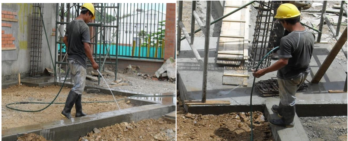
Figura 49. Suministro de curado a vigas y zapatas de cimentación
