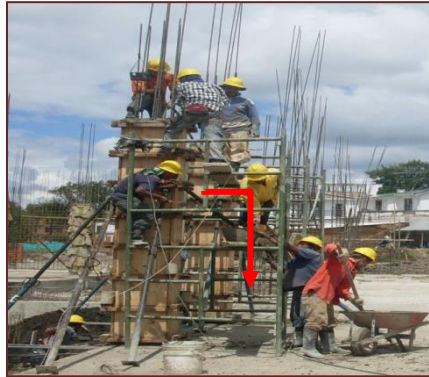
Figura 34. Colocación de concreto en las columnas
