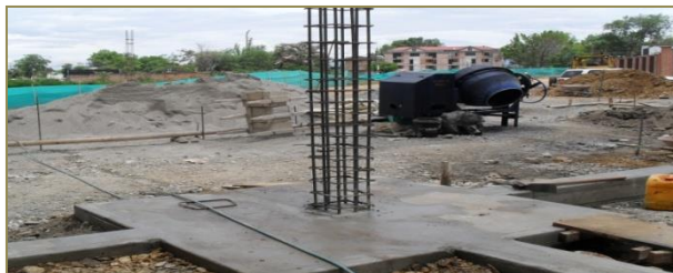
Figura 13. Cimentación zona de parqueaderos
