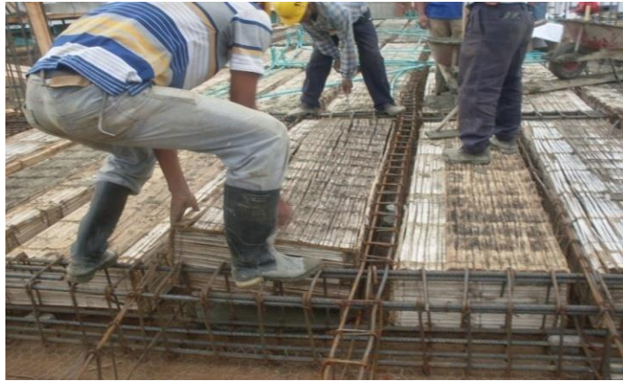
Figura 42. Instalación de casetones
