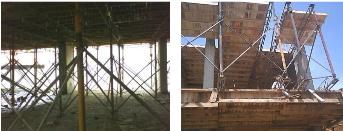
Figura 38. Sistema de soporte del encofrado de la losa
