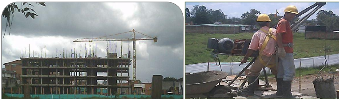
Figura 33. Métodos de transporte de la mezcla de concreto
