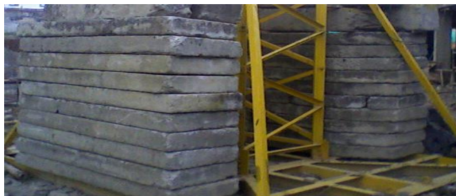
Figura 17. Bloques de soporte para la torre grúa
