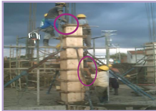
Figura 35. Vibrado de una columna
