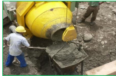
Figura 32. Descarga de la mezcla de concreto
