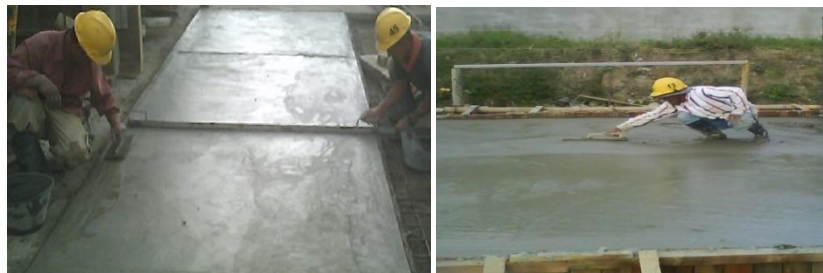
Figura 48. Acabado de la losa
