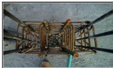
Figura 29. Comienzo armado de una columna
