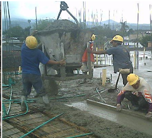
Figura 46. Vaciado de concreto en losas
