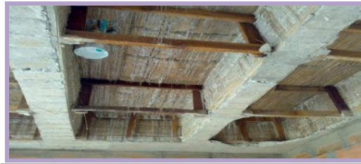
Figura 12. Losa aligerada con esterilla de guadua
