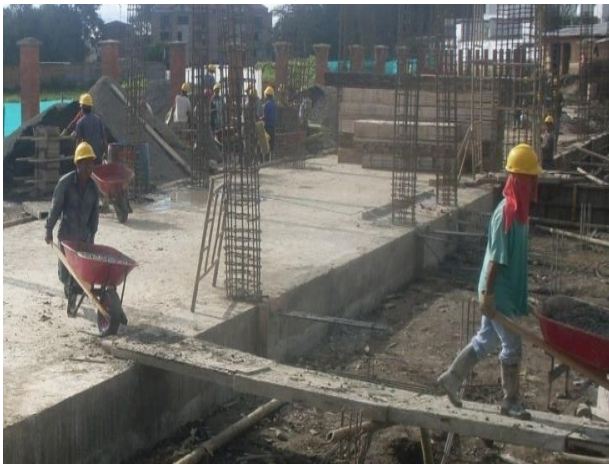
Figura 45. Transporte del concreto a través de carretillas
