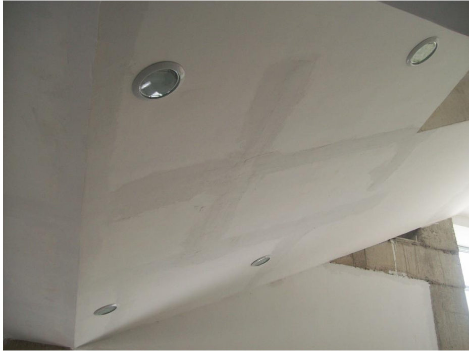
Ilustración 89, Cielo falso del primer piso en reparación.
