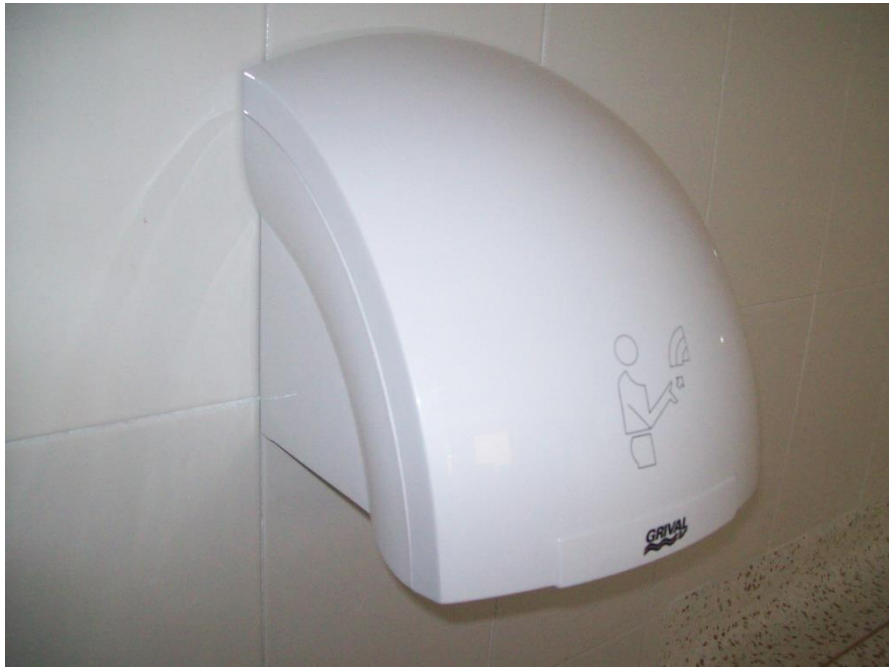
Ilustración 97, Secamanos ya instalado.
