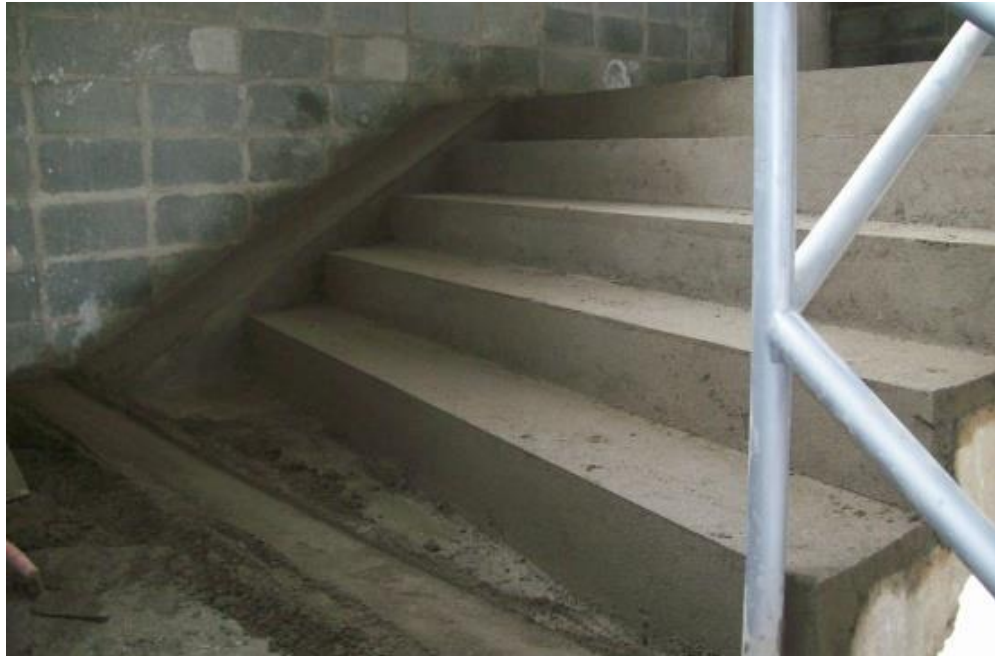
Ilustración 15, Gradas ya niveladas y listas para recibir el granito pulido.
