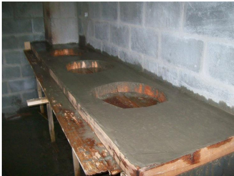
Ilustración 31, Mesón ya fundido, nótese los espacios adecuados para recibir los lavamanos.
