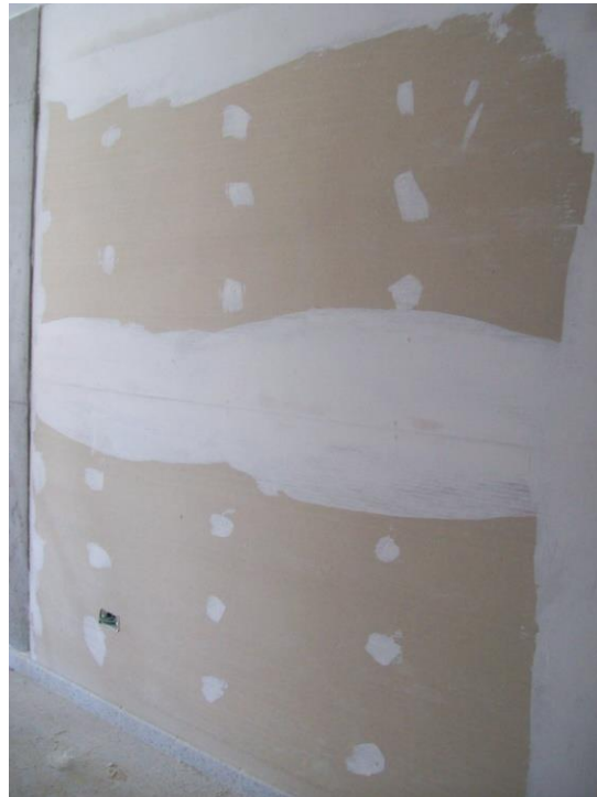
Ilustración 21, Orificios y juntas masillados con estuco panel IMPADOC.
