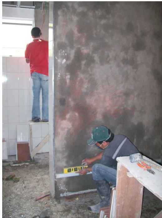
Ilustración 61, Proceso de pegado de enchape.
