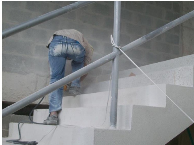
Ilustración 54, Gradas en proceso de pulida.
