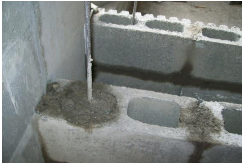
Ilustración 6, Concreto grouting confinado el acero de anclaje.
