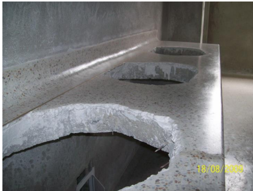
Ilustración 35, Mesón ya totalmente pulido, brillado y encerado.
