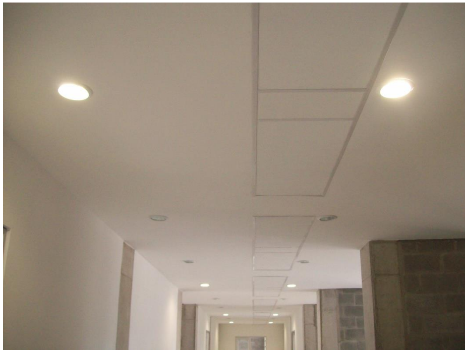
Ilustración 90, Cielo falso ya totalmente terminado.
