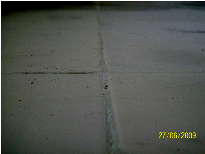
Ilustración 64, Acercamiento del boquillado en el enchape.
