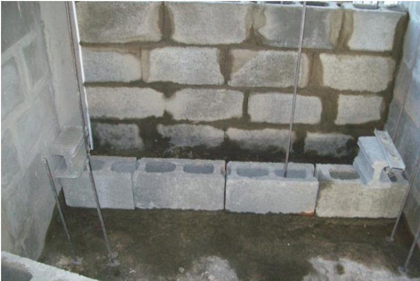
Ilustración 3, Bloque liso y anclajes ya instalados
