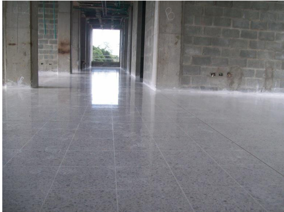
Ilustración 48, Piso ya terminado.
