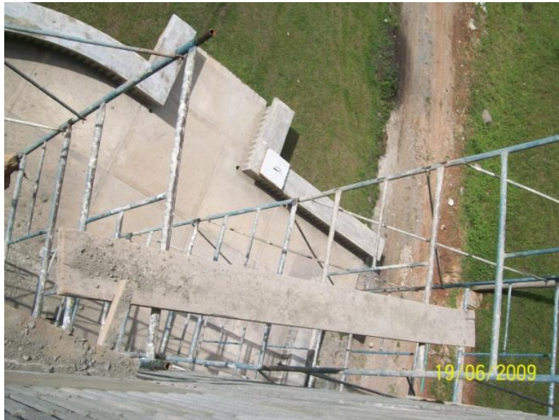
Ilustración 118, Andamios usados para la construcción de obras exteriores.
