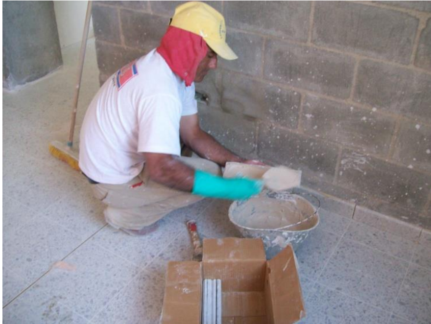
Ilustración 66, Proceso de pegado de guardaescoba.
