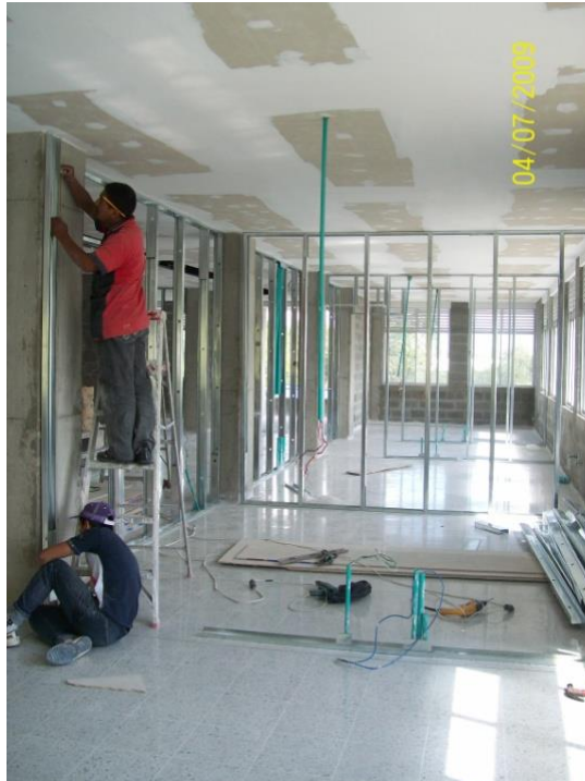
Ilustración 16, Armado del esqueleto de los muros en superboard.
