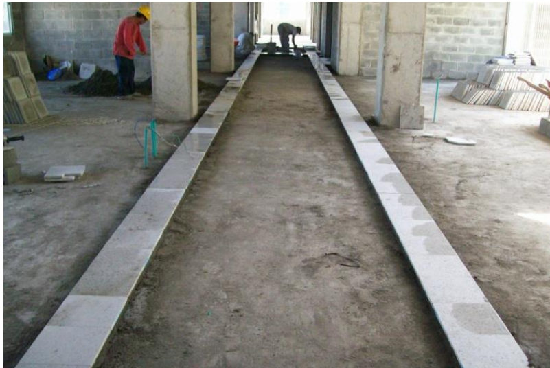
Ilustración 38, Hiladas longitudinales de distribución ya terminadas
