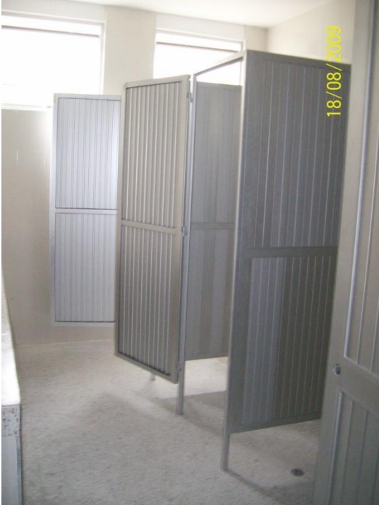
Ilustración 100, Divisiones de los baños ya instaladas.
