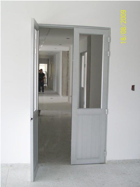
Ilustración 99, Puerta de aluminio instalada.
