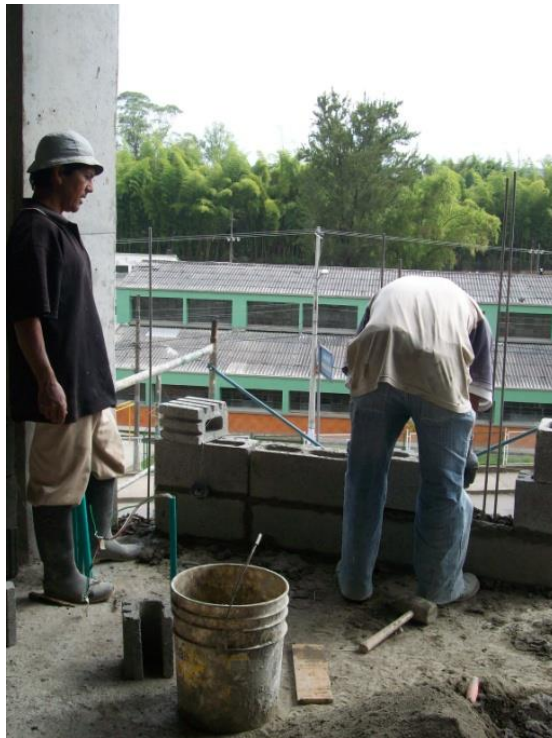
Ilustración 11, Construcción de muro en bloque acanalado.
