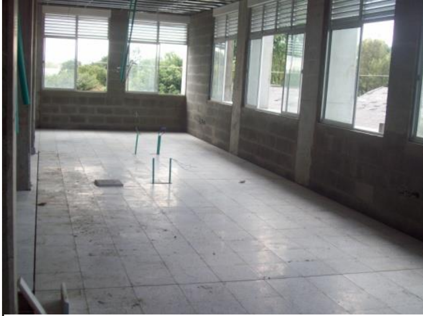
Ilustración 42, Piso en baldosa ya pegado, falta la fragua, destronado, brillo y cristalizado
