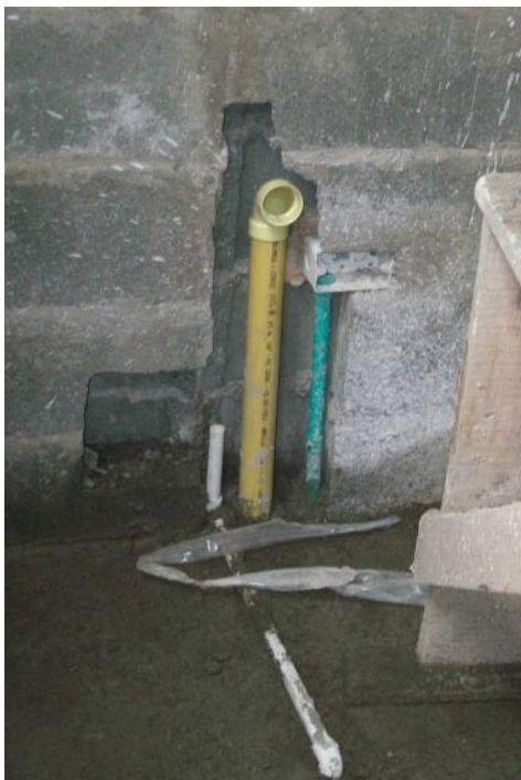
Ilustración 76, Punto sanitario con su regateo correspondiente.
