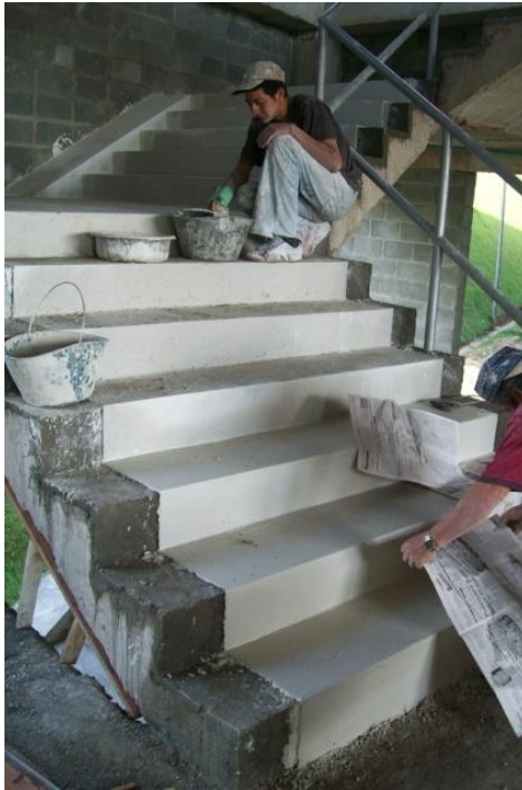
Ilustración 51, Revestimiento de granito puesto y alisado.
