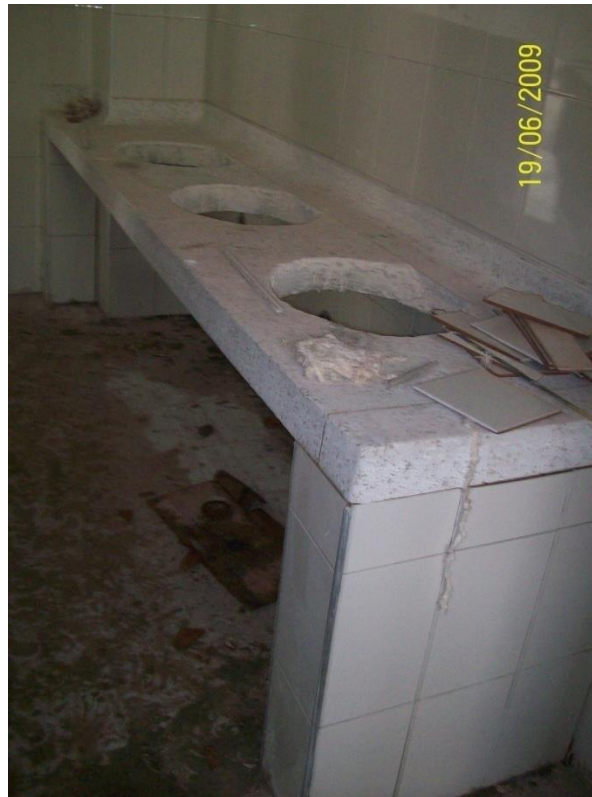
Ilustración 65, Enchape terminado, nótese la piraqua en el borde de la pata del mesón.
