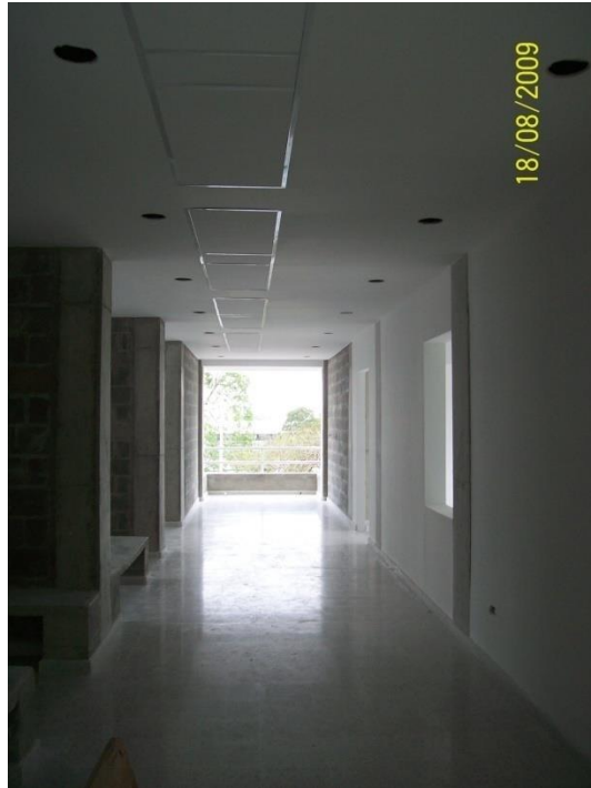
Ilustración 29, Muros en superboard ya terminados.
