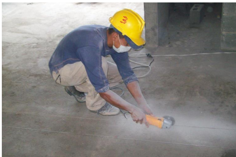
Ilustración 37, Obrero haciendo el corte para la dilatación de la losa.
