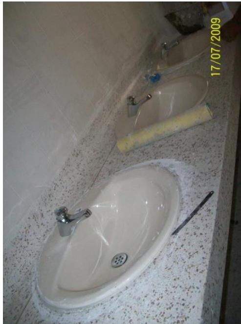
Ilustración 92, Lavamanos de incrustar ya instalados.
