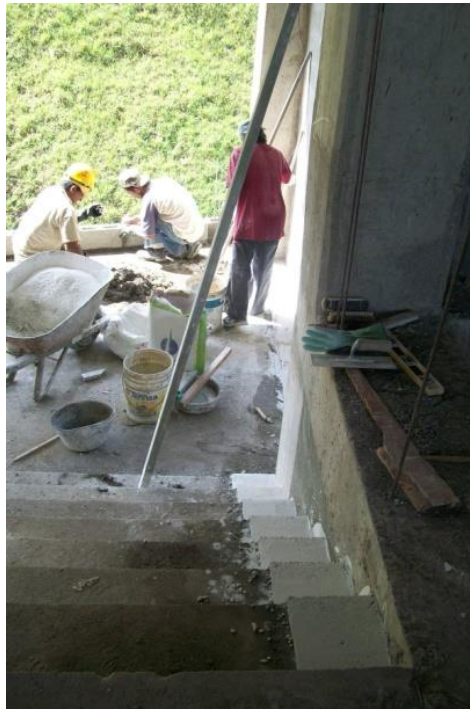
Ilustración 50, Mezcla de granito puesta en el borde interior de las gradas.
