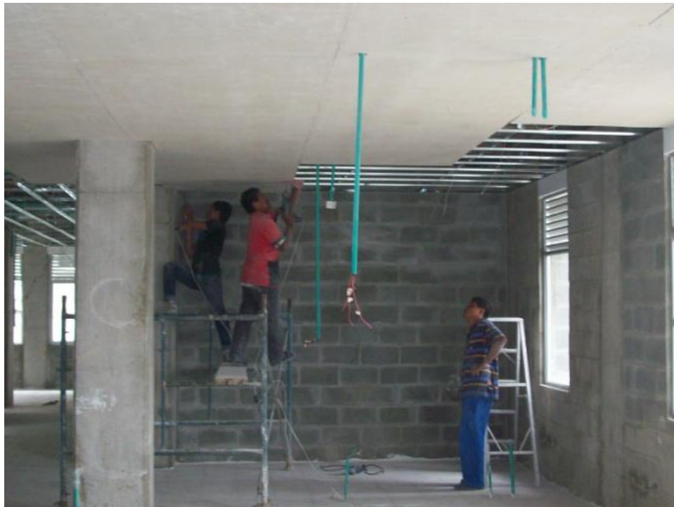
Ilustración 82, Proceso de instalación de las láminas en superboard.
