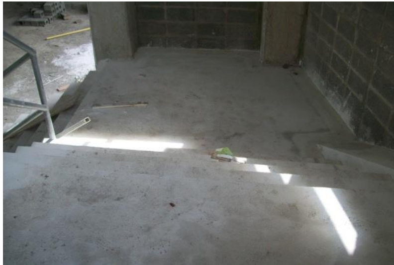
Ilustración 52, Gradas ya terminadas, falta pulirlas.
