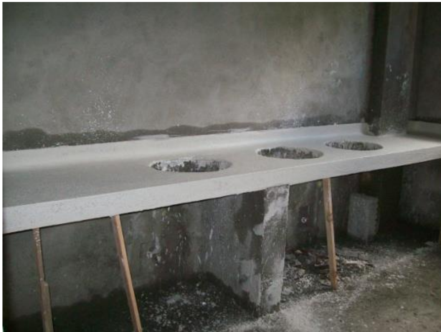
Ilustración 33, Granito ya aplicado y nivelado con codal.
