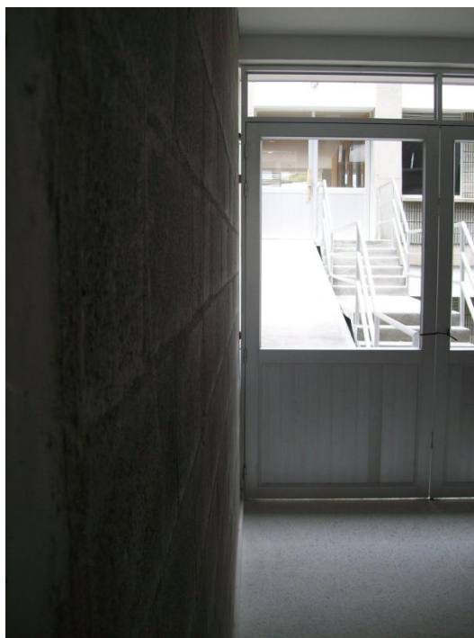
Ilustración 101, En esta imagen se puede detallar el espacio entre la columna y la puerta, fue sellado con silicona.
