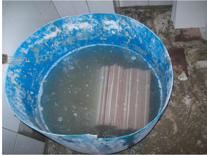
Ilustración 60, Cerámica en proceso de humedecimiento.
