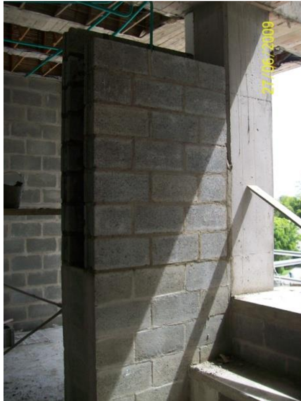
Ilustración 8, Muro ya terminado, obsérvese que es de doble cara.
