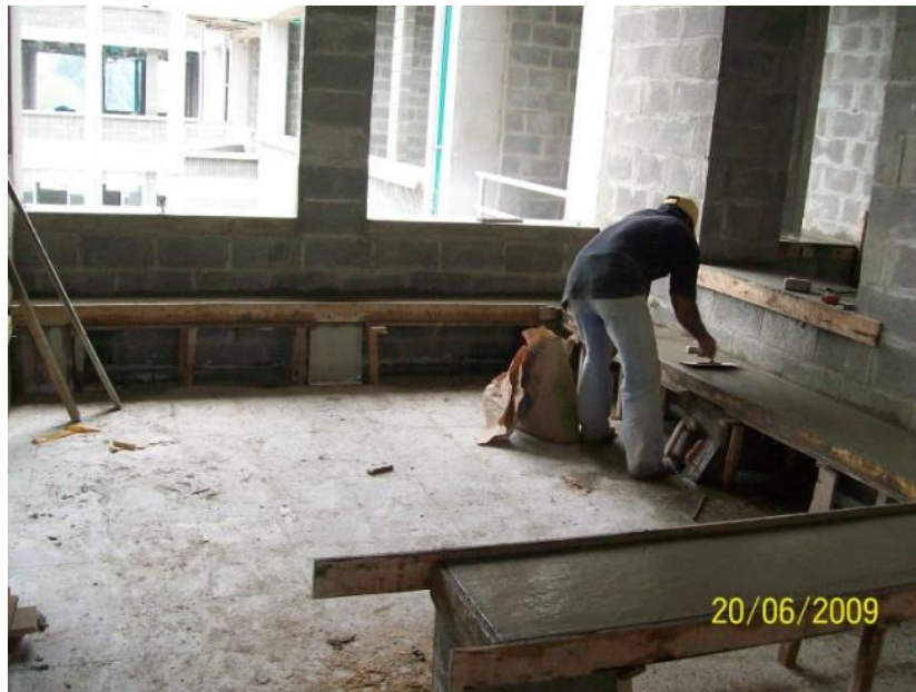
Ilustración 111, Banca ya fundida, nótese las patas en bloque liso.
