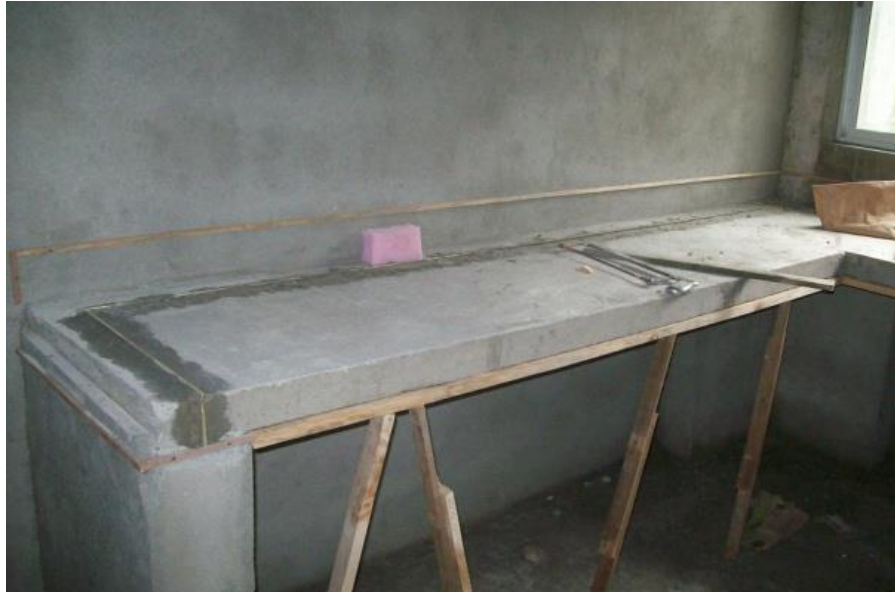
Ilustración 32, Pega de dilatación en bronce antes de aplicar la mezcla de granito, también se puede ver formaleta que recibirá el recubrimiento
