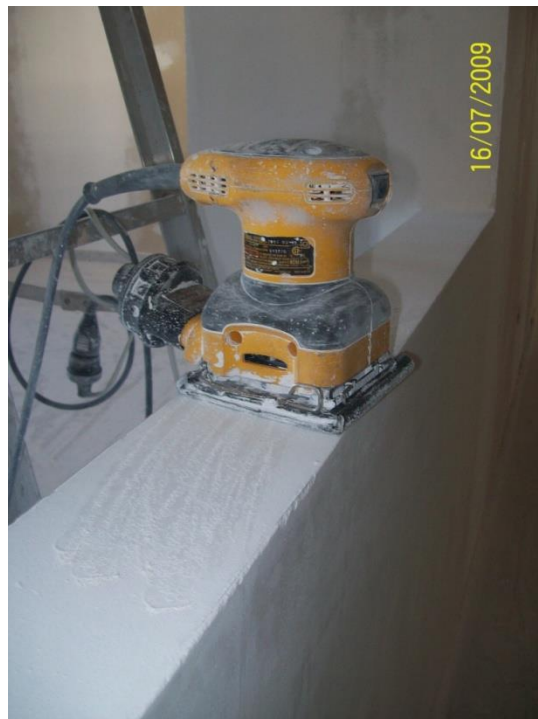
Ilustración 25, lijadora usada en el perfeccionamiento de los muros.
