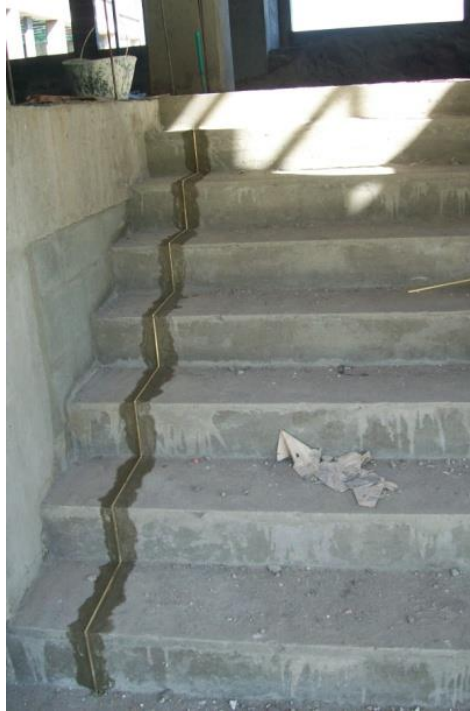
Ilustración 49, Dilataciones en bronce ya pegadas a las gradas.
