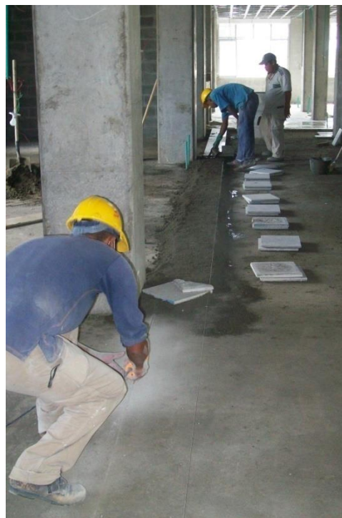
Ilustración 39, Proceso de extensión del mortero para una hilada de distribución.
