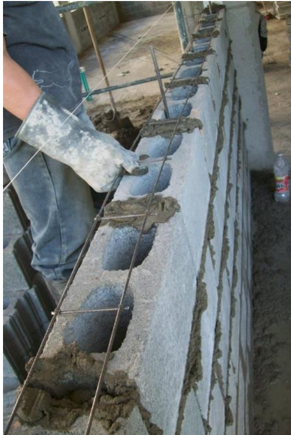
Ilustración 5, Detalle de la parrilla horizontal entre hiladas, nótese las camas de adhesión.
