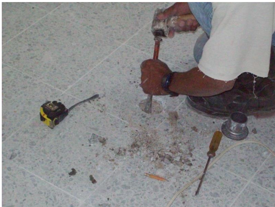
Ilustración 78, Sifón obstruido en proceso de localización.
