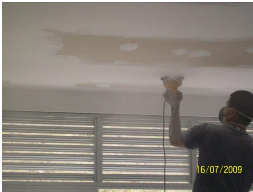
Ilustración 84, Proceso de lijado del cielo falso.
