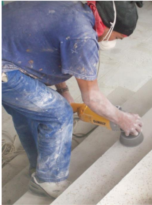
Ilustración 53, Gradas en proceso de pulida con disco de esmeril.
