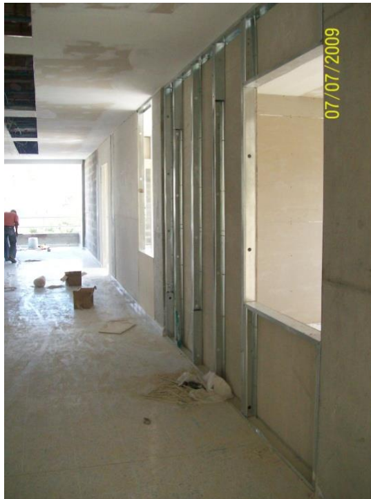
Ilustración 17, Placas de un lado del muro ya instaladas sobre la perfilería.
