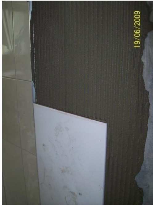
Ilustración 62, Detalle de pasta de cemento usada para adherir el enchape.
