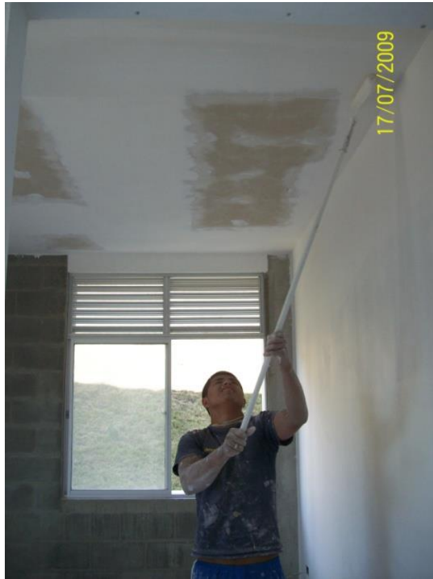
Ilustración 85, Cielo falso siendo pintado.
