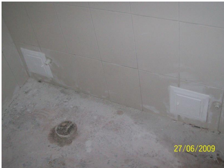
Ilustración 75, Tapas de registro ya instaladas.
