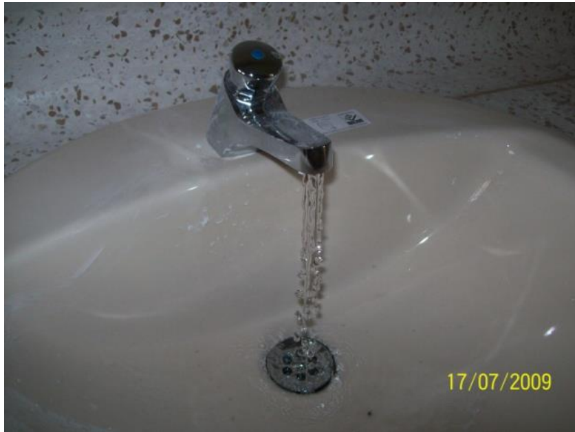
Ilustración 93, Grifo GRIVAL ya funcionando.
