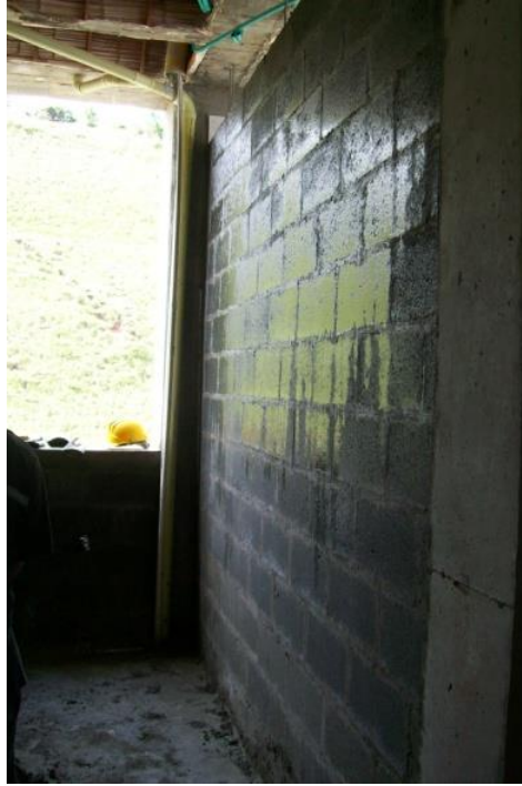
Ilustración 56, Muro humedecido para recibir pañete.
