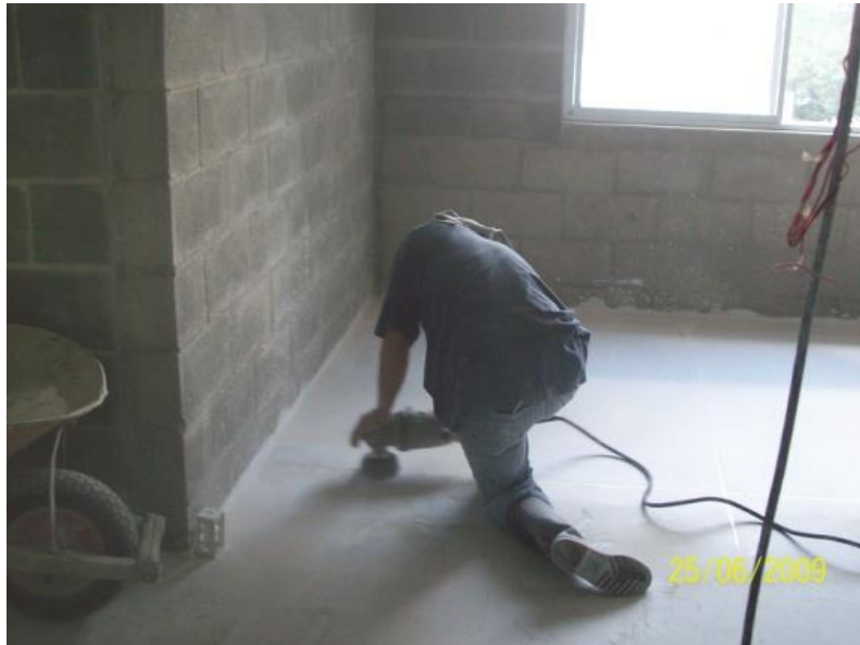
Ilustración 46, Proceso de pulida después de destronado.
