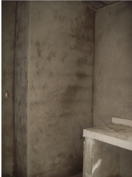
Ilustración 58, Mortero ya aplicado y curado.
