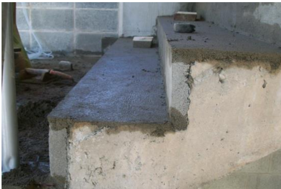
Ilustración 14, Acercamiento del mortero ya aplicado con grosor aproximado a 4 cm.
