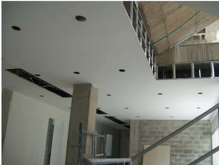
Ilustración 86, Cielo falso ya pintado y con las aberturas de las lámparas.
