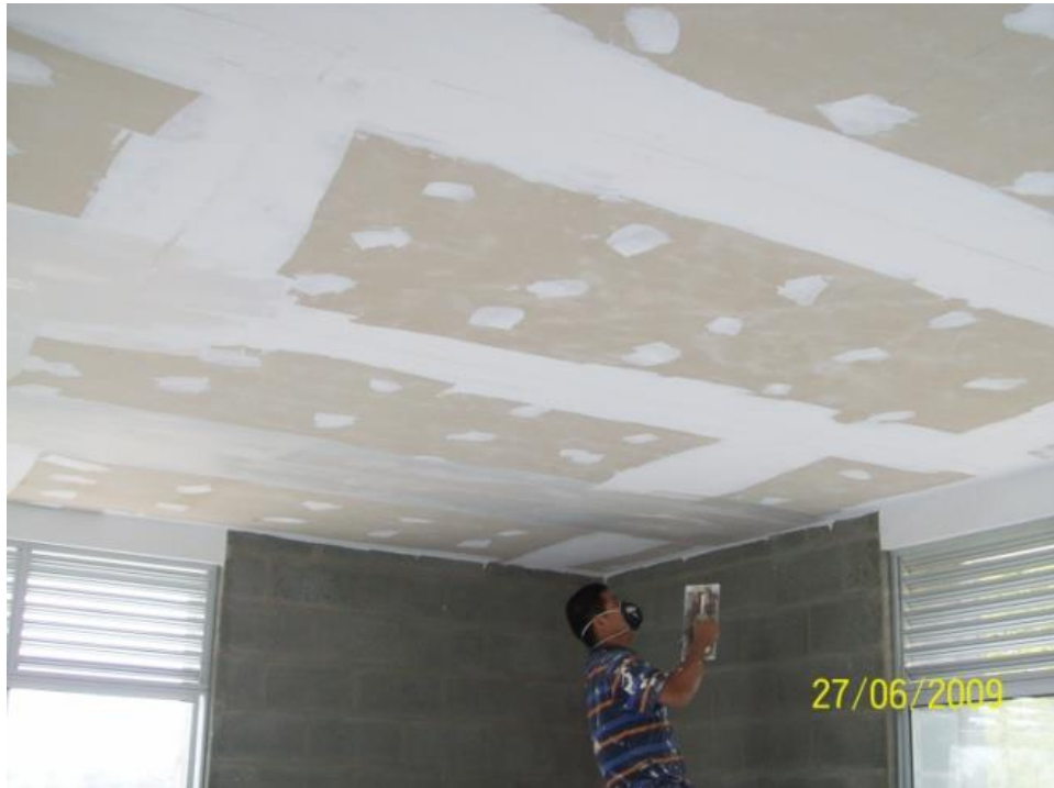
Ilustración 83, Cielo estucado.
