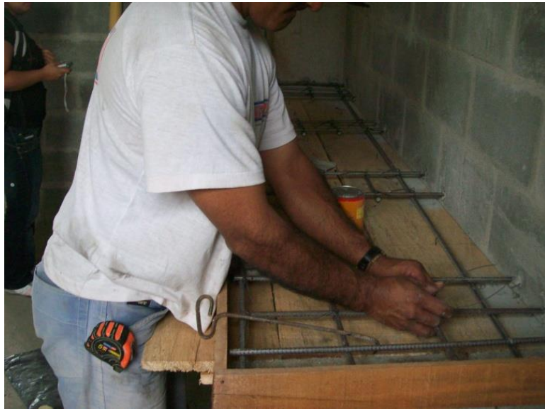
Ilustración 30, Armado y anclaje de las parrillas de acero de refuerzo para los mesones en concreto.
