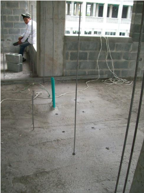
Ilustración 4, Detalle de las los anclajes ya instalados en las perforaciones de la losa.
