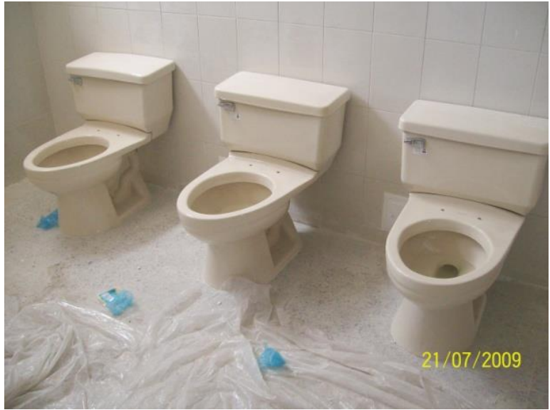
Ilustración 95, Sanitarios instalados y funcionando
