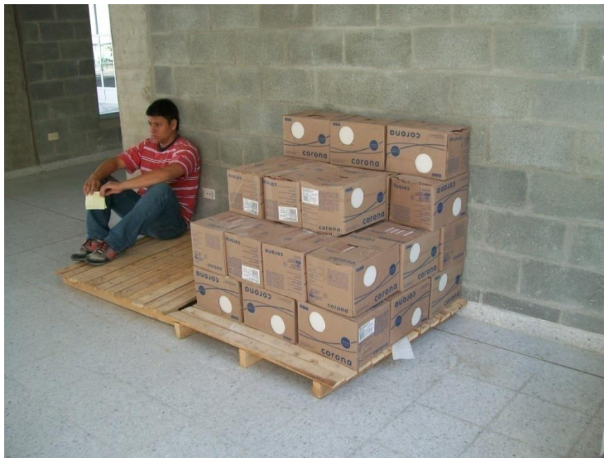
Ilustración 59, Tabletas para enchape suministradas, nótese que están en sentido vertical.
