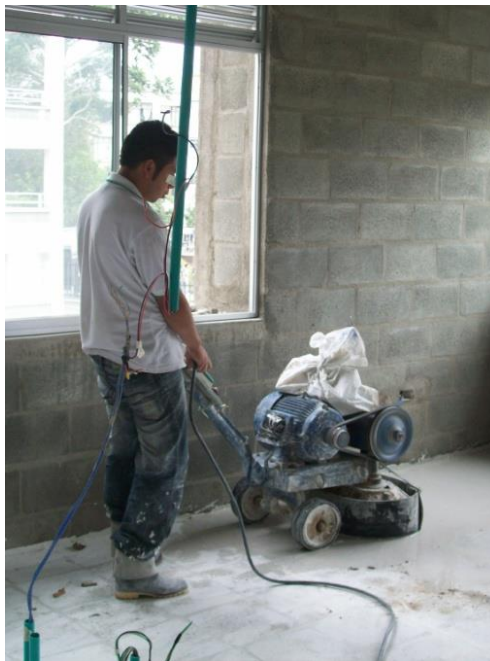
Ilustración 45, Destroncadora funcionando.
