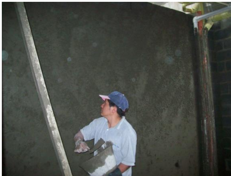
Ilustración 57, Aplicación de mortero.
