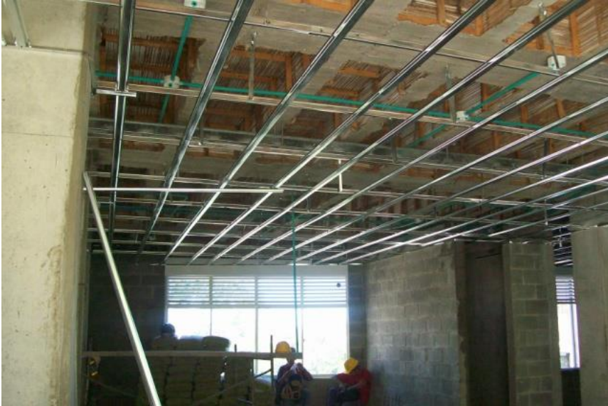
Ilustración 80, Esqueleteado en perfilera de aluminio galvanizado.
