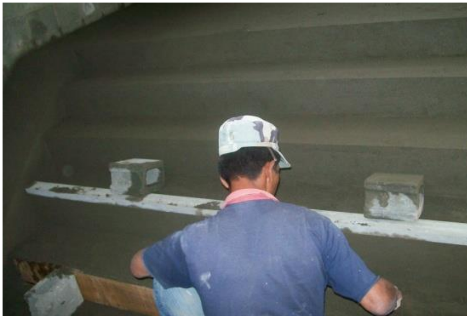
Ilustración 13, Proceso de nivelación de gradas.
