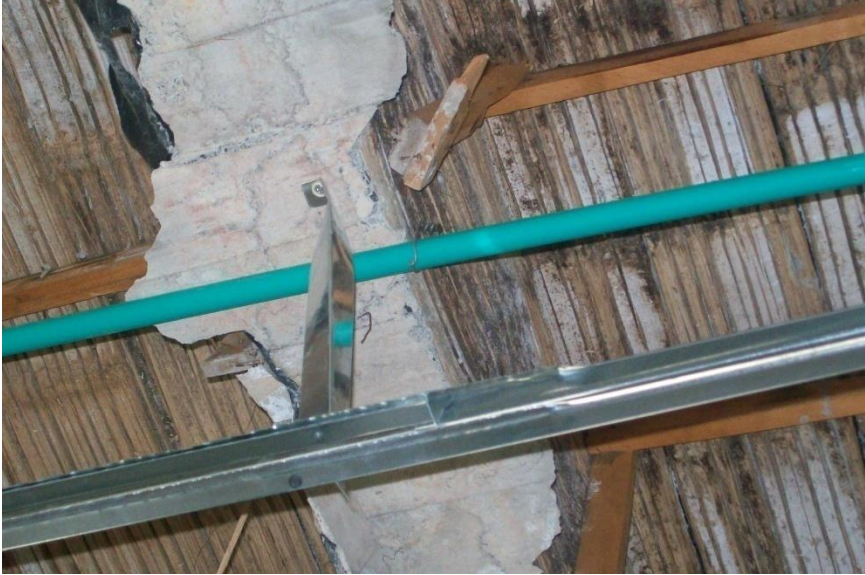
Ilustración 79, Cuelga rígida usada para sostener el esqueleteado.
