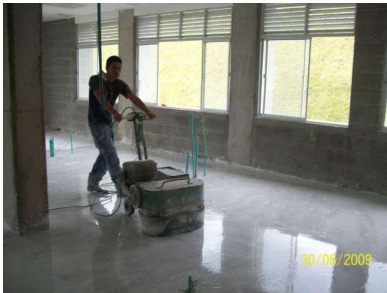
Ilustración 47, proceso de pulida con acido.
