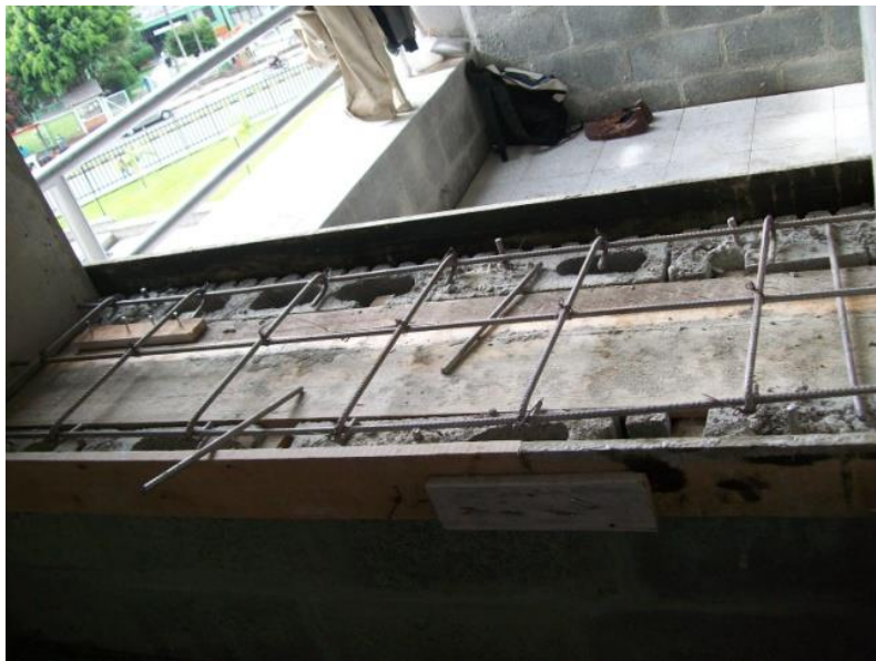
Ilustración 12, Detalle de los aceros antes de fundir un alfaja
