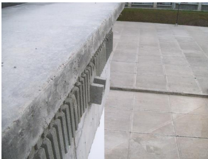
Ilustración 69, Gárgolas ya terminadas, lado exterior.
