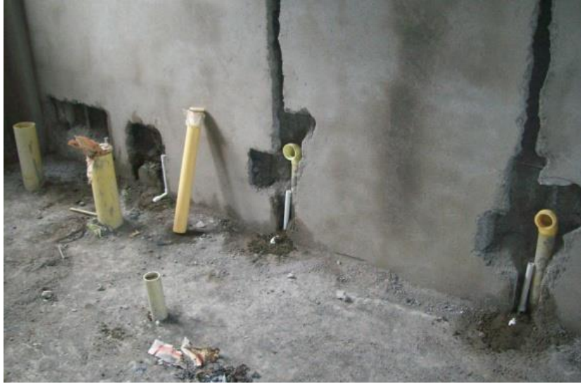
Ilustración 70, Puntos hidráulicos y regateos hechos para instalaciones hidráulicas y sanitarias.
