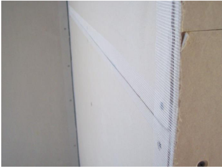
Ilustración 20, Acercamiento de la cinta malla colocada en las uniones de las láminas.
