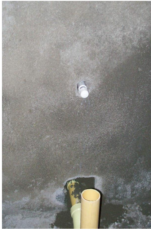
Ilustración 72, Punto ya terminado, obsérvese el tapón instalado.
