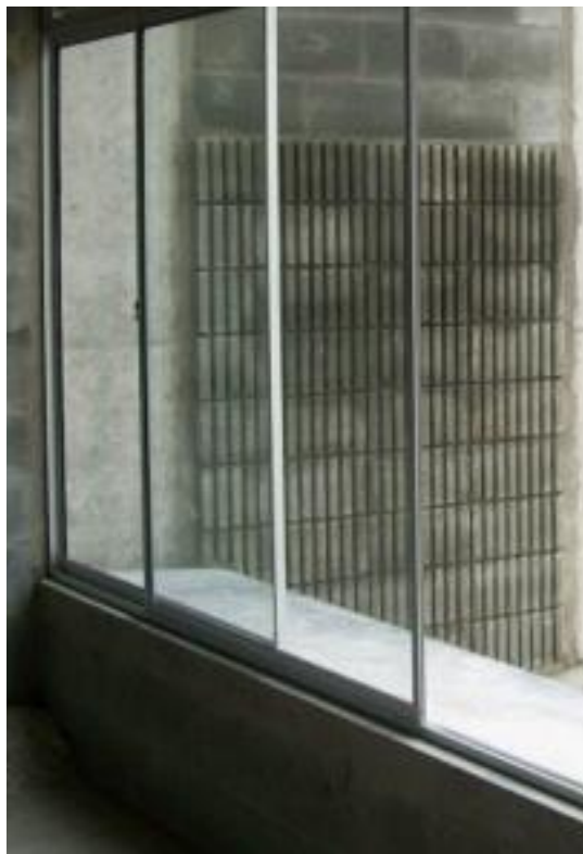
Ilustración 10, Muro exterior en bloque acanalado, obsérvese las líneas que forman las estrías
