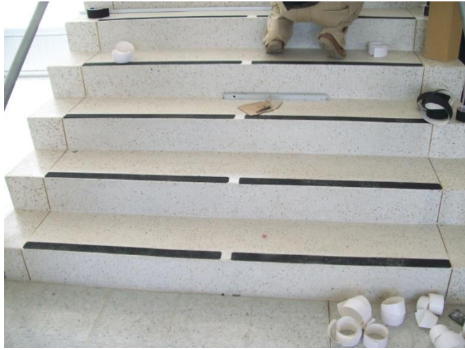
Ilustración 55, Gradadas con cinta anti resbalante.
