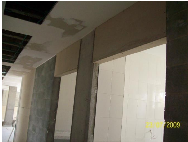
Ilustración 27, Dinteles hechos en lámina de superboard.
