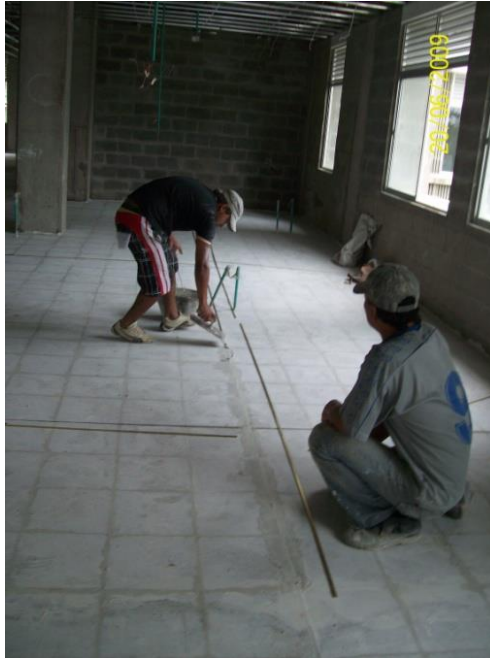
Ilustración 44, Proceso de pega de dilataciones en bronce.
