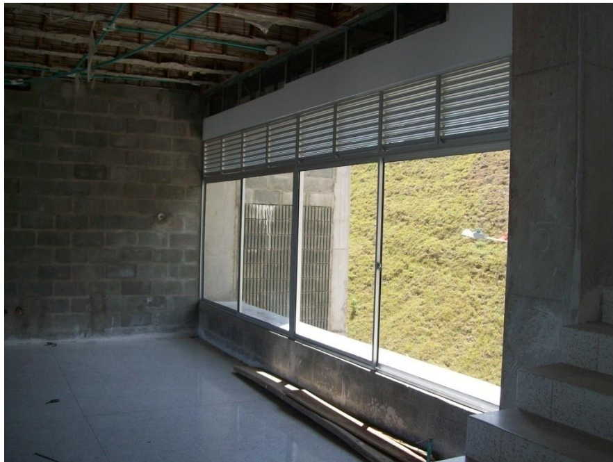
Ilustración 104, Ventana ya terminada.
