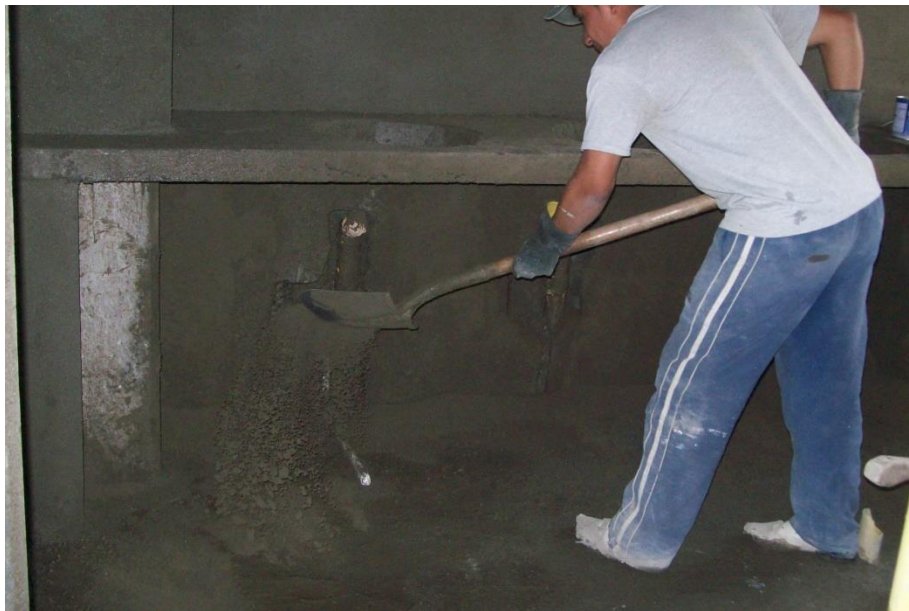
Ilustración 73, Proceso de sellado del los regateos con mortero de revoque.
