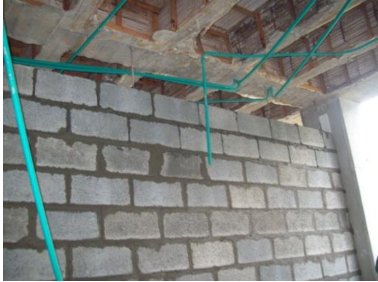
Ilustración 7, Muro ya terminado, nótense los anclajes en la losa superior.
