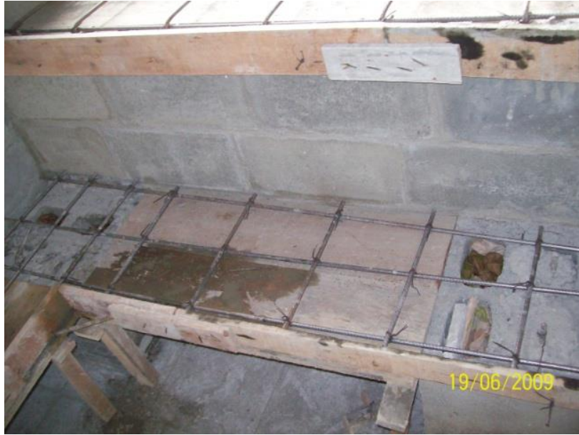
Ilustración 110, Parrilla armada y anclada.
