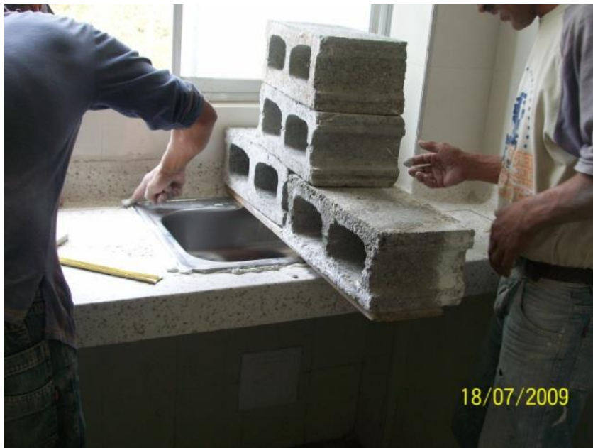
Ilustración 94, Instalación de lavaplatos.
