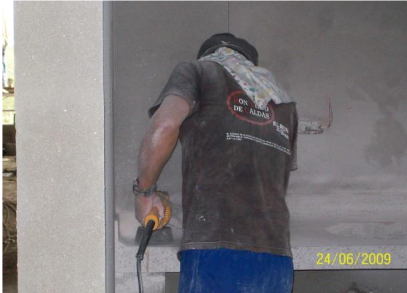
Ilustración 34, Proceso de pulida de mesón con disco de esmeril.
