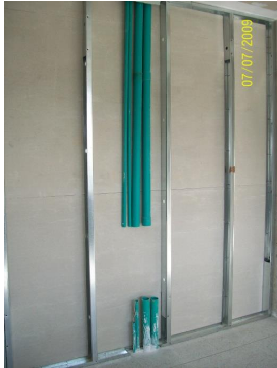
Ilustración 18, Detalle de algunas instalaciones eléctricas contenidas en medio del muro.
