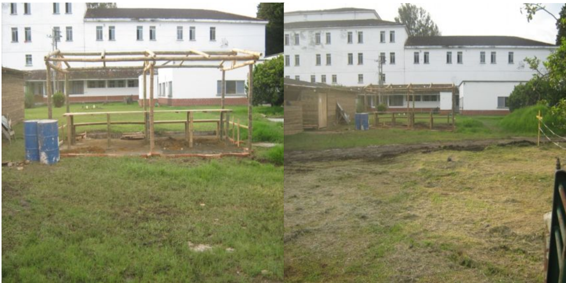
Fotografías 81 y 82 – Construcción de campamentos para los obreros.
