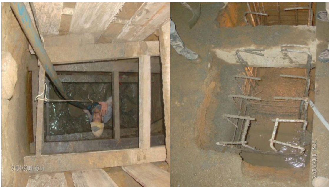
Fotografías 97 y 98 - Barretes en concreto.
