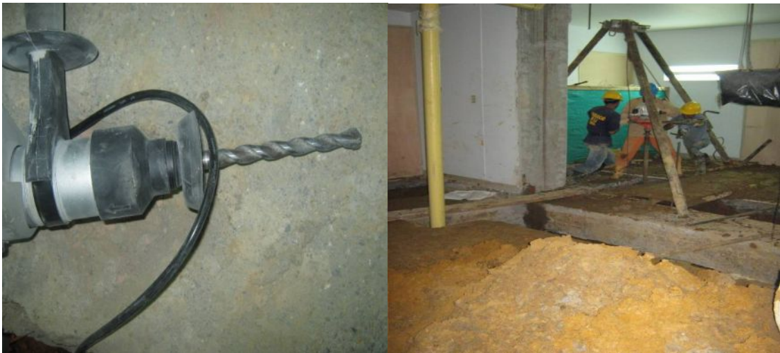
Fotografías 71 y 72 - Broca de Tungsteno y Trípode para soporte de barrenos.
