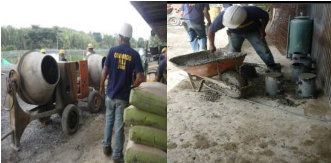
Fotografía 15 y 16 - Elaboración de cilindros para ensayos de laboratorio.
