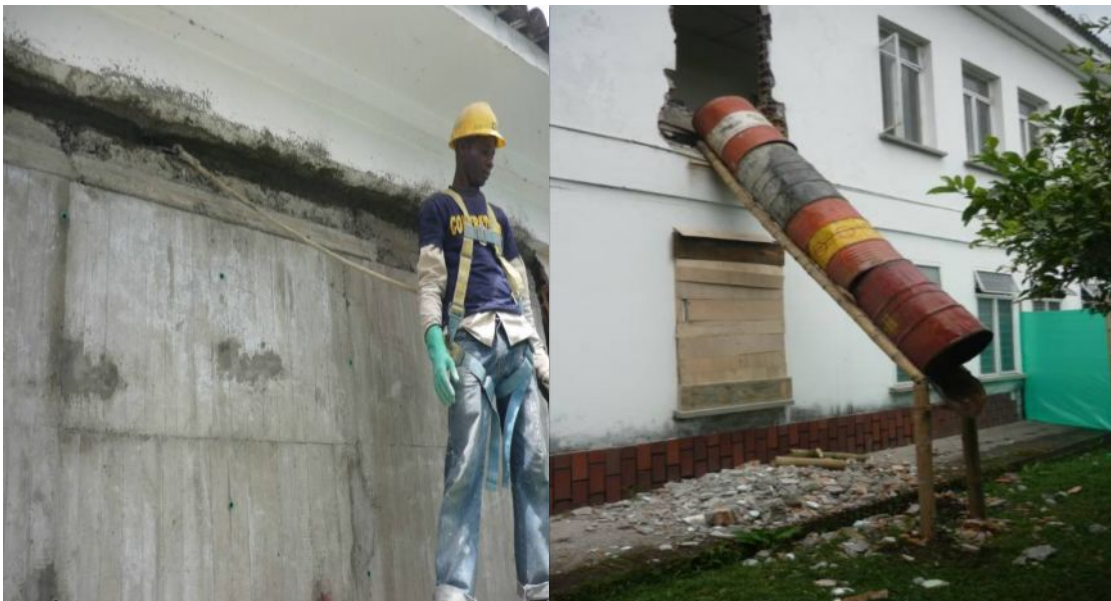
Fotografías 79 y 80 – Arnés, línea de vida y Shutt para evacuación de escombros.
