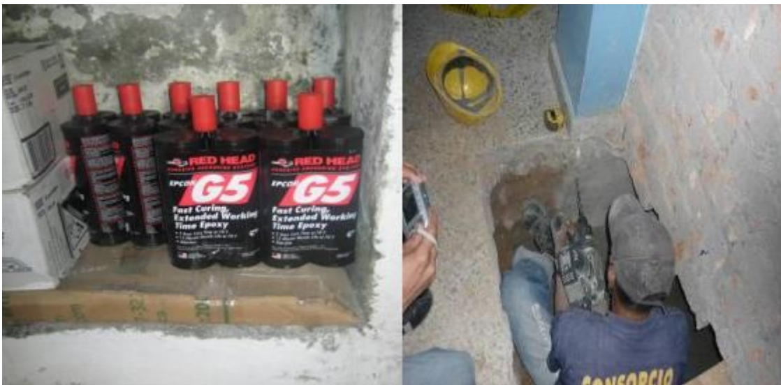
Fotografías 31 y 32 – Tipo de epóxico utilizado en obra.
