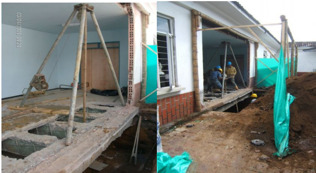
Fotografías 89 y 90 – Perforación manual para pilotes con barreno helicoidal.
