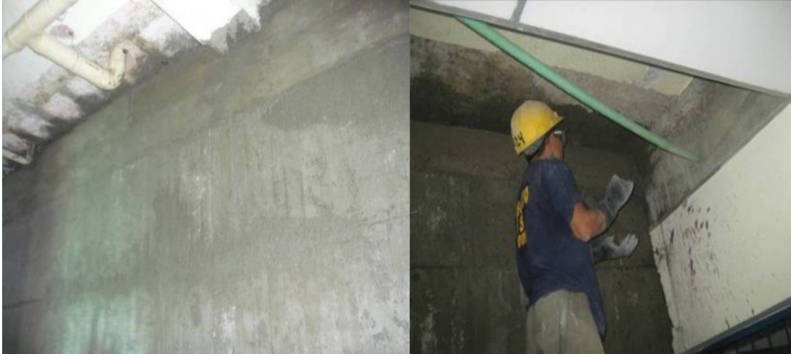
Fotografías 113 y 114 – Remate de las pantallas con concreto Dry Pack.
