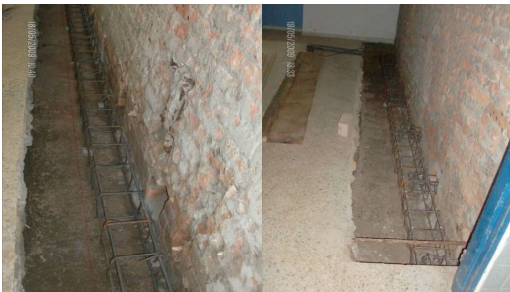
Fotografías 115 y 116 – Cimentación sector 2.
