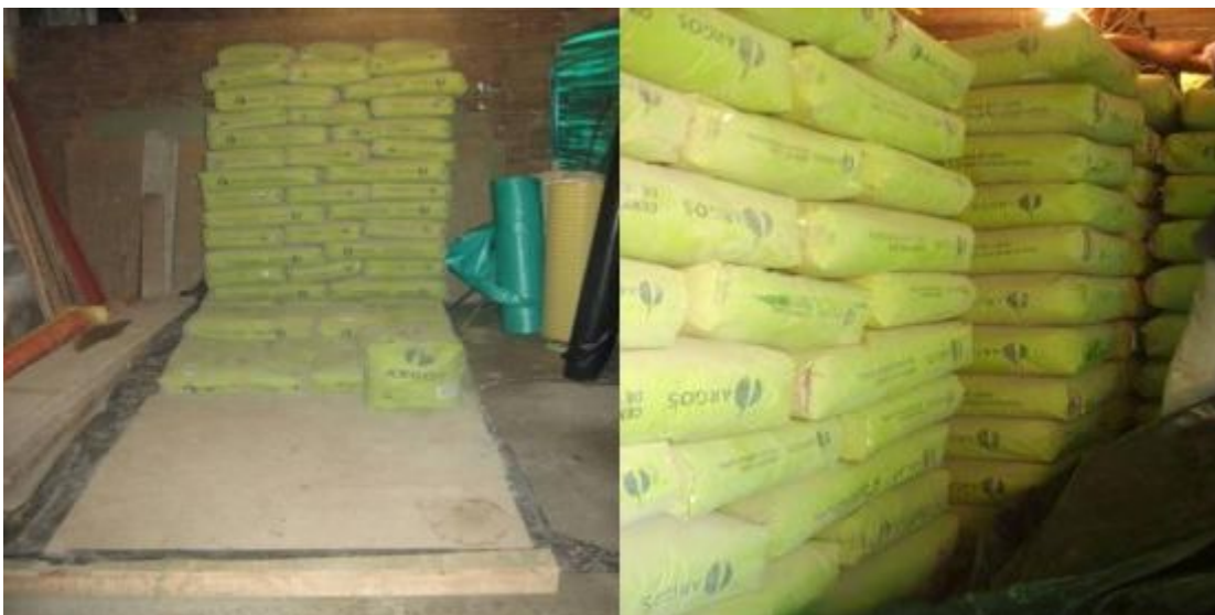
Fotografías 5 y 6 – Almacenamiento del cemento estructural.
