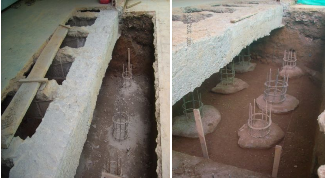
Fotografías 99 y 100 - Vista de pilotes fundidos.
