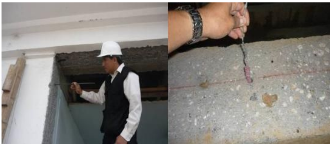
Fotografías 27 y 28 – Limpieza y revisión de profundidades de anclaje.
