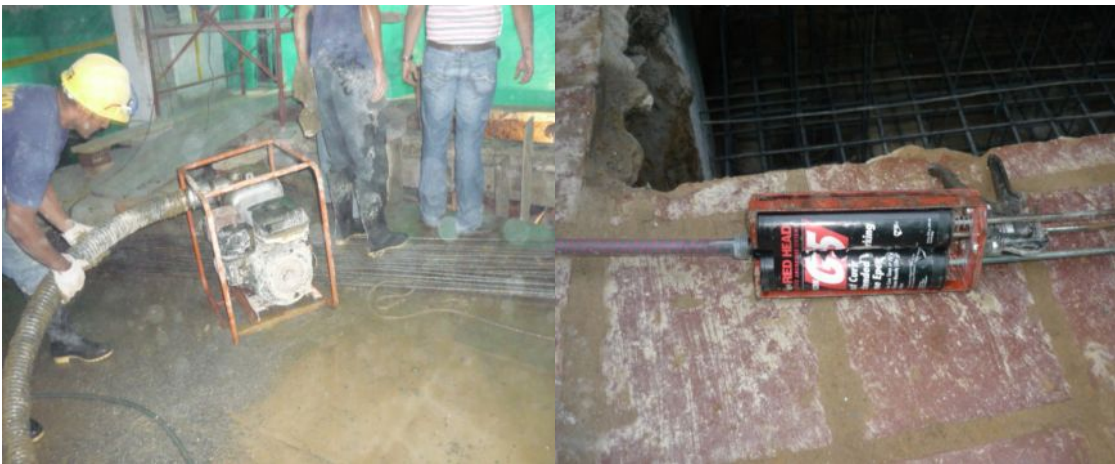
Fotografías 67 y 68 – Motobomba y Pistola para inyección de epóxico.
