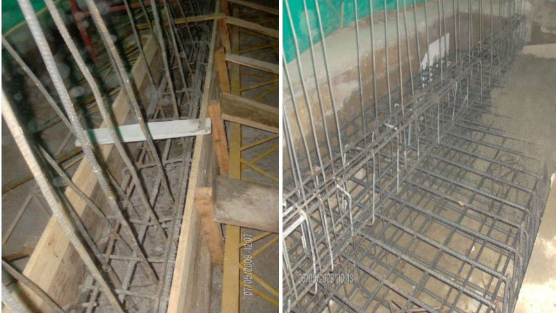
Fotografías 105 y 106 - Control de longitud de desarrollo del acero para construcción de pantallas.
