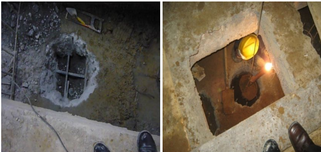
Fotografías 101 y 102 - Perforación de zapata existente para pilotaje.
