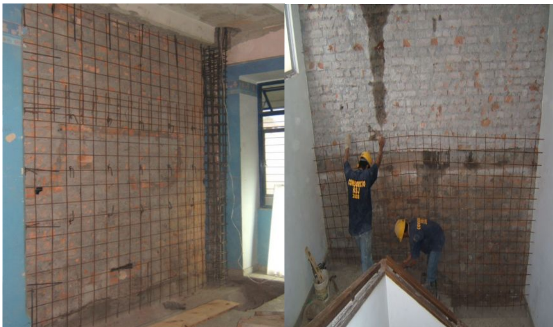
Fotografías 125 y 126 – Acero de refuerzo para repello estructural.
