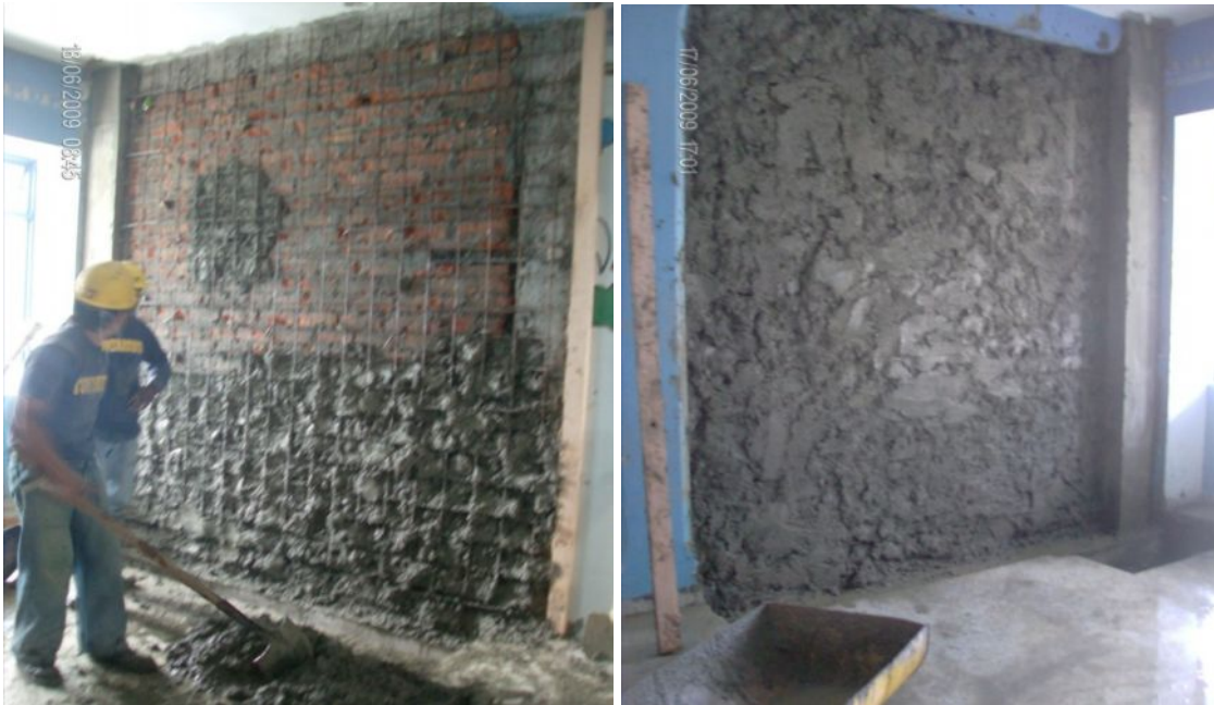
Fotografías 129 y 130 – repello estructural.
