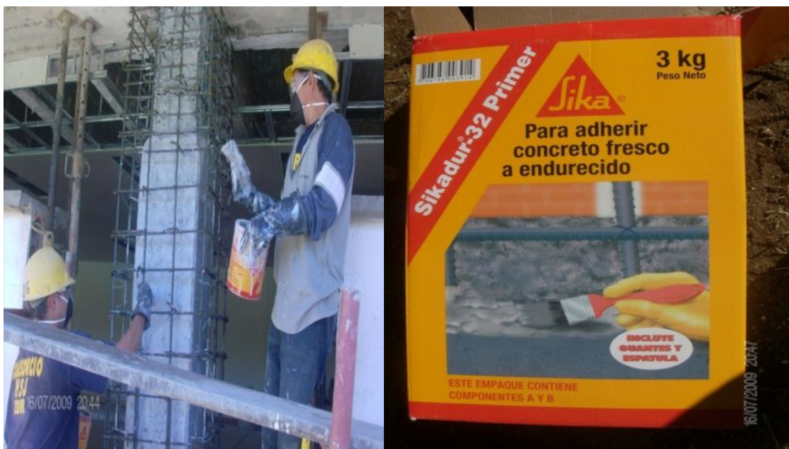
Fotografías 139 y 140 – impregnado de Sikadur-32.
