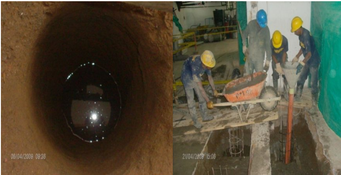
Fotografías 95 y 96 - Fundición de pilotes por el sistema tremie.
