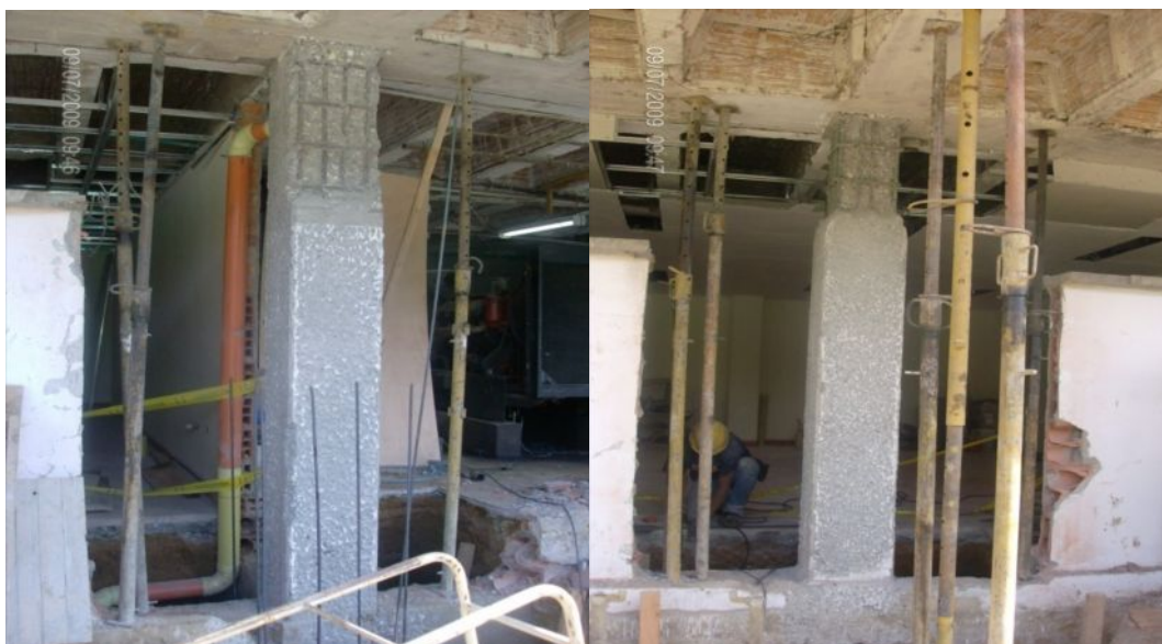
Fotografías 137 y 138 – Alzaprimado de losa existente, sector 11.
