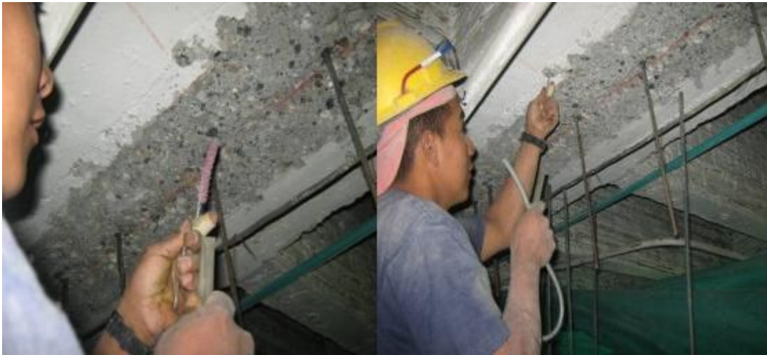
Fotografías 29 y 30 – Limpieza y revisión de profundidades de anclaje.
