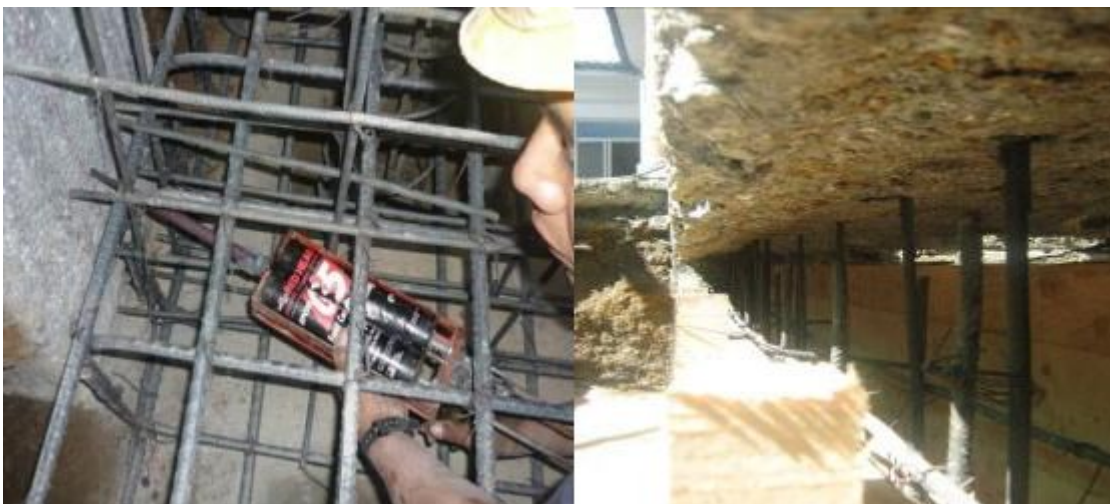
Fotografías 25 y 26 – Anclajes estructurales.
