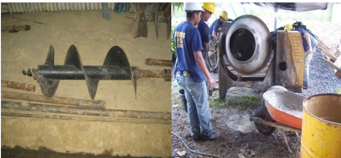
Fotografías 59 y 60 - Barreno helicoidal y Mezcladora mecánica.
