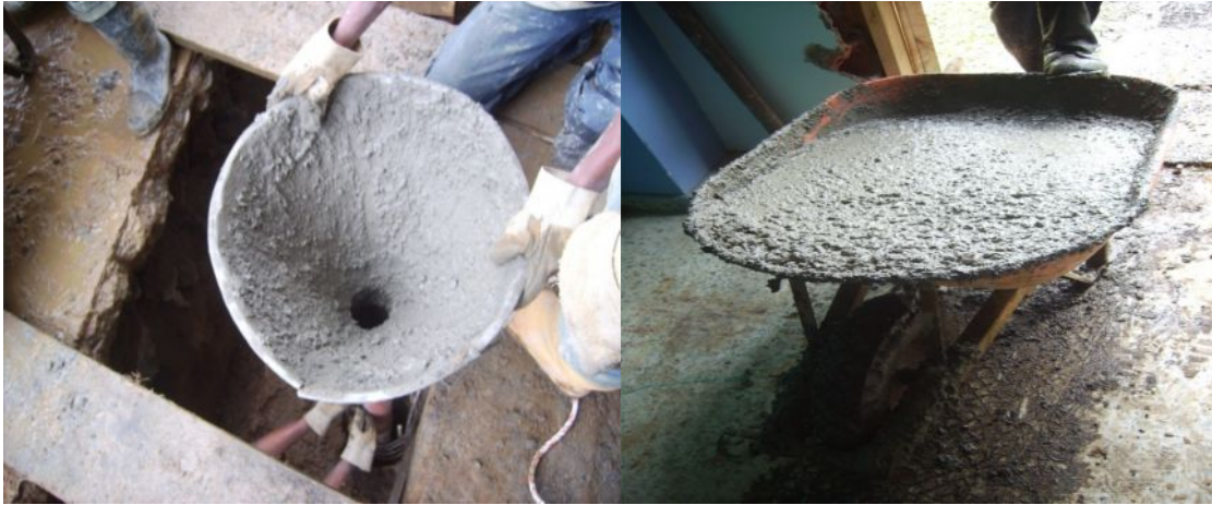
Fotografías 61 y 62 - Embudo para fundición de pilotes y Carreta para transporte de concreto.
