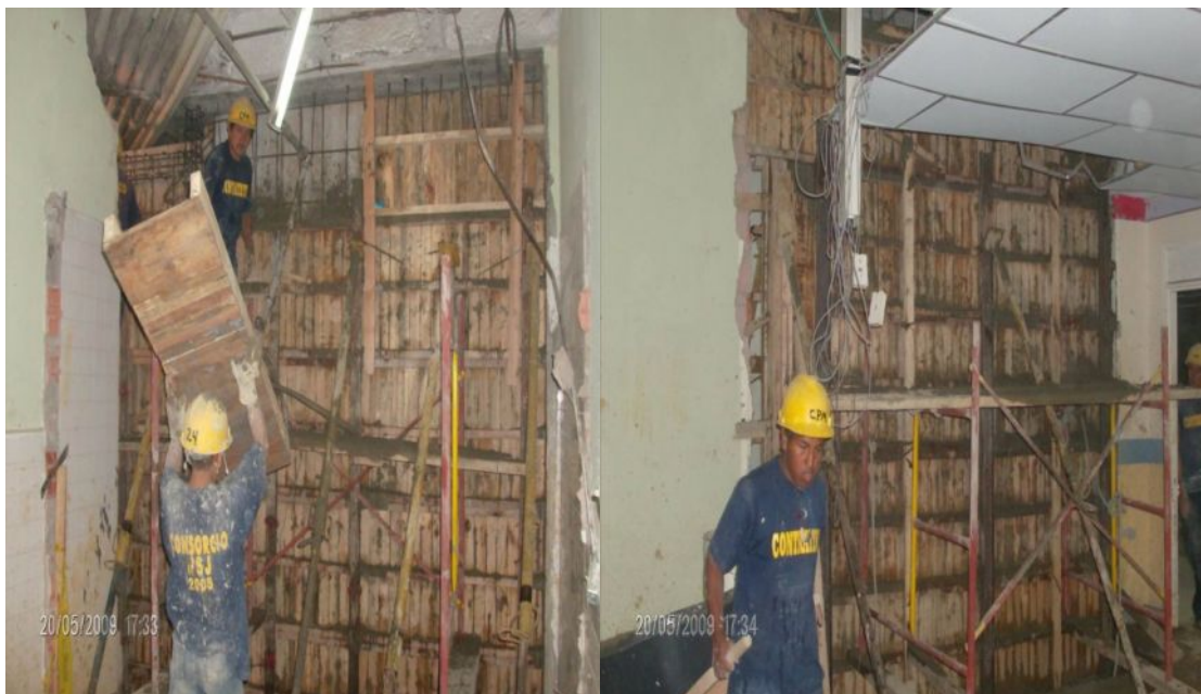
Fotografías 107 y 108 – Revisión de formaleta y plomado de pantallas de concreto.
