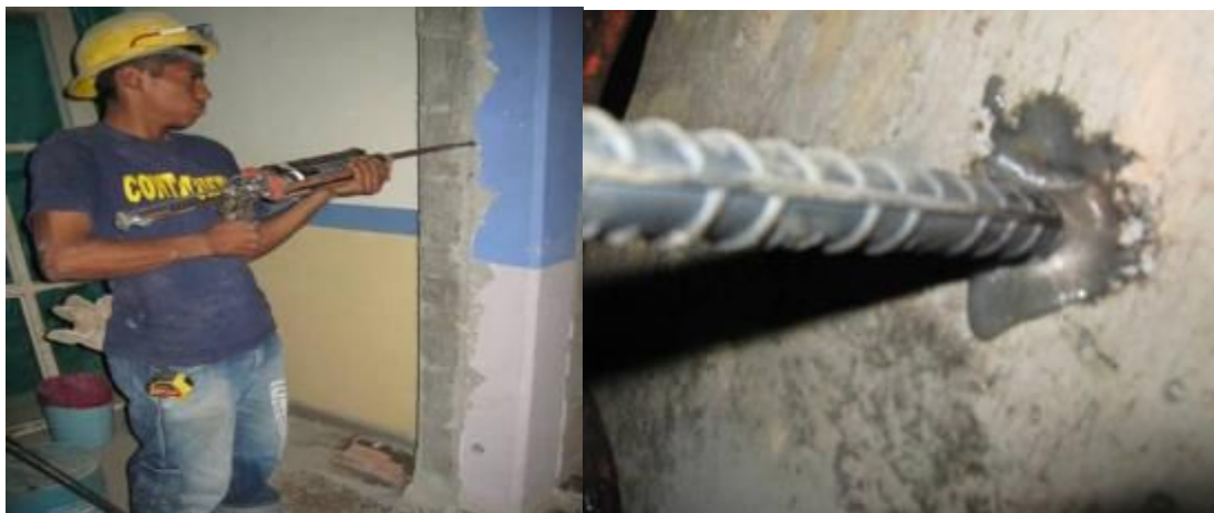
Fotografías 33 y 34 – Elaboración de anclaje estructural.
