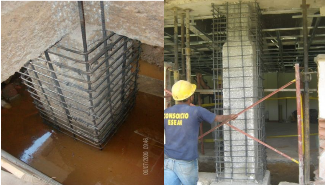
Fotografías 141 y 142 – Revisión del acero de refuerzo para encamisado de columnas del sector 11.
