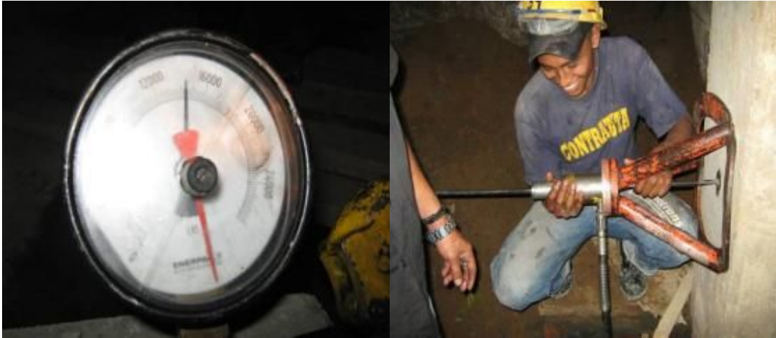
Fotografías 37 y 38 – Prueba de extracción a tensión directa.
