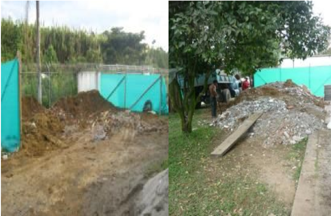
Fotografías 45 y 46 – Evacuación de escombros.
