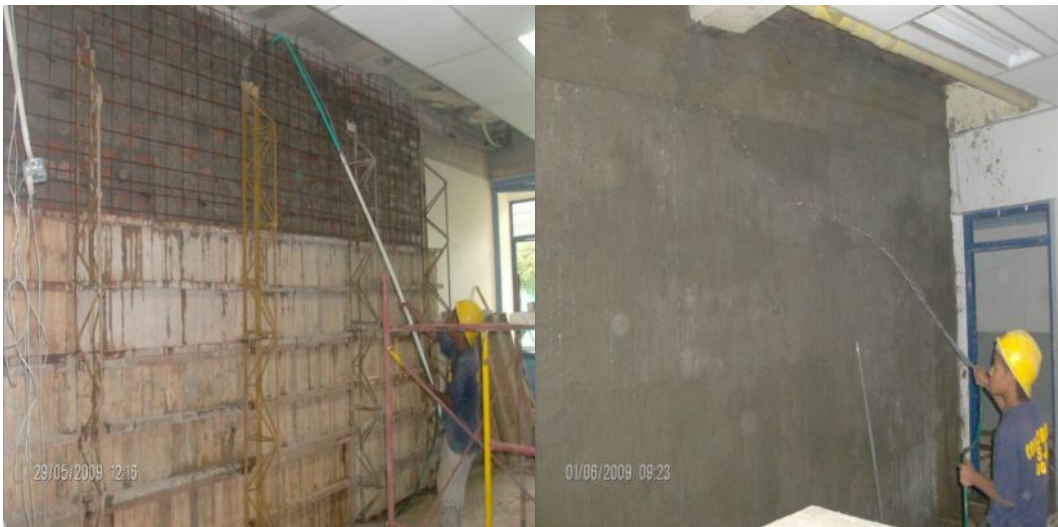
Fotografías 127 y 128 – Curado de pantallas de concreto.
