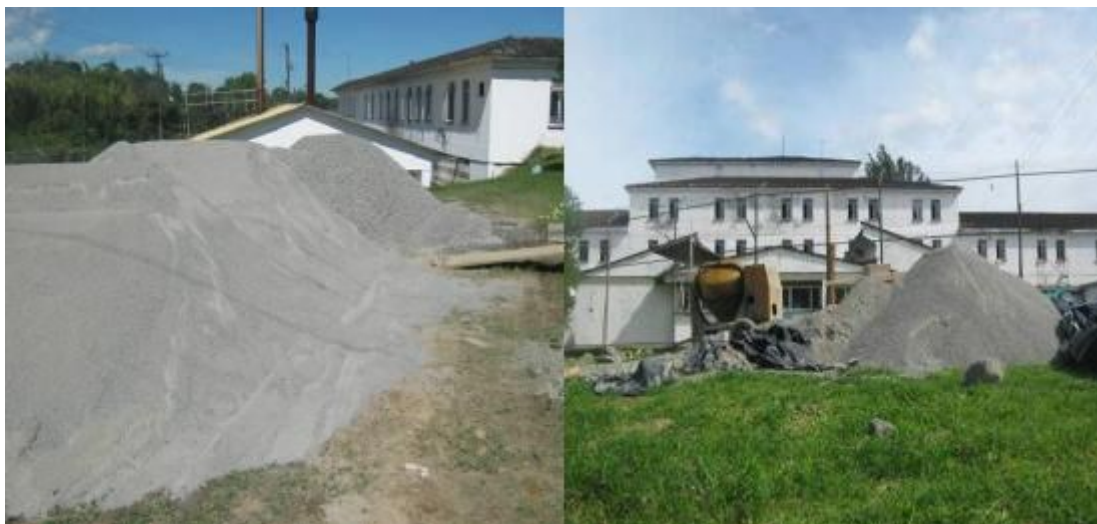
Fotografías 1 y 2 - Acopio del material granular.
