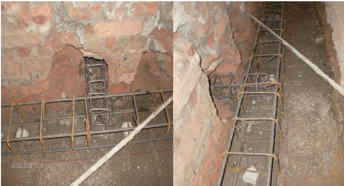
Fotografías 117 y 118 – Pasador para cimentación sector 2.
