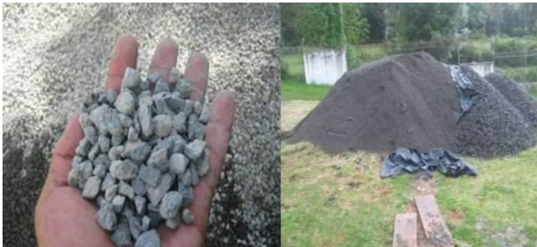
Fotografías 3 y 4 – Materia granular pantallas de concreto.
