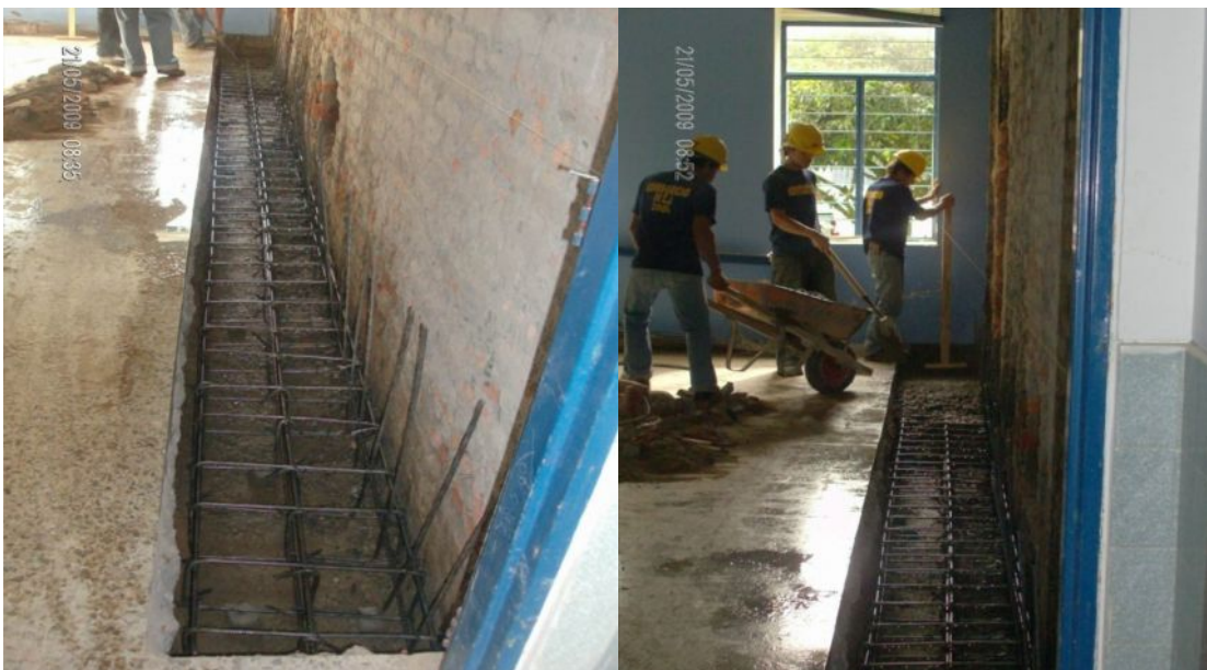
Fotografías 119 y 120 – Viga de cimentación sector 2.
