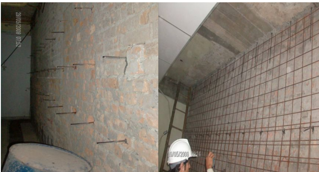
Fotografías 123 y 124 – Pasadores para refuerzo del repello estructural.
