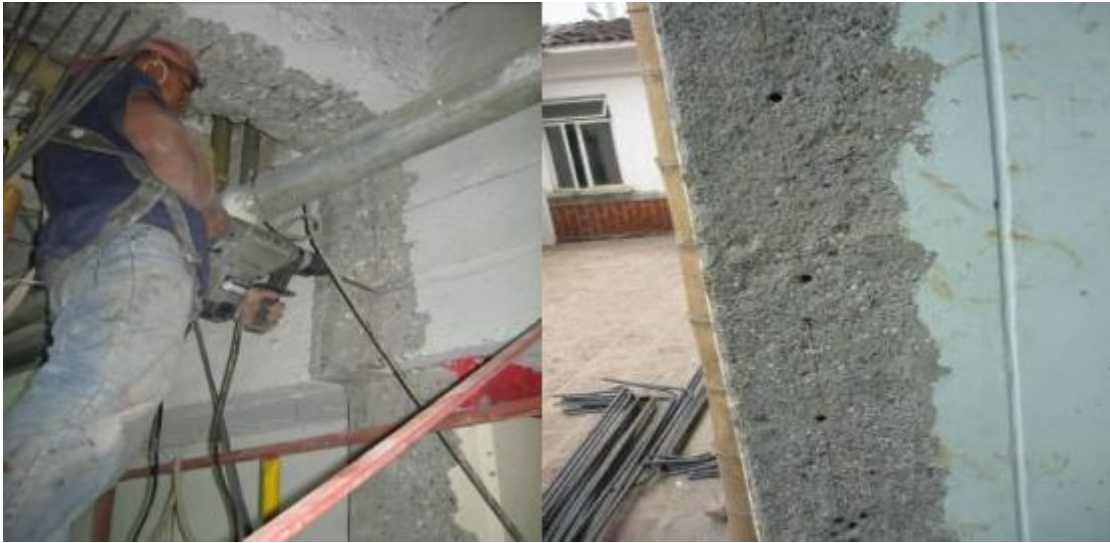
Fotografías 23 y 24 – Perforación para anclajes.
