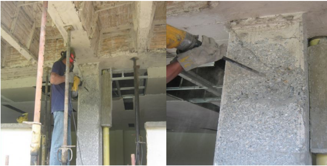
Fotografías 133 y 134 – Revisión núcleo de columnas sector 11.
