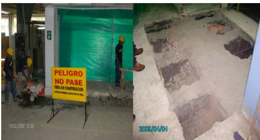
Fotografías 87 y 88 – Demolición de piso y contra piso.
