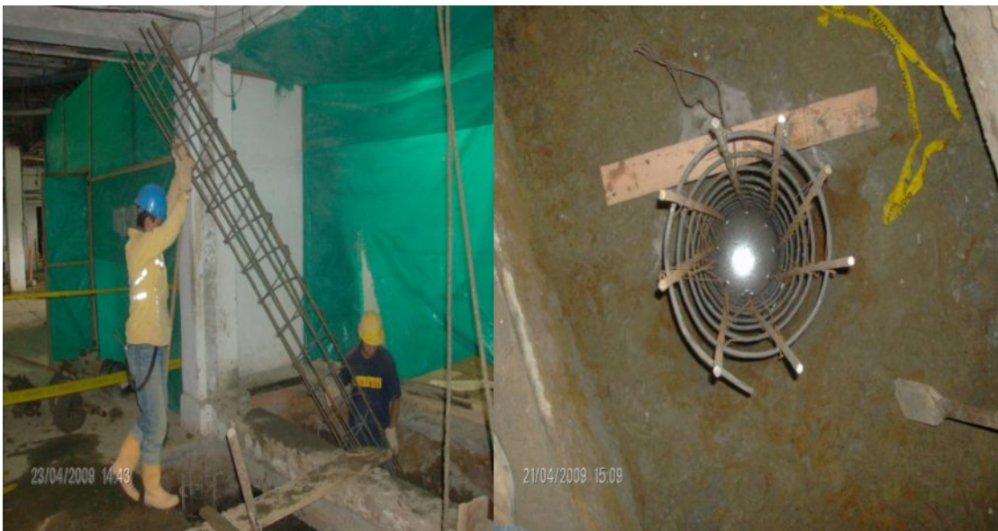
Fotografías 93 y 94 – Revisión de acero para pilotaje.
