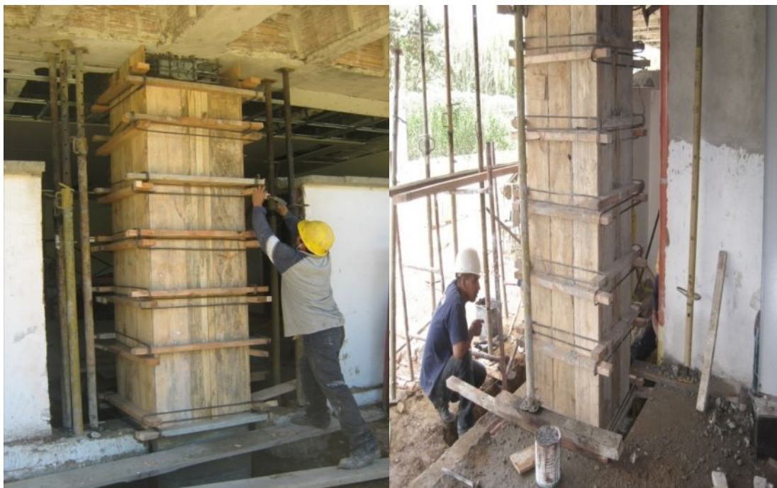
Fotografías 143 y 144 – Encofrado de columnas para encamisado.
