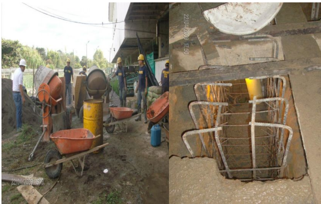
Fotografías 93 y 94 - Fundición de pilotes y barretes de concreto.
