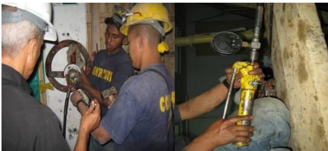
Fotografías 35 y 36 – Prueba de extracción a tensión directa.
