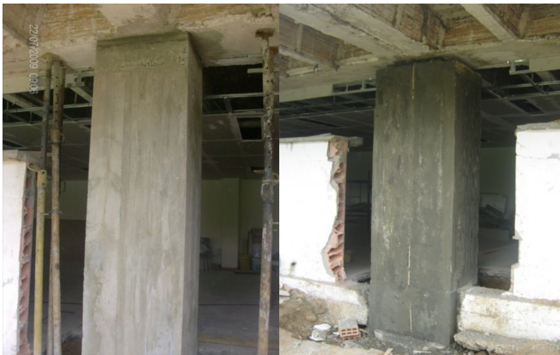
Fotografías 145 y 146 –Columnas encamisadas en el sector 11.
