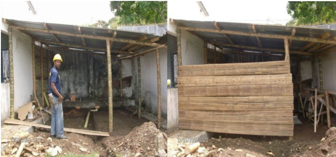
Fotografías 83 y 84 – Baños para personal de obra.
