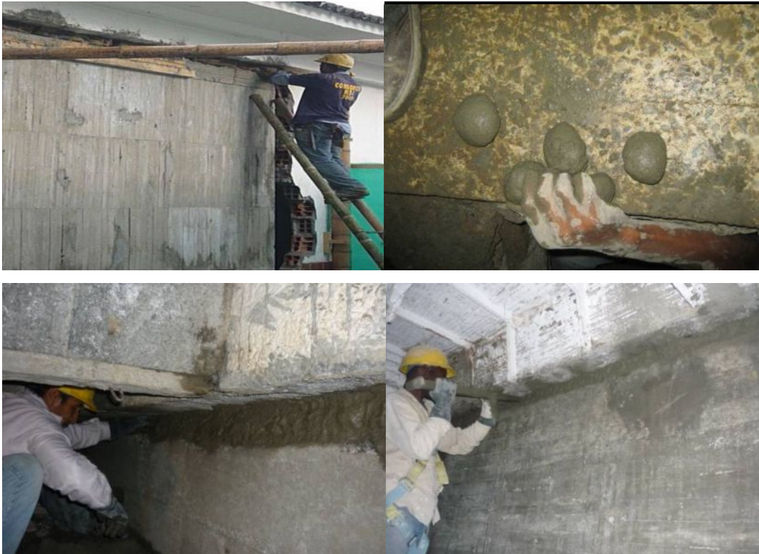
Fotografías 109, 1110, 111, 112 – Concreto Dry Pack.
