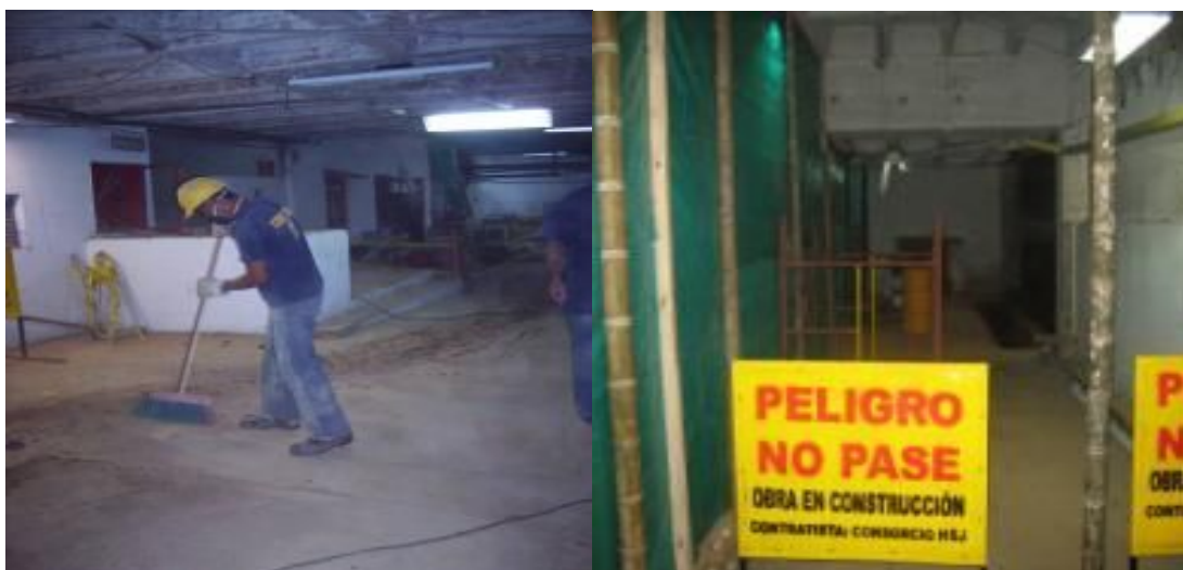
Fotografías 47 y 48 – Limpieza de obra.
