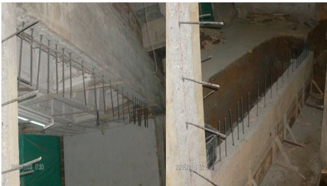
Fotografías 107 y 108 – Revisión de la distribución y separación de anclajes para construcción de pantallas de concreto
