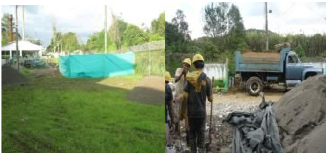
Fotografías 43 y 44 – Acopio y disposición de escombros.
