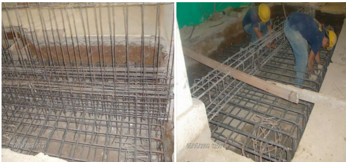
Fotografías 103 y 104 - Revisión de acero para zapatas nuevas.
