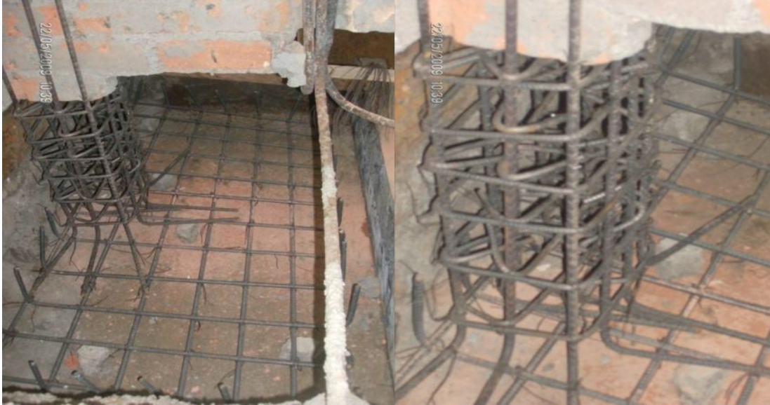
Fotografías 121 y 122 – Revisión de acero para zapata y arranque de columna nueva, sector 2.
