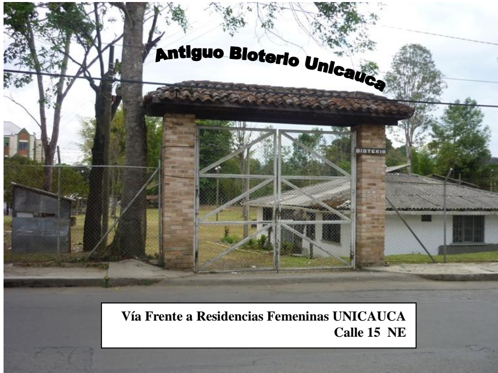
Fotografía 1: Entrada al lugar de ubicación del proyecto
