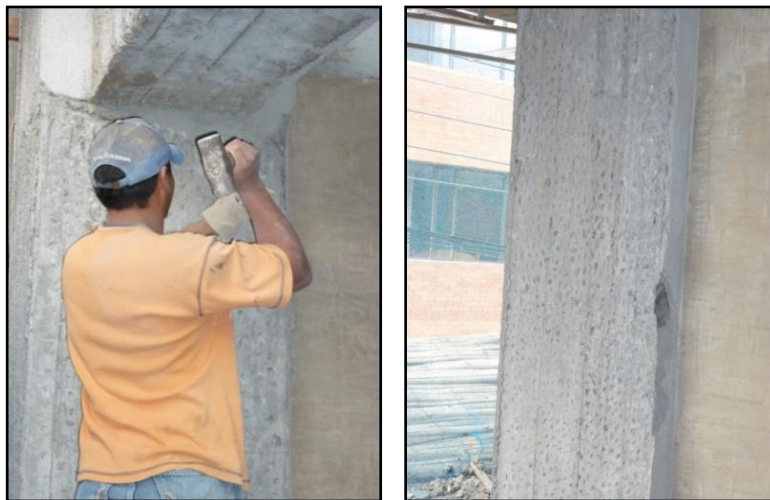
Ilustración 57. Picado de columnas para garantizar mayor adherencia repello
