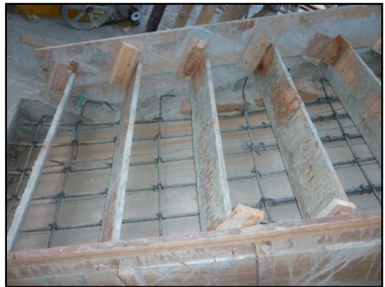
Ilustración 60. Formaleta y distribución acero grada
