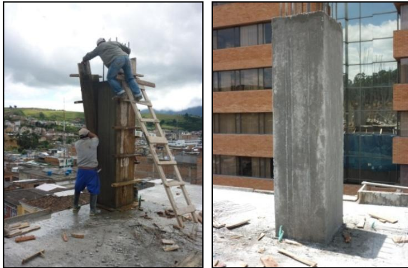
Ilustración 19. Desencofrado columna
