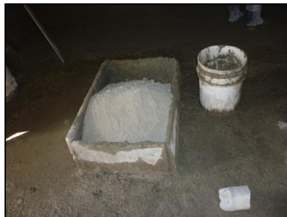
Ilustración 50. Mezcla de mortero
