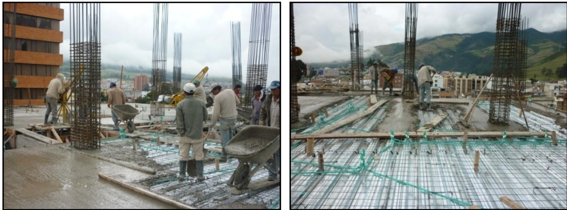
Ilustración 43. Vaciado del concreto
