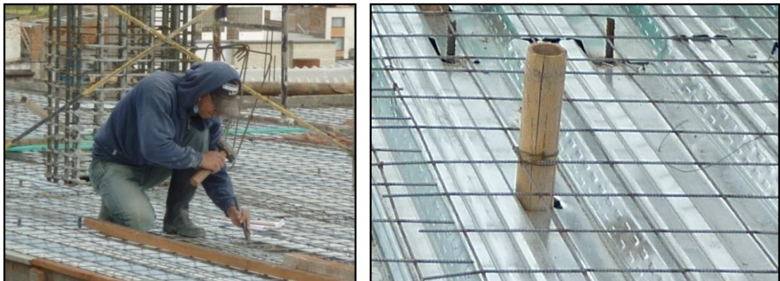
Ilustración 41. Perforaciones en la lámina para tubería sanitaria
