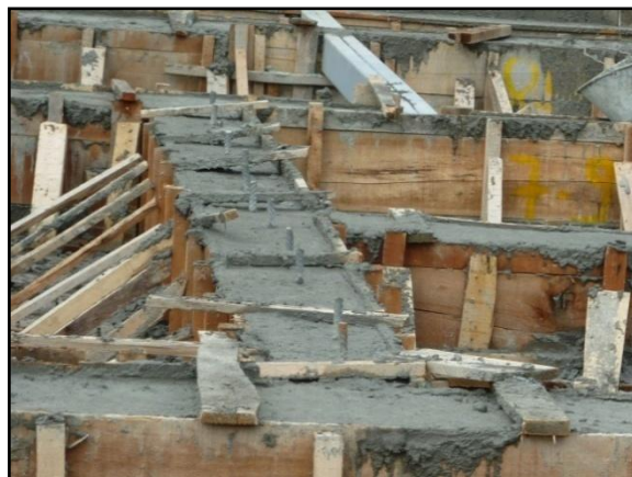
Ilustración 33. Instalación de conectores de cortante
