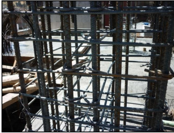
Ilustración 11. Disposición de ganchos y flejes
