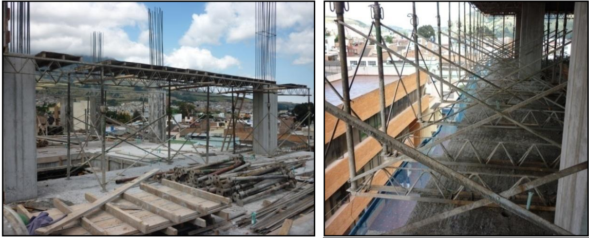
Ilustración 22. Formaleta vigas aéreas
