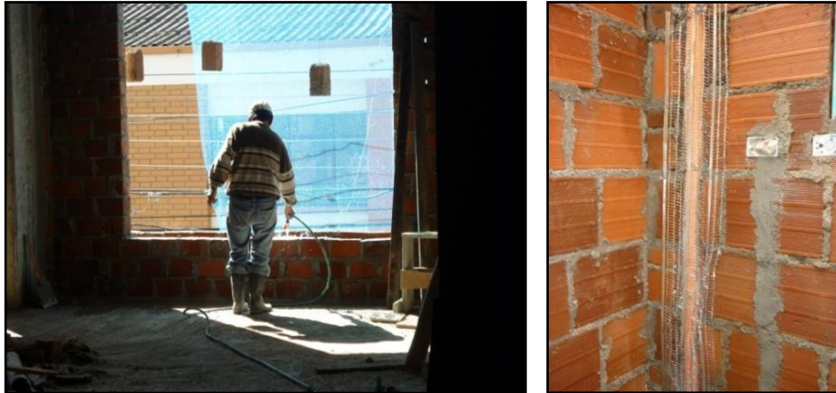
Ilustración 56. Humedecimiento ladrillo y uso de malla de vena
