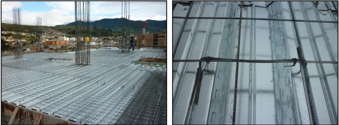
Ilustración 40. Separadores malla electro-soldada
