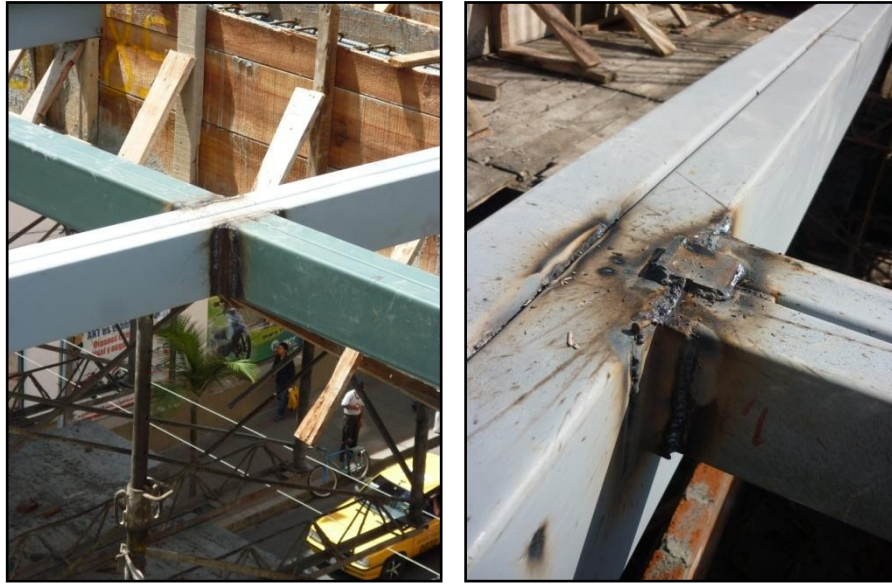
Ilustración 30. Instalación de vigas metálicas en cajón.
