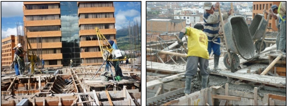
Ilustración 31. Vaciado del concreto
