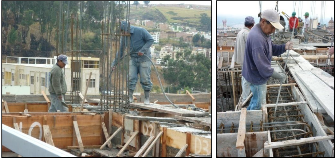
Ilustración 34. Vibrado manual y mecánico del concreto
