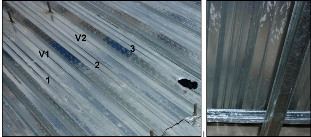
Ilustración 37. Instalación adecuada lámina metaldeck
