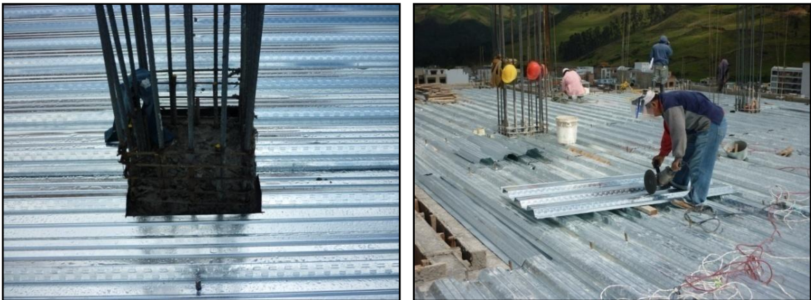
Ilustración 36. Corte lámina metaldeck
