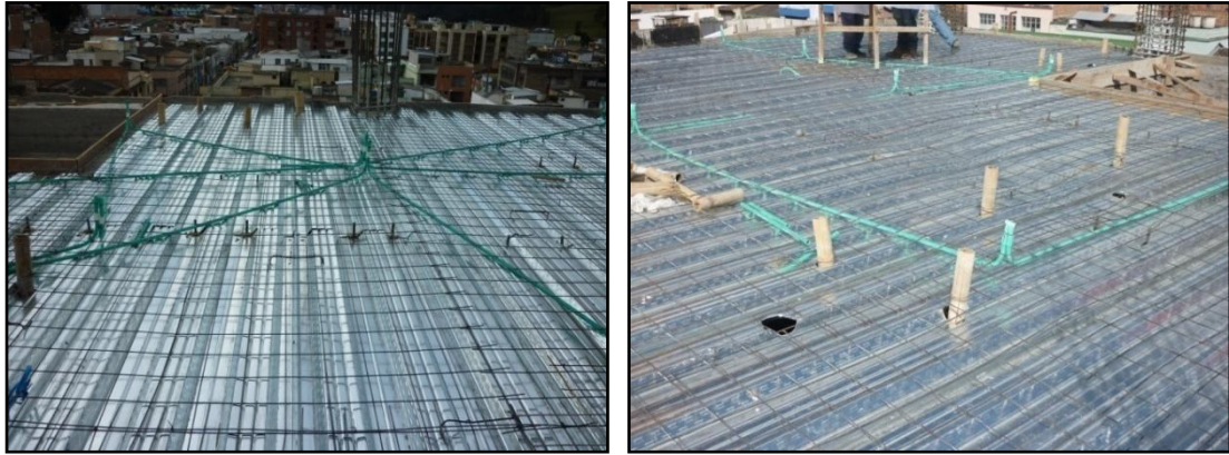
Ilustración 42. Instalación ductería eléctrica
