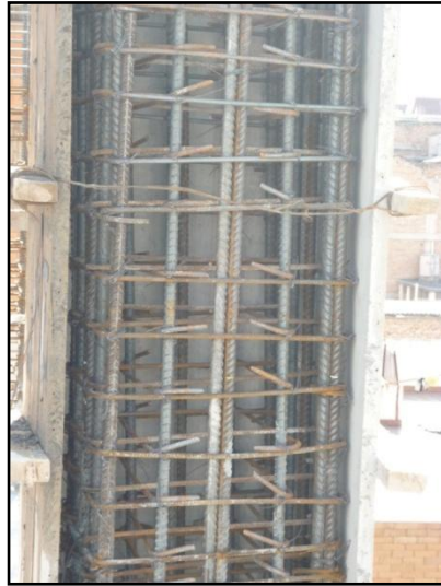
Ilustración 13. Detalle formaleta (recubrimiento)
