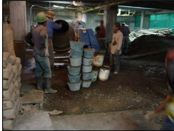
Ilustración 4. Mezclado del concreto (elementos de dosificación)
