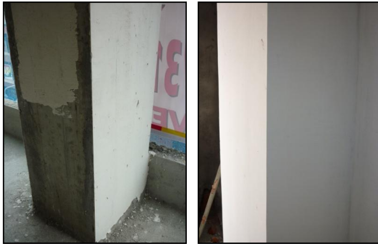
Ilustración 58. Uso de “estuka dos” sobre columnas
