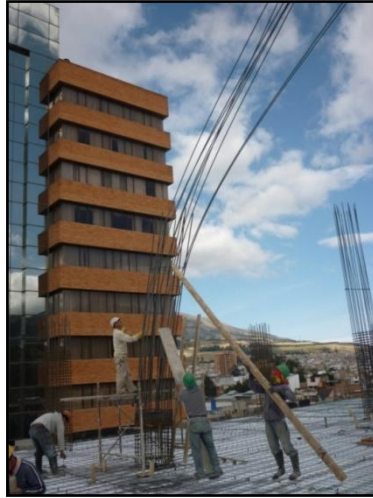
Ilustración 10. Instalación varillas de 9 m.
