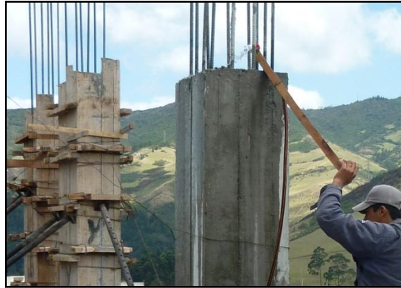
Ilustración 20. Curado del concreto
