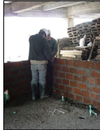
Ilustración 52. Plomado de muros
