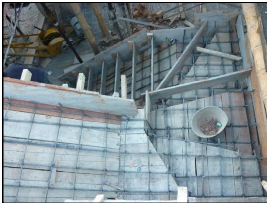
Ilustración 60. Formaleta y distribución acero grada
