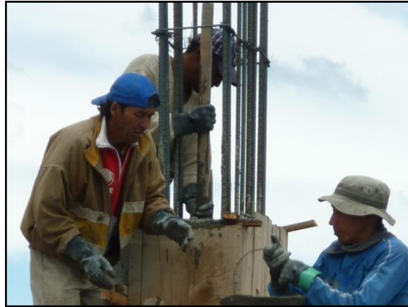
Ilustración 17. Vibrado manual concreto
