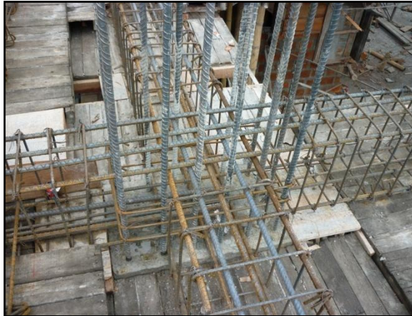
Ilustración 26. Disposición flejes en la intersección viga-columna
