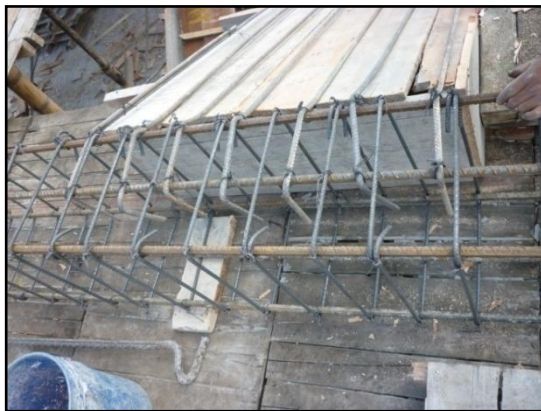
Ilustración 61. Anclaje de acero grada a viga
