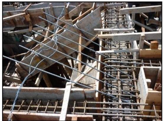
Ilustración 61. Anclaje de acero grada a viga
