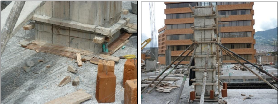
Ilustración 12. Apuntalamiento del encofrado columna
