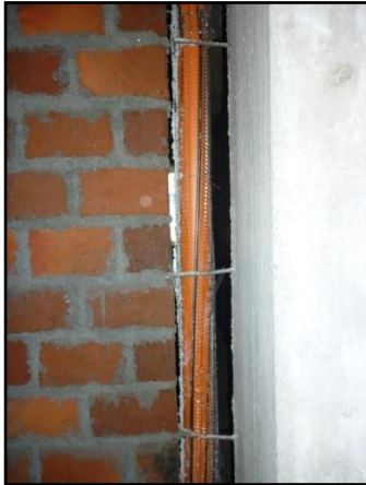
Ilustración 51. Anclaje de muros.
