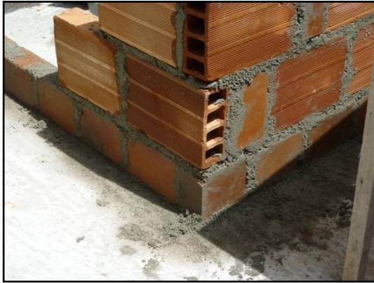
Ilustración 48. Construcción de muros
