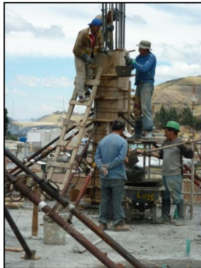
Ilustración 15. Vaciado del concreto
