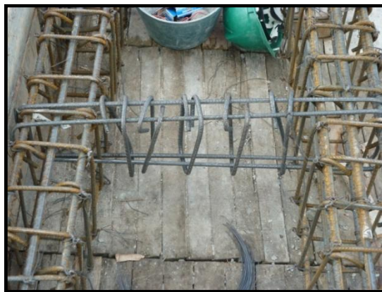
Ilustración 25. Disposición refuerzo vigas aéreas
