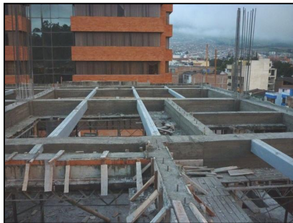
Ilustración 35. Vigas desencofradas
