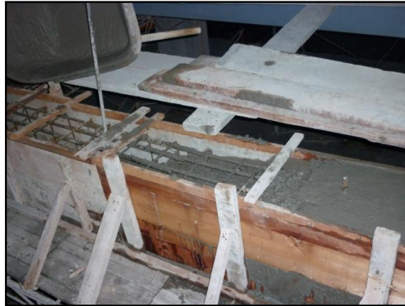
Ilustración 32. Junta a 45°
