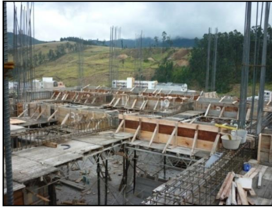
Ilustración 27. Instalación formaleta lateral
