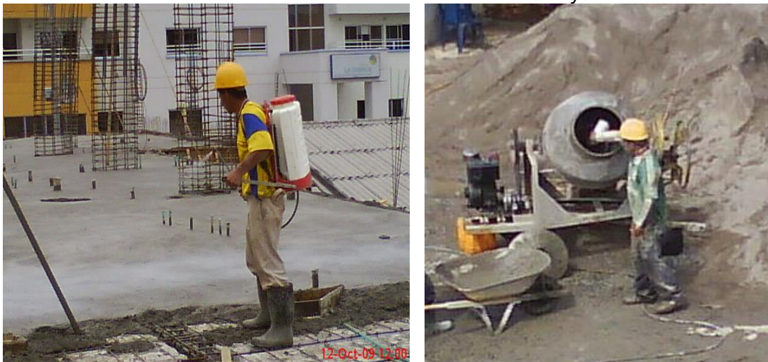
Ilustración 5. Adición de antisol blanco y de viscocrete
