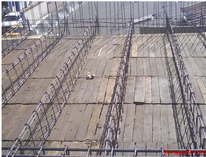
Ilustración 38. Refuerzo en viguetas
