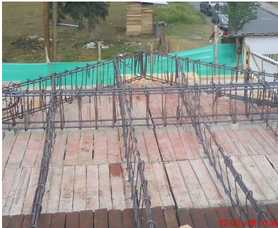
Ilustración 22. Acero de la losa.
