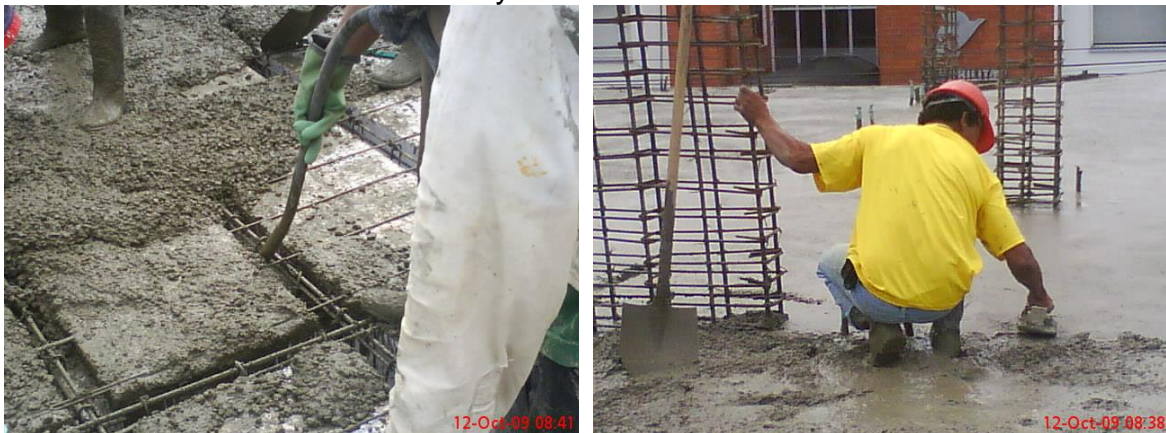
Ilustración 27. Vibrado y terminado del concreto en la losa
