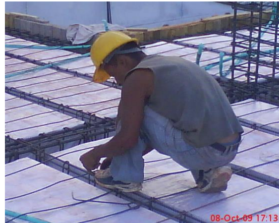
Ilustración 22. Acero de la losa.
