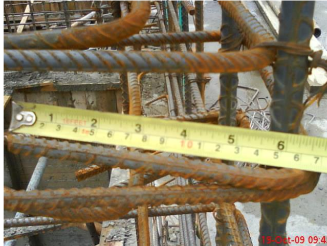
Ilustración 24. Angulo de doblaje del gancho estándar distinto a 135°
