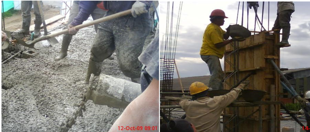
Ilustración 17. Colocación del concreto
