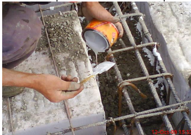
Ilustración 28. Imprimación de sikadur 32 primer
