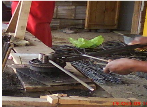
Ilustración 9. Figurado del acero
