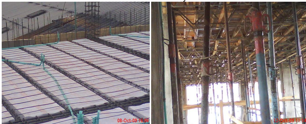
Ilustración 20. Casetones y encofrado
