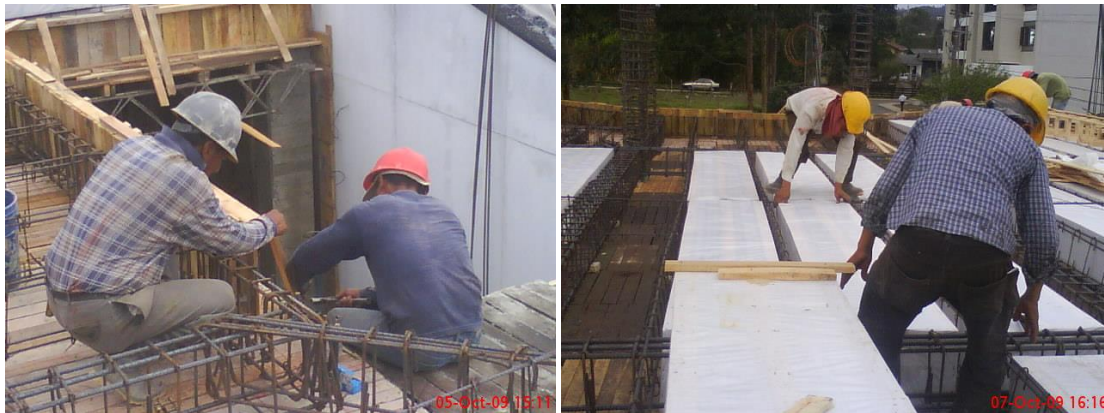
Ilustración 26. Colocación de formaleta lateral y de casetones
