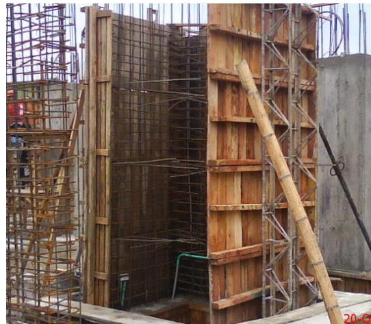
Ilustración 32. Armado de la formaleta
