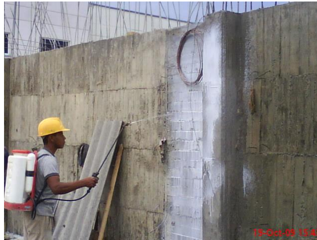
Ilustración 19. Curado de columnas
