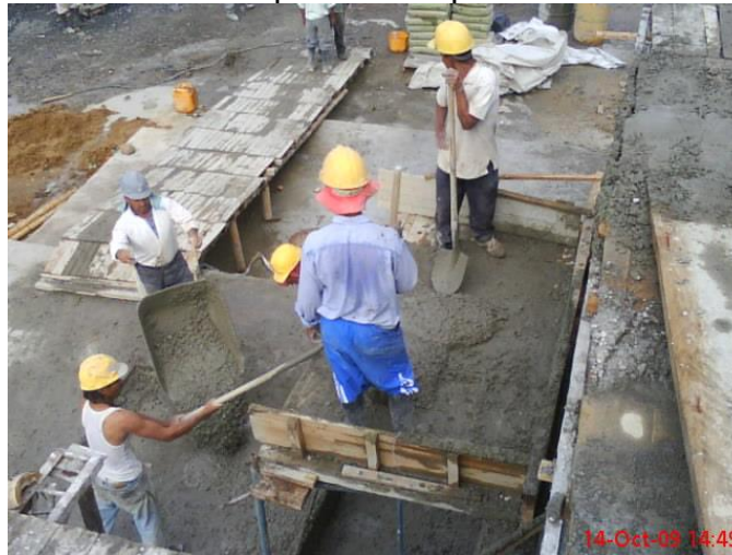
Ilustración 29. Estación provisional para elevar el concreto
