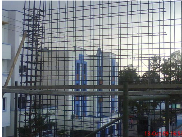
Ilustración 35. Armado del castillo de acero de pantallas
