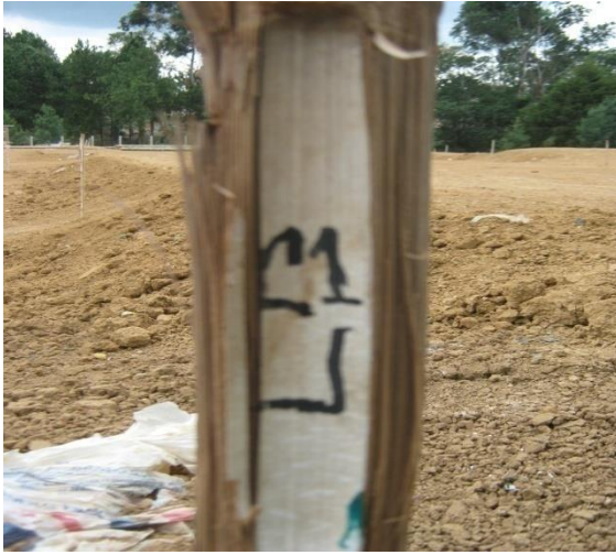
Foto 10. Replanteo y localización de viviendas en los bloques 8 y 9
