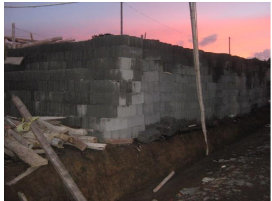
Foto 30 Almacenamiento de los bloques para la losa de entrepiso.
