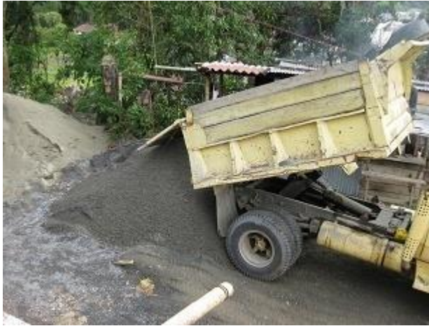
Foto 18. Llegada de agregado a la obra
