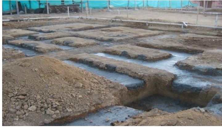
Foto 15. Solados que cubren la tubería instalada
