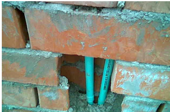
Foto 23. Ubicación tubería eléctrica dentro de las dovelas del ladrillo estructural.
