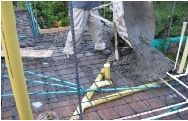
Foto. 32 Vaciado del concreto en el sitio
