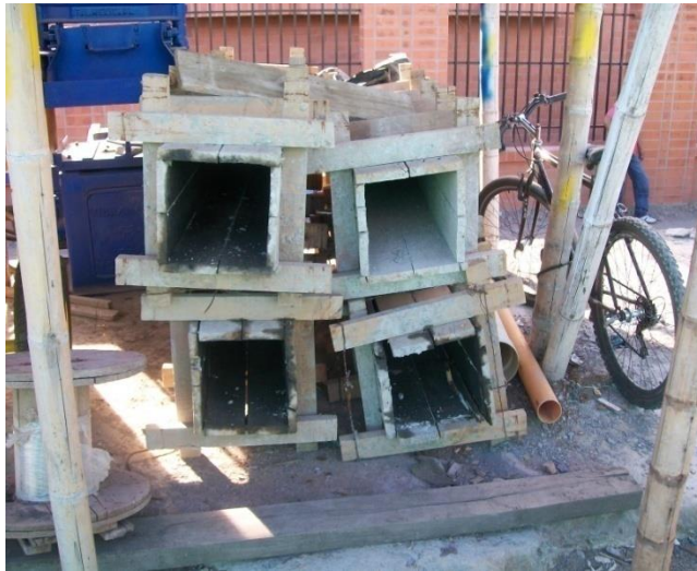
Foto 16. Madera utilizada para formaleta de las columnas
