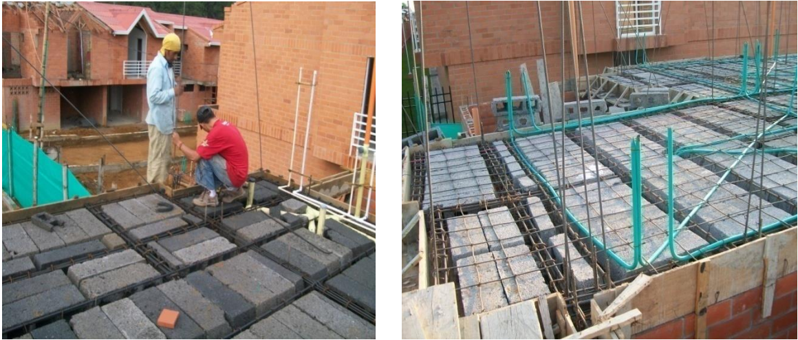
Foto 28. Acero de refuerzo y bloques instalados para la losa de entrepiso
