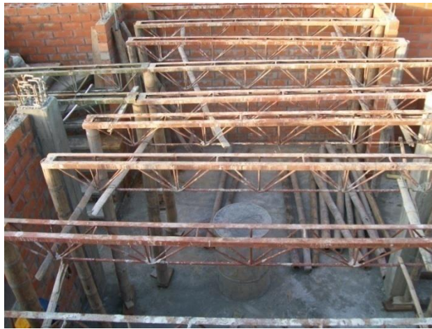
Foto 27. Cerchas instaladas para el armado del encofrado para la losa aligerada
