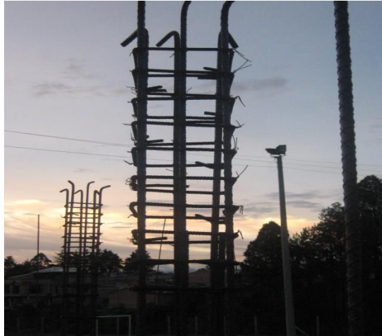
Foto 20. Estribos instalados
