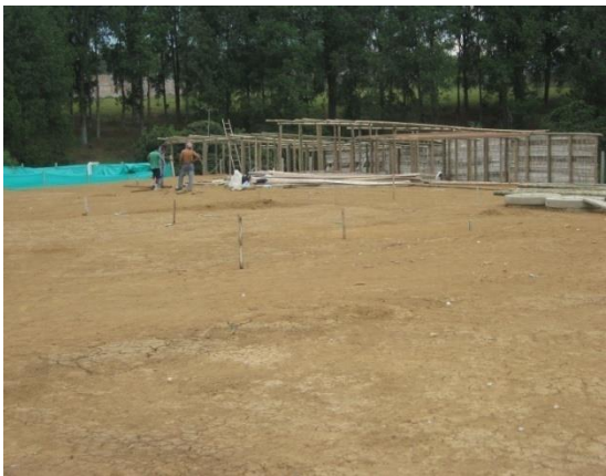
Foto 9. Construcción del nuevo almacén y localización de los niveles en el terreno
