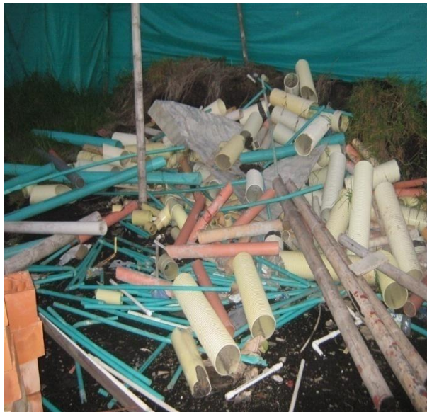
Foto. 5 Desperdicios de tubería sanitaria, tubería eléctrica y tubería de aguas lluvias
