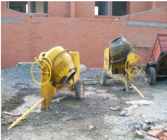
Foto 34. Trompos para la mezcla de Concreto.
