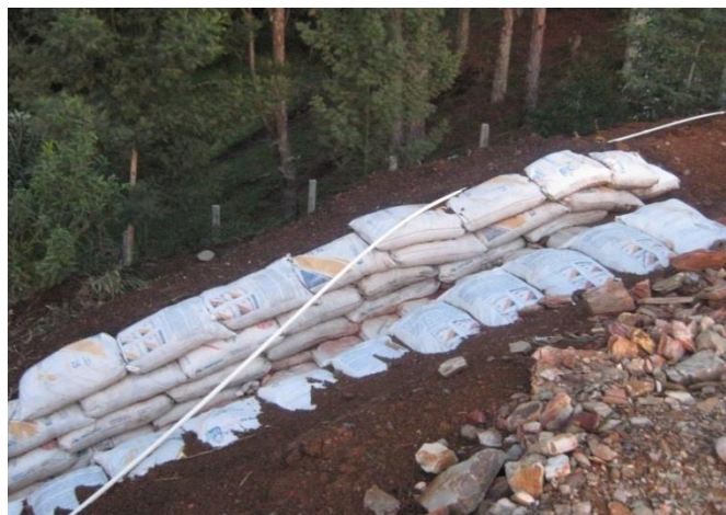
Foto 12. Muro en costalillas con arena para encauce de aguas lluvias.
