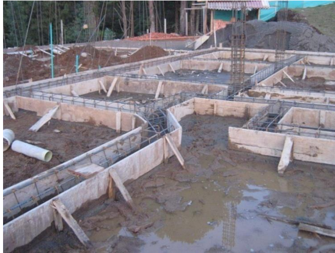
Foto 19. Hierro para las vigas de cimentación
