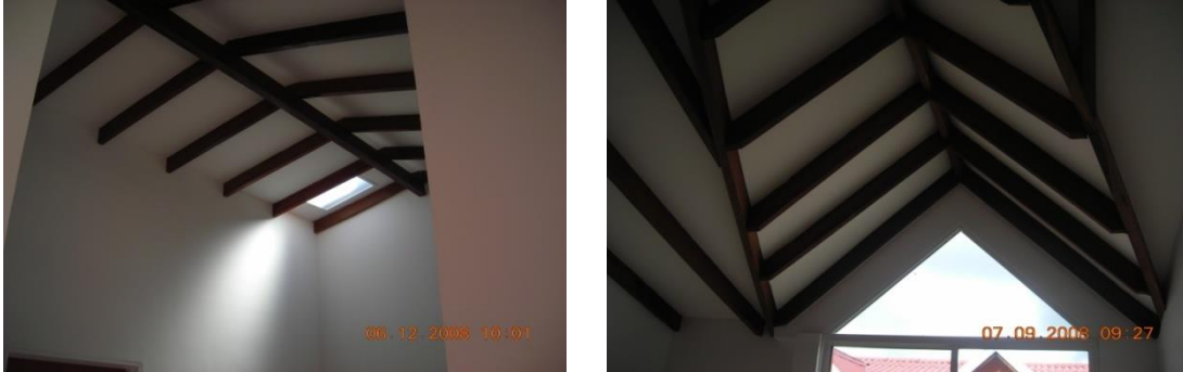
Foto 7. Cubiertas instaladas bloque 11
