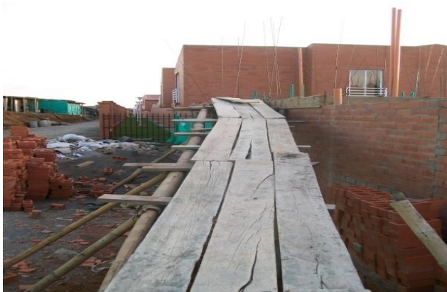
Foto 31. Rampa para el transito de los buguis con concreto
