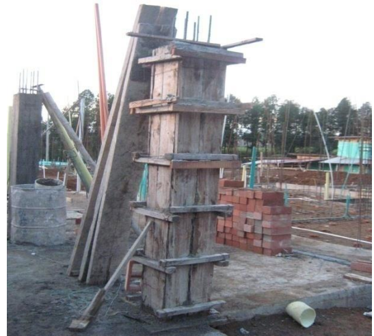
Foto 21. Encofrado de la columna
