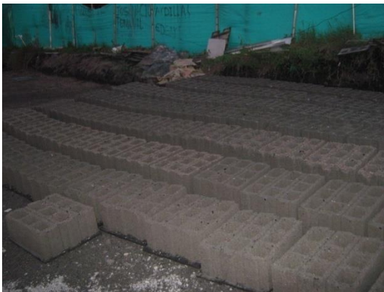
Foto 30 Almacenamiento de los bloques para la losa de entrepiso.
