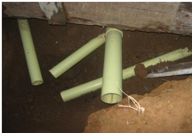
Foto 14 Tubería sanitaria instalada
