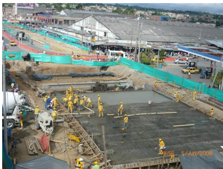
Figura 3. Control de calidad para actividades con el camión mezclador de concreto.
