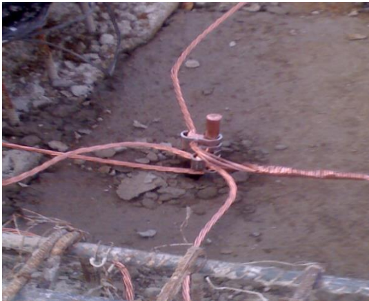
Figuras N° 36 y 37. Instalación del sistema puesta en tierra (Jaula Faraday) y refuerzo de soldadura en los nudos.
