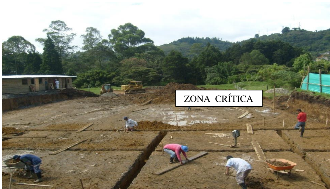
Figura N° 8. Ubicación de Zona Crítica en el terreno.
