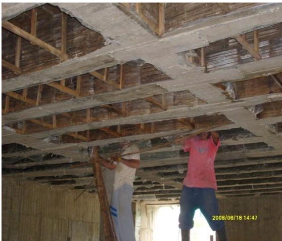
Figuras N° 82 y 83. Retiro de casetones del sótano y apariencia de la bóveda.
