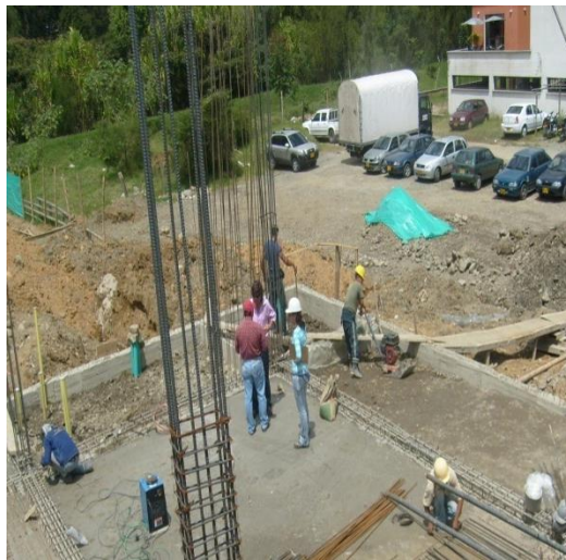
Figuras N° 19 y 20. Compactación con equipo manual (Rana).
