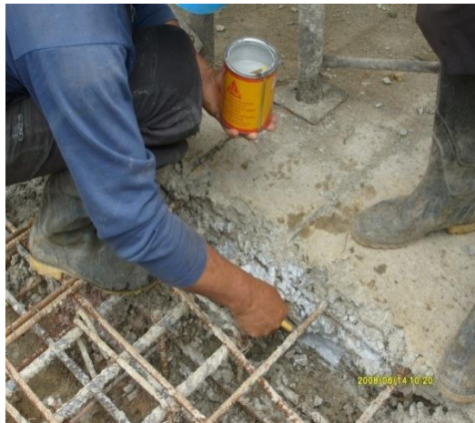
Figuras N° 42 y 43. Aplicación de epóxico en bordes y nudos de columnas.
