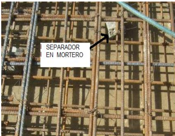
Figuras N° 34 y 35. Toma de colocación de separadores de mortero y de acero.
