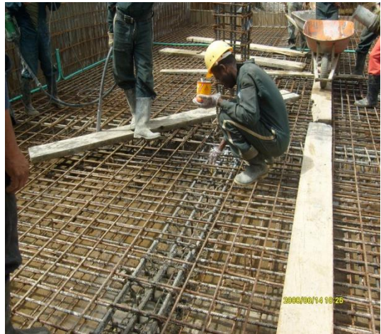
Figuras N° 42 y 43. Aplicación de epóxico en bordes y nudos de columnas.
