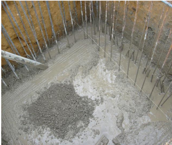
Figuras N° 107 y 108. Colocación de solados y armado de pantallas en los fosos.
