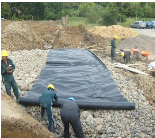
Figuras N° 11 y 12. Instalación de Geotextil NT y colocación de material amarillo.
