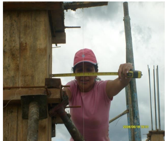
Figuras N° 94 y 95. Chequeo del aplomo en las dos caras de la Columna.
