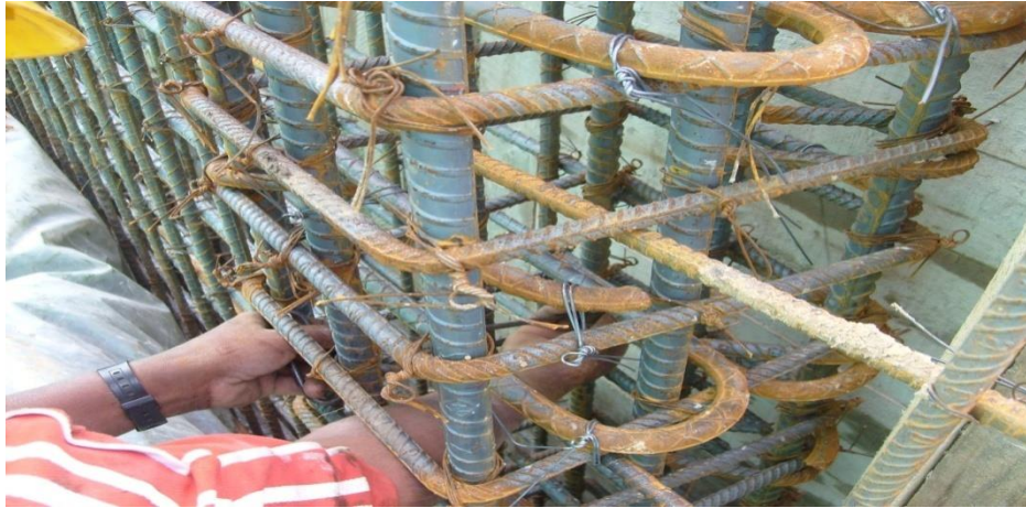
Figura N° 89. Colocación de bastones en acero para cierre en las parrillas de Muros.
