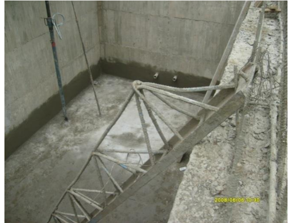
Figura N° 68 y 69. Aplicación de impermeabilizante en toda la zona inferior del Tanque de Almacenamiento.
