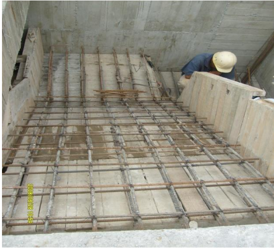
Figuras N° 103 y 104. Aceros de Refuerzo y Fundición del Concreto en las Escaleras.
