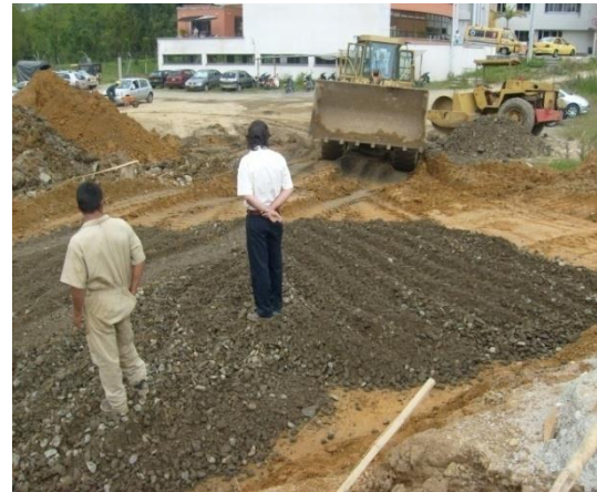
Figuras N° 13 y 14. Equipo vibro compactador para el material amarillo y colocación de roca muerta.
