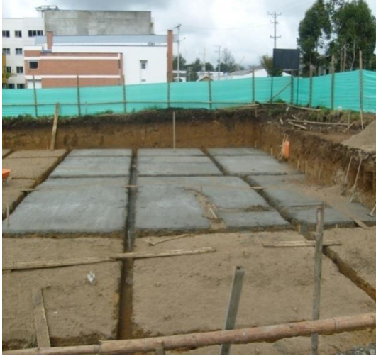
Figuras N° 30 y 31. Toma de Limpieza de Solados.
