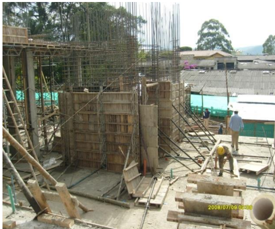
Figuras N° 109 y 110. Encofrado de pantallas y vaciado del concreto en Ascensores.
