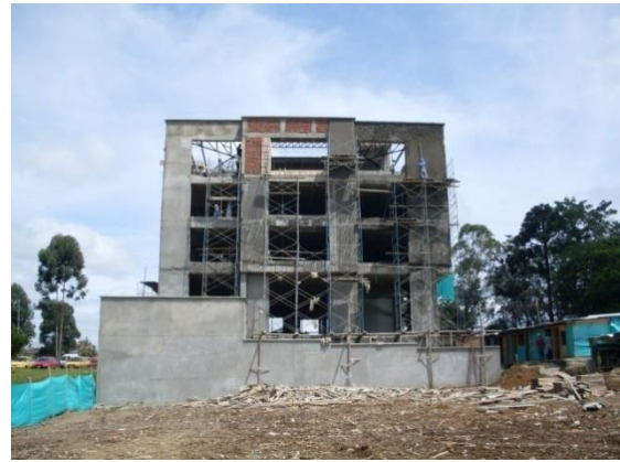
Figura N° 119 y 120. Aplicación de mortero en muros de ladrillo y fachadas.
