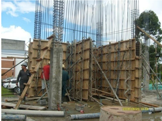
Figura N° 92. Revisión del encofrado de Muros y puntales.
