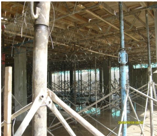
Figuras N° 70 y 71. Diseño de obra falsa en formaleta tipo Gleason e instalación de tablonés.
