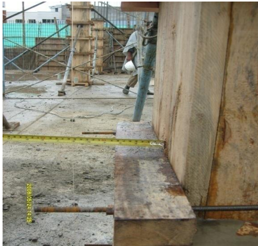
Figuras N° 94 y 95. Chequeo del aplomo en las dos caras de la Columna.
