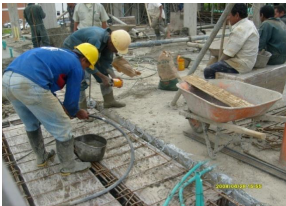
Figuras N° 78 y 79. Aplicación de epóxido entre cortes.
