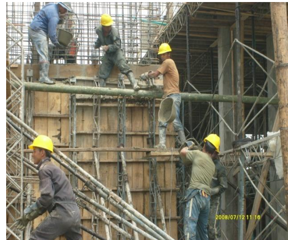
Figuras N° 109 y 110. Encofrado de pantallas y vaciado del concreto en Ascensores.
