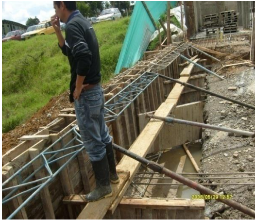
Figuras N° 17 y 18. Construcción del muro de contención en concreto reforzado.
