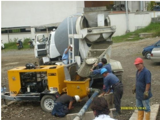
Figuras N° 76 y 77. Tipo de colocación del concreto: Bomba Estacionaria y Auto bomba.
