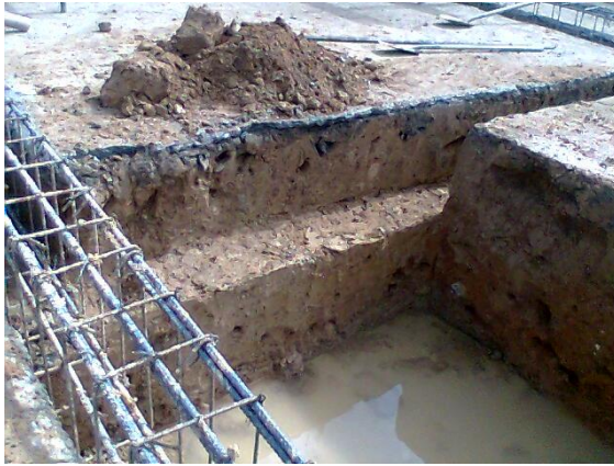
Figuras N° 105 y 106. Nivel freático en fosos y la evacuación por bombeo eléctrico.
