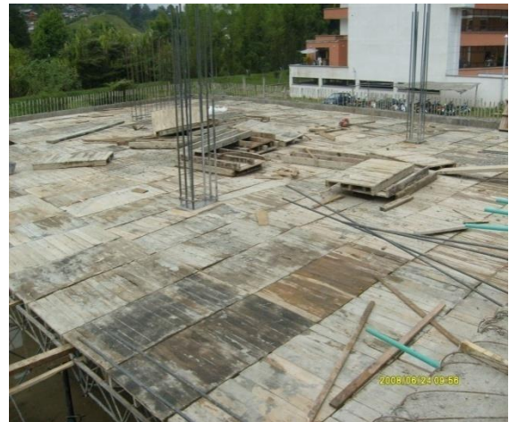
Figuras N° 70 y 71. Diseño de obra falsa en formaleta tipo Gleason e instalación de tablonés.
