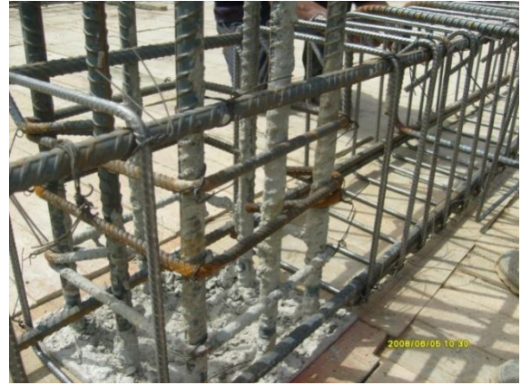
Figuras N° 73 y 74. Toma de instalación de viguetas, riostras en entrepisos y colocación de estribos en los nudos.
