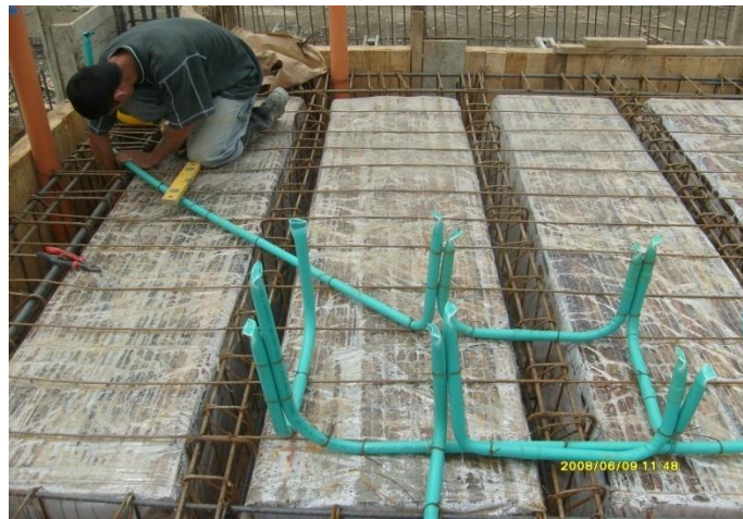
Figura N° 75. Instalación de tubería eléctrica, sanitaria y verificación de limpieza.
