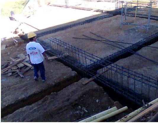
Figuras N° 23 y 24. Castillo de acero de vigas de cimentación y su colocación en las divisiones.
