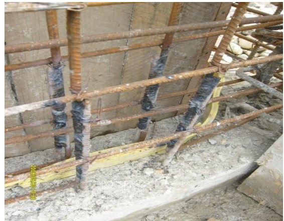
Figura N° 65 y 66. Instalación de platina con tubería de desagüe, cinta PVC y soldadura en varillas del muro.
