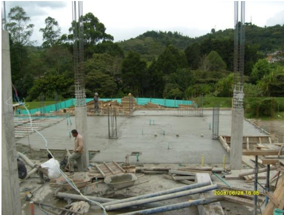
Figuras N° 80 y 81. Aplicación de Antisol en las losas.
