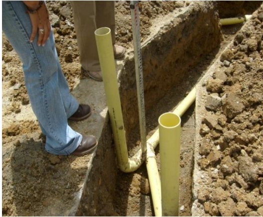
Figuras N° 32 y 33. Chequeo de pendientes en tubería sanitarias con el equipo de estación total.
