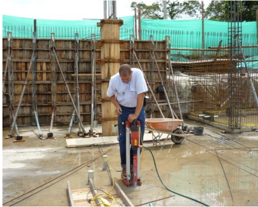
Figuras N° 45 y 46. Toma de núcleos de la losa de cimentación y toma de medidas.
