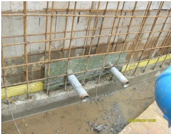
Figura N° 65 y 66. Instalación de platina con tubería de desagüe, cinta PVC y soldadura en varillas del muro.
