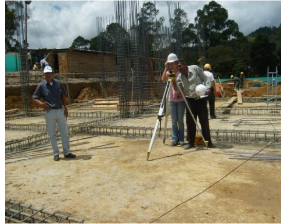
Figuras N° 32 y 33. Chequeo de pendientes en tubería sanitarias con el equipo de estación total.
