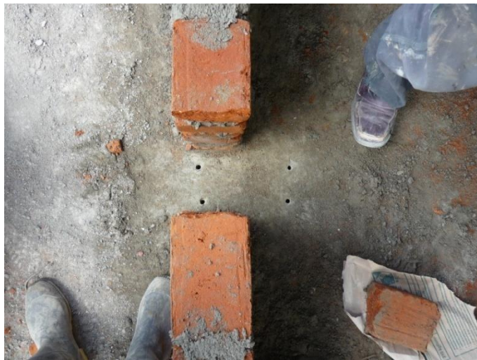
Figura N° 118. Perforación en el piso para anclar aceros de amarre.
