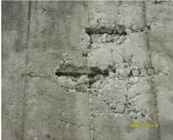
Figuras N° 101 y 102. Aceros de Refuerzo visible y Corrección de sobre ancho en Muro.
