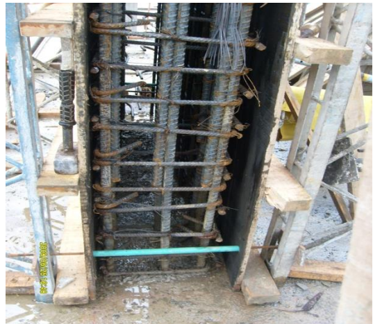
Figuras N° 90 y 91. Verificación del ancho de recubrimiento y limpieza de Columnas y Muros.
