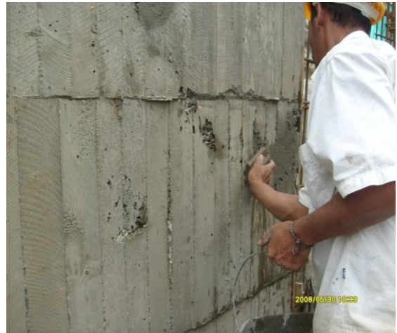
Figuras N° 60 y 61. Hormigueros en muro perimetral y resane en zonas afectadas.
