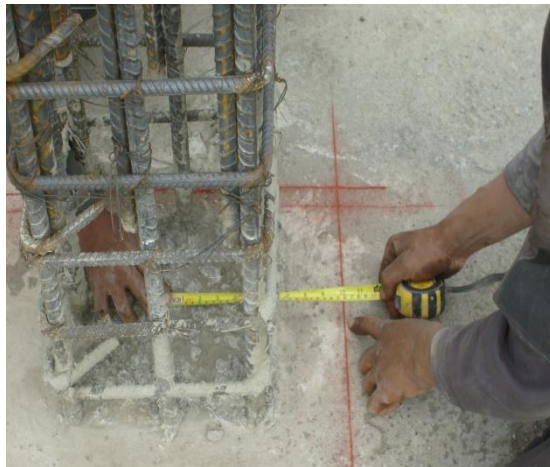
Figuras N° 90 y 91. Verificación del ancho de recubrimiento y limpieza de Columnas y Muros.
