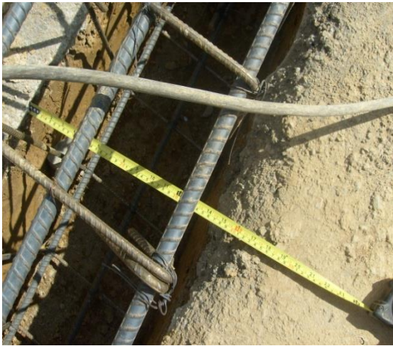
Figuras N° 25 y 26. Revisión del espacio de recubrimiento y la colocación de panelitas de mortero.
