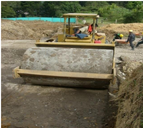
Figuras N° 15 y 16. Equipo vibro compactador para el compactar roca muerta.
