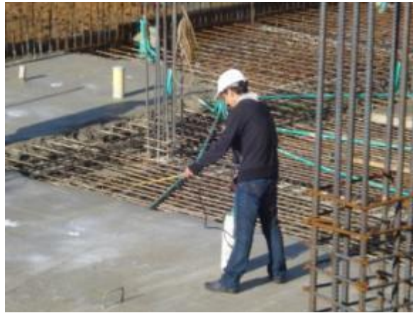
Figuras N° 42 y 43. Aplicación de epóxico en bordes y nudos de columnas.
