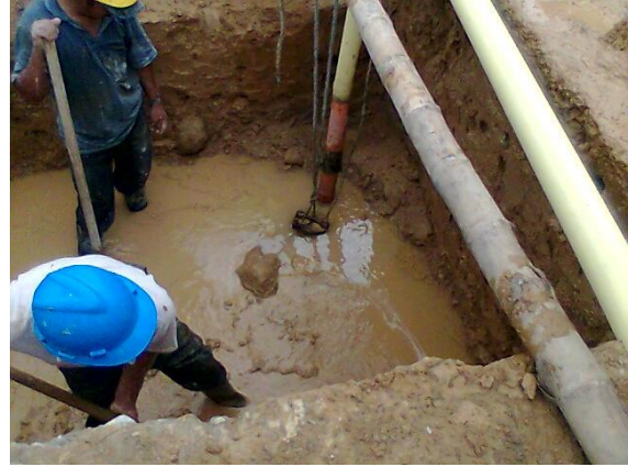
Figuras N° 105 y 106. Nivel freático en fosos y la evacuación por bombeo eléctrico.
