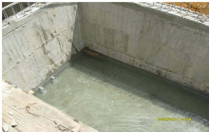
Figura N° 67. Prueba de filtración al Tanque de Almacenamiento.
