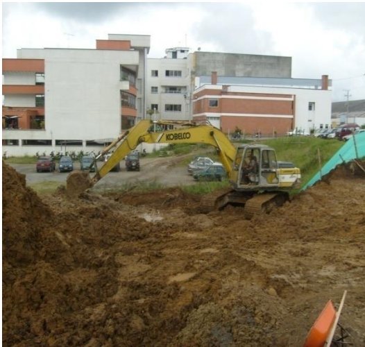
Figuras N° 9 y 10. Retiro de material sobrante y colocación de base rocosa.
