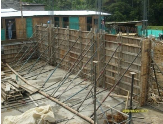
Figuras N° 54 y 55. Puntales de las formaletas del muro perimetral y distancia de acero a la formaleta.
