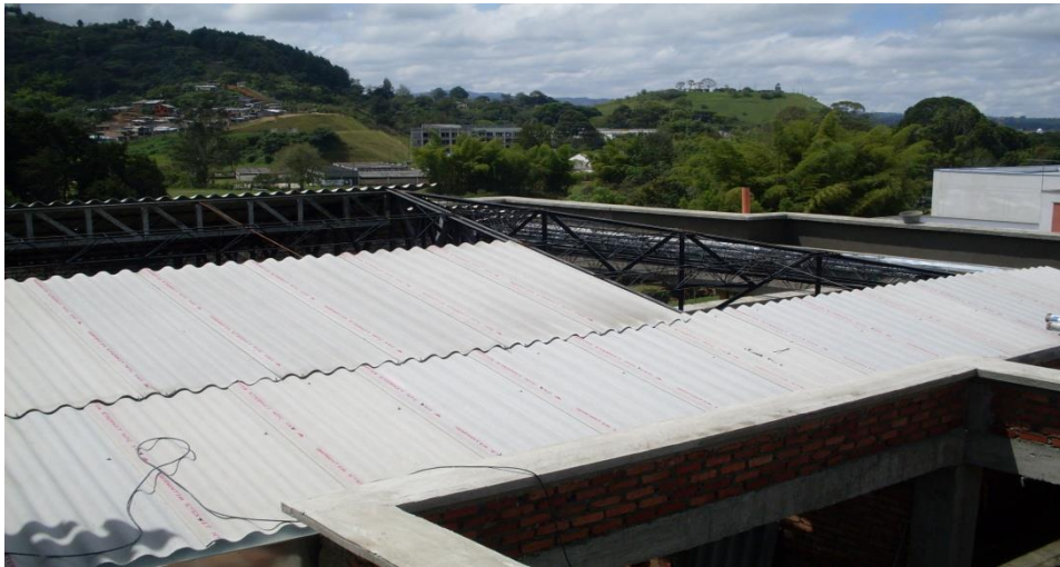
Figura N° 112. Toma externa de la Cubierta.
