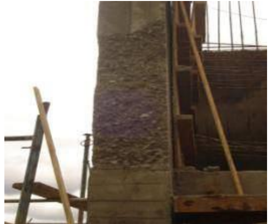
Figuras N° 101 y 102. Aceros de Refuerzo visible y Corrección de sobre ancho en Muro.
