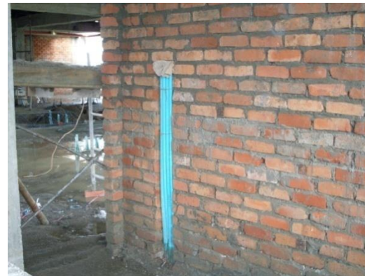
Figuras N° 116 y 117. Toma de Vigueta y Columneta del muro en ladrillo e instalación del sistema eléctrico.
