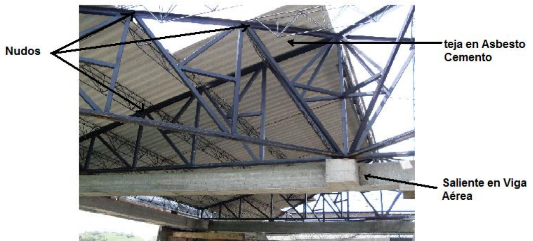
Figura N° 111. Toma interna de la Cubierta.
