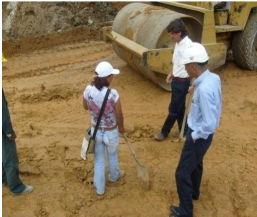
Figuras N° 13 y 14. Equipo vibro compactador para el material amarillo y colocación de roca muerta.
