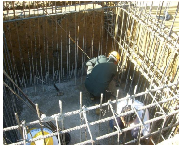
Figuras N° 107 y 108. Colocación de solados y armado de pantallas en los fosos.
