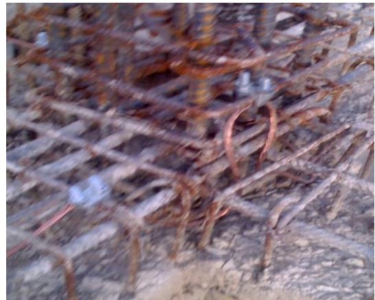
Figuras N° 36 y 37. Instalación del sistema puesta en tierra (Jaula Faraday) y refuerzo de soldadura en los nudos.
