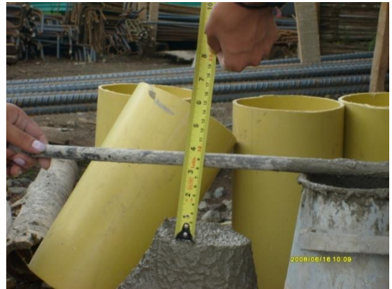
Figuras N° 98 y 99. Chequeo del asentamiento del concreto 1:2:2 para las columnas.
