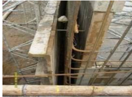
Figuras N° 54 y 55. Puntales de las formaletas del muro perimetral y distancia de acero a la formaleta.
