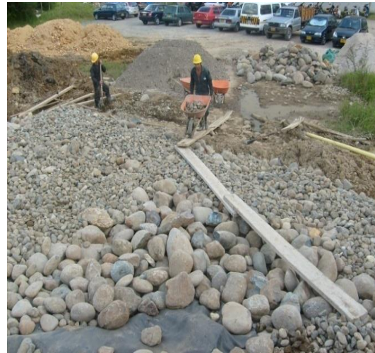
Figuras N° 9 y 10. Retiro de material sobrante y colocación de base rocosa.
