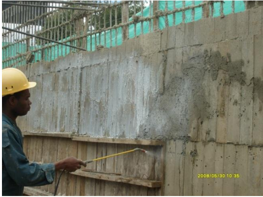
Figuras N° 58 y 59. Aplicación de Antisol en muro perimetral.
