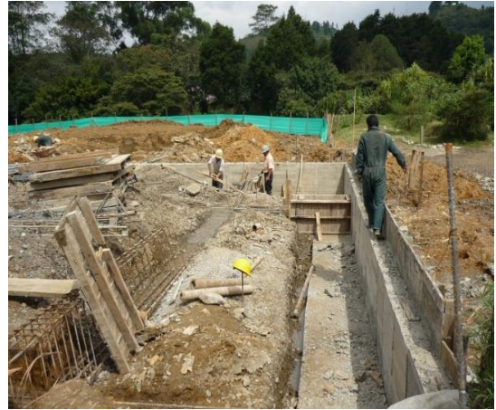
Figuras N° 17 y 18. Construcción del muro de contención en concreto reforzado.
