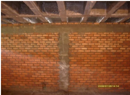
Figuras N° 116 y 117. Toma de Vigueta y Columneta del muro en ladrillo e instalación del sistema eléctrico.
