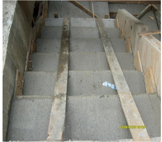
Figuras N° 103 y 104. Aceros de Refuerzo y Fundición del Concreto en las Escaleras.
