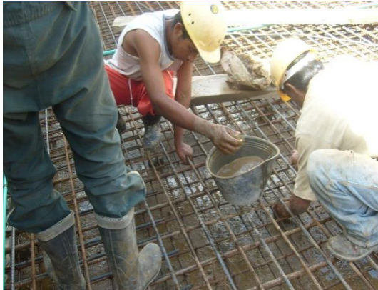
Figuras N° 40 y 41. Limpieza y lavado de las parillas.
