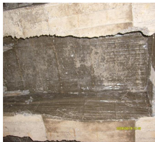
Figuras N° 82 y 83. Retiro de casetones del sótano y apariencia de la bóveda.
