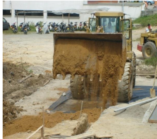
Figuras N° 11 y 12. Instalación de Geotextil NT y colocación de material amarillo.
