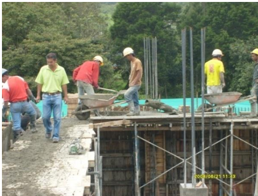
Figuras N° 56 y 57. Vertimiento del concreto en muro perimetral.
