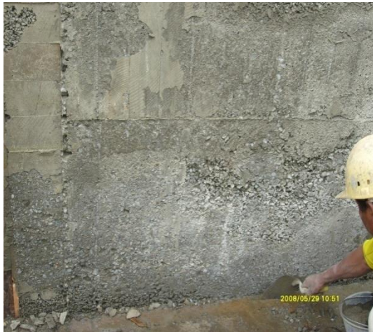
Figuras N° 60 y 61. Hormigueros en muro perimetral y resane en zonas afectadas.
