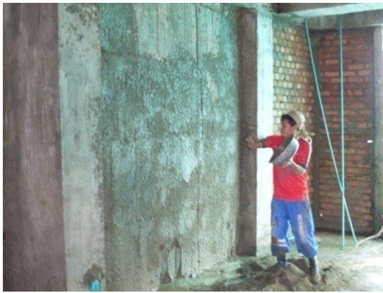
Figura N° 119 y 120. Aplicación de mortero en muros de ladrillo y fachadas.
