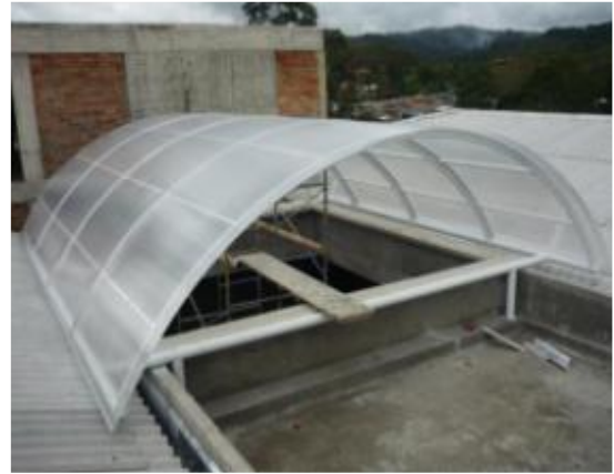
Figuras N° 113 y 114. Instalación del marco y láminas de poli carbonato del Domo.
