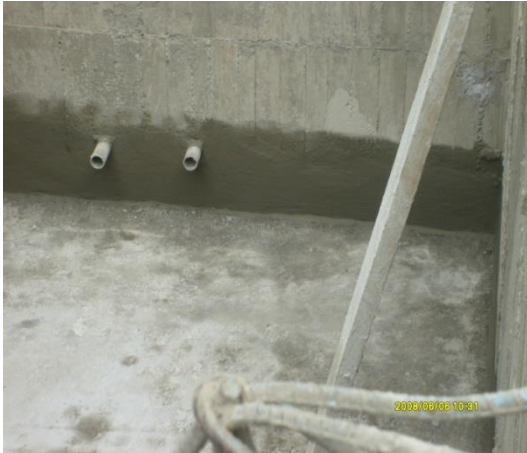
Figura N° 68 y 69. Aplicación de impermeabilizante en toda la zona inferior del Tanque de Almacenamiento.
