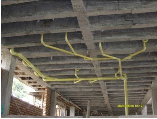
Figuras N° 122 y 123. Tuberías colgantes del sistema Hidrosanitario.
