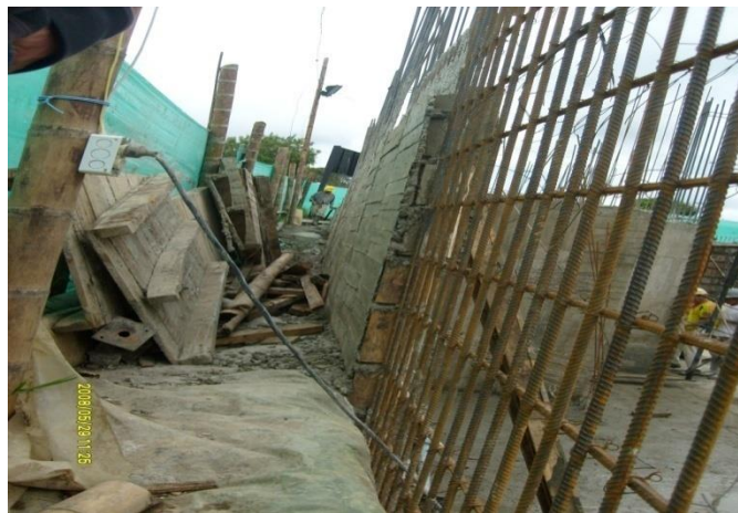
Figura N° 53. Instalación del plástico en suelo vecino.
