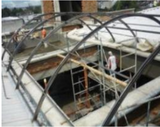
Figuras N° 113 y 114. Instalación del marco y láminas de poli carbonato del Domo.
