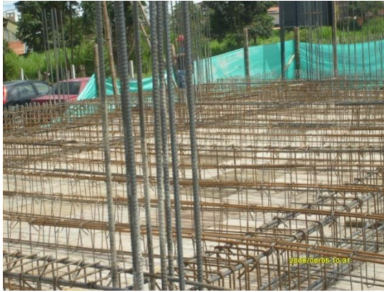
Figuras N° 73 y 74. Toma de instalación de viguetas, riostras en entrepisos y colocación de estribos en los nudos.
