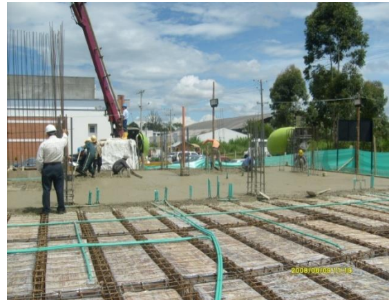
Figuras N° 76 y 77. Tipo de colocación del concreto: Bomba Estacionaria y Auto bomba.
