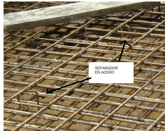
Figuras N° 34 y 35. Toma de colocación de separadores de mortero y de acero.
