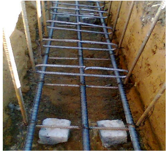
Figuras N° 25 y 26. Revisión del espacio de recubrimiento y la colocación de panelitas de mortero.
