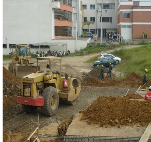
Figuras N° 15 y 16. Equipo vibro compactador para el compactar roca muerta.
