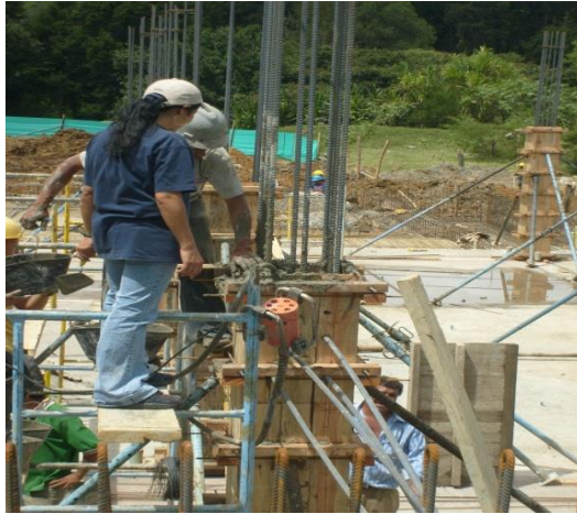
Figura N° 93. Revisión de vaciado del concreto y el vibrado en Columnas.
