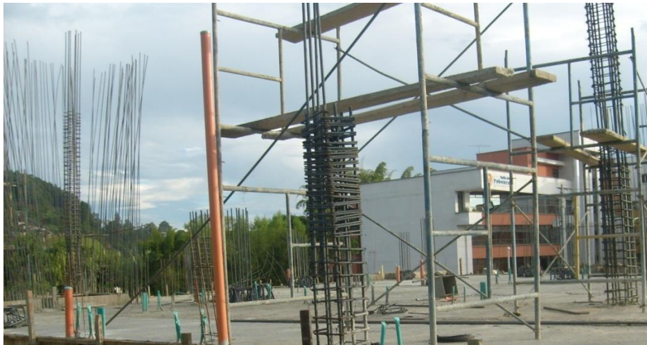
Figura N° 88. Toma de colocación de estribos en las columnas.
