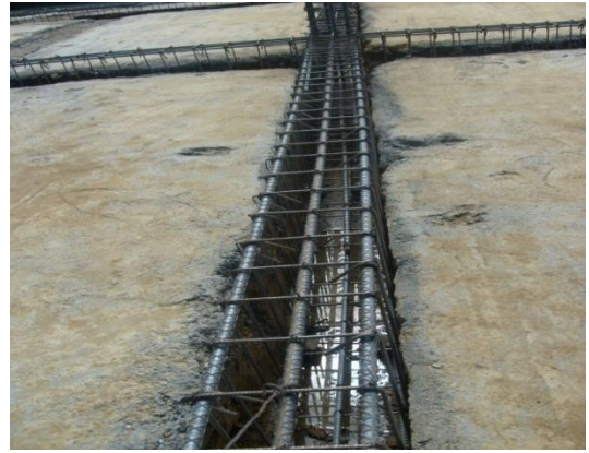
Figuras N° 23 y 24. Castillo de acero de vigas de cimentación y su colocación en las divisiones.
