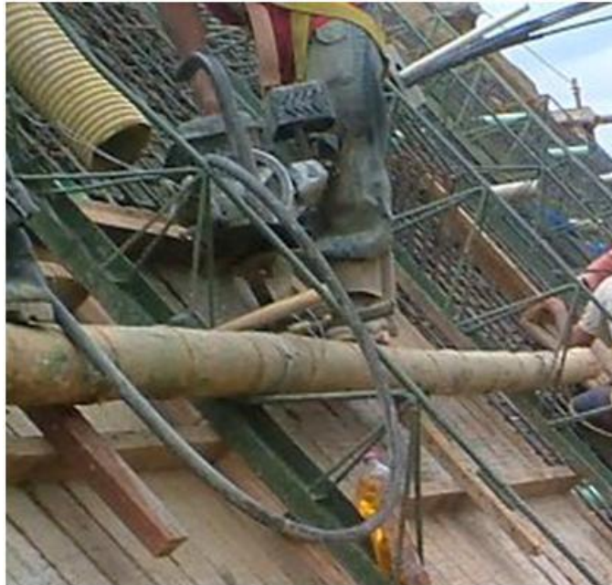
Figura 17. Vibrado del concreto
