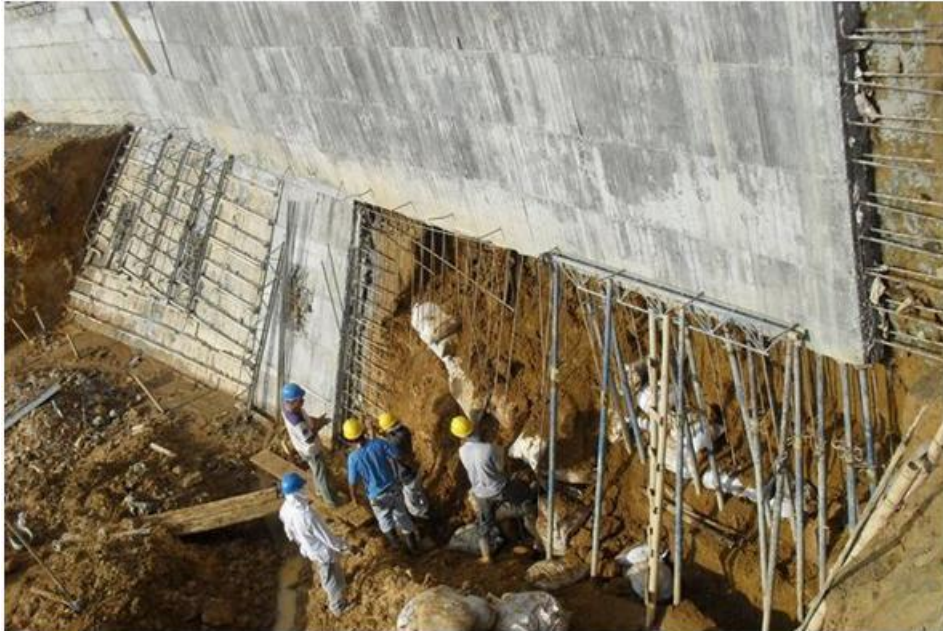
Figura 29. Deslizamiento de talud reemplazado.
