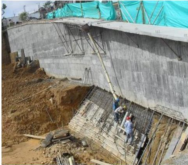
Figura 21. Vaciado del concreto para pantallas.
