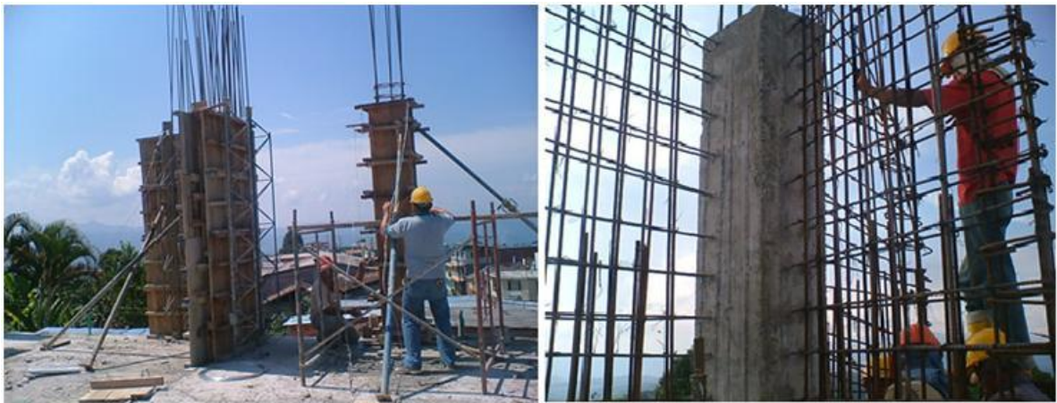
Figura 38. Acero de refuerzo y Formaleta para columnas y pantallas.
