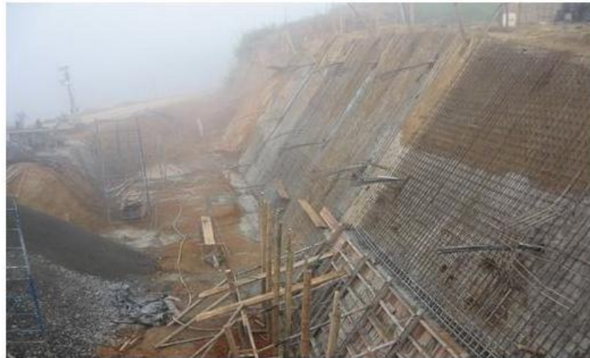
Figura 35. Distribución de anclajes activos.
