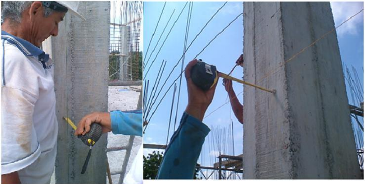
Figura 39. Chequeo de alineamiento en columnas.
