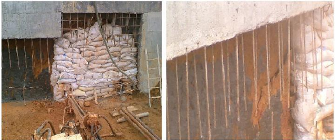
Figura 28. Reemplazo con sacos en talud deslizado
