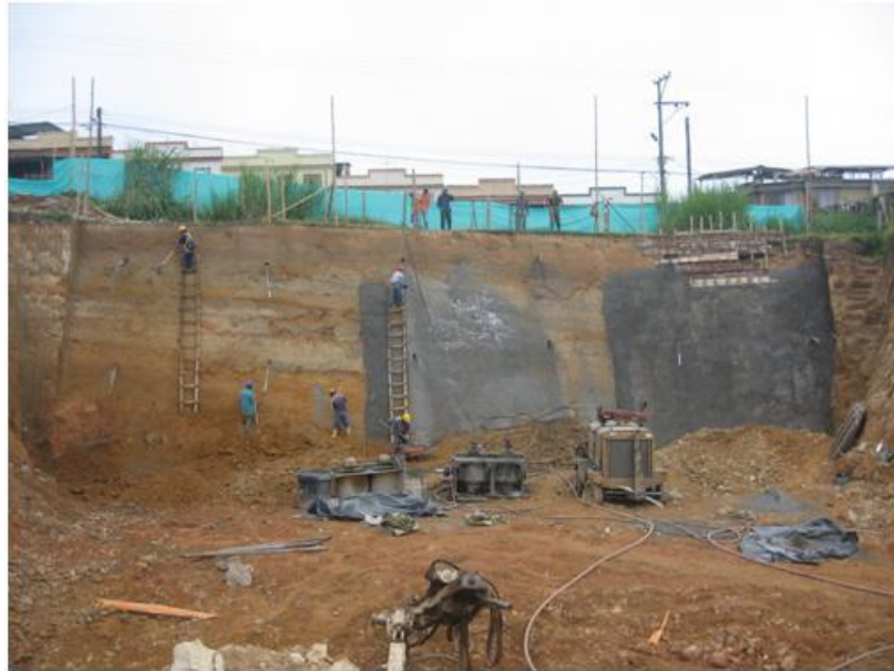
Figura 27. Perfilamiento y solado de limpieza de Talud
