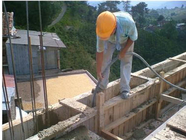
Figura 24. Vibrado del concreto.
