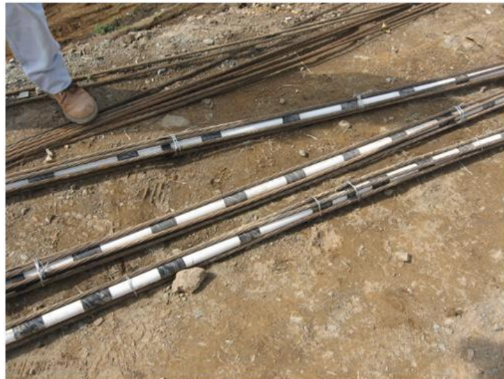
Figura 8. Tubería de inyección con bandas de caucho
