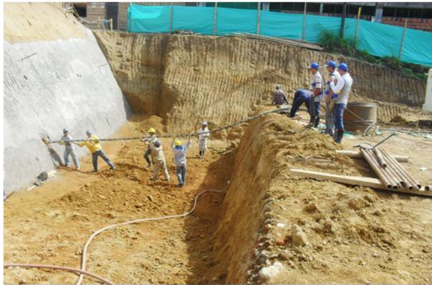
Figura 34. Introducción de anclaje activo.
