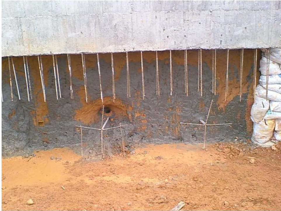
Figura 11. Anclajes pasivos
