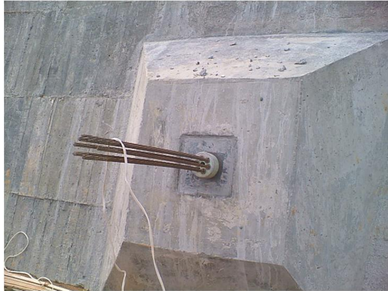
Figura 10. Dispositivo de apoyo anclaje activo.
