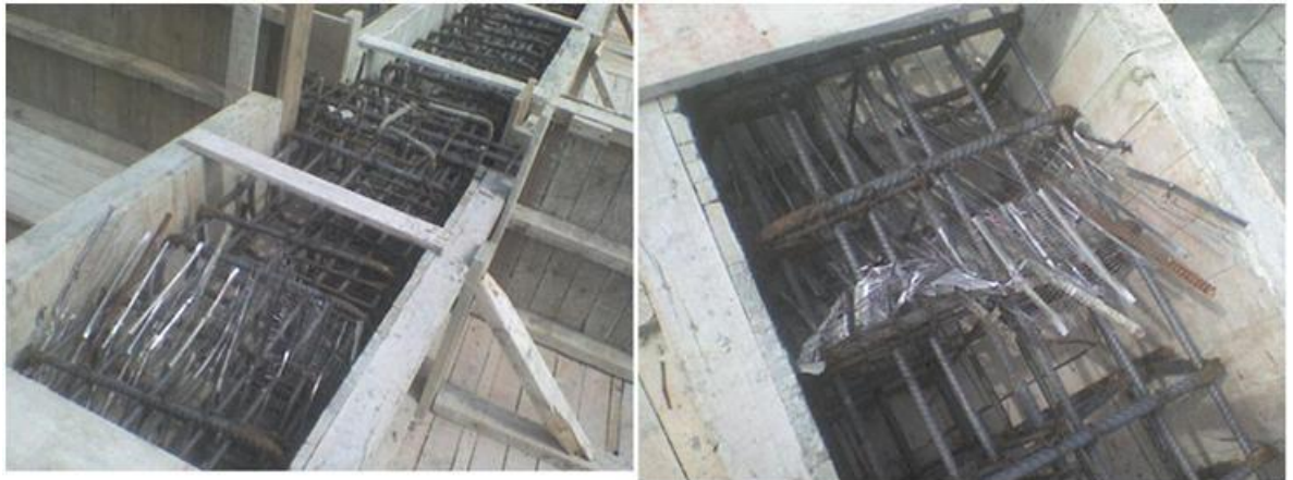
Figura 41. Malla venada en vigas de concreto.
