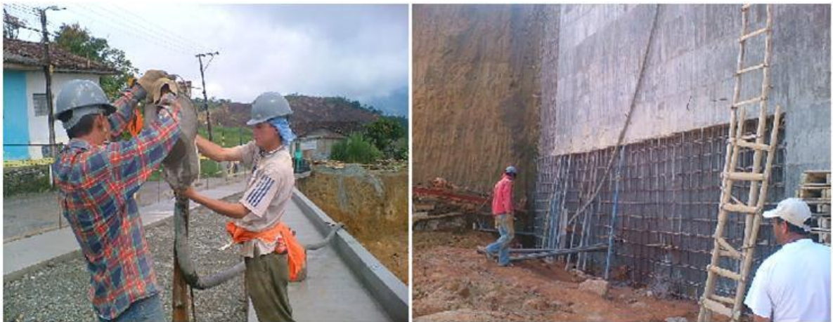
Figura 33. Llenado de anclajes pasivos.
