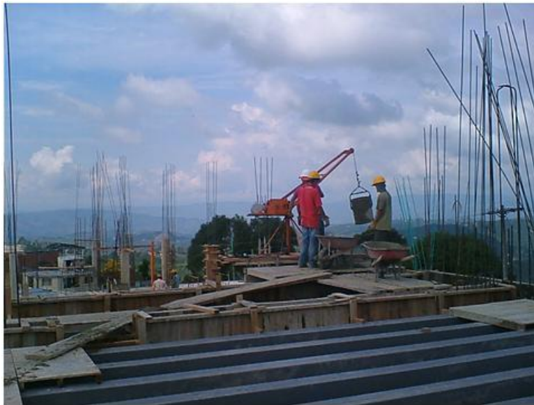
Figura 23. Transporte del concreto.
