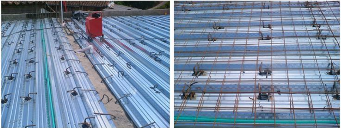
Figura 42. Losa de entre piso con Placa de Metaldeck
