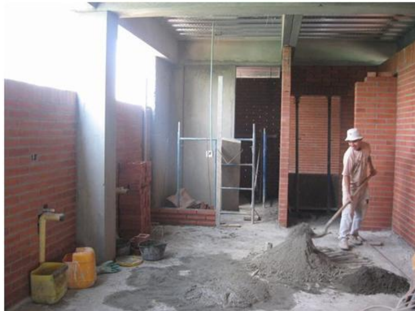
Figura 26. Elaboración del concreto Grouting.
