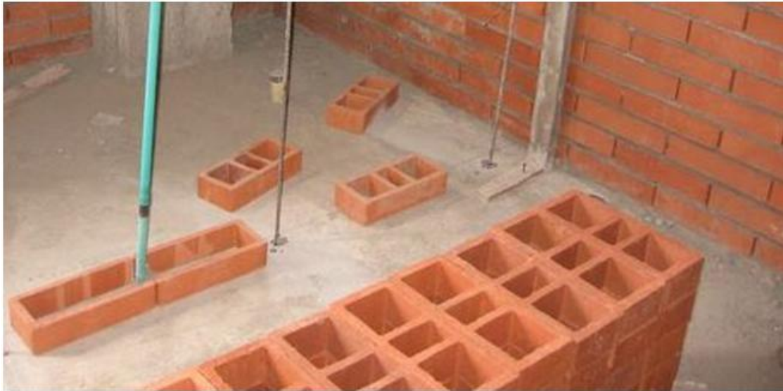
Figura 12. Unidades de Mampostería
