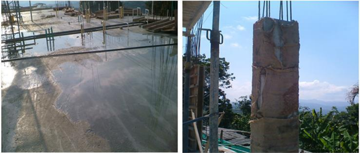
Figura 25. Curado del concreto.
