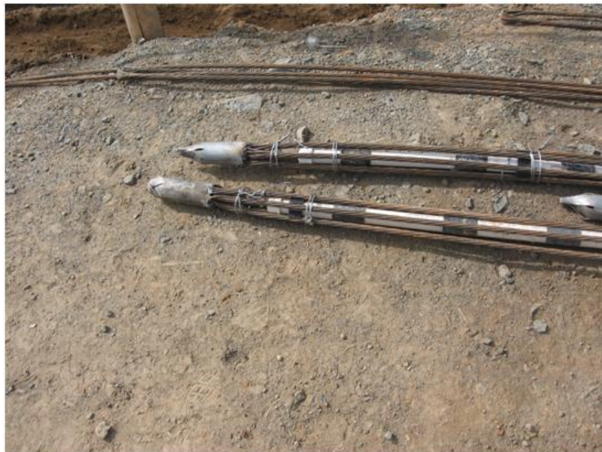
Figura 7. Anclaje activo (Punta metálica, torón)
