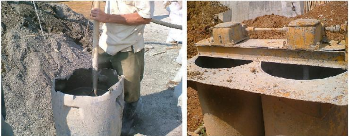
Figura 32. Preparación de lechada para anclajes
