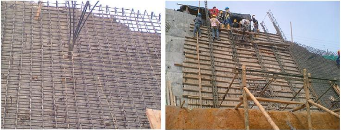
Figura 30. Acero de refuerzo y Formaletas para pantallas.
