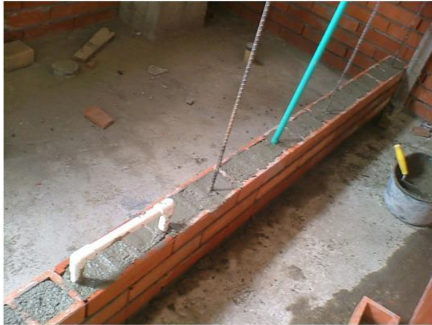
Figura 44. Concreto Grouting para primeros 25cm de muro estructural
