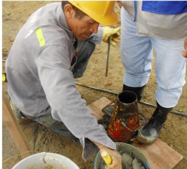
. Figura 16. Ensayo de asentamiento
