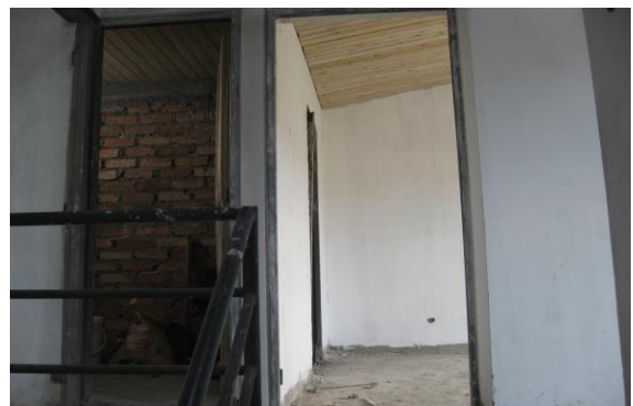
figura 11. Dilataciones bien terminadas.
