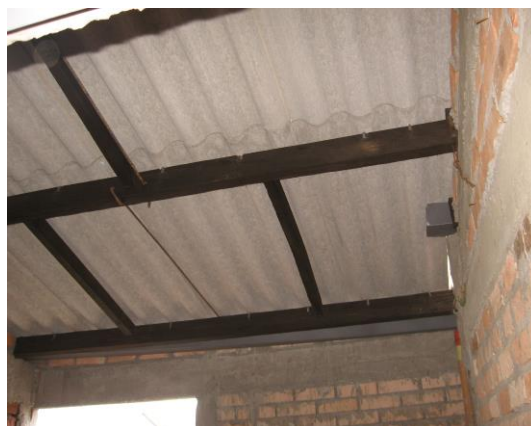
Figura 69. Gancho sujetador de las hojas de asbesto figura 70. Tensores
