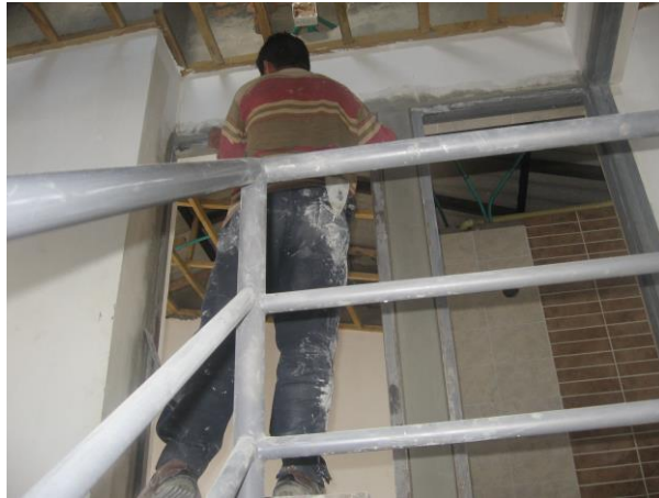
Figura 12. Terminando las dilataciones
