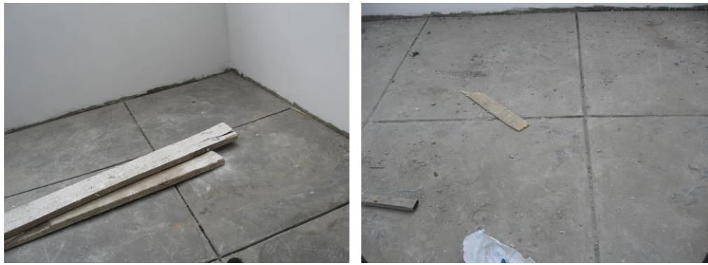
Figura 32. Y 33. Concreto con juntas de dilataciones (piso patio)
