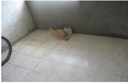
Figura 34. Colocación de piso en cerámica
