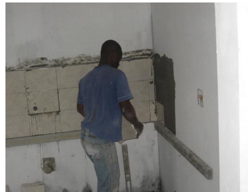
Figura 21. Y 22. Colocación de enchape de la cocina
