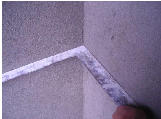
Figura 9. verificación del repello con la escuadra metálica
