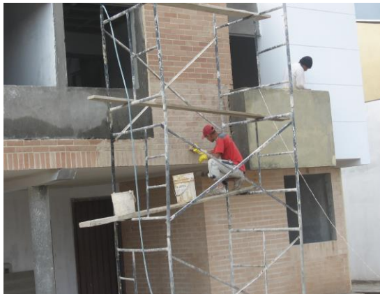
Figura 49. y 50. Aplicación de la perlita en la fachada
