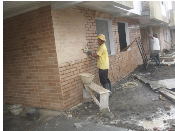
Figura 49. y 50. Aplicación de la perlita en la fachada
