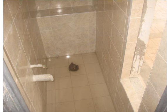
Figura 26 y 27 enchape terminado de los baños
