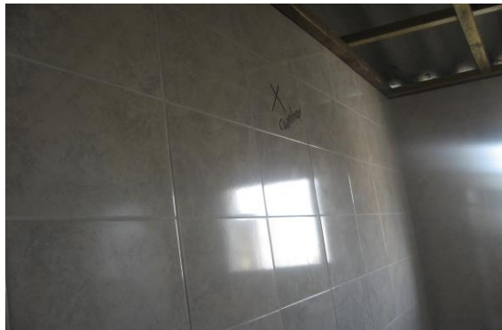
Figura 24 y 25. Enchape muro de los baños
