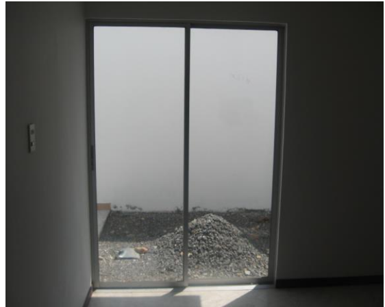
figura 66. Puerta ventana del comedor
