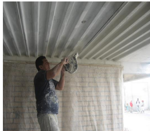
Figura 74. Aplicación de la perlita
