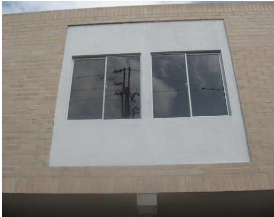
Figura 65. Ventanas del segundo piso
