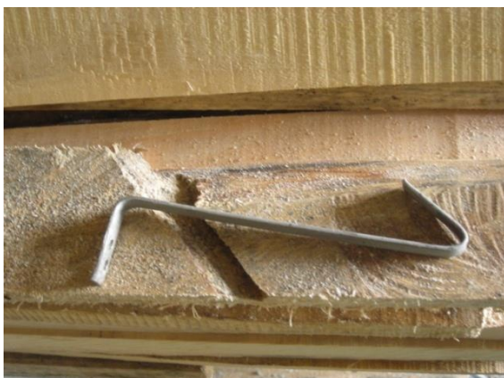
Figura 69. Gancho sujetador de las hojas de asbesto figura 70. Tensores
