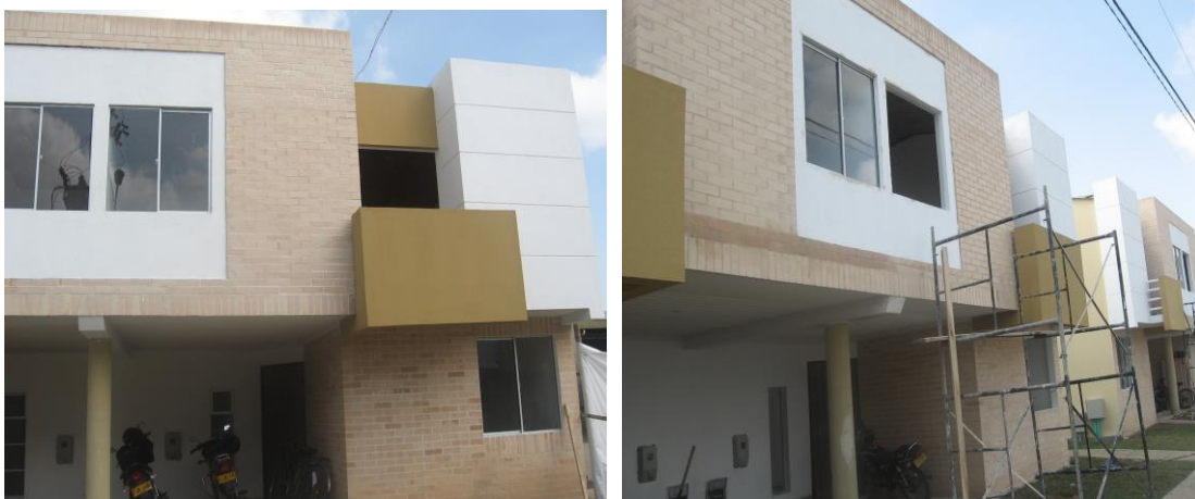
Figura 51. y 52. Fachada terminada
