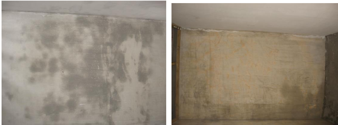
Figura 15. Y 16. Estuco aplicado en zonas húmedas
