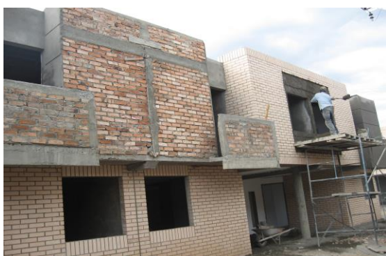
Figura 7. repellando la fachada
