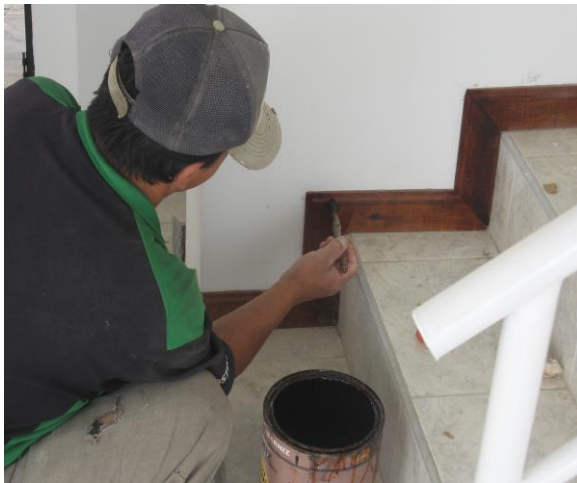
Figura 94. Aplicación del barniz al guardaescoba
