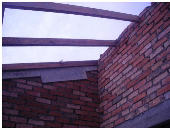
Figura 67. Ubicación de las teleras sobre las culatas Figura 68. Teleras ubicadas paralelamente
