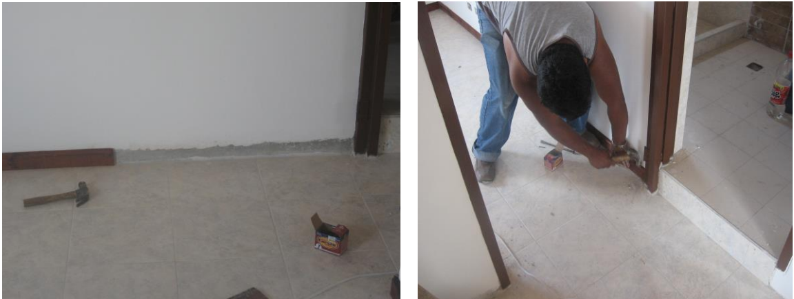
Figura 89. Y 90. Colación del guardaescoba
