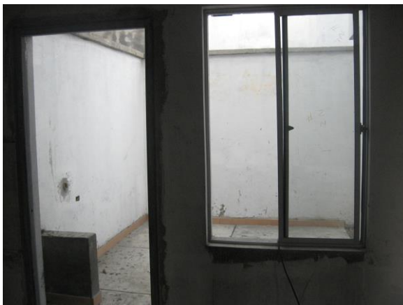
Figura 63. Ventana de la cocina
