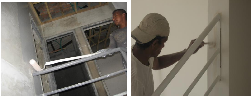
Figura 41. Y 42. Aplicación de la pintura sobre los muros
