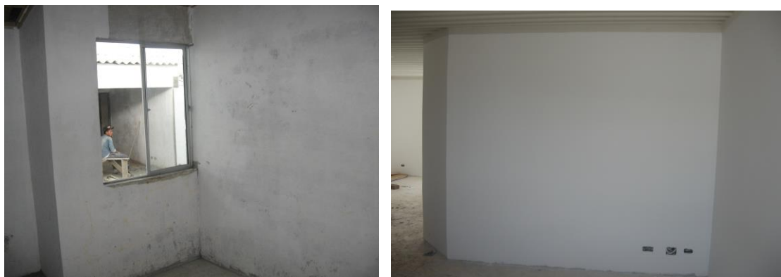
Figura 43. Muros con una sola capa de pintura Figura 44. Muros pintados
