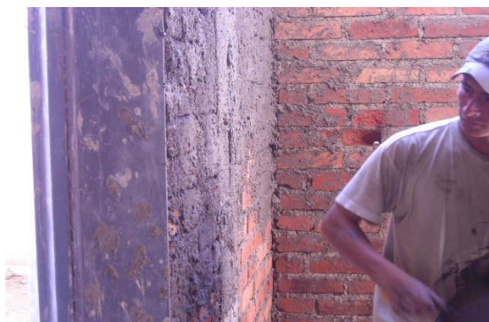
figura 5. champeo con mezcla de agua y cemento
