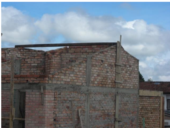
Figura 67. Ubicación de las teleras sobre las culatas Figura 68. Teleras ubicadas paralelamente
