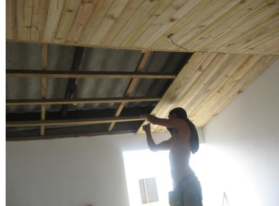
Figura 81. Y 82. Colocación del machihembre a dos aguas
