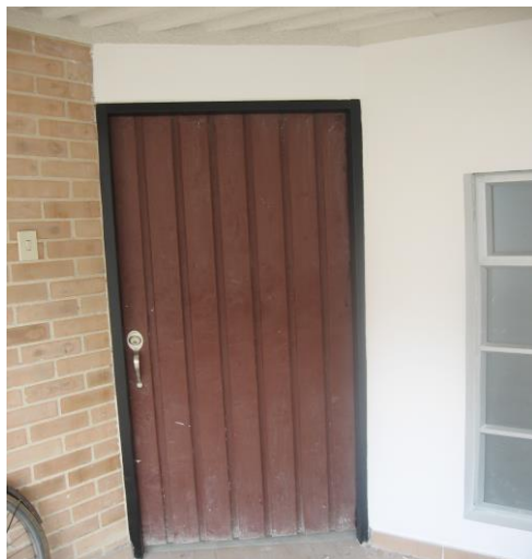
Figura 55. Puerta principal sin pintar
