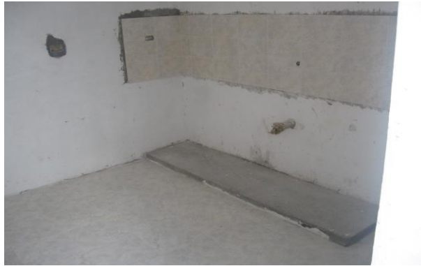
Figura 23. Muro cocina enchapado
