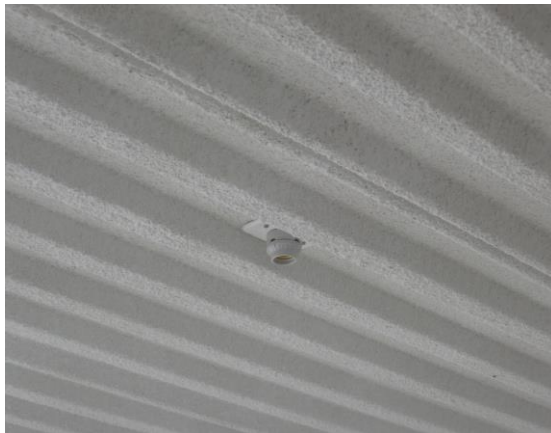
Figura 75. Y 76. Cielorraso con perlita
