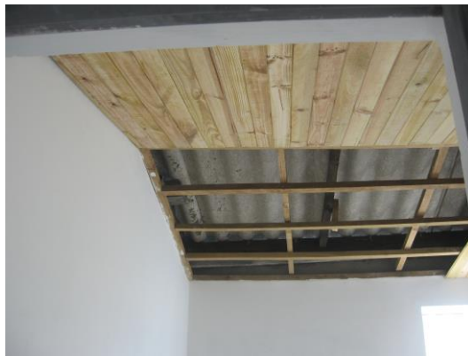
Figura 81. Y 82. Colocación del machihembre a dos aguas
