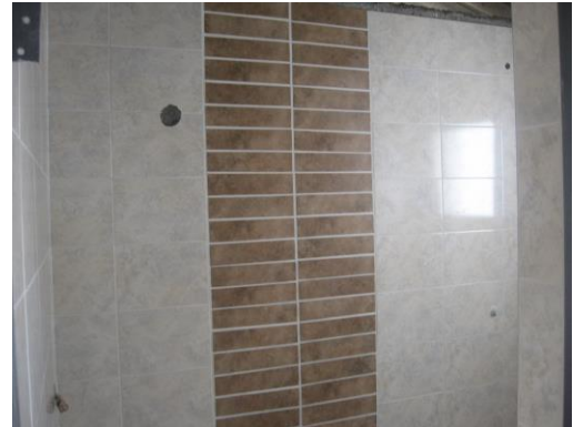
Figura 24 y 25. Enchape muro de los baños
