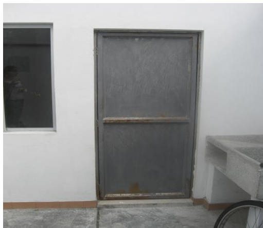
Figura 57. Puerta del patio sin pintar
