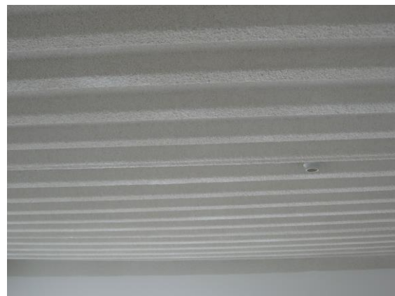
Figura 75. Y 76. Cielorraso con perlita
