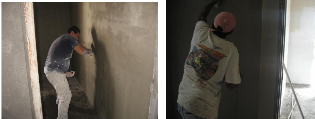
Figura 13. Y 14. Disposición del estuco sobre muros
