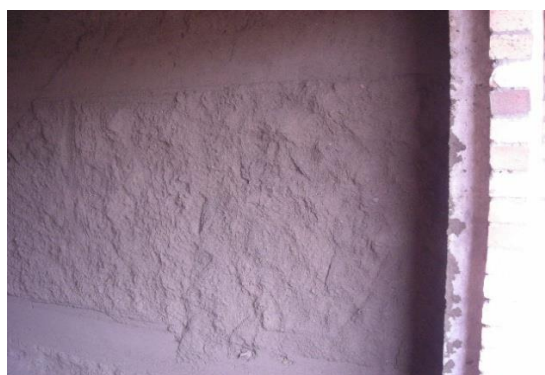
Figura 8. champeado de muro
