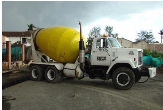
Figura N° 50. Medio de transporte del concreto: Mixer
