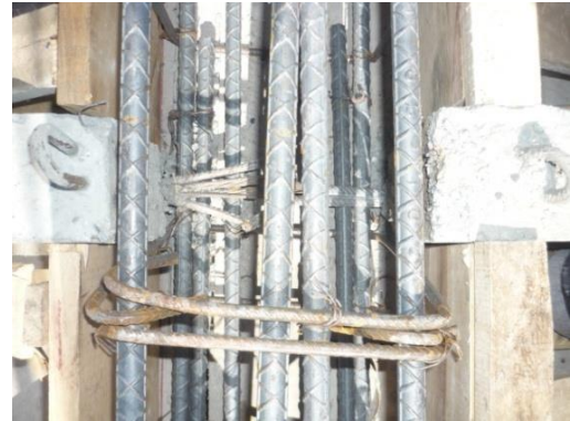
Figura N° 37. Amarre de las viguetas a las vigas principales
