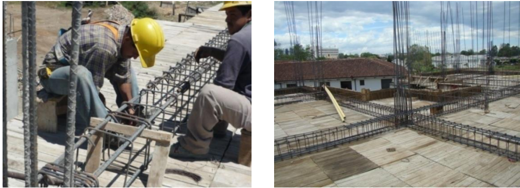
Figura N° 33. Armado de vigas
