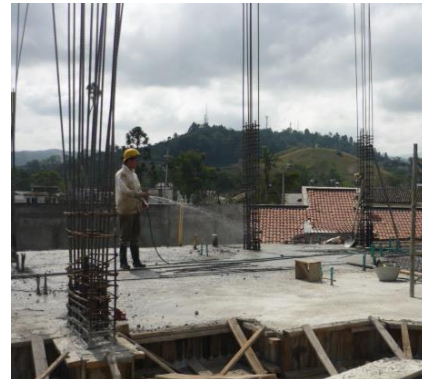
Figura N° 45. Curado de la losa
