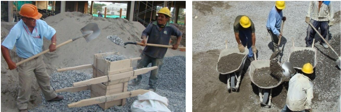
Figura N° 22. Elementos empleados en la medición de proporciones en volumen suelto
