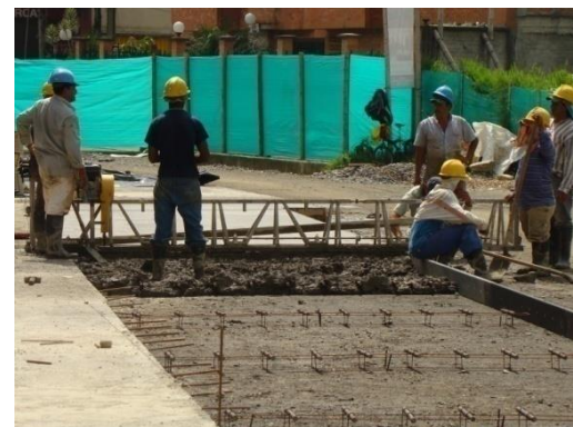
Figura N° 52. Vibrado del concreto
