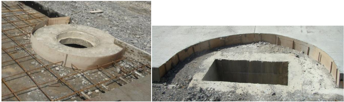
Figura N° 49. Demarcación de juntas de expansión
