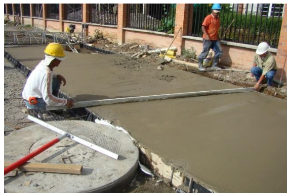
Figura N° 53. Terminado del concreto
