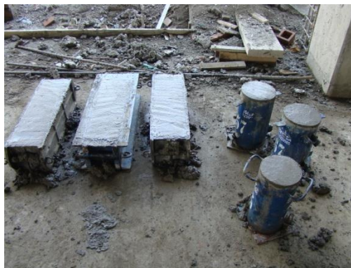
Figura N° 68. Toma de vigas y cilindros para el pavimento rígido
