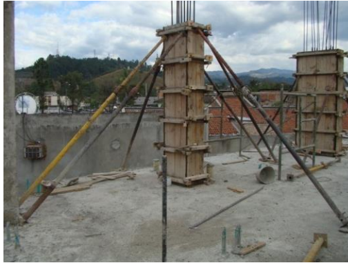
Figura N° 24. Formaleta en madera
