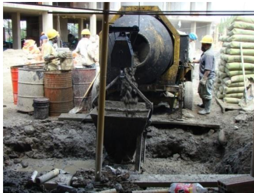
Figura N° 26. Mezclado del concreto
