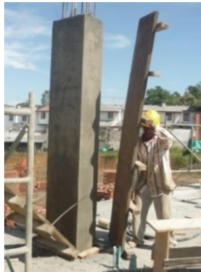
Figura N° 30. Desencofrado de columnas
