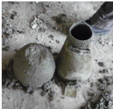
Figura N° 63. Medida del asentamiento para las columnas y pantallas
