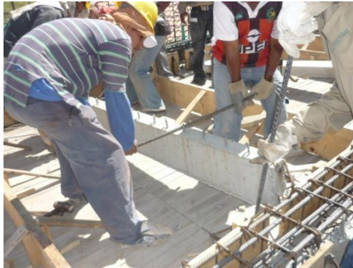
Figura N° 36. Instalación de viguetas prefabricadas
