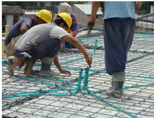
Figura N° 41. Instalaciones eléctricas
