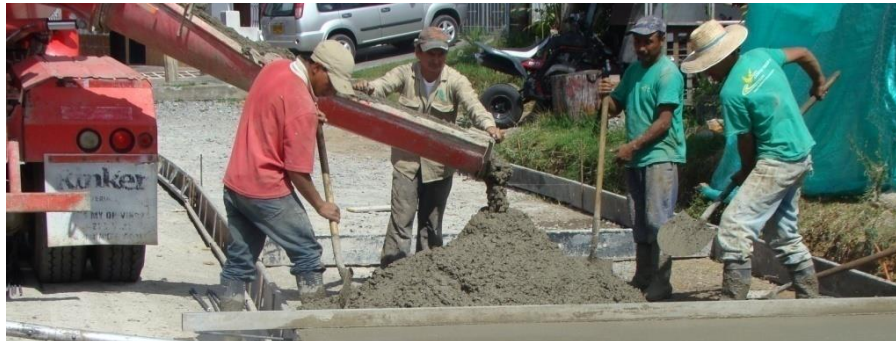
Figura N° 51. Colocación del concreto
