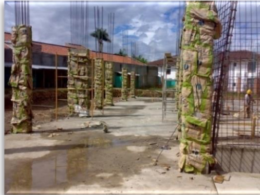
Figura N° 31. Curado con materiales sellantes
