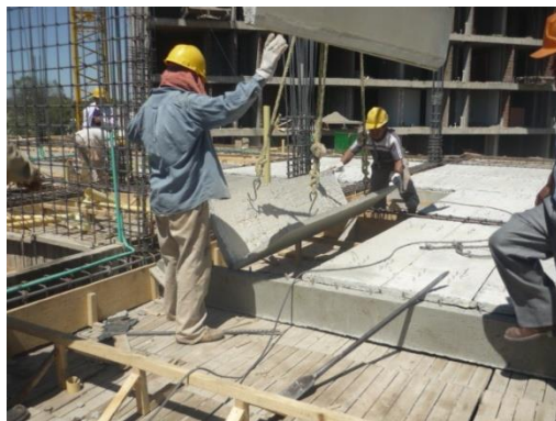
Figura N° 39. Instalación de placas prefabricadas
