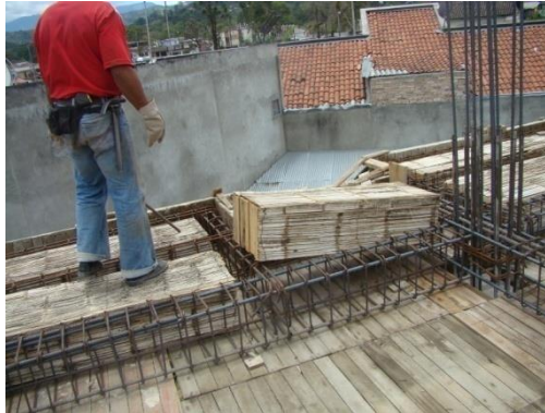
Figura N° 35. Instalación de casetones
