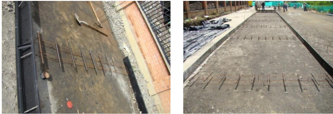
Figura N° 47. Colocación de los pasadores
