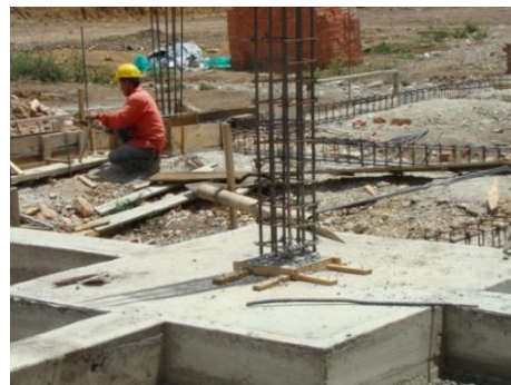
Figura N° 12. Cimentación zona de parqueaderos
