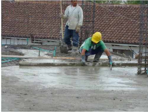
Figura N° 44. Acabado de la losa
