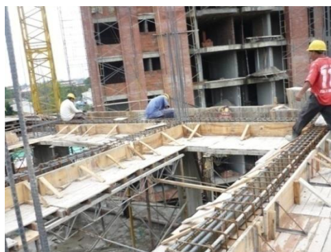
Figura N° 34. Encofrado de vigas
