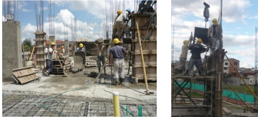
Figura N° 29. Vibrado del concreto
