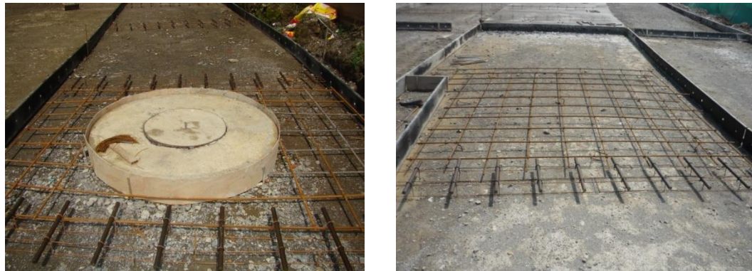
Figura N° 48. Losas que requieren refuerzo
