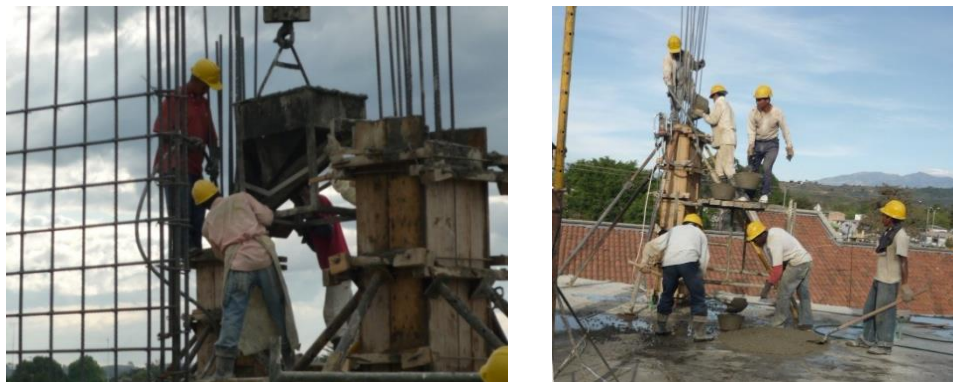
Figura N° 28. Colocación del concreto en las columnas
