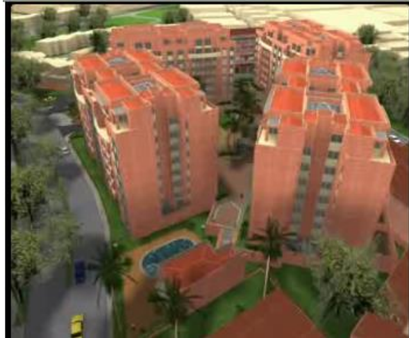
Figura N° 1. Proyecto “Conjunto Residencial La Estación”.
