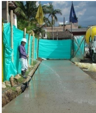
Figura N° 57. Curado del concreto
