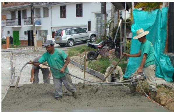
Figura N° 52. Vibrado del concreto
