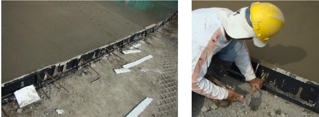
Figura N° 54. Colocación de barras de amarre
