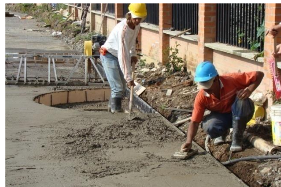
Figura N° 53. Terminado del concreto
