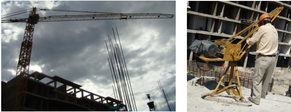
Figura N° 27. Métodos de transporte de la mezcla de concreto
