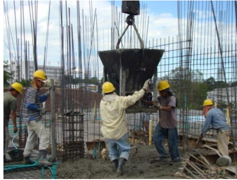
Figura N° 42. Vaciado del concreto en la losa
