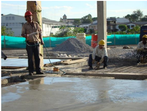
Figura N° 45. Curado de la losa
