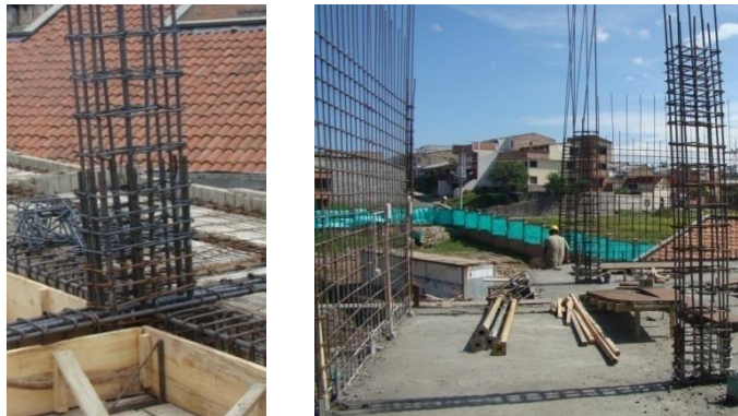
Figura N° 23. Colocación del refuerzo en columnas y pantallas
