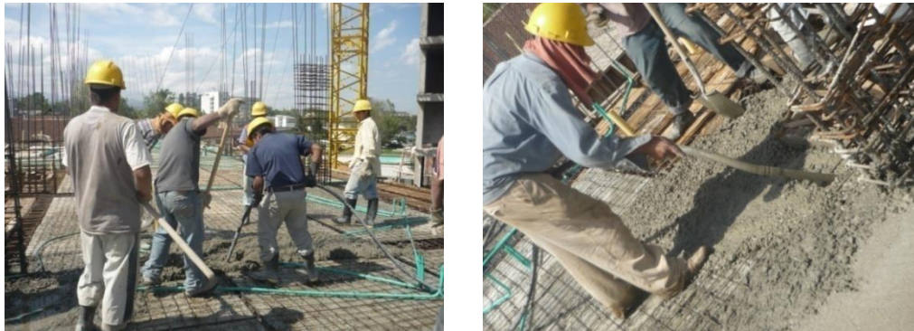
Figura N° 43. Vibrado de la losa
