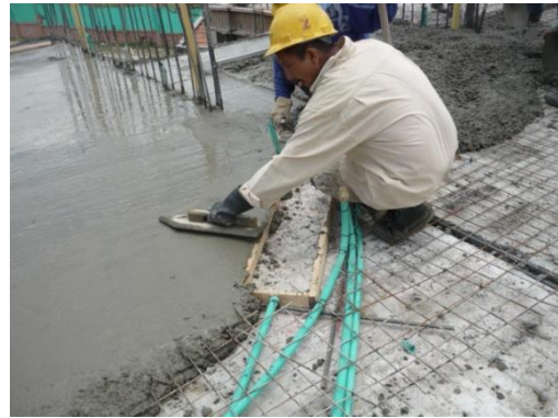
Figura N° 44. Acabado de la losa
