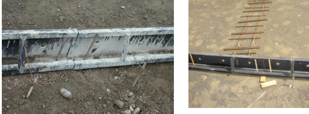
Figura N° 46. Instalación de Formaletas fijas
