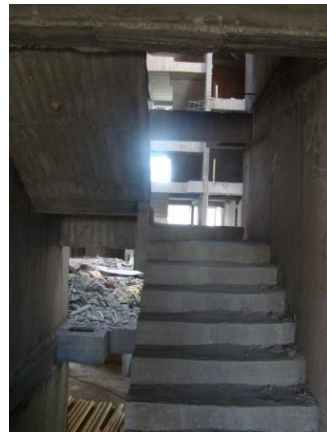
Figura N° 14. Escaleras terminadas
