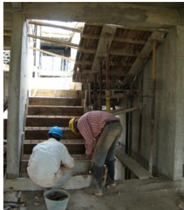
Figura N° 13. Formaleta para escaleras
