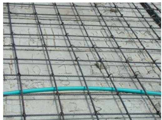
Figura N° 40. Refuerzo negativo
