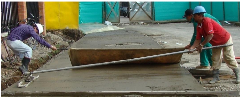
Figura N° 55. Acabado superficial usando el flotador
