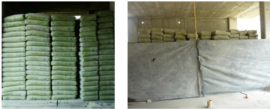
Figura N° 17. Almacenamiento cemento Argos “La Estación”
