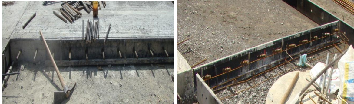
Figura N° 58. Junta transversal de construcción
