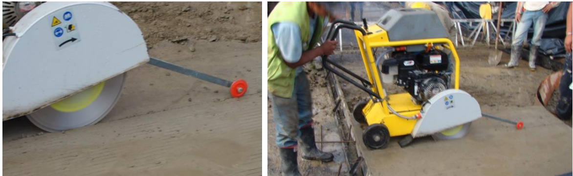
Figura N° 59. Corte de las juntas
