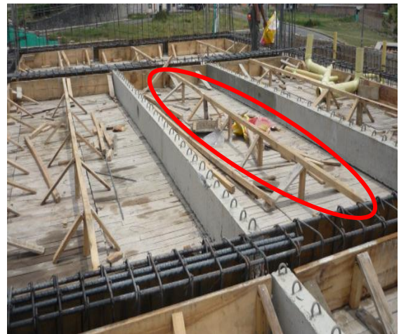
Figura 59. Apoyos entre vigas transversales
