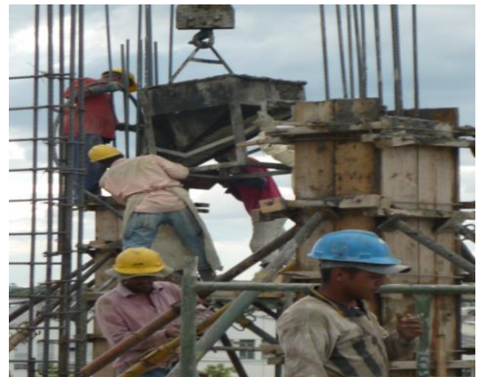
Figura 91. Colocación de concreto en la columna
