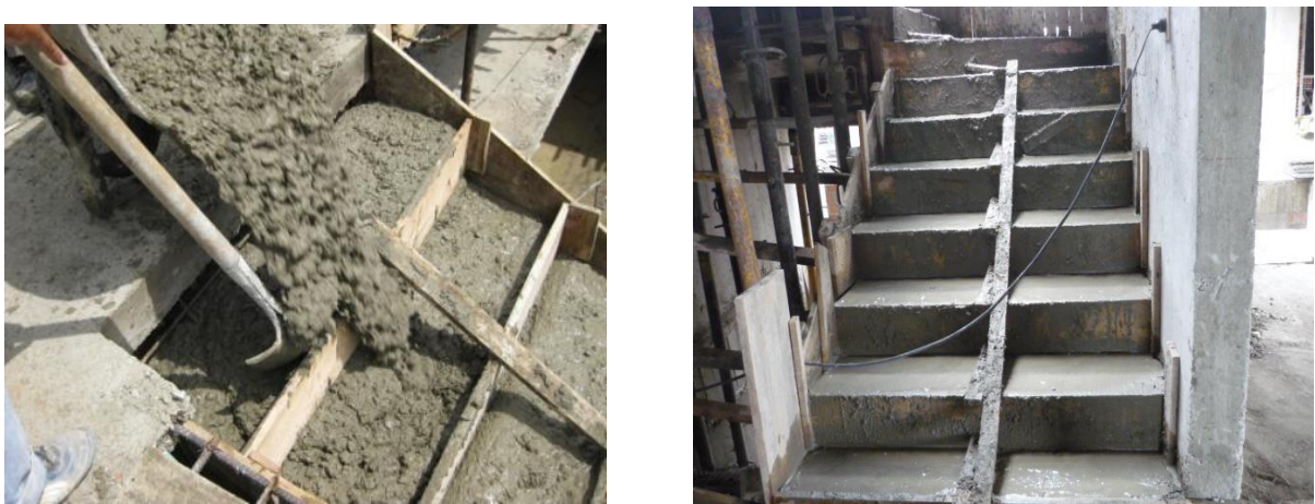
Figura 109. Colocación del acero de refuerzo y vaciado del concreto
