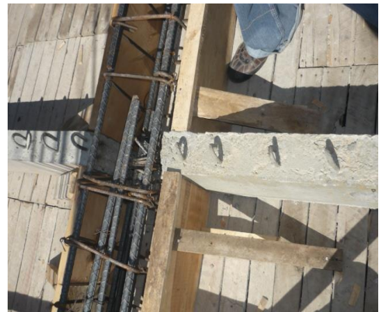
Figura 64. Colocación de las viguetas prefabricadas.
