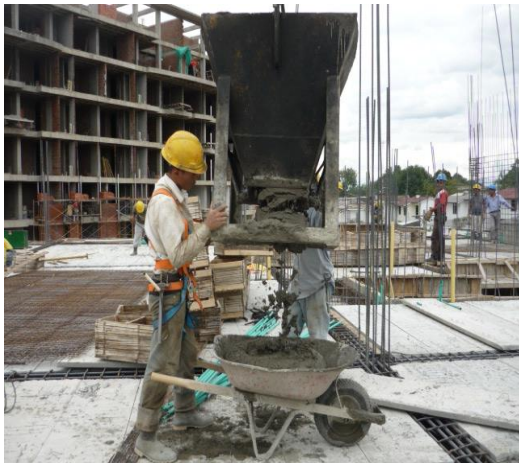
Figura 71. Transporte del concreto a través de carretillas
