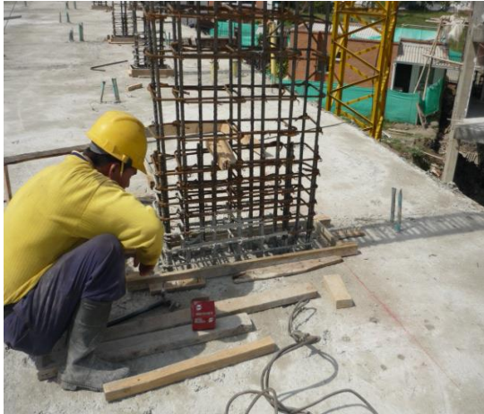
Figura 81. Armado del collarín
