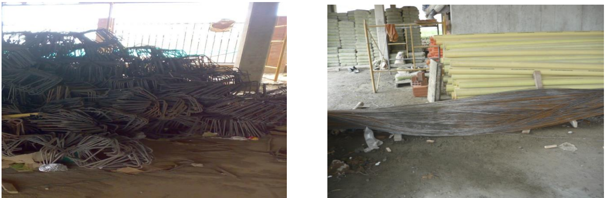
Figura 25. Almacenamiento del acero bajo techo de concreto
