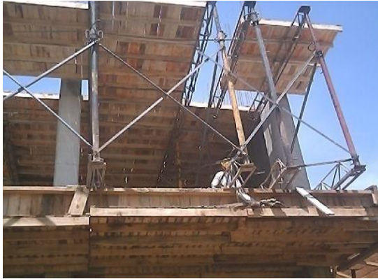
Figura 32. Encofrado de losa en voladizo
