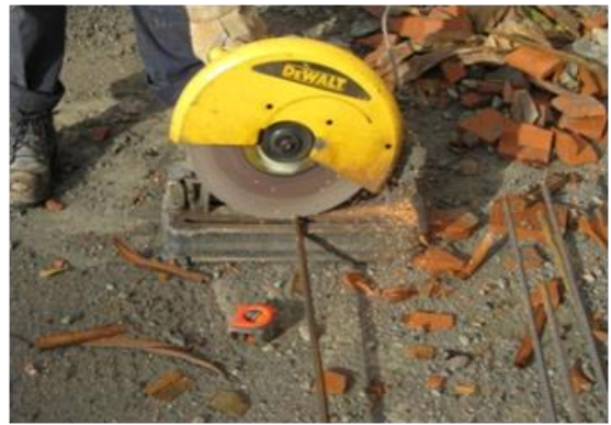
Figura 27. Corte de barras
