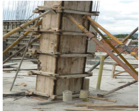
Figura 83. Columnas listas para fundir
