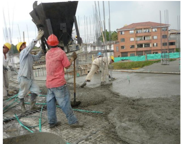
Figura 72. Vaciado de concreto
