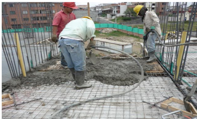
Figura 73. Vibrado en la losa
