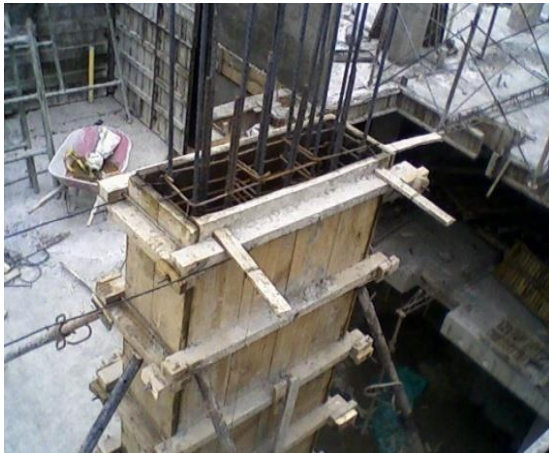
Figura 83. Columnas listas para fundir
