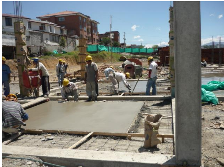
Figura 13. Cimentación zona de parqueaderos
