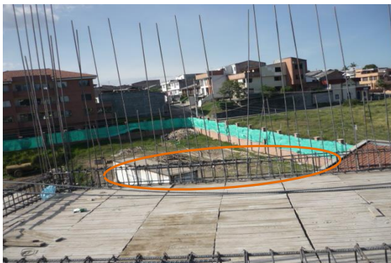
Figura 49. Separación entre estribos
