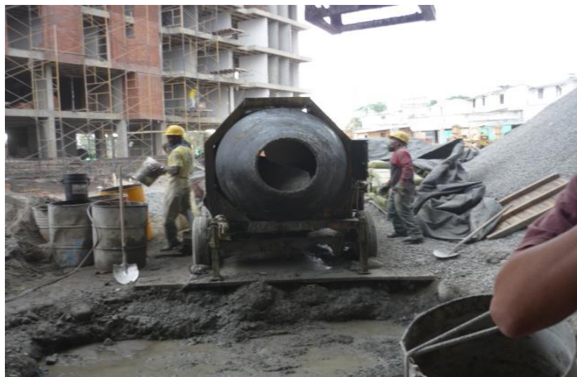
Figura 84. Preparación de la Mezcla
