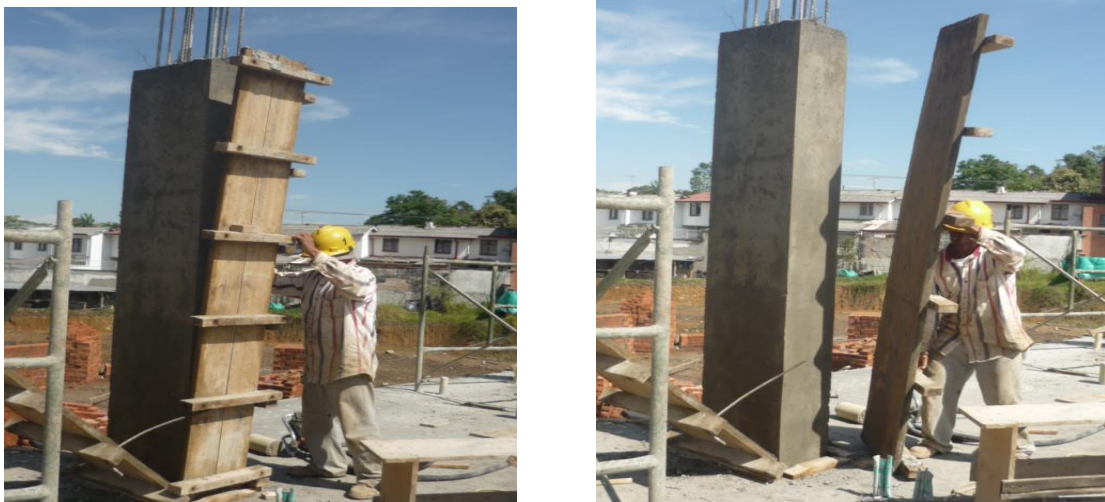
Figura 94. Columnas desencofradas
