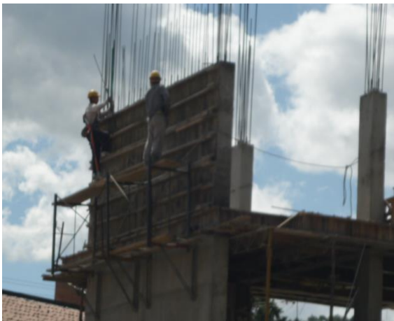
Figura 102. Armado de una pantalla
