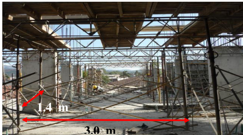
Figura 31. Sistema de soporte del encofrado de la losa
