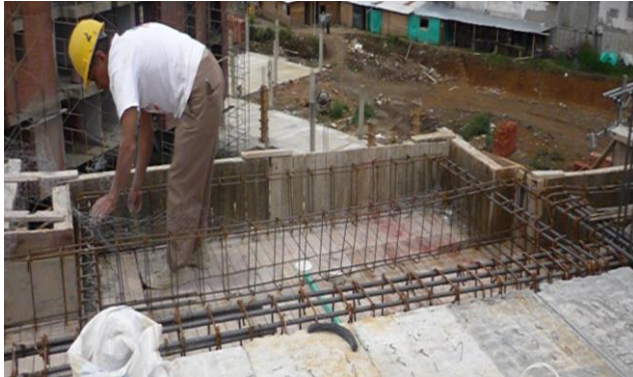
Figura 61. Colocación de la malla
