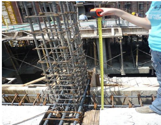
Figura 78. Chequeo de traslapos en columnas
