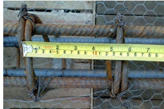
Figura 52. Separación entre estribos
