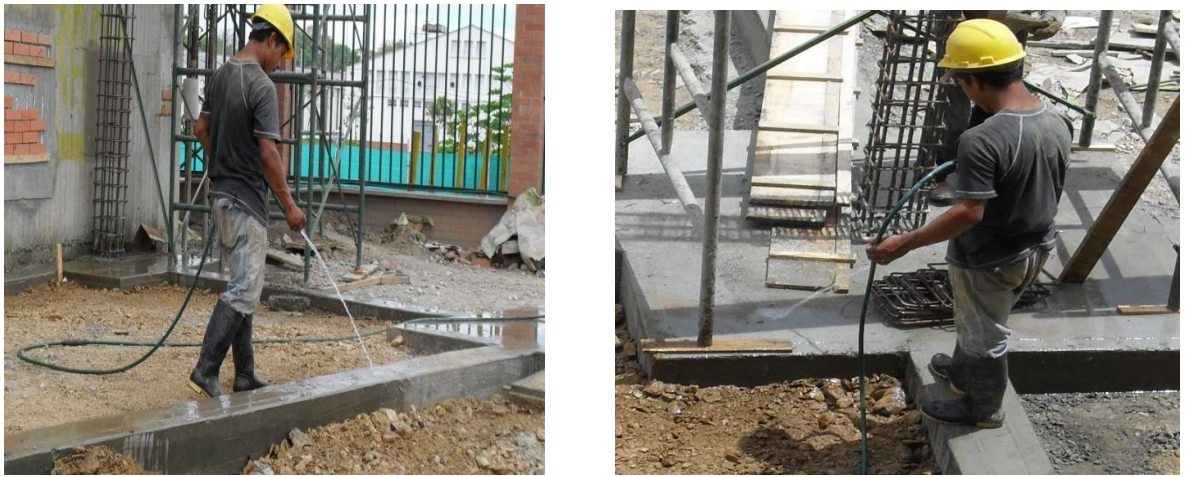
Figura 75. Suministro de curado a vigas y zapatas de cimentación
