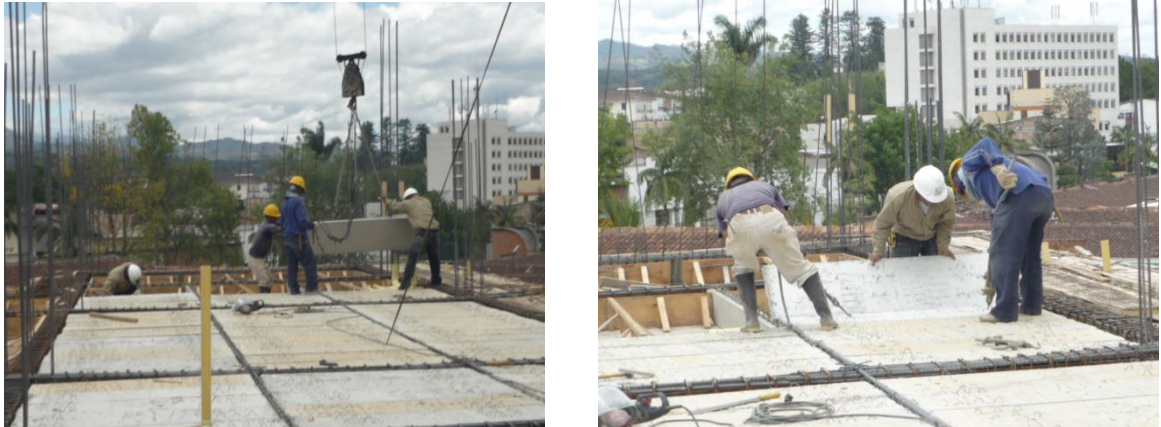
Figura 67. Colocación de placas prefabricadas.
