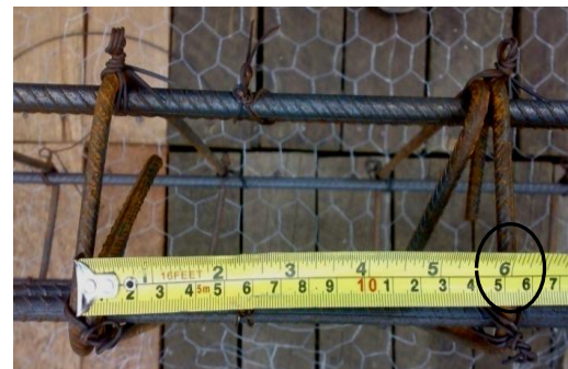
Figura 54. Separación entre estribos
