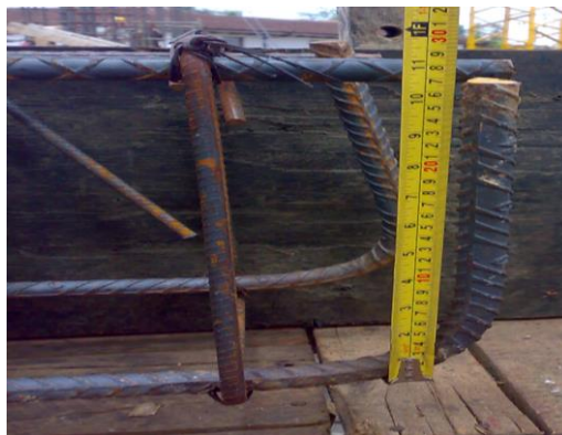
Figura 47. Longitud gancho de viga
