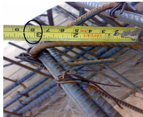
Figura 48. Longitud gancho de estribo
