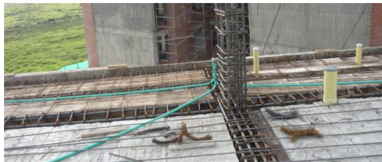
Figura 63. Instalación de casetones
