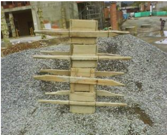
Figura 23. Elementos empleados en la medición de proporciones en volumen suelto
