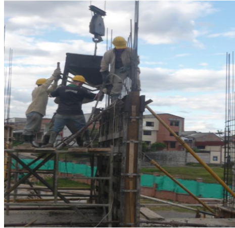
Figura 105. Transporte de concreto con pluma grúa
