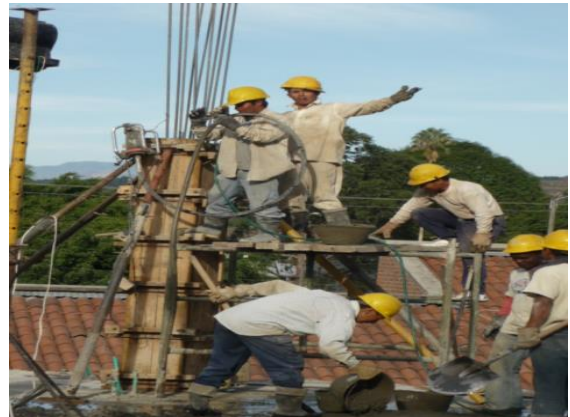
Figura 93. Vibrado de una columna
