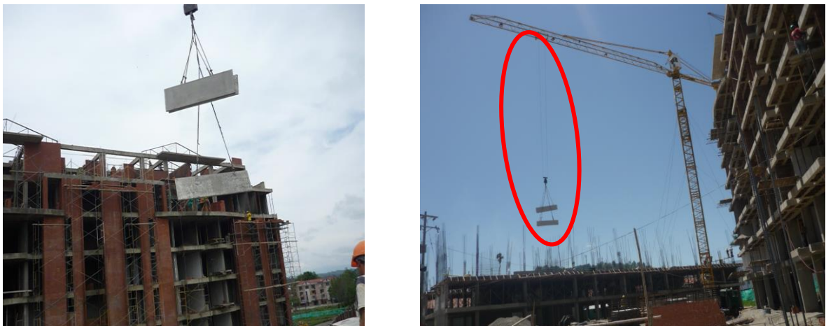
Figura 68. Transporte de elementos prefabricados.
