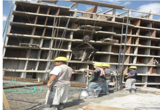
Figura 90. Bache transportado por la torre grúa
