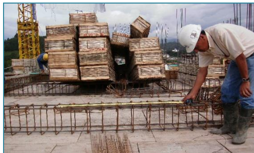
Figura 38. Verificación longitud de los traslapos
