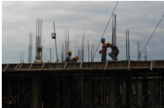
Figura 60. Encofrado de carteras externas o laterales
