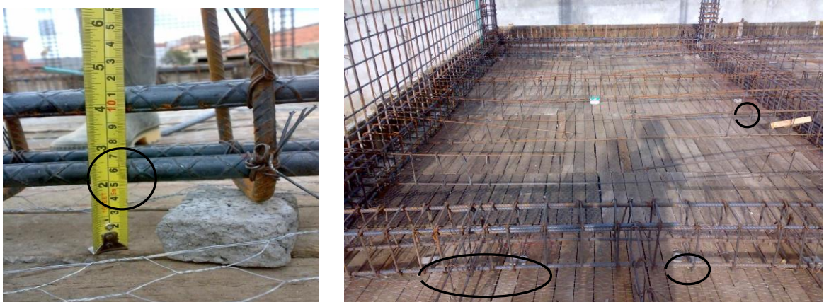
Figura 40. Recubrimiento de las vigas
