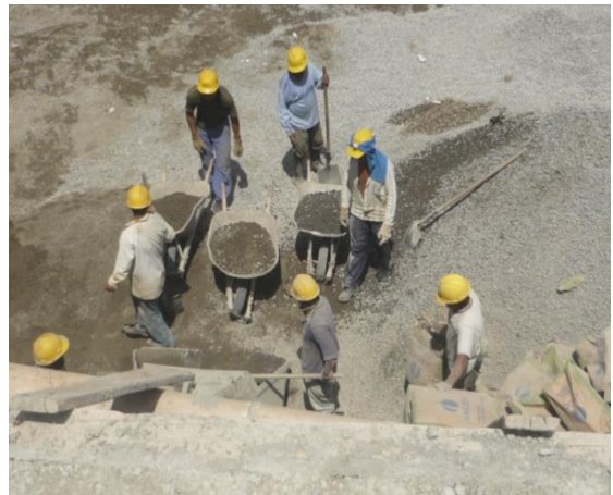
Figura 23. Elementos empleados en la medición de proporciones en volumen suelto
