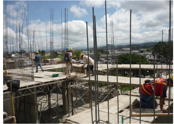
Figura 33. Avance en la colocación de tablero
