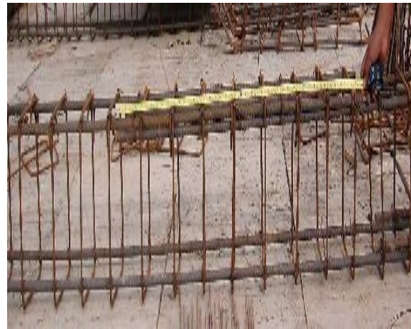
Figura 44. Medida del traslapeo
