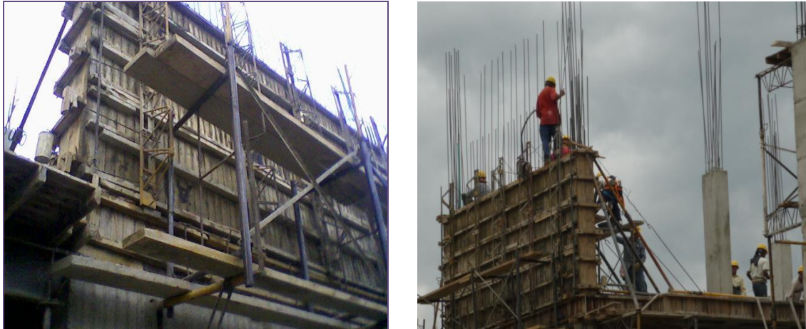
Figura 101. Montaje de formaleta en madera
