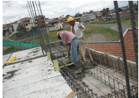
Figura 62. Solado de concreto
