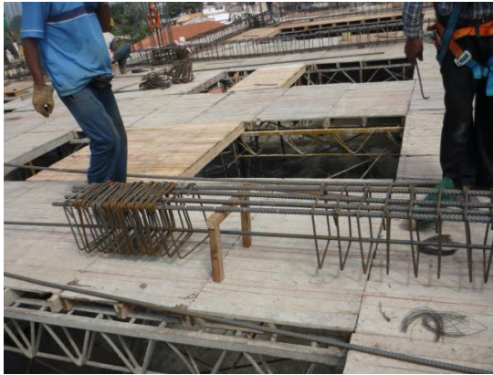
Figura 36. Armado de vigas
