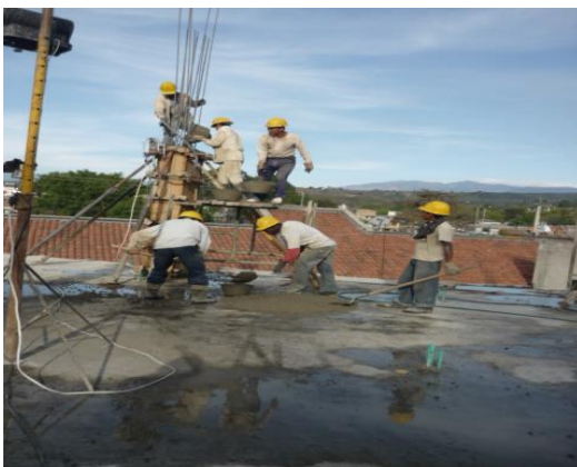
Figura 91. Colocación de concreto en la columna
