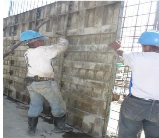
Figura 98. Montaje de formaleta manoportante
