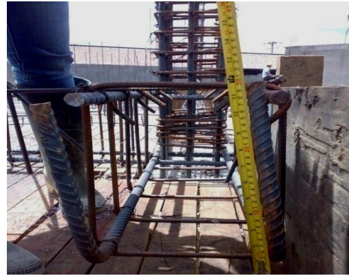
Figura 56. Longitud gancho de viga
