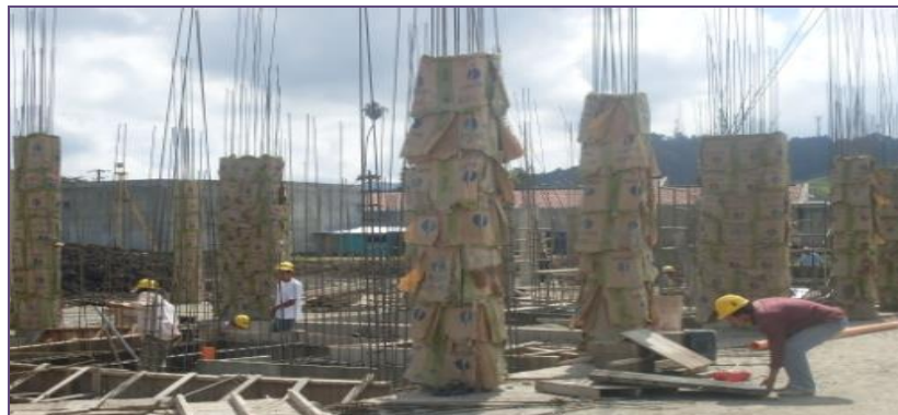
Figura 95. Curado con materiales sellantes
