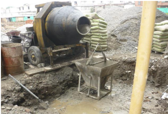
Figura 89. Descarga de la mezcla de concreto
