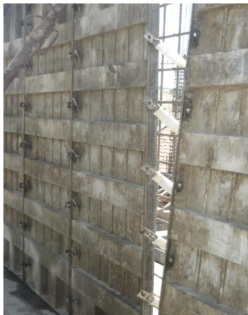
Figura 99. Formaleta externa instalada
