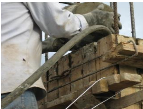
Figura 106. Transporte de concreto con pluma grúa
