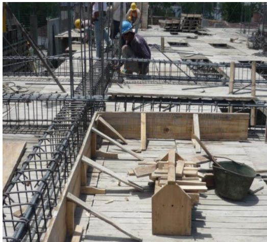
Figura 58. Encofrado de vigas
