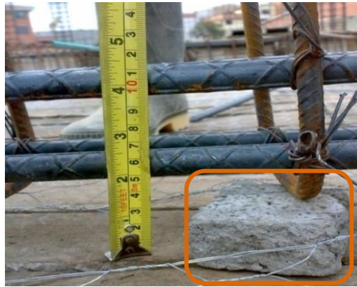
Figura 39. Colocación de paneles para garantizar recubrimiento
