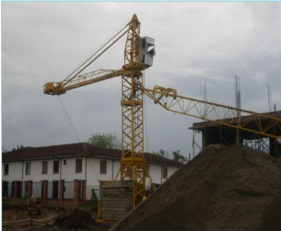
Figura 87. Armado de la Torre grúa
