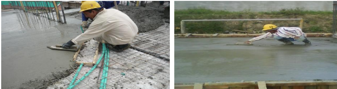
Figura 74. Acabado de la losa
