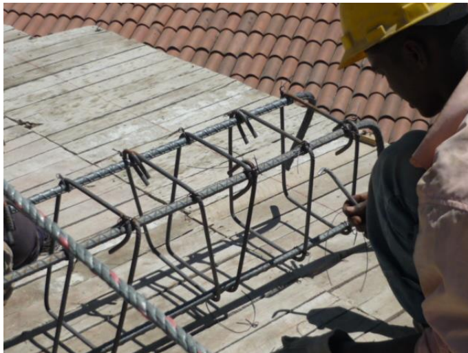
Figura 41. Gancho de los estribos
