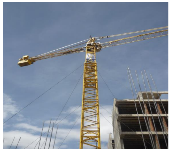
Figura 86. Torre grúa utilizada en la torre c.
