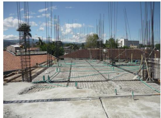
Figura 80. Columna totalmente armada
