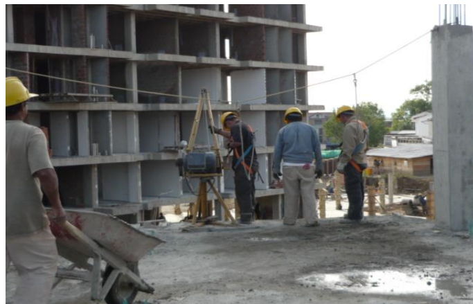
Figura 104. Transporte de concreto con pluma grúa
