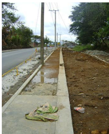
Fundición de Andenes PR0 +424 a PR0+493 (MD)
