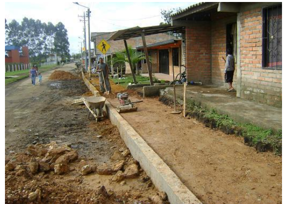
Relleno material de sitio y préstamo tramo PR0+900 – PR0+ 930(MD)
