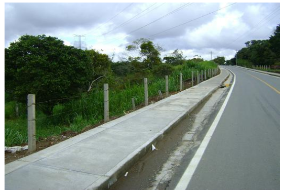
Reposición de cerca tramo PR0+000 a PR0+090.37
