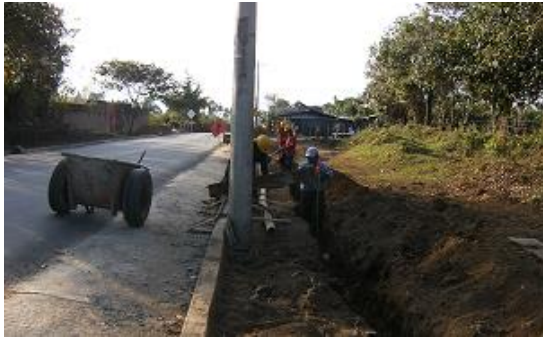
Excavación, Nivelación y compactación del suelo para construcción de andenes PR0+0515.83 (MD)
