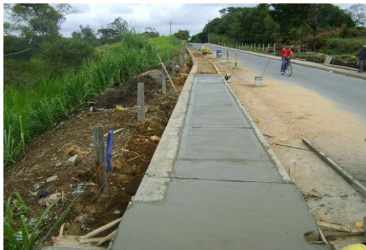
Se termina construcción de andenes en el tramo entre PR0+000 – PR0+090 (MI).
