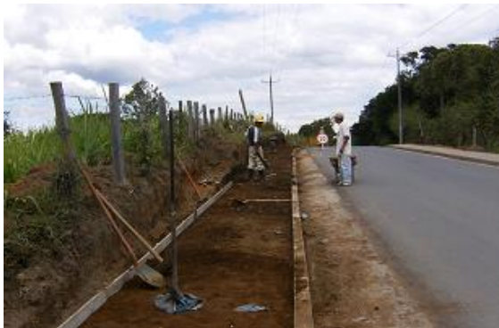
Compactación Relleno Material de sitio
