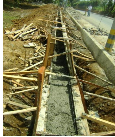
Muro de contención en Concreto ciclópeo entre PR0+0412 – PR0+493 (MD).
