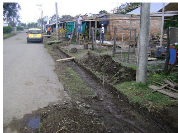
Excavaciones para bordillo en el tramo PR1+000 – PR1+050(MD)
