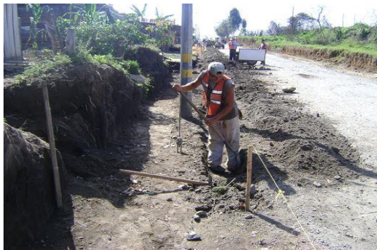
Se continúa con las excavaciones a mano tramo PR0+890 – PR0+930 (MD).
