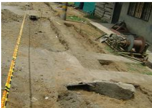
Excavación Bordillo y Anden (MD)
