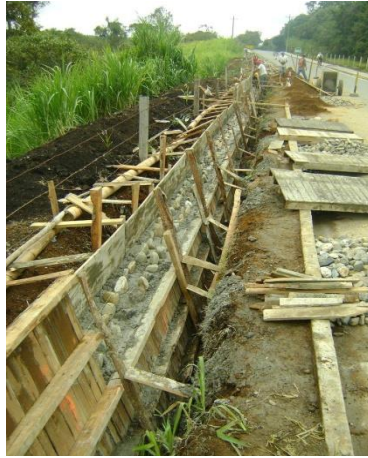
Muro de contención en Concreto ciclópeo entre PR0+000 – PR0+090 (MI).
