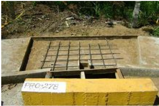
Construcción de losa PR0+0278 (MI)
