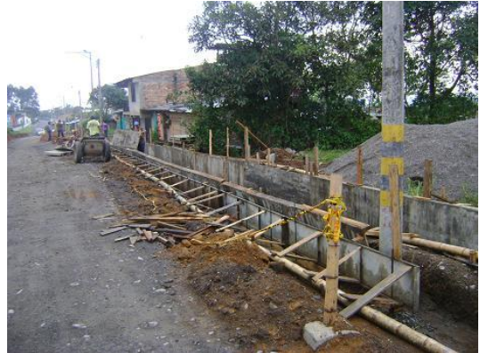
Fundición de Bordillo entre PR0+745 – PR0+780 (MD).
