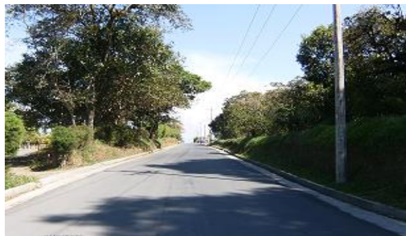
Estado inicial de la obra PR0+0280
