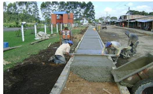
Se termina construcción de andén en el tramo entre PR1+040 – PR1+100 (MD).
