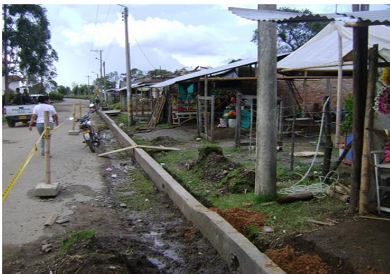
Construcción de Bordillo externo PR1+020 – PR1+100 (MD)
