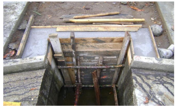
Adecuación de Alcantarillas Construcción de aletas para descole PR0+021 (MI)
