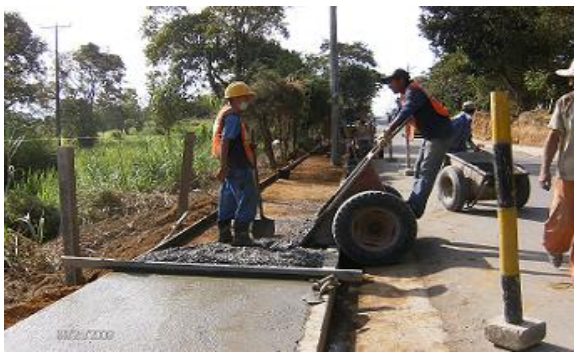
Vaciado y Curado Concreto Clase E para andenes
