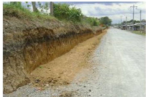
Relleno en (MI) sobre excavación
