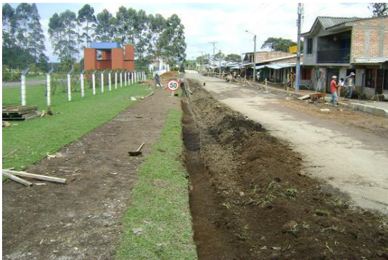
Construcción de Bordillo externo tramo PR0+913.3 – PR0+978 (MI)
