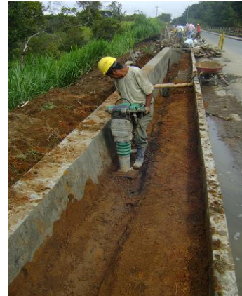
Relleno estructura muro de contención PR0+000 – PR0+090 (MI)
