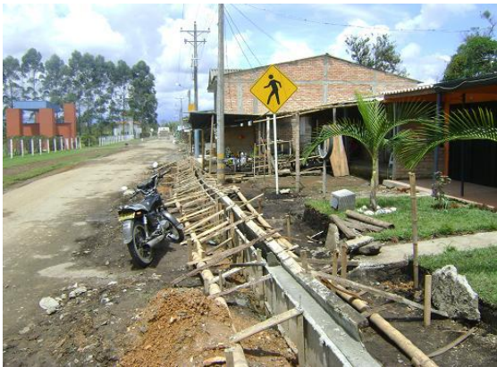
Construcción de Bordillos tramo PR0+900 – PR0+930 (MD)
