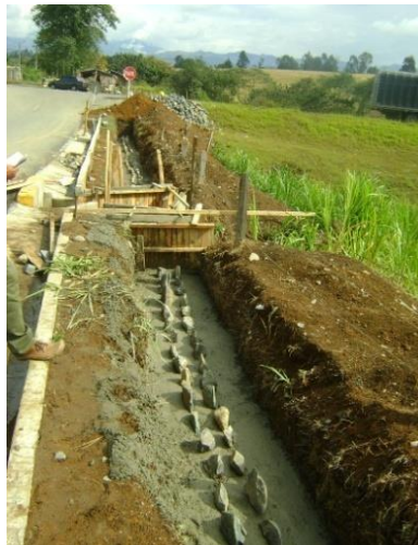
Construcción zarpa de muro de Contención PR0+020 – PR0+90 (MI)
