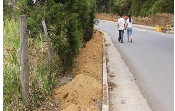
Excavación para reemplazo de suelo en malas condiciones
