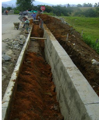
Relleno estructura muro de contención PR0+000 – PR0+090 (MI)
