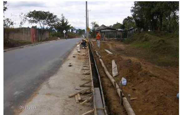
Constricción de Sardineles
