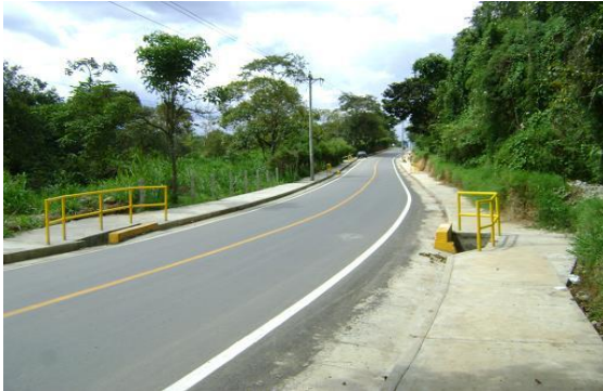
Se instalaron barandas de seguridad en alcantarillas existentes en la vía
