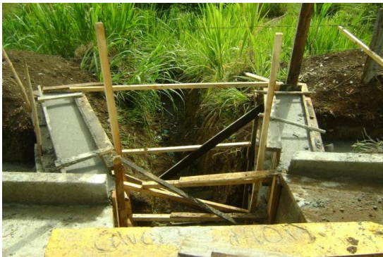
Adecuación de Alcantarillas Construcción de aletas para descole PR0+021 (MI)
