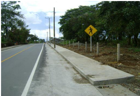
Reposición de cerca tramo PR0+407 a PR0+488
