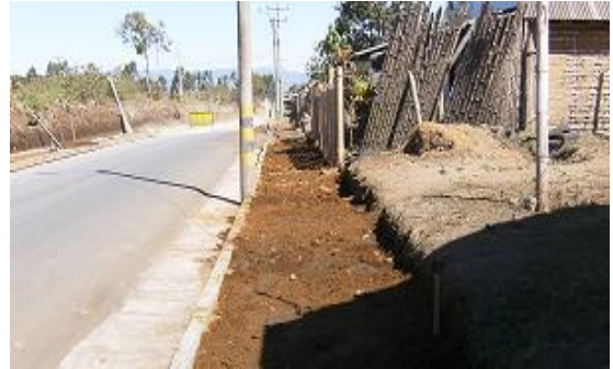
Excavación, Nivelación y compactación del suelo para construcción de andenes PR0+0515.83 (MD)
