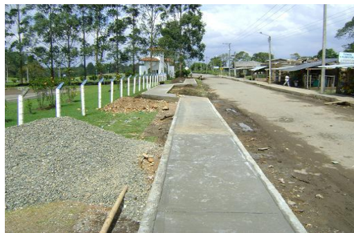
Se termina construcción de andén en el tramo entre PR0+990.5 – PR1+060 (MI).
