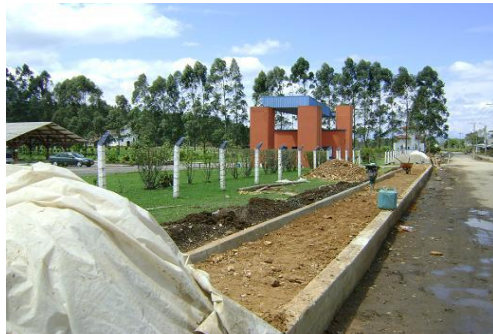
Se termina construcción de andén en el tramo entre PR1+040 – PR1+100 (MD).
