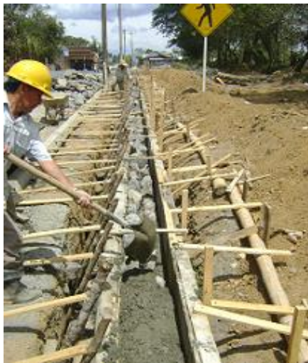
Vaciado en concreto Ciclópeo para muros y relleno de la Estructura
