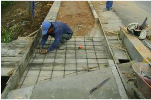
Construcción de losa PR0+0021 (MI)
