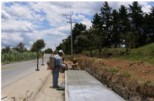
Vaciado y Curado del Concreto clase E
