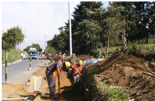
Excavación, Nivelación y Compactación del suelo para construcción de andenes en PR0+0000(MD)
