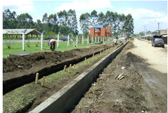
Construcción de Bordillo externo tramo PR0+913.3 – PR0+978 (MI)
