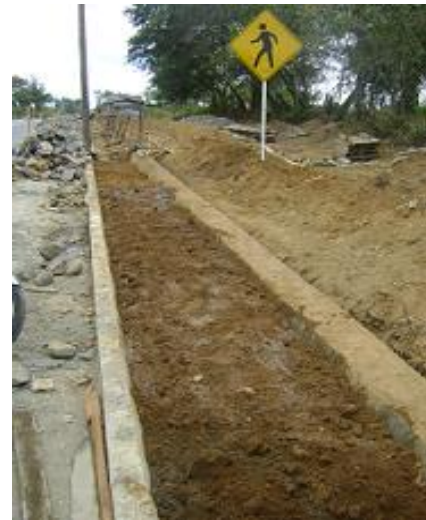
Vaciado en concreto Ciclópeo para muros y relleno de la Estructura
