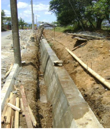
Muro de contención en Concreto ciclópeo entre PR0+0412 – PR0+493 (MD).
