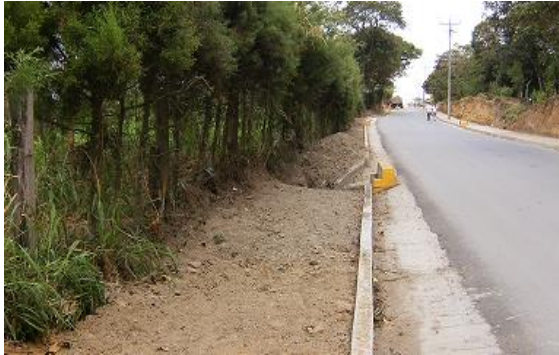
Excavación para reemplazo de suelo en malas condiciones
