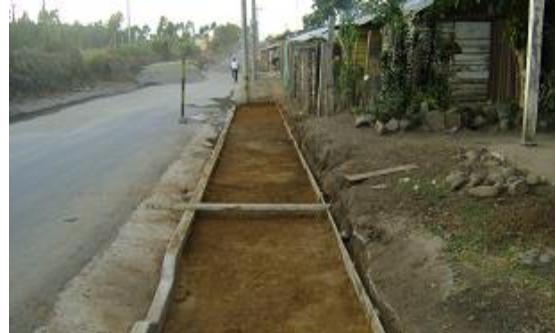
Excavación, nivelación y compactación del suelo para construcción de andenes PR0+0550(MD)
