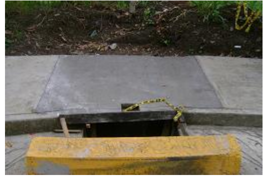
Finalización losa PR0+0021 (MI)
