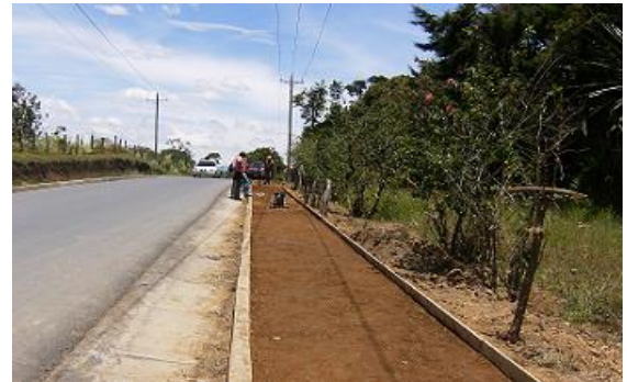
Excavación, Nivelación y Compactación del suelo para construcción de andenes en PR0+0000(MD)
