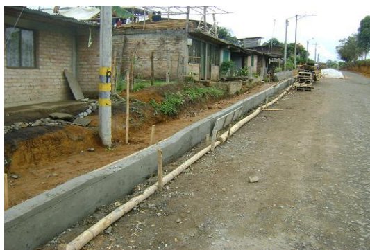
Construcción de Bordillos tramo PR0+780 – PR0+860 (LD)
