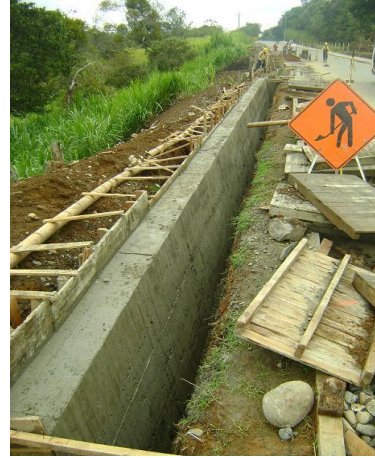
Muro de contención en Concreto ciclópeo entre PR0+000 – PR0+090 (MI).
