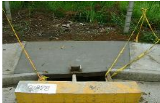
Finalización losa PR0+0278 (MI)
