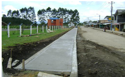
Se termina construcción de andén en el tramo entre PR0+913.3 – PR0+978 (MI).
