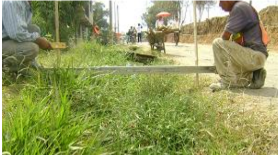
Excavación, nivelación y compactación del suelo para construcción de andenes PR0+0550(MD)
