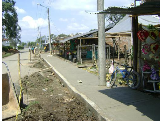
Construcción de andenes en el tramo PR1+020 – PR1+040 (MD).
