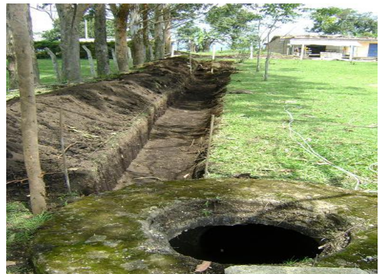
Se inicia canal de desagüe aguas lluvias desde alcantarilla ubicada en el PR1+060 hasta cámara de inspección.
