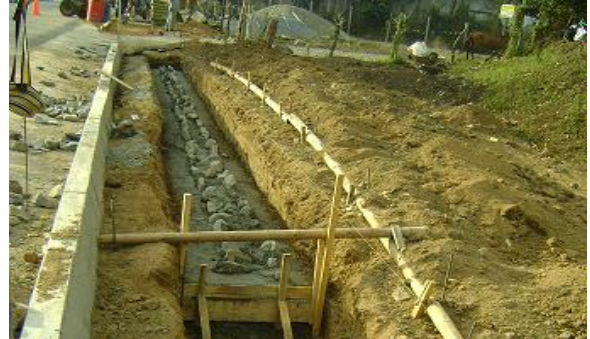
Excavación para muros de concreto Ciclópeo
