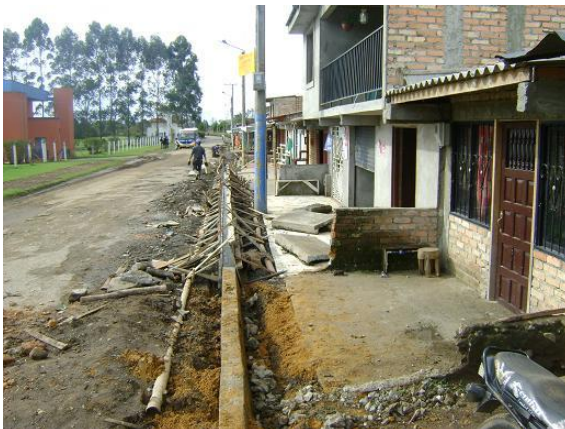
Construcción de Bordillos tramo PR0+931 – PR1+000 (MD)
