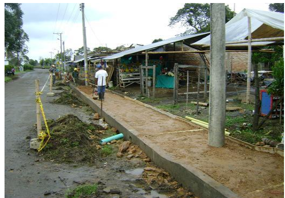
Continua con el relleno estructura con material de préstamo PR1+020 – PR1+040 (MD)
