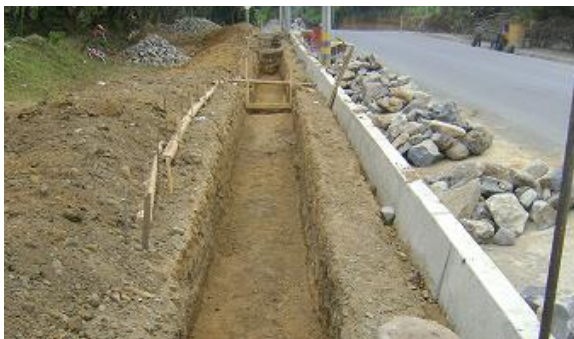
Excavación para muros de concreto Ciclópeo
