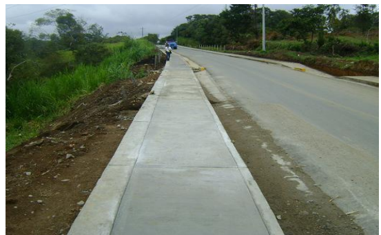
Construcción de Bordillos tramo PR0+870 – PR0+ 890 (LD)
