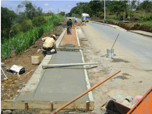
Fundición de Anden entre PR0+000 – PR0+020 (MI).
