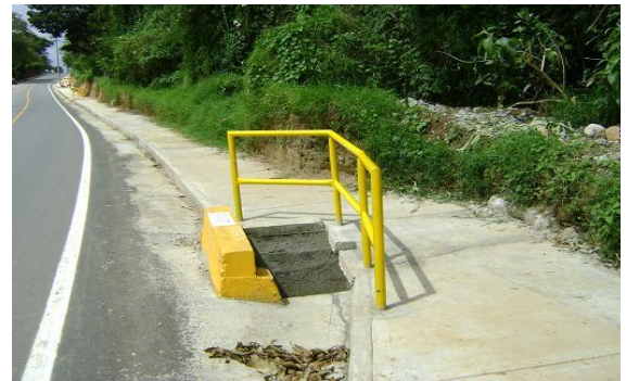
Se instalaron barandas de seguridad en alcantarillas existentes en la vía
