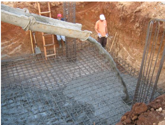
Fundida con premezclado de la zapata de cimentación
