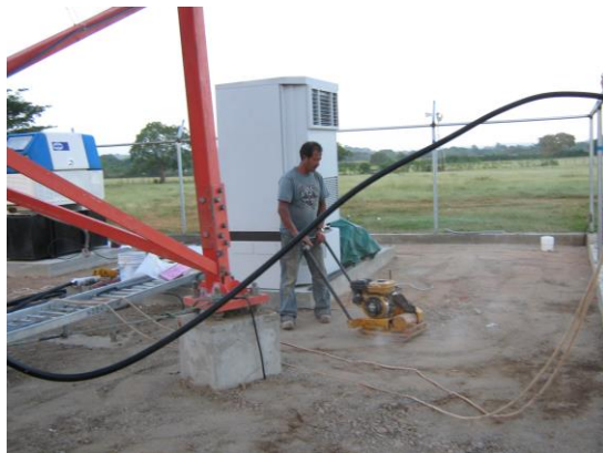
Detalle de la nivelación con material seleccionado en toda la estación
