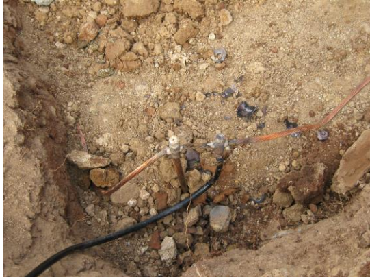
Detalle de soldadura Cadwell para conformación del sistema de puesta a tierra
