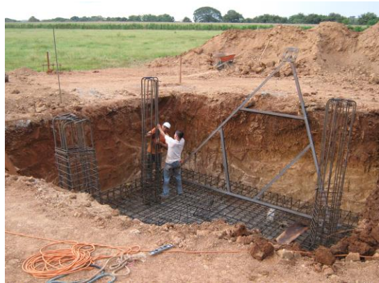
Ubicación y montaje de pernos de anclaje de la torre
