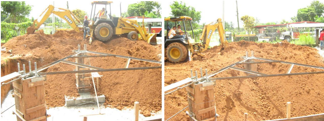
Formaleta y fundida de placa para equipos
