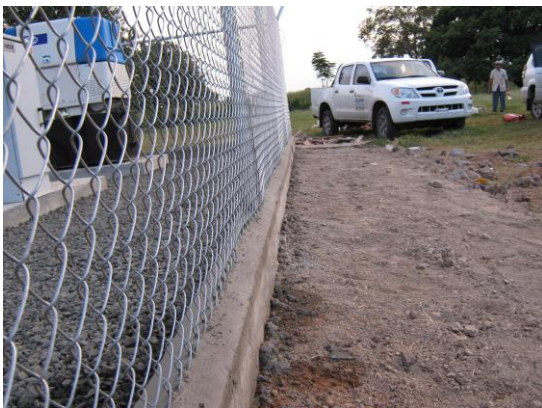
Mortero de fijación de la malla ciclón sobre viga de cerramiento
