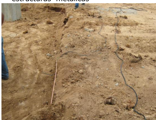
Cable 1/0 para conformación del anillo de tierras y colas para aterrizaje de estructuras metálicas
