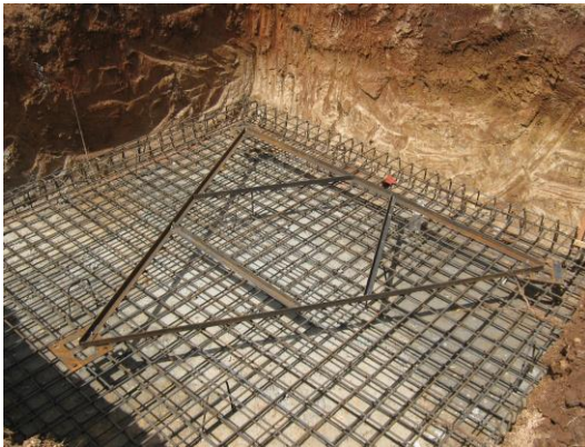
Fundida con premezclado de la zapata de cimentación
