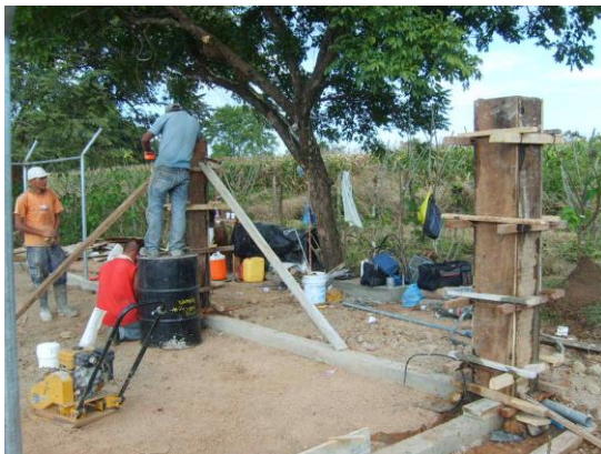
Fundida de columnas para soporte del portón
