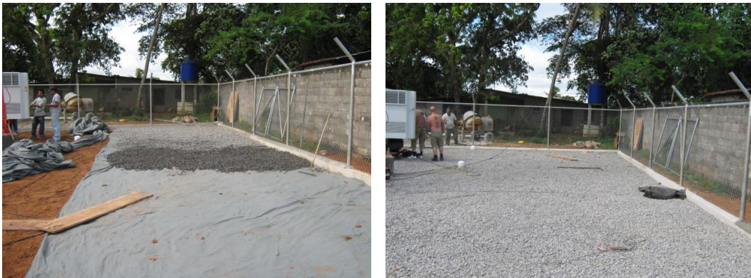
Geotextil y extendida de gravilla
