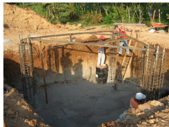
Ubicación y montaje de pernos de anclaje de la torre
