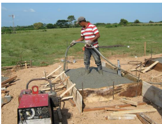
Formaleta y fundida de placa del Generador
