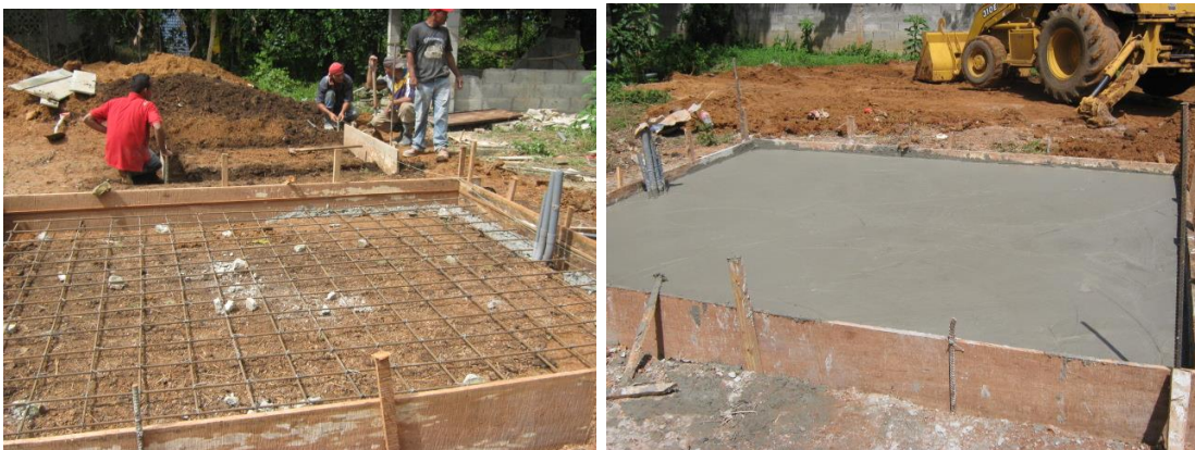
Formaleta y fundida de placa para equipos
