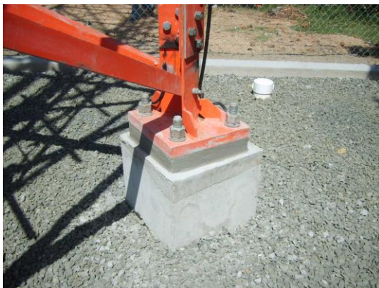
Formaleta y fundida de placa del Generador
