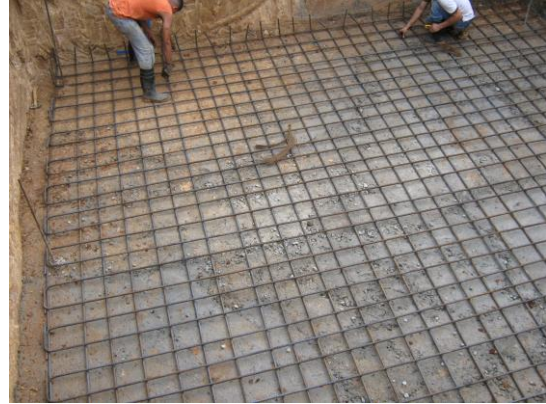
Colocación de refuerzo para pedestales
