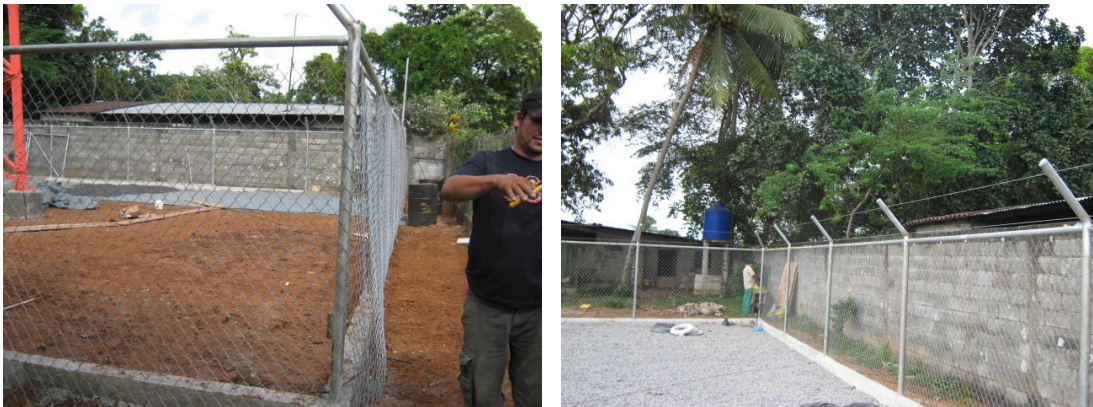
Colocación de malla ciclón cerramiento
