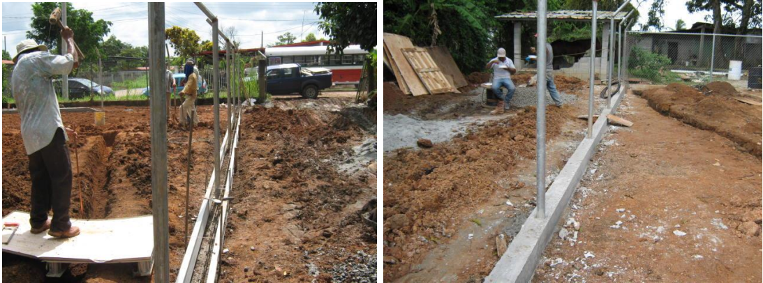
Fundición de columnas para soporte del portón
