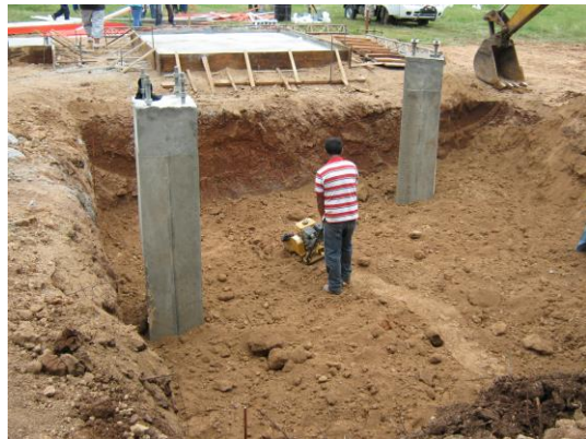
Compactación del material de relleno
