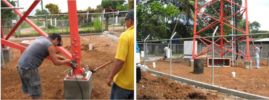
Conformación del anillo de tierras y colas para aterrizaje de estructuras metálicas.
