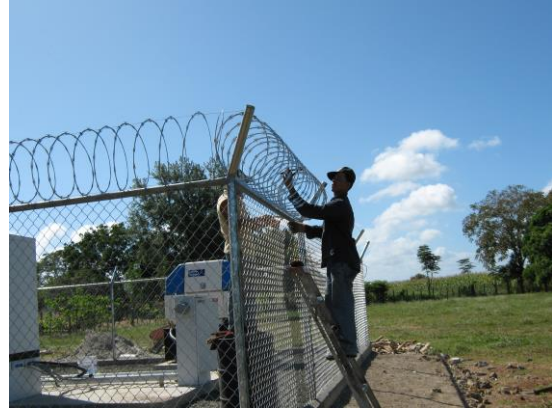
Instalación de concertina cerramiento
