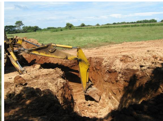
Excavación mecánica para la cimentación de la torre
