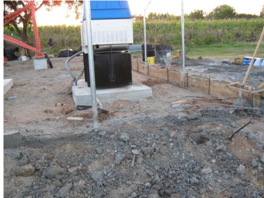
Formaleta y fundida de placa de equipos
