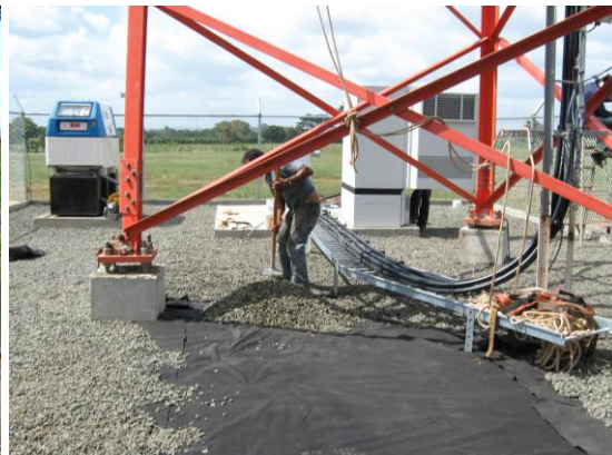
Geotextil y extendida de gravilla
