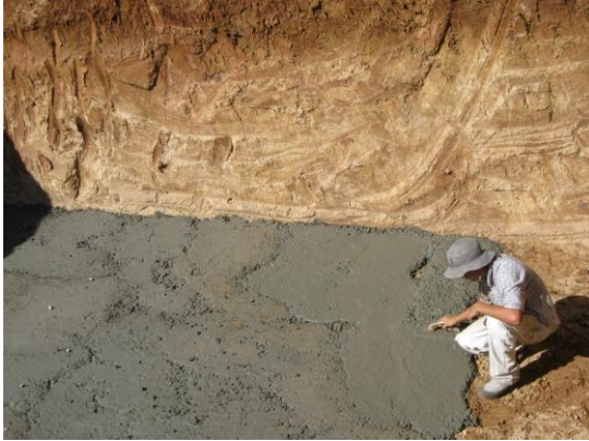
Armada y colocación de plantilla para ubicación de pedestales
