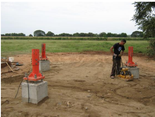
Nivel de terminación del relleno con material de sitio
