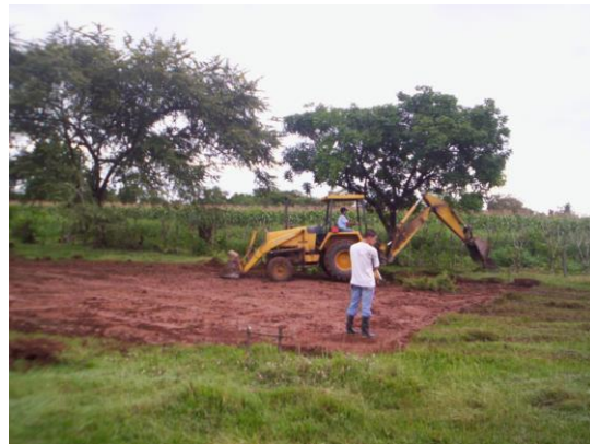
Limpieza y descapote del terreno
