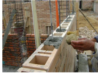
Figura No. 119 Fundición de las dovelas
