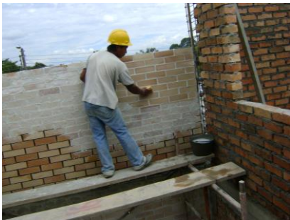
Figura No. 108 Limpieza de muro
