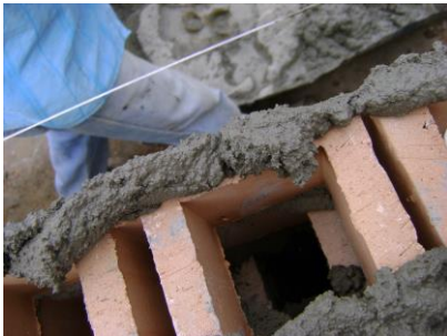
Figura No. 114 Dovelas
