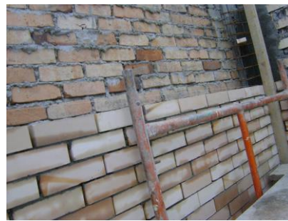
Figura No. 107 andamios para pega ladrillo
