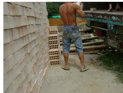
Figura No.37 Colocación de ladrillo
