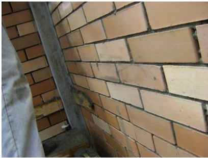
Figura No. 106 Aplomado de muro
