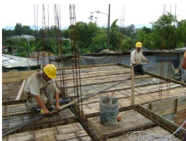
Figura No.54 Chequeo de corte de barras
