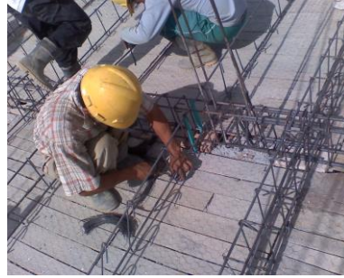
Figura No. 132 Amarre de refuerzo para nervios
