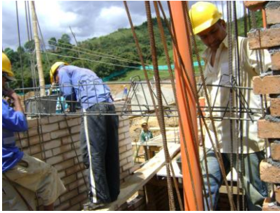
Figura No. 118 Fundición las dovelas
