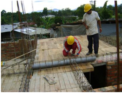
Figura No. 131 Colocación de malla con vena
