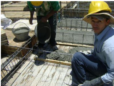
Figura No. 135 Colocación de torta
