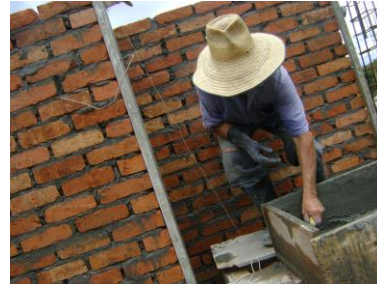
Figura No. 99 Mezcla del mortero 1:3
