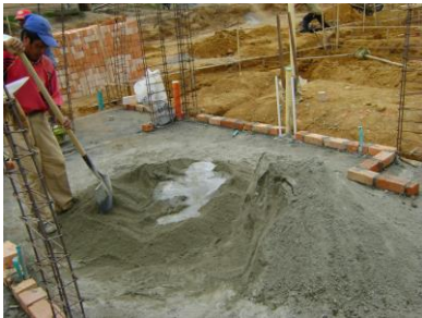
Figura No. 102 Mezcla del mortero para pega
