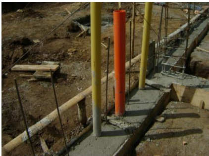
Figura No. 87 Cimentación terminada
