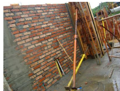
Figura No. 90 Apoyos para dar rigidez a la formaleta
