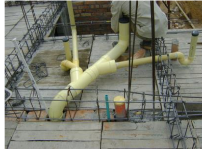
Figura No. 134 Instalación sanitaria (muñeco)
