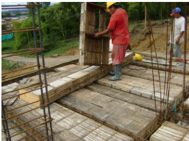
Figura No. 137 Instalación de casetones
