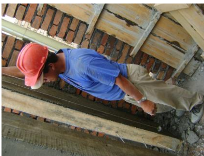
Figura No. 91 Chequeo del plomo de columna
