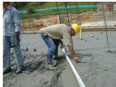
Figura No. 146 Acabado de la losa
