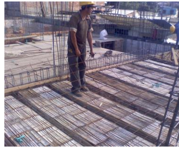
Figura No. 140 Colocación de refuerzo de temperatura
