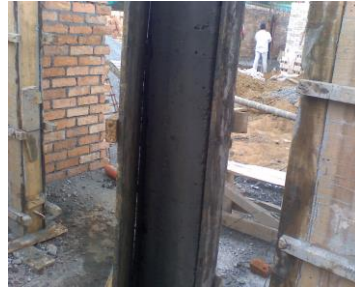
Figura No. 94 Desencofrado la columna
