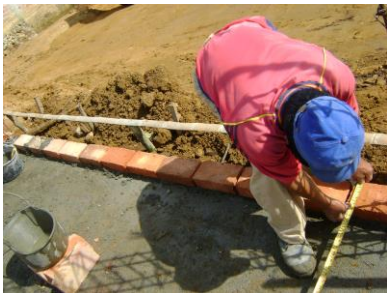
Figura No. 96 Planteo de los muros
