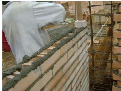
Figura No. 113 Pelos para confinar el muro con la columna
