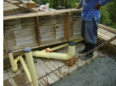
Figura No. 138 Instalación sanitaria en casetones
