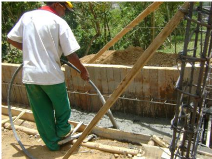
Figura No. 85 Vibrado del concreto
