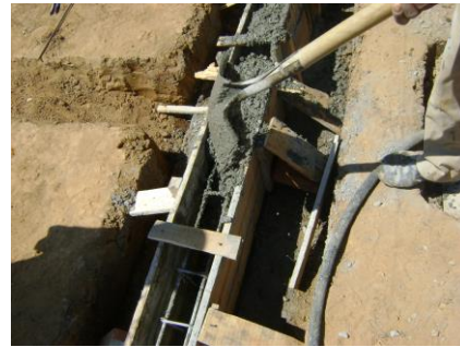
Figura No. 84 Colocación de concreto
