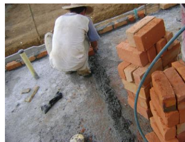
Figura No. 97 Mortero de pega primera hilada
