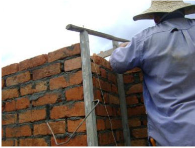
Figura No. 98 Utilización de los codales
