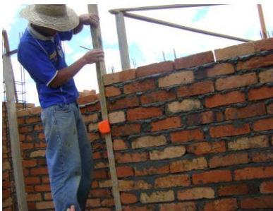
Figura No. 100 Medición de cada hilada
