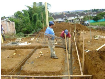
Figura No. 79 Colocación del acero de refuerzo
