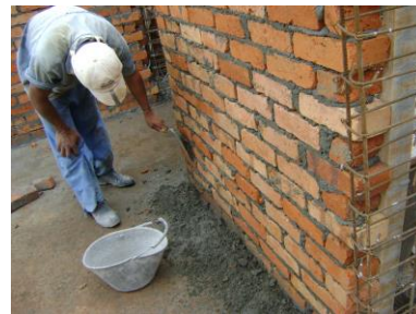
Figura No. 103 limpieza del muro
