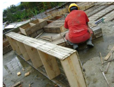
Figura No. 136 Acomodo de casetones
