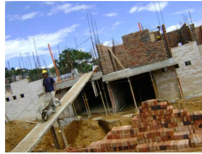
Figura No. 148 Rampa Transporte del concreto
