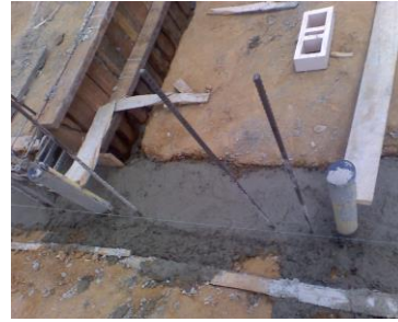
Figura No. 111 Cimentaci3n refuerzo Vertical
