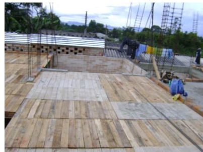
Figura No. 130 Colocación de tableros para la losa
