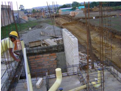
Figura No. 124 Viga de confinamiento
