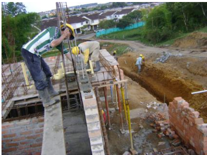
Figura No. 120 Vibración manual del grouting
