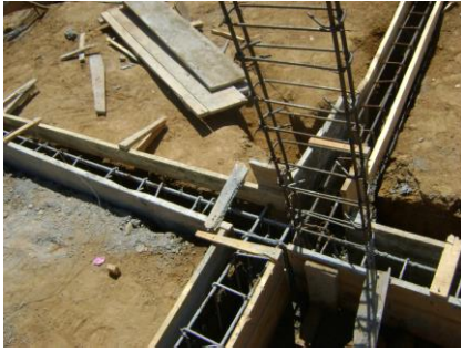
Figura No. 81 Formaletas de las vigas
