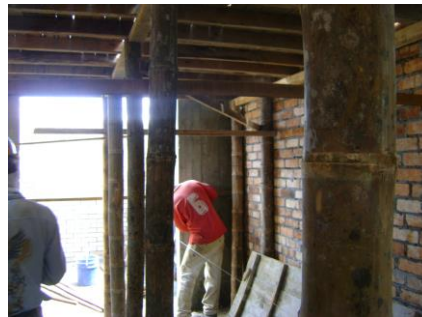
Figura No. 128 Nivelación de encofrado de losa
