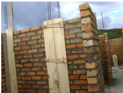
Figura No. 89 Formateo de la columna
