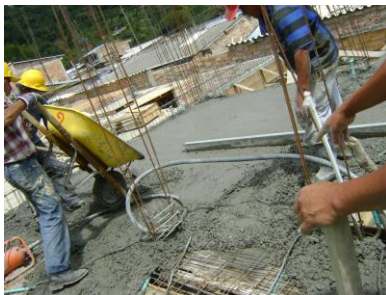
Figura No. 143 Colocación del concreto
