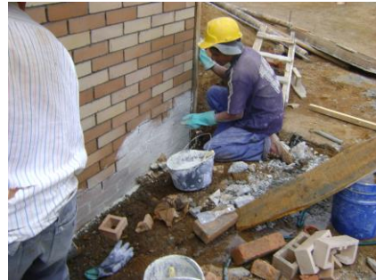
Figura No. 121 Acabado del muro
