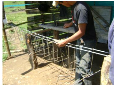
Figura No.53 chequeo de espaciamiento para cortante
