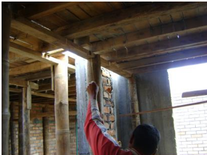
Figura No. 129 Nivelación de la losa
