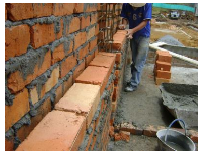
Figura No. 101 Pega de ladrillo
