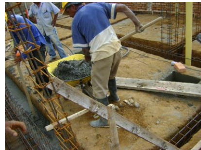
Figura No. 86 Terminado y nivelación
