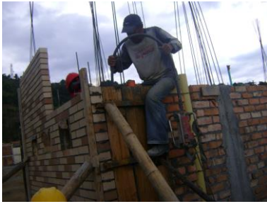
Figura No. 93 Vibrado de columna
