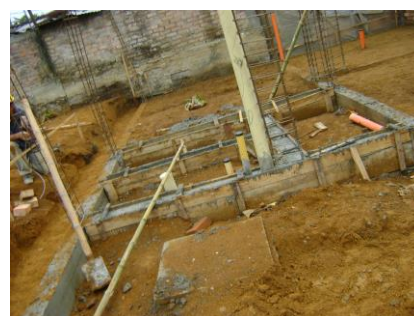
Figura No. 88 Desencofrado de las vigas de cimentación
