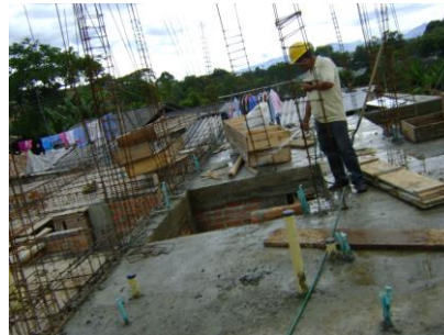
Figura No. 149 Curado de la losa
