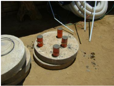
Figura No. 74 Toma de muestras de grouting
