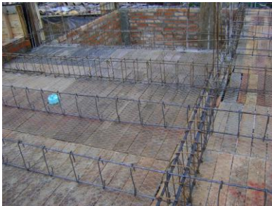
Figura No. 133 Colocación del refuerzo
