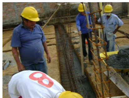
Figura No. 80 Fundición de la zarpa
