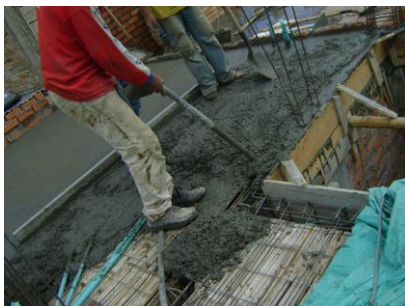
Figura No. 145 Vibrado del concreto
