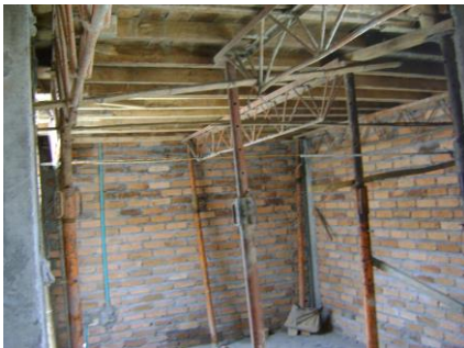
Figura No. 127 Soportes de losa gatos y cerchas
