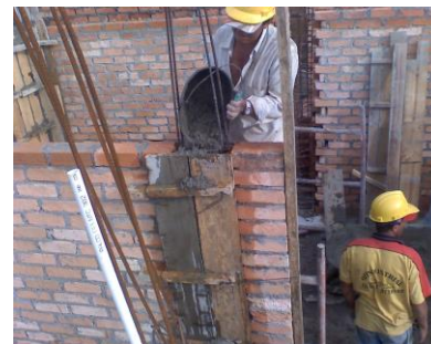
Figura No. 92 Fundición de la columna
