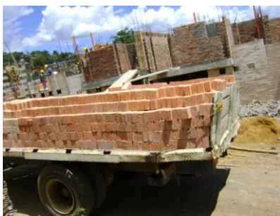
Figura No.38 Transporte de ladrillo macizo
