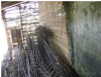
Figura No.52 Almacenamiento del acero
