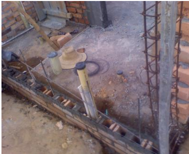
Figura No. 112 Refuerzo horizontal
