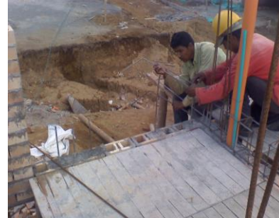
Figura No. 123 Terminación de muro en la losa
