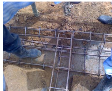
Figura No.55 Chequeo de recubrimiento
