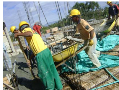
Figura No. 144 manto para no contaminar la mezcla
