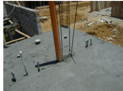
Figura No. 125 Fundición de viga de confinamiento
