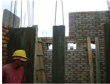
Figura No. 95 Columnas terminadas
