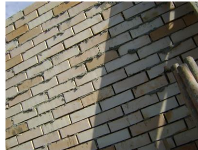
Figura No. 109 Terminado de muro a la vista
