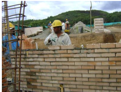
Figura No. 115 Pega de ladrillo estructural
