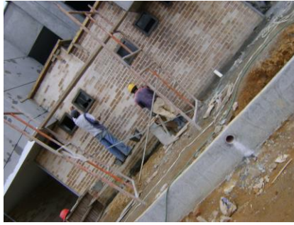
Figura No. 126 Muro estructural terminado
