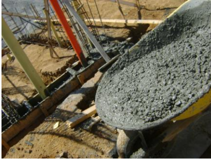
Figura No. 83 Transporte de concreto
