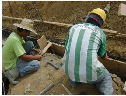
Figura No. 82 Formaletas de las vigas
