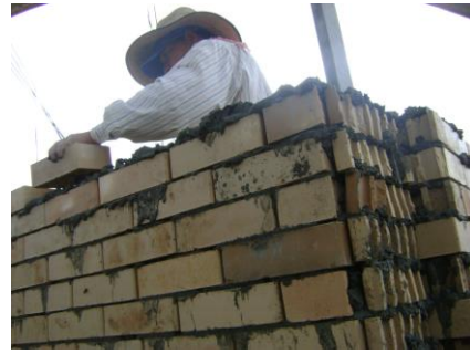
Figura No. 105 Pega de ladrillo
