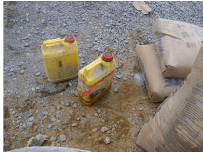
Figura No 61. Aditivo plastificante usado en la preparación de mezclas de concreto
