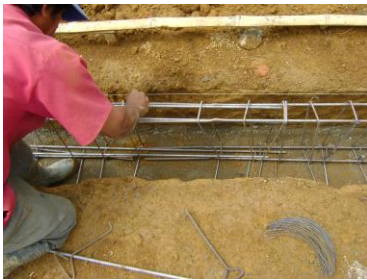
Figura No.56 Chequeo longitud de traslapo
