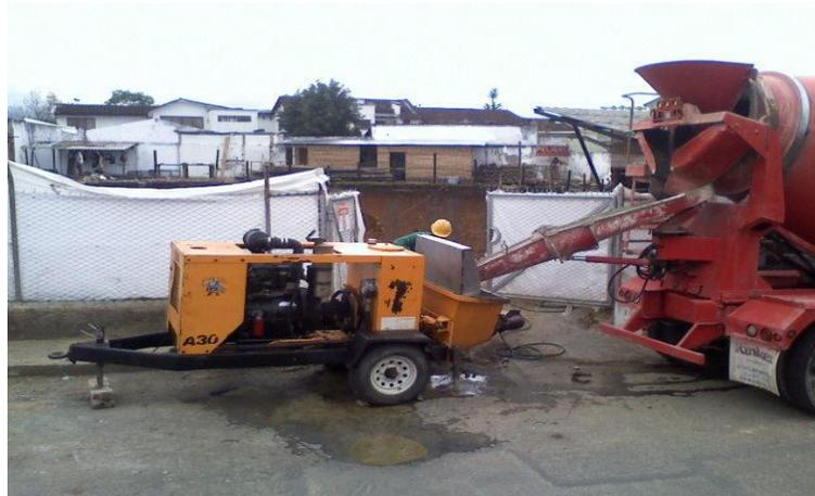
FOTO 26. BOMBA ESTACIONARIA Y MIXER DESCARGANDO
