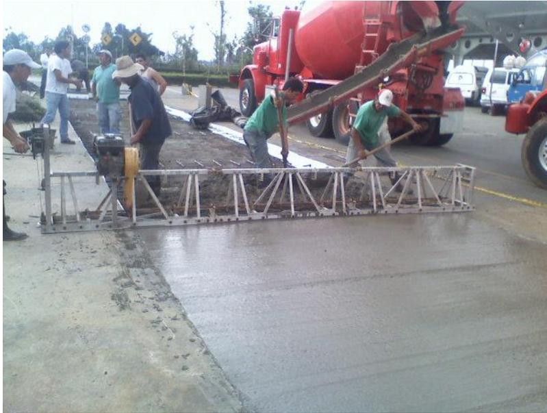
FOTO 41 REPARACION LOSAS PAVIMENTO TERMINAL
