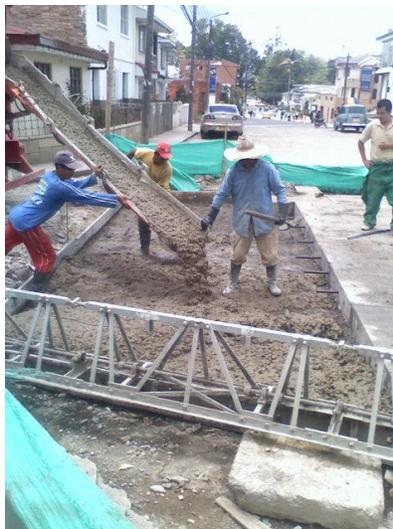
FOTO 23. CONCRETO VACIADO DIRECTAMENTE CON LAS CANALES
