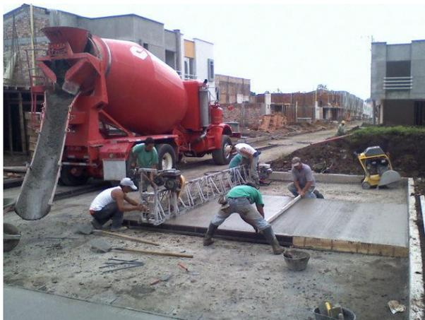
FOTO 34. MIXER, REGLA VIBRATORIA, CORTADORA
