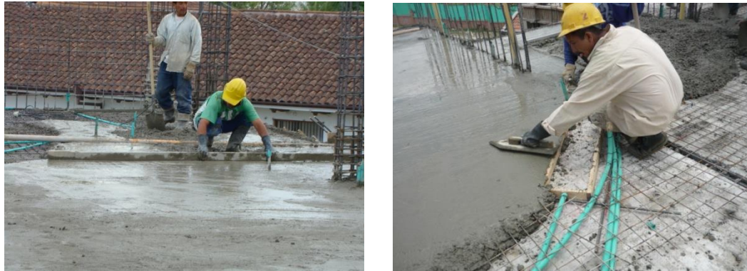
Figura N° 43. Acabado de la losa
