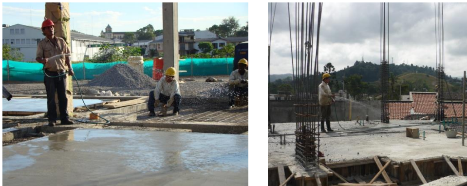
Figura N° 44. Curado de la losa
