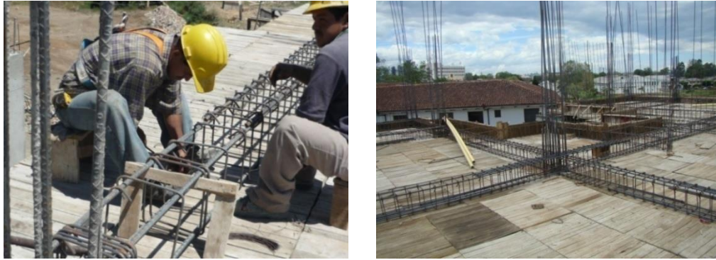
Figura N° 32. Armado de vigas
