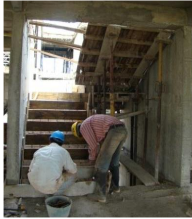
Figura N° 12. Formaleta para escaleras
