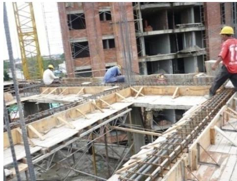
Figura N° 33. Encofrado de vigas
