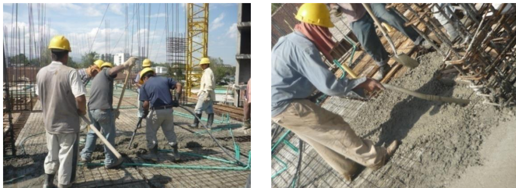
Figura N° 42. Vibrado de la losa
