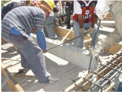
Figura N° 35. Instalación de viguetas prefabricadas
