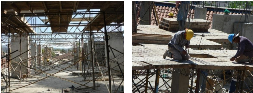
Figura N° 31. Sistema de soporte del encofrado de la losa
