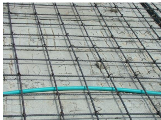
Figura N° 39. Refuerzo negativo
