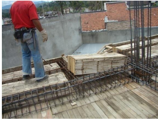
Figura N° 34. Instalación de casetones
