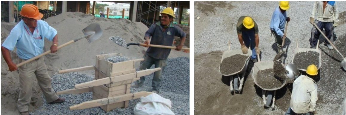
Figura N° 21. Elementos empleados en la medición de proporciones en volumen suelto
