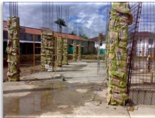
Figura N° 30. Curado con materiales sellantes
