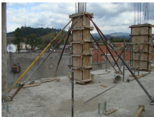
Figura N° 23. Formaleta en madera
