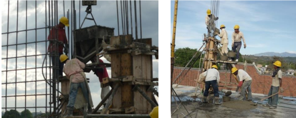
Figura N° 27. Colocación del concreto en las columnas
