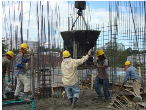
Figura N° 41. Vaciado del concreto en la losa
