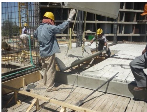
Figura N° 38. Instalación de placas prefabricadas
