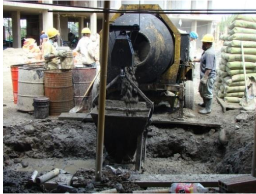
Figura N° 25. Mezclado del concreto
