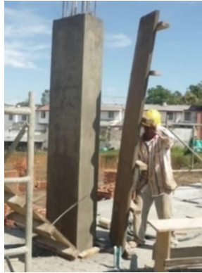
Figura N° 29. Desencofrado de columnas
