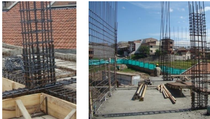
Figura N° 22. Colocación del refuerzo en columnas y pantallas
