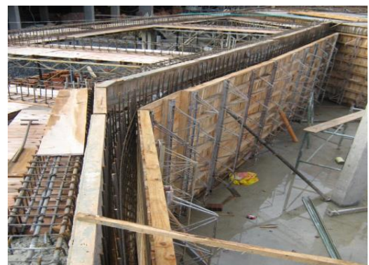
Figura N° 24. Formaleta para pantallas
