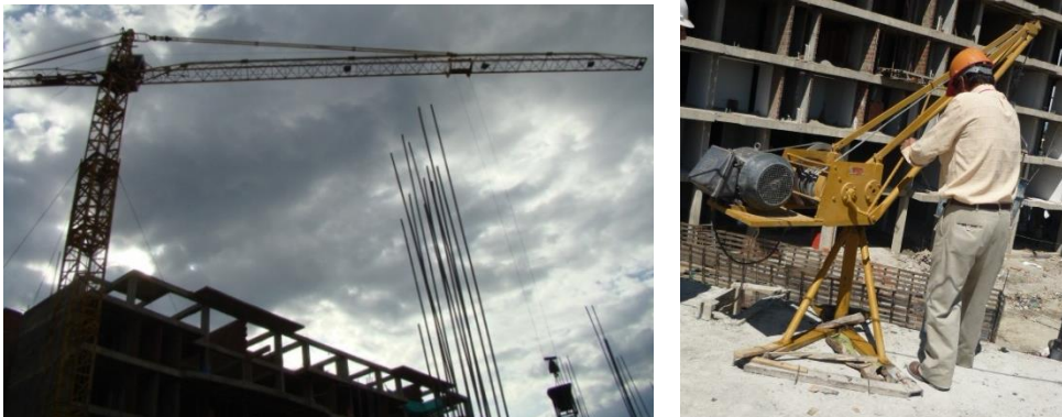
Figura N° 26. Métodos de transporte de la mezcla de concreto
