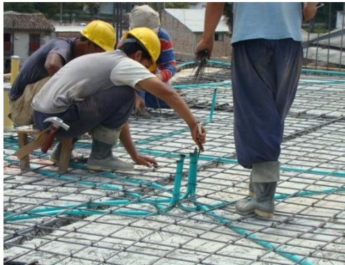
Figura N° 40. Instalaciones eléctricas
