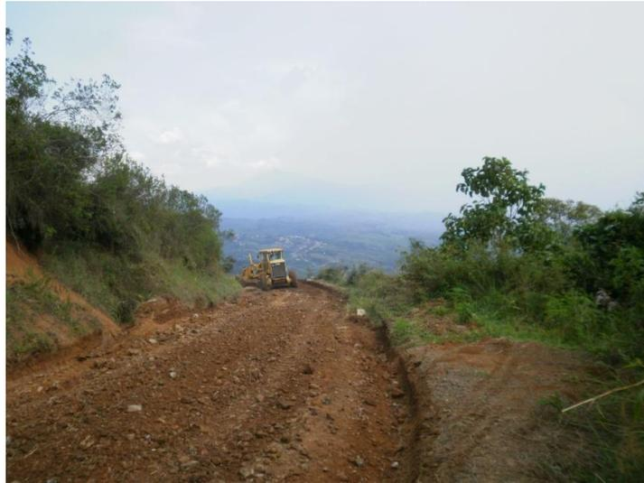
Figura 35. Colocación del material.
