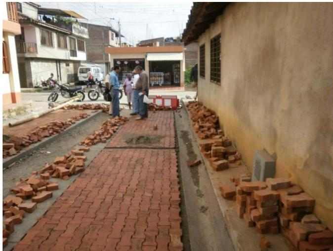
Fig. 57. Colocación adoquín.
