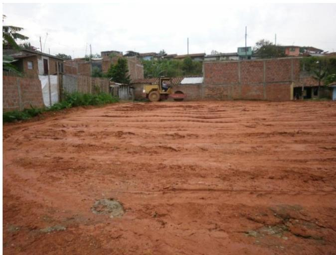
Figura 43. Compactación del material de relleno
