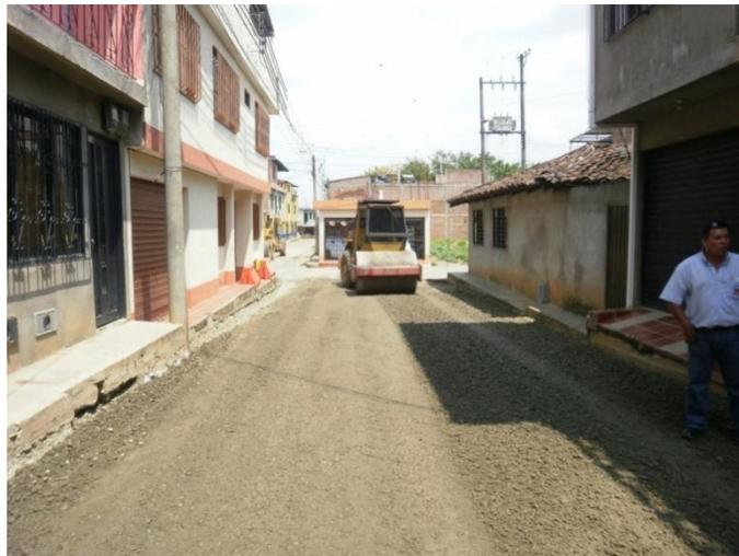
Fig. 56. Compactación de la base (material triturado)
