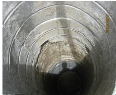
FIGURA 39. Y 40. VISTA DE CONSTRUCCIÓN DE CAISSONS EN EL PUENTE LADERAS DEL SECTOR PR64+868
