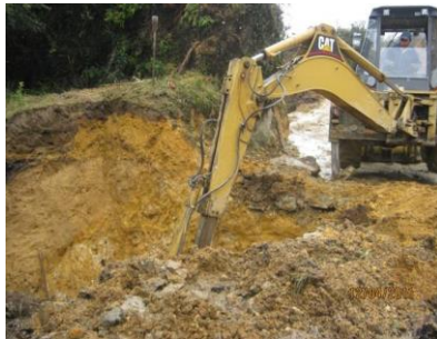
FIGURA 3. Y 4. VISTA DE ACTIVIDAD DE CORTES Y EXPLANACIÓN LA PARA RECTIFICACIÓN DEL ALINEAMIENTO GEOMETRICO EN EL PR46+800
