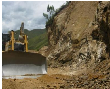
FIGURA 32. VISTA DE ACTIVIDAD DE CORTE EN EL SECTOR PR67+500 AL PR67+600
