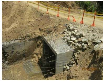
FIGURA 35. Y 36. VISTA DE ACTIVIDAD DE CONSTRUCCIÓN DEL BOXCULVERT EN EL SECTOR PR72+153
