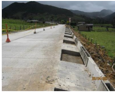
FIGURAS 15. Y 16. VISTA DE CONSTRUCCIÓN DE CUNETAS EN EL SECTOR PR44+250 AL PR44+330
