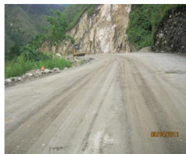
FIGURA 33. Y 34. VISTA DE SUBBASE GRANULAR INSTALADA EN EL SECTOR PR68+990 AL PR69+150
