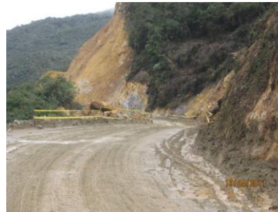
FIGURA 3. Y 4. VISTA DE ACTIVIDAD DE CORTES Y EXPLANACIÓN LA PARA RECTIFICACIÓN DEL ALINEAMIENTO GEOMETRICO EN EL PR46+800
