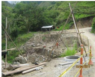
FIGURA 39. Y 40. VISTA DE CONSTRUCCIÓN DE CAISSONS EN EL PUENTE LADERAS DEL SECTOR PR64+868
