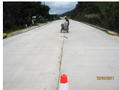
FIGURA 22. VISTA DE ACTIVIDAD SELLO DE JUNTA LONGITUDINAL DEL PR43 AL PR44
