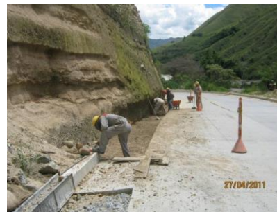
FIGURA 26. Y 27. VISTA DE CONSTRUCCIÓN DE CUNETAS LOCALIZADAS EN EL PR64+330 AL PR64+395 EN LA MARGEN IZQUIERDA
