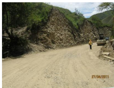
FIGURA 41. Y 42. VISTA DEL CERO DE SUBBASE GRANULAR EN EL SECTOR PR69+000 AL PR69+300
