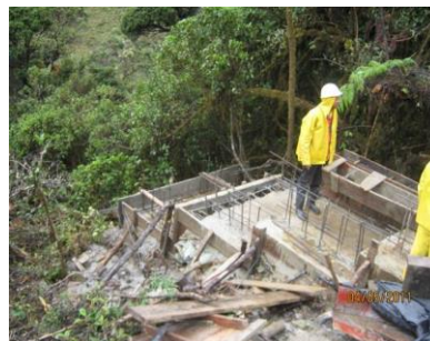
FIGURA 14. VISTA DE CONSTRUCCIÓN DEL DISIPADOR DEL SECTOR PR52+370
