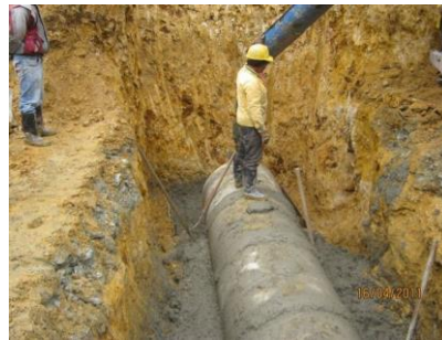
FIGURA 12. VISTA DE FUNDICIÓN DE LOSA DE CIMENTACIÓN DE LA TUBERÍA REFORZADA DE 36" EN EL PR44+398
