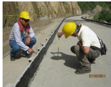
FIGURA 49. VISTA DE ACTIVIDAD DE CHEQUEO DE ESPESORES DE LA CAPA DE SUBBASE GRANULAR
