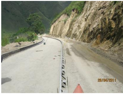
FIGURA 43. Y 44. VISTA DE FUNDICIÓN DE PAVIMENTO EN CCTO HIDRÁULICO EN EL SECTOR PR68+850 AL PR68+960 DEL CARRIL DERECHO
