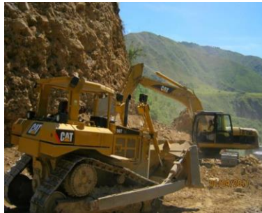
FIGURA 30. Y 31. VISTA DE ACTIVIDAD DE CORTES PARA AMPLIACION DE BANCA EN EL SECTOR PR72+930 AL PR73+100
