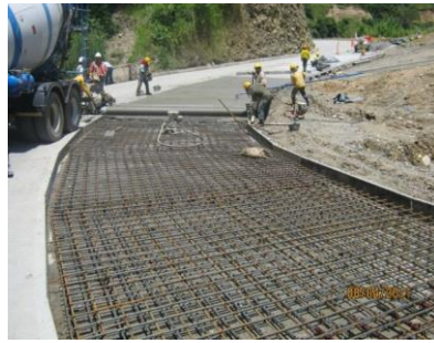
FIGURA 28. Y 29. VISTA DE CONSTRUCCIÓN DE LOSAS DE CONCRETO CON REFUERZO EN EL SECTOR PR63+870 AL PR63+930 DEL CARRIL DERECHO
