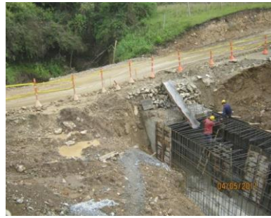
FIGURA 35. Y 36. VISTA DE ACTIVIDAD DE CONSTRUCCIÓN DEL BOXCULVERT EN EL SECTOR PR72+153
