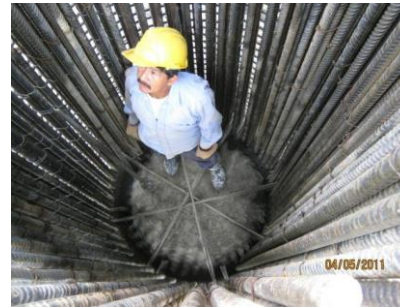
FIGURAS 17. Y 18. VISTA DE FUNDICIÓN DE CAISSONS DE UNO DE LOS ESTRIBOS DEL PUENTE DE GUANACAS EN EL PR79+200
