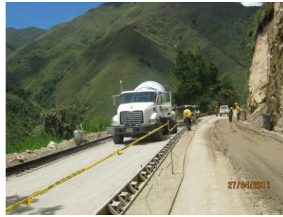
FIGURA 43. Y 44. VISTA DE FUNDICIÓN DE PAVIMENTO EN CCTO HIDRÁULICO EN EL SECTOR PR68+850 AL PR68+960 DEL CARRIL DERECHO
