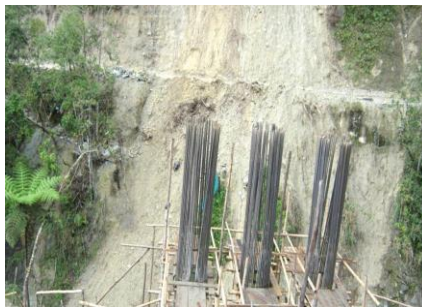
FIGURA 21. VISTA DE REFUERZO DE LAS COLUMNAS DEL PILA DEL PUENTE DE GUANACAS EN EL PR80+300
