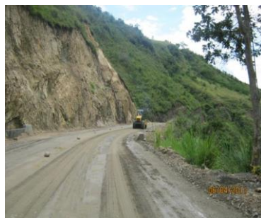
FIGURA 33. Y 34. VISTA DE SUBBASE GRANULAR INSTALADA EN EL SECTOR PR68+990 AL PR69+150
