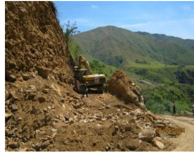
FIGURA 30. Y 31. VISTA DE ACTIVIDAD DE CORTES PARA AMPLIACION DE BANCA EN EL SECTOR PR72+930 AL PR73+100
