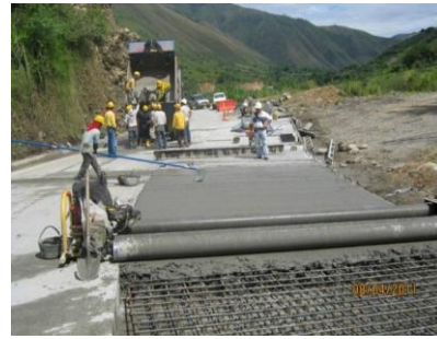
FIGURA 28. Y 29. VISTA DE CONSTRUCCIÓN DE LOSAS DE CONCRETO CON REFUERZO EN EL SECTOR PR63+870 AL PR63+930 DEL CARRIL DERECHO
