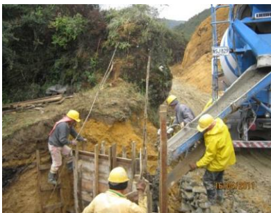
FIGURA 13. VISTA DE CONSTRUCCIÓN DE LA FUNDICIÓN DE LA ESTRUCTURA DE SALIDA DEL SECTOR PR47+950
