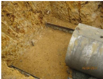
FIGURA 11. VISTA DE FUNDICIÓN DE LOSA DE CIMENTACIÓN DE LA TUBERÍA REFORZADA DE 36" EN EL PR47+950
