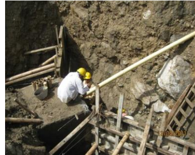
FIGURA 25. VISTA DE CONSTRUCCIÓN DE ESTRUCTURA DE ENTRADA AL BOXCULVERT EXISTENTE EN EL PR71+220
