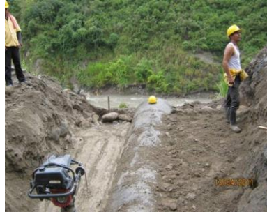
FIGURA 24. VISTA DE RELLENO ESTRUCTURAL DE LA ALCANTARILLA DE 36" EN EL PR69+220
