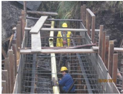
FIGURA 9. VISTA DE INSTALACIÓN DE REFUERZO DEL BOXCULVERT EN EL PR50+724
