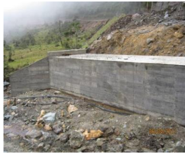
FIGURA 10. VISTA DE BOXCULVERT EN EL PR53+900
