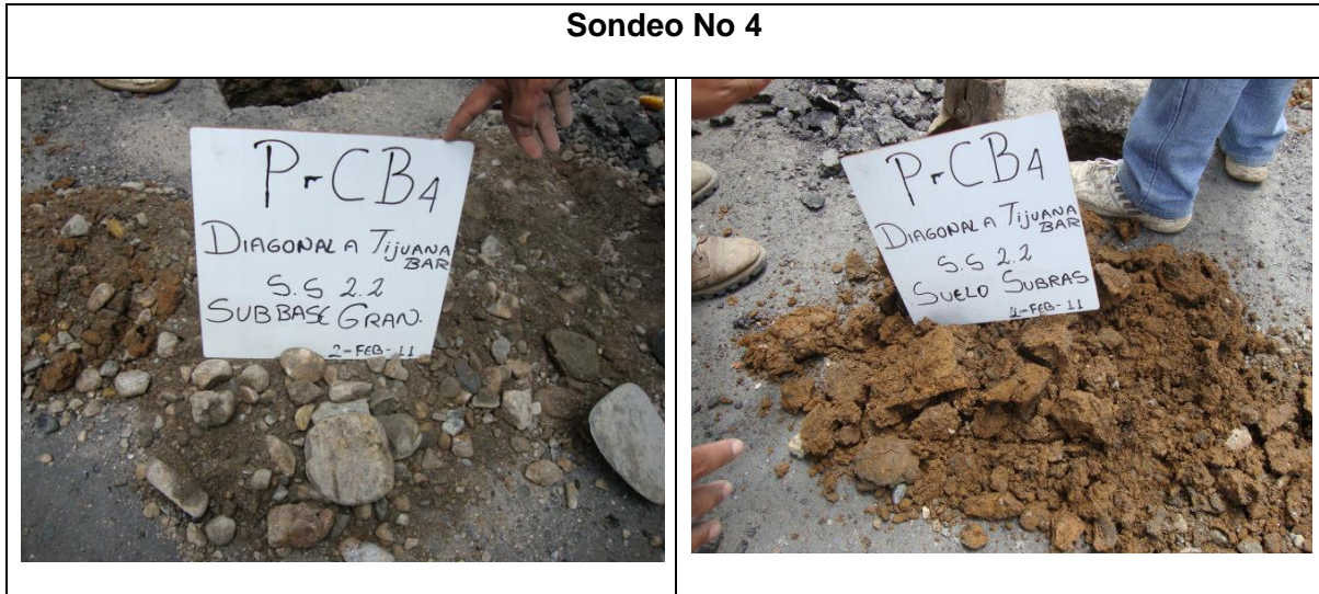
Figura No. 28 Fotografía del sondeo No.4. En la Carrera Novena
