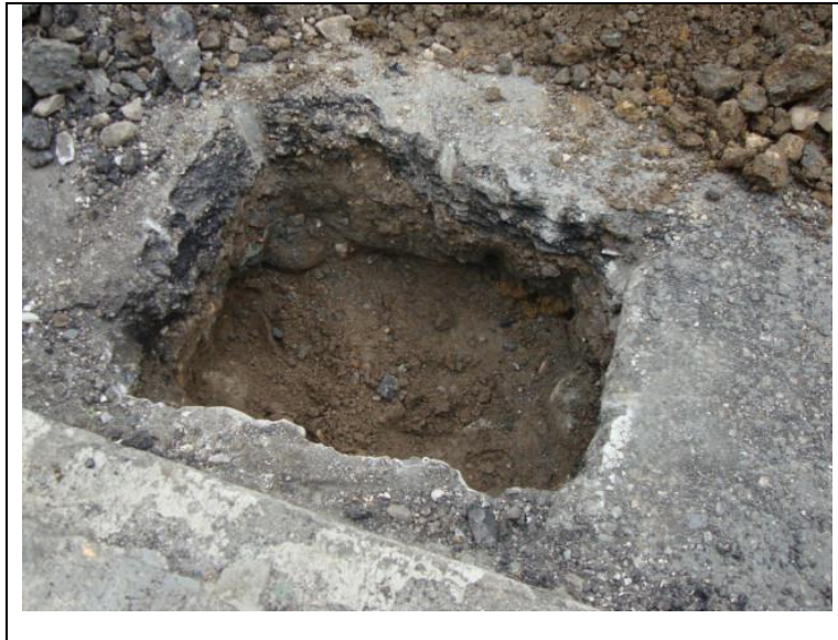
Figura No. 41 Apique de Calibración
