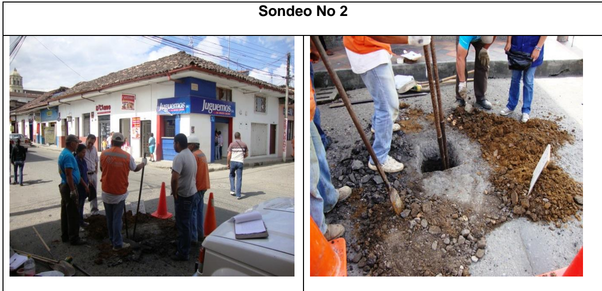
Figura No. 26 Fotografía del sondeo No.2. En la Carrera Novena
