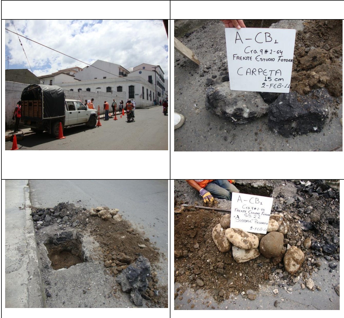
Figura No. 21 Detalles del apique No.1 realizado sobre la carrera Novena.
