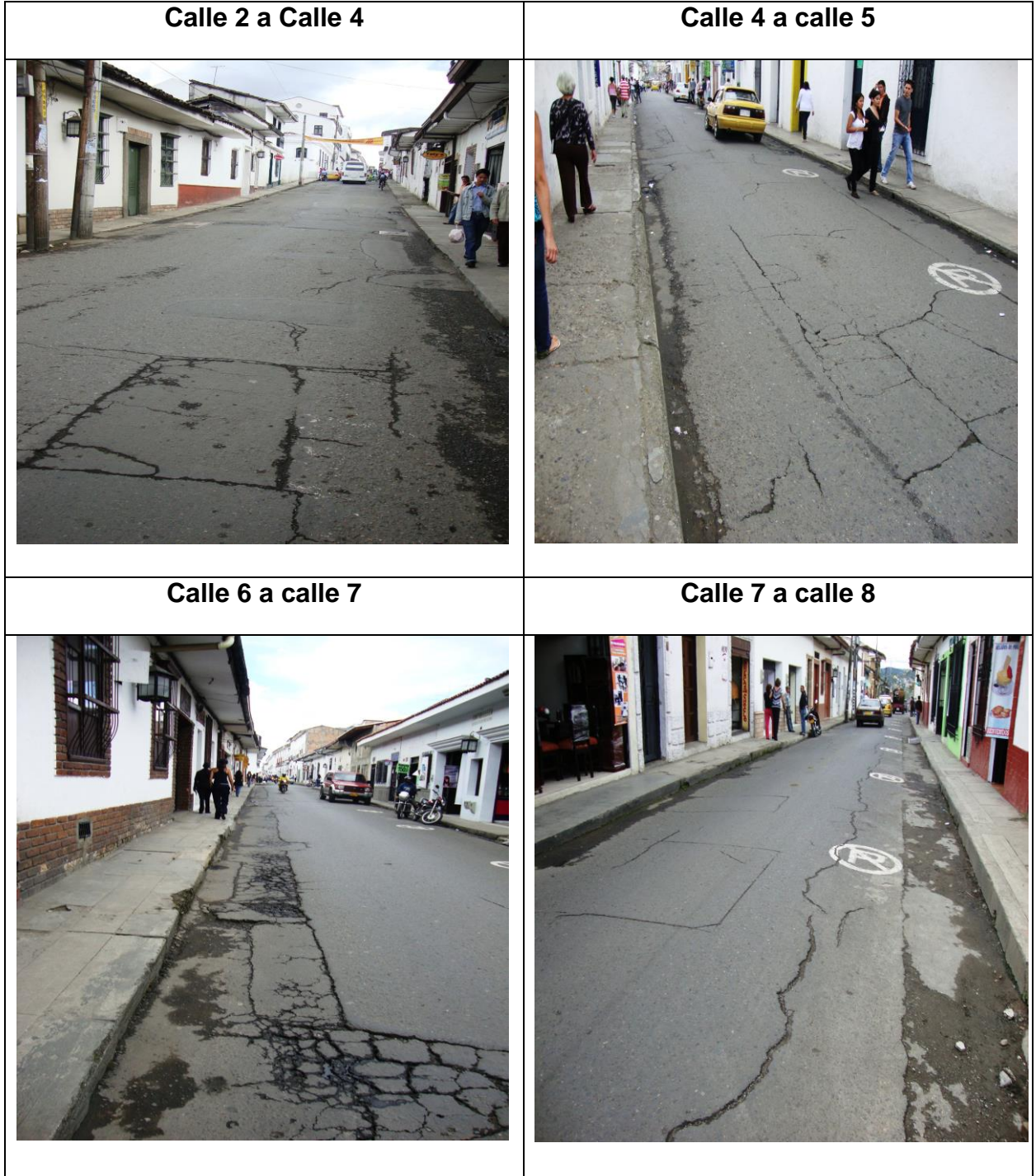
Figura No. 8 Estado superficial del tramo 1 Carrera 9ª
