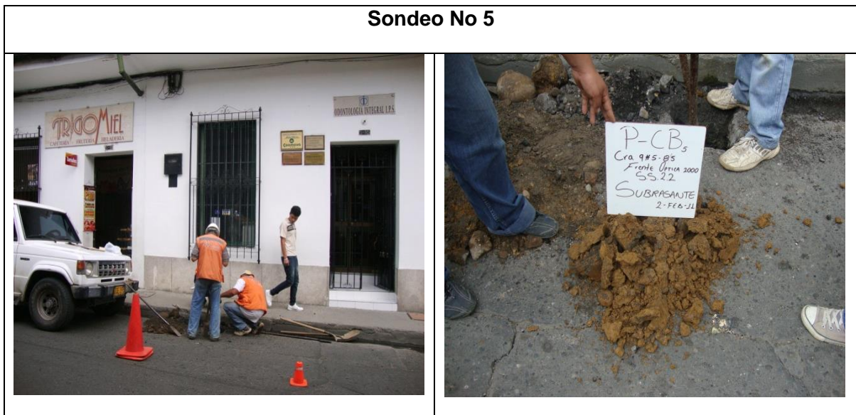
Figura No. 29 Fotografía del sondeo No.5. En la Carrera Novena
