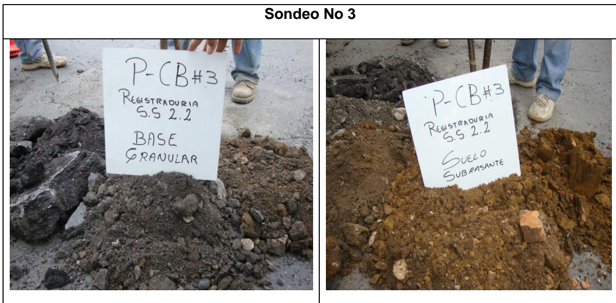
Figura No. 27 Fotografía del sondeo No.3. En la Carrera Novena
