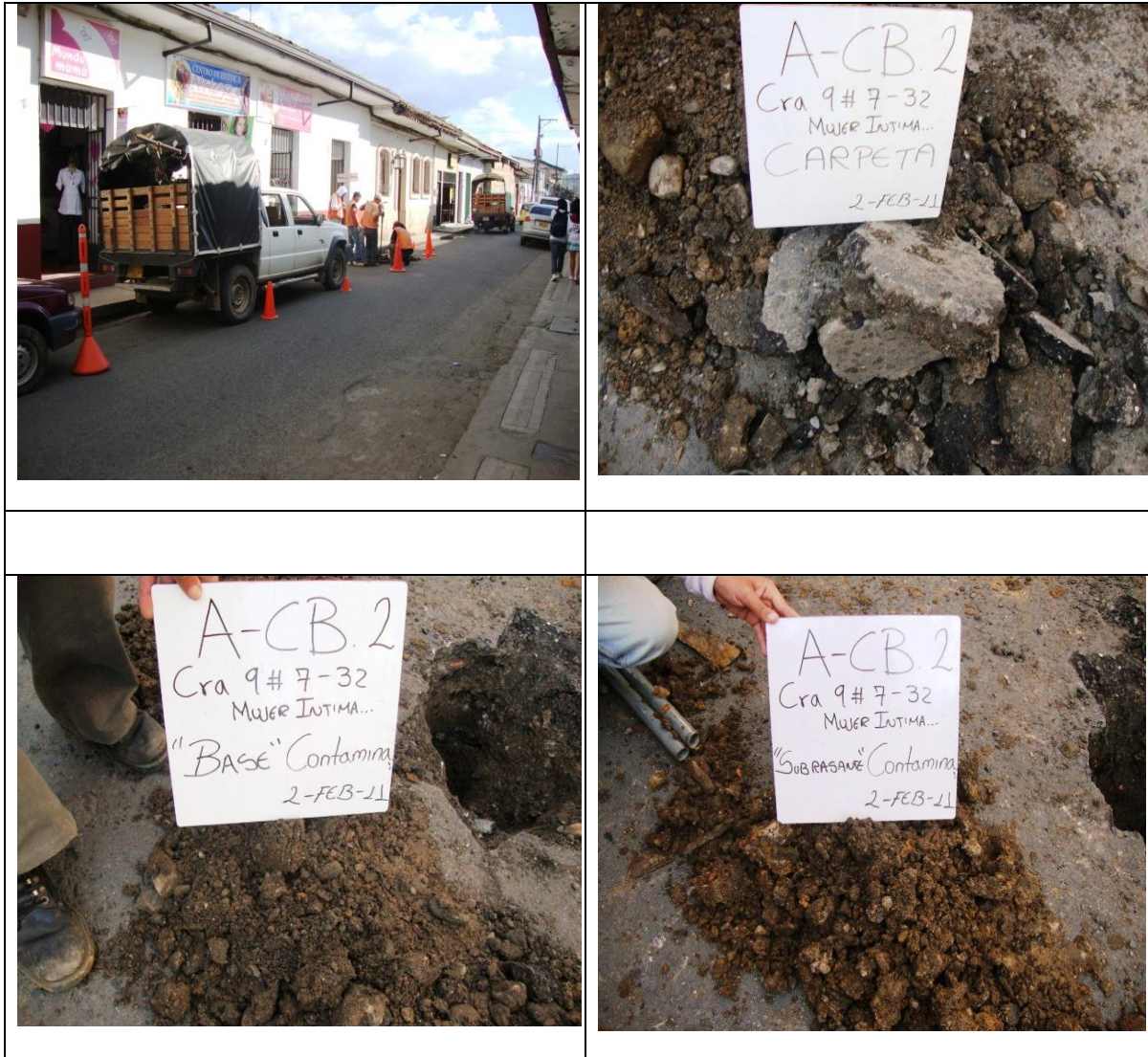
Figura No. 22 Detalles del apique No.2 realizado sobre la carrera Novena.
