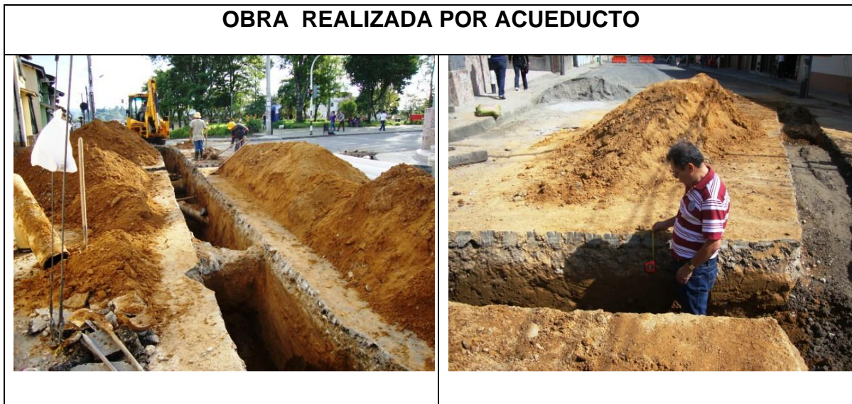
Figura No. 36 Detalles del suelo de subrasante en la intercepción de la Carrera 11 con Calle 8. Inicio del tramo de la carrera 11.
