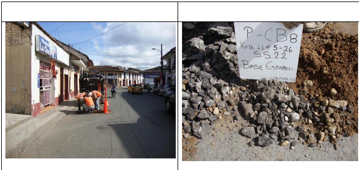
Figura No. 33 Fotografía del sondeo No.8 En la Carrera Once
