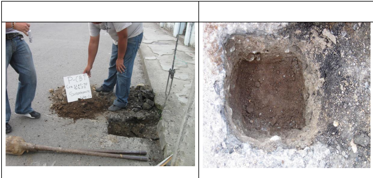
Figura No. 32 Fotografía del sondeo No.7 En la Carrera Once
