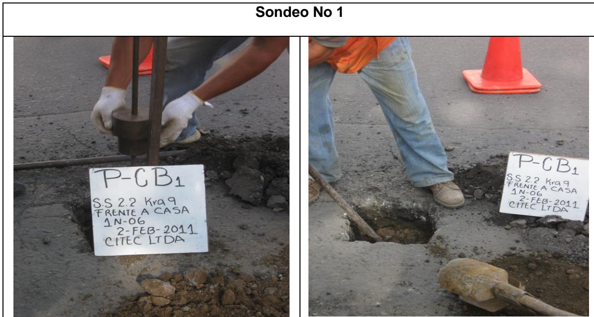
Figura No. 25 Fotografía del sondeo No.1. En la Carrera Novena
