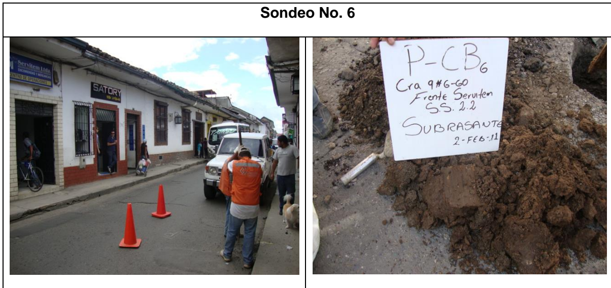
Figura No. 30 Fotografía del sondeo No.6 En la Carrera Novena
