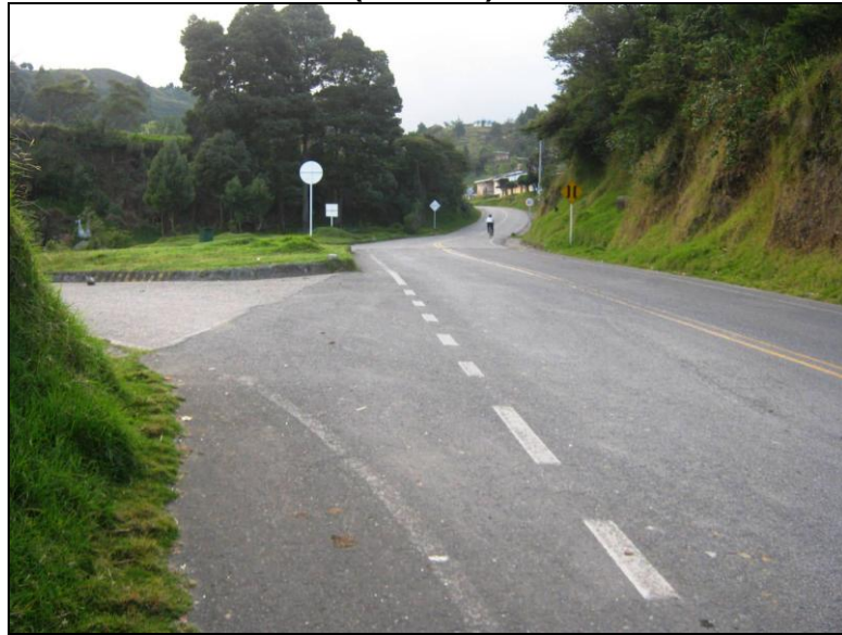
Figura 4. Detalle del Tramo Crucero de Popayán - Totoró Sector (K6+800).
