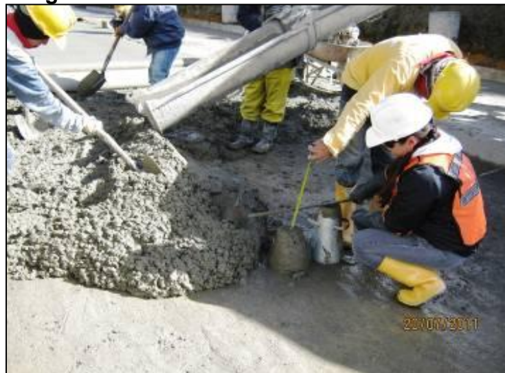
Figura 26. Toma de asentamiento al concreto.
