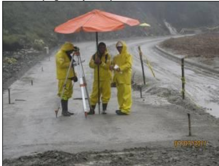
Figura 22. Toma de topografía y chequeo de localización de obras.
