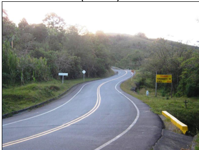
Figura 5. Detalle del Tramo Crucero de Popayán - Totoró Sector (K22+200).
