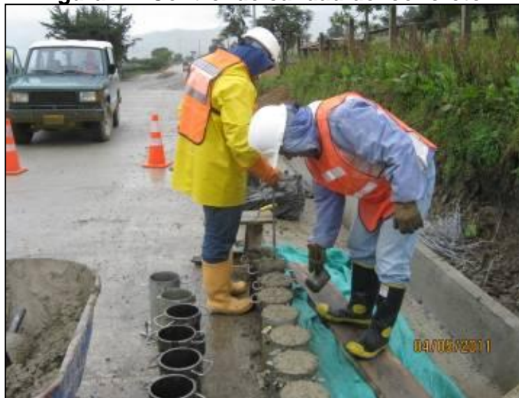
Figura 24. Control de calidad del concreto.
