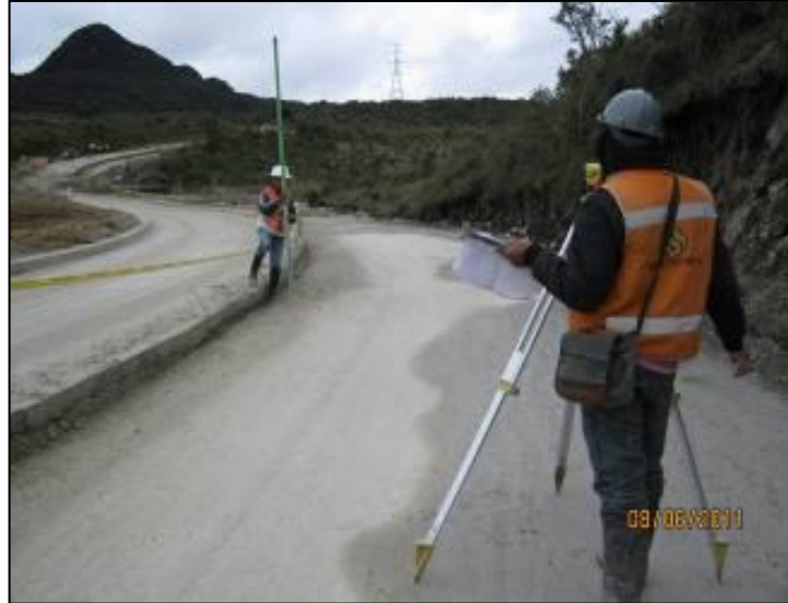
Figura 23. Toma de topografía y chequeo de localización de obras.
