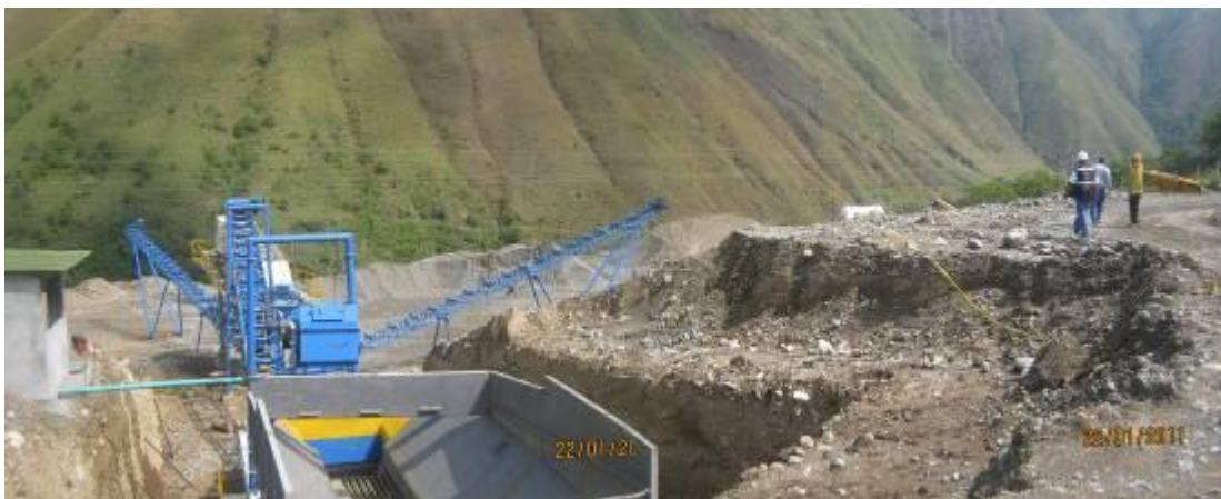
Figura 19. Planta de Trituración Tramo La Plata – Inzá.
