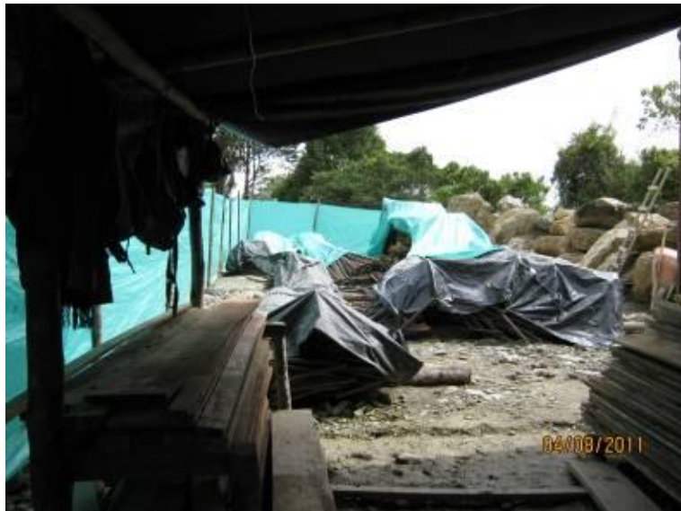
Figura 13. Detalle del almacenamiento de materiales.
