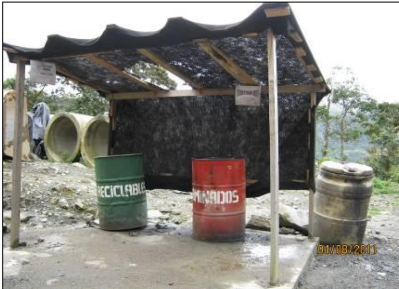
Figura 14. Detalle del manejo de residuos en la planta de concreto y trituración.
