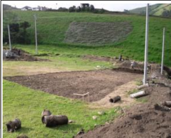
Eliminación de capa vegetal
