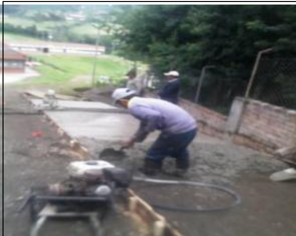
Formaleta y riego de concreto
