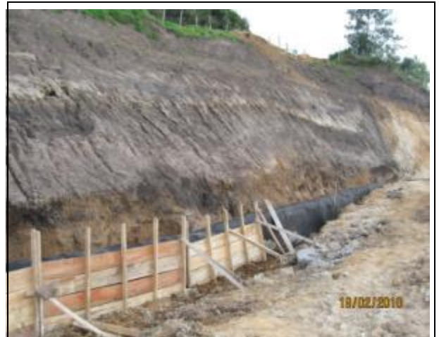
construcción del filtro
