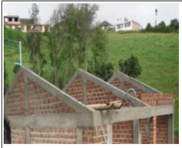
Culatas y vigas cinta
