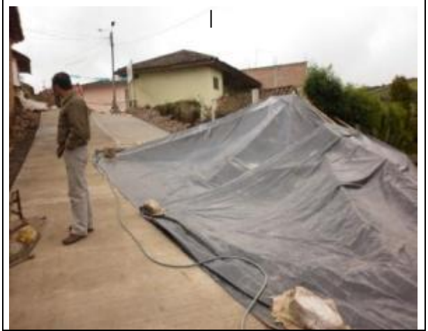
Protegiendo el Concreto
