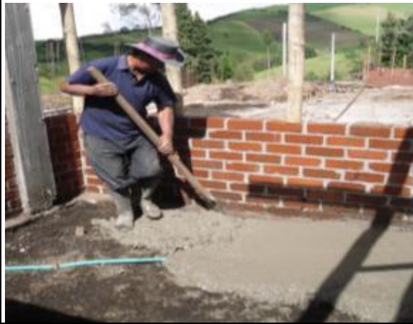
Construcción del Piso en concreto
