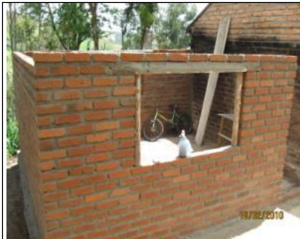
construcción de muros
