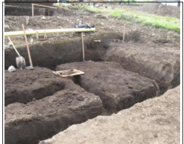
Suministro tubería diámetro 4 pulgadas
