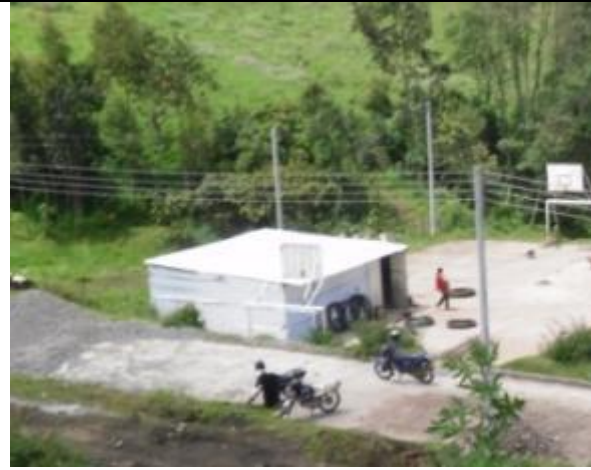
Almacén de materiales
