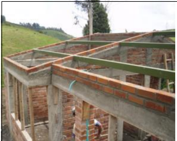
Instalación de perlines
