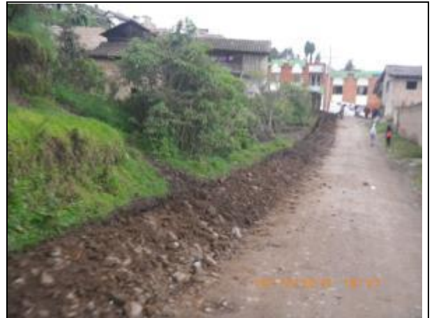
Excavación para la red
