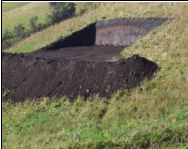
Explanación de lote a construir
