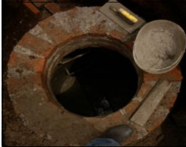
Construcción de cámara
