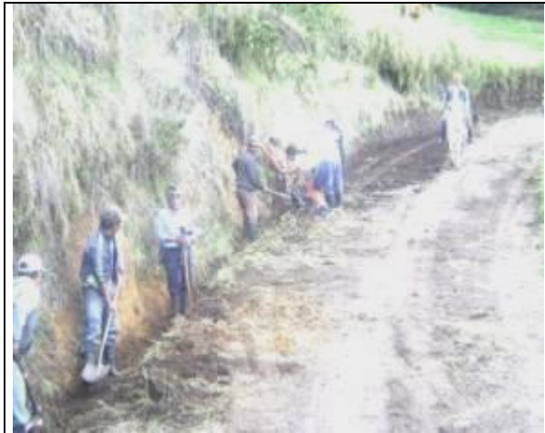
Elaboración de cunetas con la comunidad
