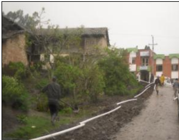
Suministro de tubería \Phi= 2 pulgadas
