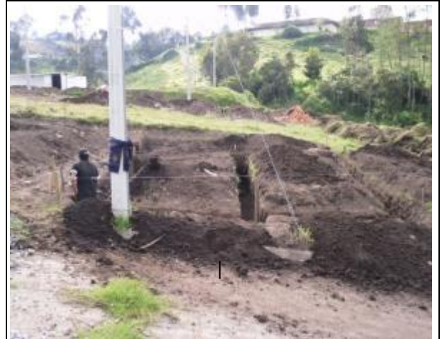
Excavaciones para cimientos
