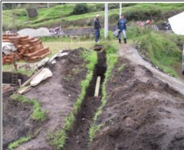
Reposición de tubería
