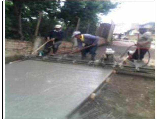
Utilizando la regla y el vibrador
