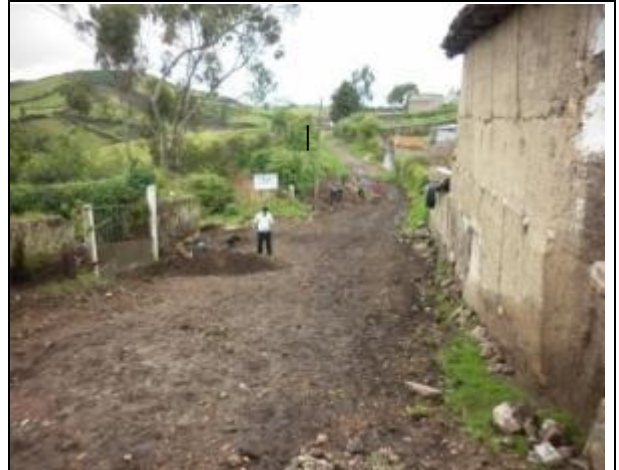
Obras de Alcantarillado
