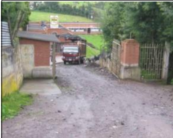
Vía a Pavimentar
