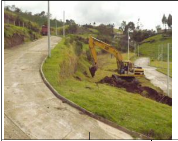
Inicio de obras
