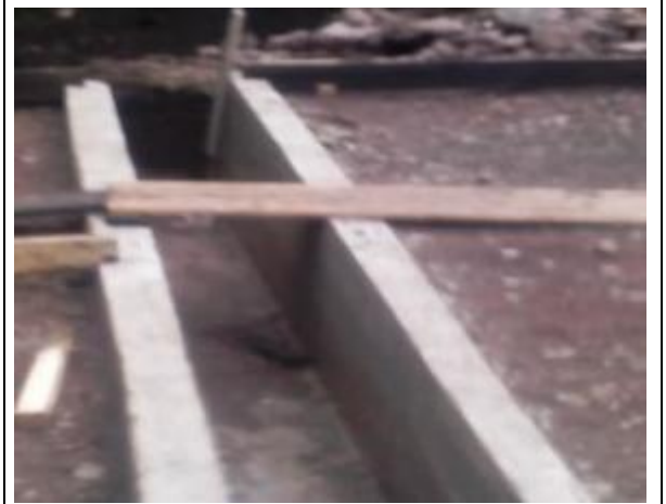
Construcción y espacio para rejillas
