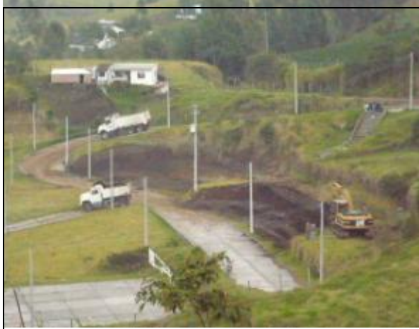
Adelantamiento de Obra
