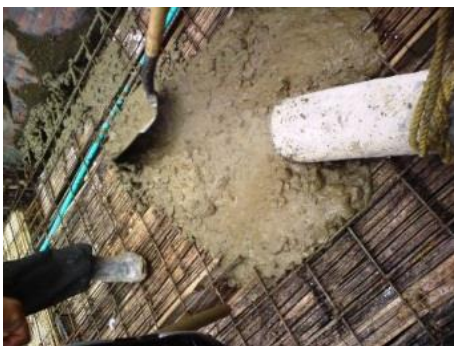
Figura No. 82 Vaciado del concreto premezclado
