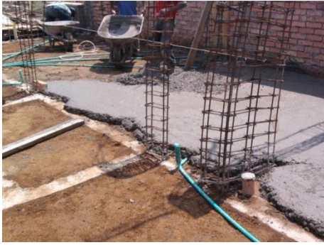
Figura No. 61 Vertido de mezcla para primario
