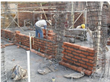
Figura No. 63 Muro en soga con ladrillo limpio
