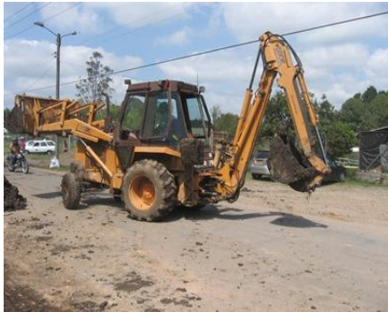
Figura No. 8 Retro-excavadora
