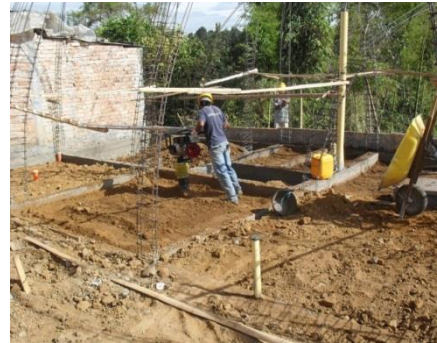
Figura No. 58 Compactación mecánica
