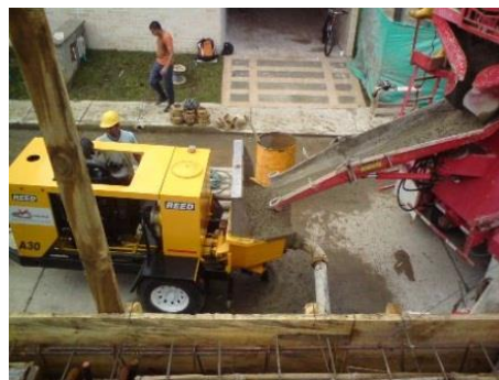
Figura No. 79 Vaciado del premezclado a la Bomba
