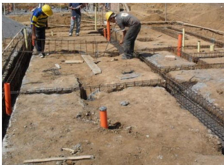
Figura No. 37 Instalación de los castillos de la viga de cimentación
