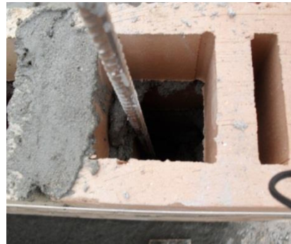
Figura No. 66 Refuerzo del muro estructural
