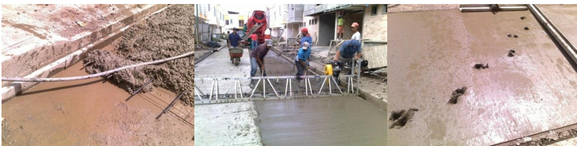
Figura No. 102 Concreto premezclado, esparcido, vibrado y nivelado
