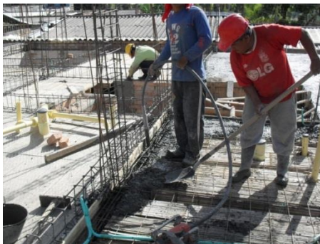
Figura No. 88 Proceso de vibrado en la fundición de la losa de entrespiso
