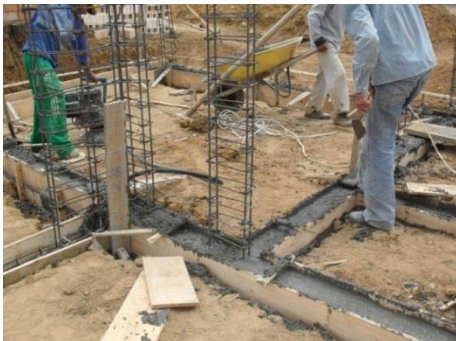
Figura No. 51 Fundición de la viga de cimentación
