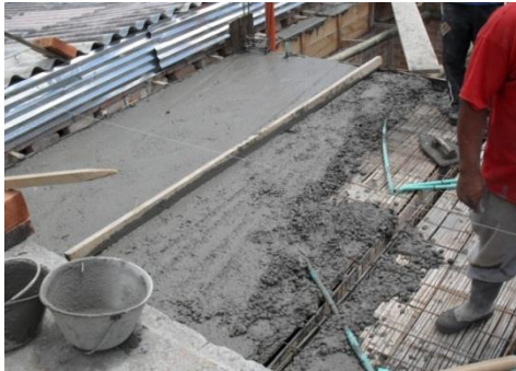
Figura No. 86 Chequeo del espesor de la losa con ayuda de hilos guía
