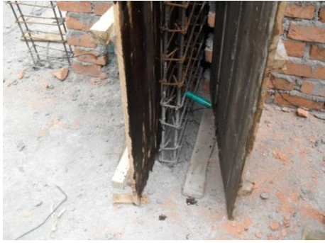
Figura No. 67 Colocación de formaletas a columnas y pantallas
