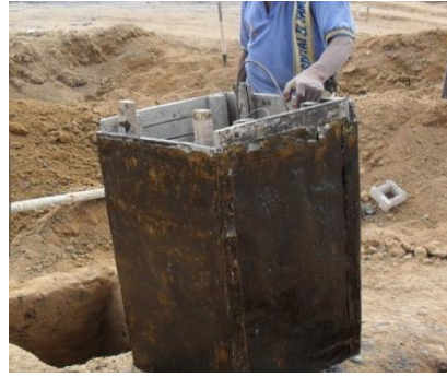
Figura No. 46 Retiro de la formaleta reutilizable
