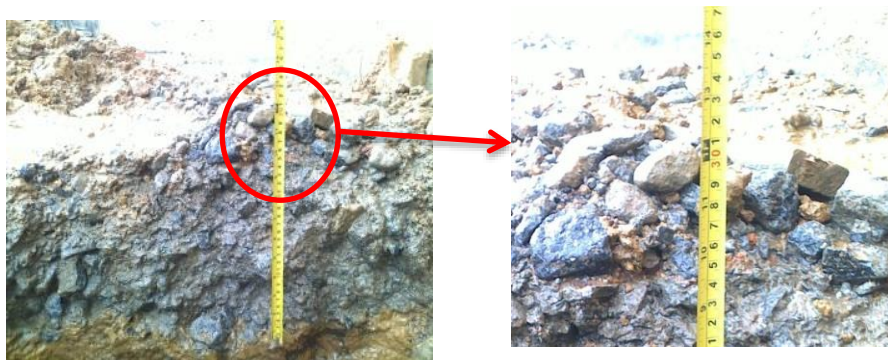
Figura No. 95 Material conformado
