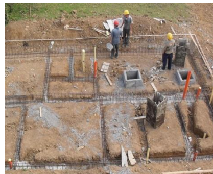
Figura No. 38 Instalación de los castillos de la viga de cimentación
