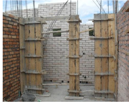
Figura No. 68 Chequeo de verticalidad a columnas y pantallas
