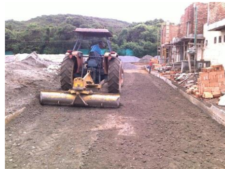
Figura No. 92 Dispersión del material
