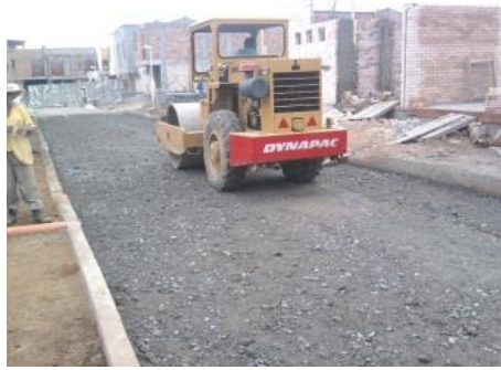
Figura No. 94 Conformación del Material
