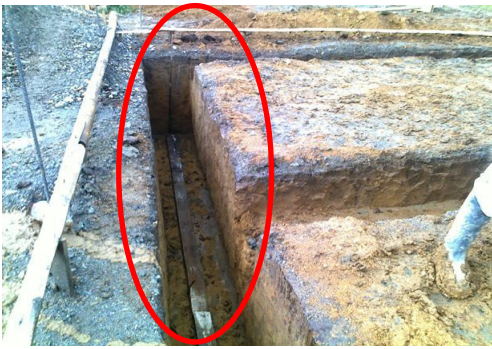
Figura No. 33 Zapata corrida
