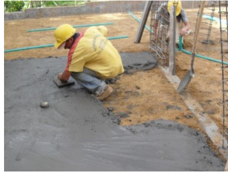
Figura No. 62 Nivelación con llana de madera
