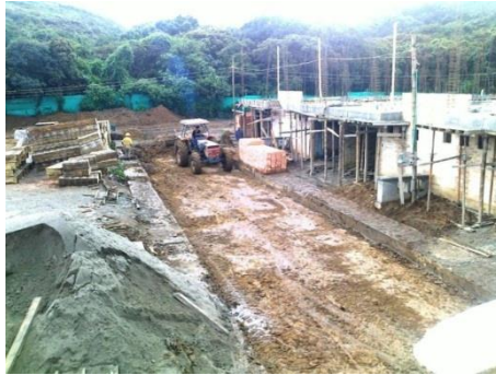
Figura No. 90 Explanación del terreno
