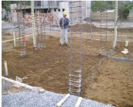
Figura No. 57 Compactación manual
