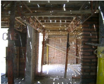
Figura No. 70 Colocación de los tacos o gatos metálicos de la estructura de soporte
