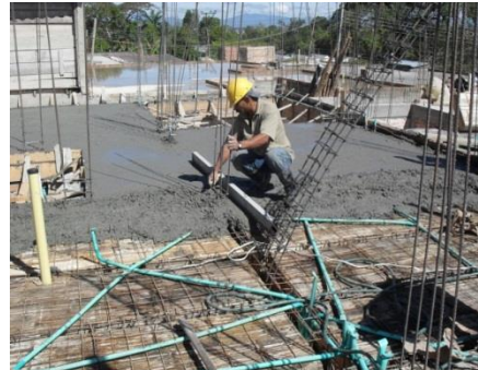
Figura No. 87 Tallado y atezado de la losa de entrespiso
