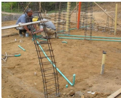
Figura No. 59 Identificación de puntos eléctricos
