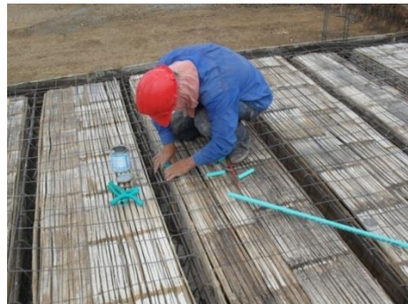
Figura No. 76 Colocación de casetones
