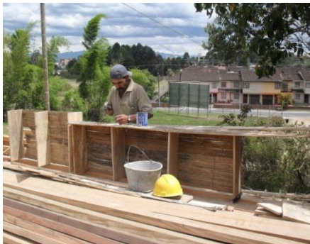
Figura No. 75 Fabricación artesanal de casetones
