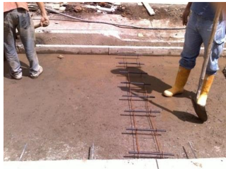
Figura No. 101 Canastilla para juntas longitudinales
