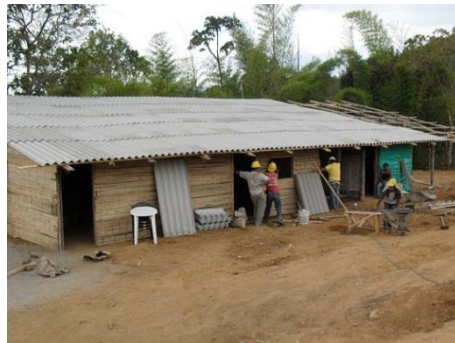
Figura No. 5 Campamento
