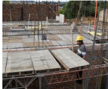
Figura No. 71 Colocación de los tableros de la estructura de soporte
