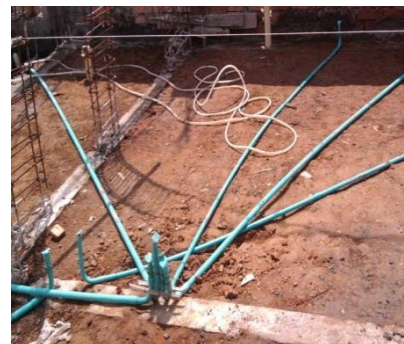
Figura No. 60 Instalación de la red de tubería eléctrica
