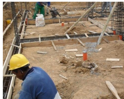
Figura No. 41 Colocación de la formaleta de la viga de cimentación
