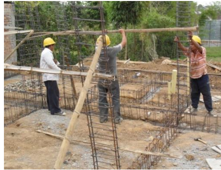
Figura No. 39 Alineación y verticalidad de castillos de columnas y pantallas
