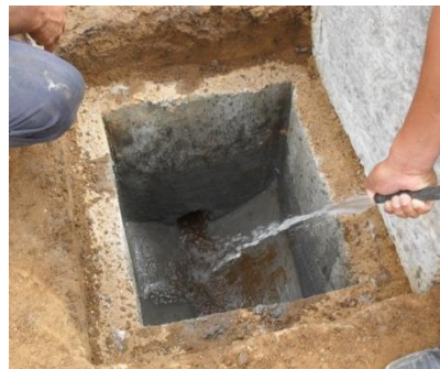
Figura No. 50 Chequeo de la funcionalidad de las cajas de inspección
