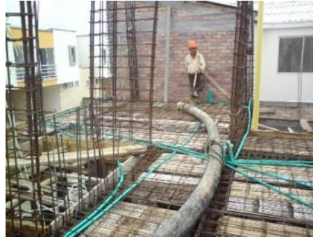
Figura No. 81 Manguera para concreto "Moco" preparada para el vaciado
