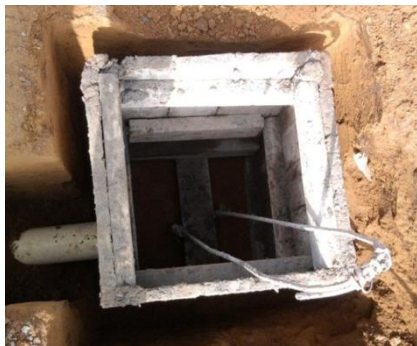
Figura No. 43 Formaleta rectangular de madera y reutilizable
