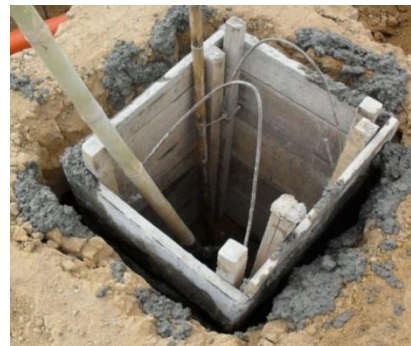
Figura No. 44 Fundición de la caja de inspección
