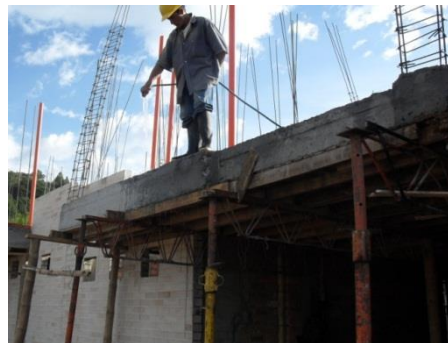
Figura No. 89 Proceso de curado (hidratación) de la losa de entrespiso
