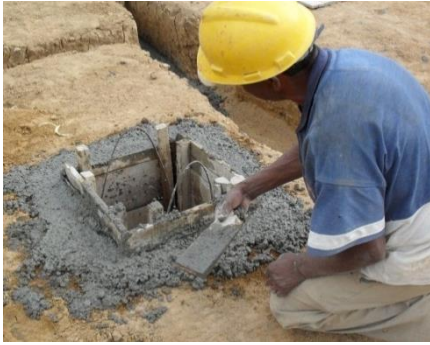
Figura No. 45 Remate de los bordes de la caja de inspección
