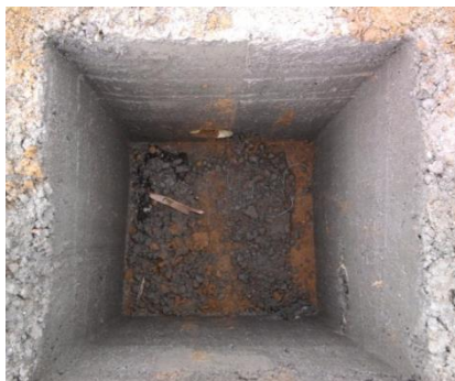
Figura No. 47 Limpieza de la caja de inspección
