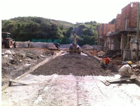
Figura No. 91 Riego de la Sub-Base
