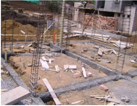
Figura No. 53 Retiro de la formaleta de la viga de cimentación
