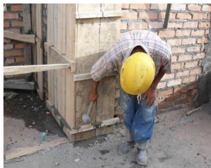
Figura No. 69 Proceso de golpeteo con martillo de caucho
