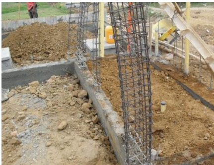
Figura No. 55 Enraze con material limo arcilloso de manera gradual
