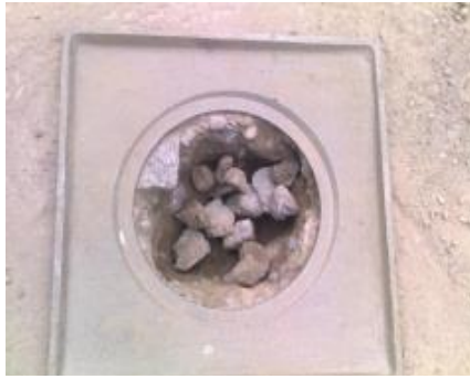
Figura No. 99 Ensayo de Densidad de Campo
