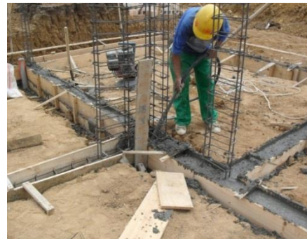
Figura No. 52 Proceso de vibrado
