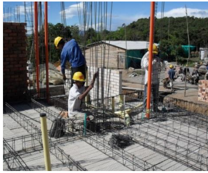
Figura No. 74 Colocación de estribos de las columnas y pantallas
