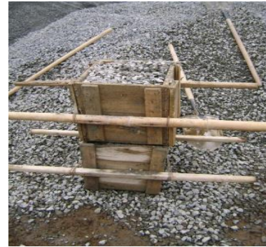
Figura No. 23 Cajones 0.04 \text{ m}^3 . Agregado Grueso TMN \frac{3}{4} "
