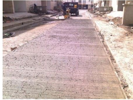
Figura No. 103 Rayado del pavimento fresco para dar la rugosidad
