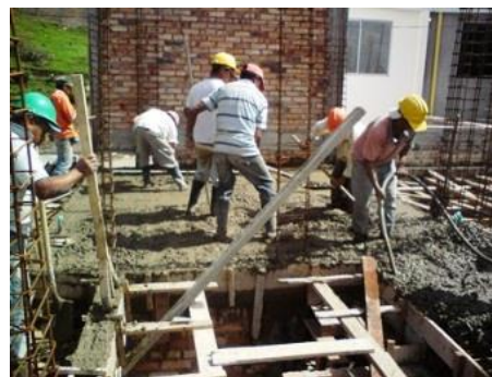
Figura No. 83 Vibrado del concreto
