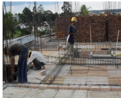
Figura No. 73 Colocación de estribos de la viga de entrepiso
