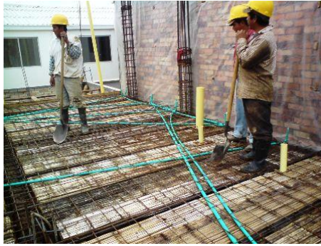
Figura No. 80 Preparación de la losa
