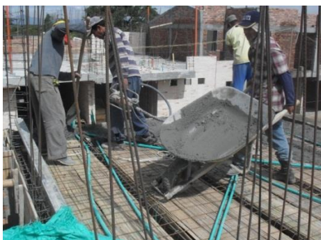
Figura No. 84 Vertido de concreto con carretas o buggis
