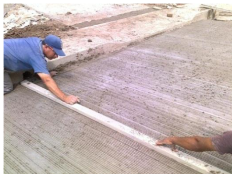
Figura No. 104 Marcado del pavimento
