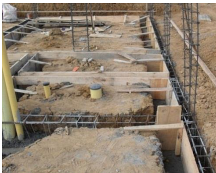
Figura No. 40 Colocación de la formaleta de la viga de cimentación
