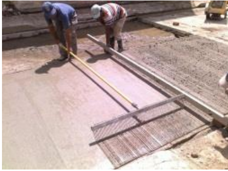
Figura No. 103 Rayado del pavimento fresco para dar la rugosidad
