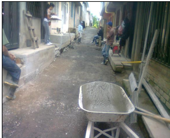
Foto 48. Preparación de superficie
