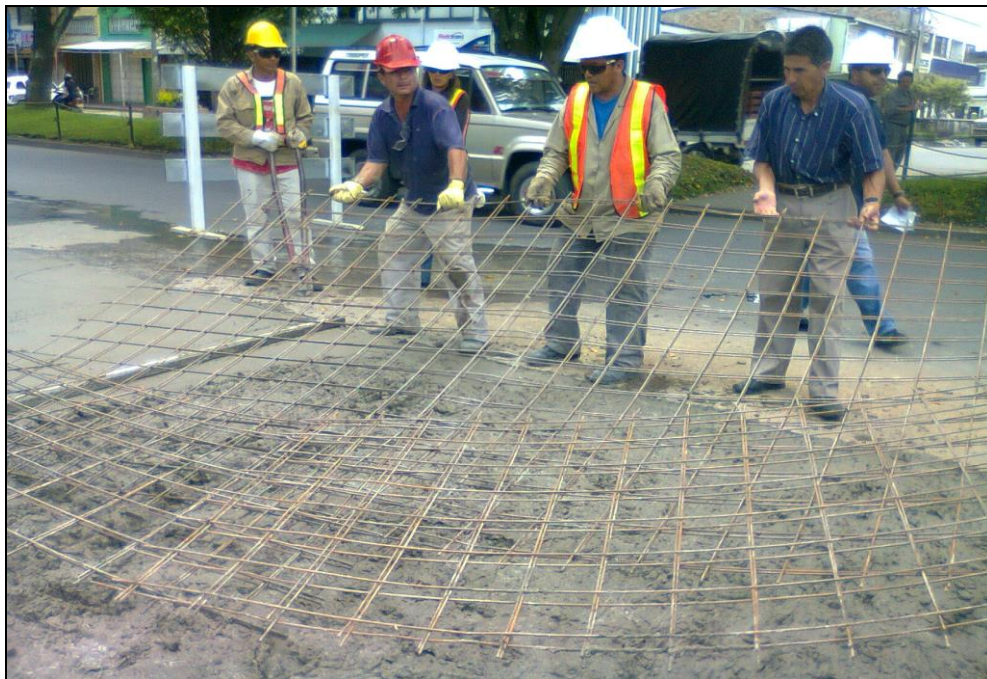
Foto 57. Refuerzo de losa con malla electrosoldada
