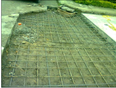
Foto 25. Refuerzo de losa atípica
