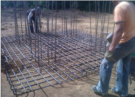
Foto 75. Refuerzo para zapata
