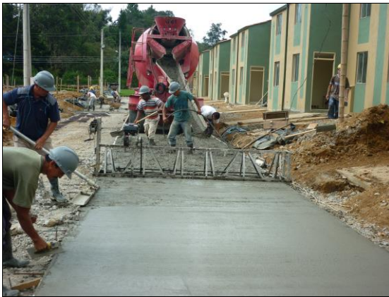
Foto 36. Colocación con regla
