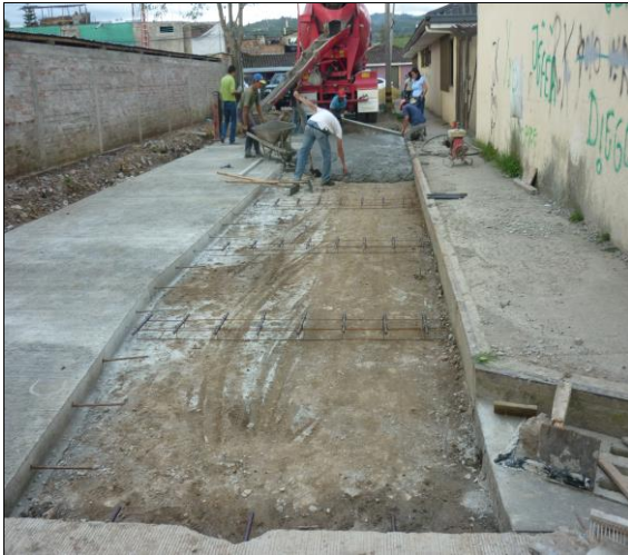
Foto 21. Canastillas para pasajuntas
