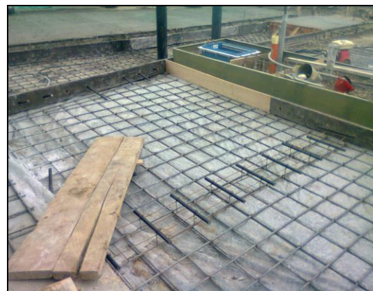
Foto 54. Refuerzo en la parte inferior
