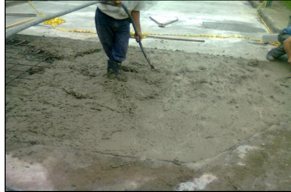
Foto 39. Fundición de losa
