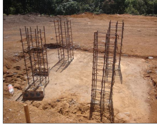
Foto 79. Pedestales del silo
