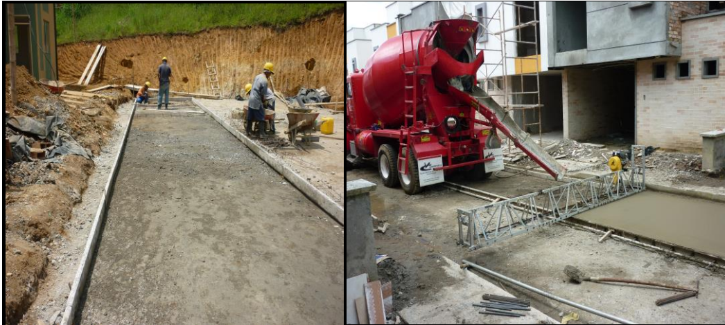
Foto 17. Colocación de moldes fijos
