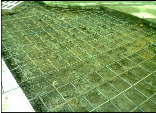
Foto 38. Refuerzo de losa atípica
