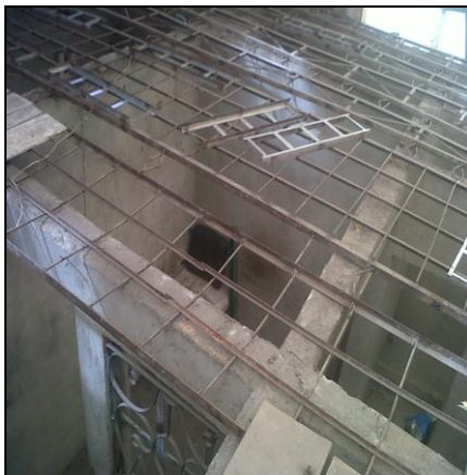
Foto 61. Acero de refuerzo (ángulos)
