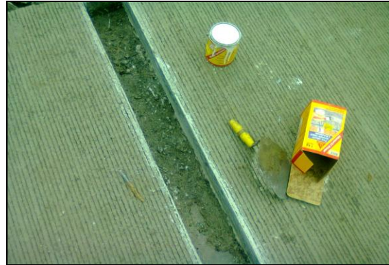
Foto 59. Arreglo de fisura
