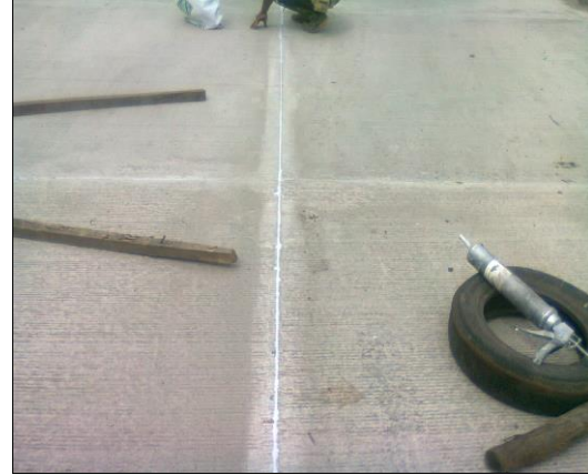
Foto 32. Sellado de juntas
