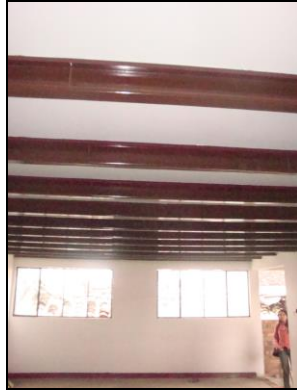
Foto 65. Sistema Steel deck
