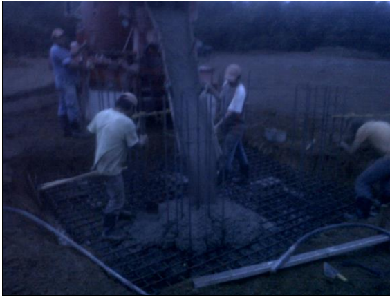
Foto 78. Fundición de zapata (7000 psi)
