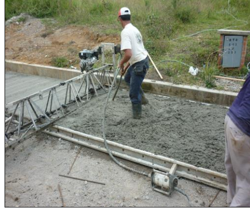
Foto 20. Construcción de un carril
