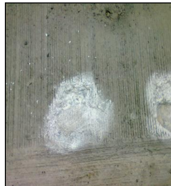
Foto 44. Huellas sobre losa
