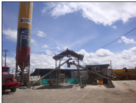
Foto 6. Almacenamiento de cemento
