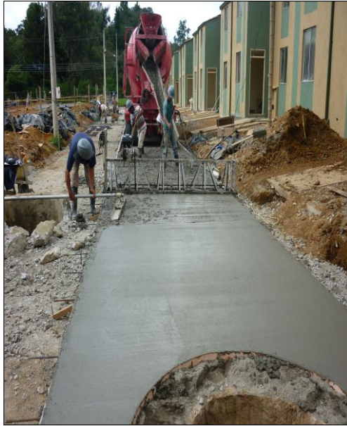
Foto 27. Flotado del concreto
