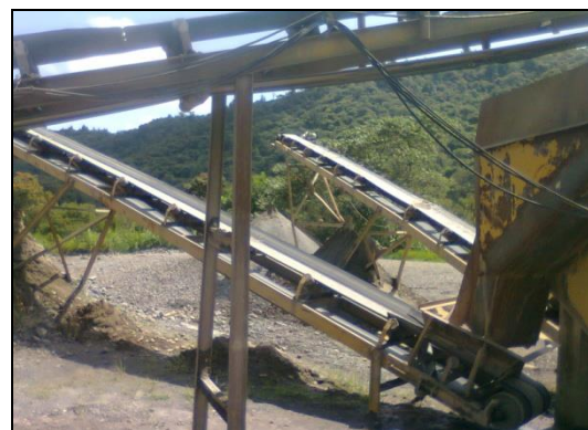
Foto 3. Planta trituradora de ECOCIVIL
