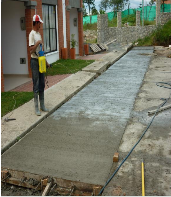
Foto 29. Adición de Antisol
