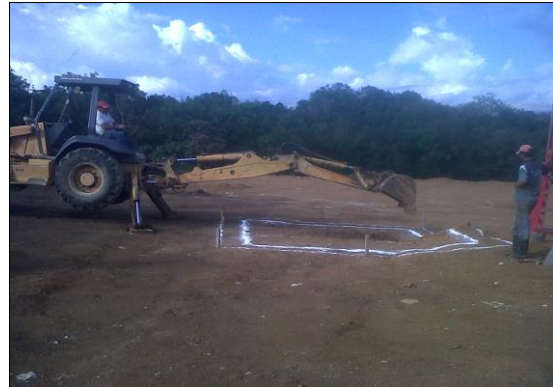
Foto 76. Localización y Excavación
