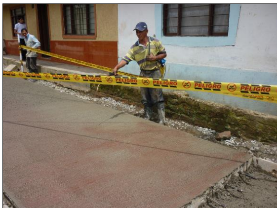
Foto 35. Curado del concreto
