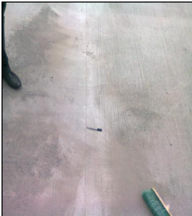
Foto 40. Losa fisurada
