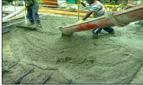
Foto 56. Concreto MR 43 acelerado
