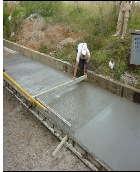
Foto 28. Macrotexturizado de concreto
