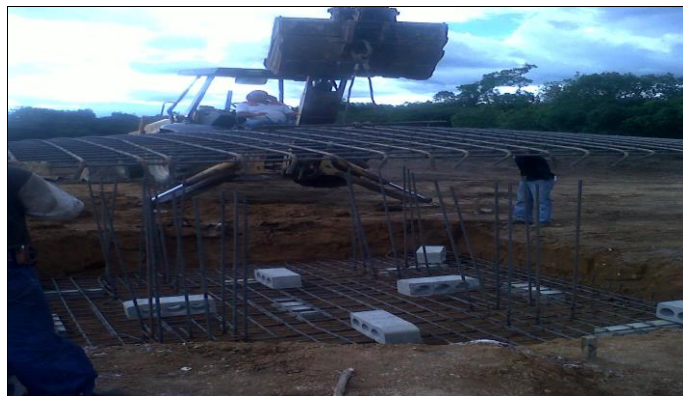
Foto 77. Colocación de refuerzo
