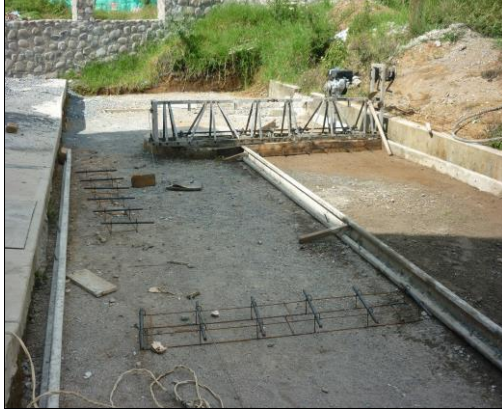
Foto 19. Colocación de moldes
