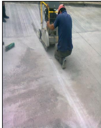
Foto 41. Corte de junta
