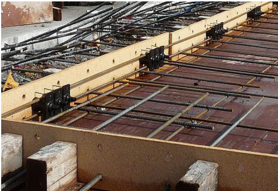
Foto 53. Instalación de anclajes
