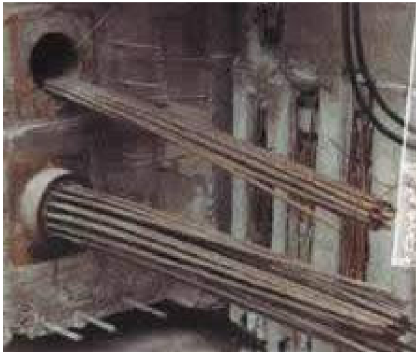
Foto 39. Cables Antes y Después del tensionado.
