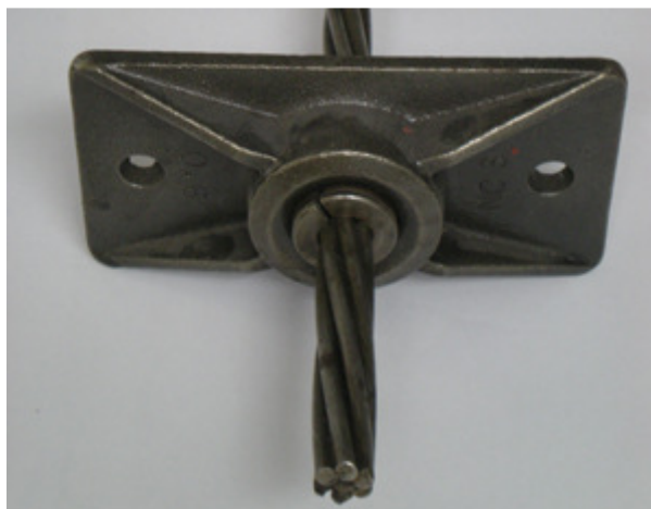
Foto 52. Anclaje Monotorón
