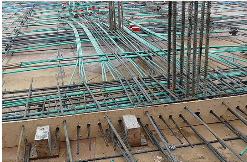
Foto 54. Ubicación del refuerzo activo.
