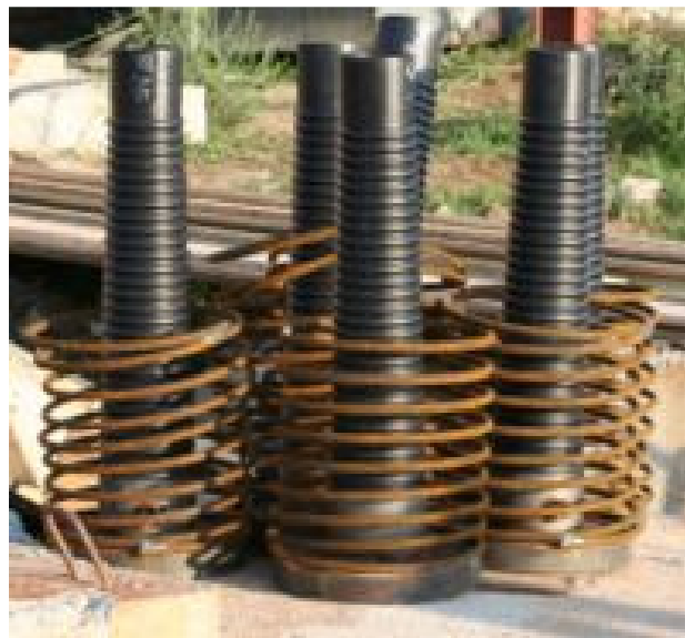
Foto 34. Trompetas y refuerzo listos para ser instalados
