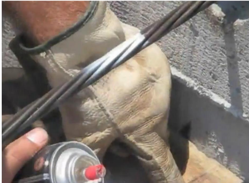
Foto 42. Chequeo de alargamientos mediante pintura de torones
