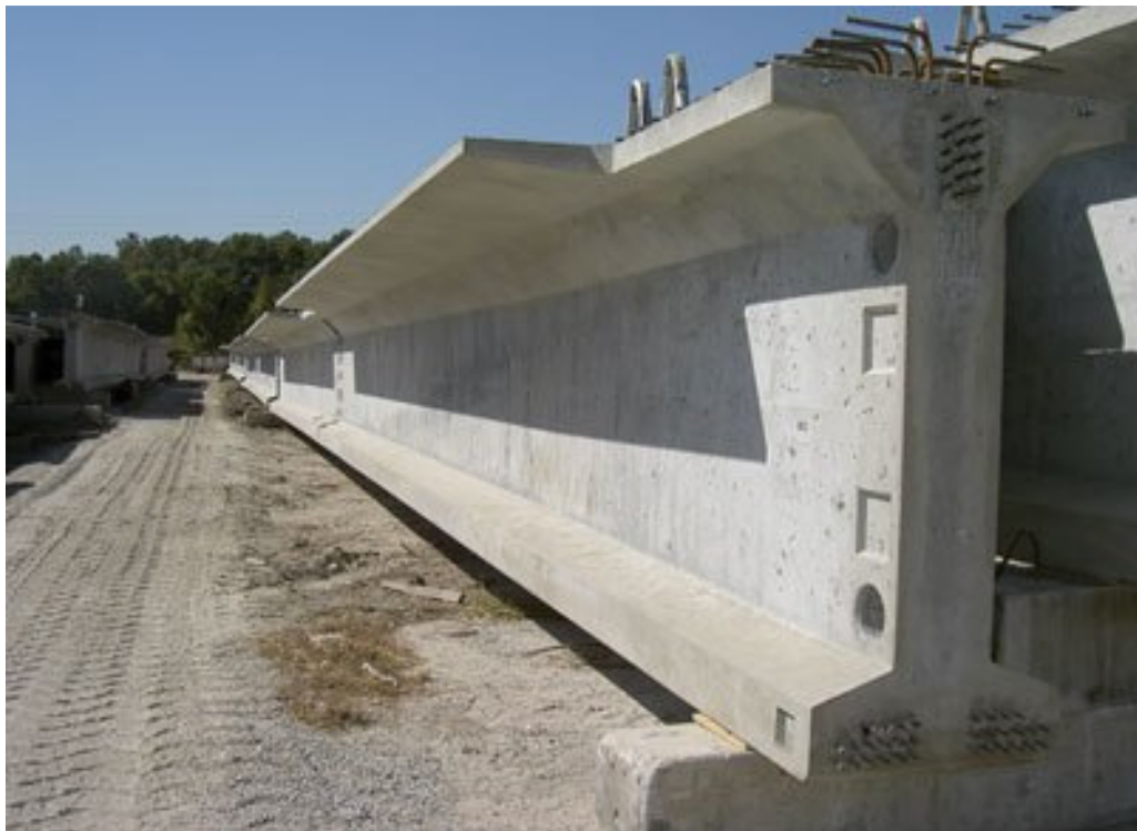
Foto 37. Viga t curada al vapor Aeropuerto Hartsfiel Atlanta -Florida
