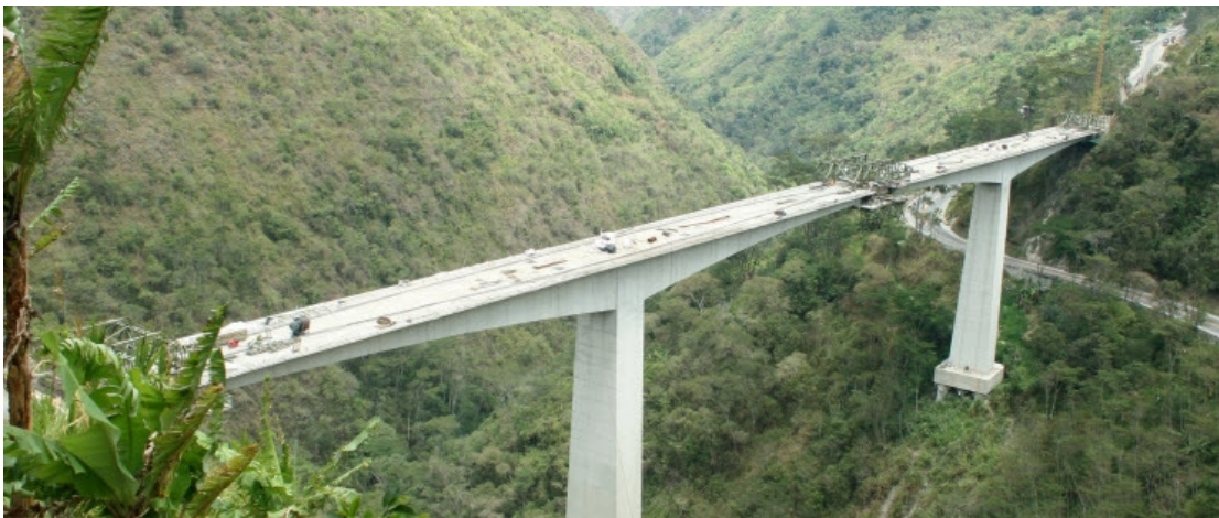
Foto 3. Viaducto El tigre en la vía Ibagué – Armenia; altura 122m
