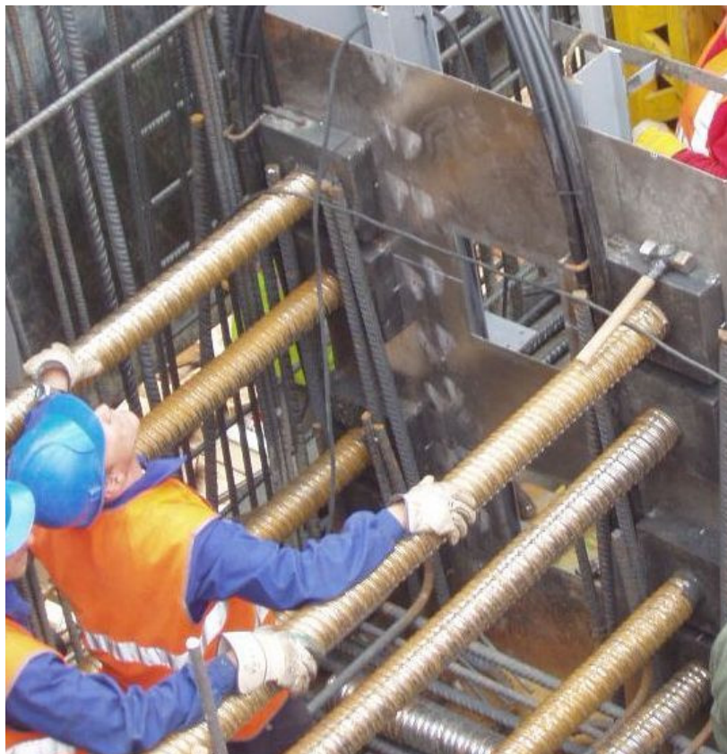
Foto 9. Viga Postensada adherida
