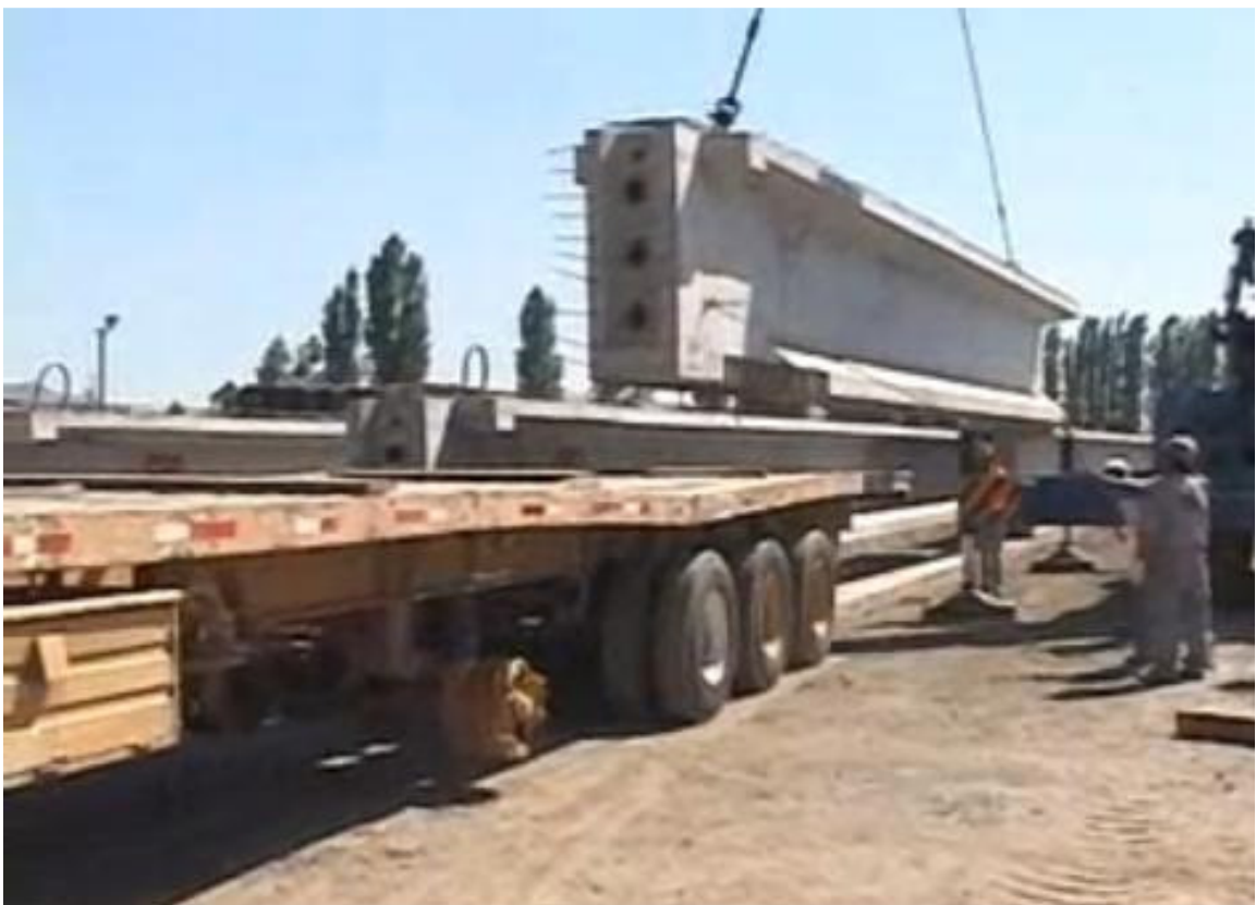
Foto 38. Traslado De vigas Postensadas hasta la obra
