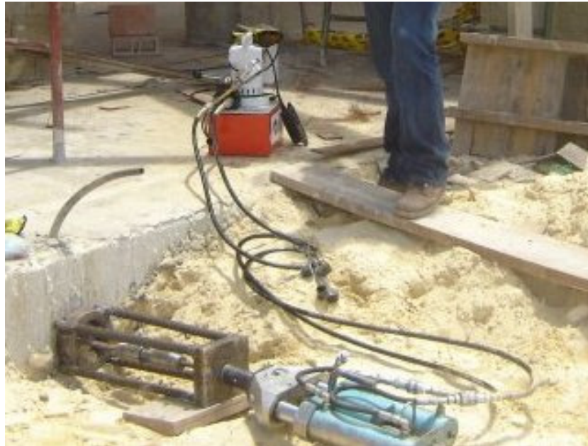
Foto 50. Gato twin y Bomba eléctrica
