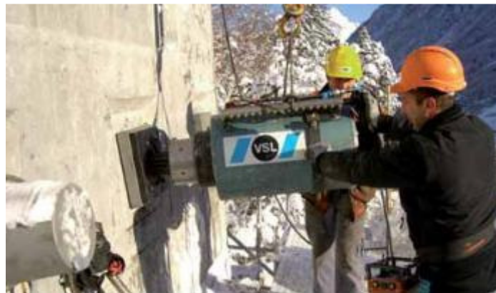
Foto 15. Proceso de tensado de cables
