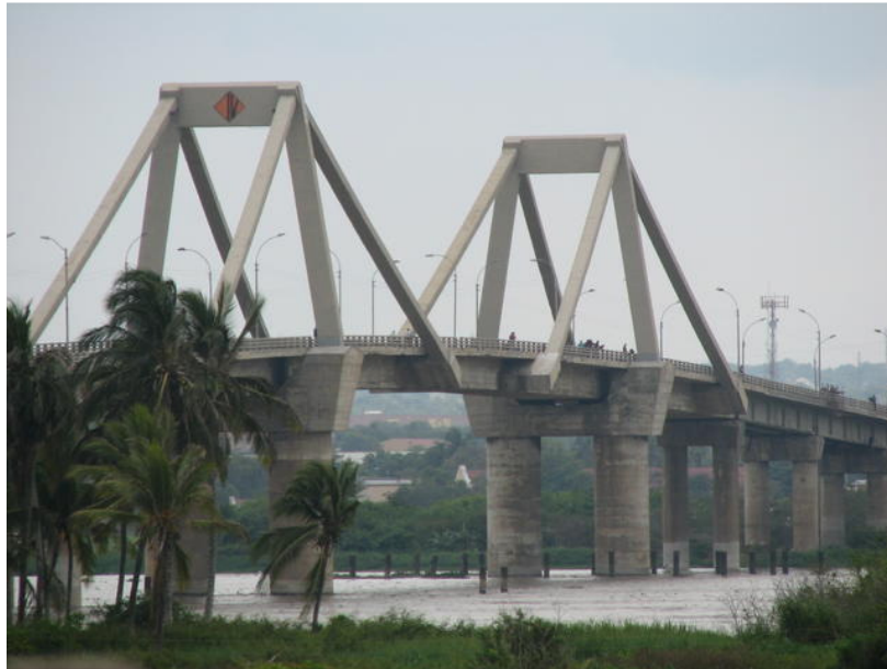
Foto 1. Puente Laureano Gómez "Pumarejo" - Barranquilla
