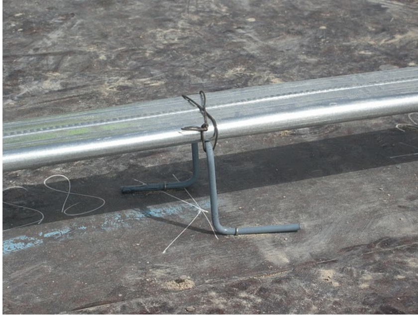
Foto 51. Sillas de sostenimiento.
