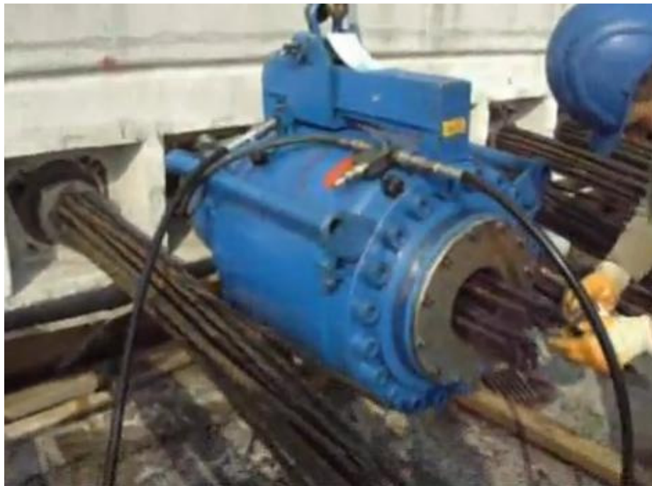
Foto 26. Gato Hidráulico montado para tensionamiento
