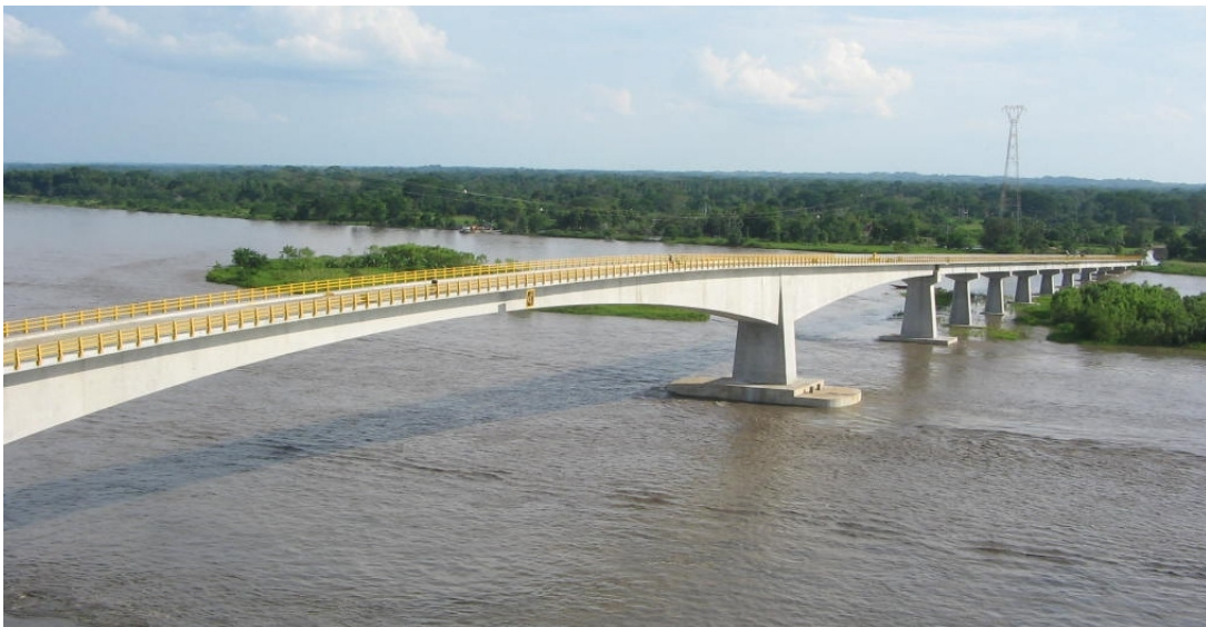
Foto 44. Puente en voladizos sucesivos, Barranca – Yondó
