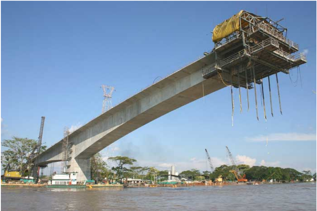
Foto 48. Carro sobre Dovela 18; Puente Yondó
