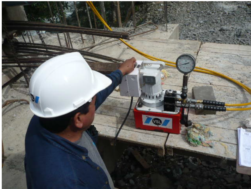
Foto 27. Operario accionando central hidráulica
