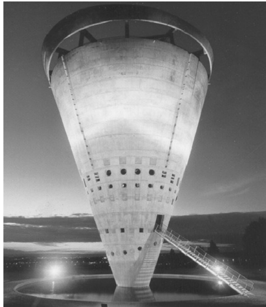
Foto 13. Estructura cónica invertida preesforzada de 40m de altura
