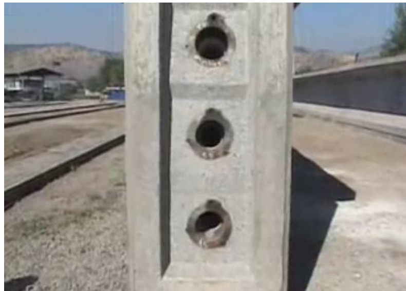
Foto 8. Viga a Postensar
