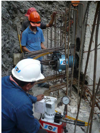
Foto 40. Gato y Bomba Eléctrica dispuestos para el tensionamiento
