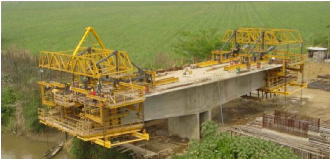
Foto 48. Construcción de dovelas laterales - T; Puente Yondó
