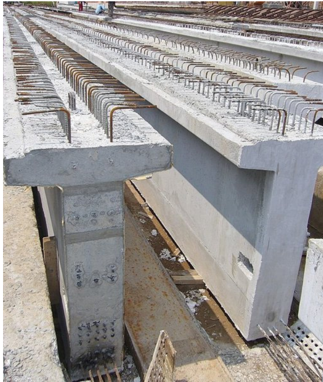
Foto 6. Viga t pretensada
