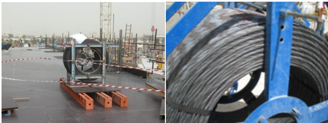
Foto 32. Rollo de torón montado en un Devanador
