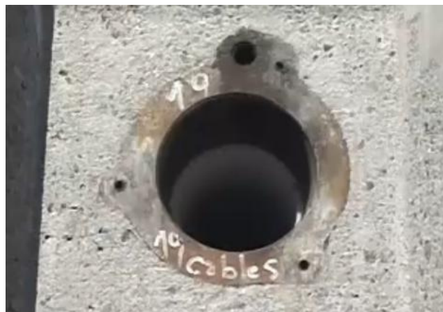
Foto 35. Trompeta instalada y Marcada
