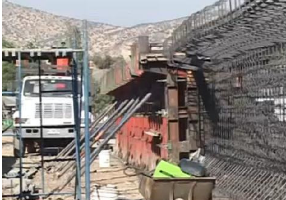
Foto 36. Hormigonado De vigas Postensadas
