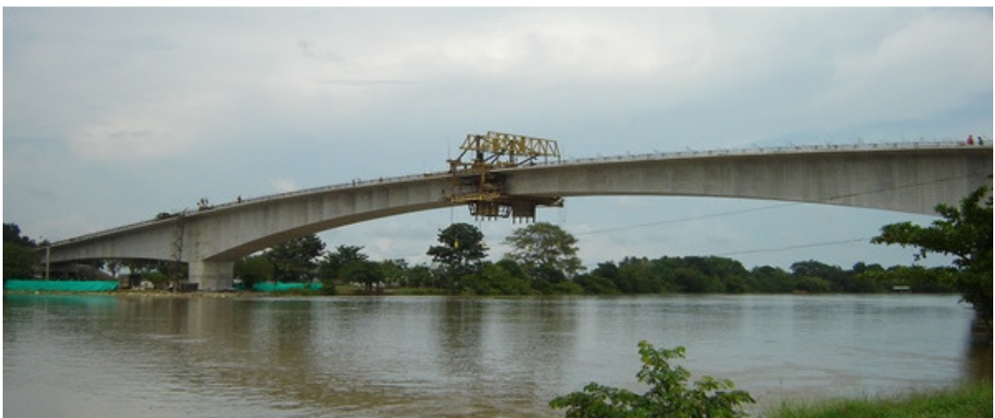
Foto 49. Carro sobre Dovela de Cierre; Puente Yondó
