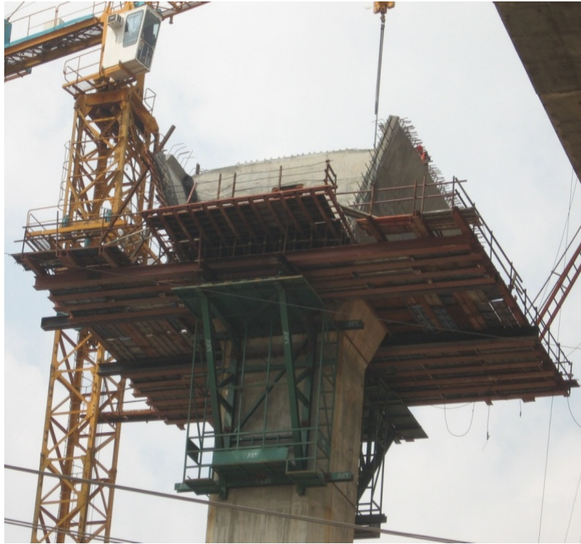
Foto 47. Construcción de dovela cero o sobre pila
