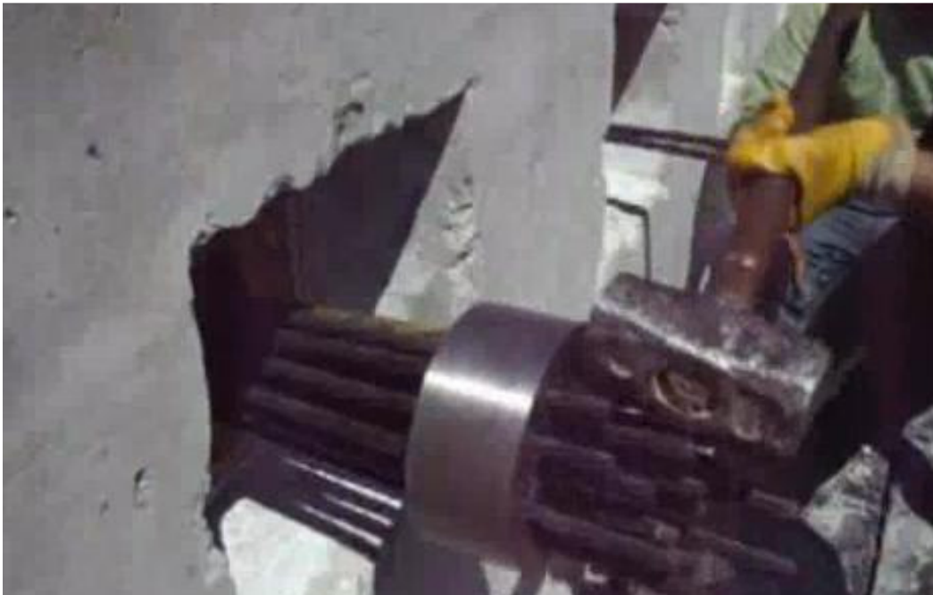
Foto 41. Instalación de Anclajes.
