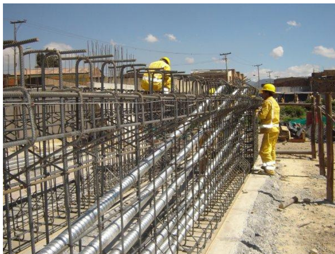
Foto 33. Instalación de Ducto
