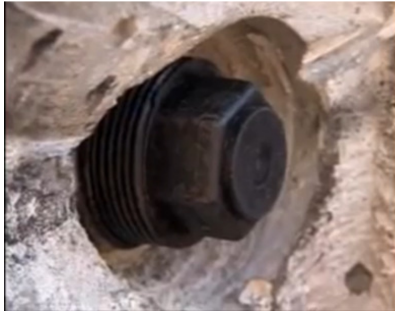
Foto 58. Taponamiento de anclaje
