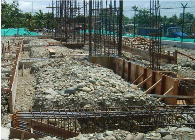
Foto No 11, cimientos eje C bodega No 1 TLBUEN hierro y formaleta de cimientos, tomado de archivo fotográfico constructora CRP. SAS.
