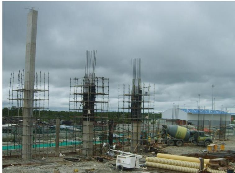
Foto No 16, Imágenes de las columnas exteriores con culata posterior ejes C, D y E empleando en su elaboración los andamios de carga. Tomado de archivo fotográfico constructora CRP. SAS.
