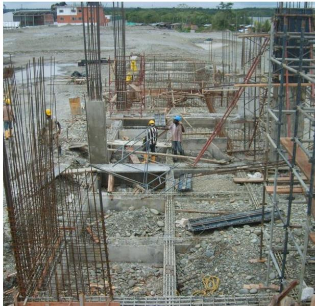
Foto No 17, Vigas de cemento bodega 1 A, mostrando inicio de columnas y pantallas. A la izquierda esta ubicado el eje B y a la derecha el A. tomado de archivo fotográfico constructora CRP. SAS.
