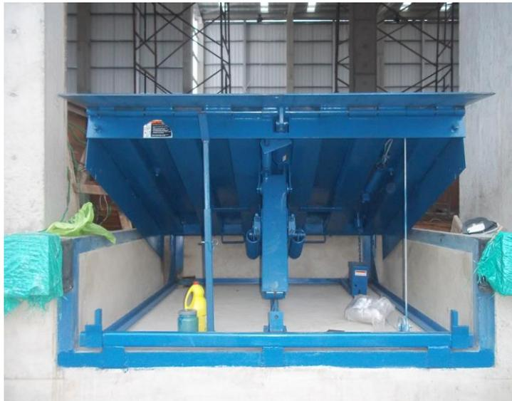
Foto No 30, imagen de una plataforma niveladora terminada, tomado de archivo fotográfico constructora CRP. SAS.
