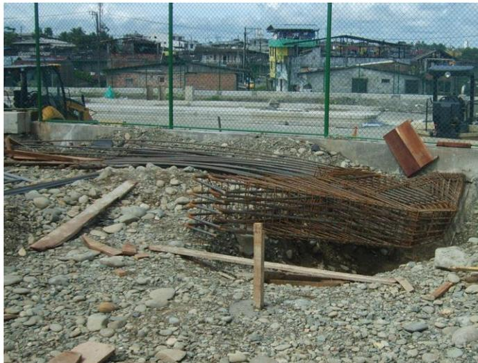
Foto No 12, cimientos eje C bodega No 1 TLBUEN volcamiento cimiento eje C3, tomado de archivo fotográfico constructora CRP. SAS.
