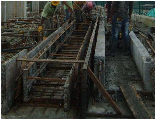
Foto No 31, Viga canal mostrando el proceso de encofrado, tomado de archivo fotográfico constructora CRP. SAS.
