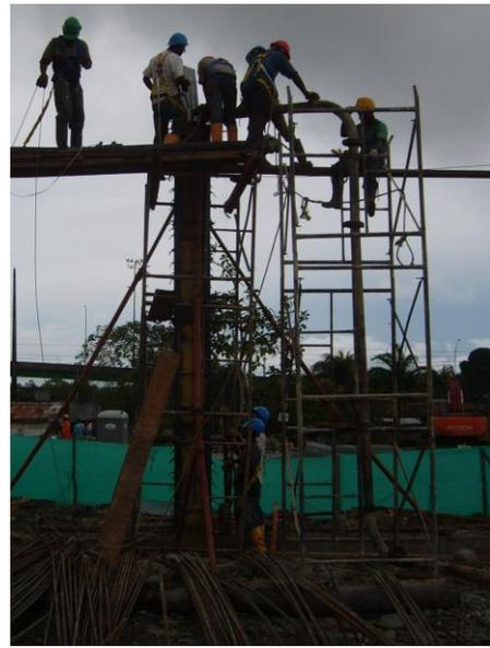
Foto No 14 y 15, proceso de encofrado columna CB2 y fundición de una columneta CB1. Tomado de archivo fotográfico constructora CRP. SAS.
