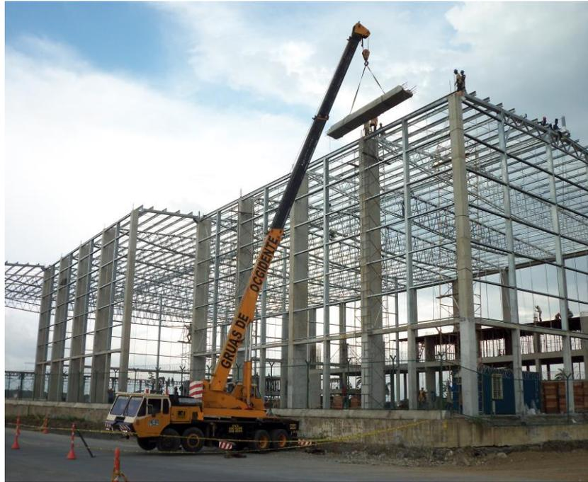
Foto No 32, izado de la viga canal prefabricada eje C, Bodega 1A, tomado de archivo fotográfico constructora CRP. SAS.
