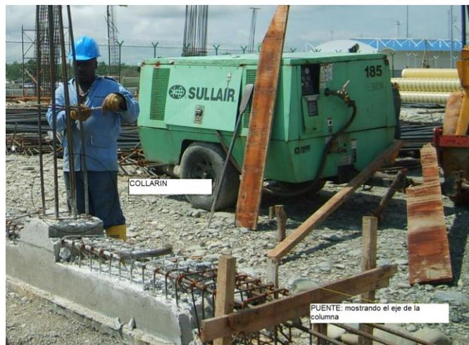
Foto No 13, columneta CB1, con collarín de arranque y amarre del refuerzo, también vemos el puente o referencia de eje. Tomado de archivo fotográfico constructora CRP. SAS.
