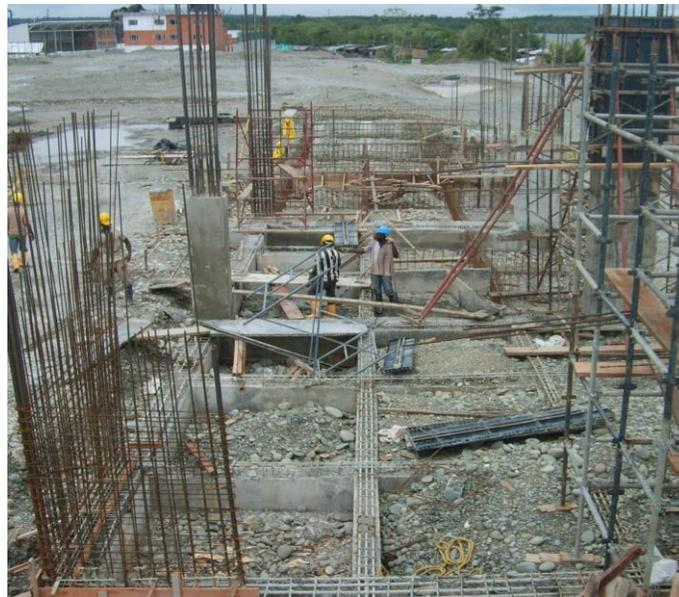
Foto No 8, Vista general, cimentación bodega 1 A, mostrando a la izquierda el eje B y a la derecha el eje A, con arranque de columnas y pantallas, además apreciamos los andamios de carga en el eje A, a punto de realizar fundición de 3 tramo de columna. tomado de archivo fotográfico constructora CRP. SAS.
