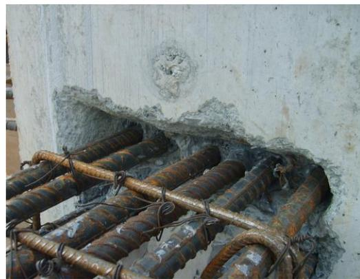
Fotos No 26 y 27 Proceso constructivo losas de entrepiso, Perforaciones y anclaje de varillas. Tomado de archivo fotográfico constructora CRP. SAS.
