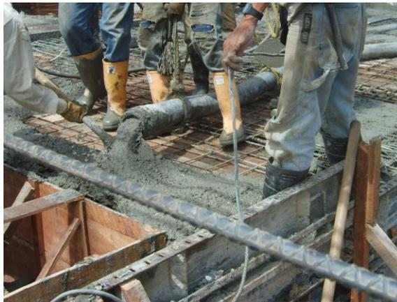
Fotos No 20, 21, 22, 23 y 24 Proceso constructivo losas de entresuelo. tomado de archivo fotográfico constructora CRP. SAS.
