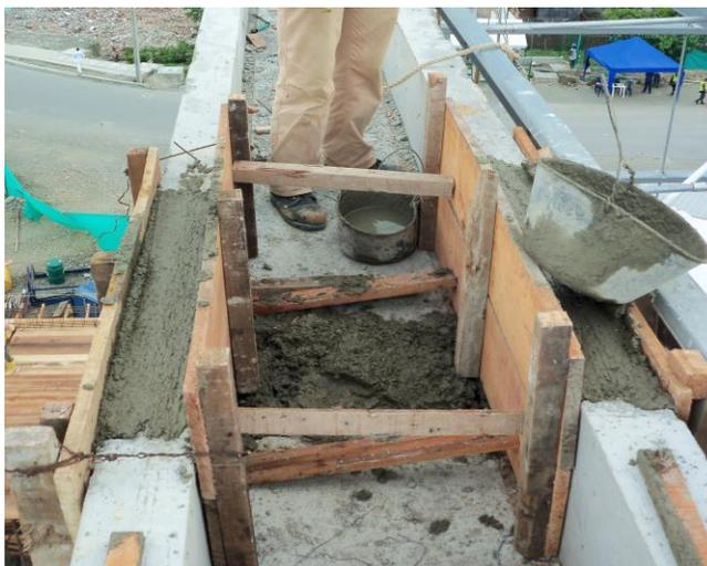
Foto No 34, fundición nudo de amarre viga canal, posición definitiva de los prefabricados en la cubierta, Bodega 1A, tomado de archivo fotográfico constructora CRP. SAS.
