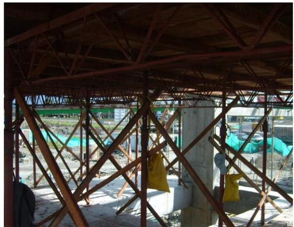
Fotos No 18 y 19, Proceso constructivo losas de entrepiso. Tomado de archivo fotográfico constructora CRP. SAS.
