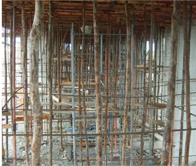
Foto No 25, Proceso constructivo losas de entrepiso, retaque de losa. tomado de archivo fotográfico constructora CRP. SAS.
