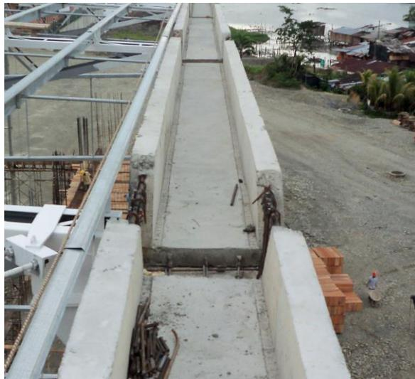
Foto No 33, izado de la viga canal prefabricada, posición definitiva de los prefabricados en la cubierta, Bodega 1A, tomado de archivo fotográfico constructora CRP. SAS.
