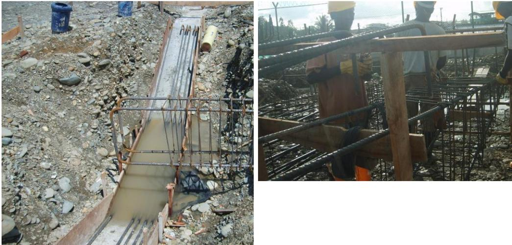
Foto No 9 y 10, cimientos eje C bodega No 1 TLBUEN soldado y armado de hierros, tomado de archivo fotográfico constructora CRP. SAS.
