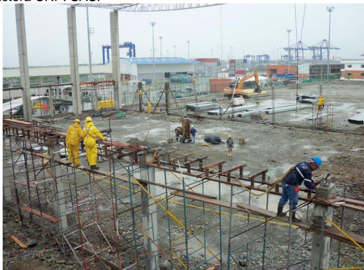
Foto No 29, encofrado de piso viga aérea, mostrando también el armado del refuerzo a lo largo del eje 5, tomado de archivo fotográfico constructora CRP. SAS.
