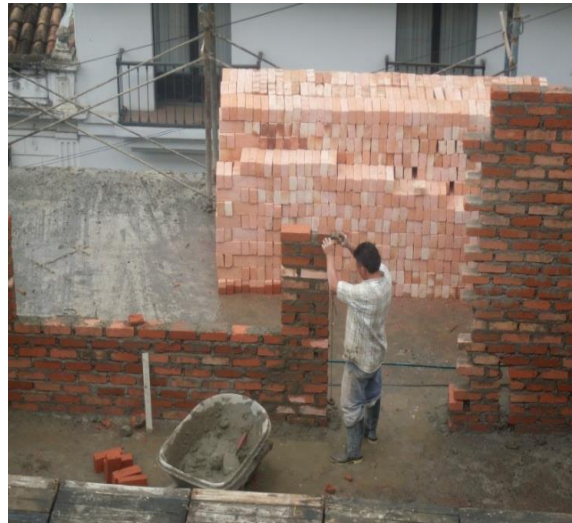
Fig. 8.58. Nivelación con plomada para terminación de muros.
