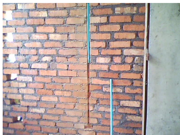
Fig. 8.75. Colocación de tubería eléctrica en la regata
