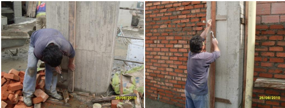
Fig. 8.52. Fijado de vara con clavos.
