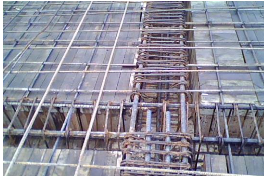
Fig. 8.27. Vista de espesor de viga lista para fundir.
