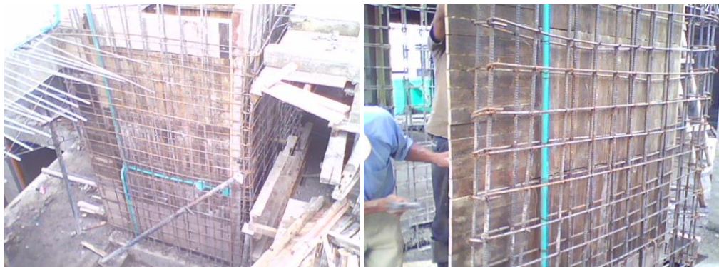
Fig. 8.73. Tubos verticales para interruptores y tomacorrientes
