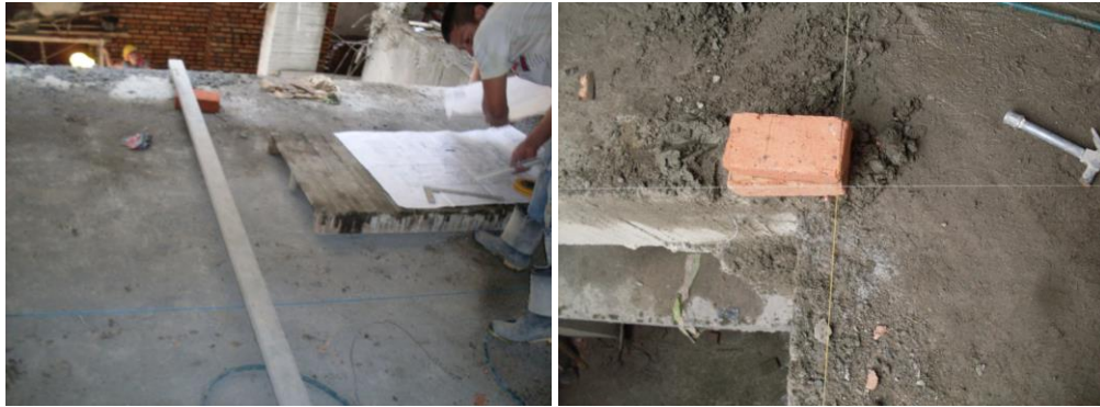
Fig. 8.64. Localización de muro desde el borde.
