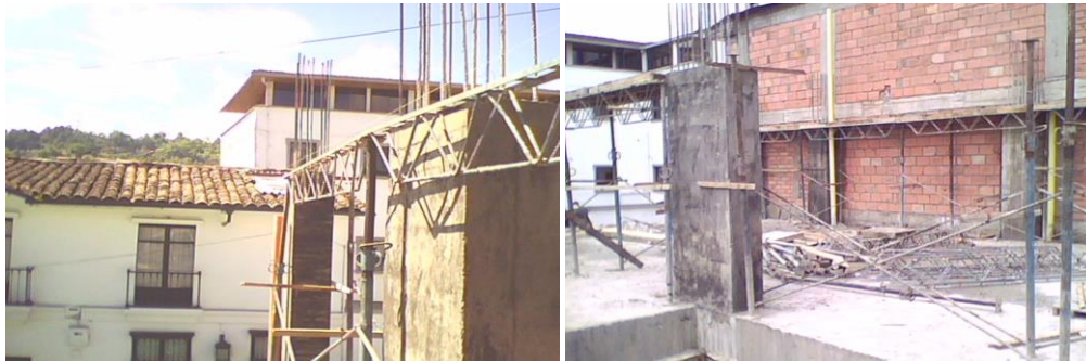
Fig. 8.22. Inicio de ubicación de formaletas en vigas
