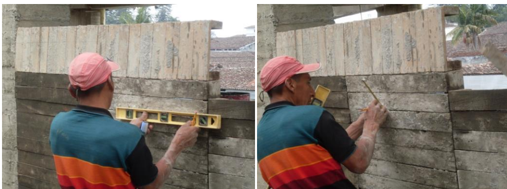
Fig. 8.34. Seguimiento localización parte media de escaleras
