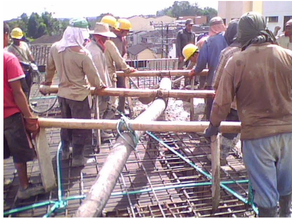
Fig. 8.76. Tubería a punto de ser embebida por concreto de la losa.
