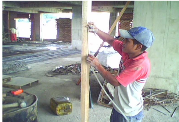
Fig. 8.54. Paso de niveles a las varas.
