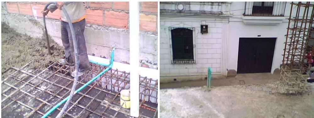
Fig. 8.71. Salida de tubos para tomas
