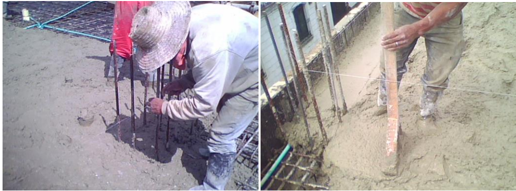
Fig. 8.42. Templado de hilo y pisón de madera.
