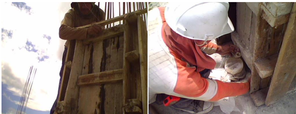
Fig. 8.9. Uso de la plomada en formaleta.
