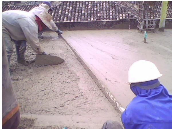
Fig. 8.46. Losa nivelada con codal.
