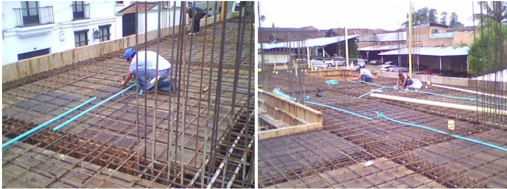
Fig. 8.69. Tendido de tubos de 1/2 pulgada..
