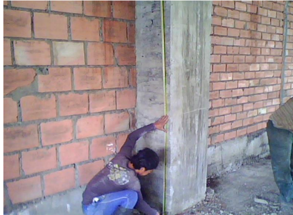
Fig. 8.48. Medida para la altura de muros.
