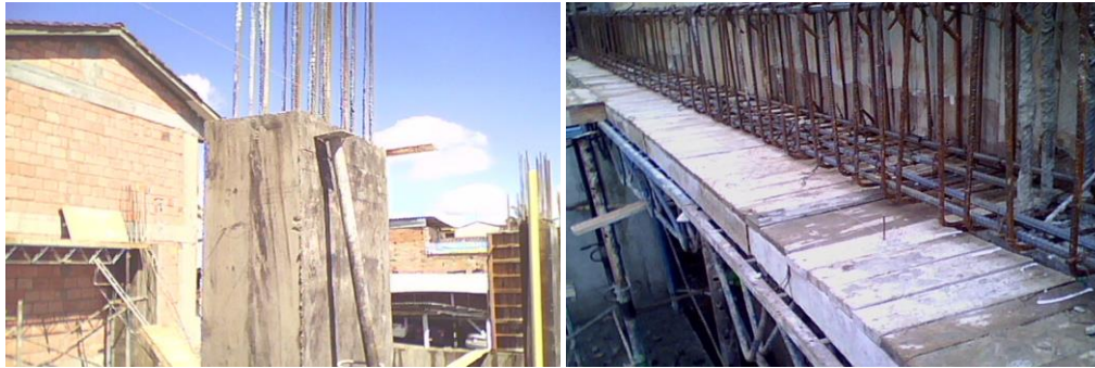
Fig. 8.18. Hilos y puntillas que ayudan para la localización.
