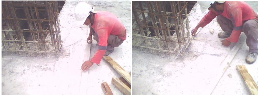
Fig. 8.5. Trazo de línea con pintura y medición perpendicular.
