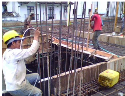
Fig. 8.39. Transporte de niveles sobre varas auxiliares
