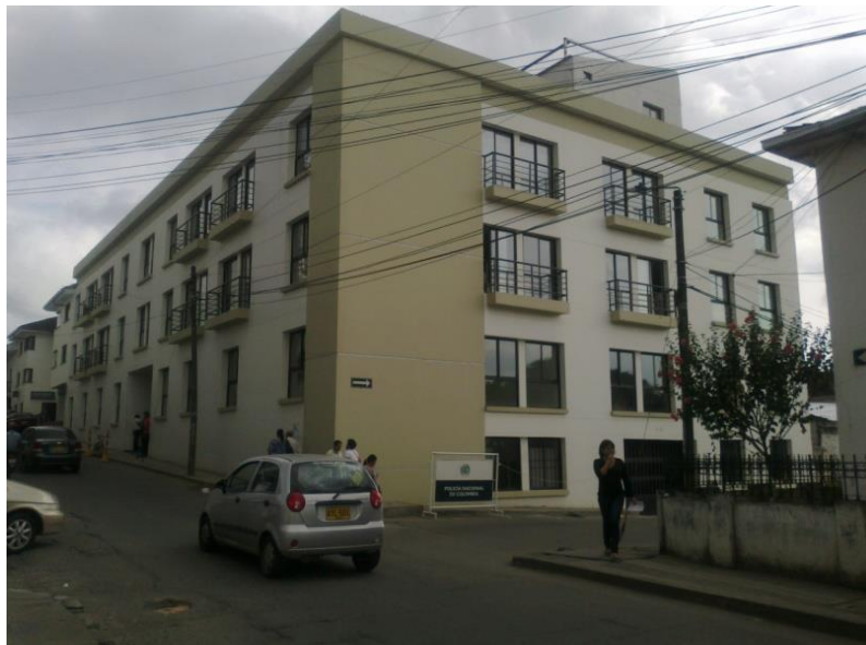
Fig. 4.3. Edificio terminado y funcionando.
