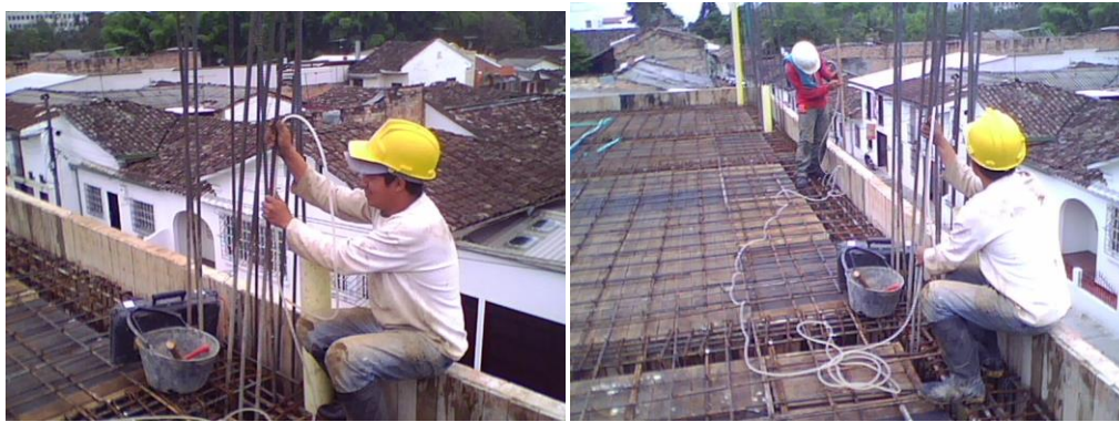
Fig. 8.38. Transporte de niveles sobre barras de acero.
