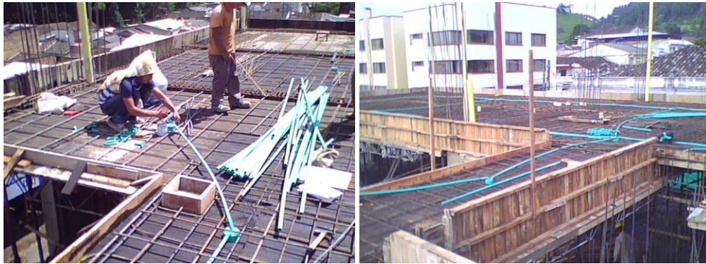
Fig. 8.72. Unión de tubos con las cajas.
