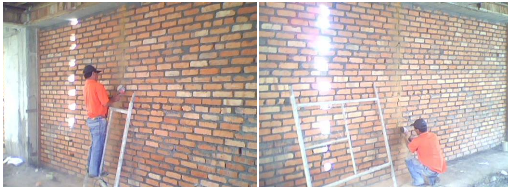
Fig. 8.74. Abierta de regata para incrustar tubería eléctrica.
