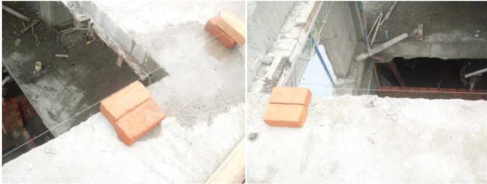
Fig. 8.61. Templado de hilos que alinean el muro
