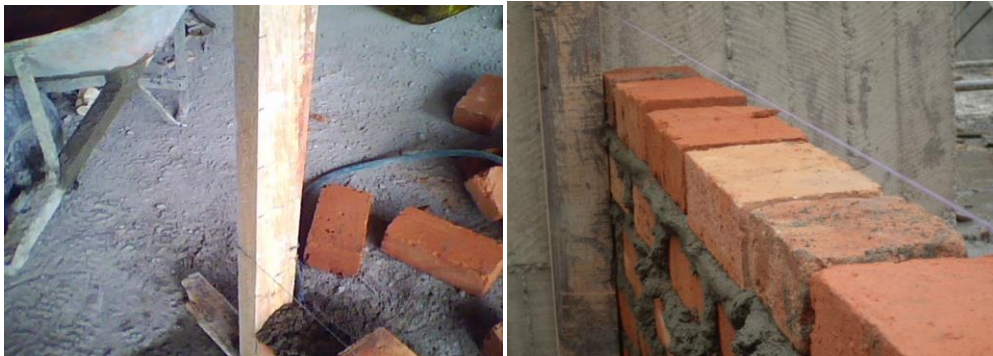
Fig. 8.56. Vista de hilo guiado por las marcas tomadas de la fig. 8.55.
