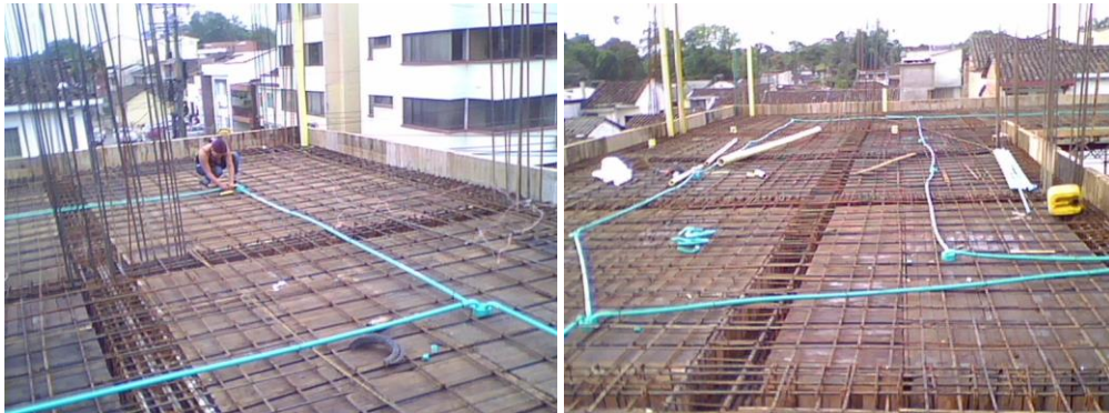
Fig. 8.70. Ubicación de tubos conforme su necesidad
