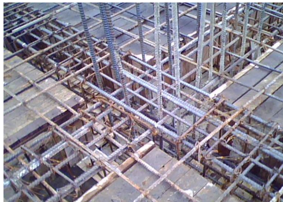
Fig. 8.21. Intersección de vigas.
