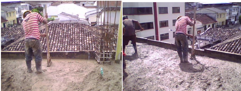
Fig. 8.43. Utilización del pisón de madera guiado por el hilo.
