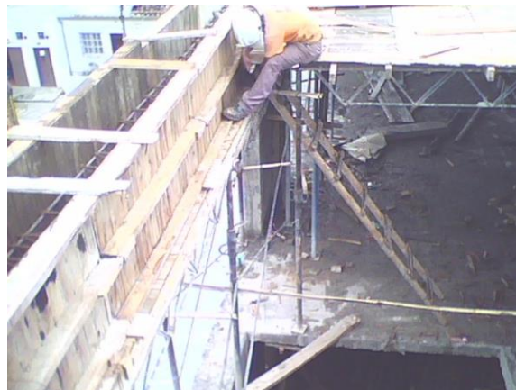
Fig. 8.24. Terminación ubicación de formaletas.
