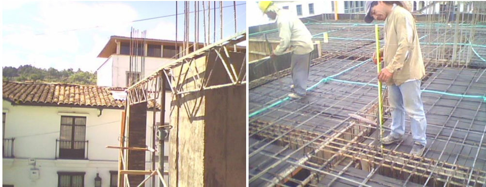
Fig. 7.5. Hilos templados para dar horizontalidad en vigas y losas
