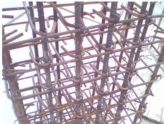
Fig. 8.8. Aceros en columnas
