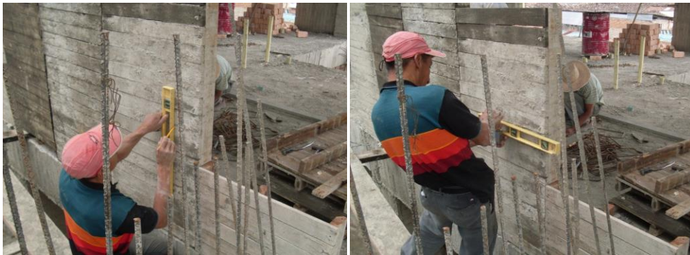
Fig. 8.32. Continuación de localización de escalones. Salvo el escalón inicial que debe tener una mayor medida en la contrahuella, ya que después esta se disminuye con el acabado del piso inferior, lo mismo pasa con el escalón final en el cual la contrahuella debe tener un menos medida que los demás porque después hay que aumentarle el acabado del piso superior.
