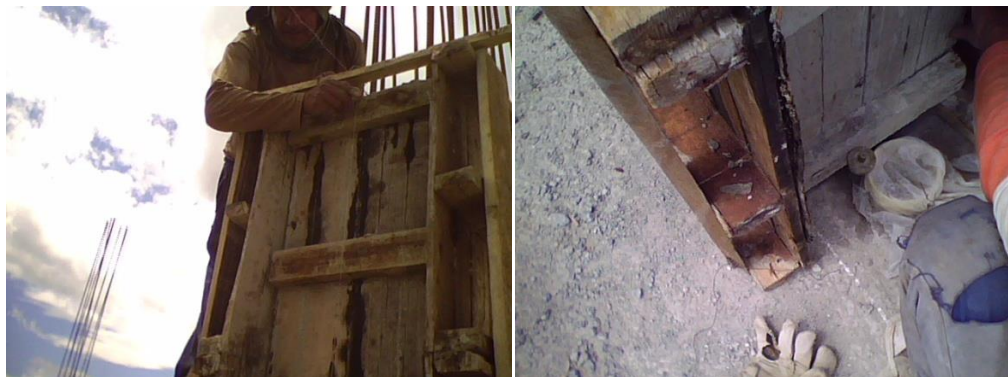
Fig. 7.4. Uso de plomada para controlar verticalidad en formaleta de columna.
