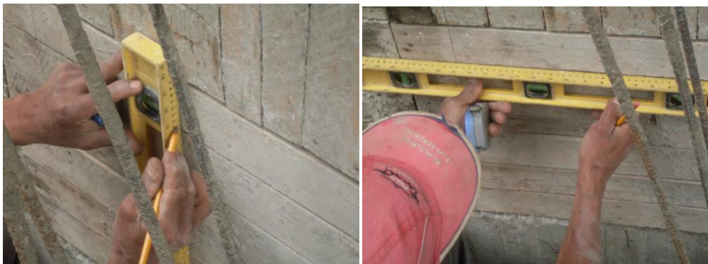
Fig. 8.30. Uso nivel de burbuja.
