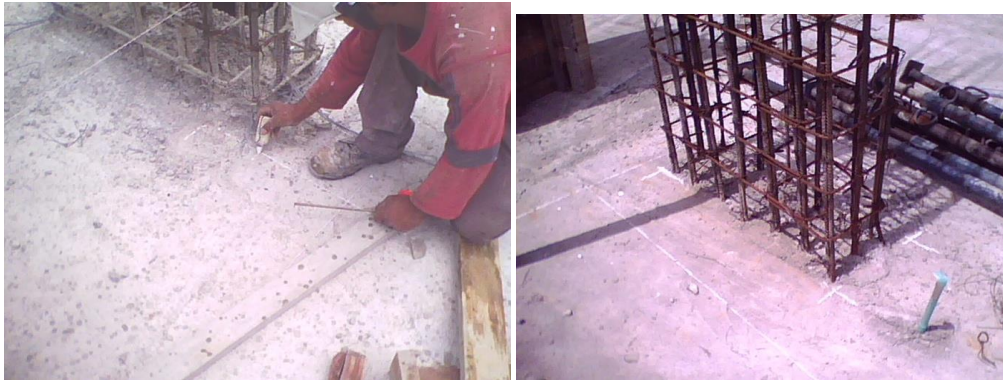
Fig. 8.7. Localización de vértices de columnas en la otra cara.
