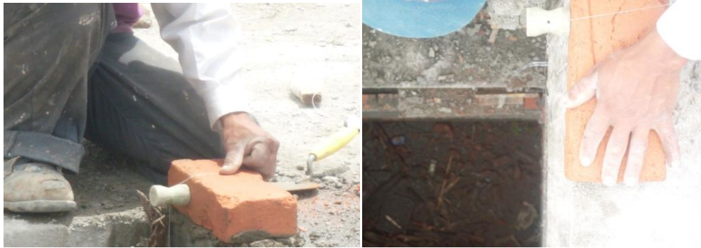
Fig. 8.59. Uso plomada de centro para localizar muros exteriores.
