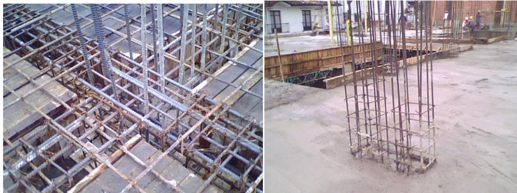
Fig. 8.15. Continuación de columnas.
