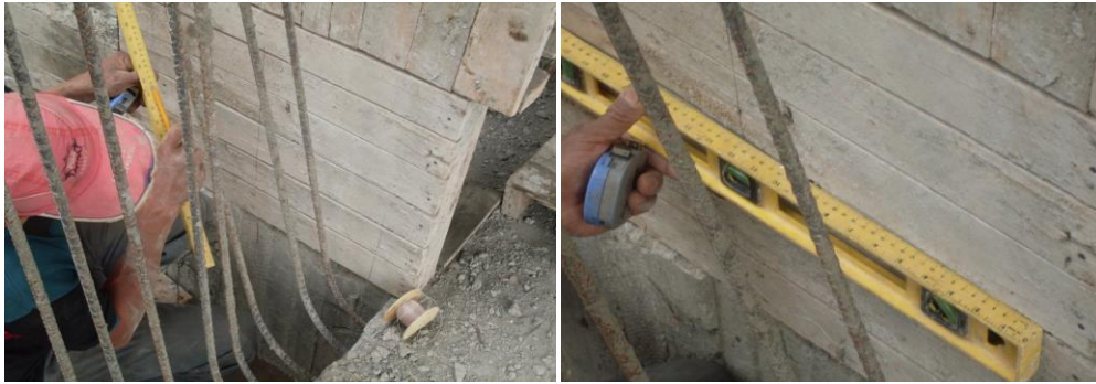
Fig. 8.29. Inicio de arriba hacia para la localización de escalera.
