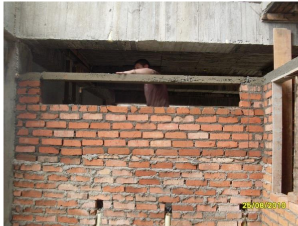
Fig. 8.68. Dintel desencofrado
