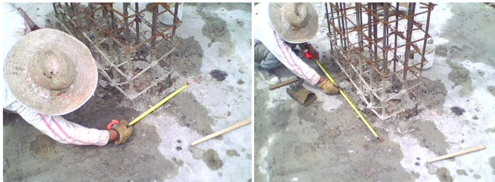
Fig. 8.8. Clavado de puntillas en los vértices.
