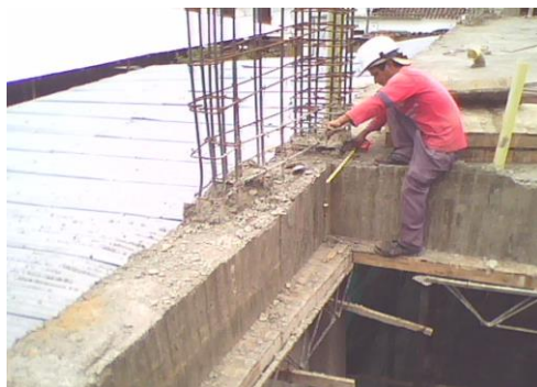
Fig. 8.26. Medición de espesor de vigas.
