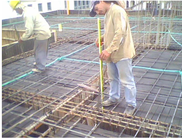
Fig. 8.40. Medida de losa a hilo guía.
