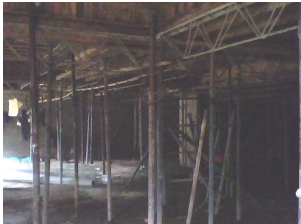
Fig. 8.41. Gatos para soporte de losa
