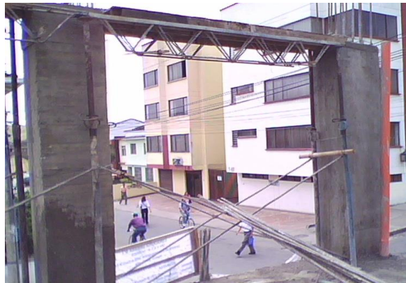
Fig. 8.17. Construcción de viga.
