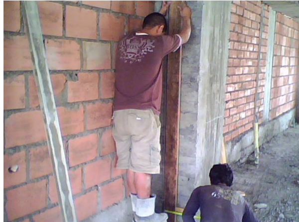
Fig. 8.50. Vara guía para la localización de muros
