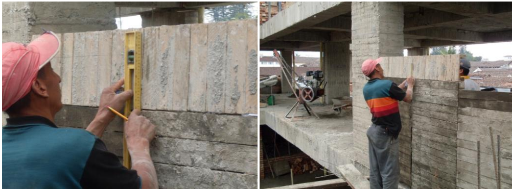
Fig. 8.36. Terminación localización escaleras.
