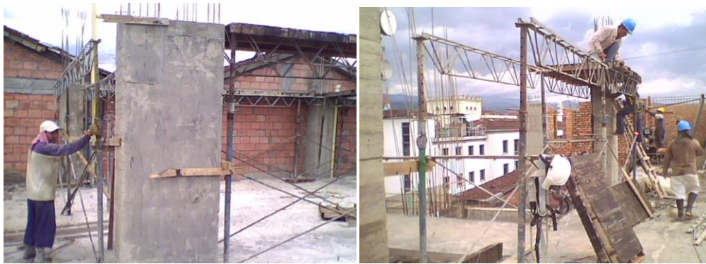
Fig. 8.23. Seguimiento ubicación formaletas en vigas.
