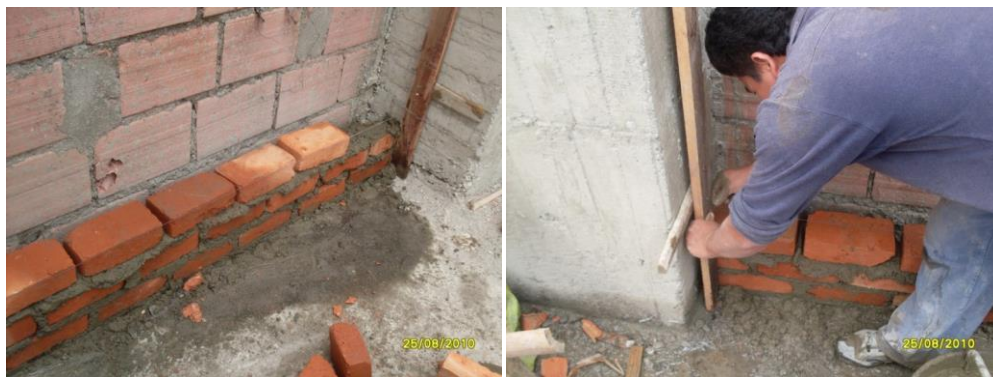
Fig. 8.57. Hiladas de ladrillo para muro en soya.
