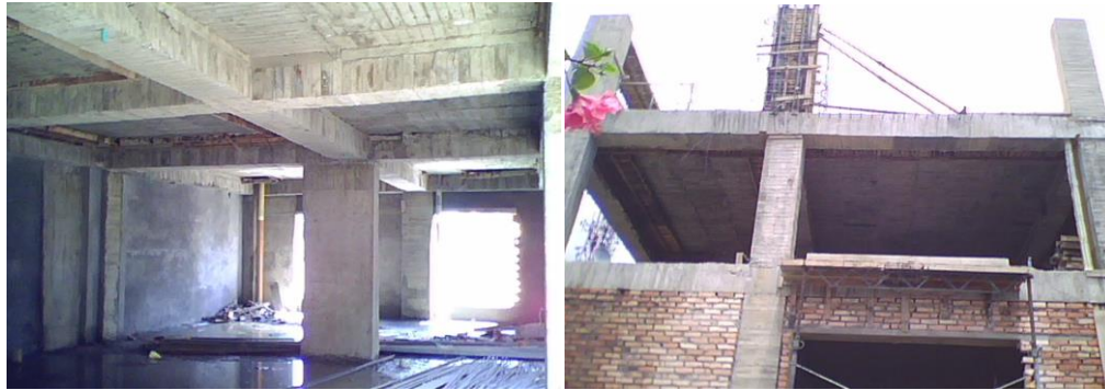
Fig. 8.25. Vista de vigas desencofradas.
