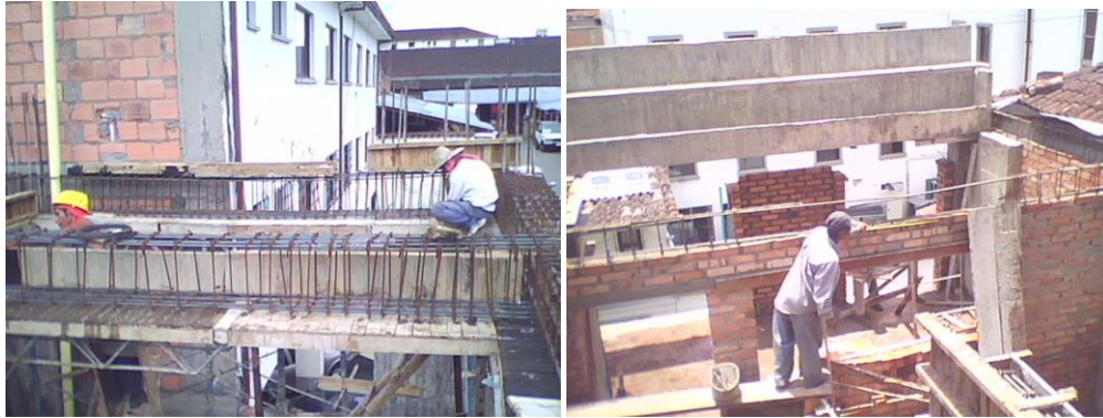
Fig. 8.20. Flejes de vigas
