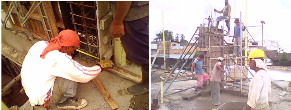
Fig. 8.10. Construcción de formaleta.
