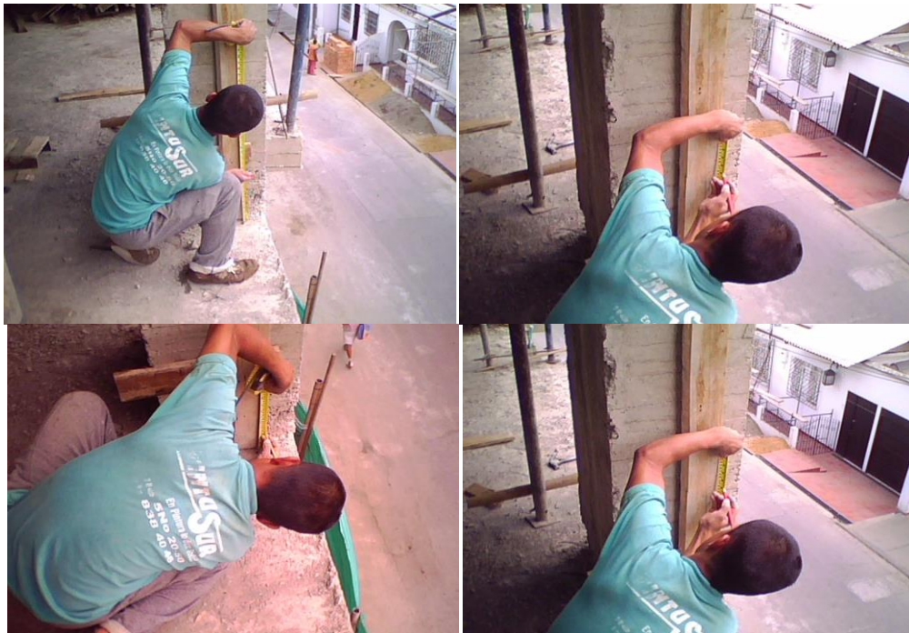
Fig. 8.55. Medida para guiar las hiladas de los muros
