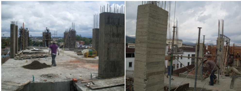
Fig. 8.13. Columnas desencofradas.
