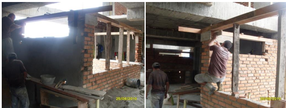
Fig. 8.67. Soporte de dinteles.
