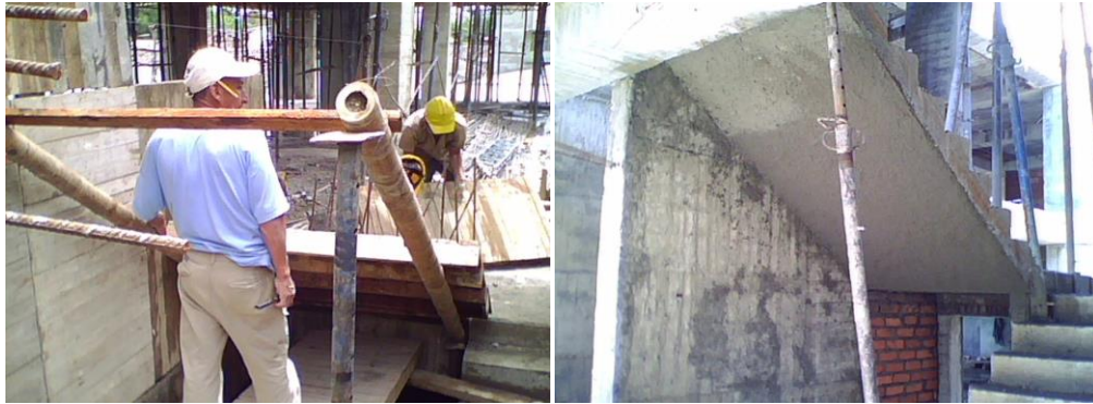
Fig. 8.37. Espesor escalera
