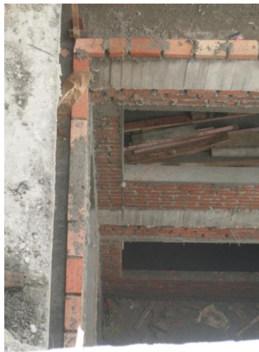
Fig. 8.60. Planteo de muro exterior.
