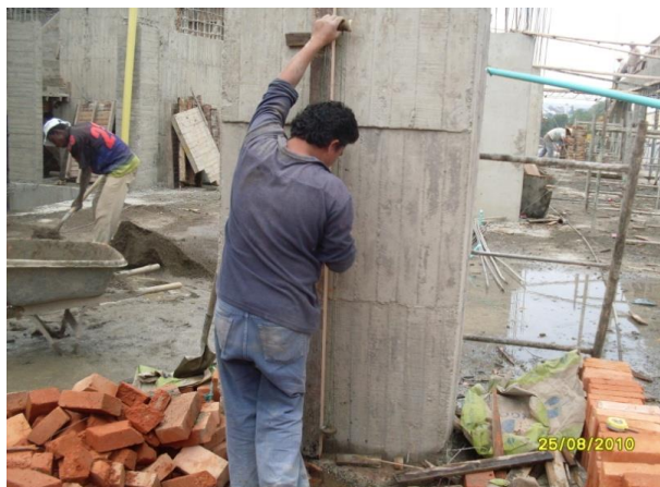
Fig. 8.51. Nivelación de la vara con plomada.
