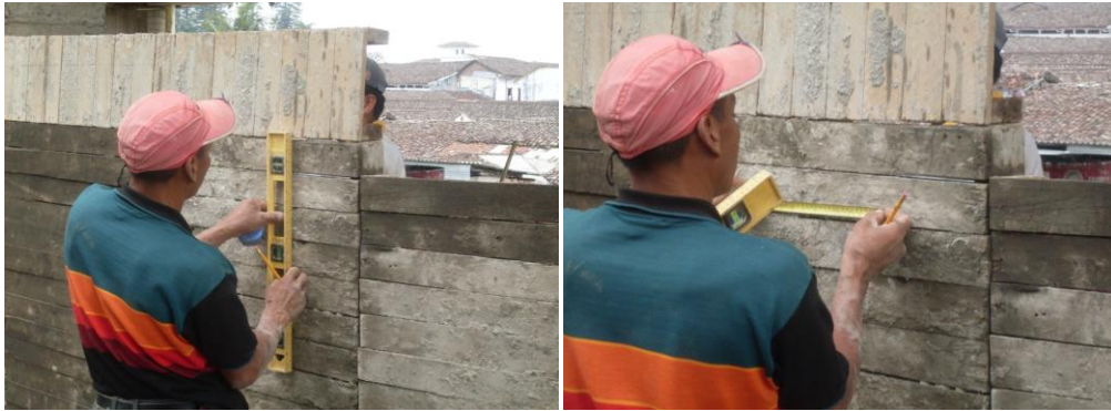
Fig. 8.33. Seguimiento de uso de nivel de burbuja y metro.
