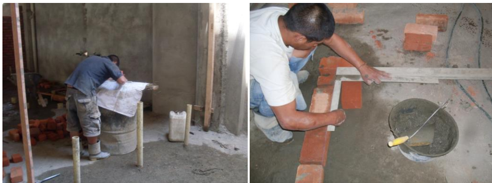
Fig. 8.65. Planos y uso de escuadra en vértices de muros
