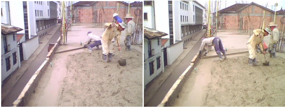
Fig. 8.45. Codal deslizado sobre las hileras hechas por el pisón de madera.
