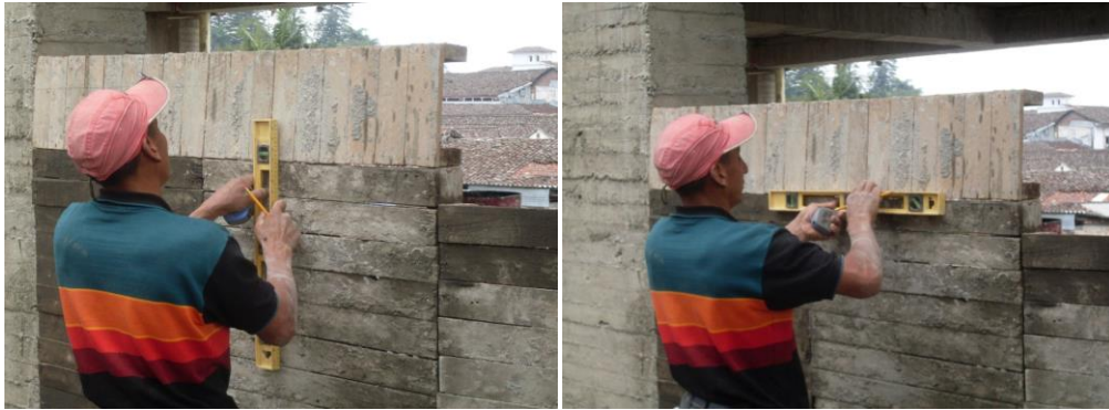
Fig. 8.35. Parte final de primera parte de escalera
