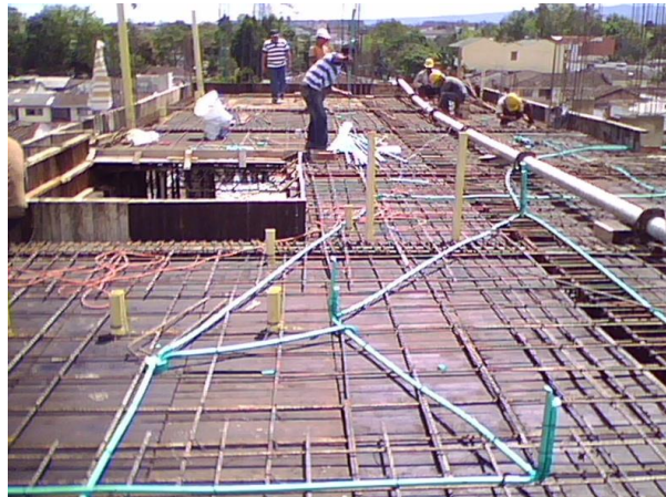
Fig. 8.77. Tubería eléctrica (verde) y sanitaria (amarilla).
