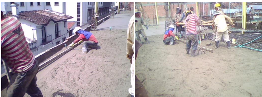
Fig. 8.44. Manejo de codal para nivelar.
