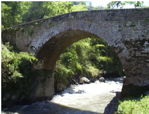
Fig. 62. Aspecto del Puente real desde un lado.
