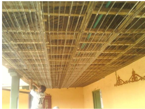
Fig. 31. Fijación de la malla a la estructura de madera.
