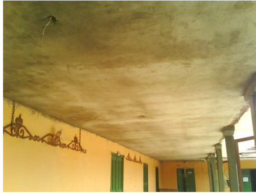
Figs. 36 y 37. Aspecto del cielo raso al aplicar el mortero a la parte superior.
