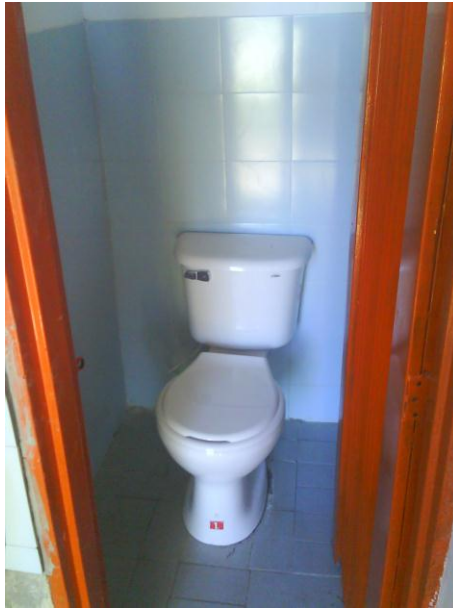
Fig. 53. Nuevos sanitarios instalados y en servicio.
