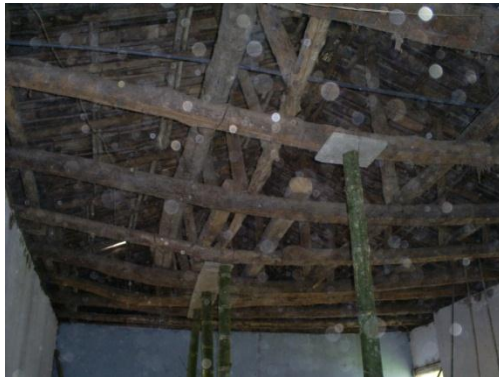
Fig. 25. Infraestructura de la cubierta y cielo raso existente.
