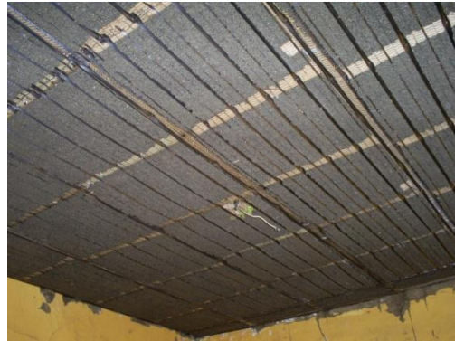
Fig. 33. Aplicación del mortero a la parte superior de la malla.
