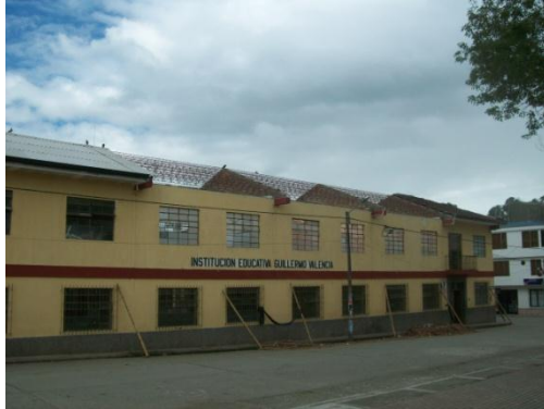
Fig. 19. Aspecto de la Institución tras la remoción de la cubierta antigua.
