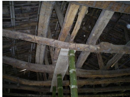
Fig. 26. Muestra de los amarres entre elementos estructurales.
