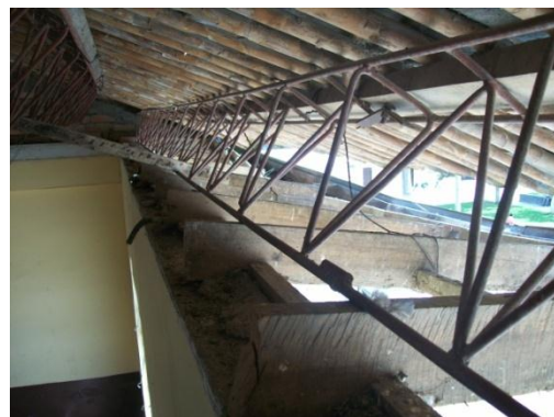
Fig. 12. Estado de las cerchas.
