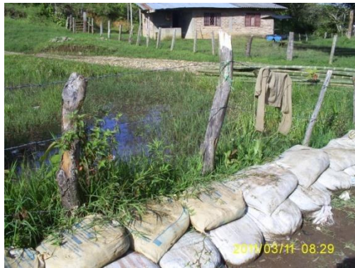
Fig. 60. Bolsas de arena puestas por la comunidad para controlar la infiltración.
