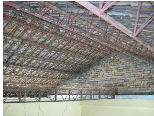
Fig. 10. Infraestructura de la cubierta antes de la intervención.
