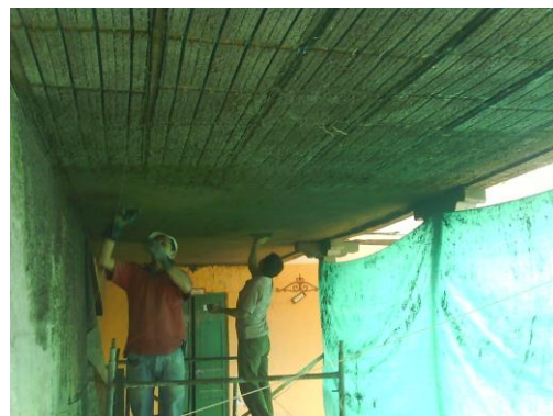
Fig. 35. Aplicación del mortero a la parte inferior de la malla.
