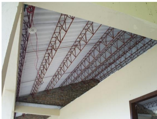
Fig. 23. Aspecto actual de la cubierta, visto desde el pasillo.
