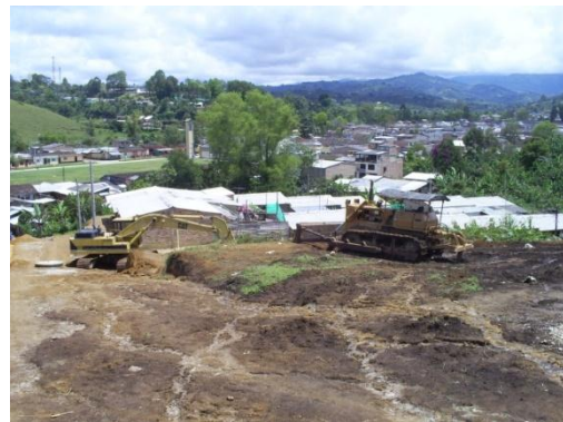
Fig. 55. Maquinaria empleada para la apertura de las vías.
