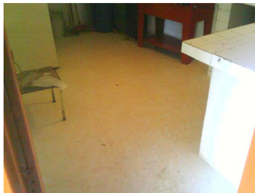
Fig. 50. Pisos rehabilitados en baldosa cerámica.
