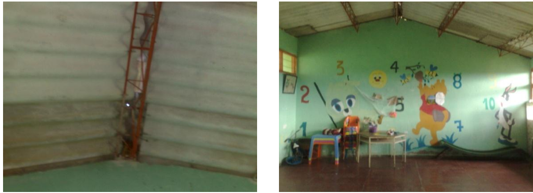
Figs. 47 y 48. Aspecto del salón del grado cero antes de realizar la intervención.
