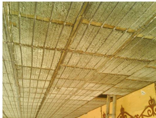
Fig. 34. Aspecto del cielo raso al aplicar el mortero a la parte superior.
