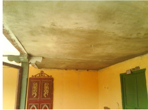
Figs. 36 y 37. Aspecto del cielo raso al aplicar el mortero a la parte superior.
