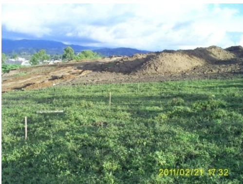
Fig. 56. Lotes estacados según las dimensiones especificadas.
