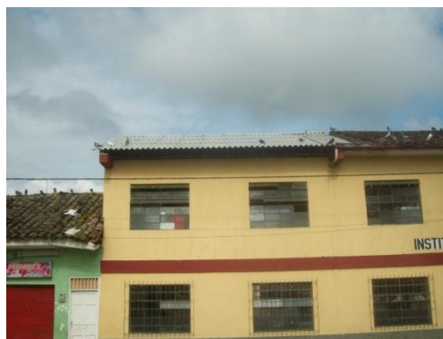
Fig. 14. Aspecto exterior de la nueva cubierta al ser instalada.
