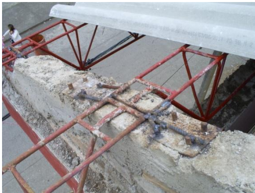
Fig. 21. Anclaje de la celosía a las culatas.
