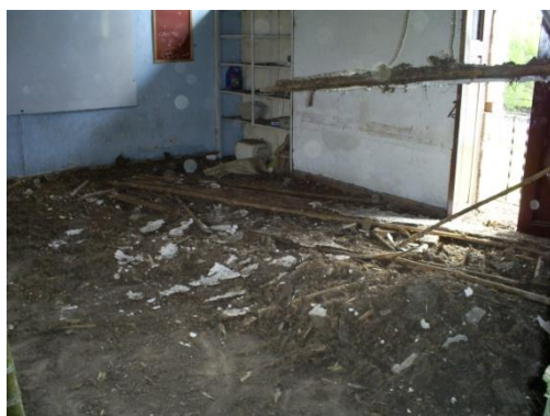
Fig. 27. Muestra del material que compone el cielo raso tras su demolición.
