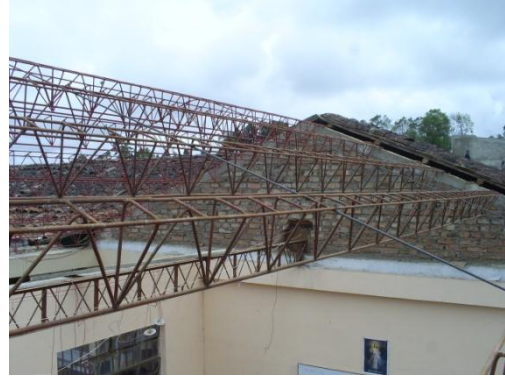
Fig. 20. Estado de las correas en celosía.
