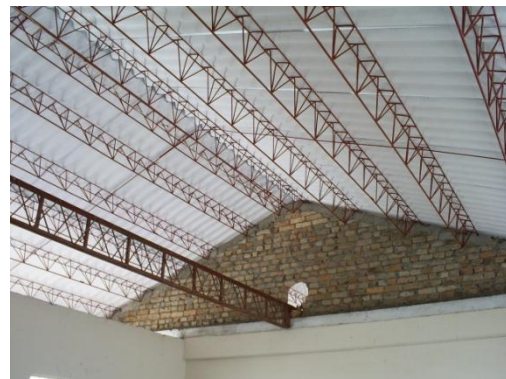
Fig. 24. Aspecto actual de un aula al concluir allí el trabajo.
