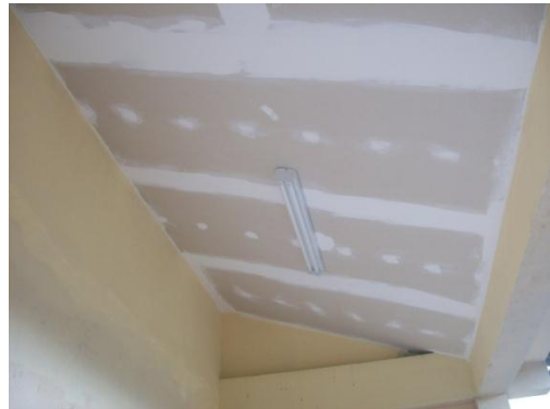
Fig. 16. Cielo raso en panel yeso y nuevas culatas construidas.
