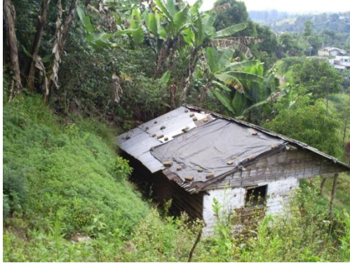
Fig. 1. Vivienda en zona de ladera de alto riesgo.
