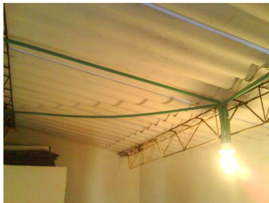
Fig. 51. Cubierta en fibro cemento reemplazada en la cocina.
