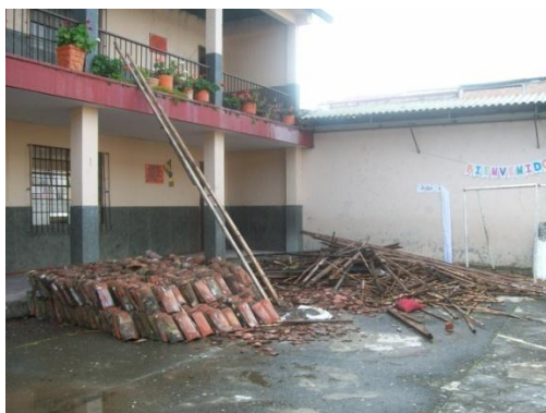
Fig. 13. Remoción de la teja de barro y del cielo raso antiguo en caña brava.
