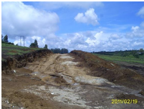
Fig. 54. Excavación resultante de la vía.
