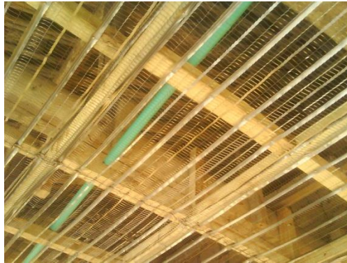
Fig. 32. Detalle del entramado de malla al finalizar su armado.
