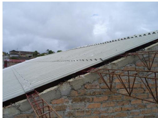
Fig. 22. Avance en la instalación de la cubierta en la primera etapa.
