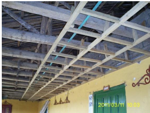
Fig. 30. Nivelación de la estructura de soporte al cielo raso.
