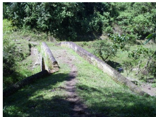
Fig. 63. Aspecto de la carpeta del puente.
