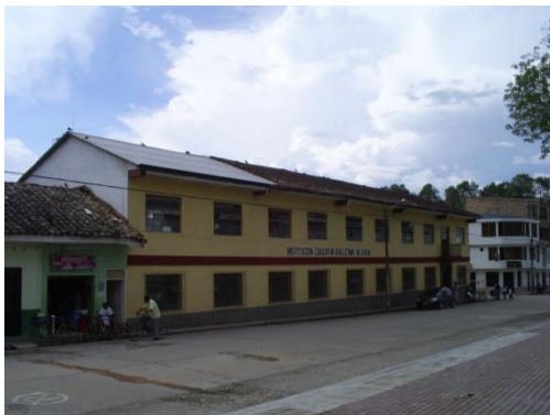
Fig. 17. Fachada de la Institución tras la primera etapa del proyecto.
