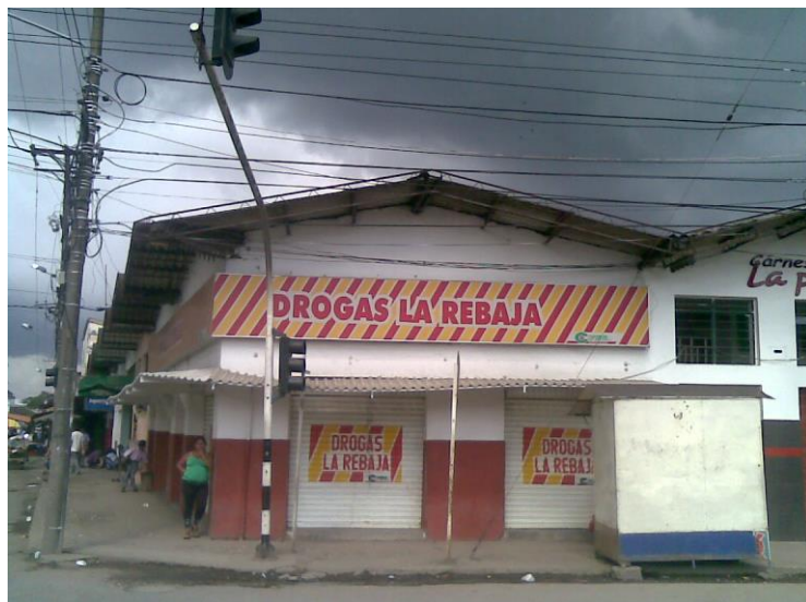
Figura 5 Ejemplo del registro fotografico predios afectados Barrio Bolívar.
