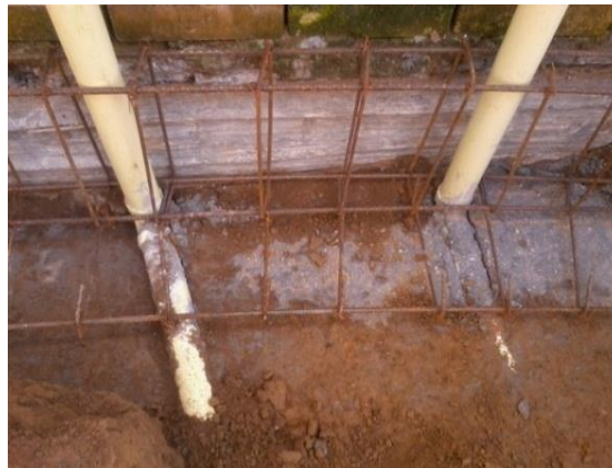
Figura 49. Tubería de desagüe corregida.
