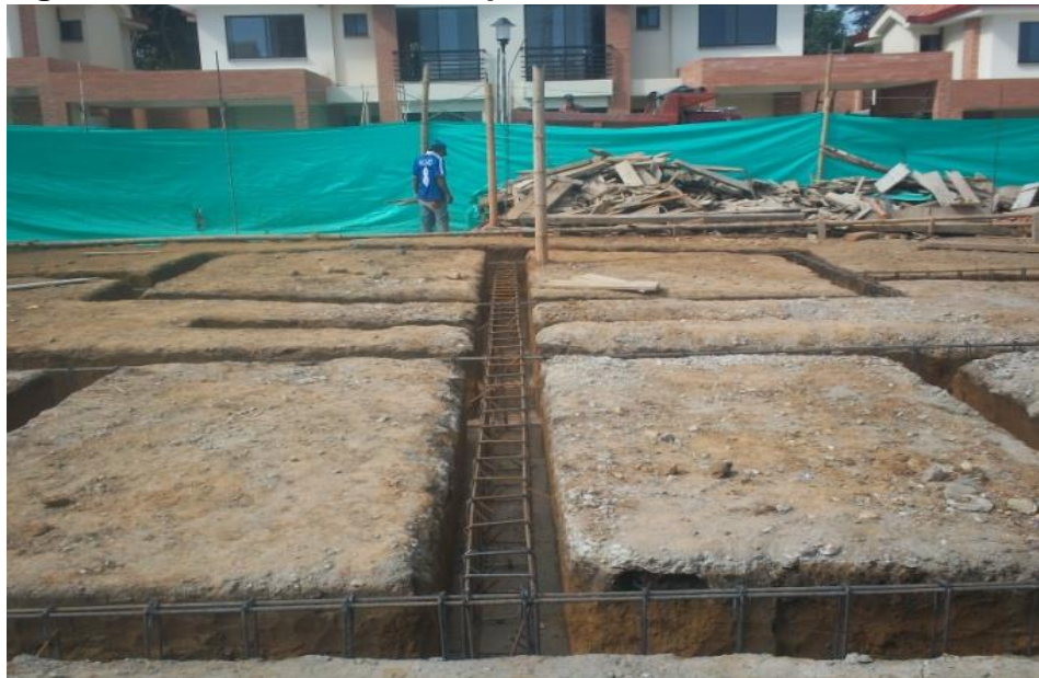
Figura 17. Acero de refuerzo para la cimentación.
