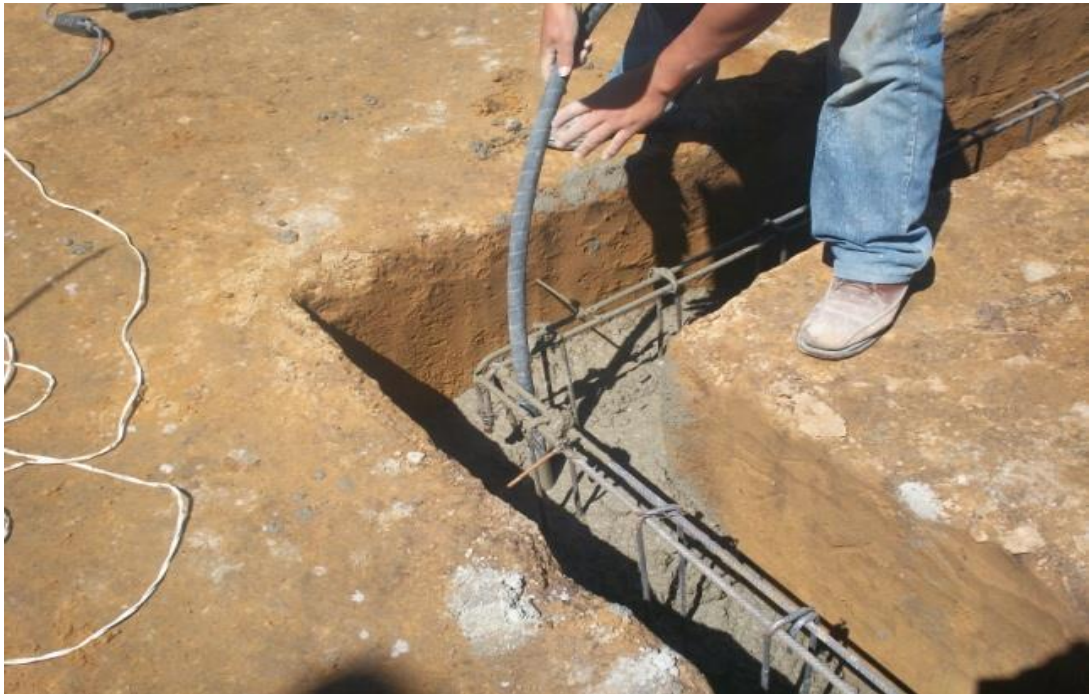
Figura 19. Operario vibrando la cimentación.
