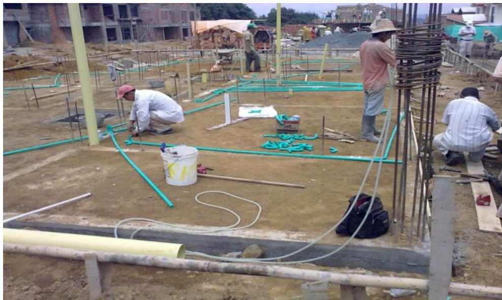
Figura 21. Instalación de la tubería de cableado
