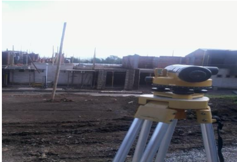
Figura 30. Nivelación de losa de entrepiso casa 60.
