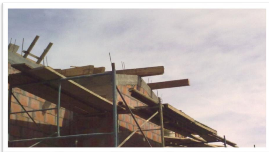
Figura 38. Viga de cubierta con sus respectivos apoyos.
