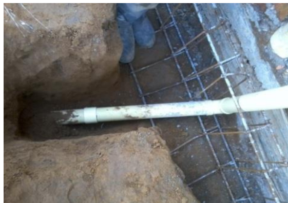
Figura 49. Tubería de desagüe corregida.
