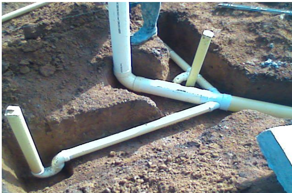
Figura 20. Tubería de desagüe.
