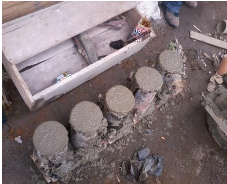
Figura 6. Toma de cilindros al concreto premezclado.
