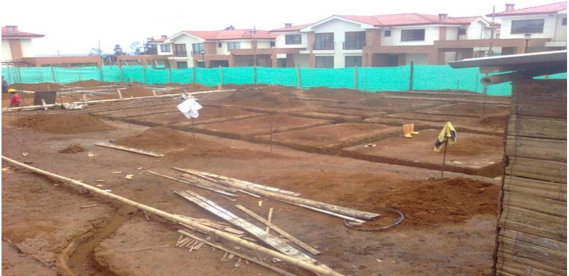
Figura 16. Excavación de un lote
