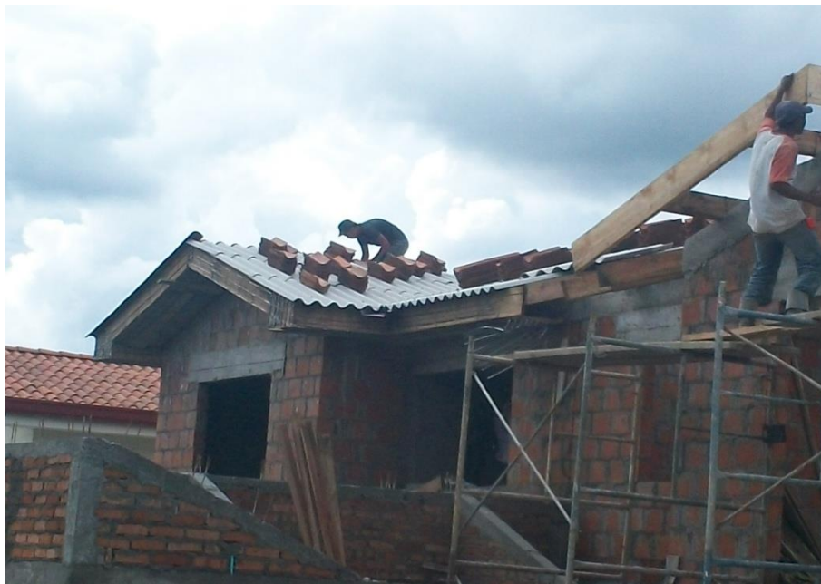
Figura 43. Cubierta en construcción.
