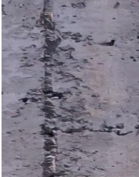
Figura 46. Cimiento que requiere mezcla de Mortero.
