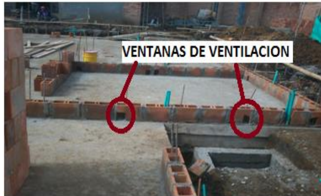
Figura 23. Pega de primera hilera de muro y ventanas de ventilación.
