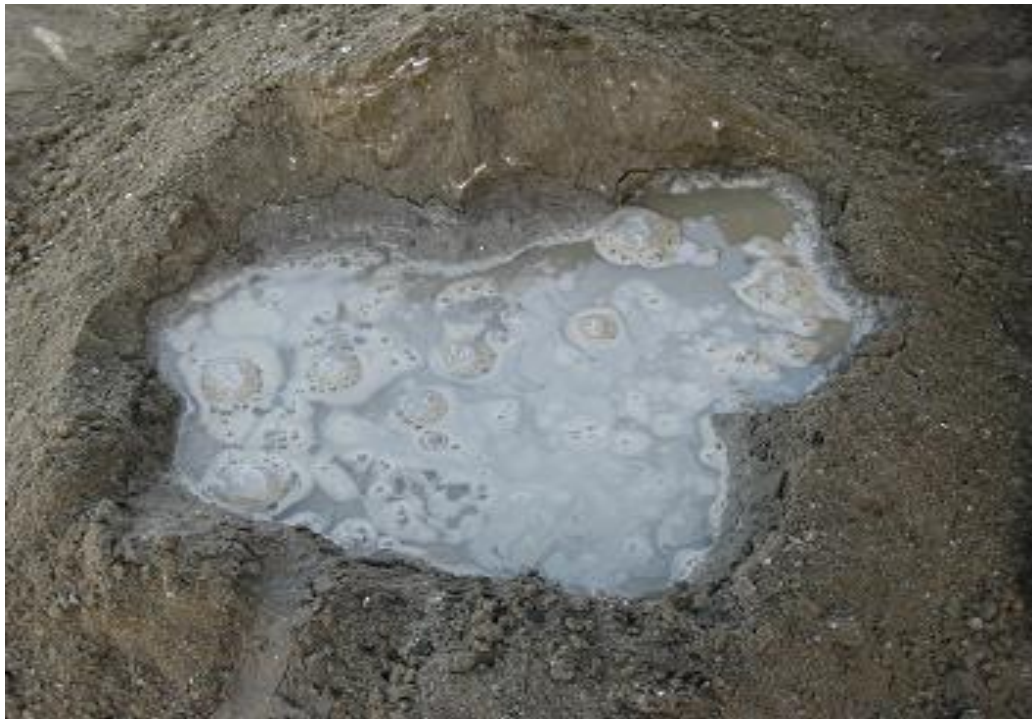
Figura 11. Preparación de mortero de pega.
