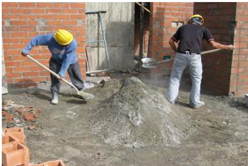
Figura 10. Preparación de mortero de pega.
