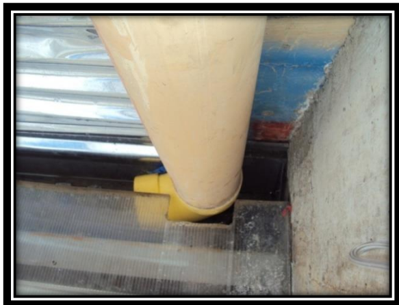
Foto 3. Bajante de aguas lluvias
