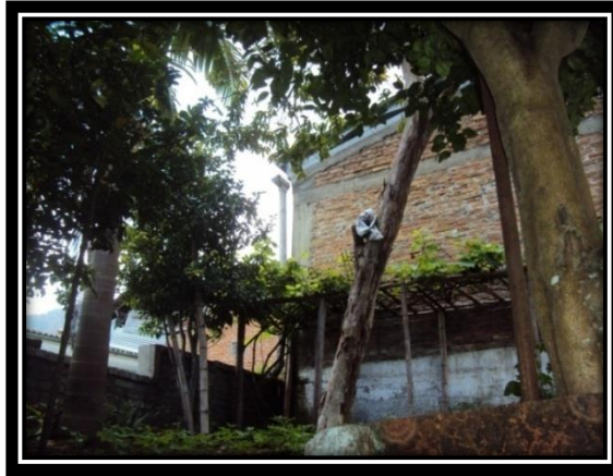
Foto 6. Bajante de aguas lluvias
