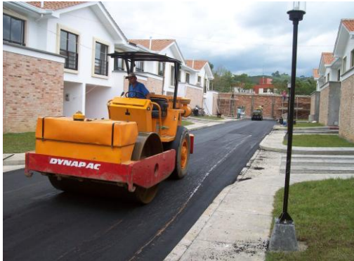
Foto 107 Compactación con rodillo liso
