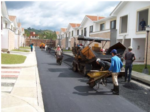
Foto 105 Extendiendo el concreto asfáltico
