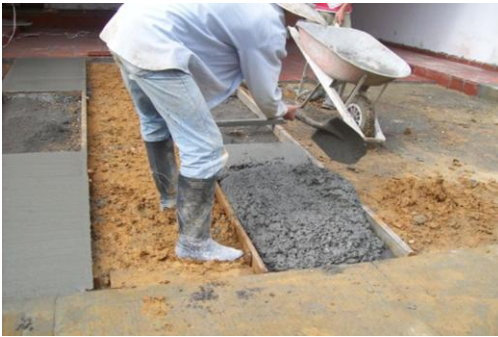
Foto 42 Regar el concreto
