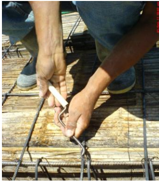
Foto 3 Amarrando toda la estructura de acero
