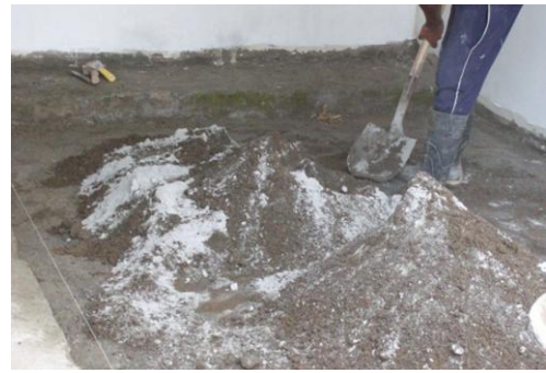
Foto 31 Preparación de la mezcla
