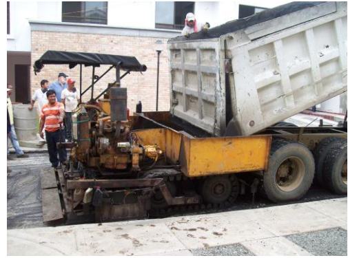
Foto 104 Cargando la Finisher de mezcla
