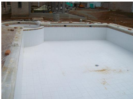
Foto 160 Emboquillado del enchape de piso
