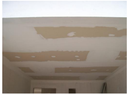
Foto 86 Zona con la aplicación del Mastik
