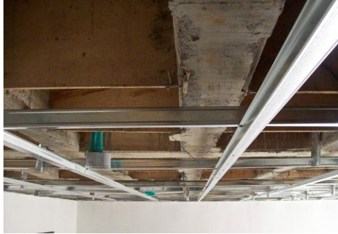
Foto 167 Estructura metálica de soporte para el panel yeso
