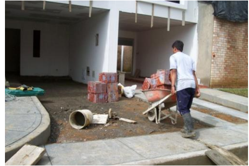
Foto 27 Transporte del material y equipo
