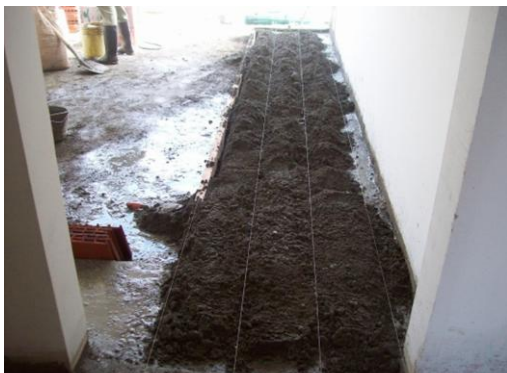
Foto 34 Mortero enrasado ligeramente
