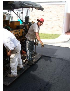
Foto 106 Control de espesor de la capa
