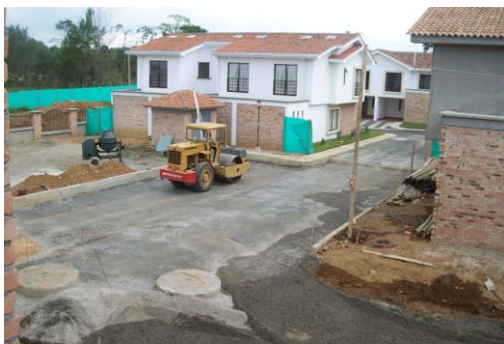
Foto 95 Compactación sub-base en parqueadero
