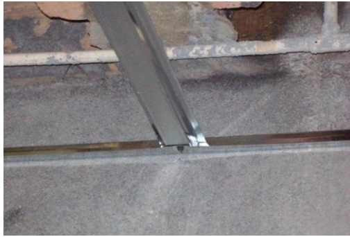
Foto 77 Unión entre la omega y el ángulo fijado al muro
