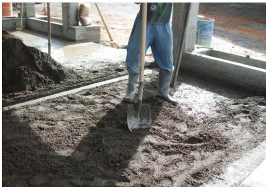
Foto 15 Regando la preparación de mortero
