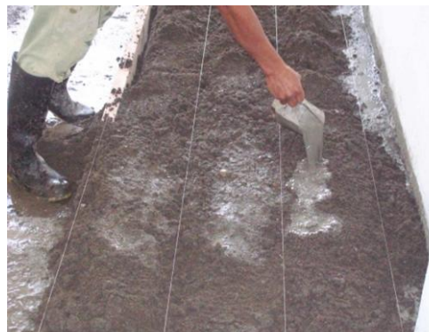
Foto 35 Añadiendo pasta agua-cemento
