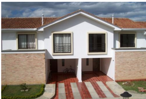
Foto 1 Vista de casas terminadas I etapa
