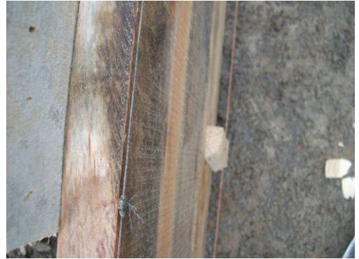
Foto 114 Fundición del sardinel
