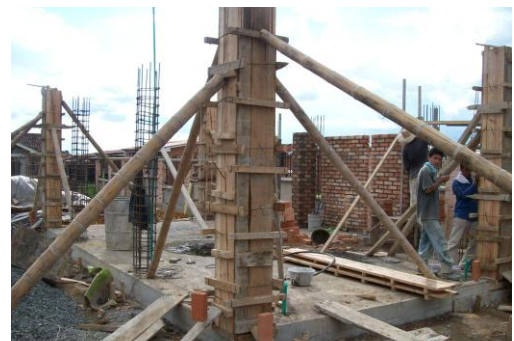
Foto 128 Elevando muros y elaboración formaletas
