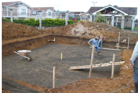
Foto 141 Construcción del solado
