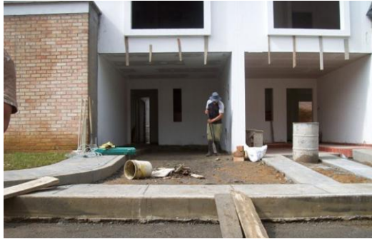
Foto 26 Limpieza de la superficie
