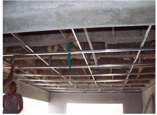
Foto 76 Estructura metálica instalada
