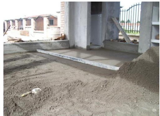
Foto 16 Nivelación con el codal entre franjas
