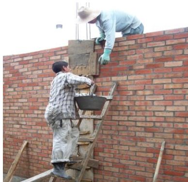
Foto 163 Fundición de las columnas
