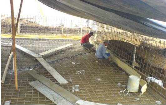
Foto 143 Instalación de la cinta impermeabilizante
