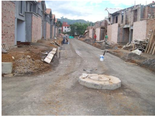
Foto 109 Localización y replanteo del sardinel
