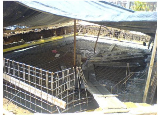
Foto 144 Fundición de la losa
