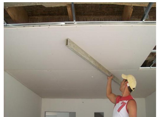
Foto 84 Chequeo de la instalación
