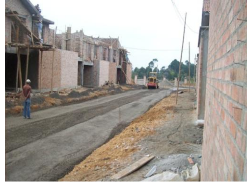
Foto 92 Compactación de la sub-base
