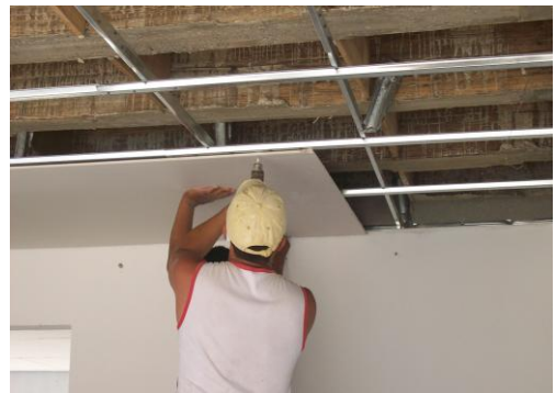
Foto 82 Ajuste con los tornillos
