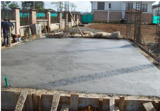
Foto 127 Fundición piso primario
