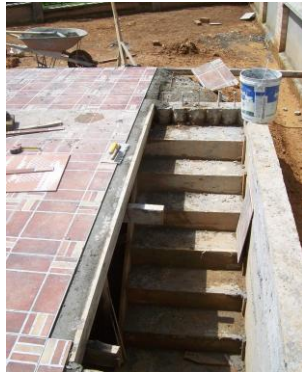
Foto 155 Gradas para acceder a la planta
