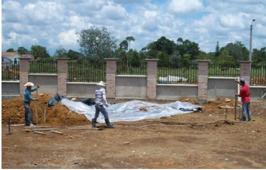
Foto 124 Localización y replanteo de salón común
