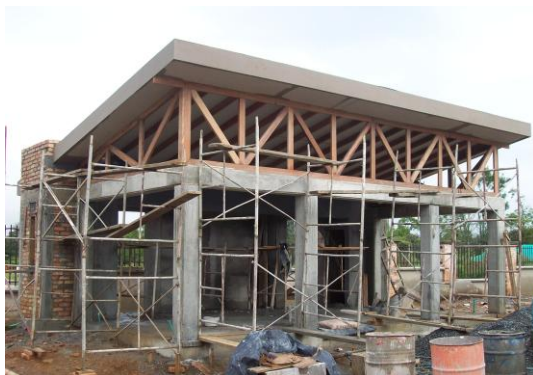
Foto 133 Instalación de la cubierta
