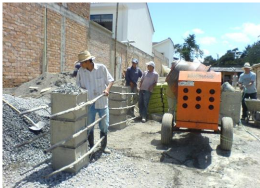
Foto 5 Control en la dosificación
