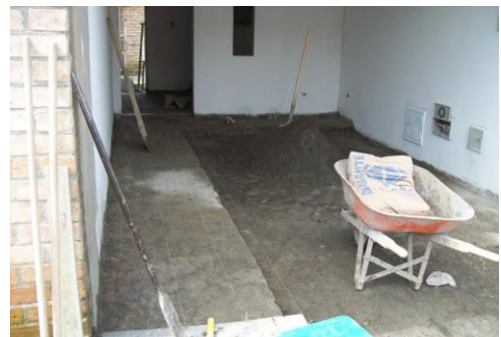
Foto 29 Colocación de los hilos
