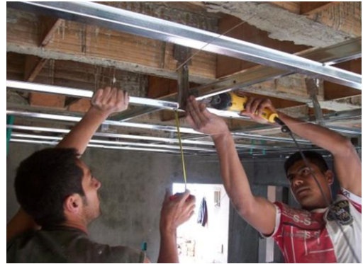
Foto 168 Ajuste y verificación de las omegas
