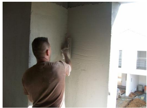
Foto 65 Aplicación del estuco en las esquinas
