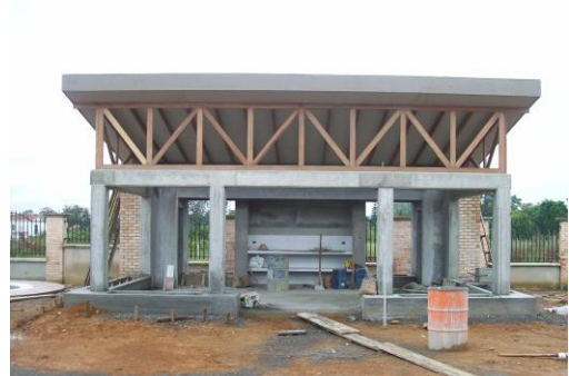
Foto 136 Desencofrado materas y enchapes en baños y cocina
