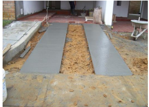
Foto 47 Fraguado del concreto
