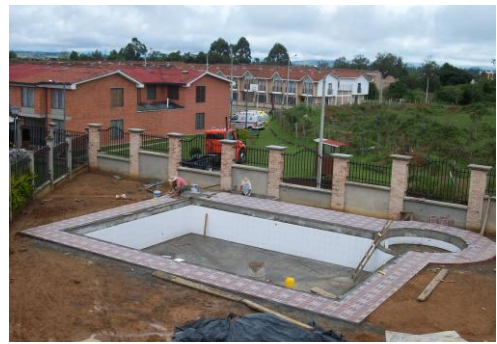
Foto 152 Instalación enchape en zona circulación
