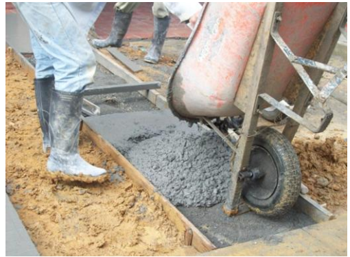
Foto 41 Vaciado del concreto
