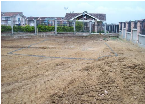
Foto 140 Localización y replanteo de la piscina
