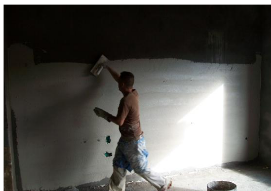
Foto 66 Aplicación de forma horizontal
