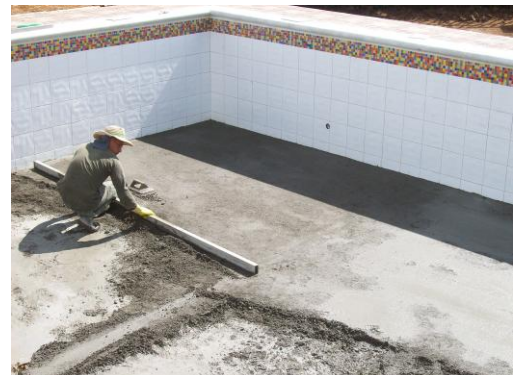
Foto 158 Mortero de nivelación del piso
