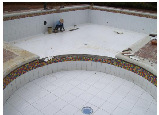
Foto 159 Limpieza del enchape
