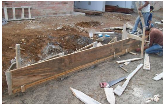
Foto 113 Formaleta con las dos caras y relleno de soporte
