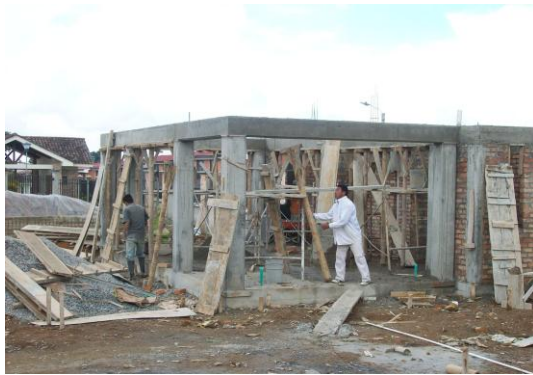
Foto 131 Desencofrado de vigas
