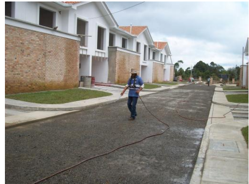
Foto 100 Humedeciendo la zona a compactar
