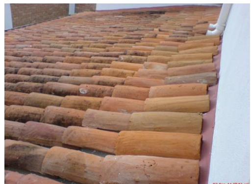
Foto 182 Cubierta en teja de barro
