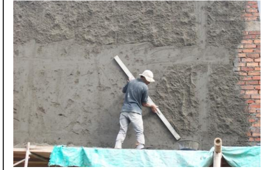
Foto 53 Pasando el codal nivelando entre las franjas
