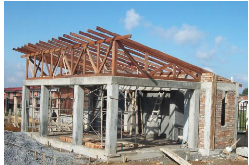
Foto 132 Estructura en madera para la cubierta
