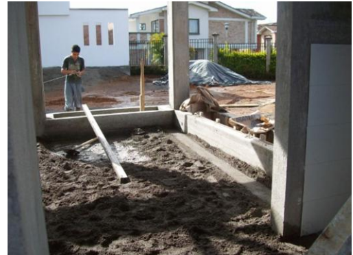
Foto 16 Nivelación con el codal entre franjas
