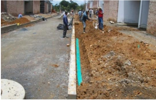
Foto 119 Instalación de redes eléctricas subterráneas
