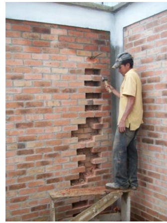
Foto 171 Romper ladrillos por donde se presenta la fisura
