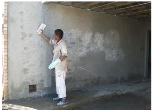
Foto 69 Limpieza de la superficie
