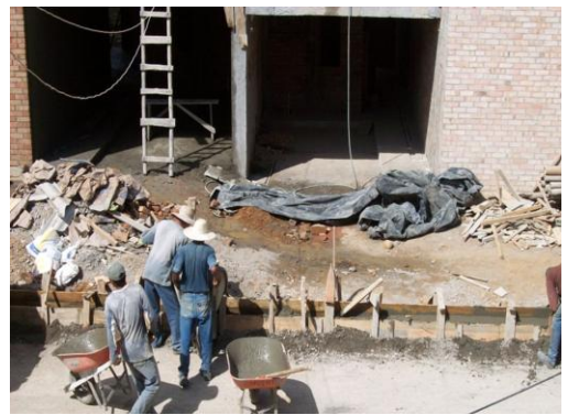
Foto 114 Fundición del sardinel
