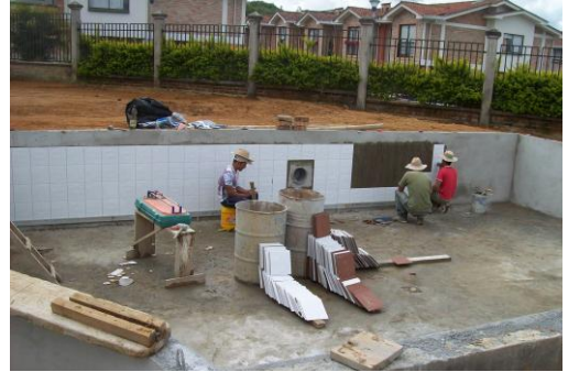
Foto 150 Instalación del enchape en los muros
