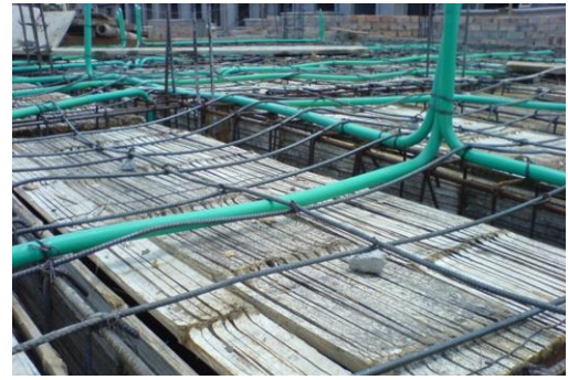
Foto 8 Instalaciones eléctricas fundidas dentro de la losa
