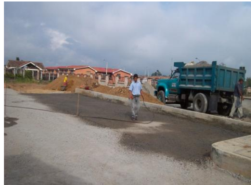
Foto 94 Humedeciendo la zona a compactar
