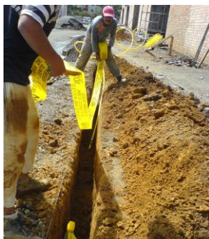
Foto 121 Instalación cinta de seguridad para red de gas
