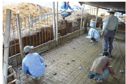
Foto 142 Armado de aceros para muros y losa
