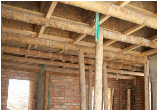
Foto 9 Apuntalamiento de la formaleta
