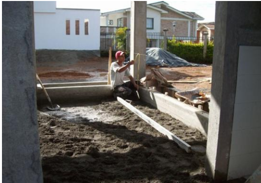
Foto 15 Regando la preparación de mortero
