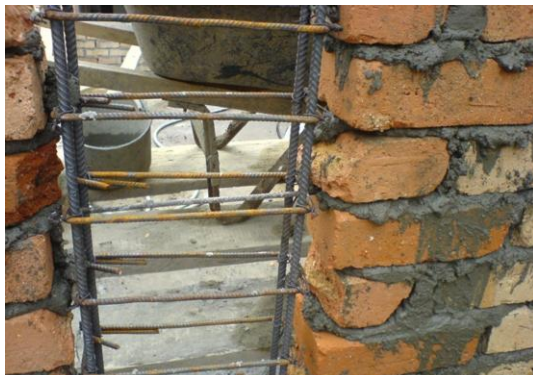
Foto 161 Estribos de la columneta
