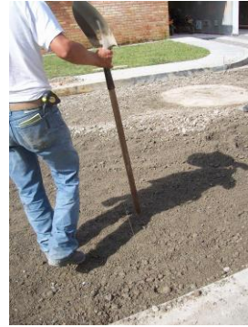
Foto 98 Método para controlar la altura enrase
