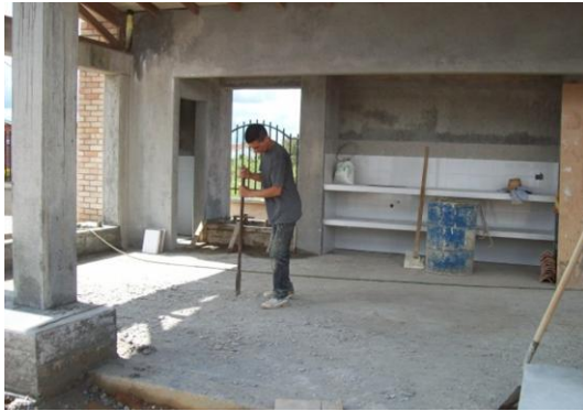
Foto 13 Nivelando puntos fijos
