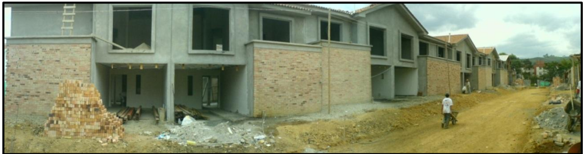
Ilustración 4: Vista general previa, al inicio de la pasantía
