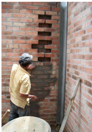
Foto 173 Reemplazar los ladrillos y pegar con mortero
