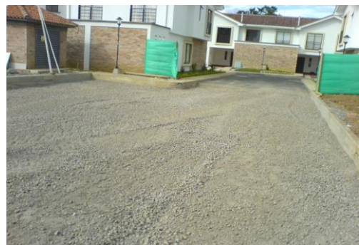
Foto 96 Compactación finalizada parqueadero
