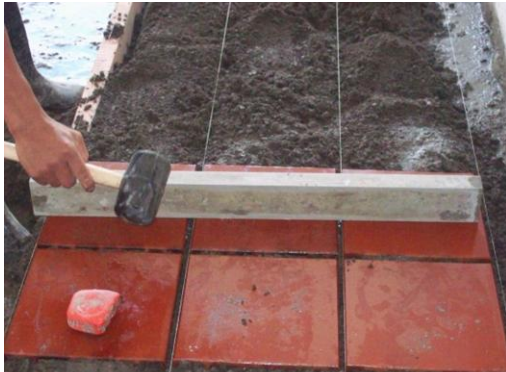
Foto 38 Nivelación con codal
