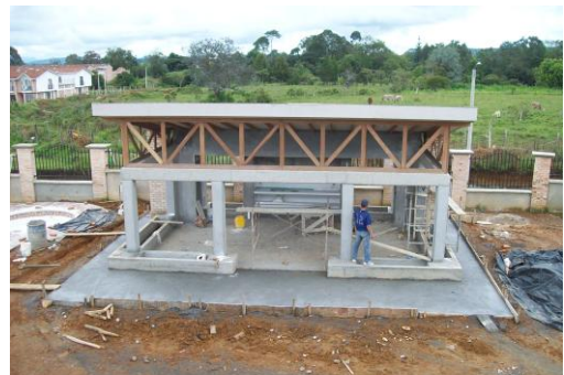
Foto 138 Construcción de la zona de circulación
