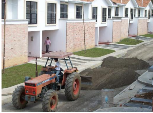
Foto 97 Regando el material de base
