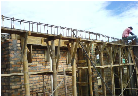
Foto 129 Instalación viga aérea
