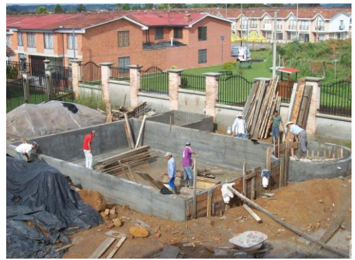
Foto 148 Desencofrado de los muros
