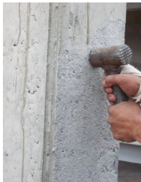
Foto 137 Abusardado de columnas y vigas
