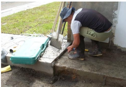
Foto 28 Replanteo y nivelación para el mortero
