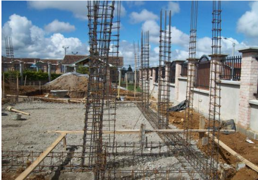
Foto 125 Instalación de castillos de acero
