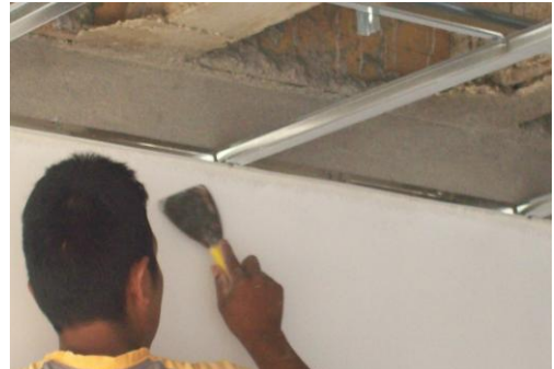
Foto 80 Limpieza de la zona donde se ubica el panel
