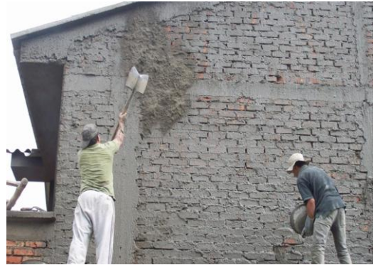
Foto 49 Lanzando del mortero
