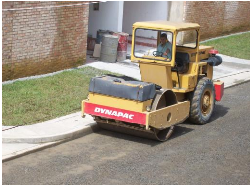
Foto 101 Compactación de la base
