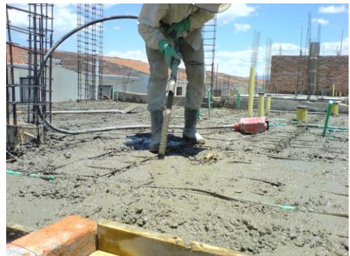
Foto 6 Vibrado del concreto
