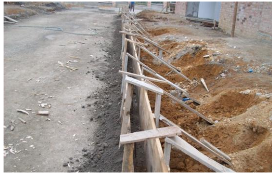
Foto 113 Formaleta con las dos caras y relleno de soporte
