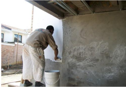
Foto 70 Aplicación del estuco Plástico
