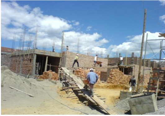
Foto 7 Rampa para vaciar el concreto
