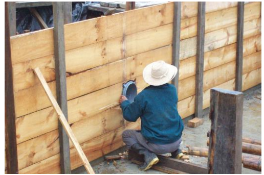
Foto 145 Instalación de artefactos de la piscina
