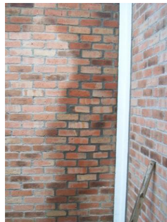
Foto 174 Muro limpio y reparado
