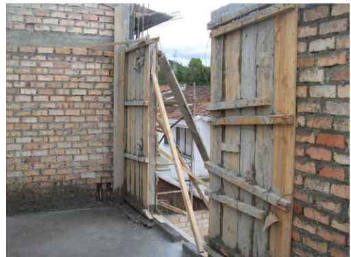
Foto 162 Pantallas en concreto
