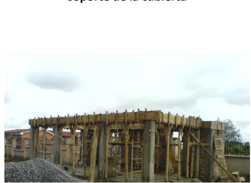
Foto 130 Formaletas para las vigas de soporte de la cubierta
