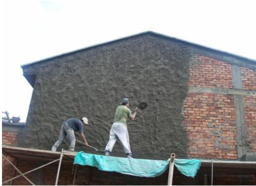
Foto 50 Cargando el muro con el mortero
