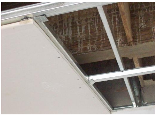
Foto 83 Platinas que sirven de amarre
