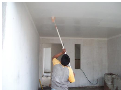
Foto 88 Aplicación de pintura al cielo raso
