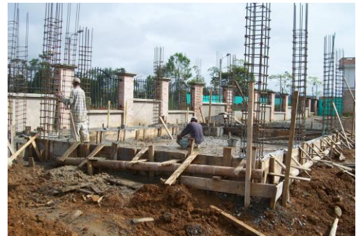
Foto 126 Fundición de las vigas de cimentación
