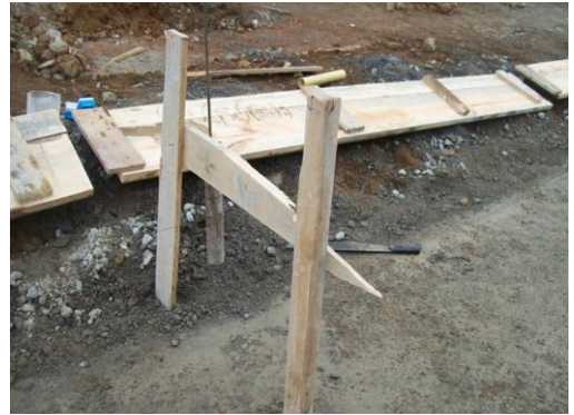
Foto 110 Puente para trazar hilos guías
