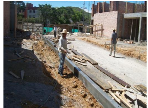
Foto 118 Curado del concreto
