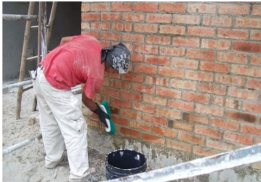
Foto 58 Limpieza con ácido diluido con agua
