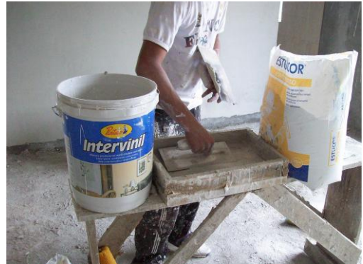
Foto 63 Estuco preparado en batea
