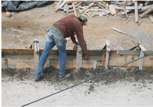
Foto 115 Afinado del concreto
