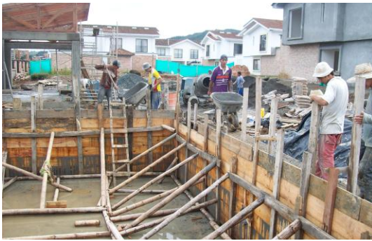
Foto 147 Fundición de los muros y losa piscina niños
