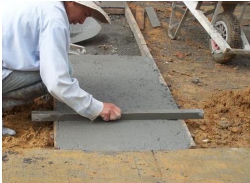
Foto 46 Enrasando con el codal
