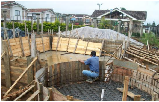
Foto 146 Formaletas muros y aceros piscina pequeña
