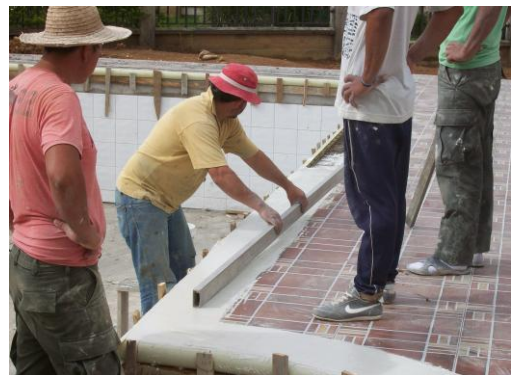
Foto 154 Aplicación de granito en rompe olas
