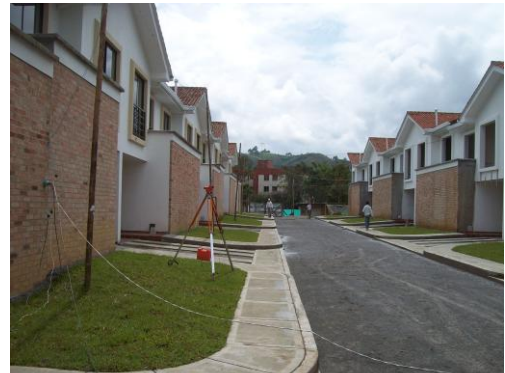
Foto 102 Control de nivelación de la vía
