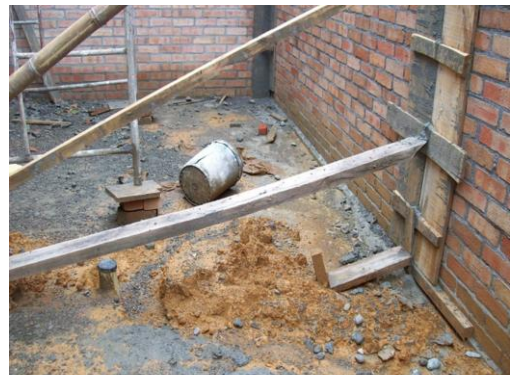
Foto 164 Apuntalamientos de columnas
