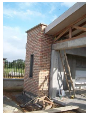
Foto 134 Muros en ladrillo a la vista
