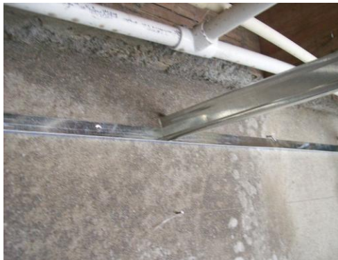
Foto 169 Hilos de chequeo entre muros
