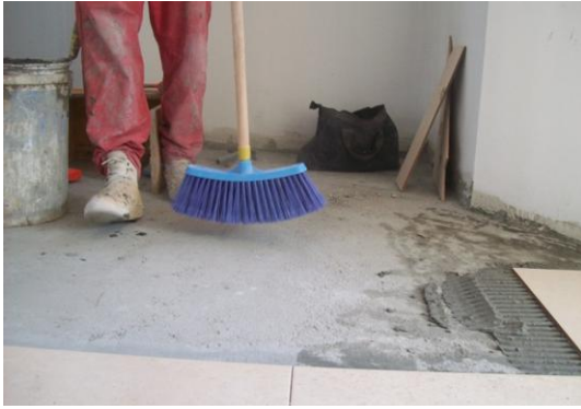
Foto 17 Limpieza de la superficie
