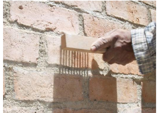
Foto 57 Cepillado de cada ladrillo
