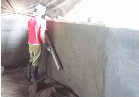
Foto 149 Mortero de nivelación para el muro
