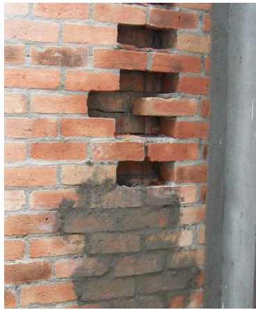
Foto 172 Zona del muro en reparación
