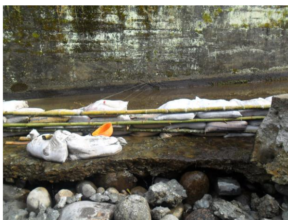
Foto 28. Socavación presentada
