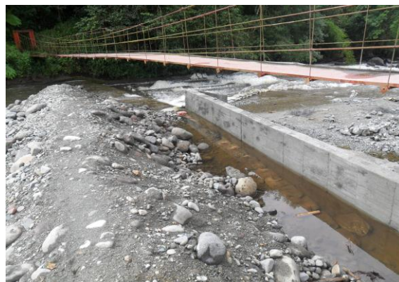
Foto 26. Muro de seguridad en ciclópeo
