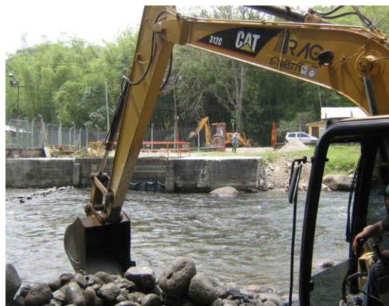
Foto 48. Vista general de la limpieza de bocatoma.
