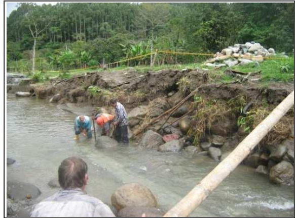
Foto 14. Vista de la viga de protección.
