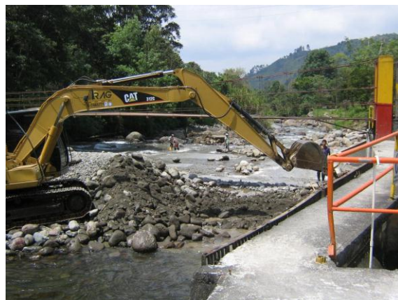
Foto 46. Demolición del muro en ciclópeo.
