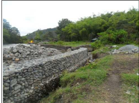
Foto 2. Hileras de gaviones margen derecha.
