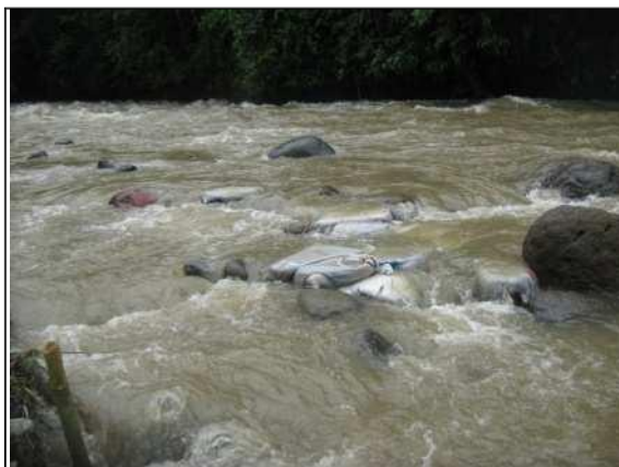
Foto 7. Rotura del jarillón por el río.
