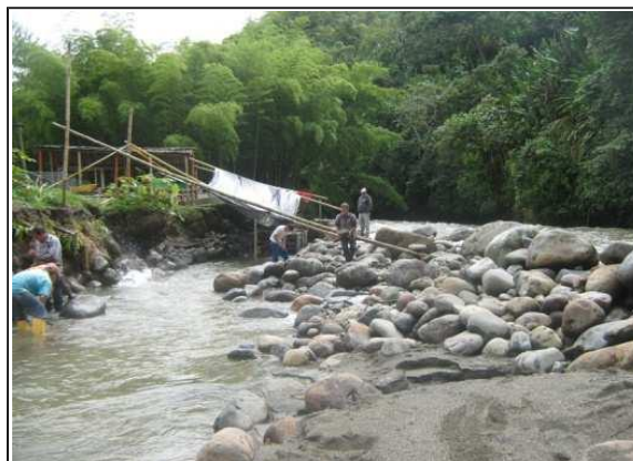
Foto 17. Proceso de recuperación del jarillón.
