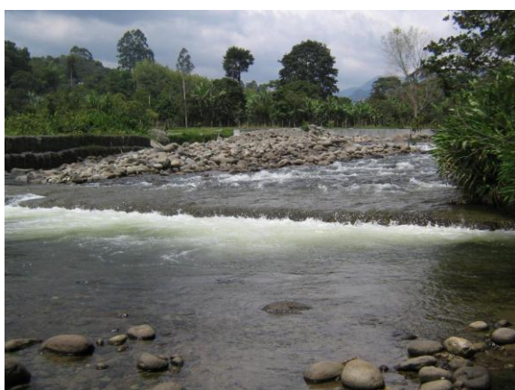
Foto 47. Disposición del material sobrante de gaviones
