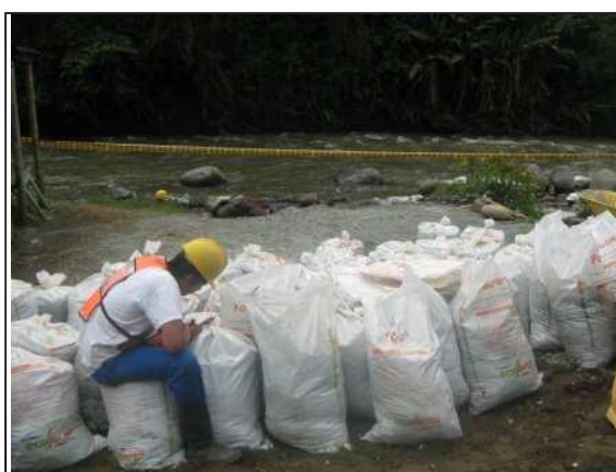
Foto 12. Costales para sellar averías en jarillón.
