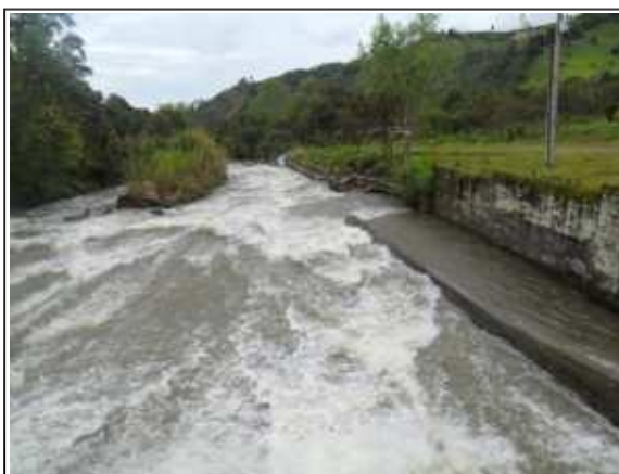
Foto 22. Vista de la losa de fondo a intervenir.
