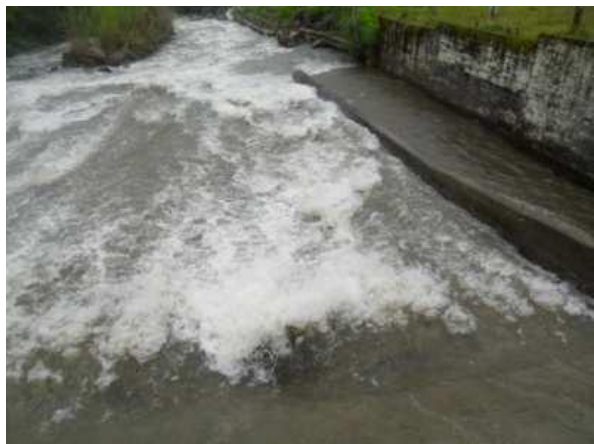
Foto 23. Sitio a intervenir para reparación de losa
