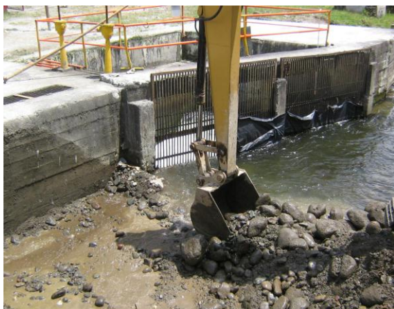
Foto 47. Limpieza de material de arrastre.
