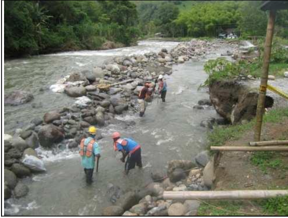
Foto 13. Zona afectada por la crecida del río.
