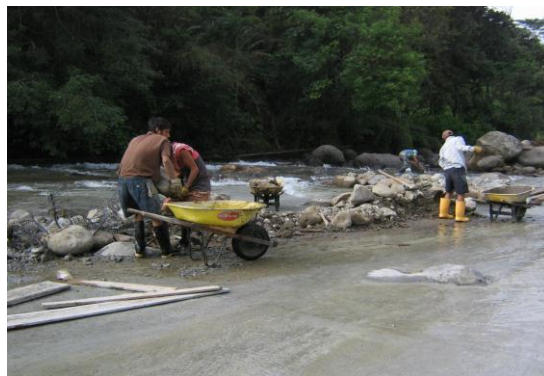
Foto 32. Fundición de losa
