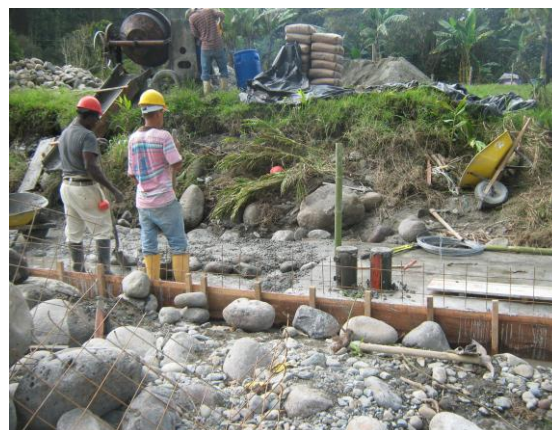
Foto 46. Preparación de mezcla y toma de muestra.
