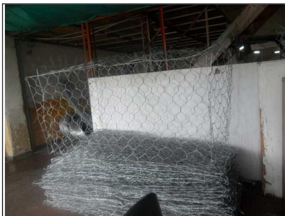
Foto 43. Acopio y elaboración de mallas para gavión.
