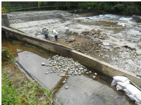
Foto. 29 Demolición de la losa
