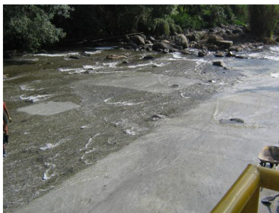
Foto 48. Vista general de la limpieza de bocatoma.
