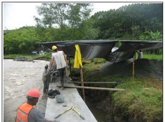
Foto 6. Recubrimiento de gaviones.
