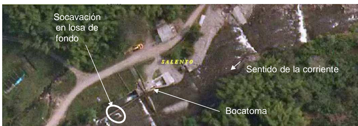
Figura 4. Detalle aérea de la zona de la bocatoma.
