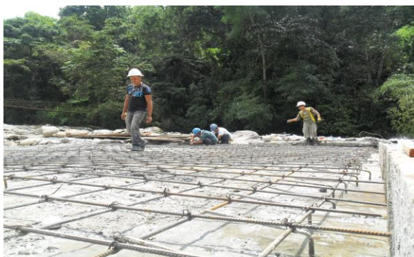
Foto 31. Armado de acero
