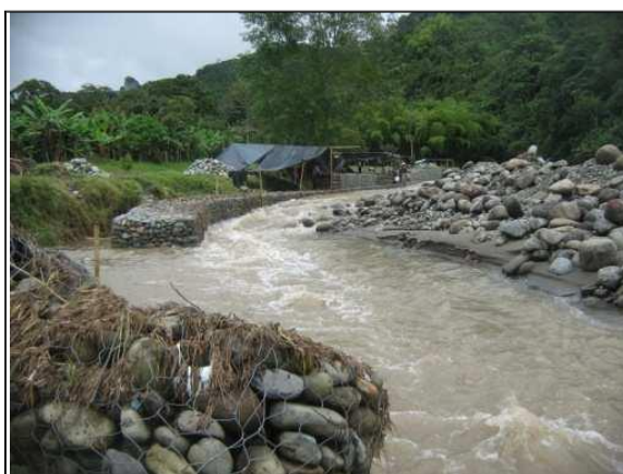
Foto 9. Vista frontal de gaviones construidos.
