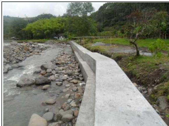
Foto 19. Terminado de gaviones recubiertos.
