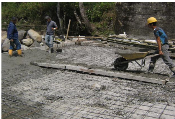
Foto 33. Fundición de losa
