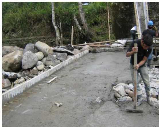
Foto 30. Nivelación en concreto ciclópeo
