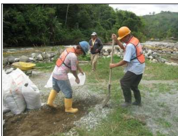
Foto 11. Proceso para obras de contención.
