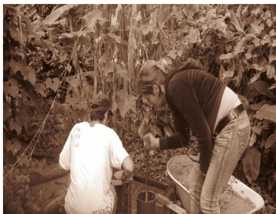
Foto 45. Toma de cilindros de concreto.
