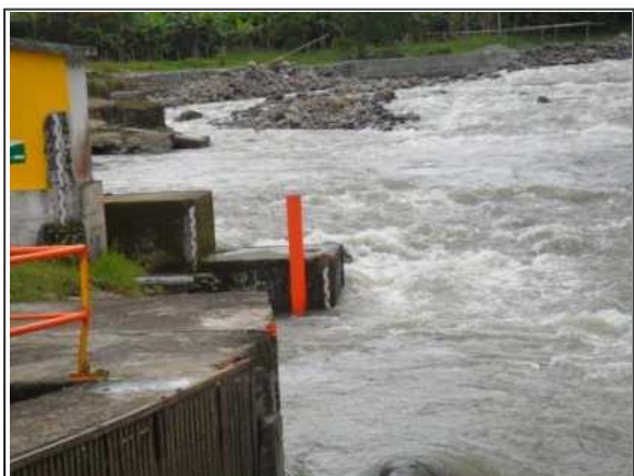
Foto 21. Presencia de fuertes corriente.
