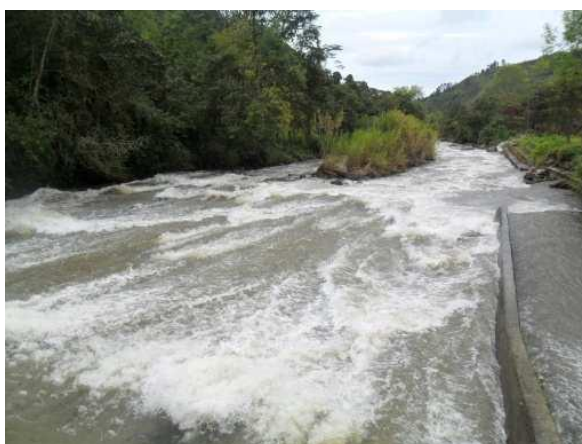
Foto 24. Vista general de la losa de fondo
