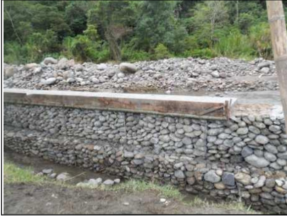
Foto 1. Construcción de gaviones.
