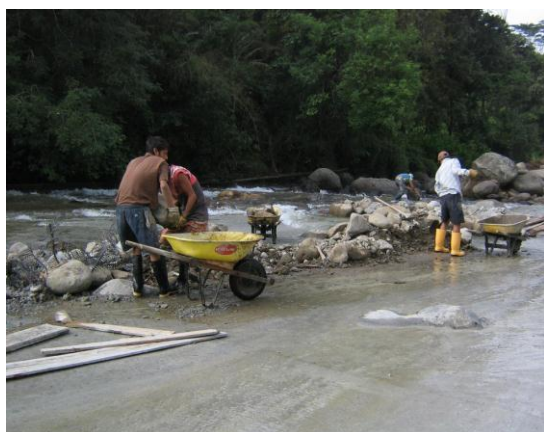
Foto 45. Evacuación de sobrantes de material.
