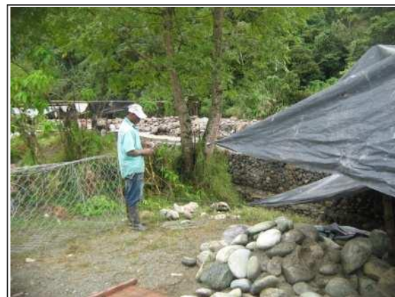
Foto 5. Colocación de carpas en plástico cal 4.
