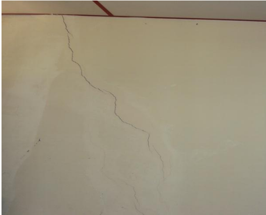
Fig. 15 Foto N° 2 muro localizado entre ejes 7-8
