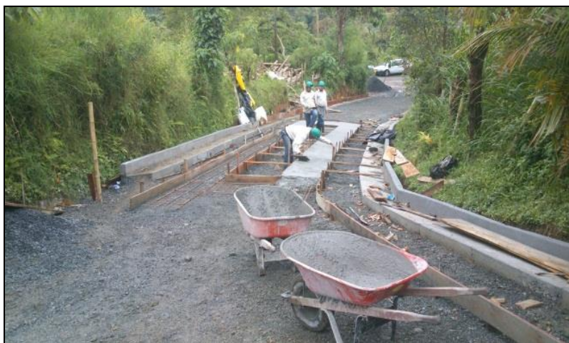
Foto No. 92. Construcción Huellas de Acceso
