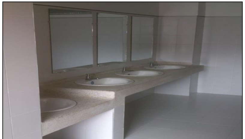
Foto No. 71. Instalación Mesón Granito Pulido Baños
