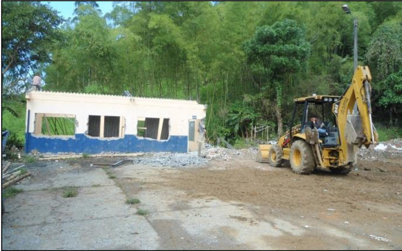
Foto No. 43. Demolición de edificación
