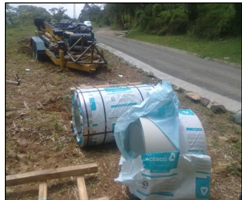
Foto No. 21 Lámina teja de cubierta
