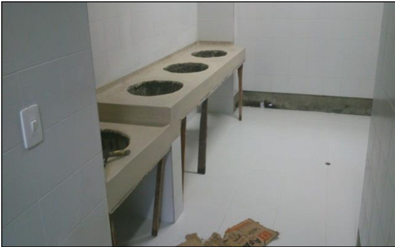
Foto No. 71. Instalación Mesón Granito Pulido Baños
