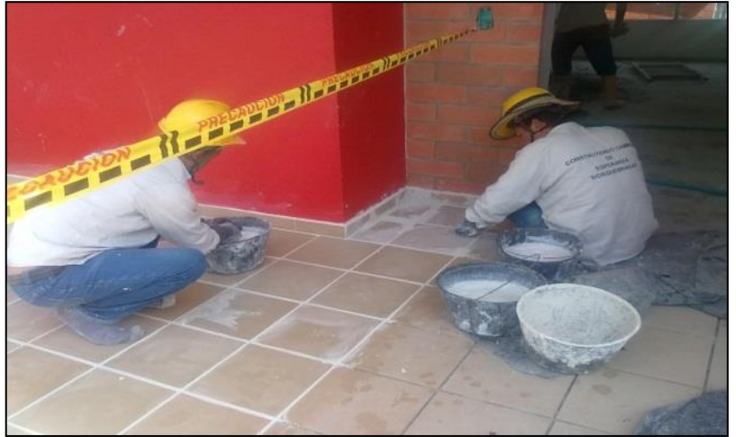
Foto No. 68. Instalación de Piso en Gres
