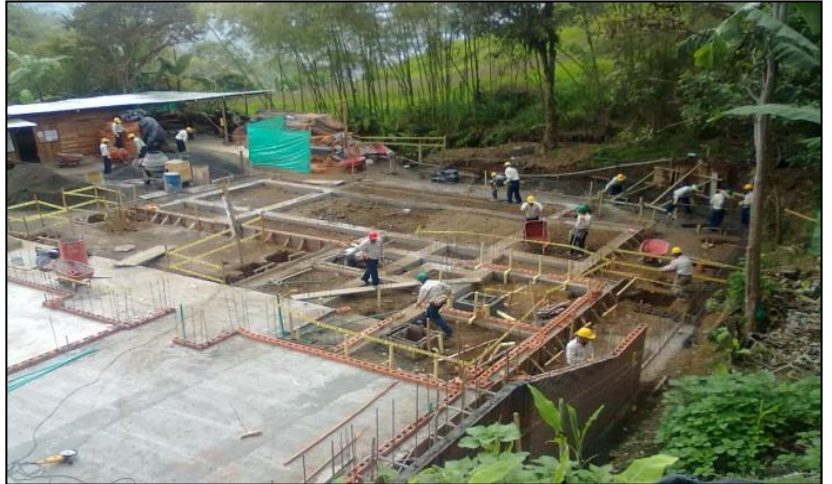
Foto No. 54. Replanteo de Mampostería
