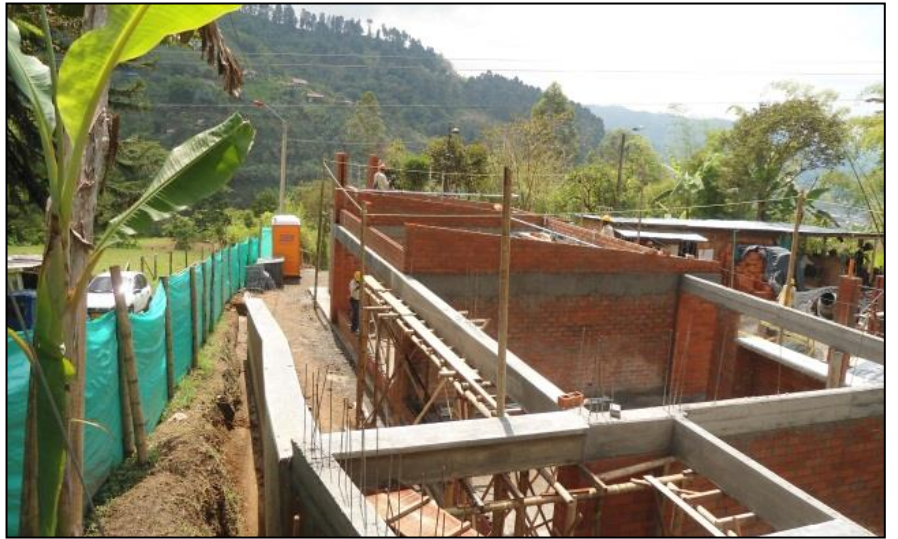
Foto No. 58. Vaciado de Viga de Amarre
