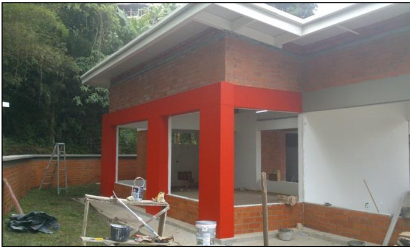
Foto No. 75. Acabados exteriores
