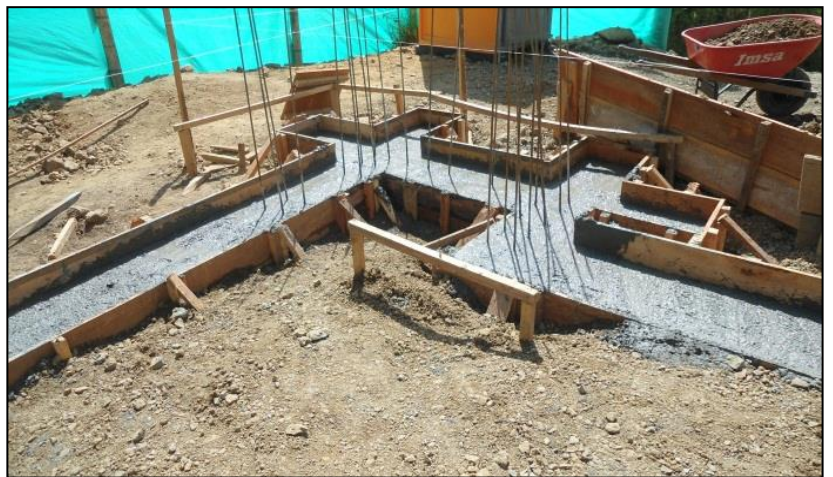
Foto No. 50. Vaciado concreto Vigas de Cimentación
