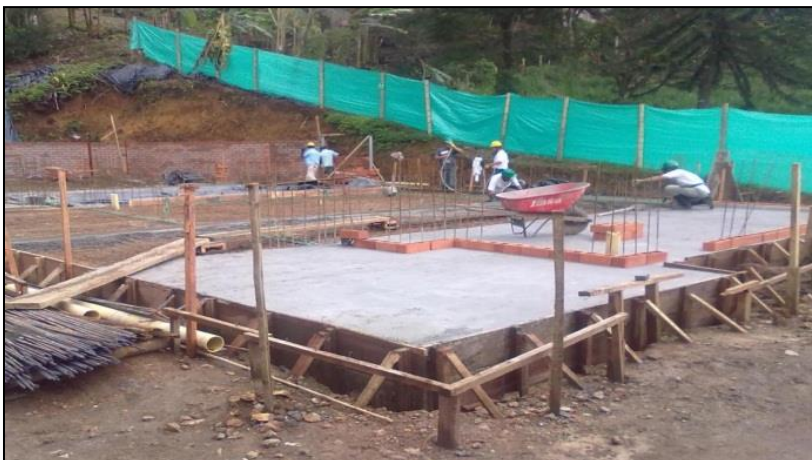
Foto No. 53. Vaciado Placa Contrapiso
