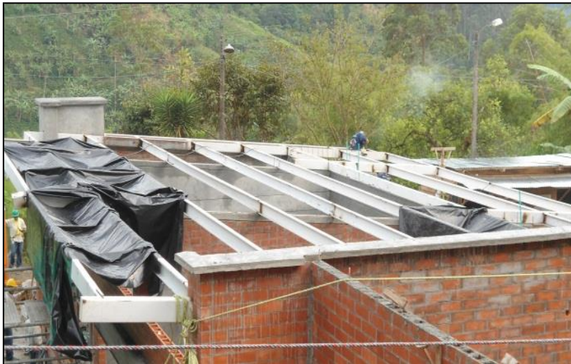
Foto No. 61. Instalación de Estructura Cubierta
