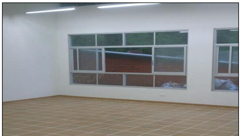
Foto No. 70. Pintura Interior de Muros
