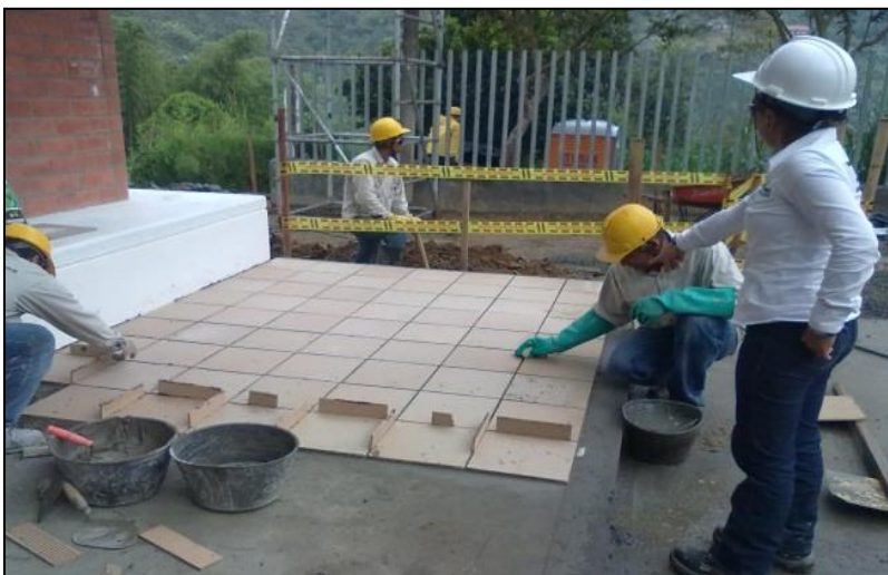
Foto No. 67. Instalación de Piso en Gres
