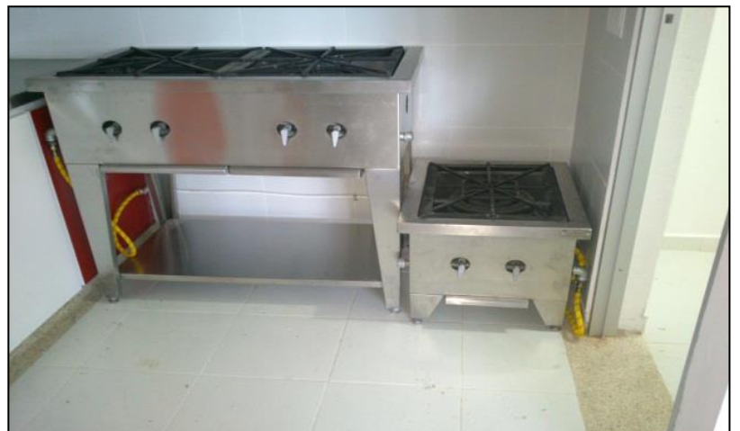
Foto No. 82. Instalación Mobiliario Cocina
