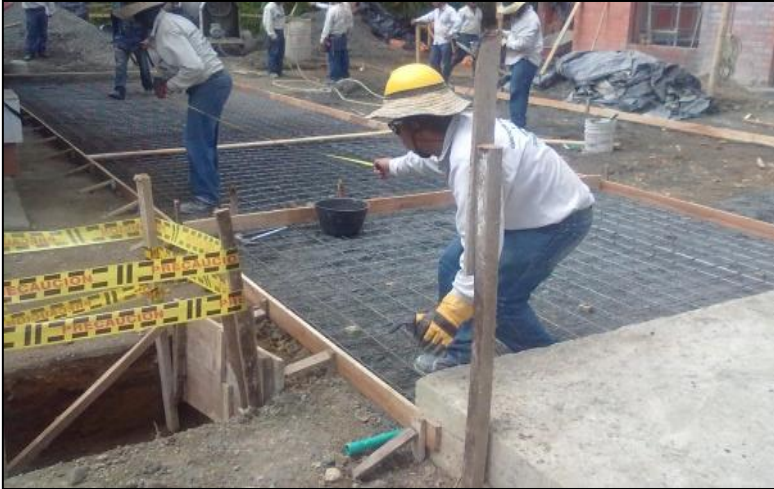
Foto No. 65. Armado de Acero Refuerzo Pavimento
