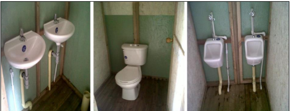
Foto No. 10. Lavamanos, sanitarios y orinales
