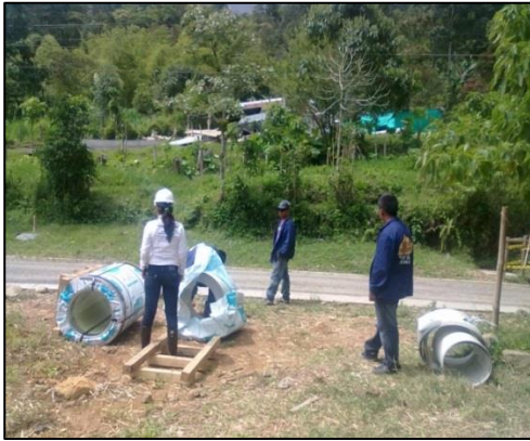
Foto No. 20 Suministro teja de cubierta
