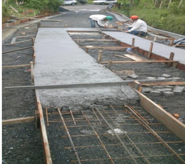
Foto No. 41. Vaciado huellas
