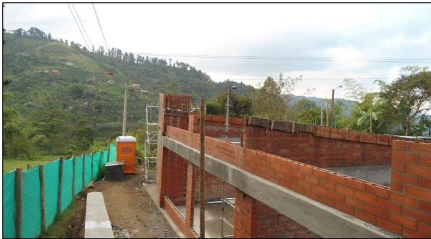
Foto No. 59. Construcción de Culatas de Muros
