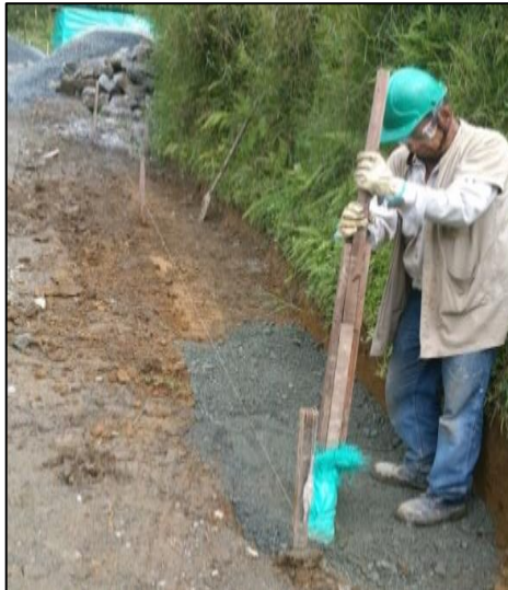
Foto No. 34. Compactación manual material granular
