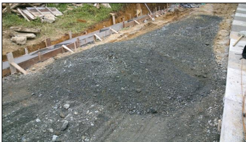
Foto No. 89. Construcción Cuneta Vehicular
