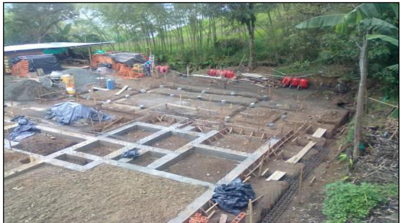
Foto No. 52. Llenos alrededor de la cimentación
