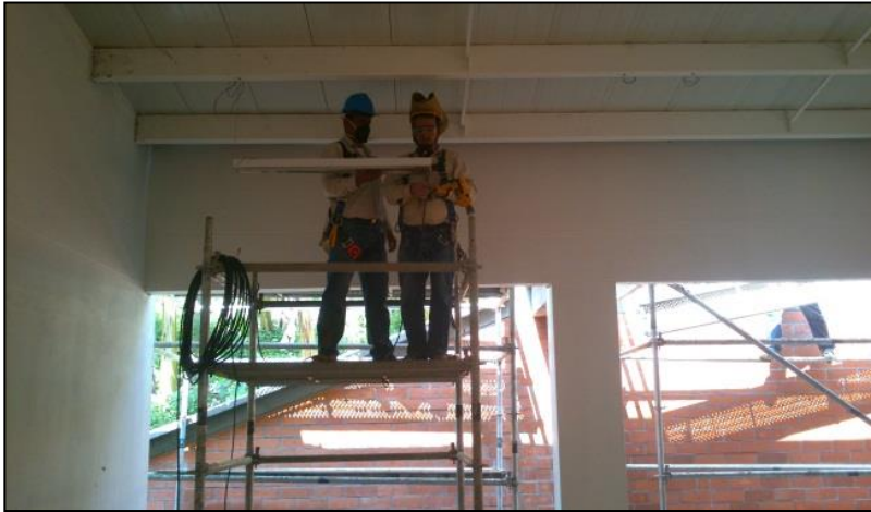
Foto No. 83. Instalación de Lámparas
