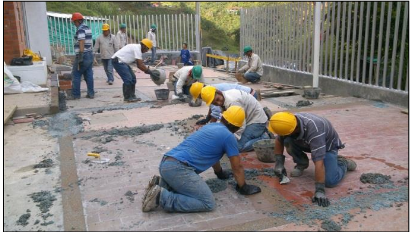
Foto No. 74. Instalación de tableta de Gres
