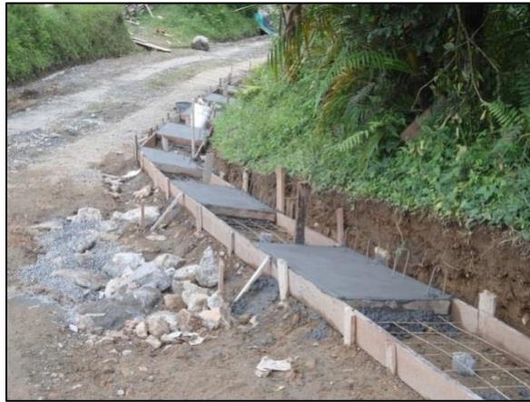
Foto No. 29. Vaciado cuneta
