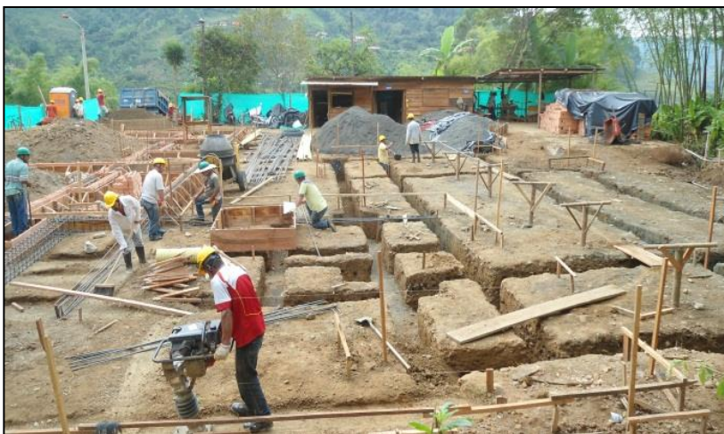
Foto No. 47. Armado de acero de refuerzo cimentación
