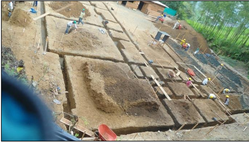
Foto No. 45. Excavación para cimentación
