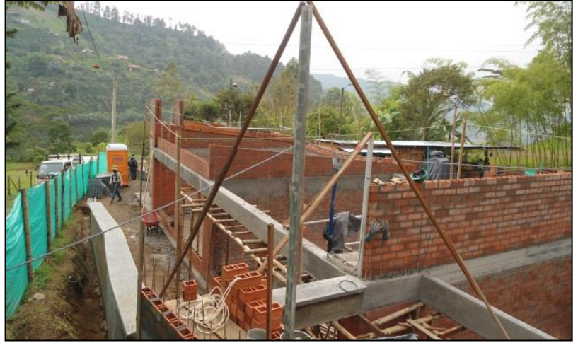
Foto No. 60. Construcción de Culatas de Muros
