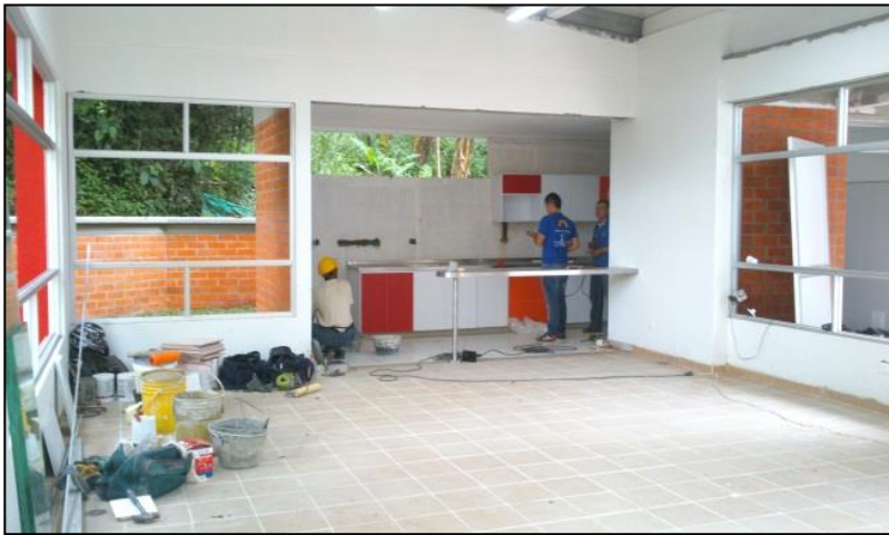
Foto No. 81. Instalación Mobiliario Cocina
