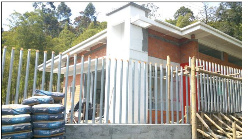
Foto No. 85. Instalación de Cerramiento
