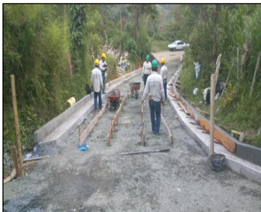
Foto No. 40. Formaleta huellas
