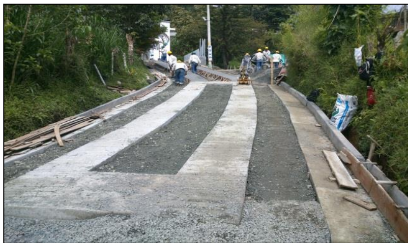
Foto No. 93. Construcción Huellas de Acceso
