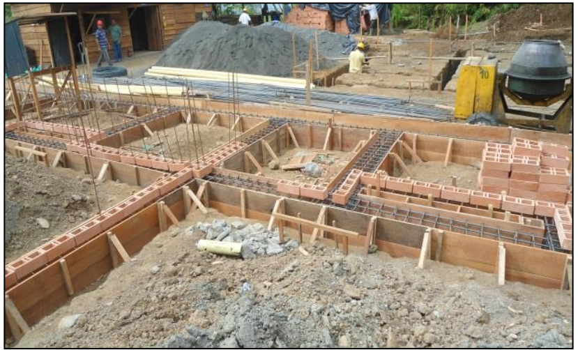
Foto No. 48. Armado de formaleta para cimentación
