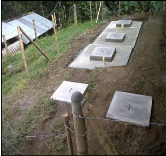
Foto No. 11. Sistema séptico
