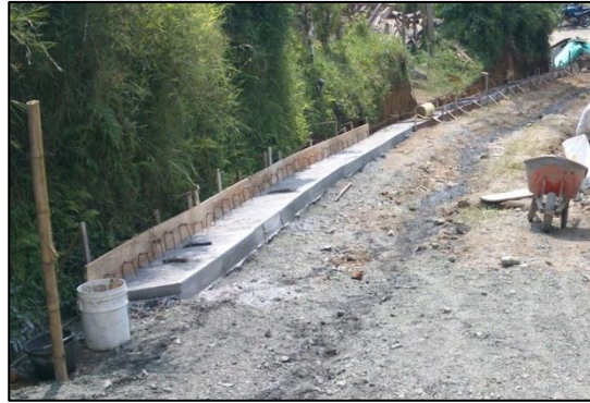
Foto No. 36. Refuerzo y formaleta sardinel
