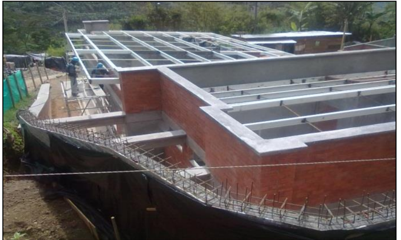
Foto No. 62. Instalación de Estructura Cubierta
