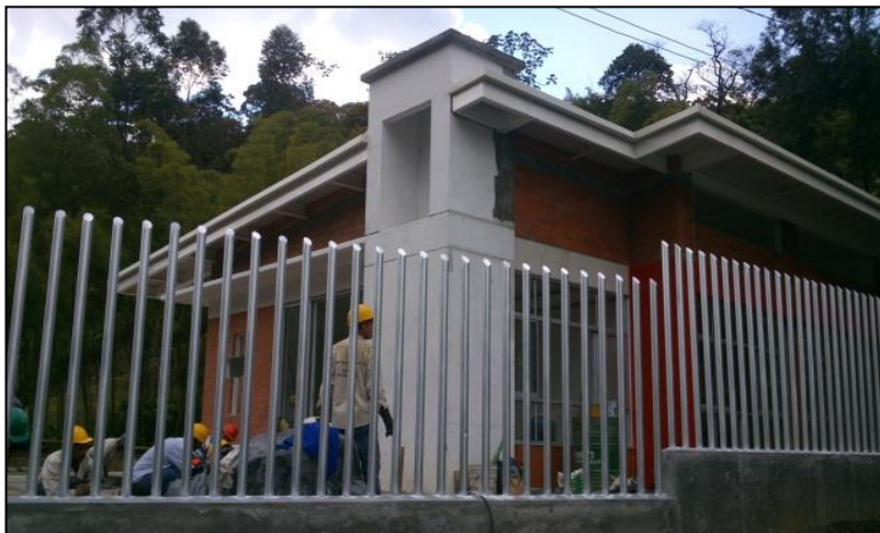
Foto No. 86. Instalación de Cerramiento
