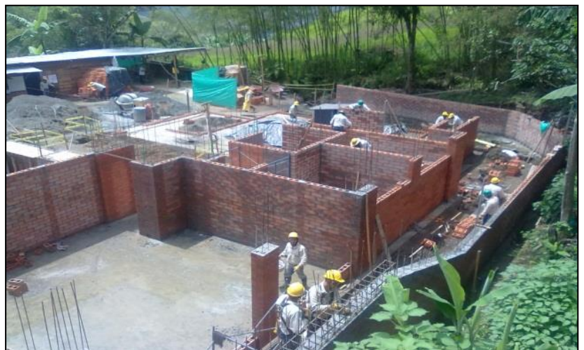
Foto No. 56. Construcción Muro de Contención
