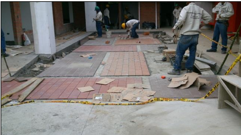
Foto No. 73. Instalación de Tableta de Gres
