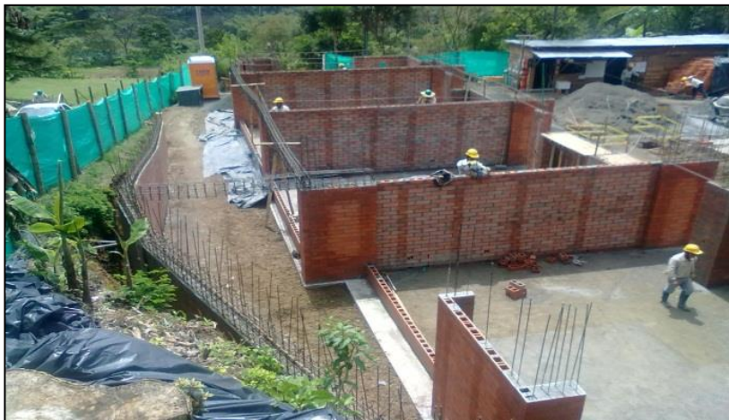
Foto No. 55. Mampostería Edificación
