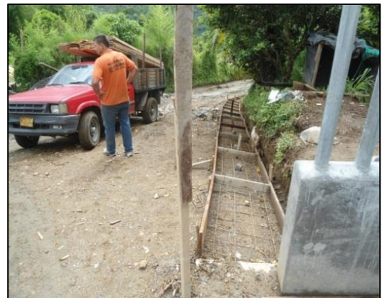
Foto No. 28. Formaleta cuneta
