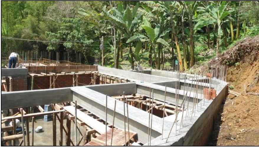
Foto No. 57. Vaciado de Viga de Amarre
