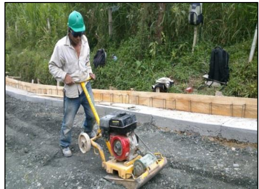
Foto No. 38. Compactación mecánica
