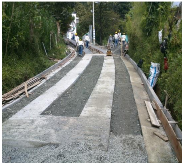
Foto No. 42. Material granular
