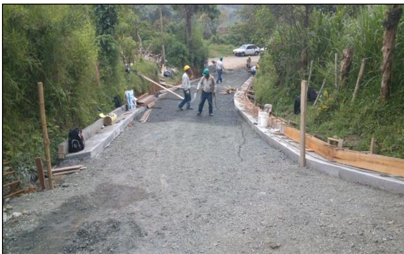
Foto No. 91. Construcción Huellas de Acceso
