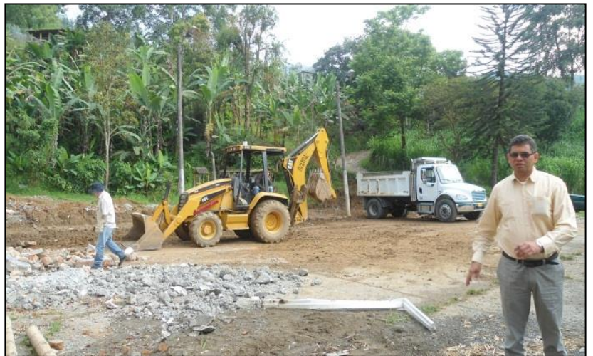
Foto No. 44. Movimiento de tierra
