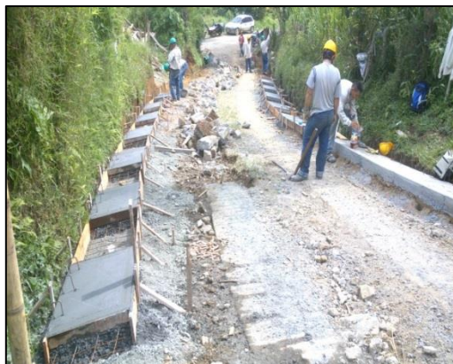
Foto No. 35. Formaleta y vaciado cuneta
