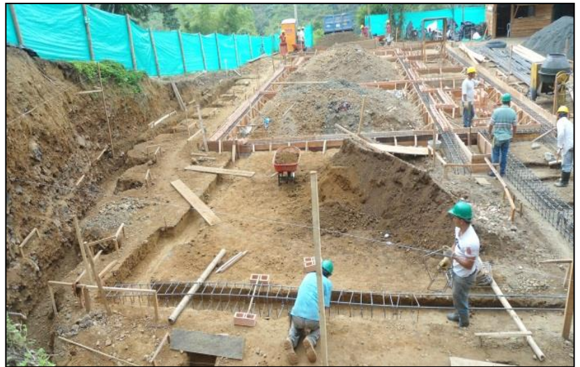
Foto No. 46. Armado de acero de refuerzo cimentación
