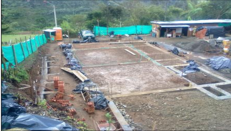
Foto No. 51. Llenos alrededor de la cimentación
