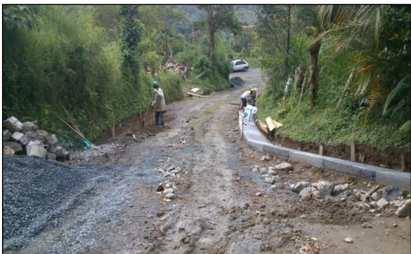
Foto No. 88. Construcción Huellas de Acceso
