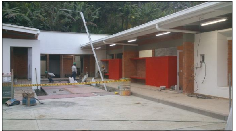
Foto No. 84. Instalación de Lámparas
