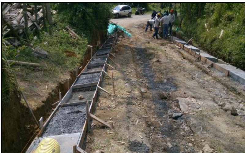
Foto No. 89. Construcción Cuneta Vehicular
