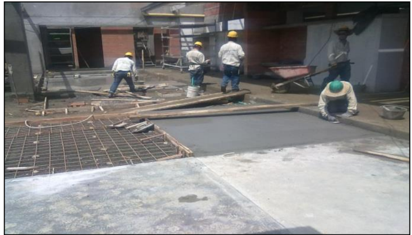
Foto No. 66. Vaciado de Concreto Zona Dura.
