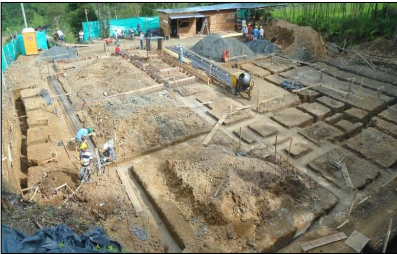
Foto No. 49. Vaciado concreto Vigas de Cimentación
