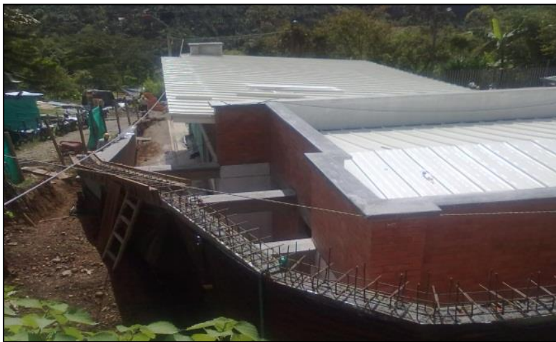
Foto No. 63. Instalación de Cubierta Termo acústica
