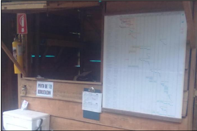
Foto No. 19. Cartelera para control de actividades en obra.
