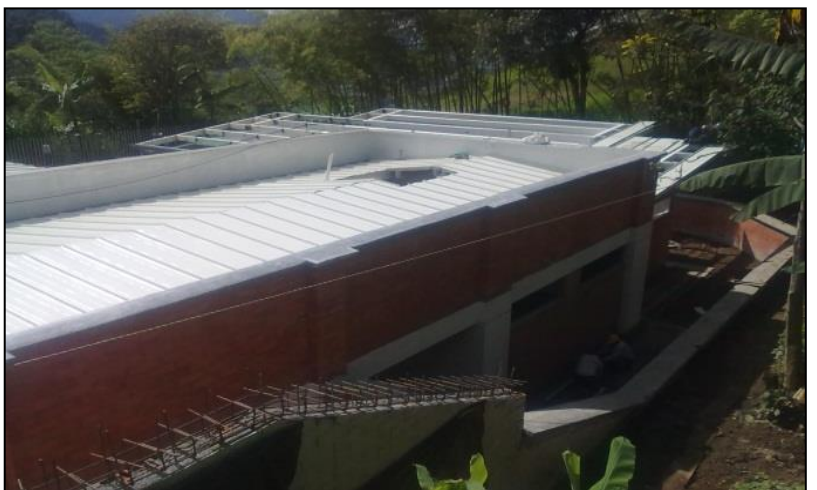
Foto No. 64. Instalación de Cubierta Termo acústica
