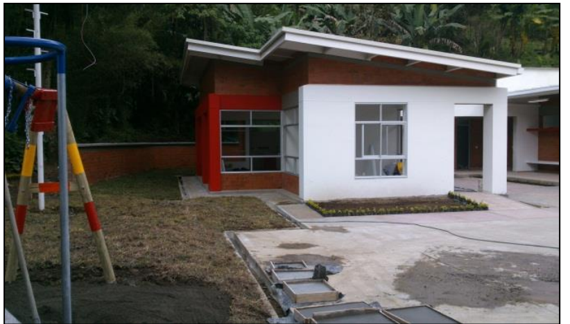
Foto No. 76. Acabados Exteriores
