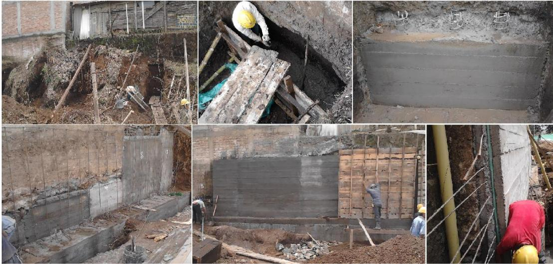
**Figura16.** Construcción de muros en lindero oriental del lote
