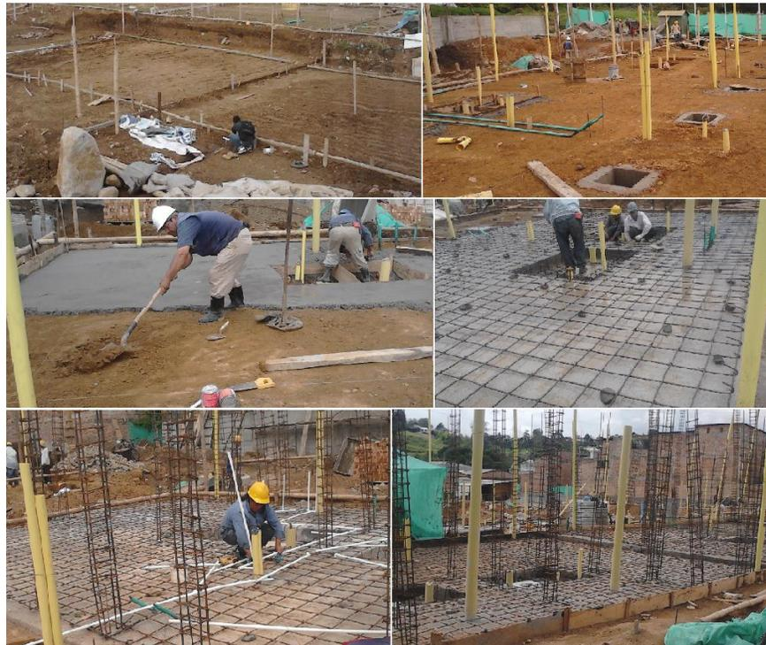
**Figura 26.** Construcción de losa de cimentación
