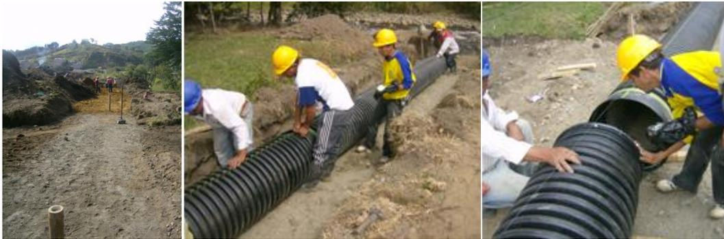
**Figura 19.** Construcción de tramos de alcantarillado
