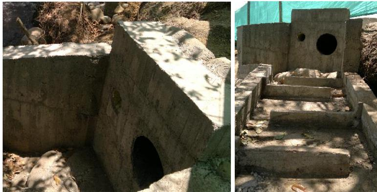
**Figura 21.** Descole alcantarillado
