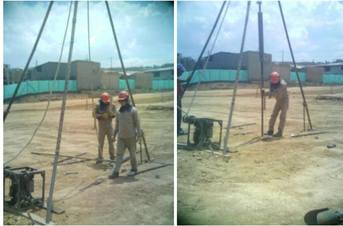
**Figura 12.** Toma de muestras inalteradas
