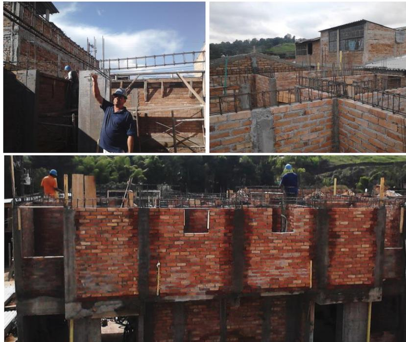
**Figura 38.** Construcción de vigas de entrepiso y cubierta
