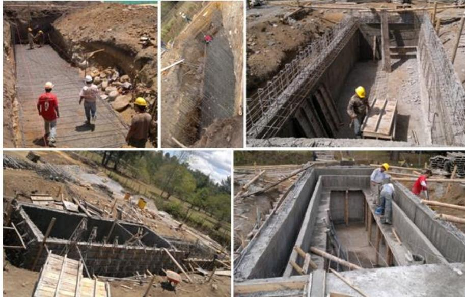
**Figura 22.** Construcción de estructura de PTAR
