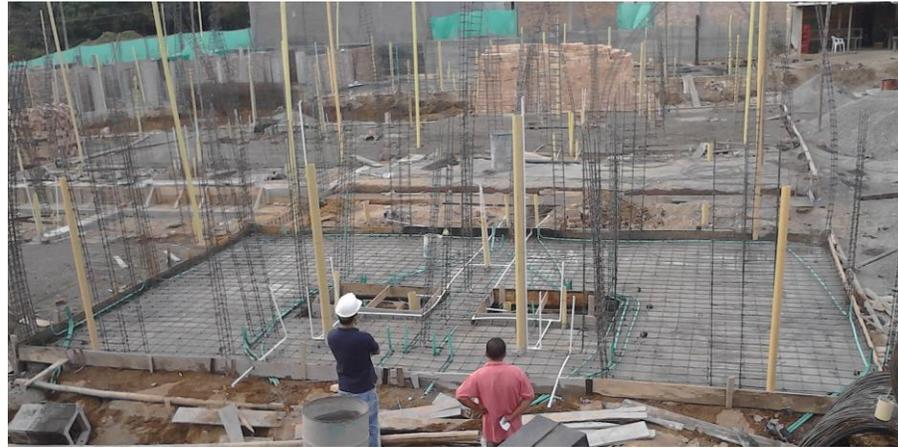
**Figura 27.** Losa de cimentación lista para fundición.
