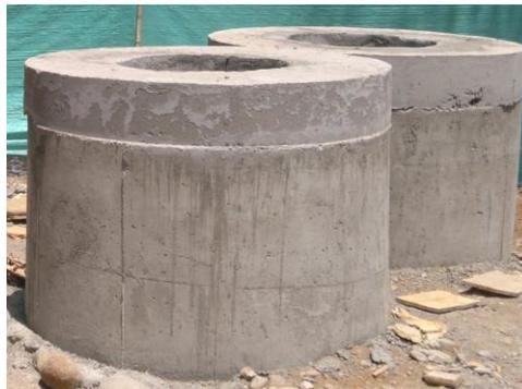
**Figura 20.** Cámaras de inspección de alcantarillado
