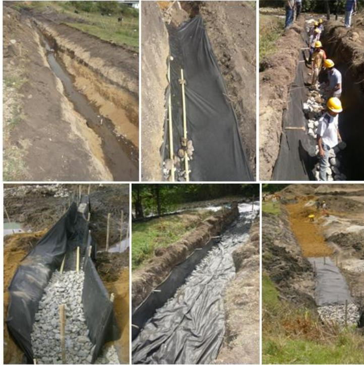
**Figura 9.** Proceso constructivo de filtros
