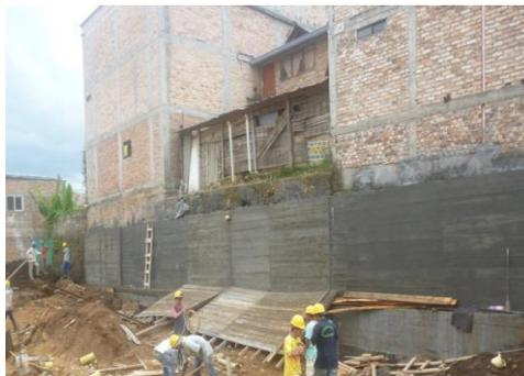
**Figura 18.** Muro de contención lindero oriental
