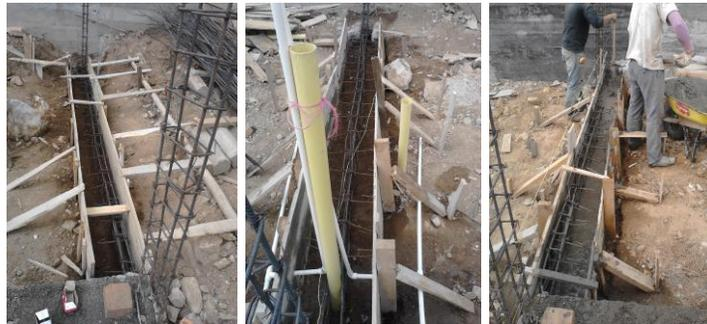
**Figura 29.** Construcción de vigas de cimentación
