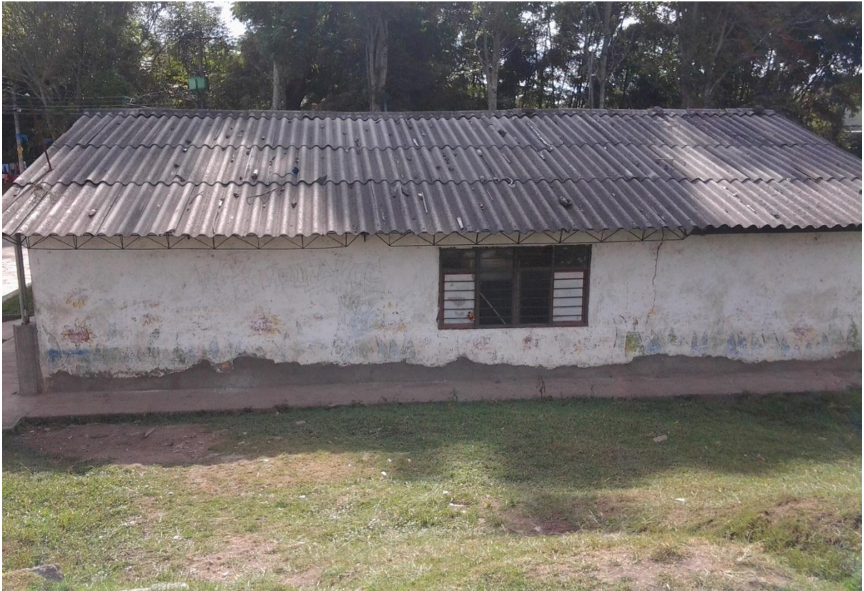
Imagen 4. SALÓN COMUNAL EXISTENTE BARRIO CANADÁ – POPAYÁN CAUCA
