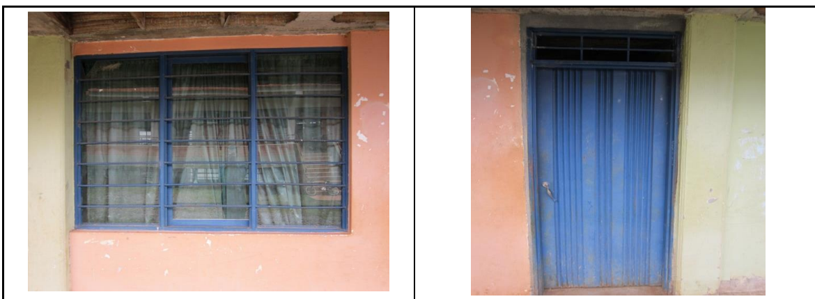
Puertas y Ventanas tipo en primer piso para suministrar en el segundo piso; existen ventanas tipo V-1 de 2.0 m y tipo V-2 de 3.30 m
