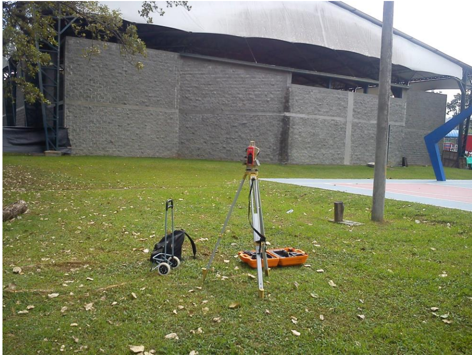
Figura 17. Toma de detalles con Estación total. En el CDU
