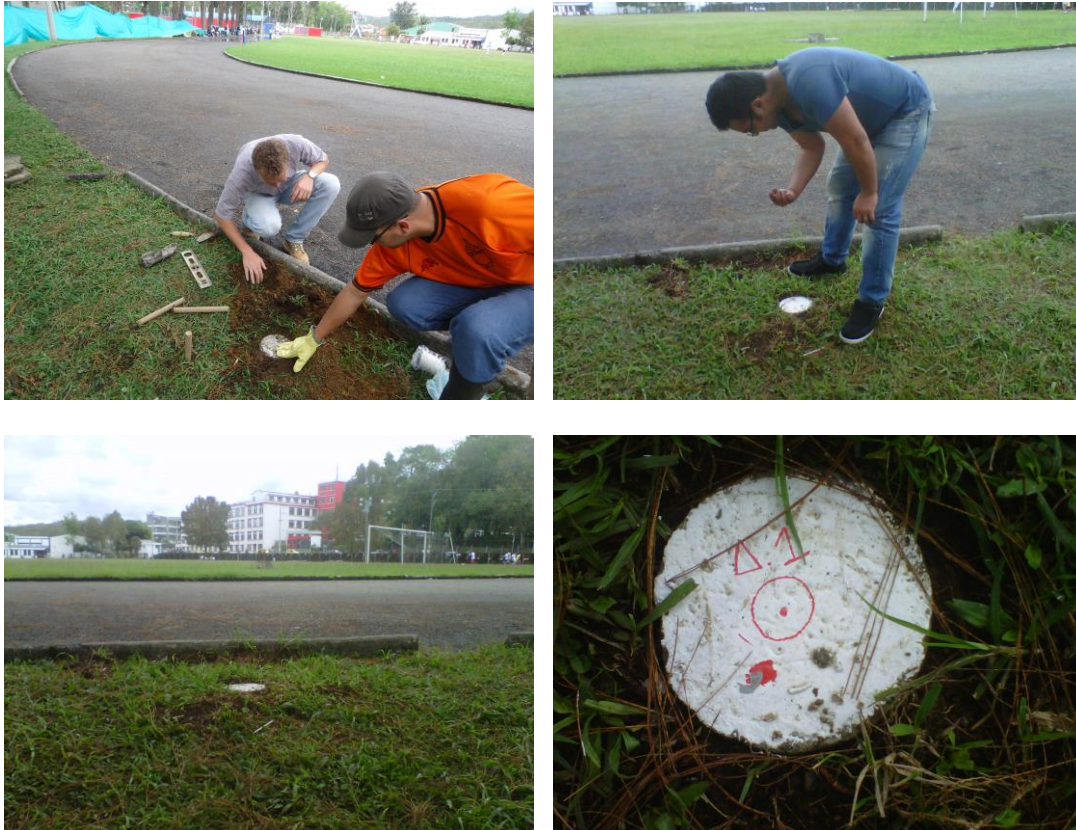
Figura 13. Proceso de Georeferenciación prefabricado del delta 1 (Junto a la Pista Atlética)
