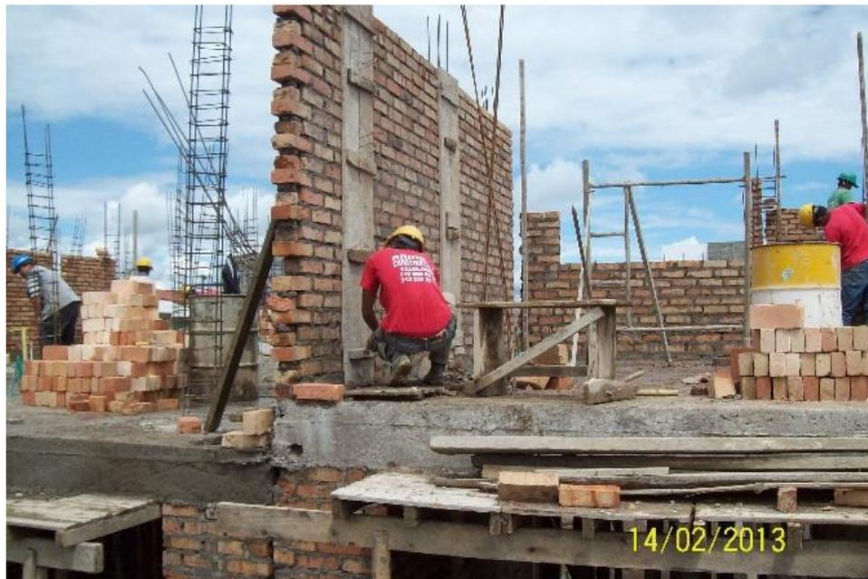
**Figura No. 62: Fundición de columnas segundo piso**
