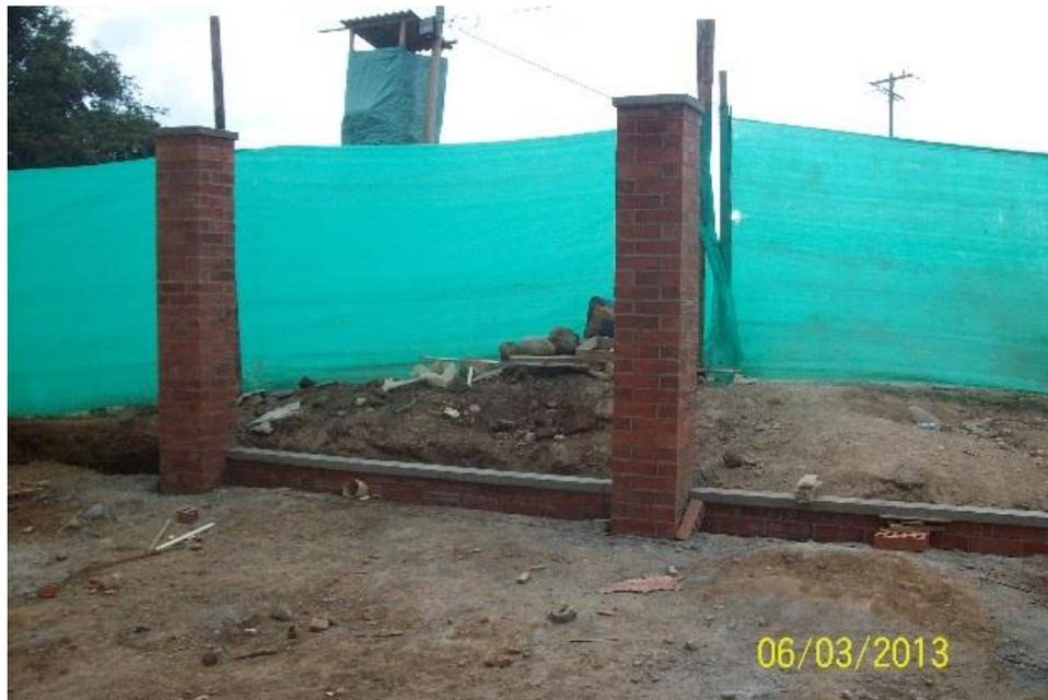
**Figura No. 96: columnas del muro de cimentación**
