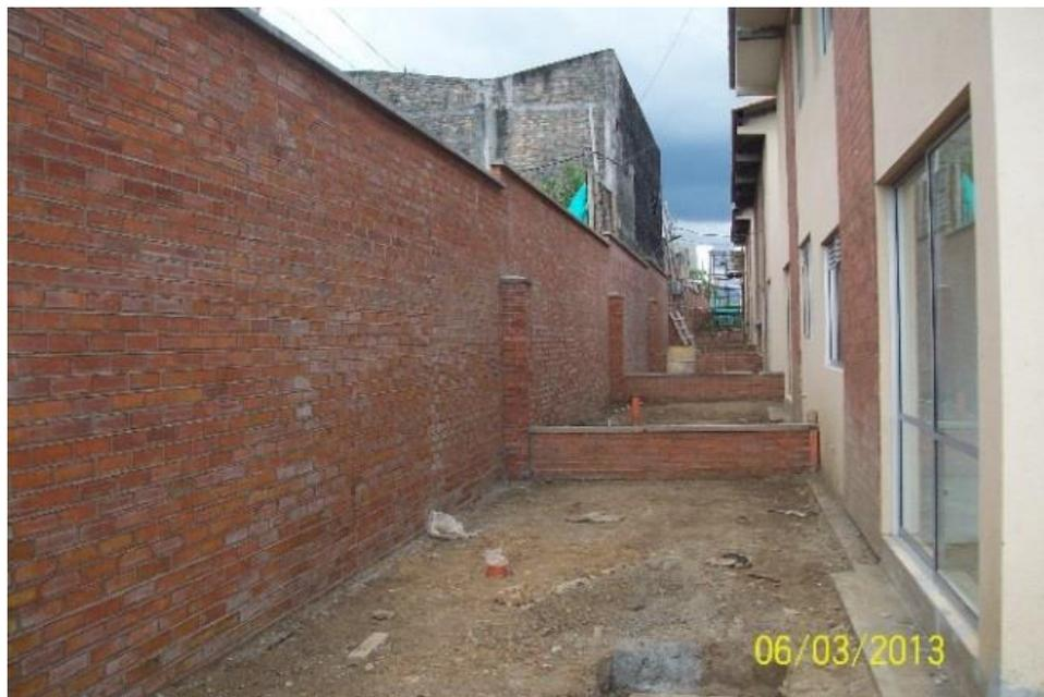
**Figura No. 97: machones del muro de cimentación**
