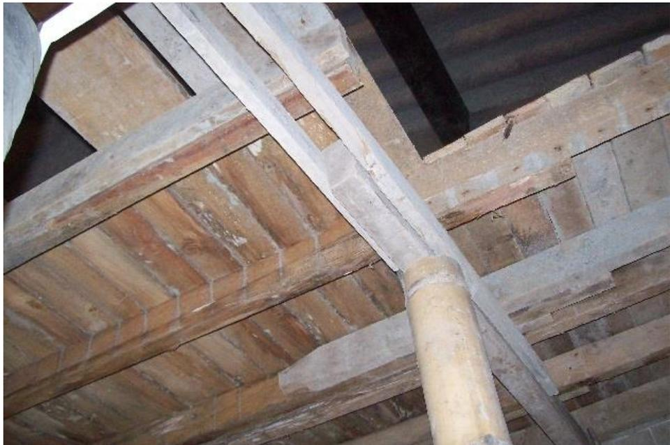
**Figura No. 66: tableros que sostienen la losa**
