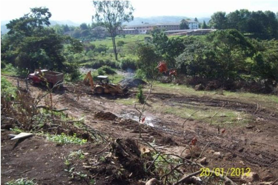
**Figura No. 188: descapote de terreno para vía**
