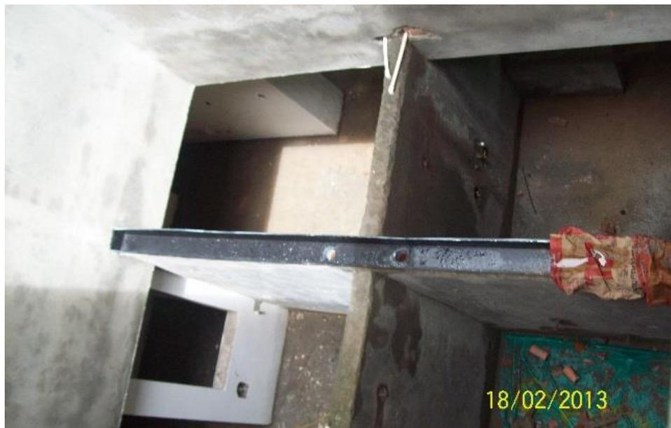
**Figura No. 113: instalación de canales internos**
