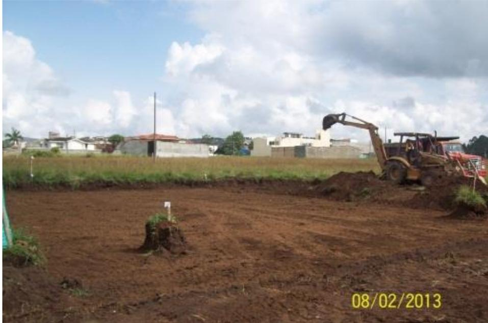
**Figura No. 22: Descapote del terreno.**
