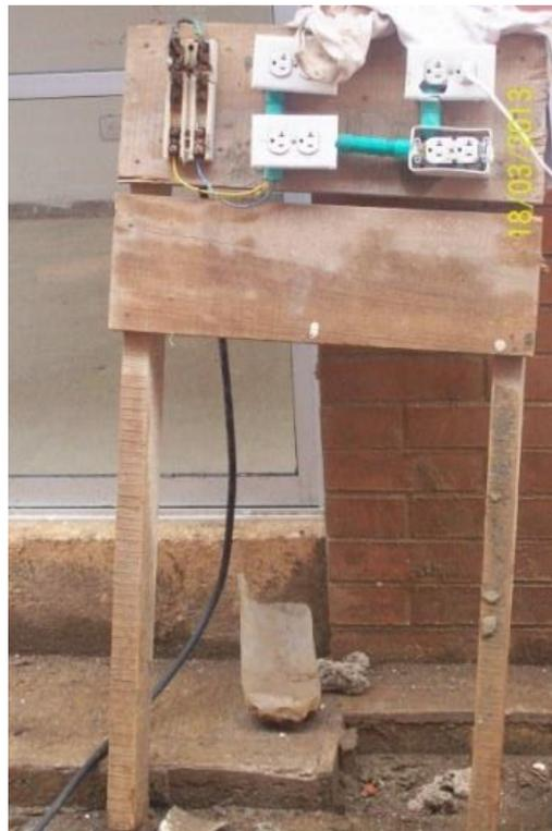
Figura No. 210: tablero eléctrico en mal estado
