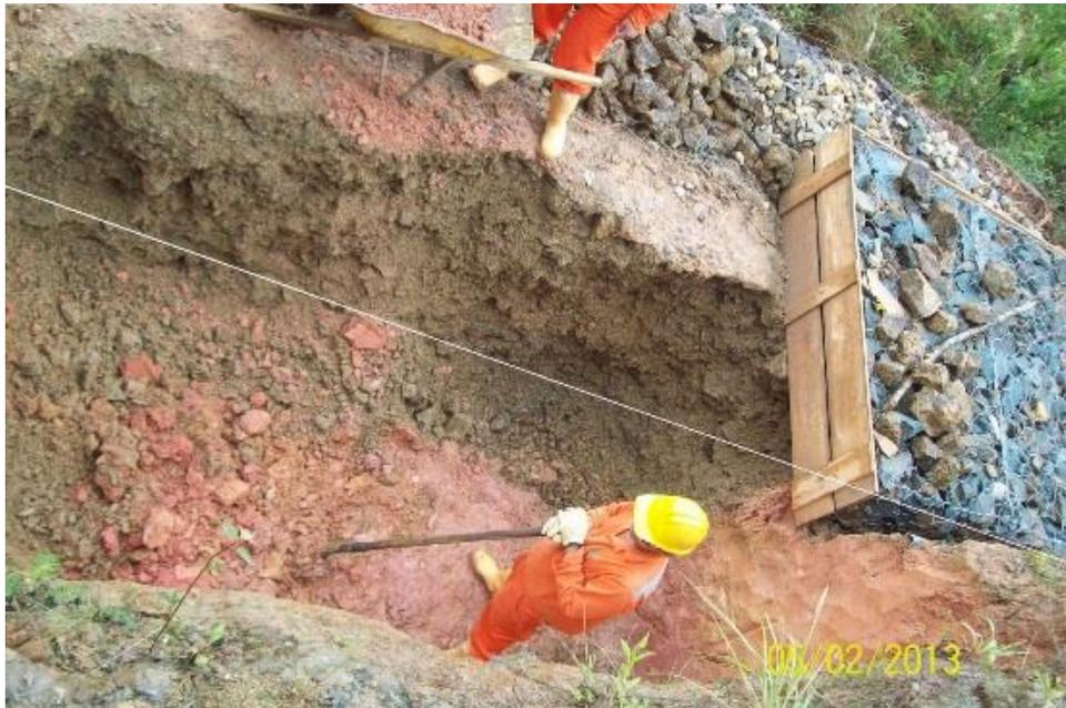
**Figura No. 216: elaboración de muros en gaviones**
