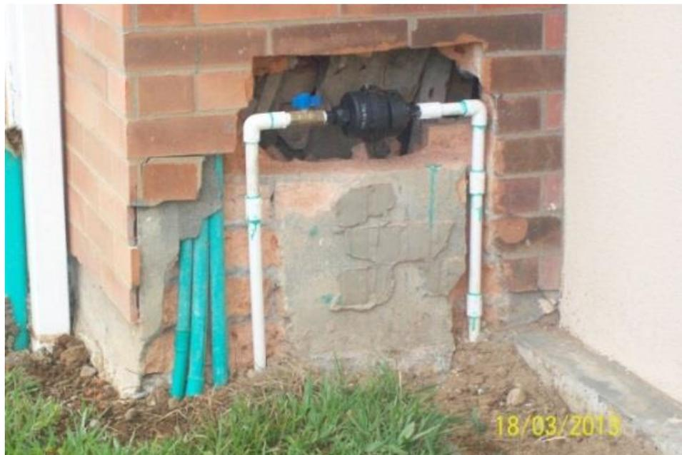
Figura No.172: instalación de contadores
