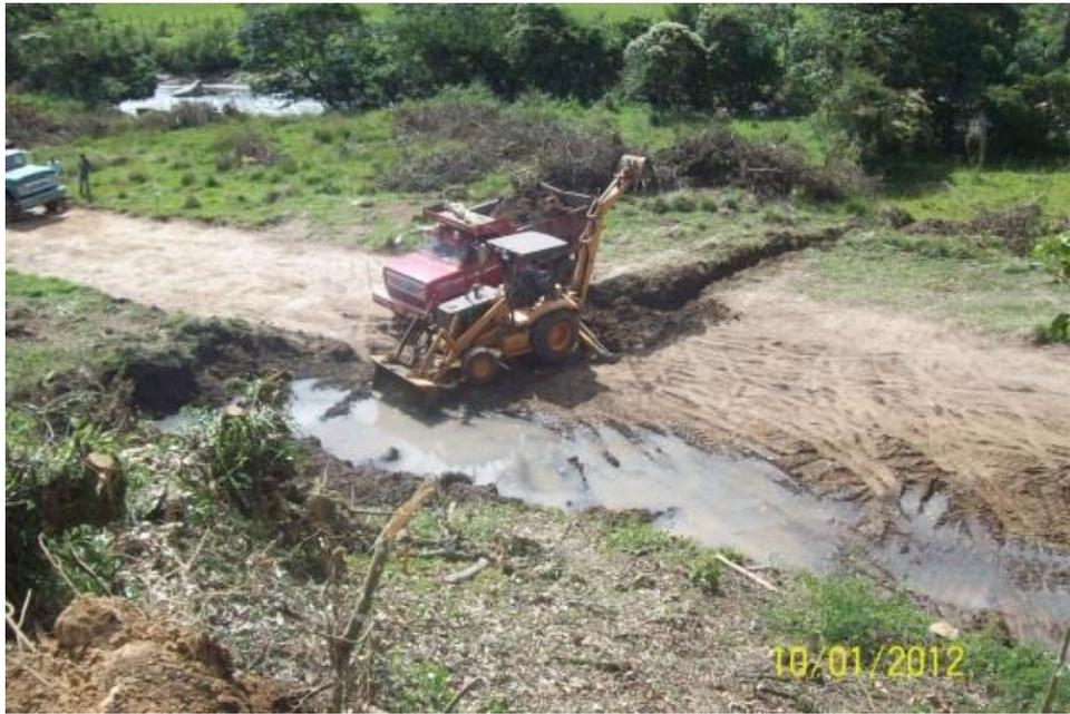
**Figura No. 193: excavación para filtros**
