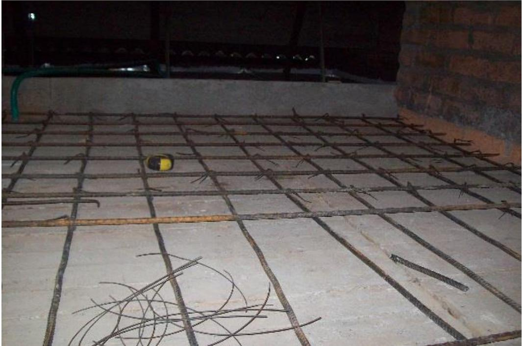
Figura No. 67: acero de refuerzo de la losa
