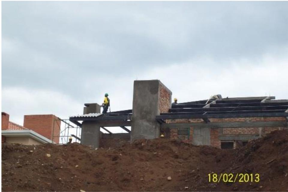
**Figura No. 181: instalación de perlineria bloques**
