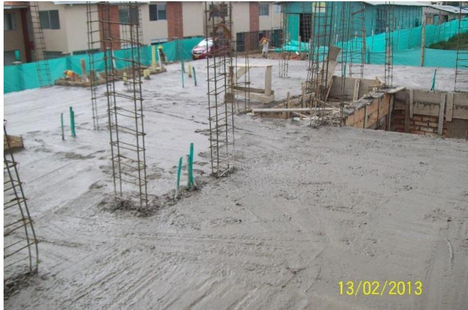
**Figura No. 59: Fundición de losa terminada**
