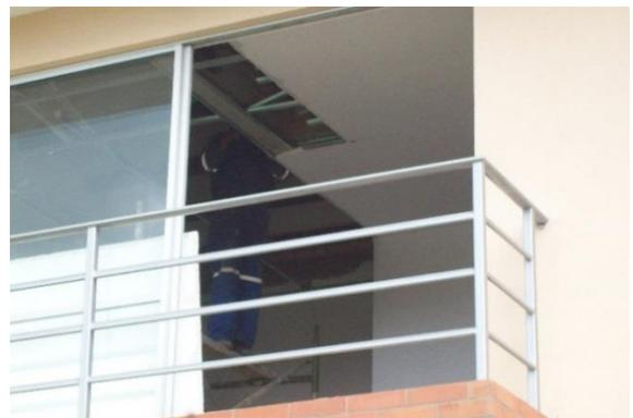
**Figura No. 92: instalación del panel yeso.**
