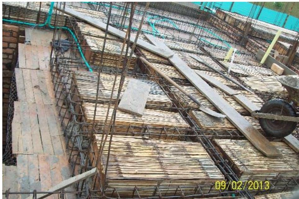
**Figura No 55: Casetones instalados antes de fundición**
