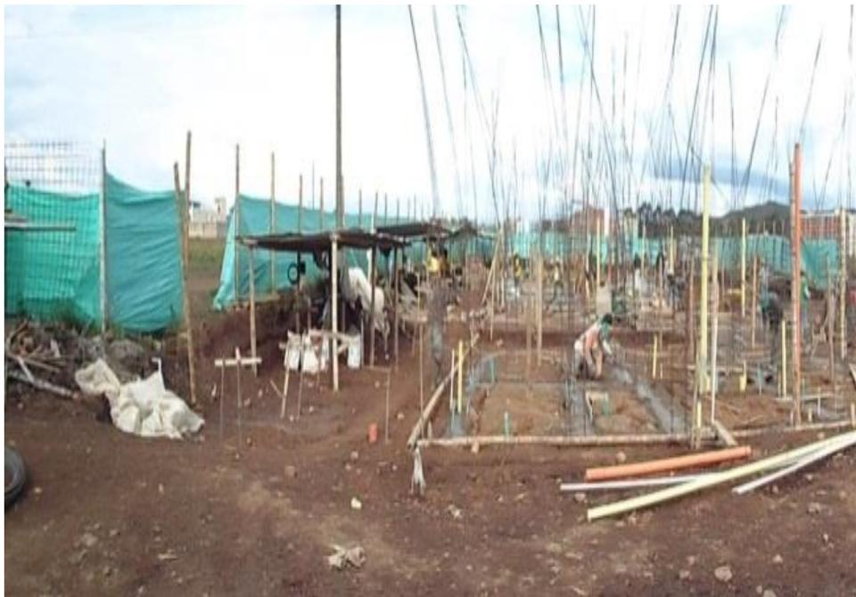
**Figura No. 151: columnetas instaladas**
