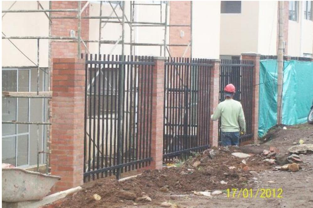
**Figura No. 98: instalación de barandas metálicas.**
