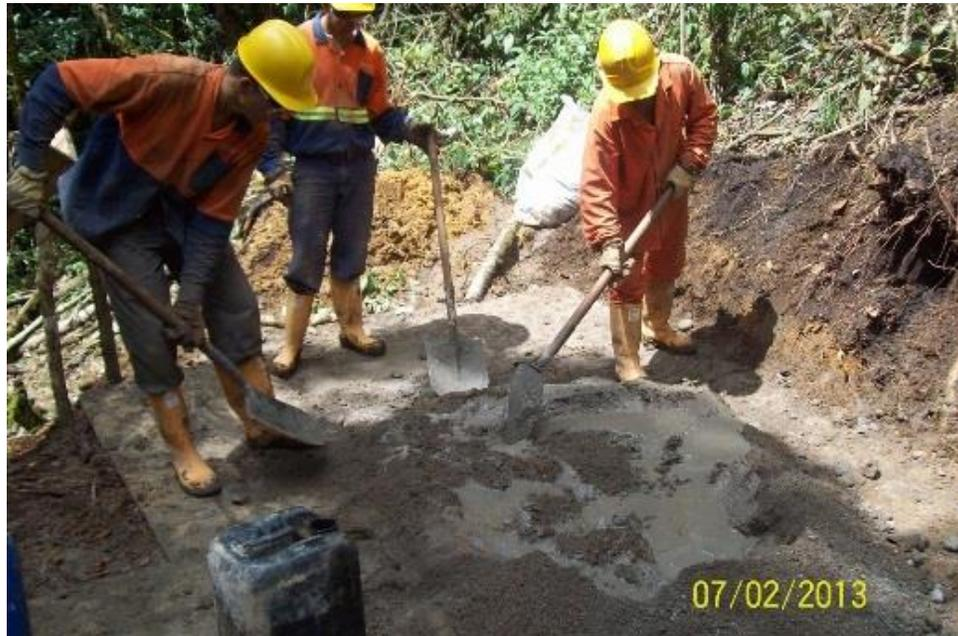
**Figura No. 227: elaboración de mezcla o mortero**
