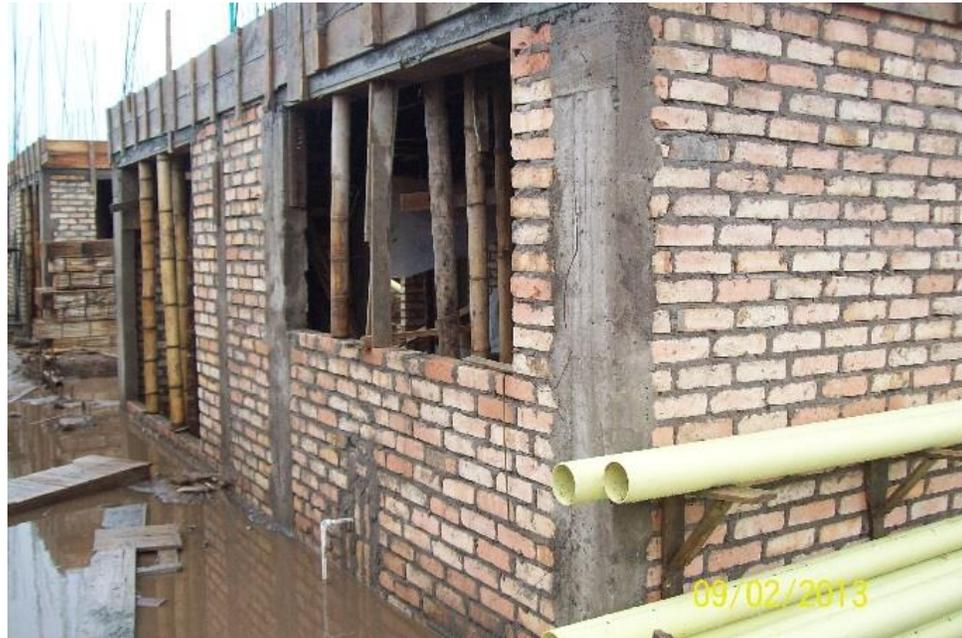
Figura No. 50: Muros y arriostramiento
