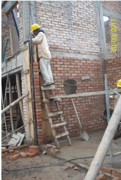
Figura No. 46: Instalación de la formaleta y apoyos de la columna
