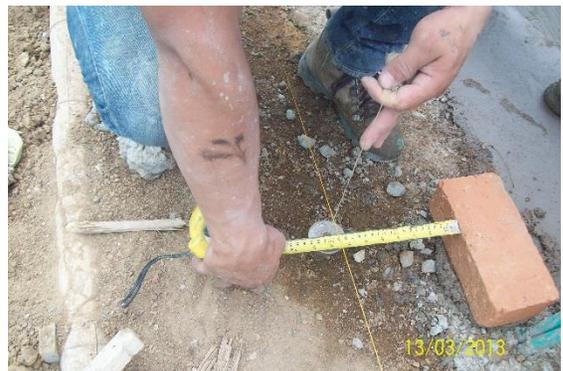
**Figuras No. 38 y 39: Verificación de escuadra, ángulos y medidas en la pega de ladrillos.**
