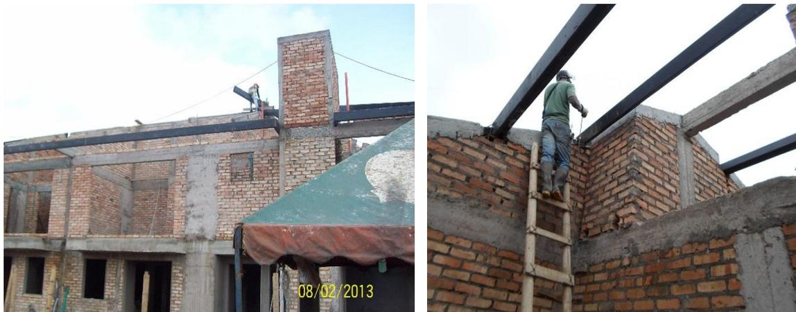
Figura No. 72 y 73: instalación de estructura del techo en perlineria metálica.
