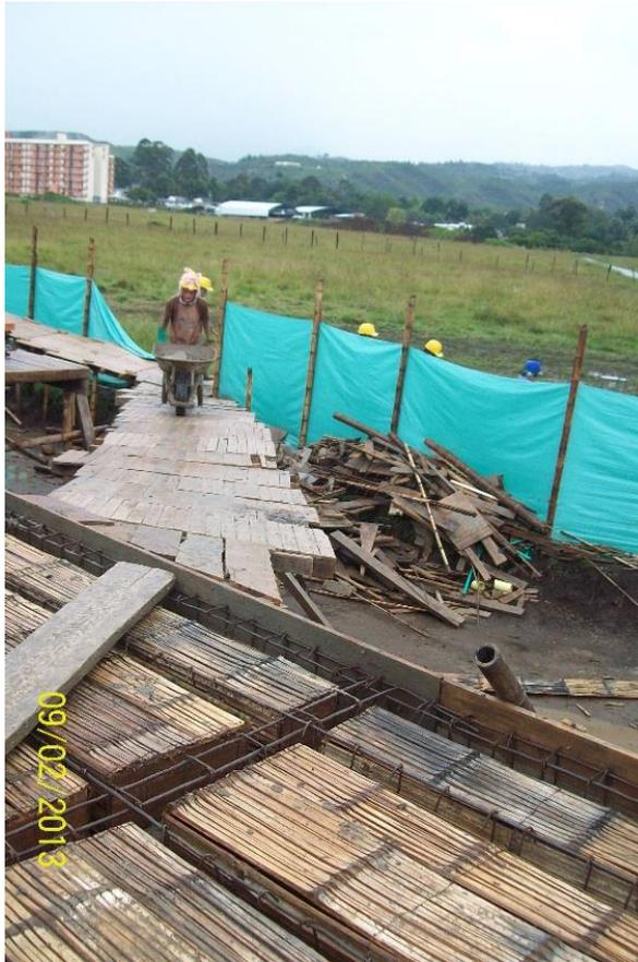
Figura No. 58: Rampa para transporte de concreto
