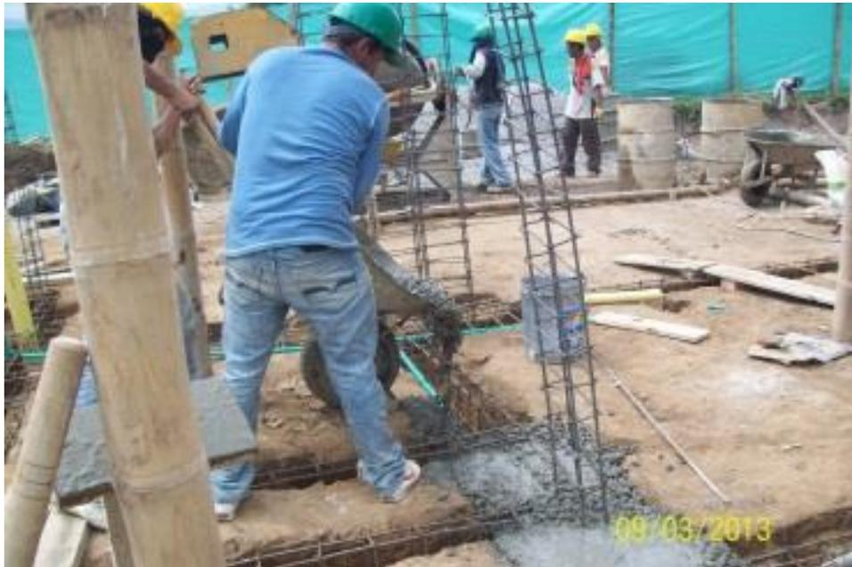
**Figura No. 32: Transporte y colocación del concreto**
