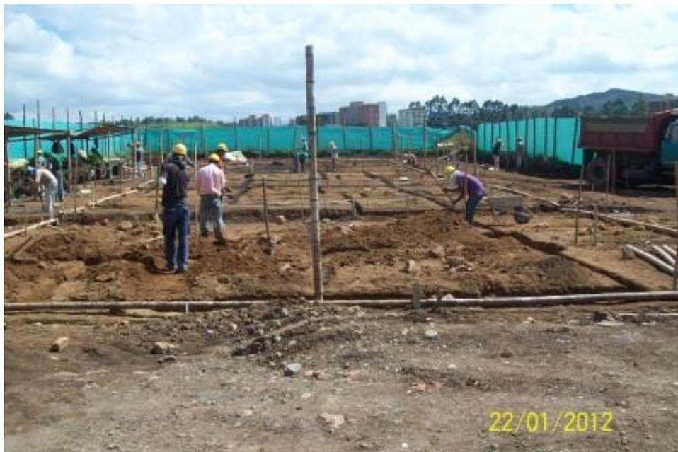
**Figura No. 25: Excavaciones para la cimentación**
