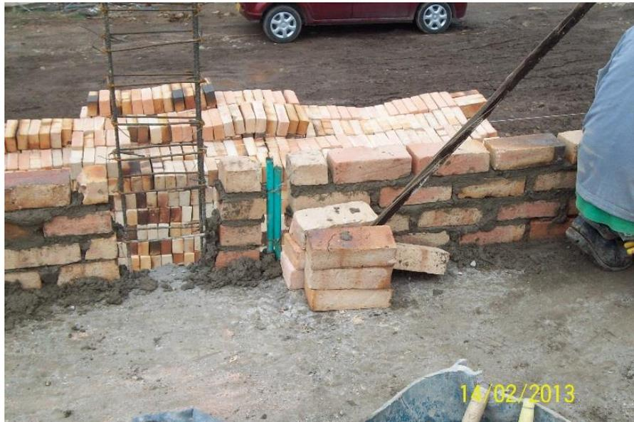
**Figura No. 43: Pega de hiladas de ladrillo, utilizando el hilo como nivel**
