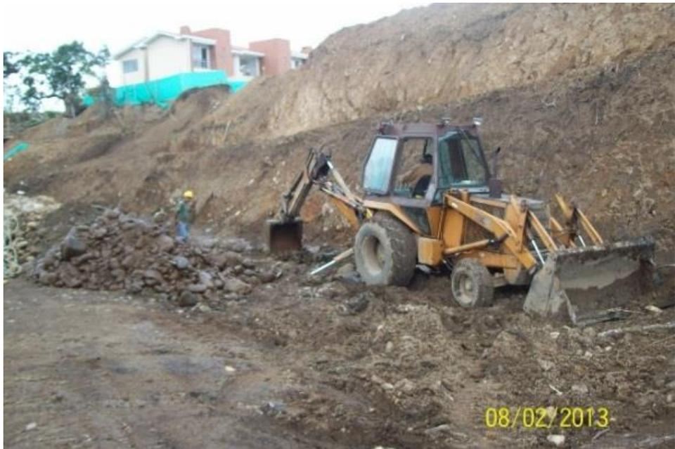
**Figura No. 194: excavación para filtros**
