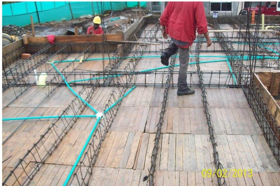
**Figura No. 51: Malla de pollo, aceros y tuberías instaladas**
