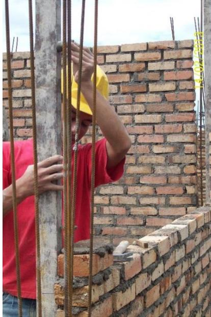
**Figura No. 44: Verificación de la verticalidad de los muros**
