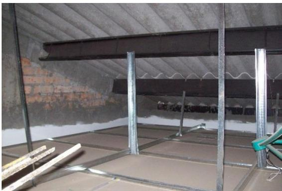
**Figura No. 91: instalación de perfiles metálicos**
