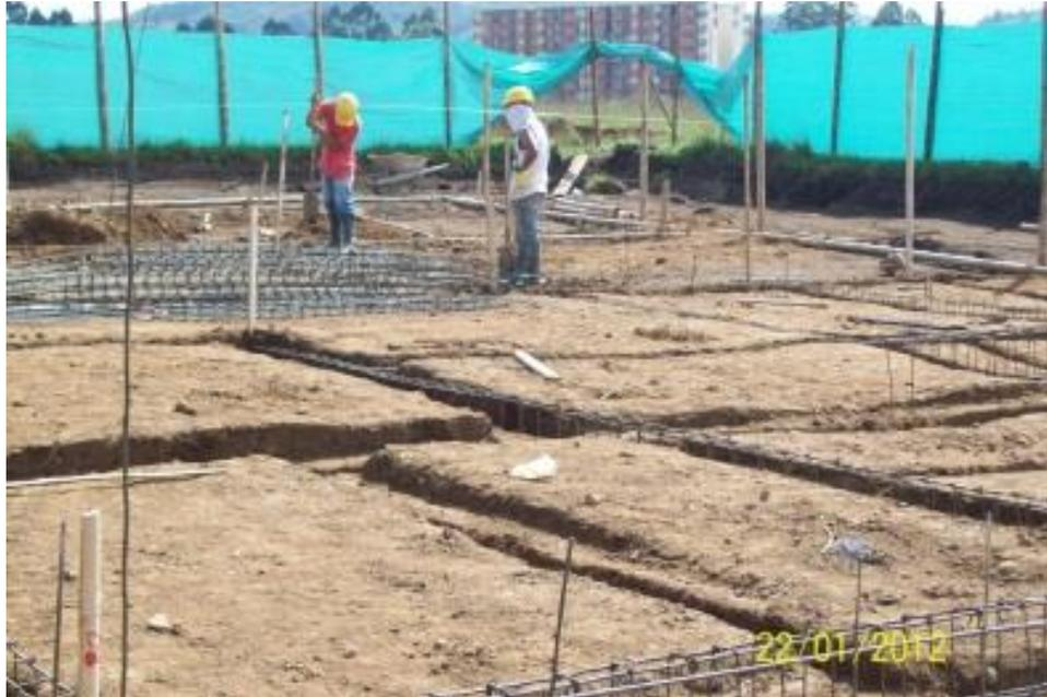
**Figuras No. 26 Colocación del acero de cimentación.**
