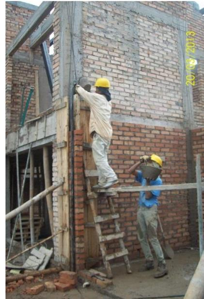
Figura No. 47: fundición de la columna
