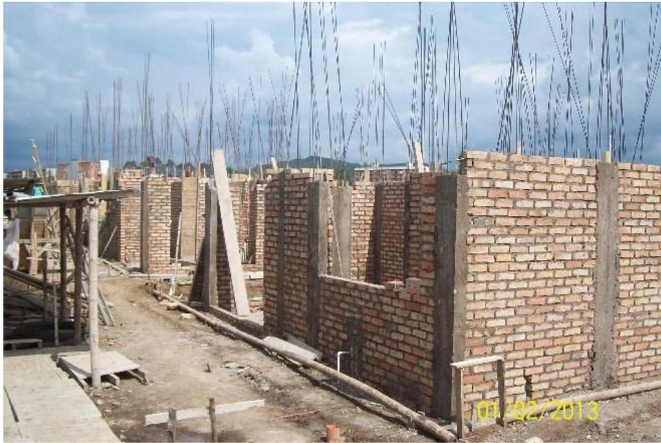
Figura No. 49: Columnas terminadas y desencofradas
