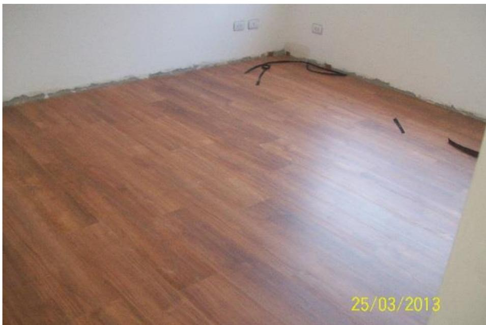
**Figura No. 116: instalación de pisos laminados**
