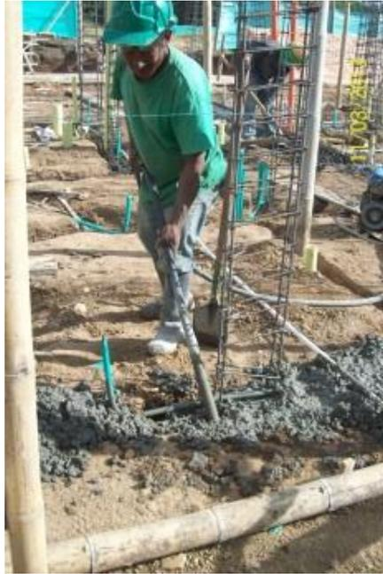
**Figura No. 33: Vibrado del concreto**
