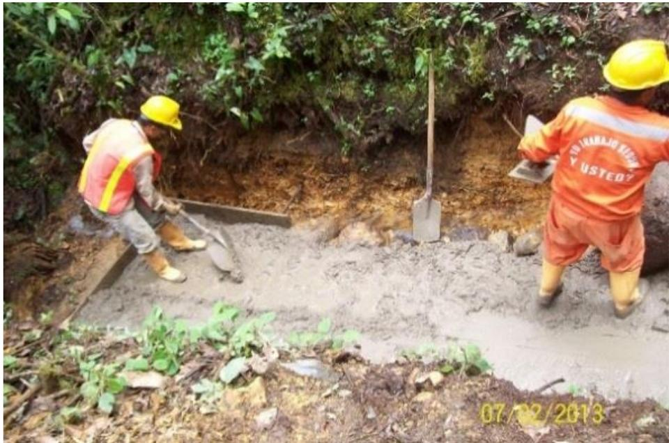
**Figura No. 226: solado del vox culvet**
