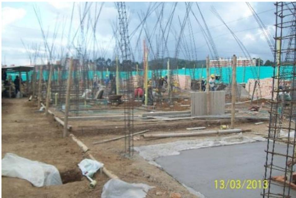
**Figura No. 37: detalle del plástico para evitar contaminación del mortero**
