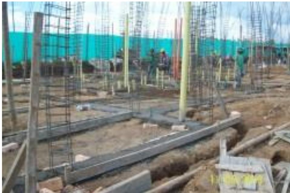
**Figura No. 35: Fundición de zapatas terminada**
