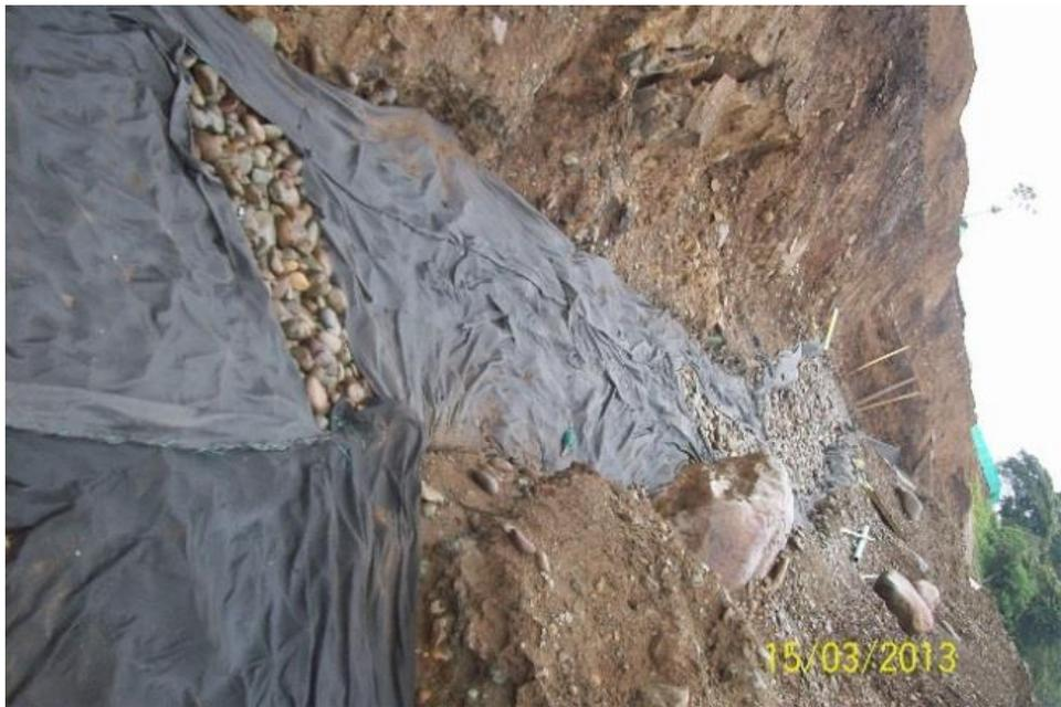
**Figura No. 136: cerramiento del geotextil**
