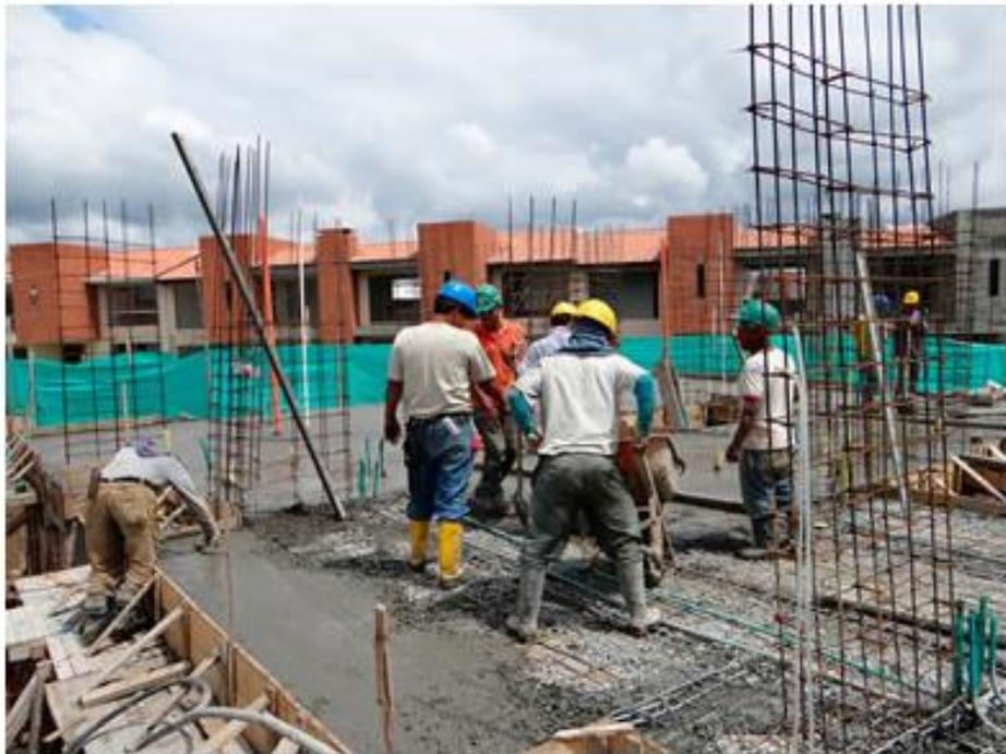
Figura No. 174: fundición de losa bloques
