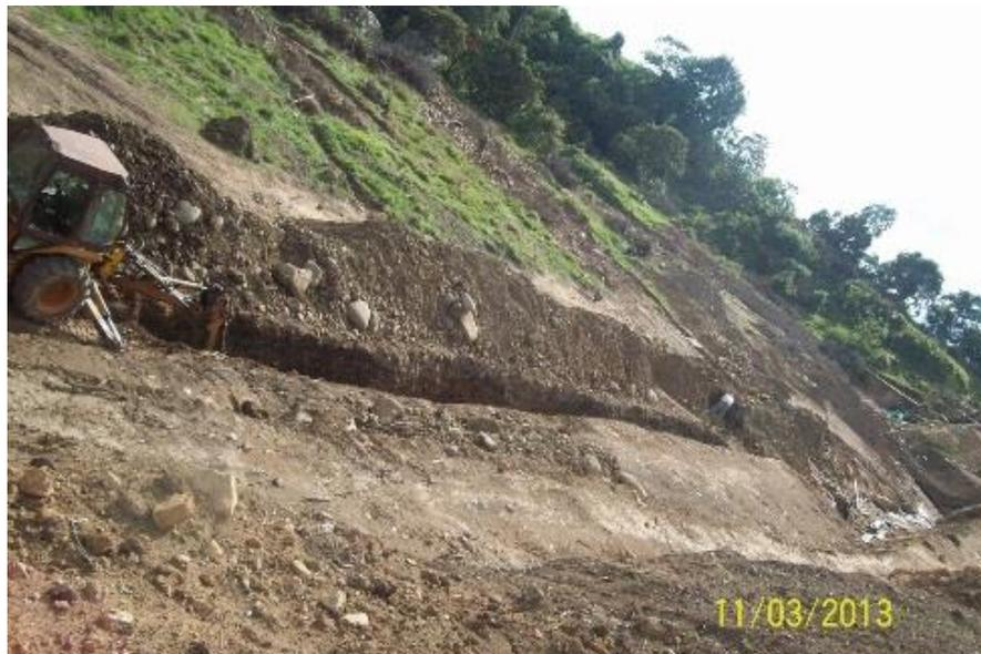
**Figura No. 196: excavación para filtros**
