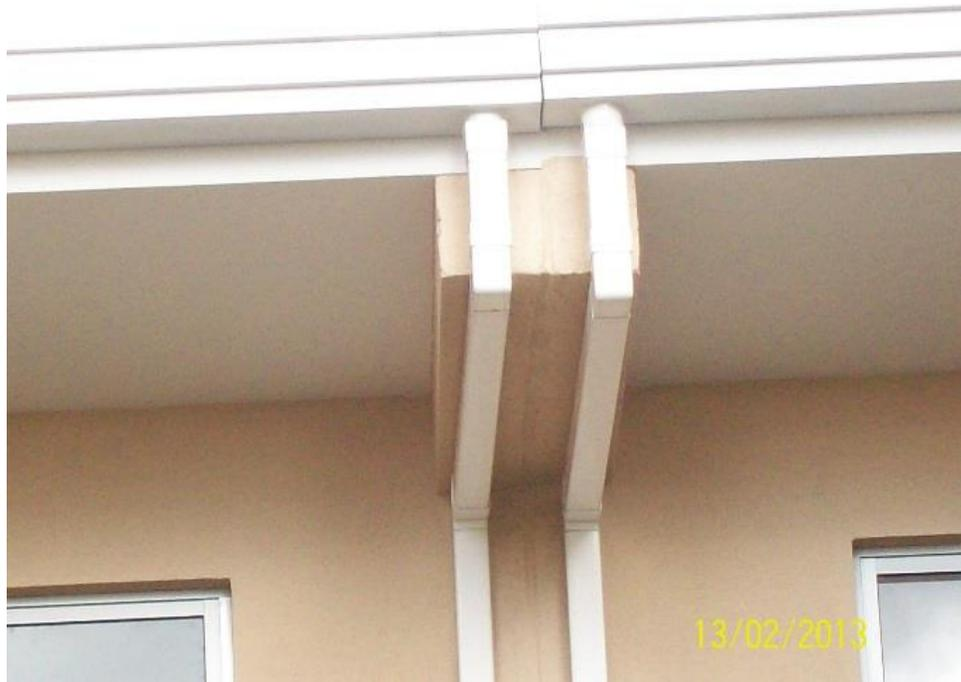
**Figura No. 112: instalación de bajantes**
