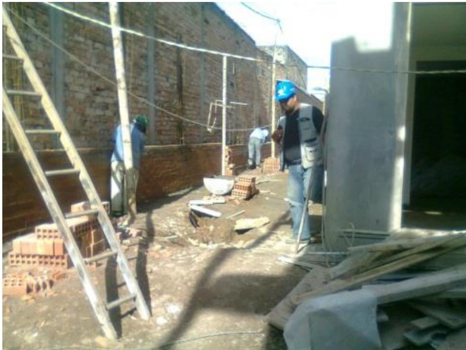
**Figura No. 164: muro de cerramiento**
