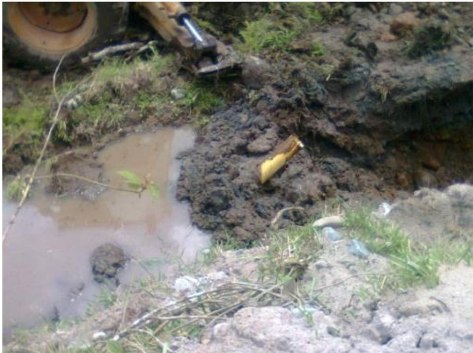
**Figura No. 204: retiro de tubería inservible**
