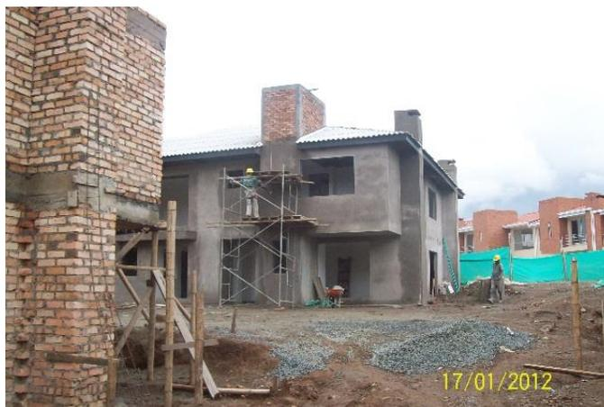
Figura No. 75: instalación de teja de asbesto cemento
