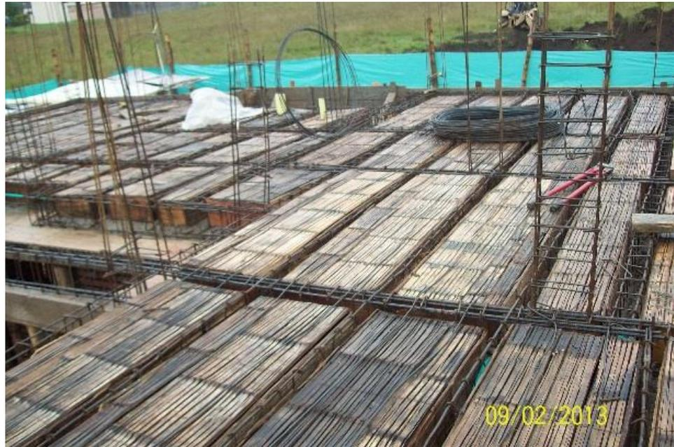
**Figura No. 56: Instalación de acero de temperatura**
