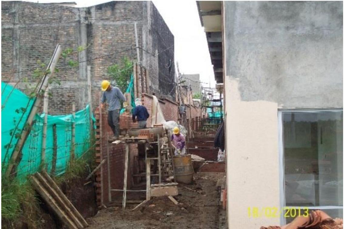
**Figura No. 94: elaboración del muro de cerramiento**
