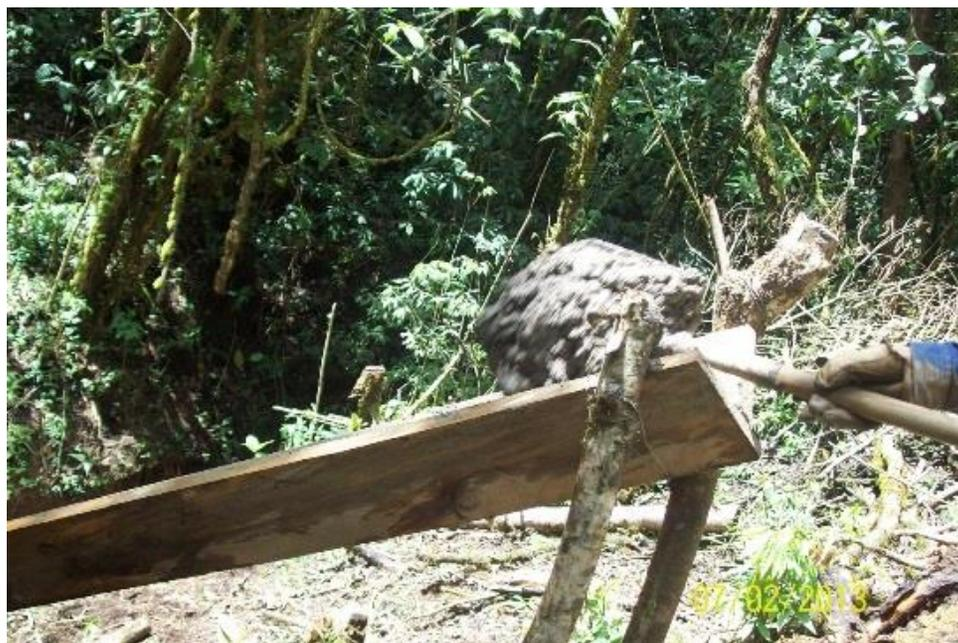
**Figura No. 228: transporte del mortero**
