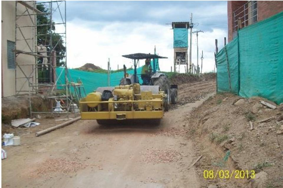
**Figura No. 125: mantenimiento de las vías internas**
