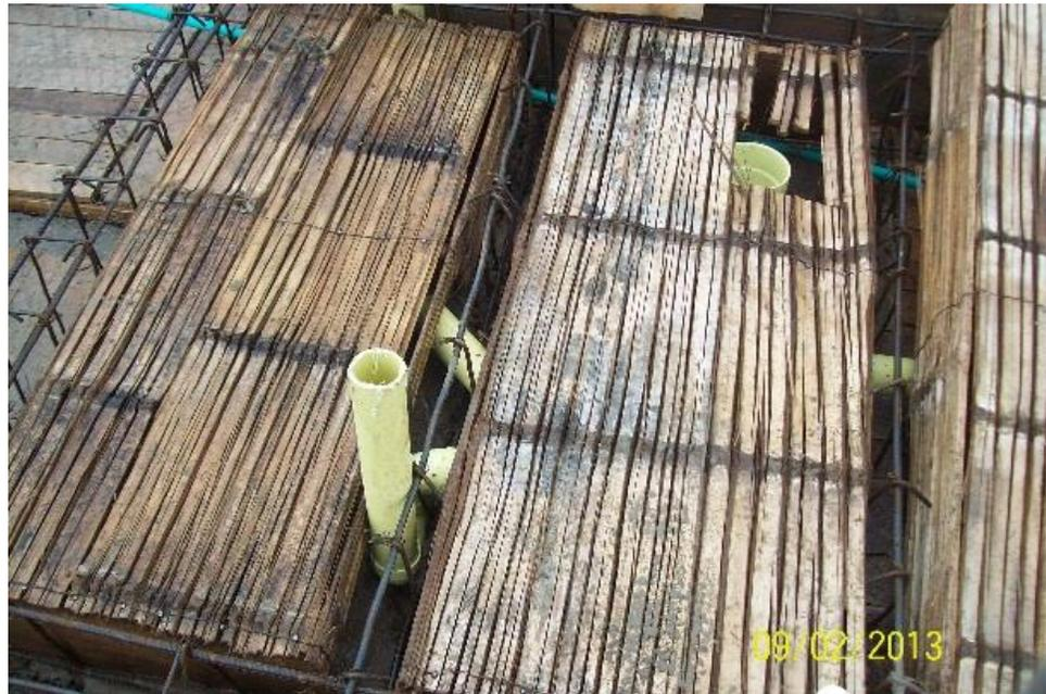
**Figura No. 54: Casetones instalados y tubería sobresaliendo**
