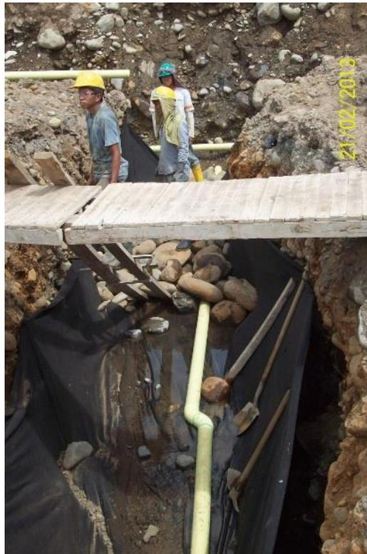
Figura No. 198: tubería perforada de filtros
