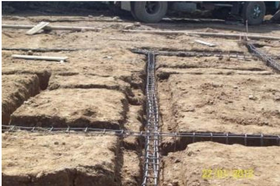
**Figura No. 27: Colocación del acero de cimentación.**
