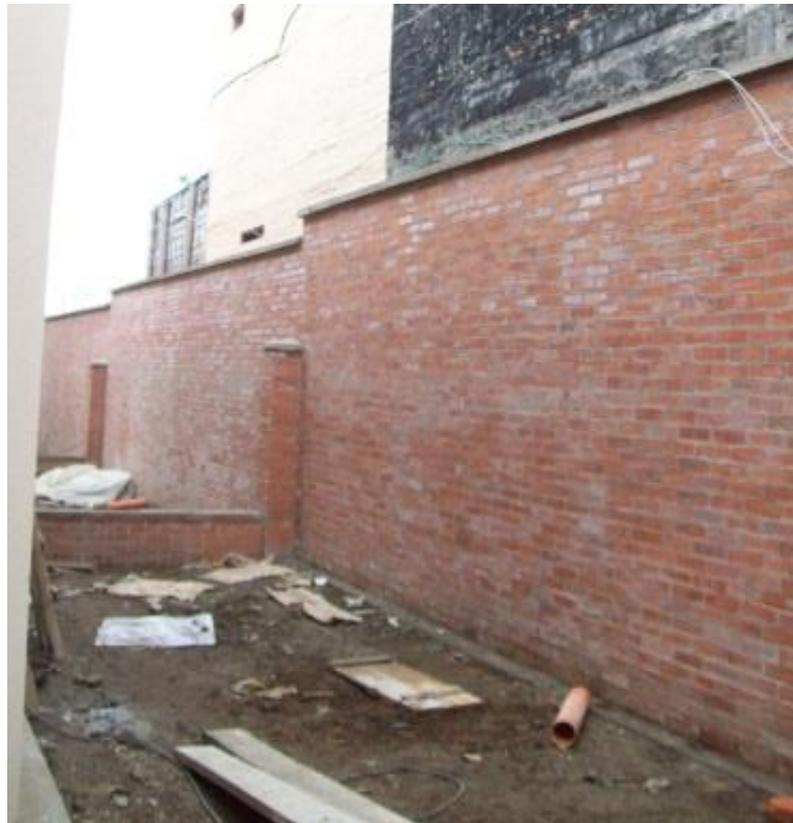
**Figura No. 166: muros de cerramiento terminados**
