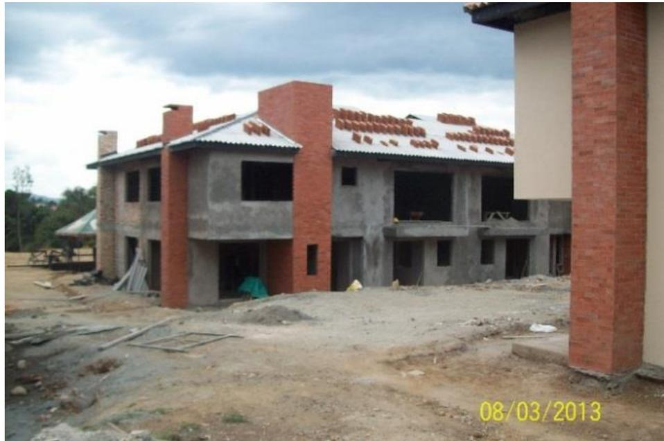
**Figura No. 76: instalación de teja de barro**
