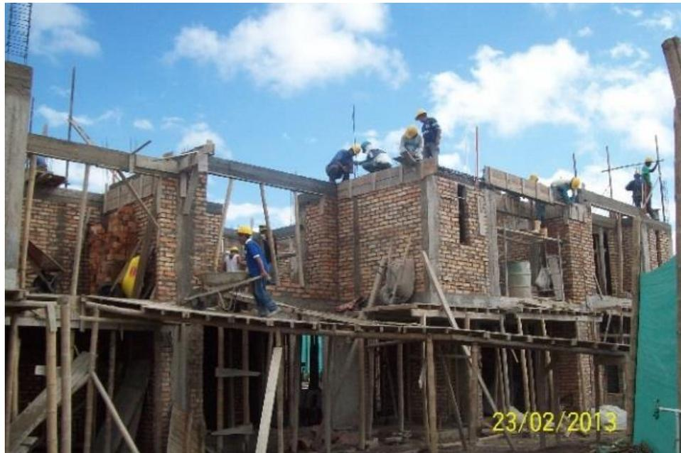
**Figura No. 64: Fundición de vigas segundo piso**
