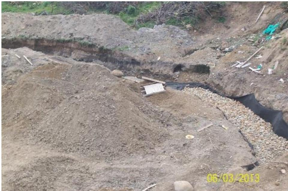
**Figura No. 200: filtros en construcción**
