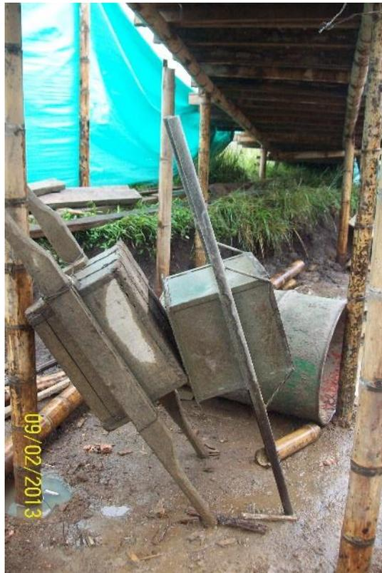
**Figura No. 31: Cajones diseñados para dosificar los materiales**
