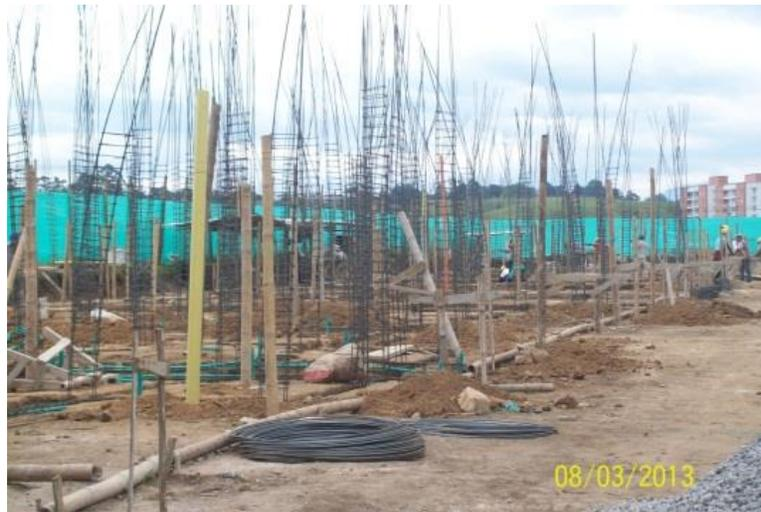
**Figura No. 28: Instalación de columnetas**
