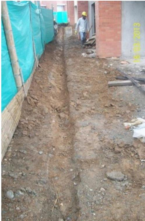
**Figura No. 163: excavación para cimentación de muros**
