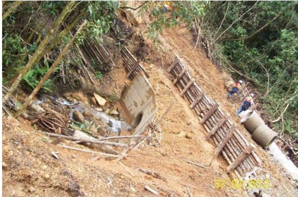
**Figura No. 224: vox culvet y trinchos elaborados**
