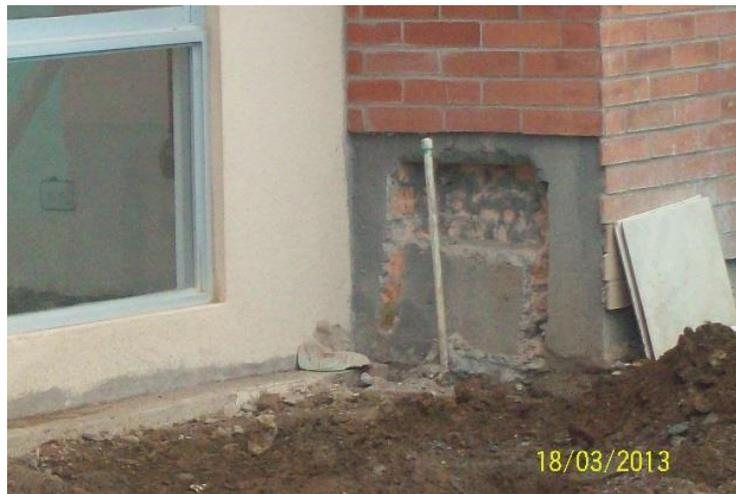
**Figura No. 121: punto para instalación de contador**
