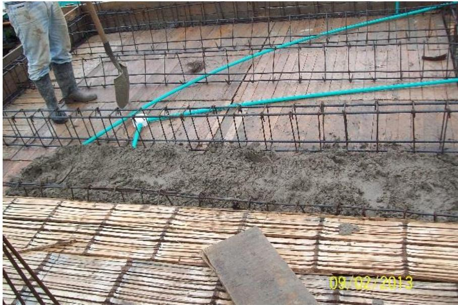
Figura No. 52: Aplicación del mortero
