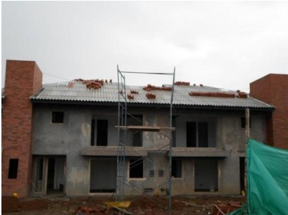
**Figura No. 183: instalación tejas casa tipo 2**
